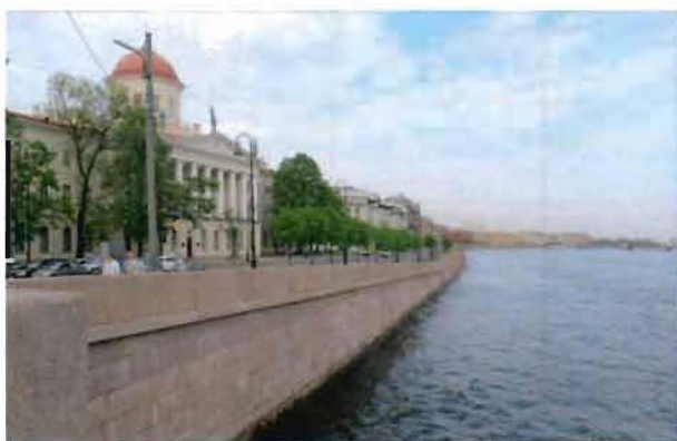
1. Вид стенки набережной от Биржевого моста
