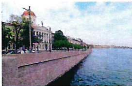
1. Вид стенки набережной от Биржевого моста
