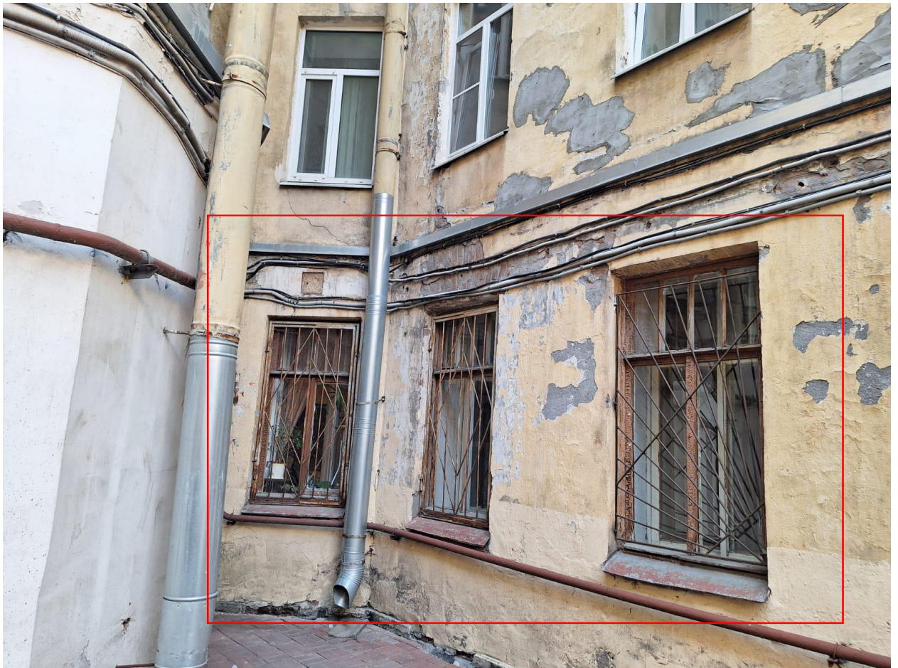
Фото 8. Фрагмент дворового фасада с окнами квартиры. Лицевой корпус. Вид на окна кв. №102
