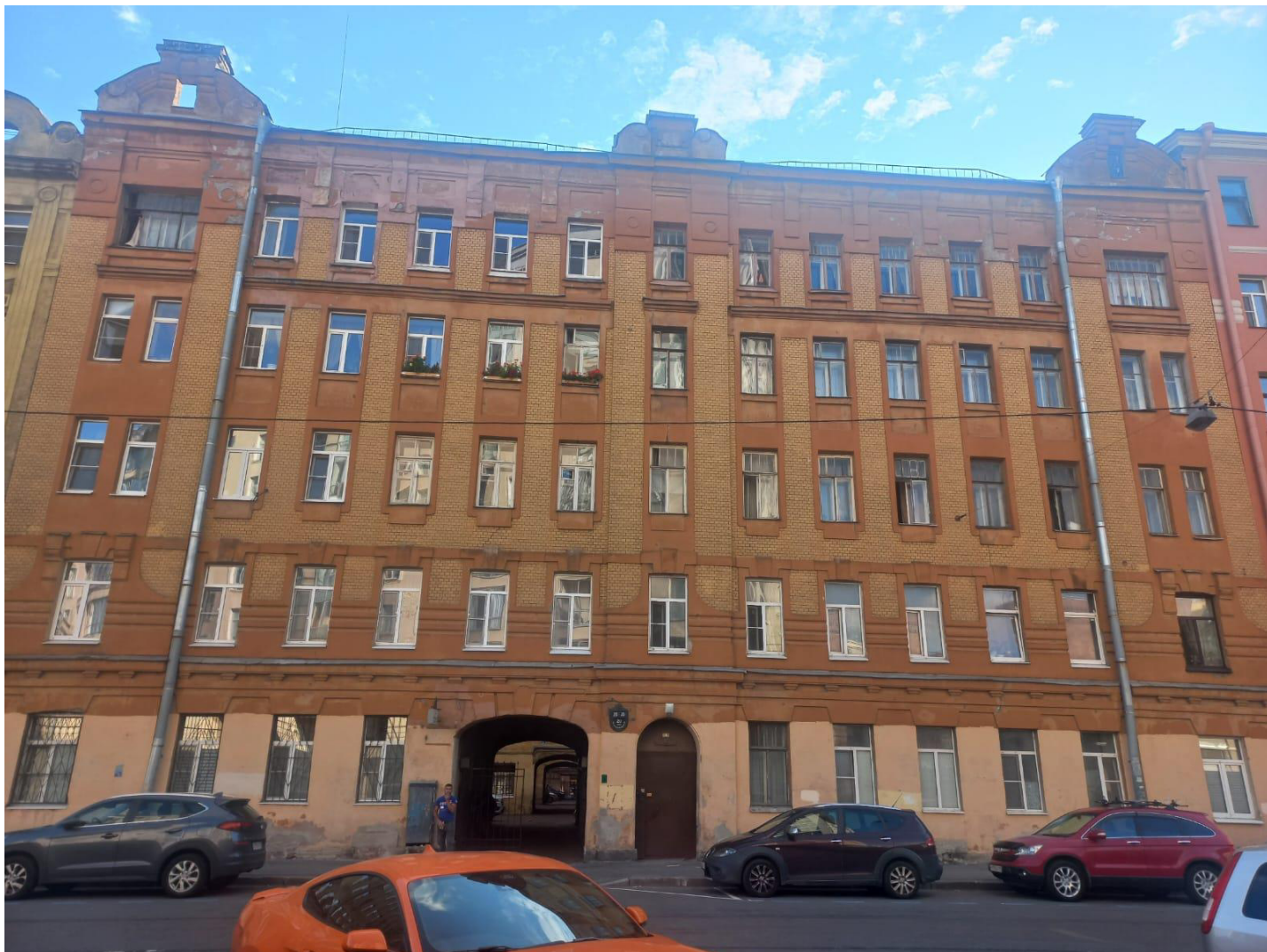
Фото 1. Лицевой фасад по ул. Петрозаводской.
