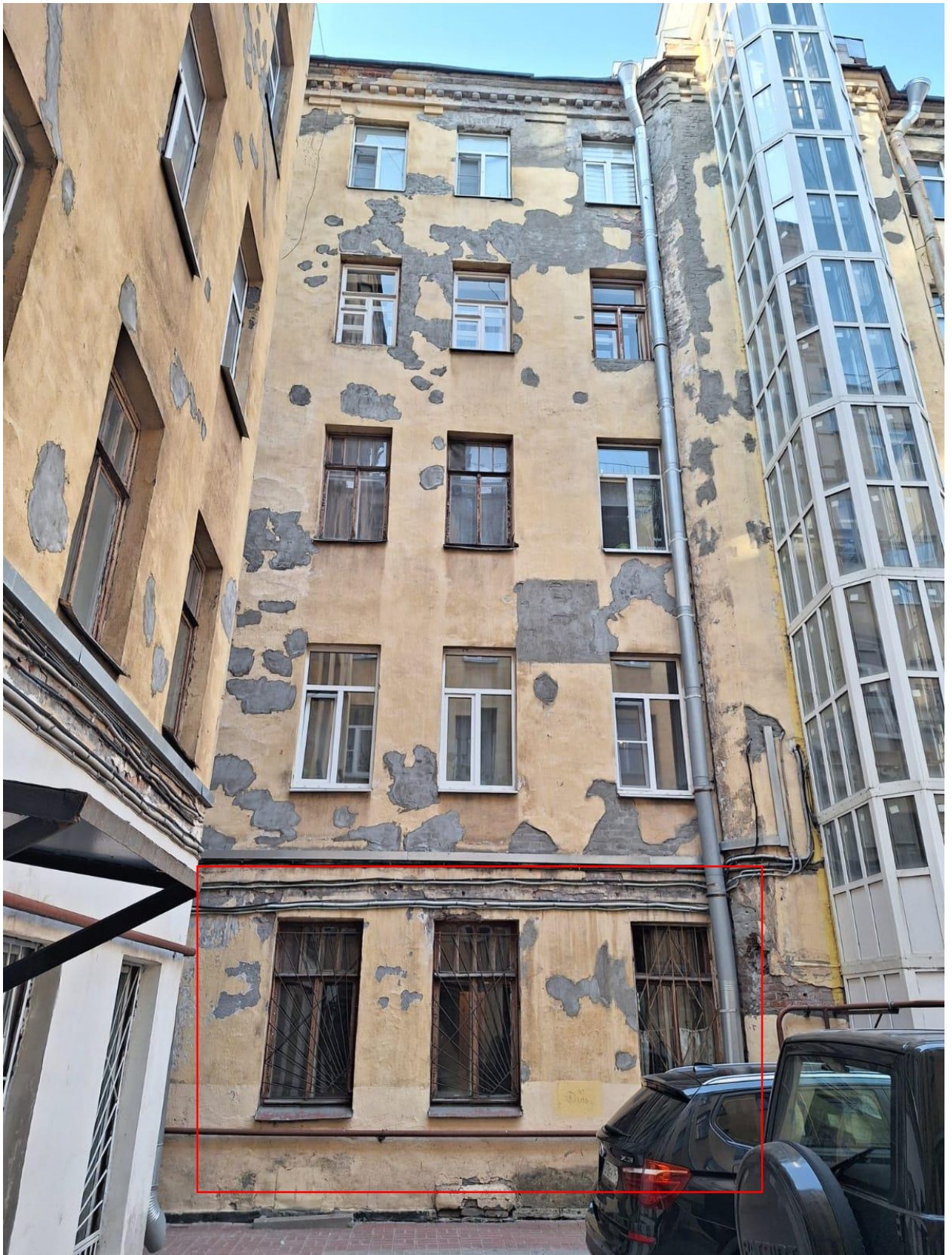
Фото 7. Фрагмент дворового фасада. Лицевой корпус. Вид на окна кв. №102.
