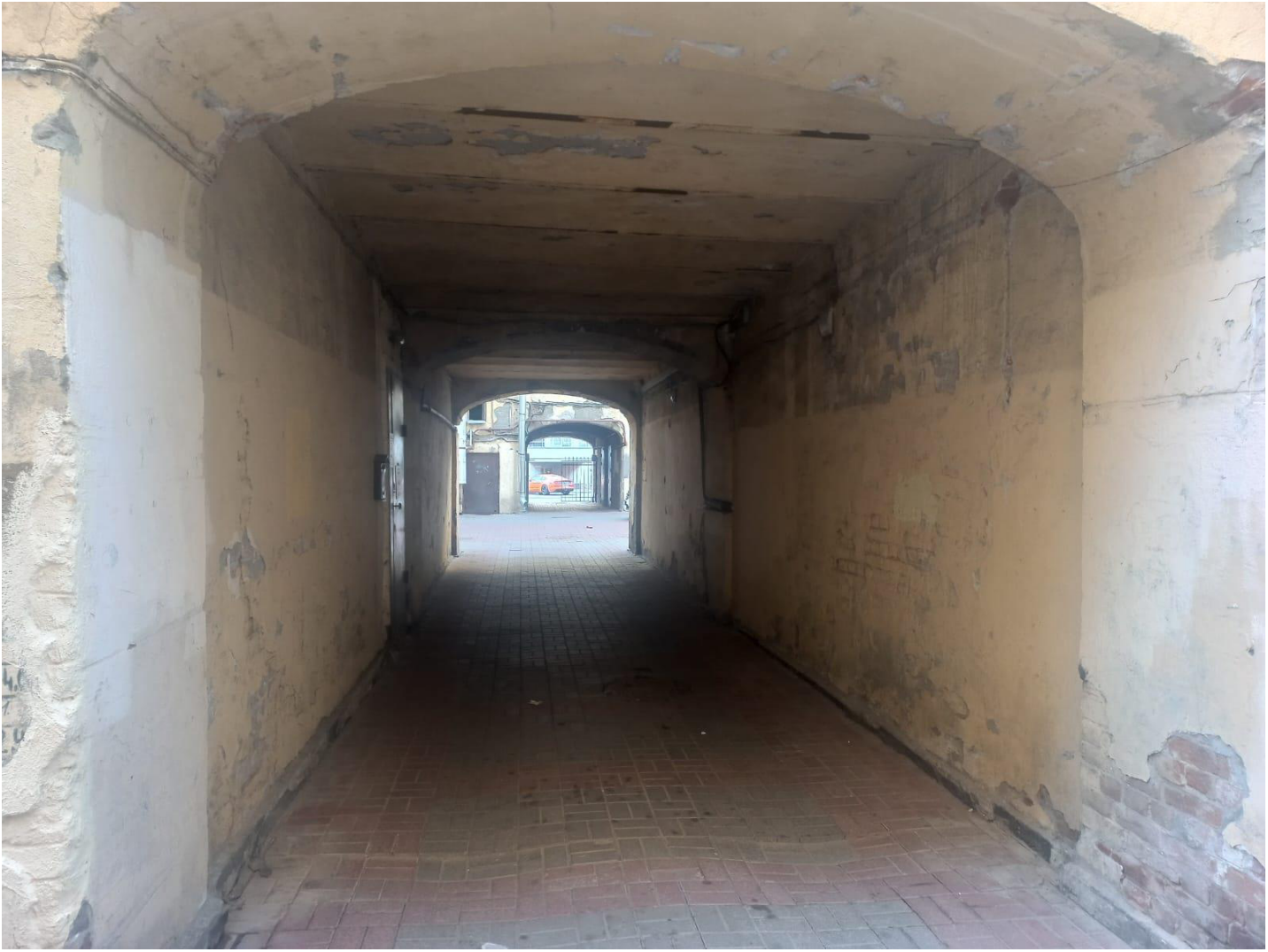
Фото 11. Проездная арка дворового корпуса. Вид в сторону внутреннего двора.
