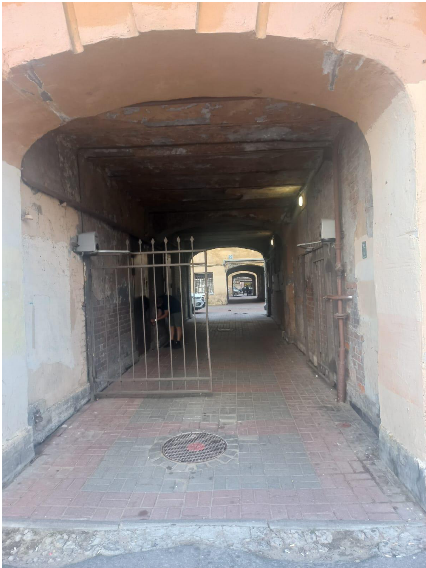
Фото 2. Проездная арка со стороны Петрозаводской улицы.
