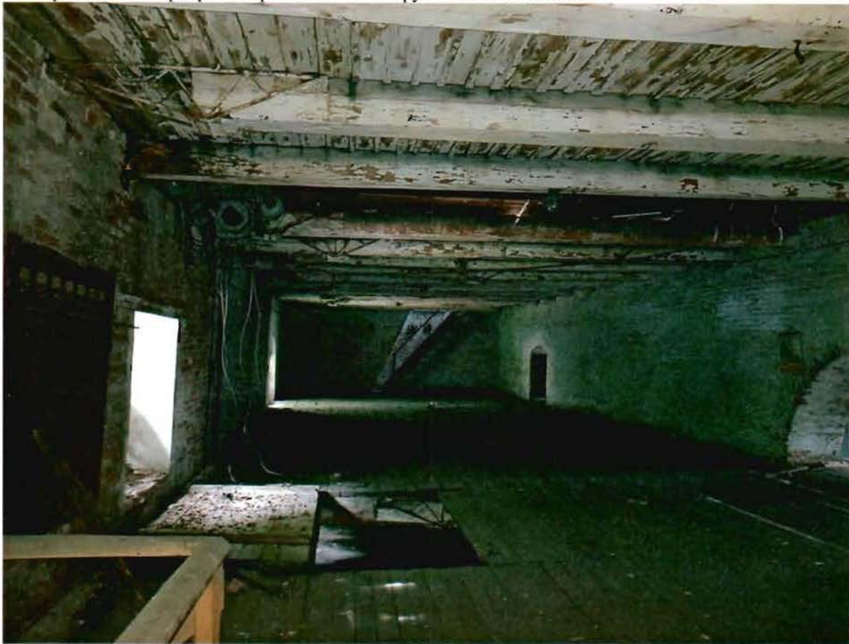
8. Стропильная система.
