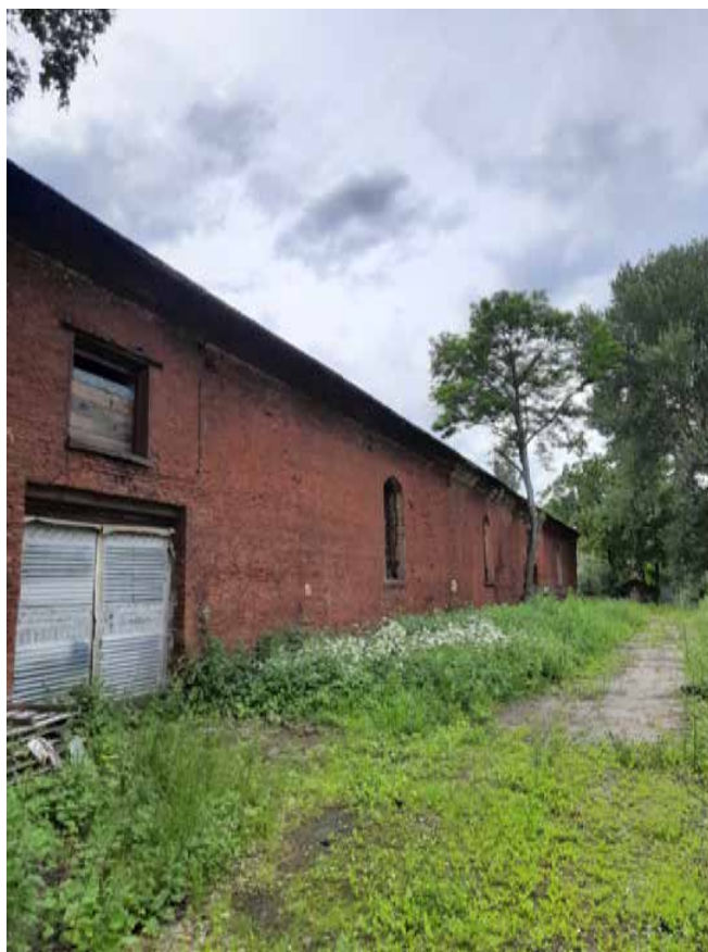
Фото 7 Фасад объекта культурного наследия федерального значения «Сарай (магазин) пенькового канатного завода»
