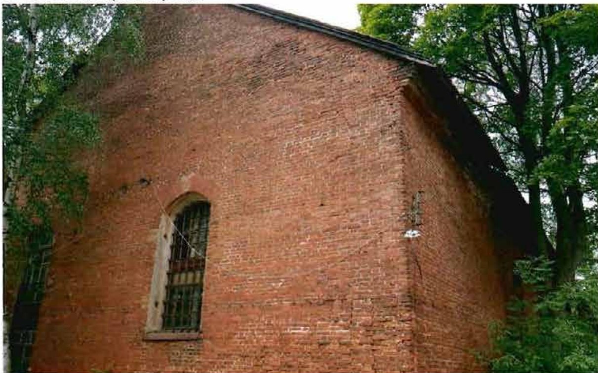
1. Восточный торцевой фасад.
