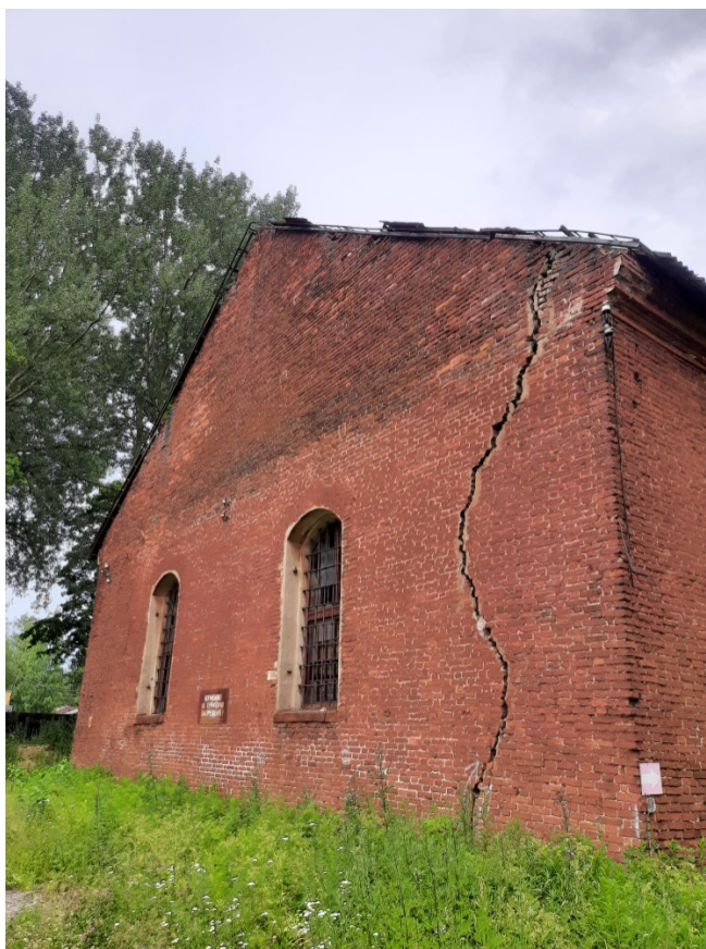
Фото 1 Фасад объекта культурного наследия федерального значения «Сарай (магазин) пенькового канатного завода»
