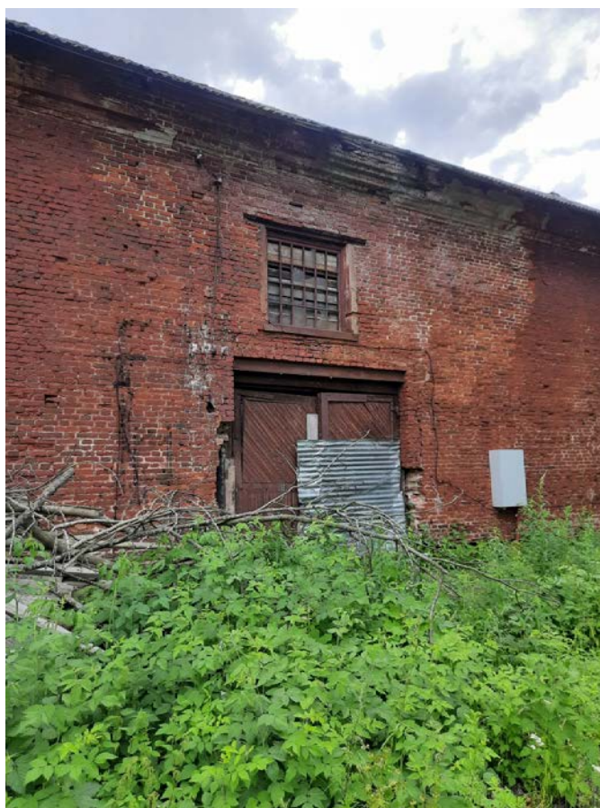
Фото 8 Фасад объекта культурного наследия федерального значения «Сарай (магазин) пенькового канатного завода»
