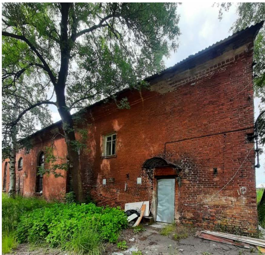
Фото 3 Фасад объекта культурного наследия федерального значения «Сарай (магазин) пенькового канатного завода»
