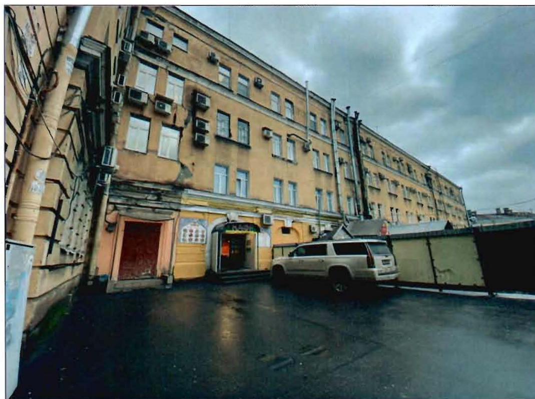
3. Южный дворовой фасад части объекта культурного наследия.
