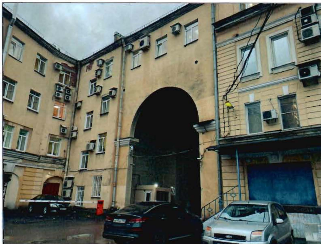
7. Восточный дворовой фасад части объекта культурного наследия.
