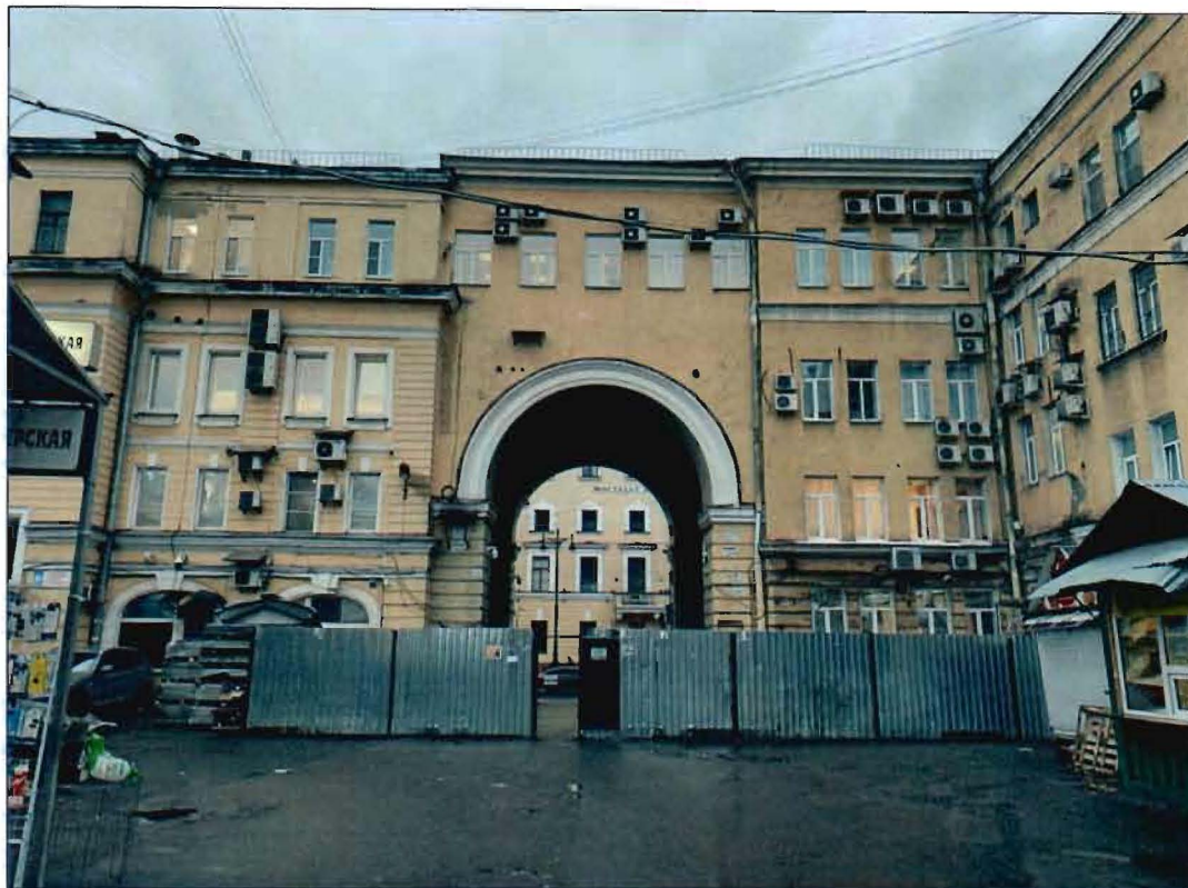
2. Восточный дворовой фасад части объекта культурного наследия.
