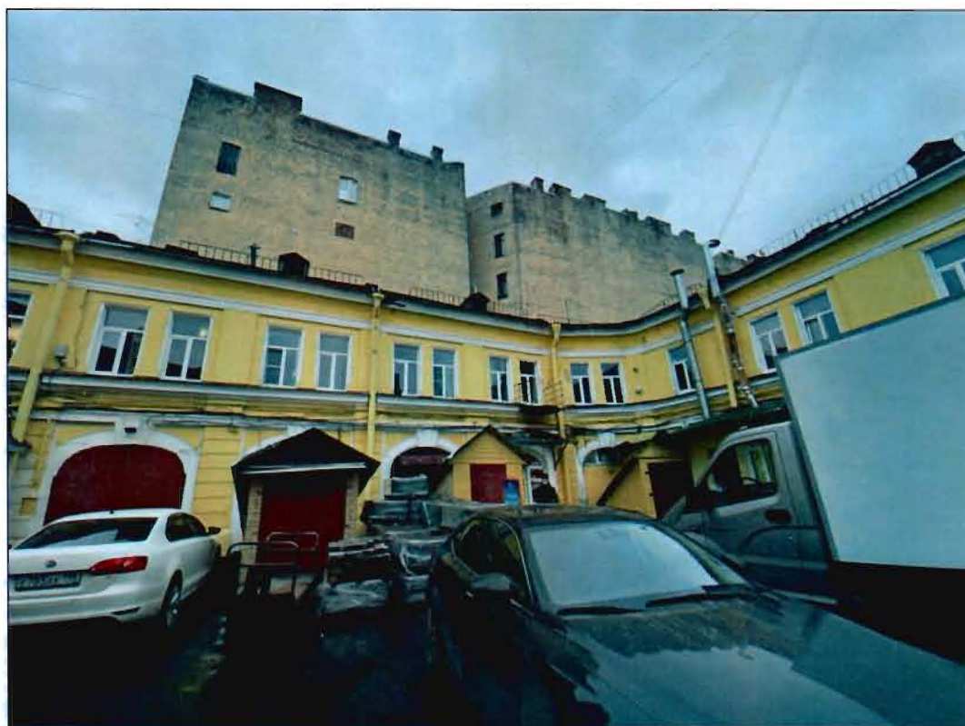
9. Фрагмент юго-восточного фасада части объекта культурного наследия.
