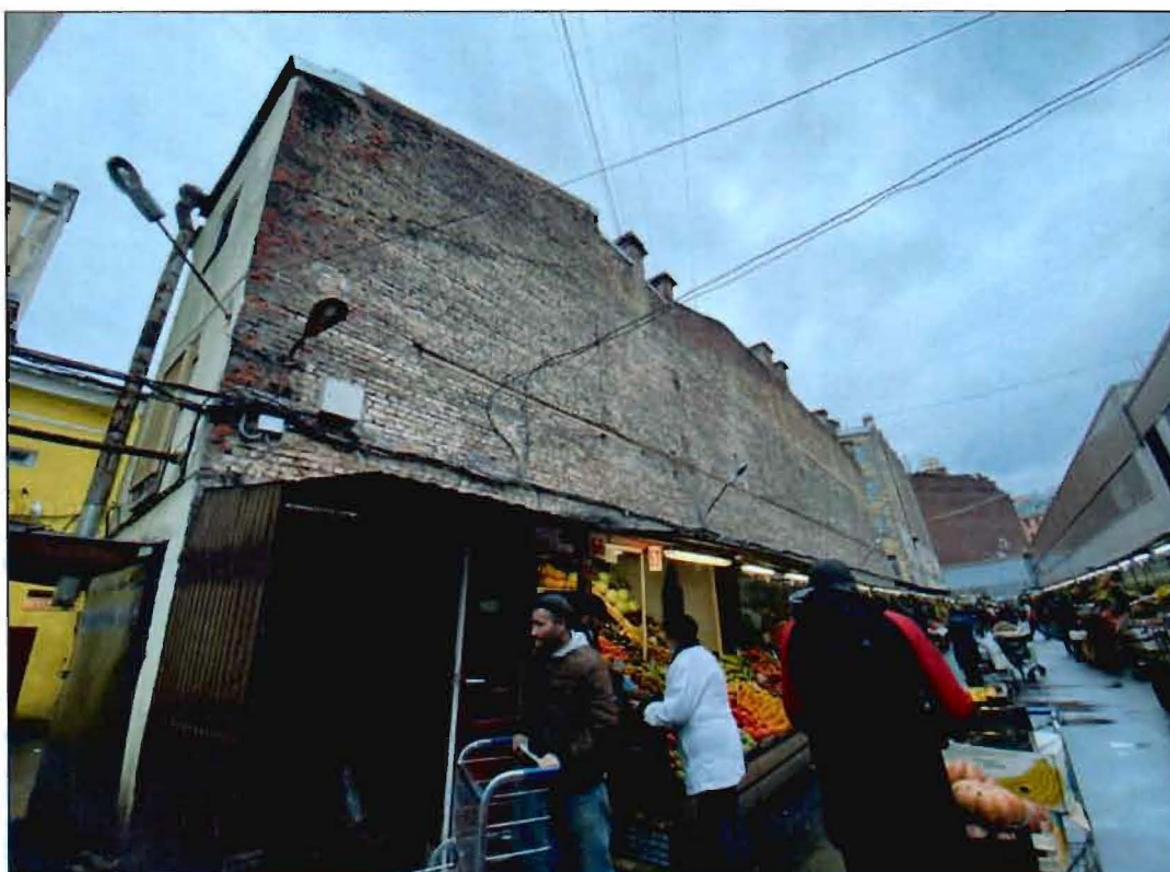
15. Северо-восточный фасад части объекта культурного наследия.
