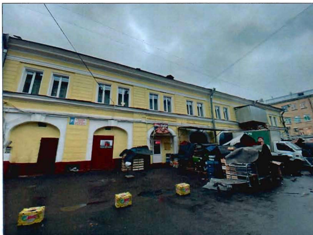
11. Фрагмент восточного фасада части объекта культурного наследия.
