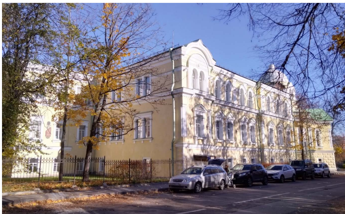
6. Вид с ул. Малой на лицевой фасад. Дата съемки: 09.10.2022
