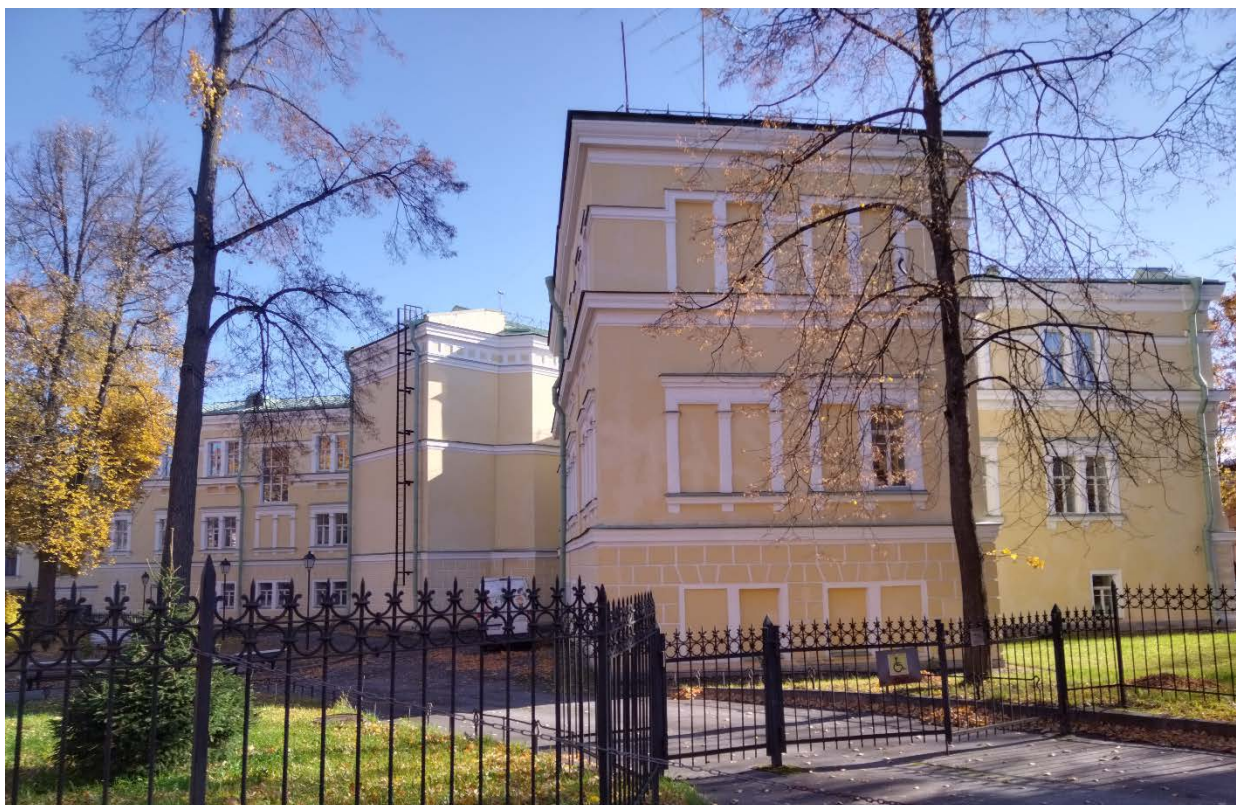
7. Вид с ул. Малой на дворовый фасад. Дата съемки: 09.10.2022
