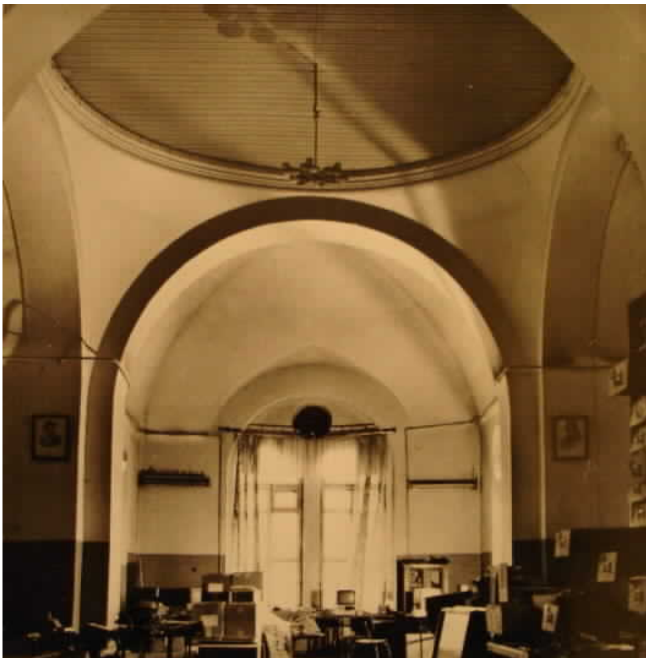
10. 1990-е гг. Интерьер Церковного зала.
