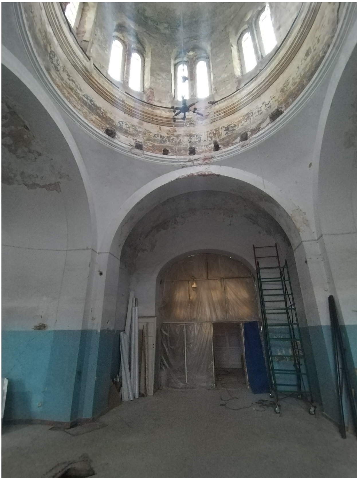
7. Церковный зал. Вид от алтаря в сторону притвора. Поздняя перегородка. Дата съемки: 03.10.2022
