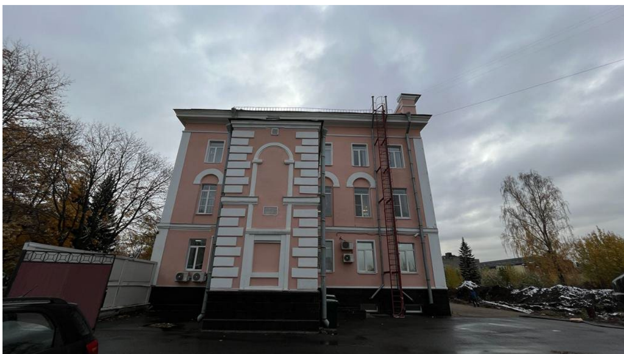
5. Вид на северо-западный торцевой фасад выявленного объекта культурного наследия «Комплекс построек «Невского железодельного, механического и корабельного завода» («Невского железопрокатного завода» П.Ф. Семянникова и В.А. Полетики). Заводоуправление», расположенного по адресу: г. Санкт-Петербург, пр. Обуховской Обороны, д. 51, литеры АФ. 18.10.2023
