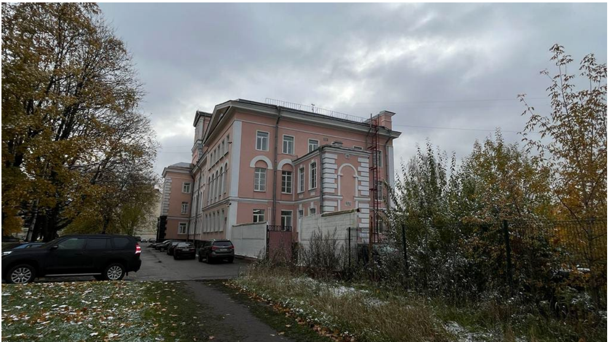
4. Вид на северо-западный торцевой фасад выявленного объекта культурного наследия «Комплекс построек «Невского железодельного, механического и корабельного завода» («Невского железопрокатного завода» П.Ф. Семянникова и В.А. Полетики). Заводоуправление», расположенного по адресу: г. Санкт-Петербург, пр. Обуховской Обороны, д. 51, литеры АФ. 18.10.2023
