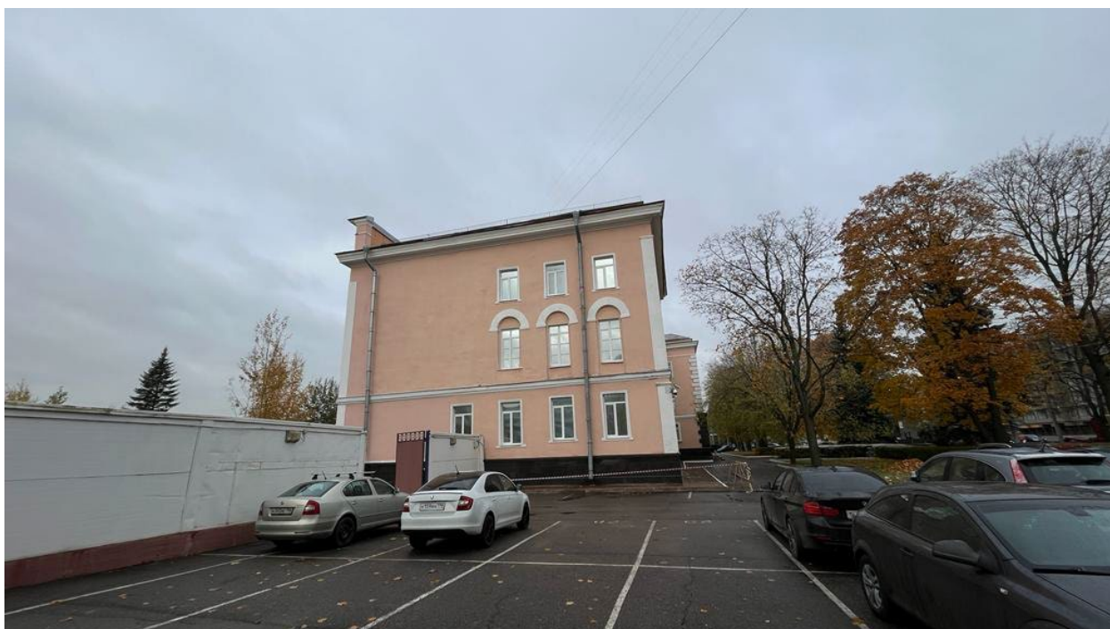
7. Вид на юго-восточный торцевой фасад выявленного объекта культурного наследия «Комплекс построек «Невского железоделательного, механического и корабельного завода» («Невского железопрокатного завода» П.Ф. Семяникова и В.А. Полетики). Заводоуправление», расположенного по адресу: г. Санкт-Петербург, пр. Обуховской Обороны, д. 51, литеры АФ. 18.10.2023
