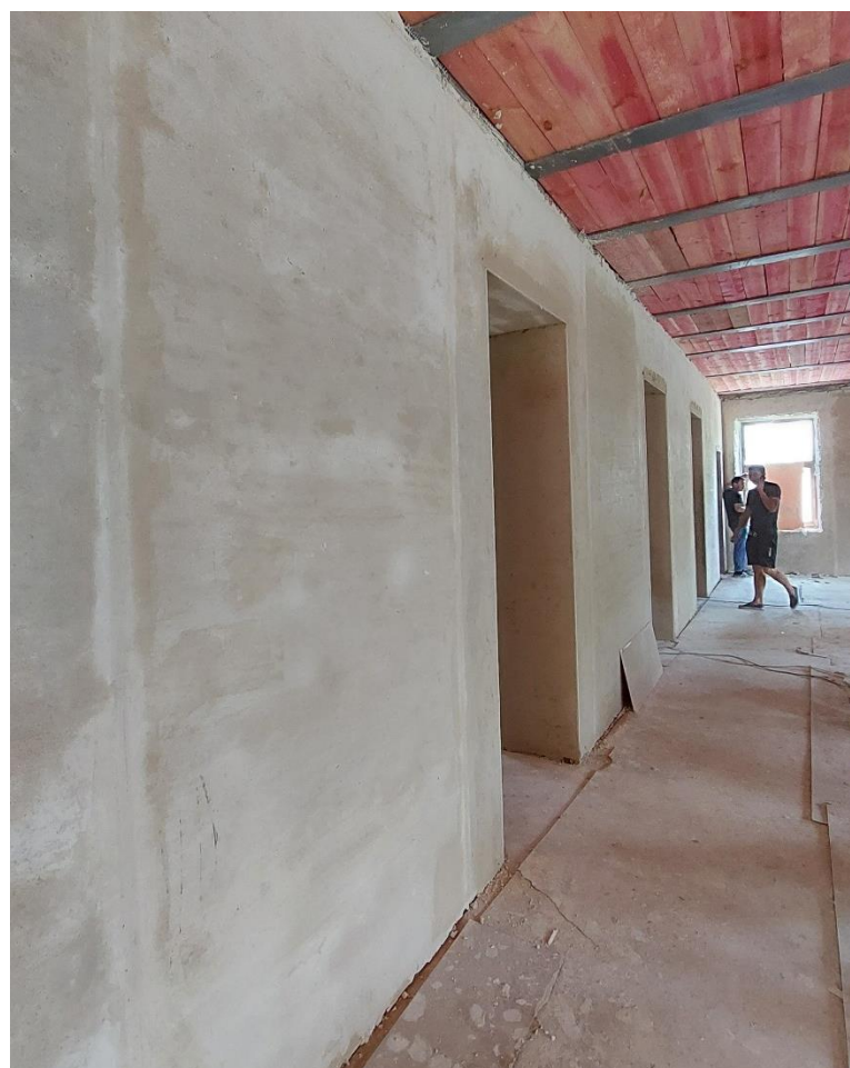
Фото 9. 2 этаж. Вид в сторону стены напротив ризалита.
