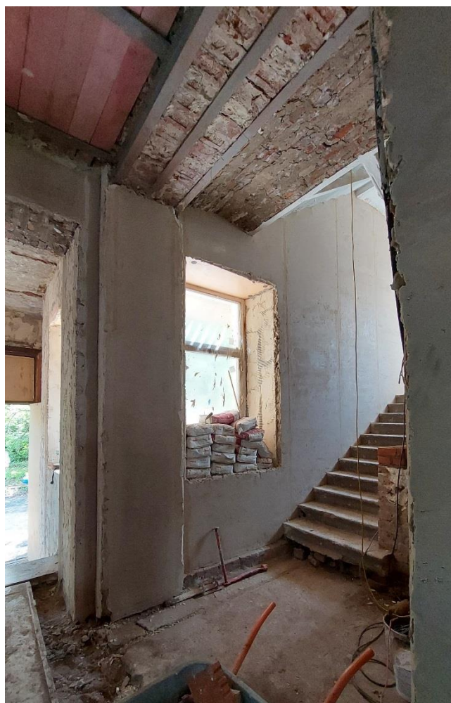
Фото 6. 1 этаж. Холл. Вид на лестницу.
