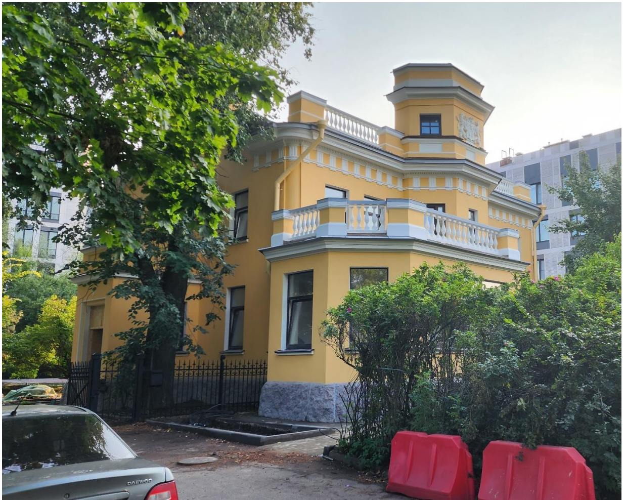
Фото 1. Северный (главный) и восточный фасады.
