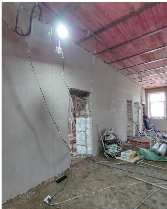
Фото 5. 1 этаж. Вид в сторону стены напротив ризалита.
