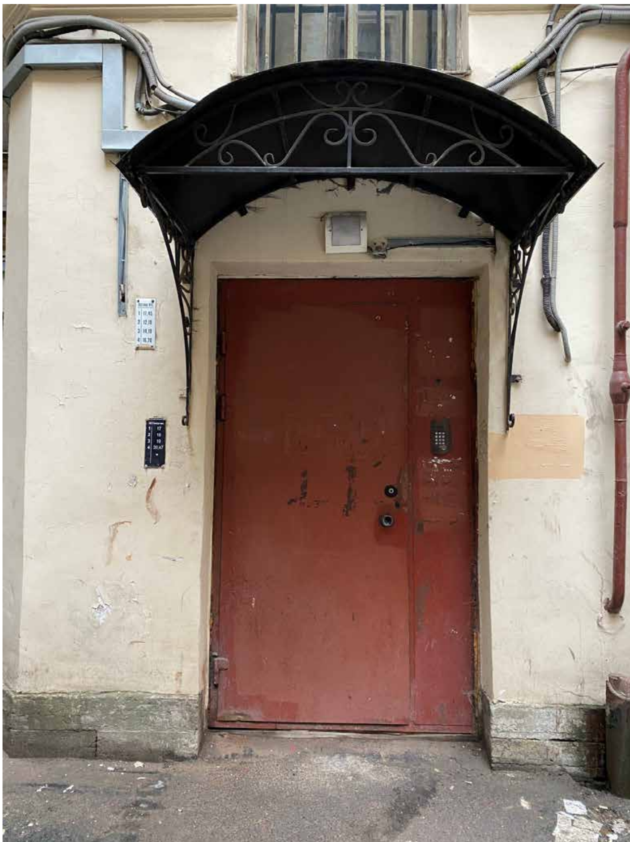
Фото 12. Вид на вход в парадную, ведущую к квартире № 19, объекта культурного наследия.
