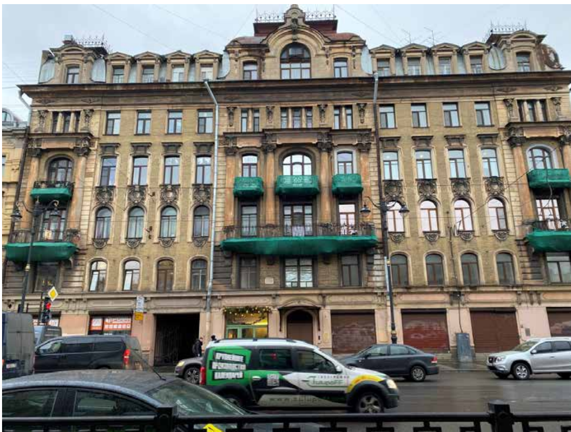
Фото 3. Общий вид лицевого фасада объекта культурного наследия с улицы Марата.
