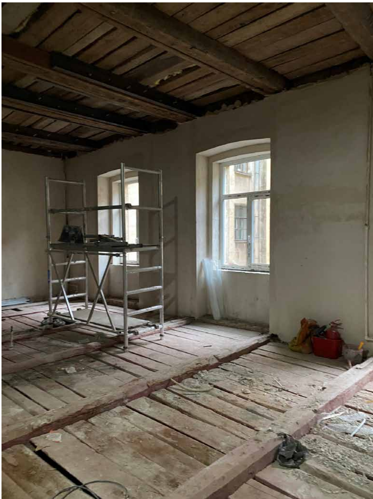
Фото 17. Вид на помещение квартиры № 19 объекта культурного наследия.
