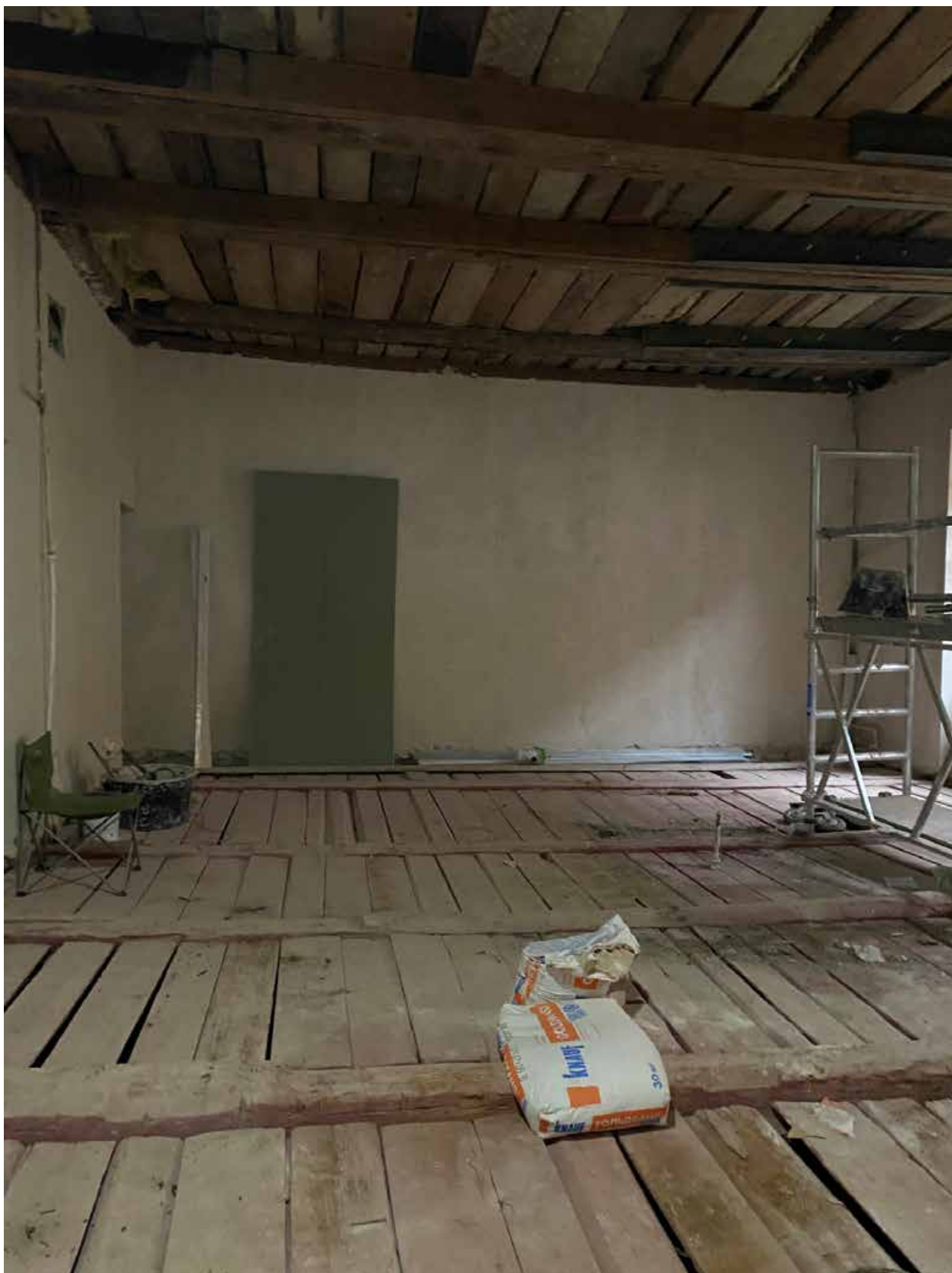
Фото 18. Вид на помещение квартиры № 19 объекта культурного наследия.
