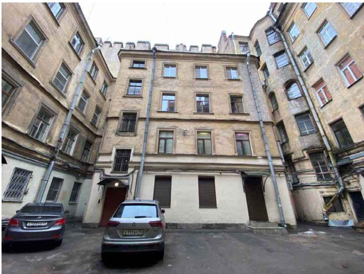
Фото 11. Вид на часть дворовых фасадов объекта культурного наследия.
