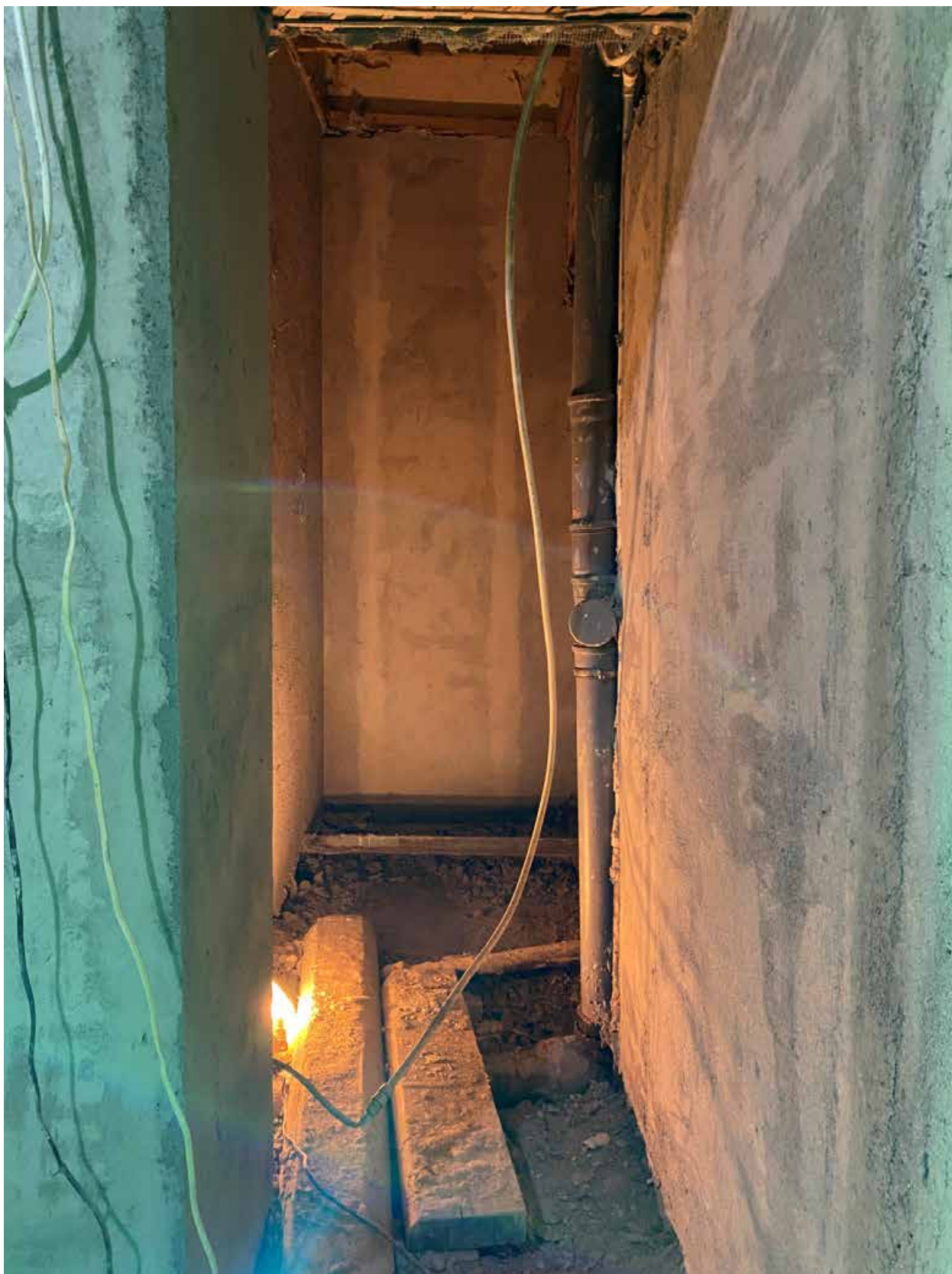
Фото 24. Вид на помещение квартиры № 19 объекта культурного наследия.
