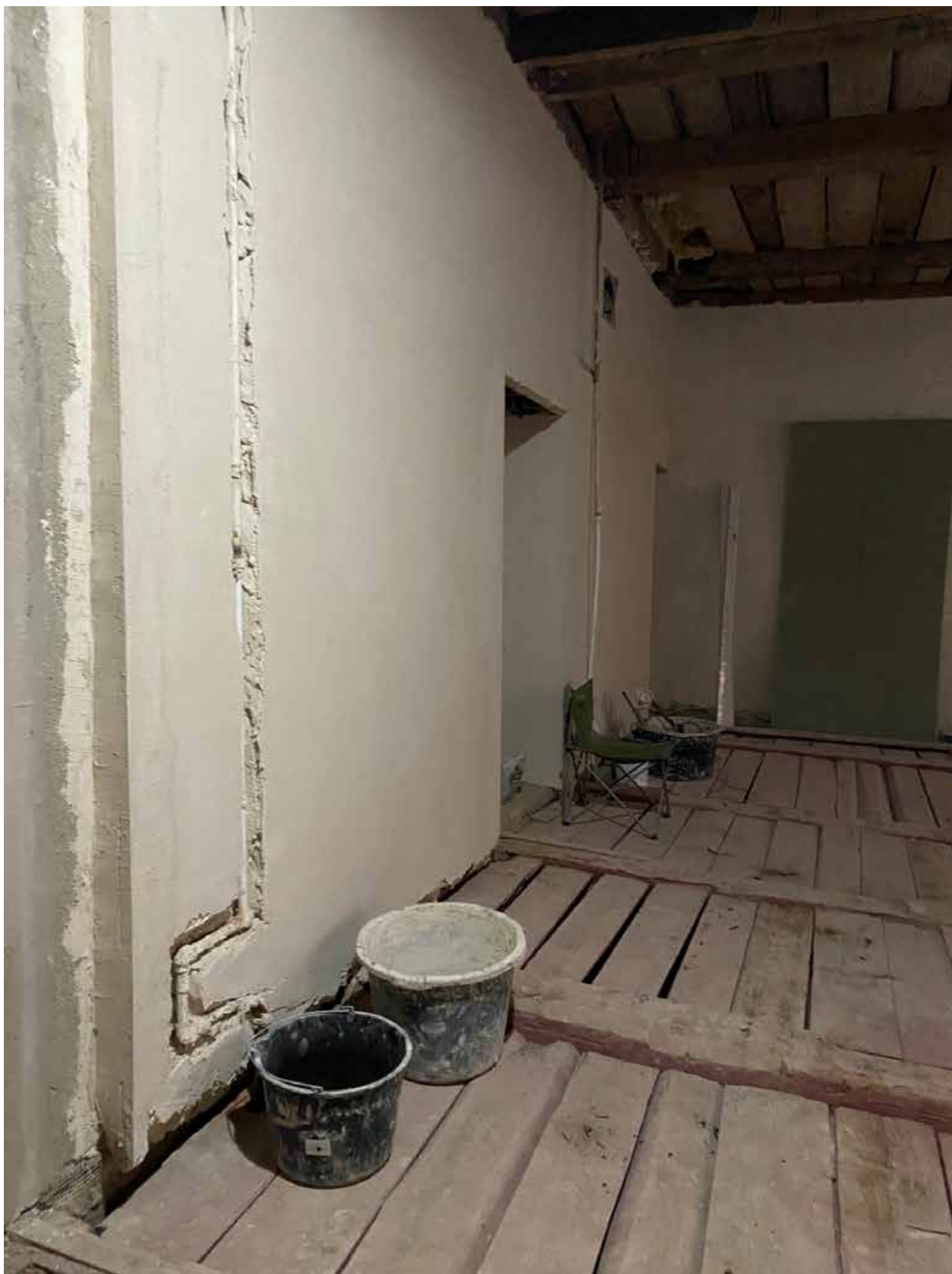
Фото 19. Вид на помещение квартиры № 19 объекта культурного наследия.
