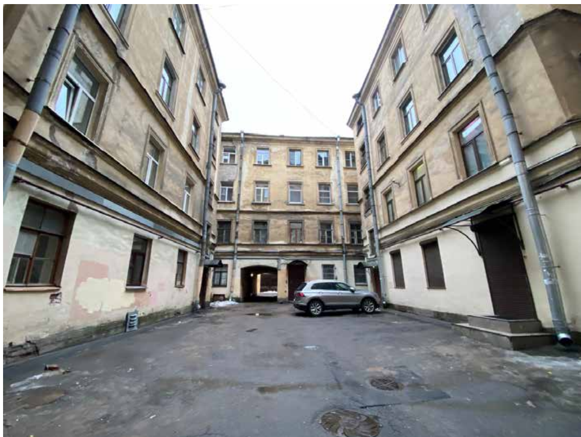
Фото 9. Вид на часть дворовых фасадов объекта культурного наследия.
