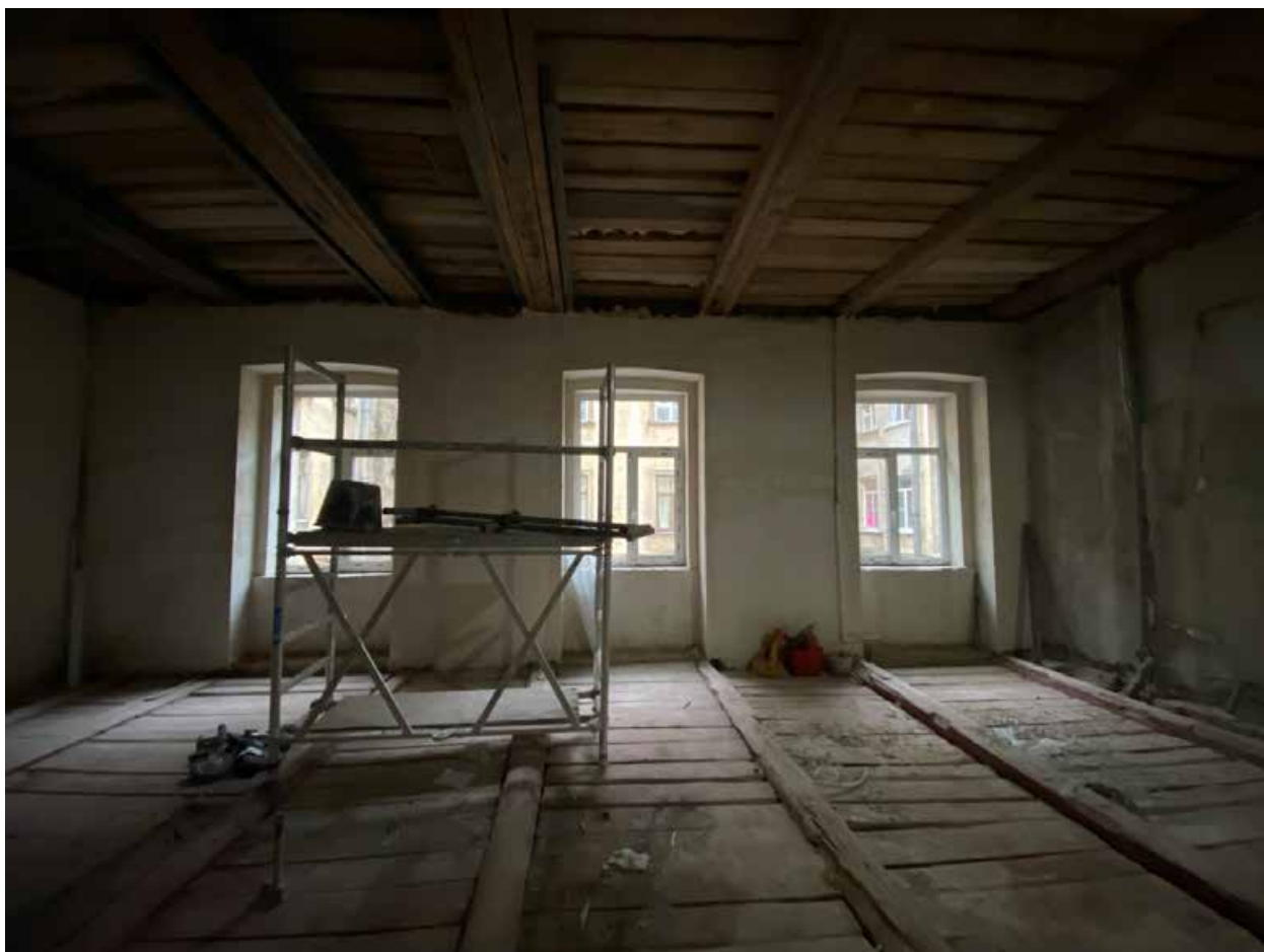
Фото 21. Вид на помещение квартиры № 19 объекта культурного наследия.
