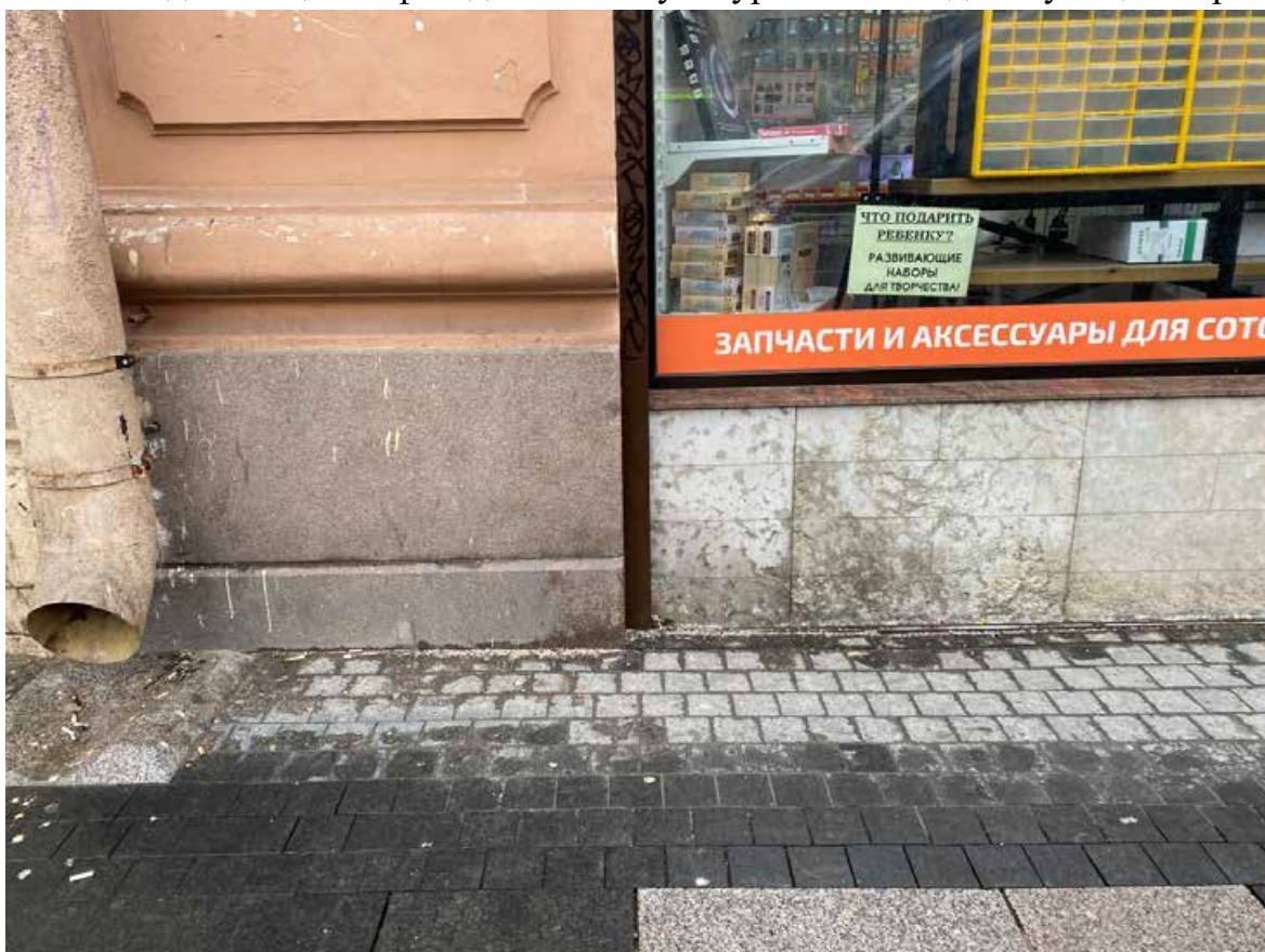
Фото 6. Вид на часть отмостки и цоколя лицевого фасада объекта культурного наследия.
