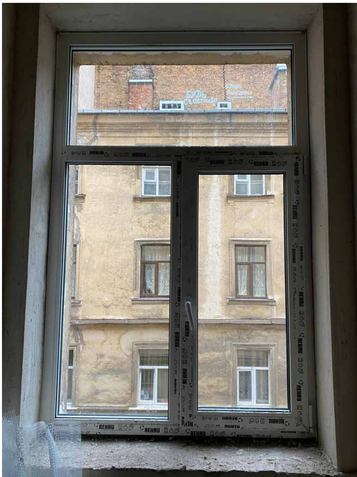
Фото 22. Вид на оконное заполнение квартиры № 19 объекта культурного наследия.
