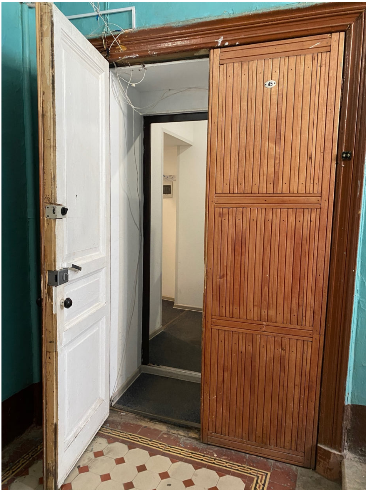
Фото 33. Вид на дверное заполнение квартиры № 45 объекта культурного наследия.
