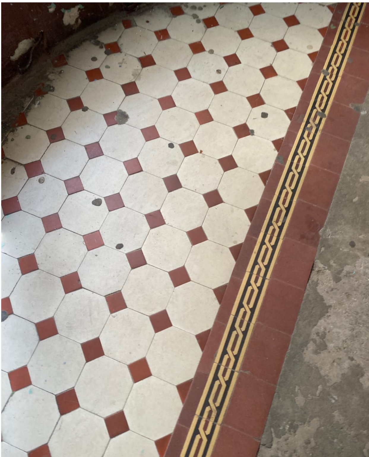
Фото 30. Покрытие площадки лестницы, ведущей в квартиру № 45, объекта культурного наследия.
