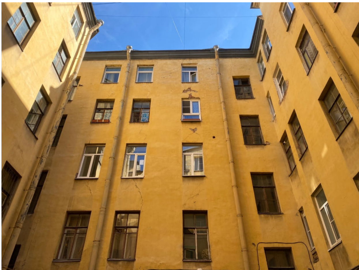
Фото 5. Фрагмент дворового фасада объекта культурного наследия.
