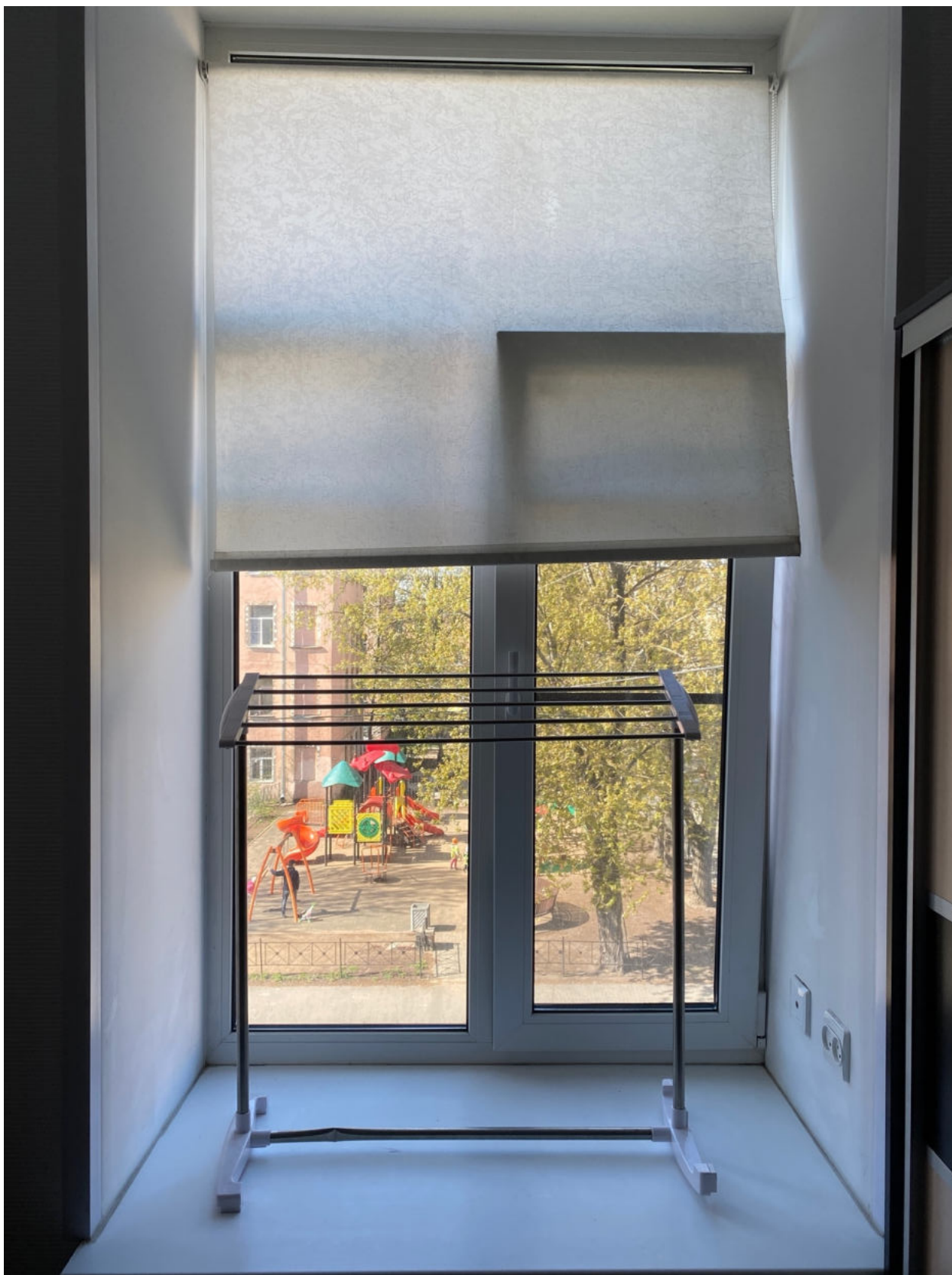
Фото 38. Вид на оконное заполнение помещения квартиры № 45 объекта культурного наследия.
