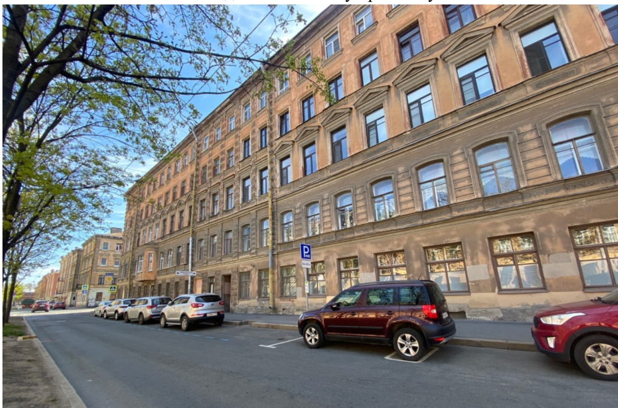
Фото 2. Фрагмент лицевого фасада объекта культурного наследия по Малодетскосельскому проспекту.
