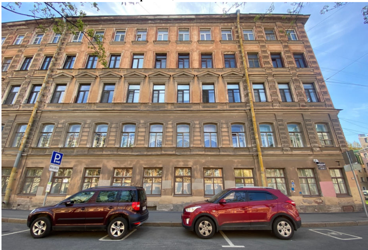
Фото 1. Фрагмент лицевого фасада объекта культурного наследия по Малодетскосельскому проспекту.
