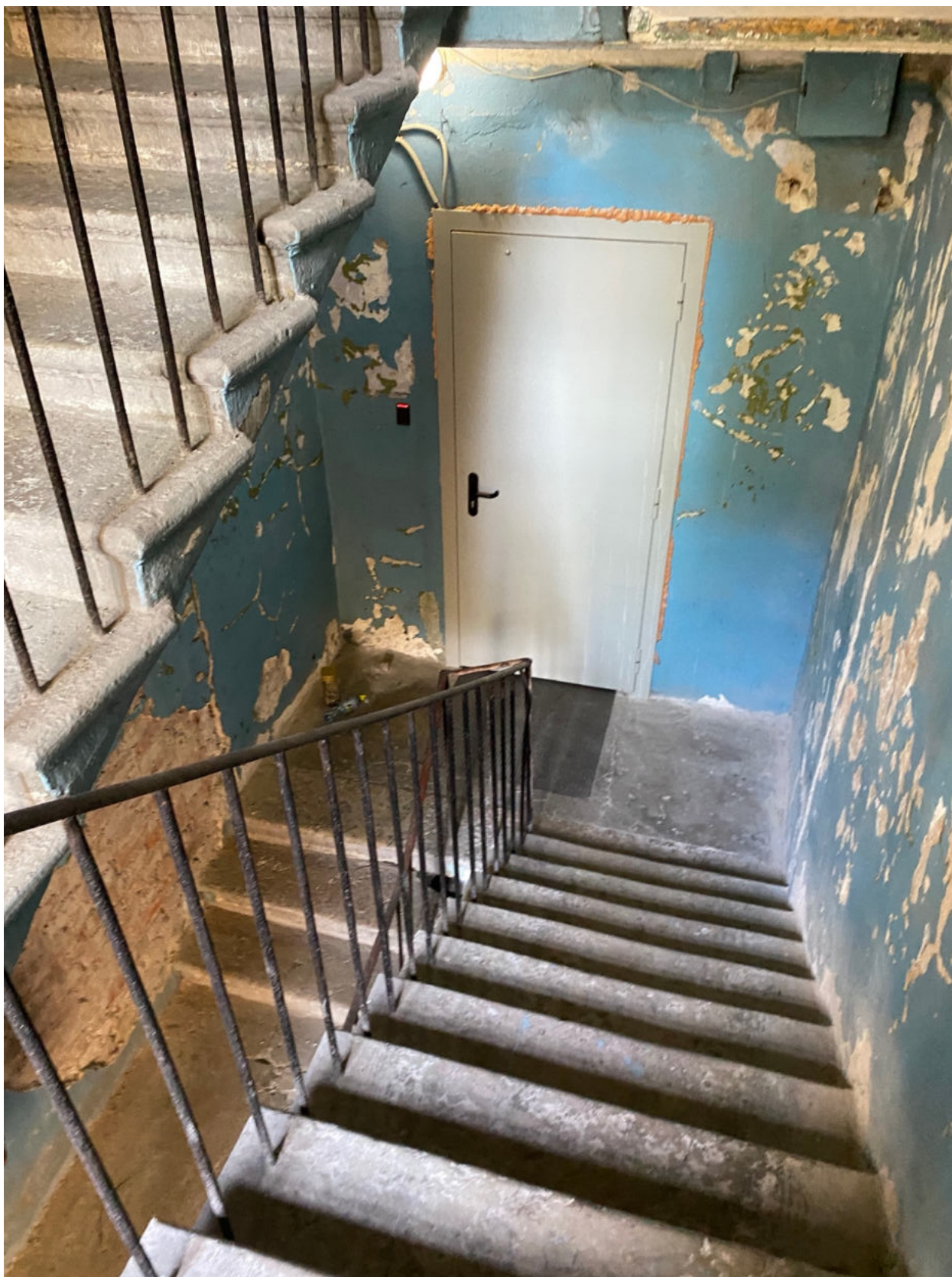
Фото 11. Лестница, ведущая в квартиру № 45, объекта культурного наследия.
