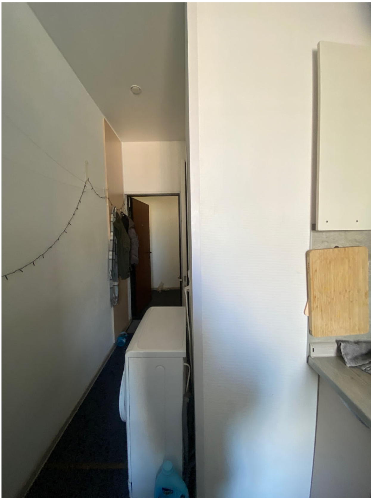
Фото 60. Вид на помещение квартиры № 45 объекта культурного наследия.
