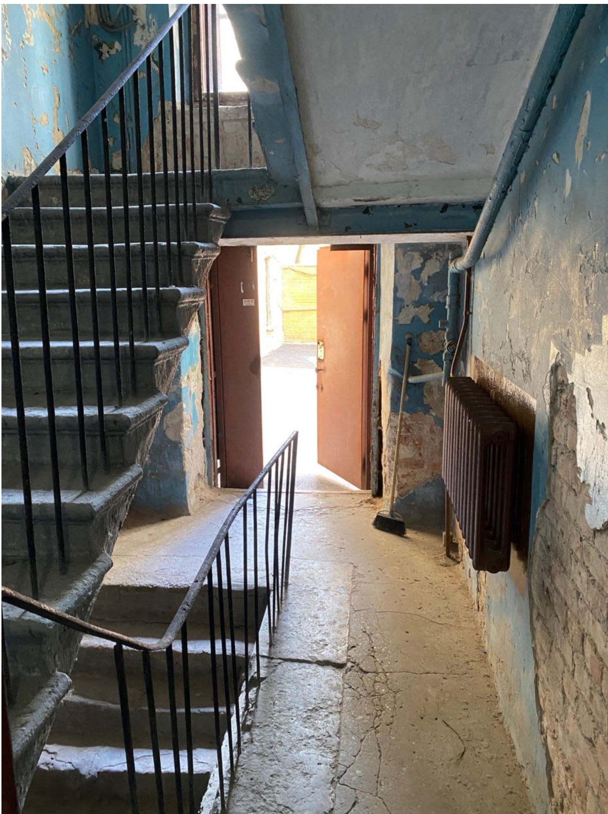
Фото 10. Лестница, ведущая в квартиру № 45, объекта культурного наследия.
