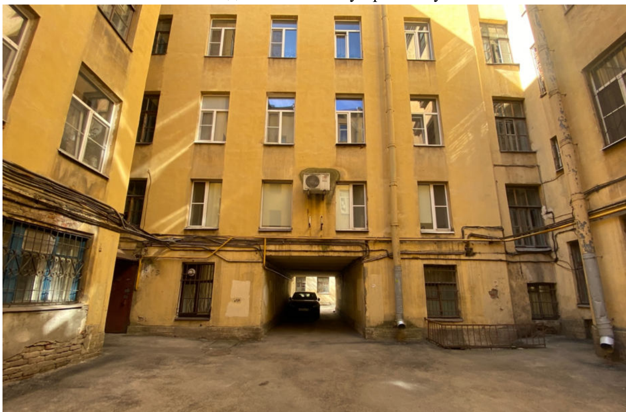
Фото 4. Фрагмент дворового фасада объекта культурного наследия.
