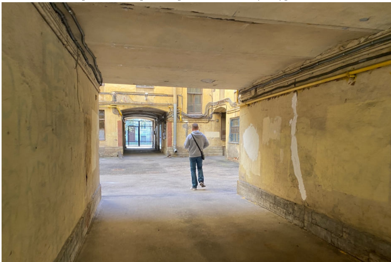
Фото 6. Вид на арку и дворовой фасад объекта культурного наследия.
