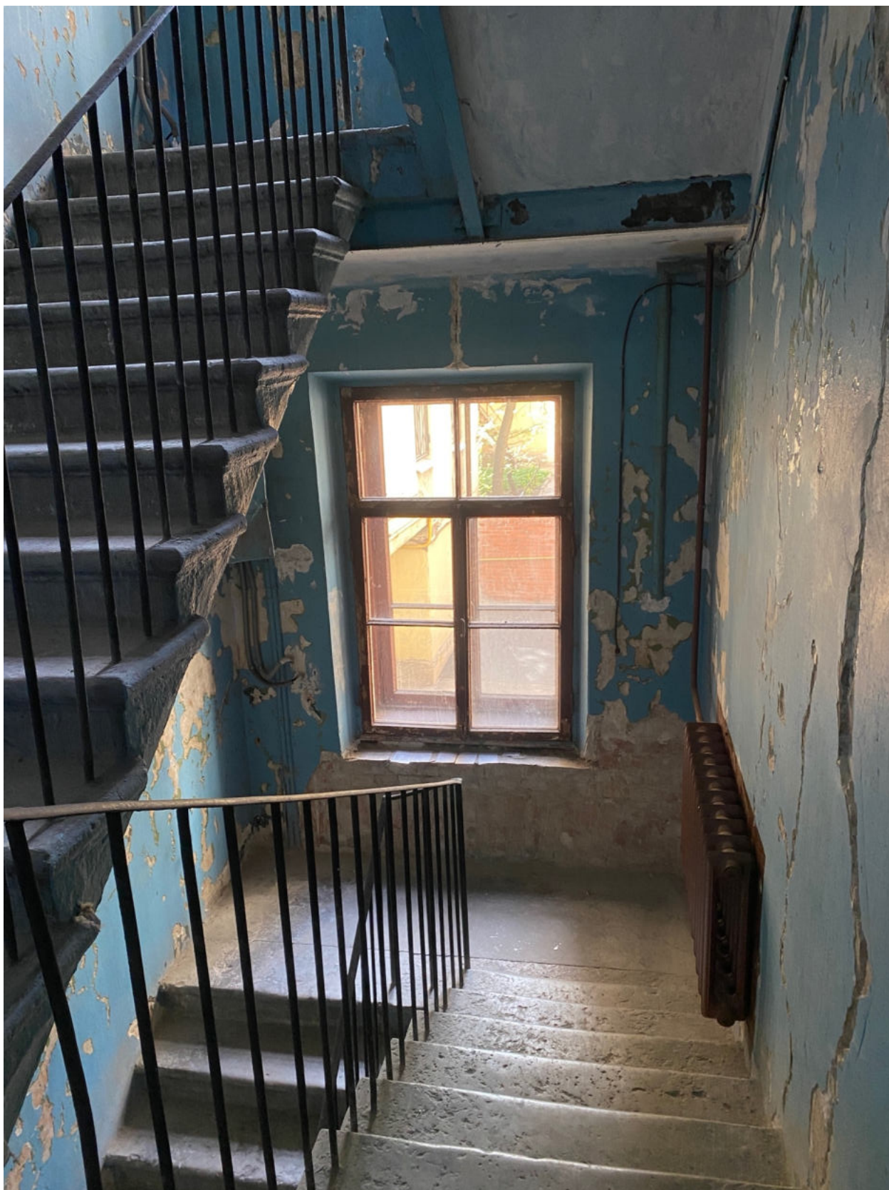
Фото 12. Лестница, ведущая в квартиру № 45, объекта культурного наследия.
