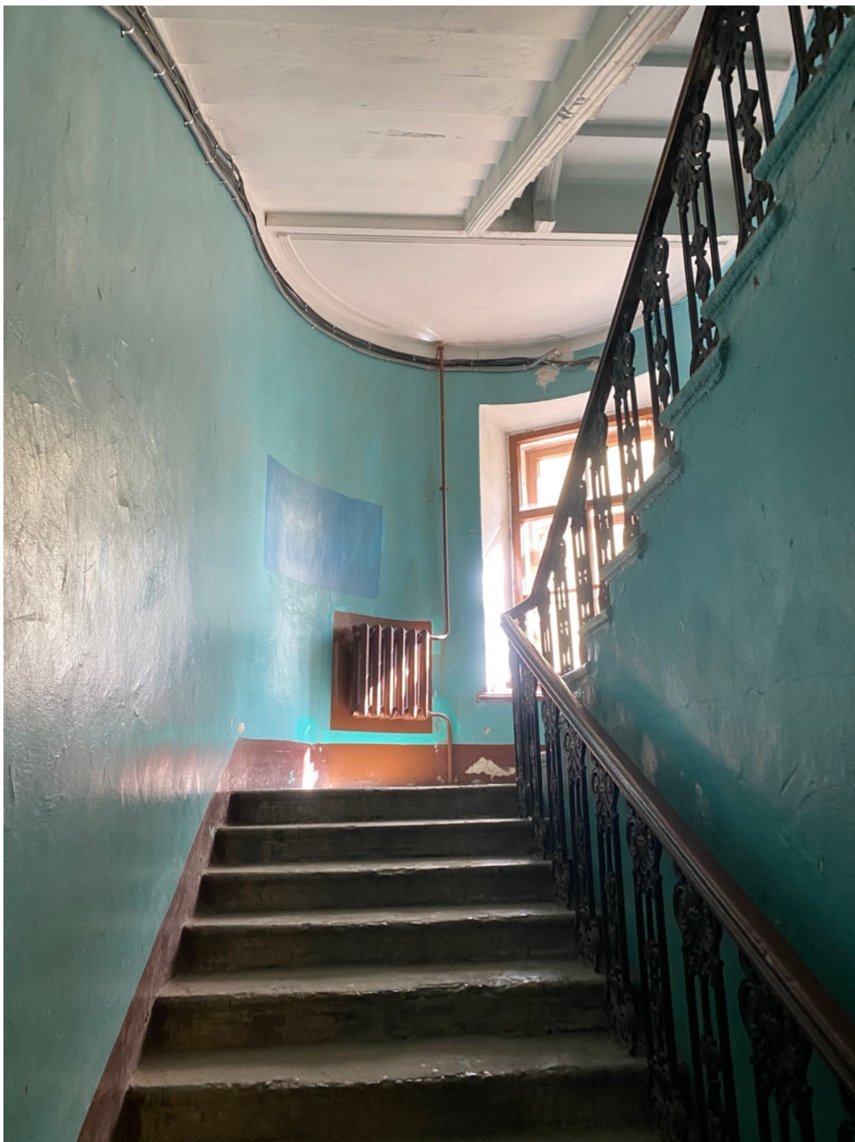
Фото 28. Лестница, ведущая в квартиру № 45, объекта культурного наследия.
