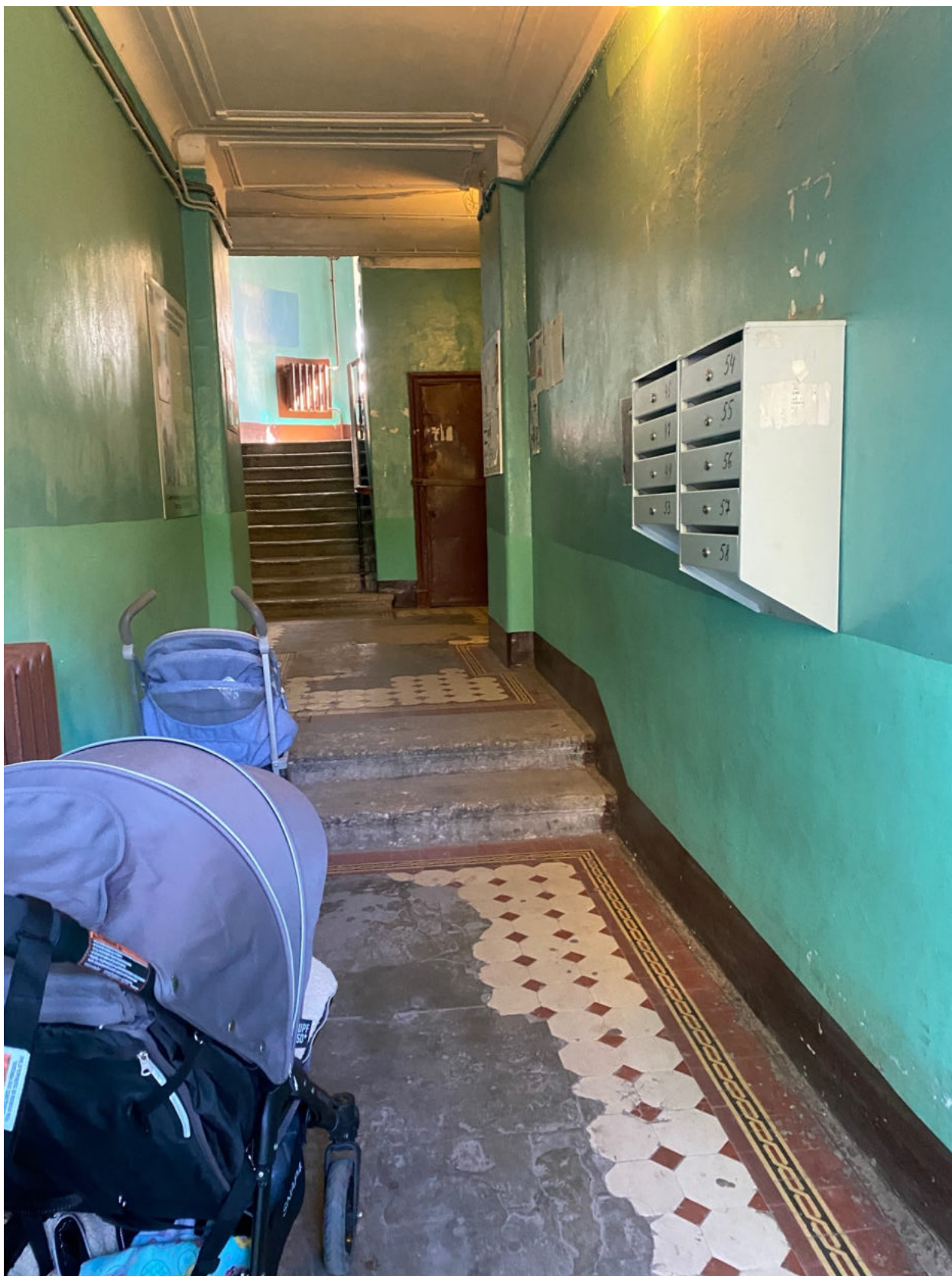
Фото 26. Вестибюль лестницы, ведущей в квартиру № 45, объекта культурного наследия.
