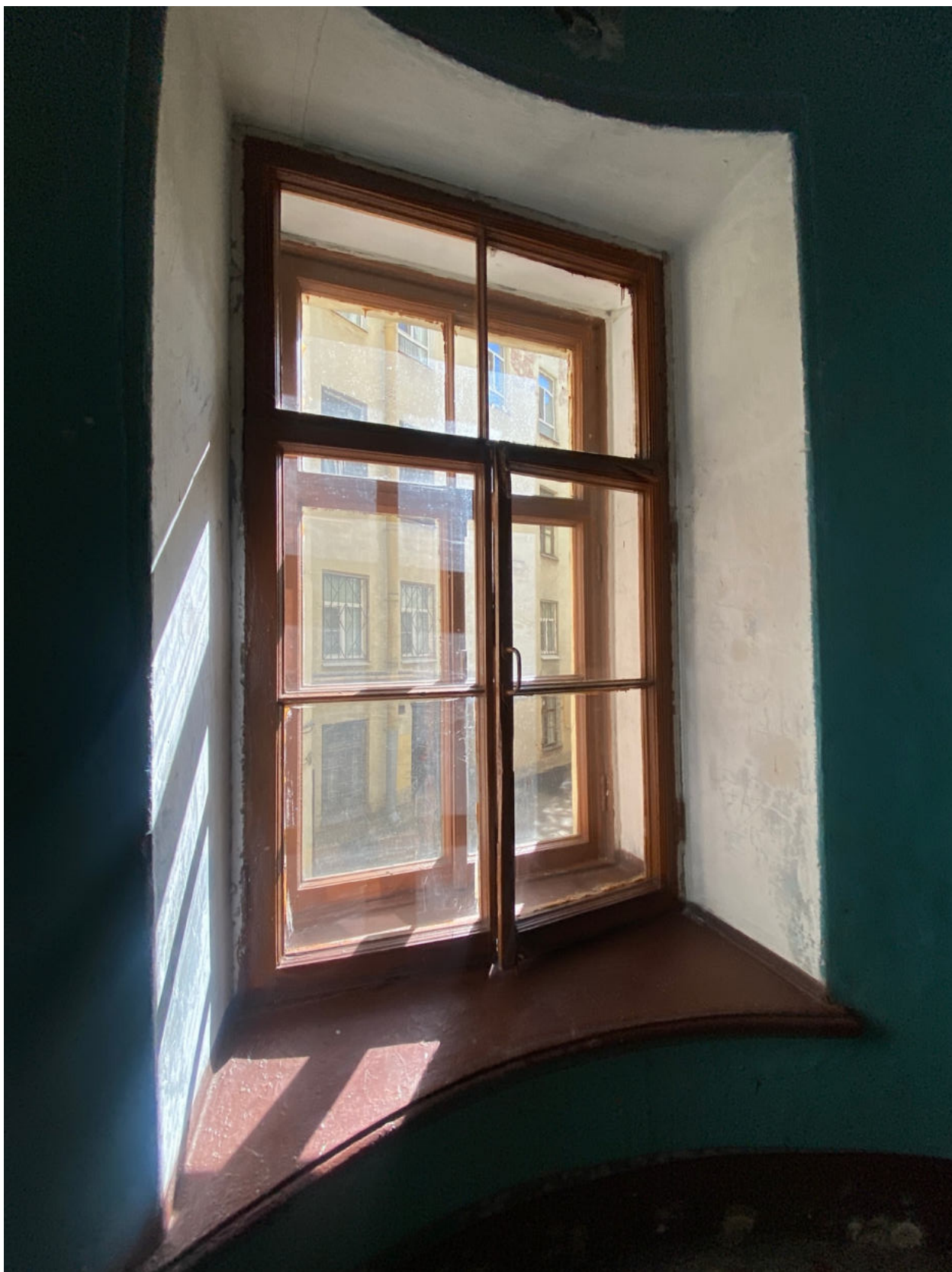
Фото 31. Вид на оконное заполнение лестницы, ведущей в квартиру № 45, объекта культурного наследия.
