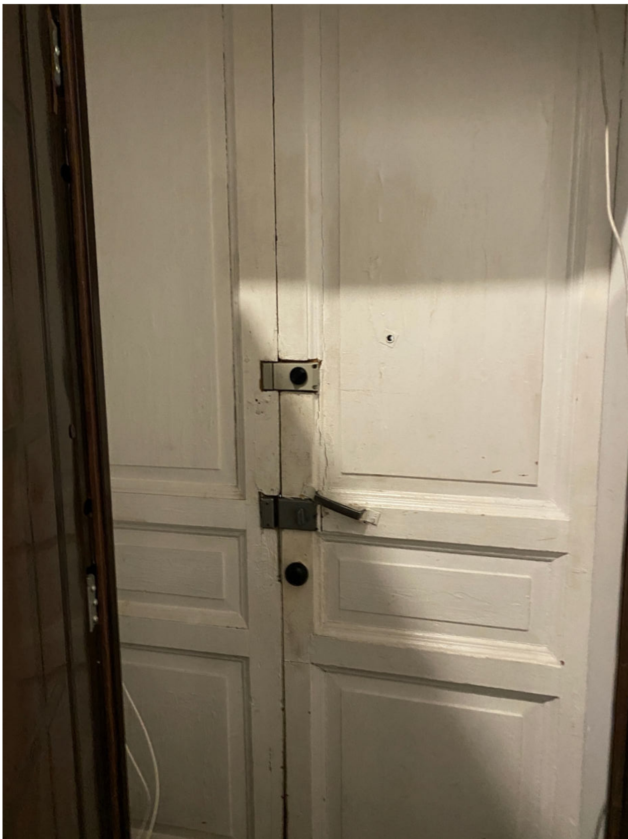
Фото 34. Вид на дверное заполнение квартиры № 45 объекта культурного наследия.
