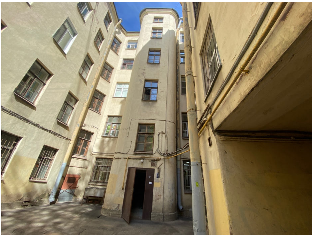
Фото 7. Фрагмент дворового фасада объекта культурного наследия.
