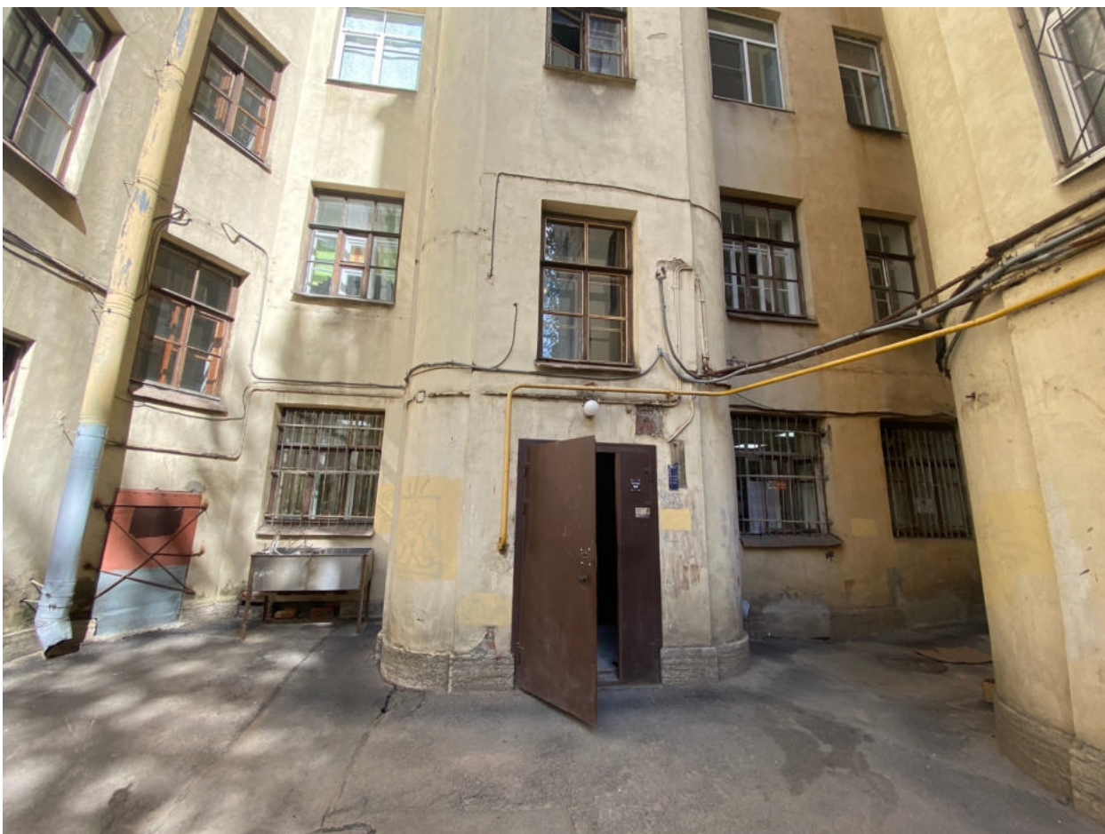
Фото 9. Фрагмент дворового фасада объекта культурного наследия.
