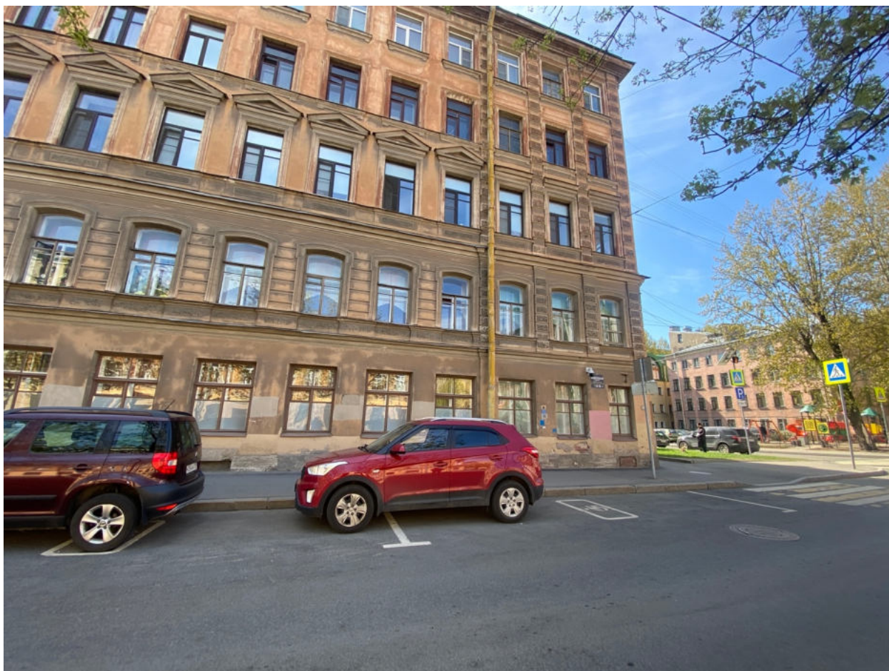
Фото 3. Фрагмент лицевого фасада объекта культурного наследия по Малодетскосельскому проспекту.
