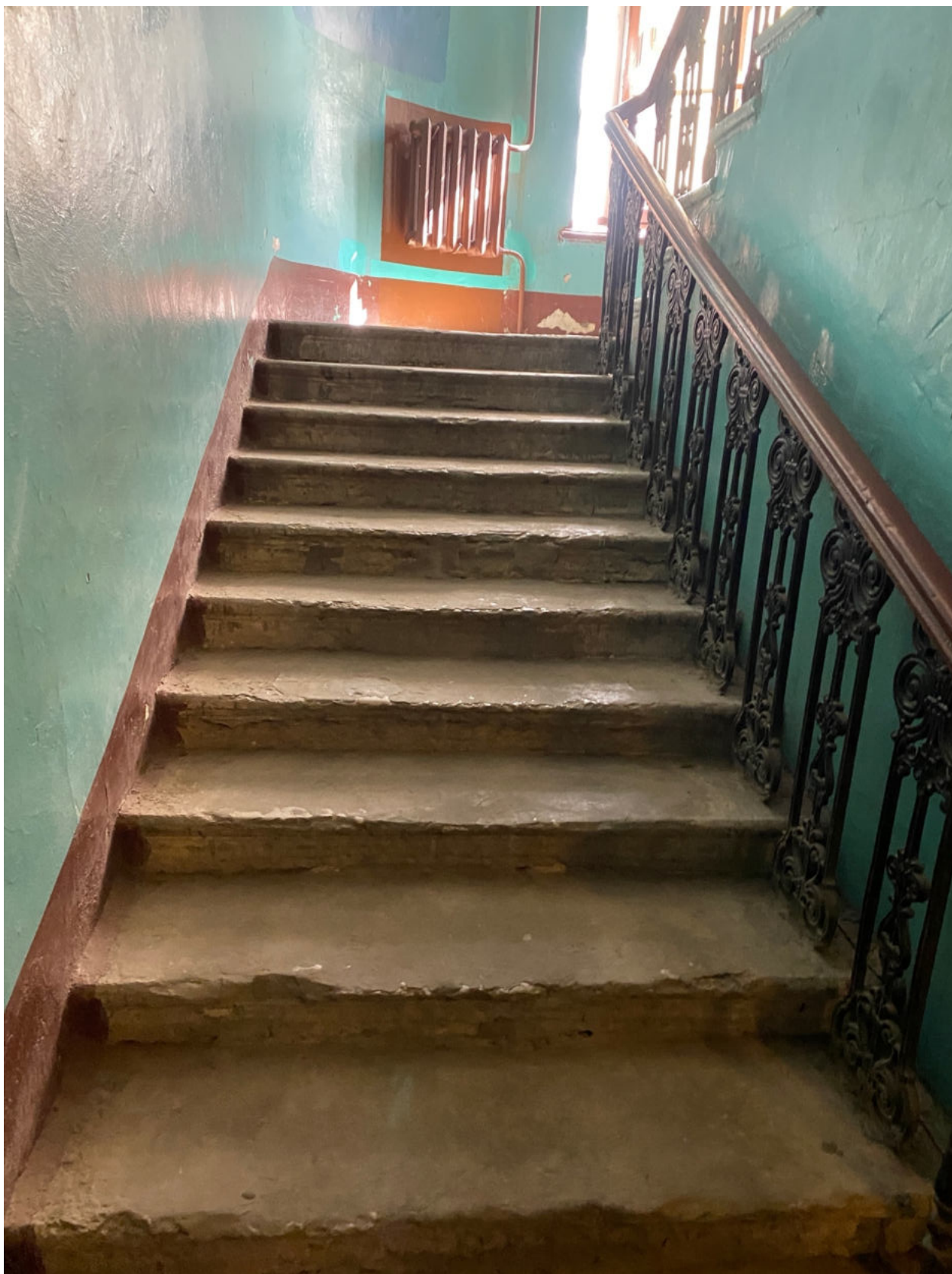
Фото 29. Лестница, ведущая в квартиру № 45, объекта культурного наследия.
