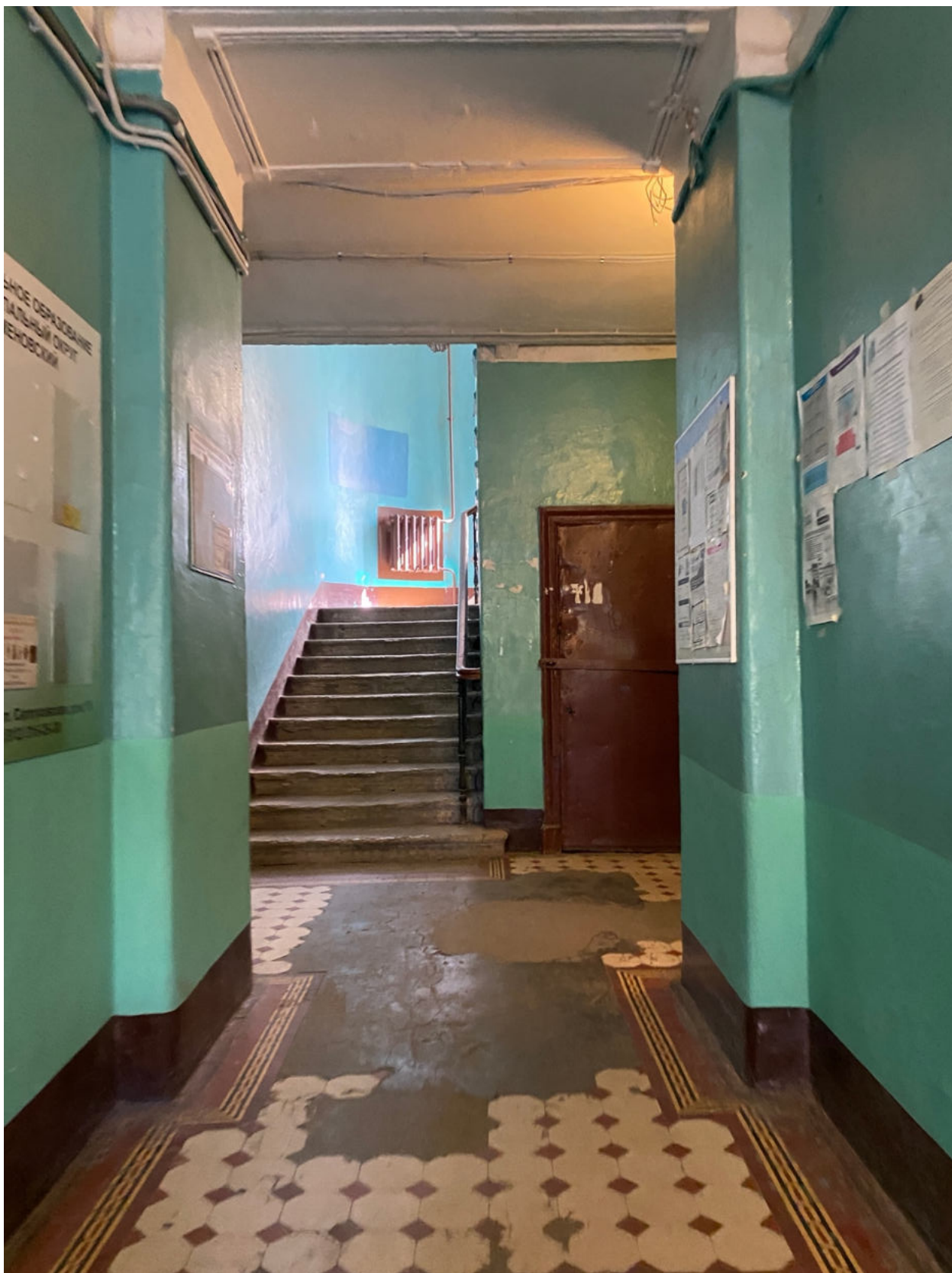
Фото 27. Вестибюль лестницы, ведущей в квартиру № 45, объекта культурного наследия.
