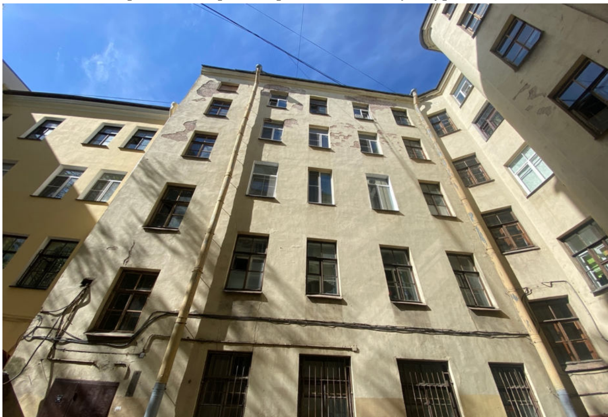
Фото 8. Фрагмент дворового фасада объекта культурного наследия.
