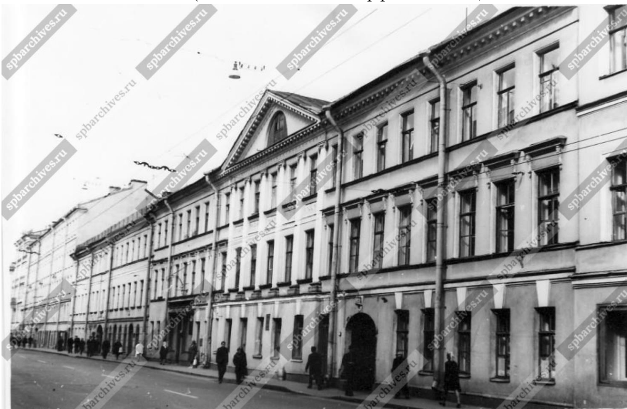
Илл. 56. Перспектива четной стороны улицы Дзержинского от набережной Фонтанки в сторону улицы Садовой по линии домов № 40-№ 38-№ 36. Август 1970 г. (источник: ЦГАКФФД СПб. Фотодокумент Ар 225597).
