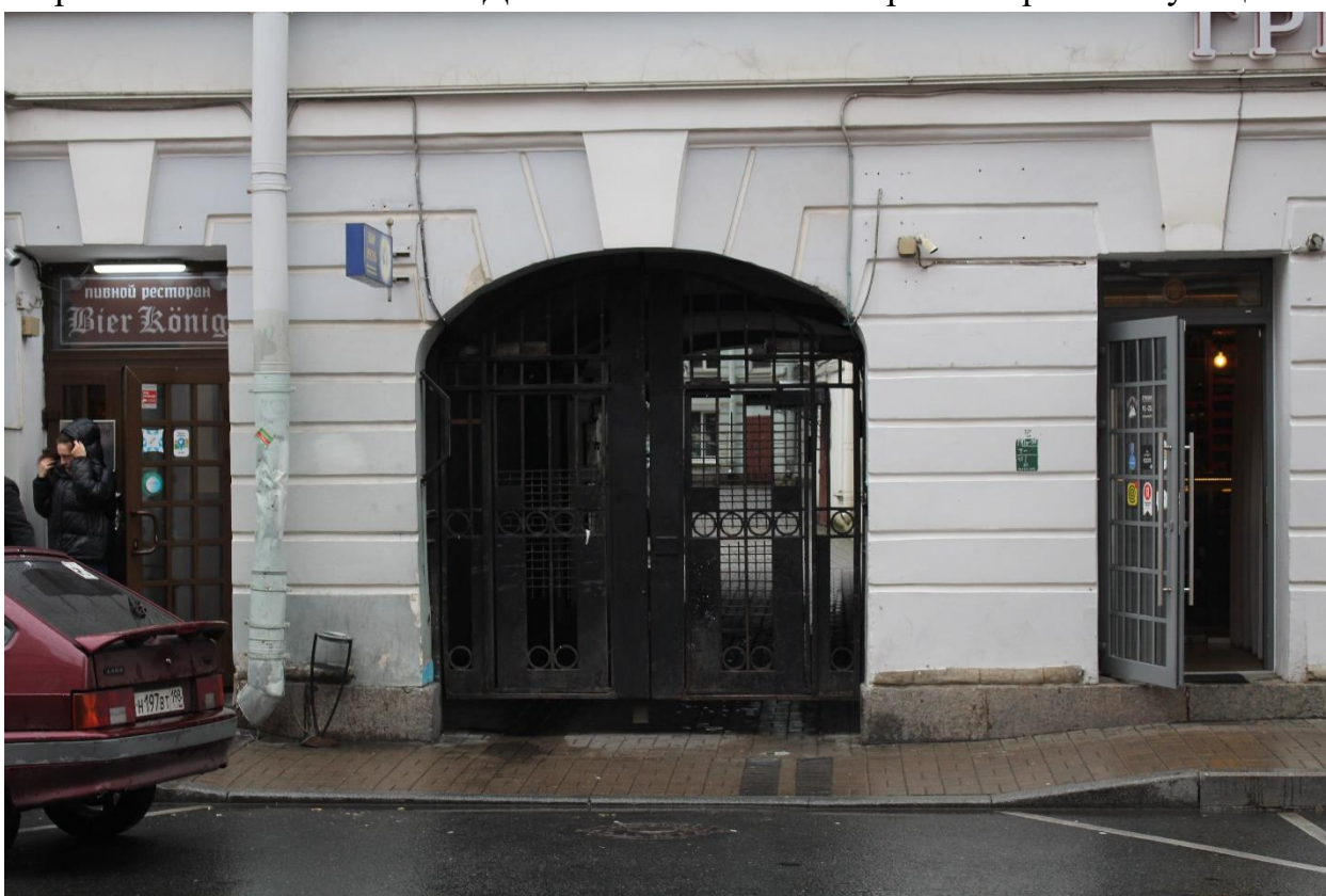
Фото 4. Вид на арку воротного проезда объекта культурного наследия регионального значения «Дом Васильевых».
