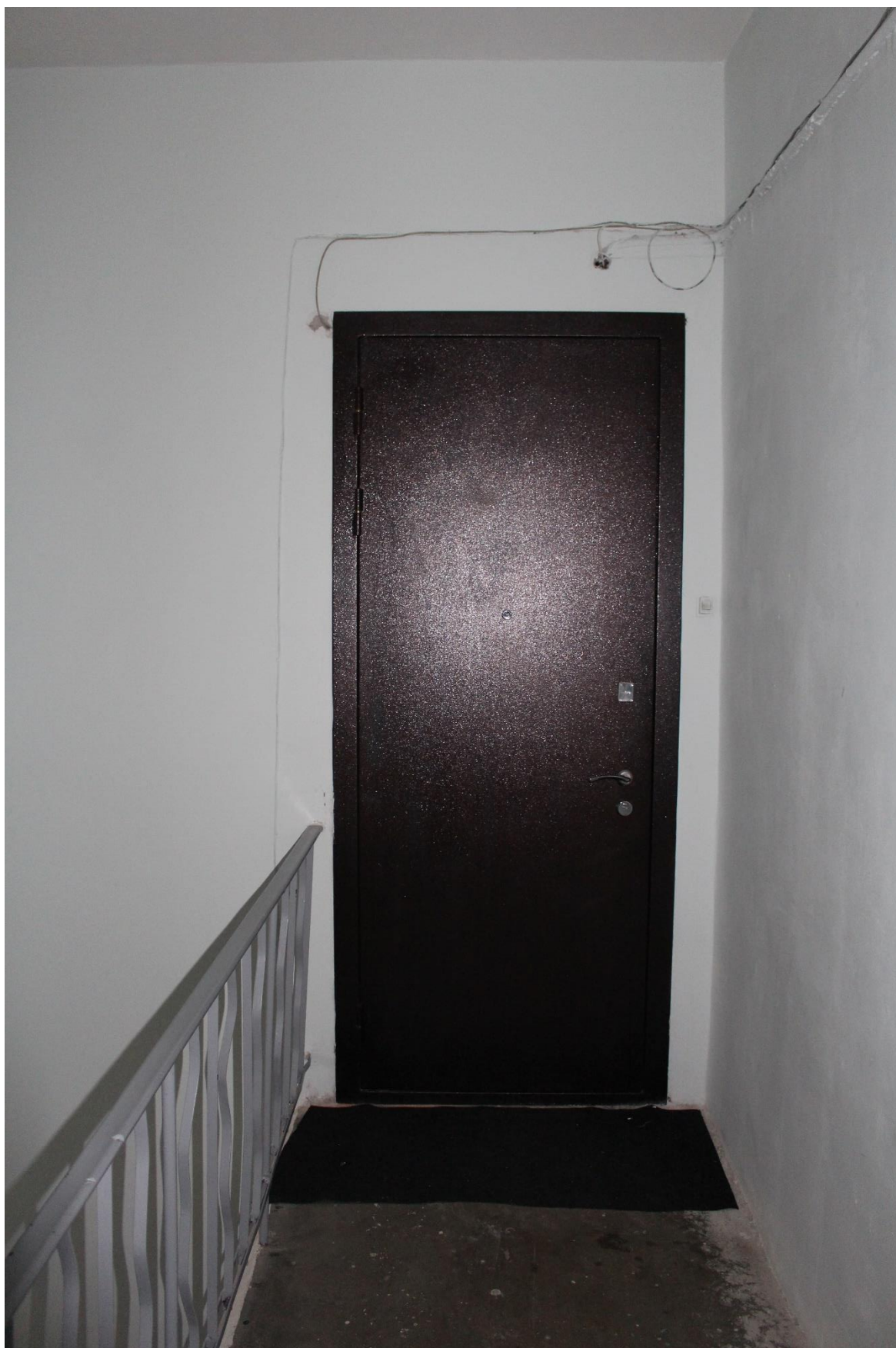
Фото 14. Вид на входную дверь в квартиру № 41.
