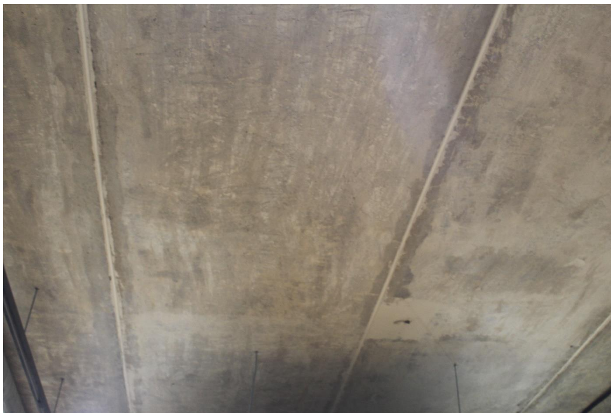
Фото 26. Квартира № 41, вид на потолок в помещении № 8.
