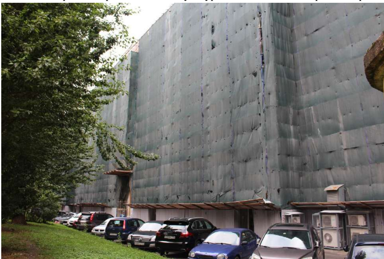
Фото 2. Фрагмент фасада объекта культурного наследия со стороны двора.
