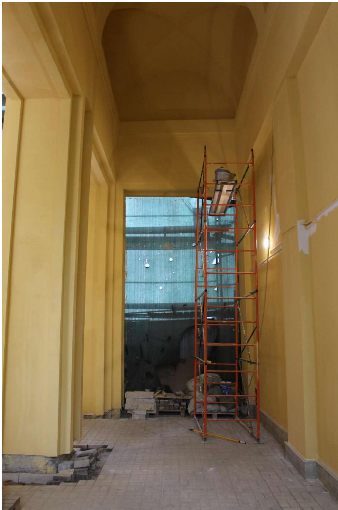
Фото 4. Арка проезда объекта культурного наследия в центральной части фасада.
