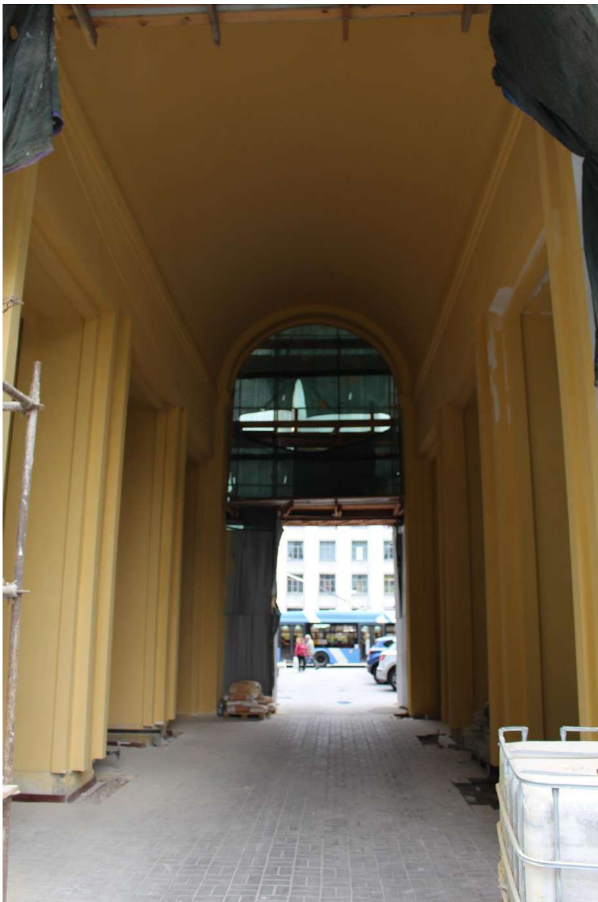
Фото 3. Арка проезда объекта культурного наследия в центральной части фасада.
