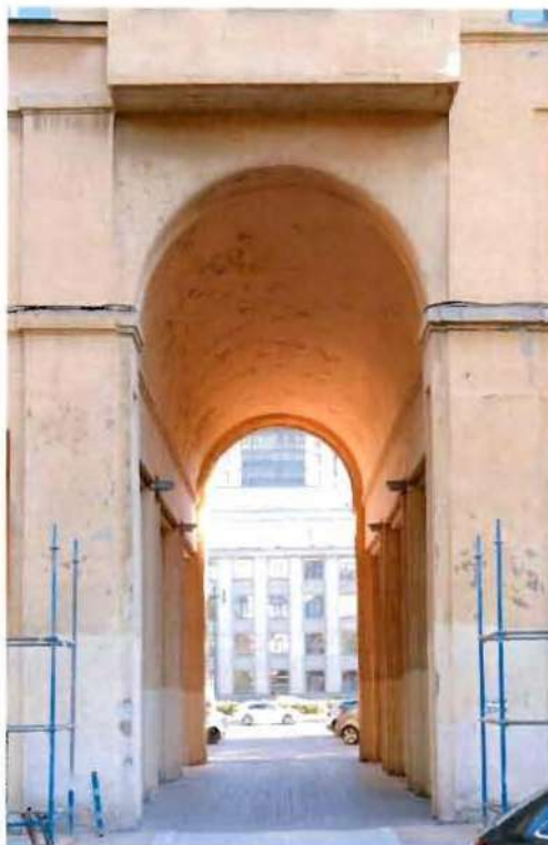
9. Фрагмент. Северная проезжая арка северного флигеля.
