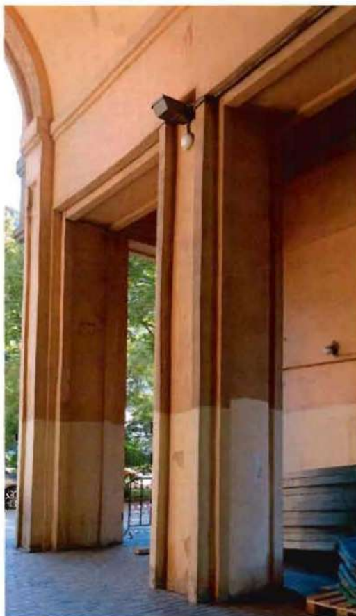
10. Фрагмент. Северная проезжая арка северного флигеля.
