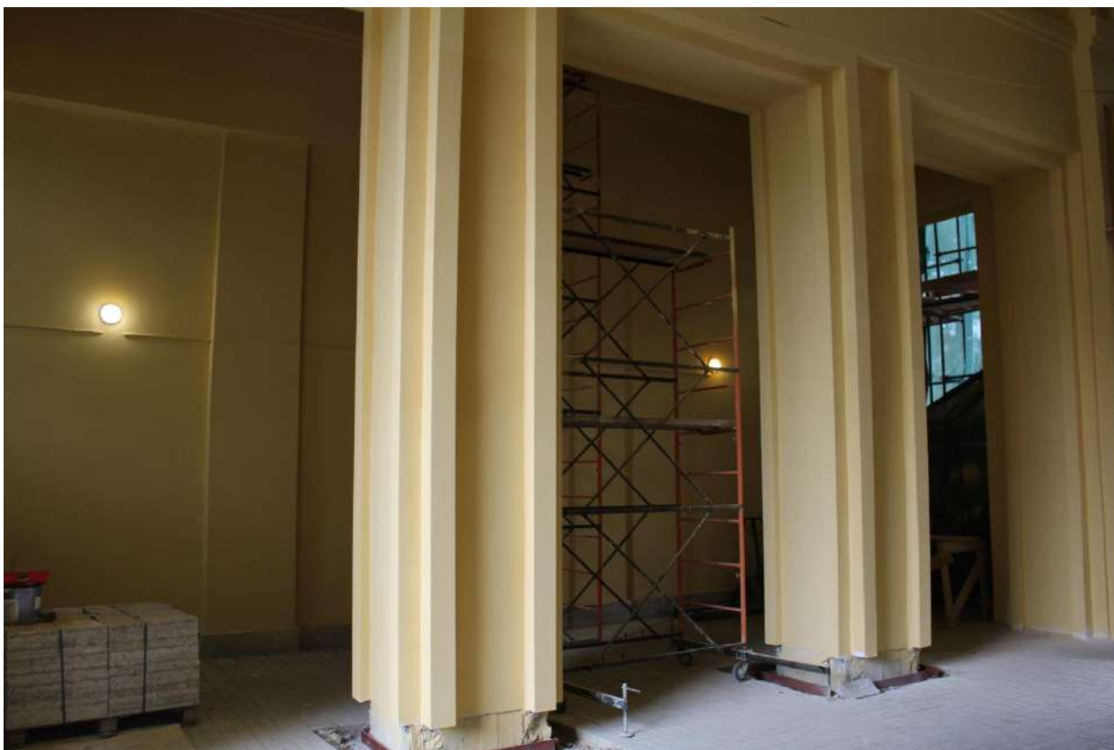
Фото 6. Арка проезда объекта культурного наследия в центральной части фасада.
