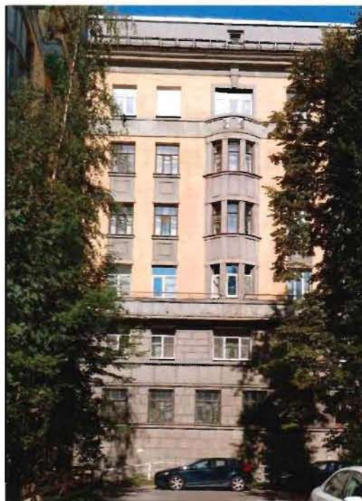
4. Фрагмент. Восточный фасад главного флигеля.
