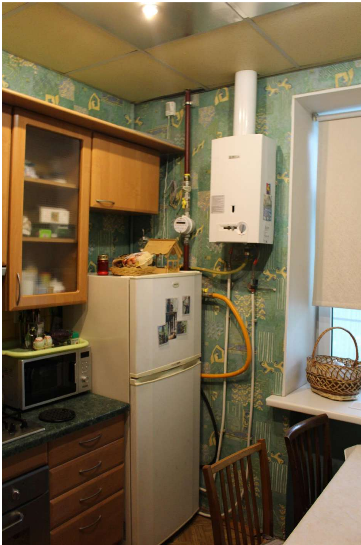
Фото 28. Вид на помещение квартиры № 163 объекта культурного наследия.
