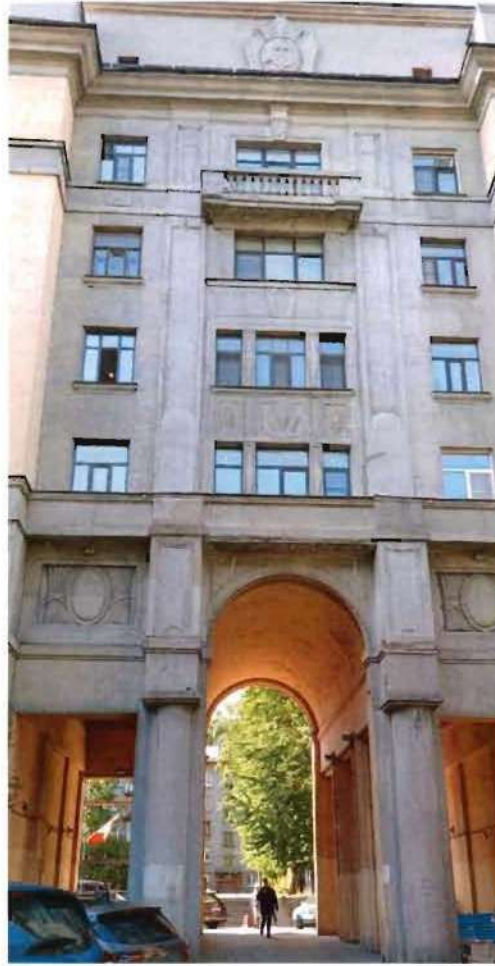
3. Фрагмент. Восточный фасад южного флигеля.
