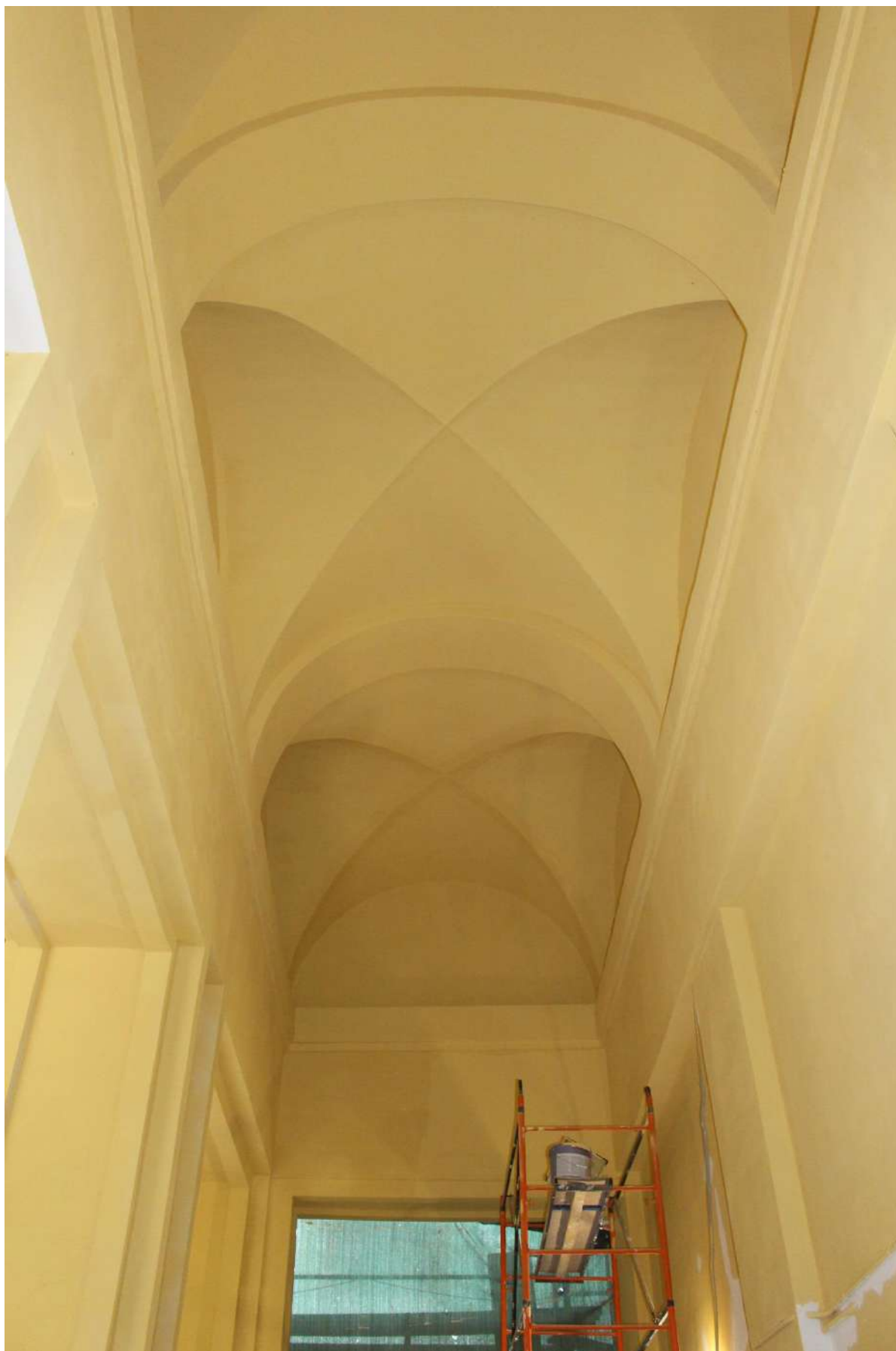
Фото 5. Своды арки проезда объекта культурного наследия в центральной части фасада.
