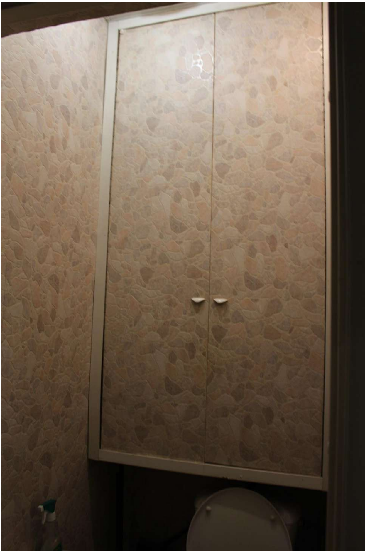
Фото 26. Вид на помещение квартиры № 163 объекта культурного наследия.
