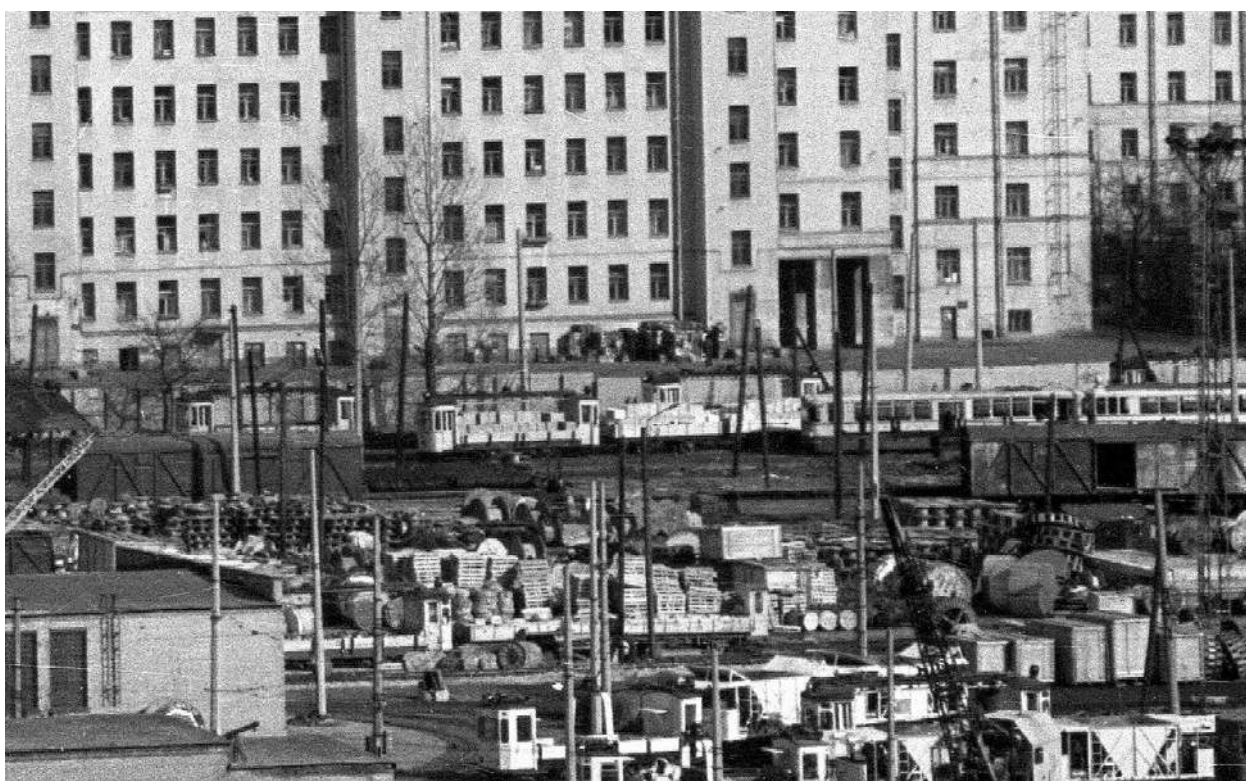
43. Вид на двор дома № 79, 1981 г. [Электронный ресурс] URL: https://p2.citywalls.ru/photo_341-349490.jpg?mt=1529160618
