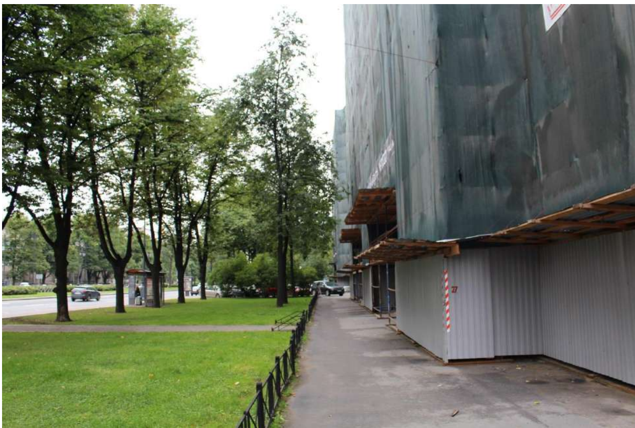
Фото 9. Фрагмент фасада объекта культурного наследия по Московскому проспекту.
