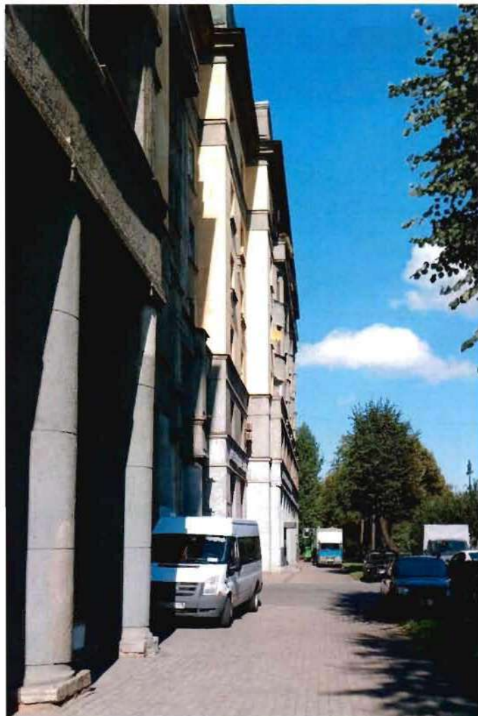
6. Фрагмент. Восточный фасад южного флигеля.
