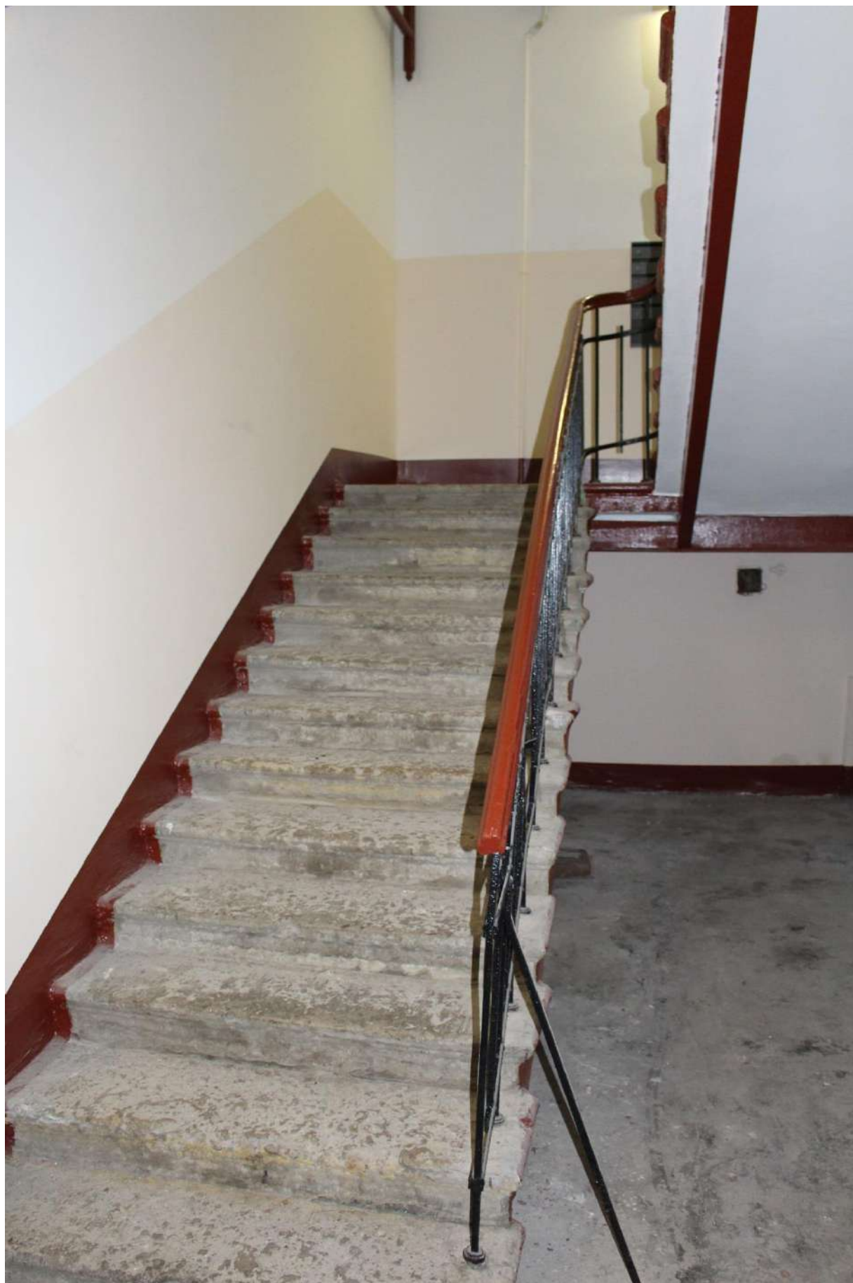
Фото 13. Вид на лестницу, ведущую в квартиру № 163, объекта культурного наследия.
