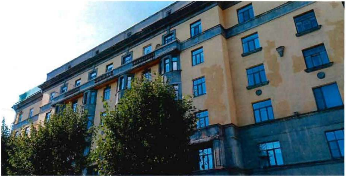
5. Фрагмент. Восточный фасад южного флигеля.
