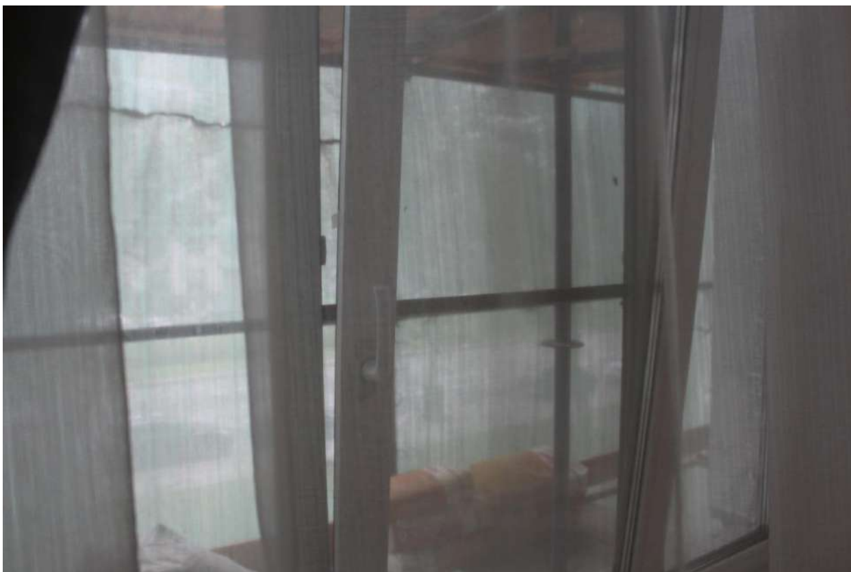
Фото 18. Вид на оконное заполнение квартиры № 163 объекта культурного наследия.
