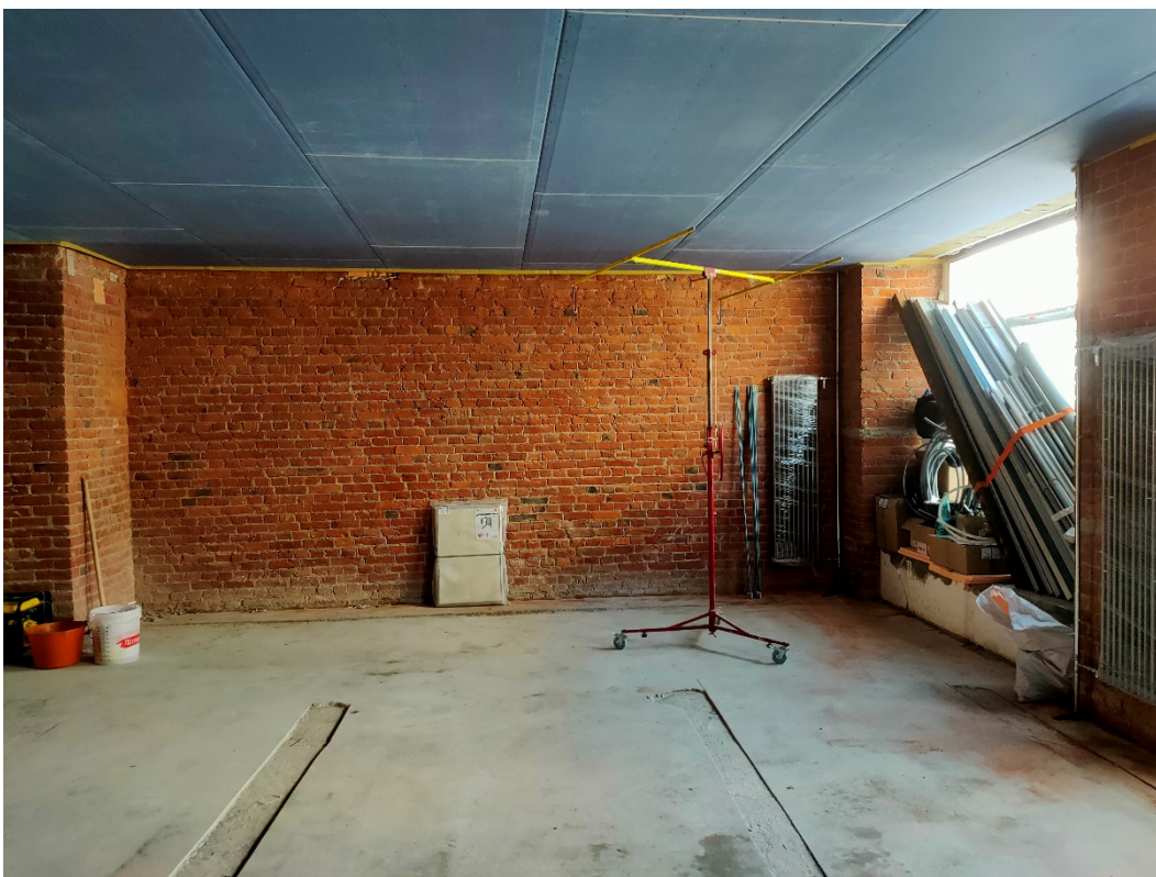
3. «Дом А.И.Семеновой», Санкт-Петербург, Рыбацкая ул., д.10, литера А. Помещение №1-Н. Общий вид. Фото 26.05.2023г.
