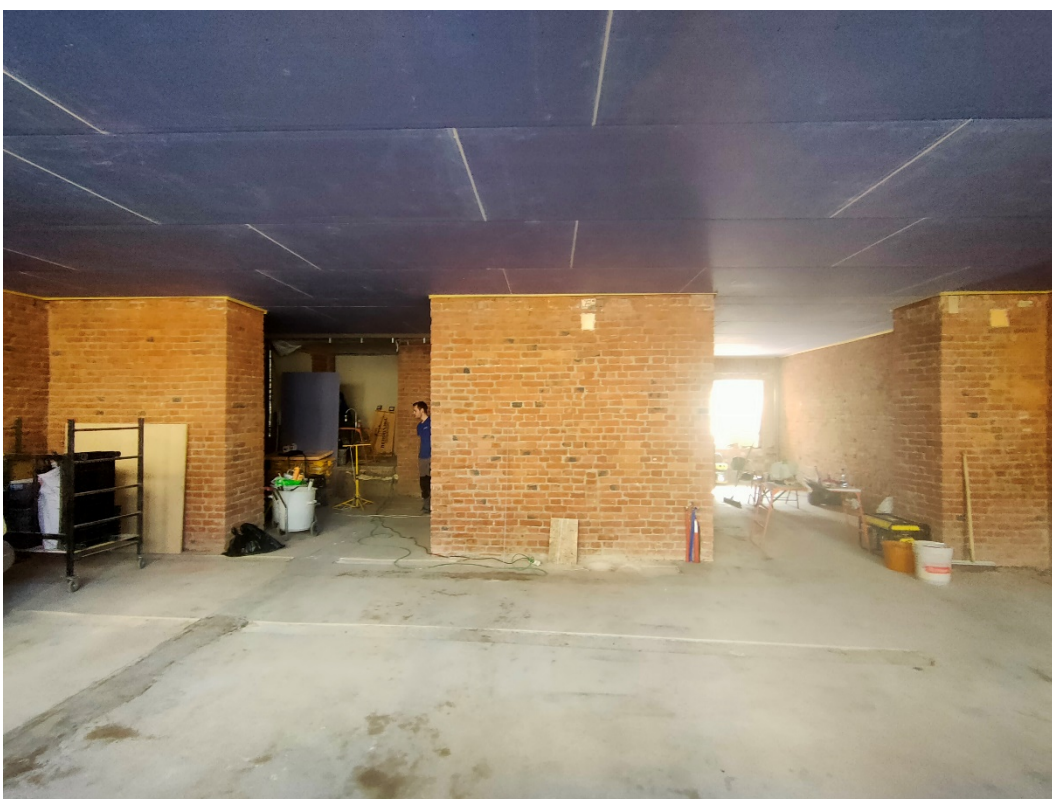
4. «Дом А.И.Семеновой», Санкт-Петербург, Рыбацкая ул., д.10, литера А. Помещение №1-Н. Общий вид. Фото 26.05.2023г.
