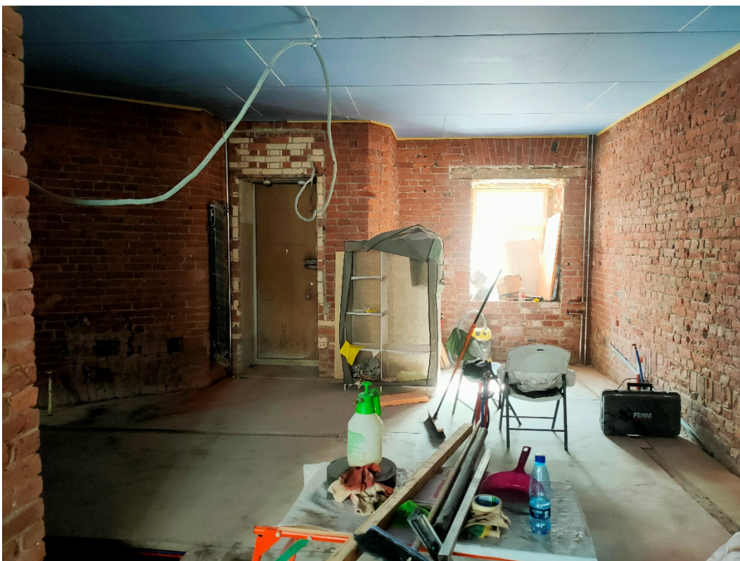
5. «Дом А.И.Семеновой», Санкт-Петербург, Рыбацкая ул., д.10, литера А. Помещение №1-Н. Общий вид. Фото 26.05.2023г.
