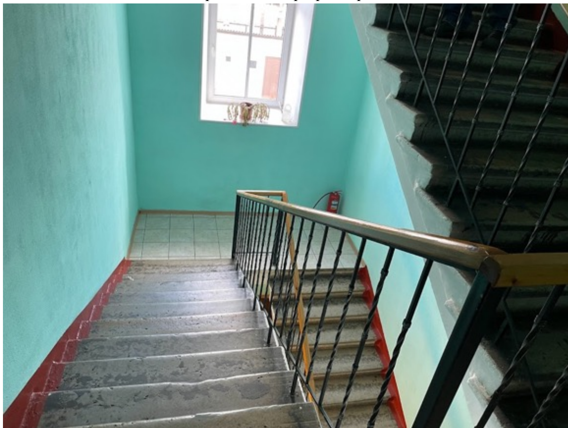
36. Лестница ЛК1 в уровне второго этажа
