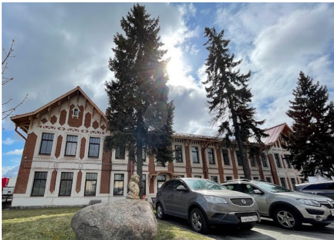
2. Вид с северо-запада
