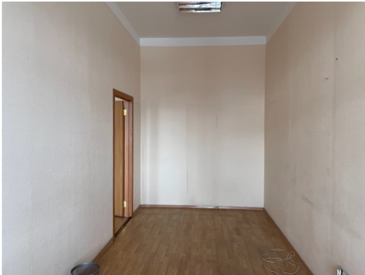
32. Фрагмент интерьера второго этажа
