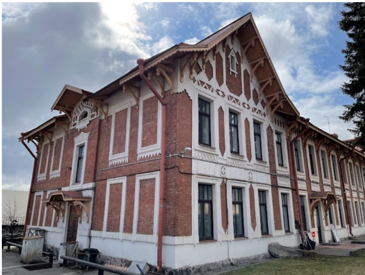
3. Северо-западный угол здания
