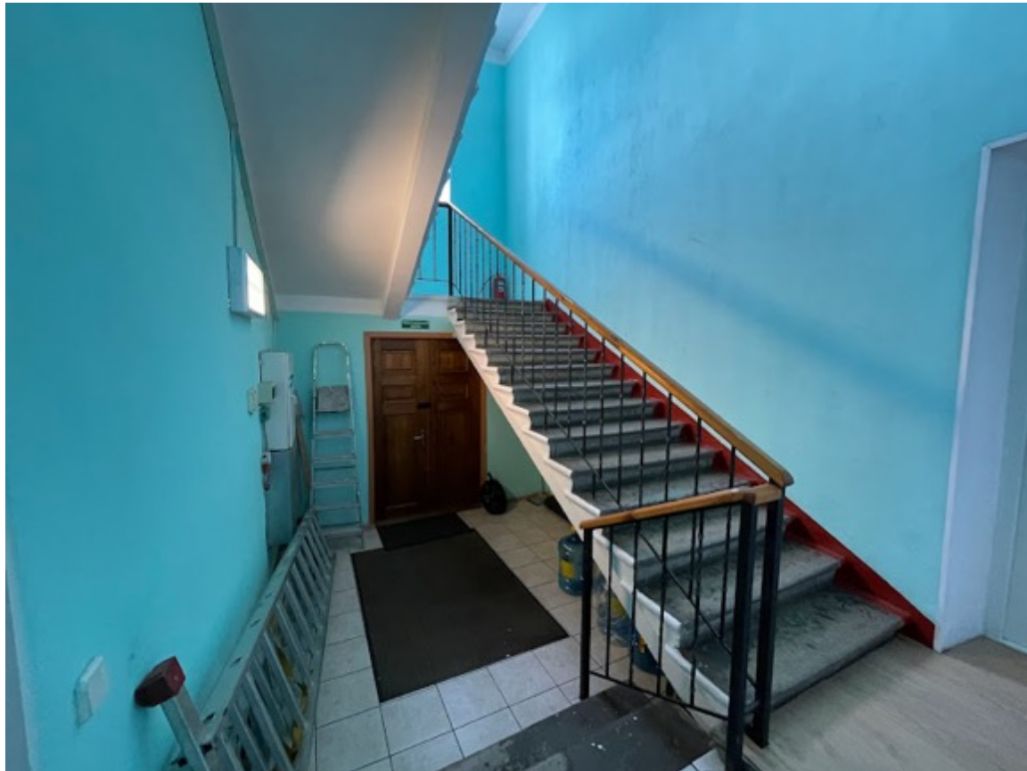
22. Лестница ЛК1 в уровне первого этажа
