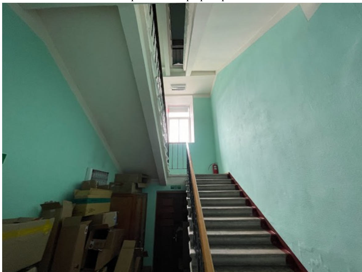
20. Лестница ЛК2 в уровне первого этажа
