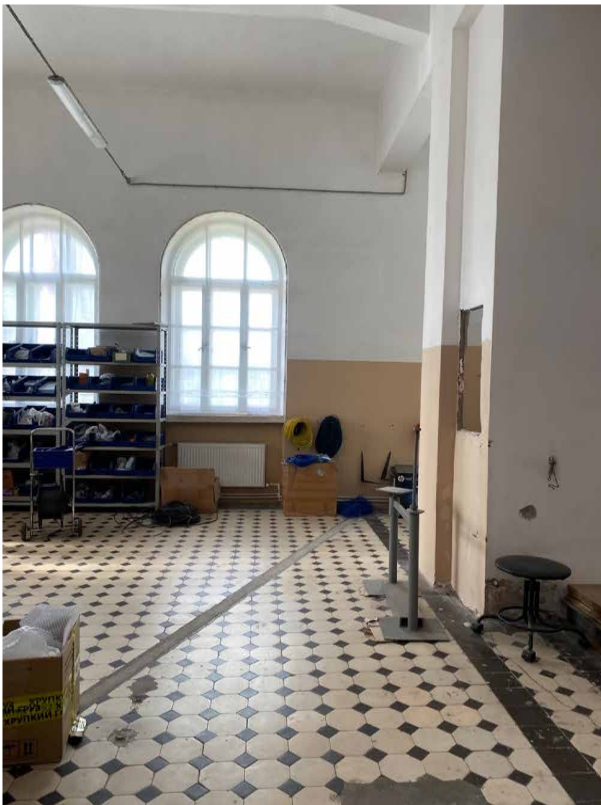
107. Интерьер помещения объекта культурного наследия в уровне 2-го этажа. Автор фото: Штиглиц М.С. Дата: 17.04.2023 г.
