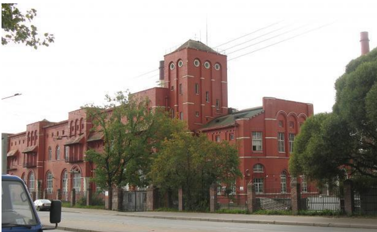
63. Главная понижающая подстанция Волховской ГЭС, 2010 г. [Электронный ресурс]. URL: https://p0.citywalls.ru/photo_53-54752.jpg?mt=1284832618
