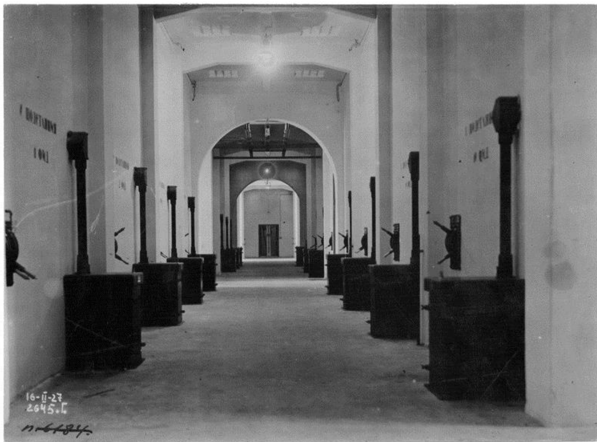
57. Главная понижающая подстанция Волховской ГЭС. Коридор управления масляными выключателями 35 000 Вольт, 1927 г. [Электронный ресурс]. URL: https://pastvu.com/p/1200603
