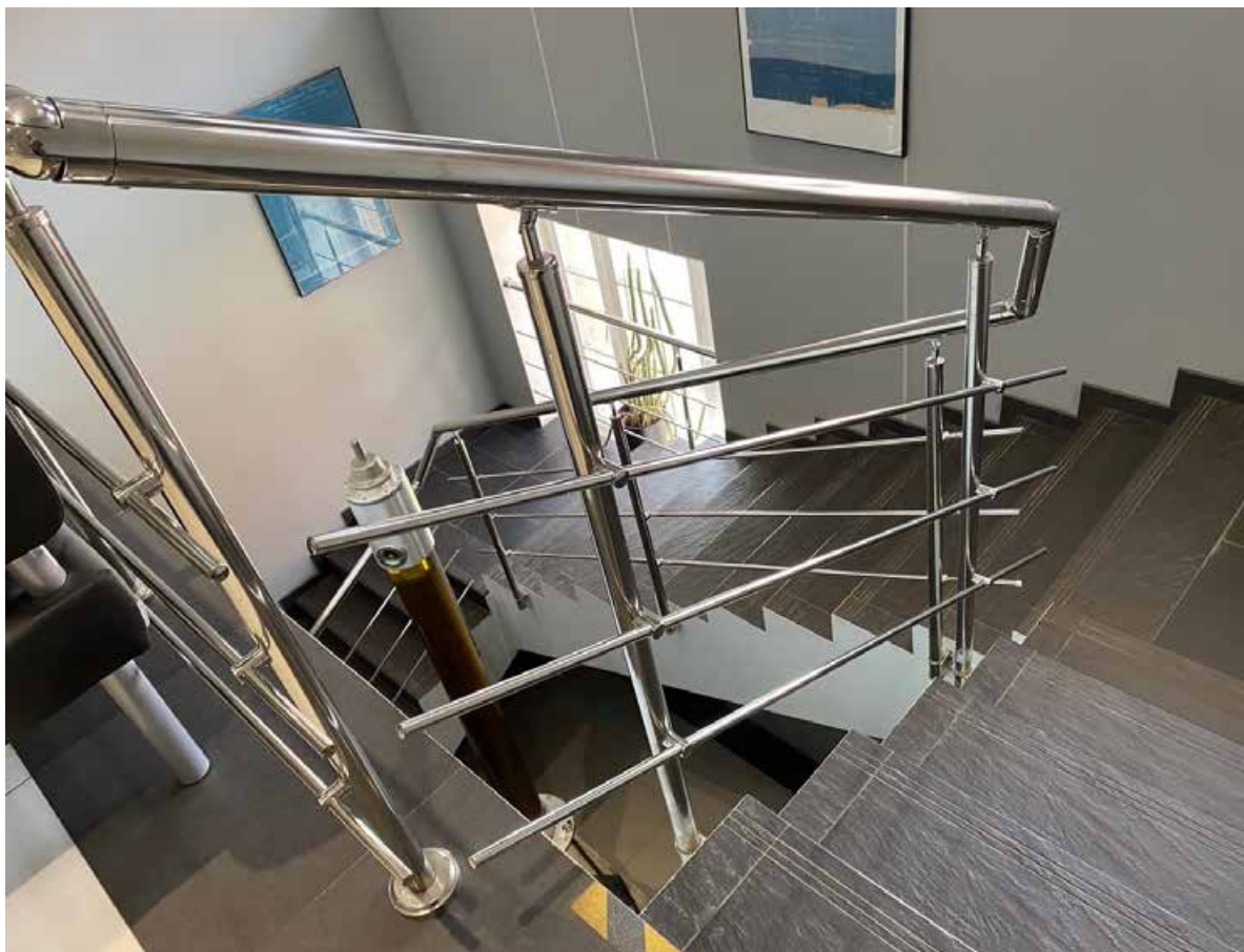
77. Лестница объекта культурного наследия в уровне 2-го этажа – помещение ЗН(58). Автор фото: Штиглиц М.С. Дата: 17.04.2023 г.
