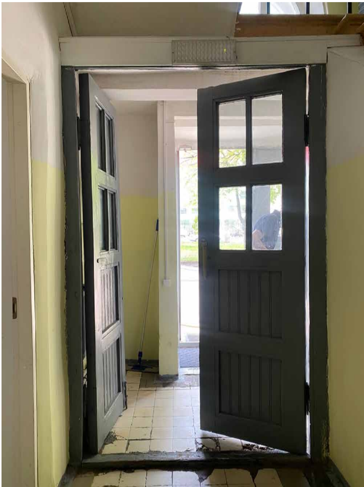
112. Интерьер тамбура объекта культурного наследия в уровне 1-го этажа. Автор фото: Штиглиц М.С. Дата: 17.04.2023 г.
