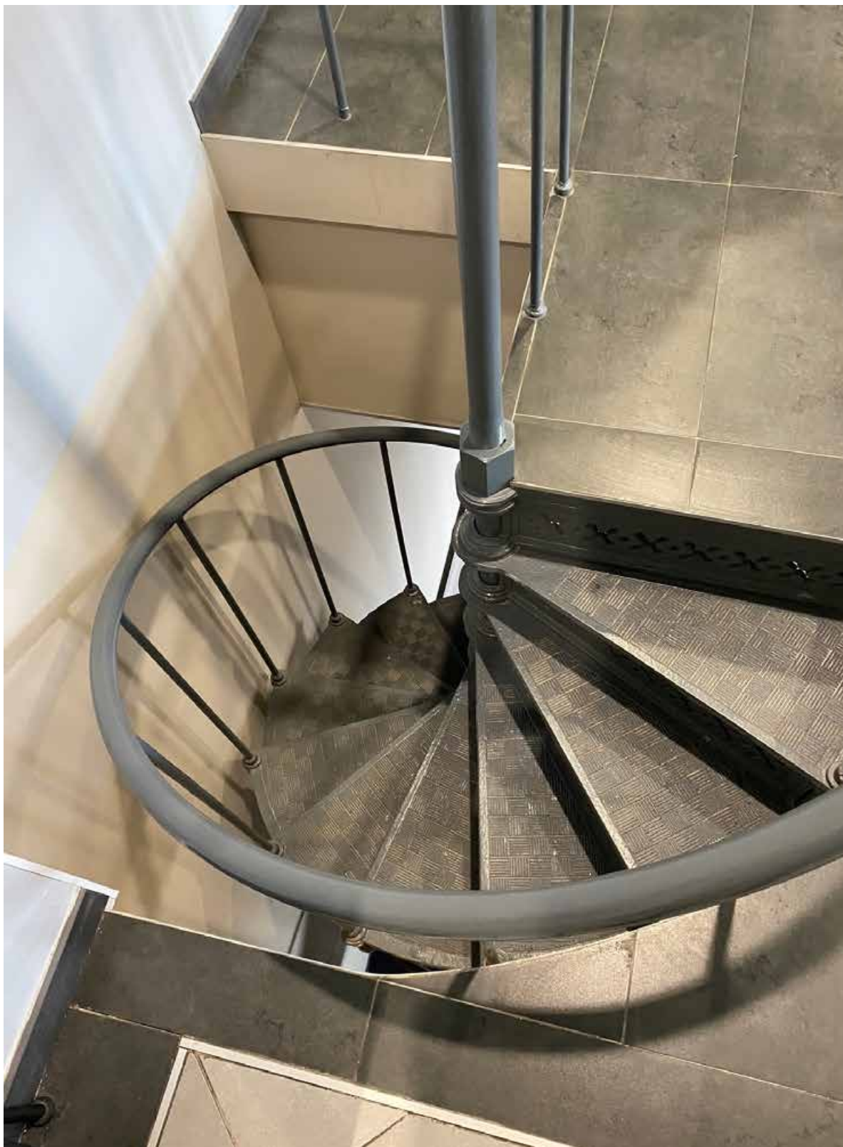
79. Лестница объекта культурного наследия в уровне 2-го этажа – помещение 3Н(59). Автор фото: Штиглиц М.С. Дата: 17.04.2023 г.
