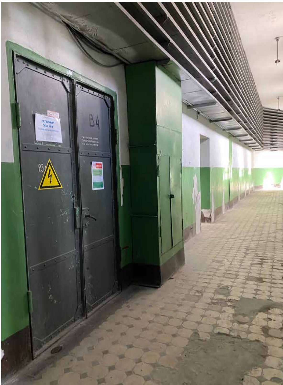
62. Интерьер объекта культурного наследия в уровне 2-го этажа – помещение 4Н(28). Автор фото: Штиглиц М.С. Дата: 17.04.2023 г.
