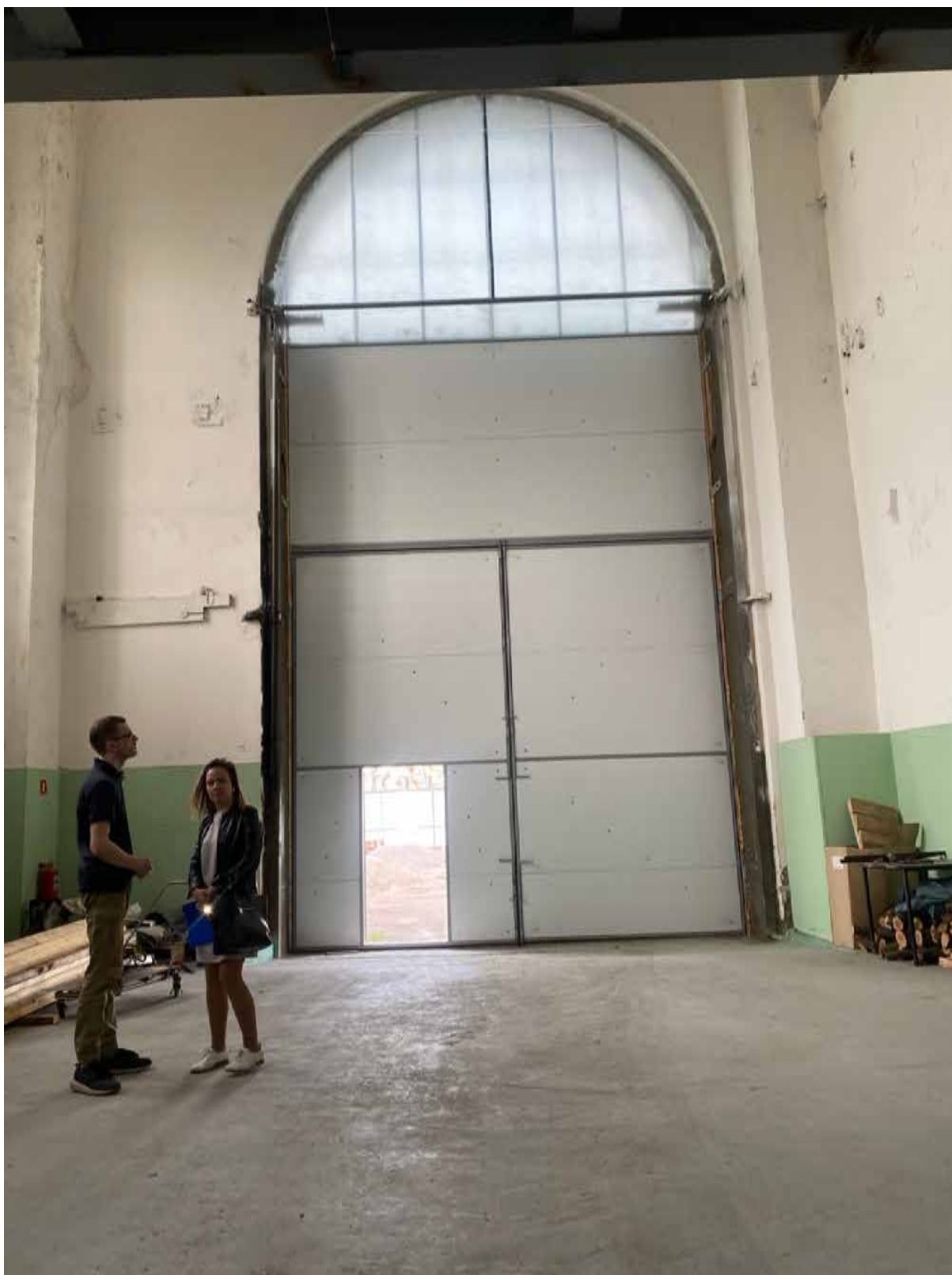
118. Интерьер помещения цеха объекта культурного наследия в уровне 1-го этажа. Автор фото: Штиглиц М.С. Дата: 17.04.2023 г.
