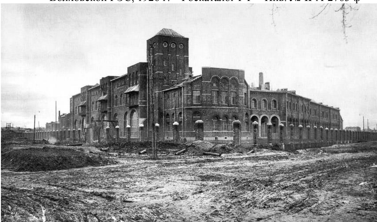
54. Главная понижающая подстанция Волховской ГЭС, 1926 г. [Электронный ресурс]. URL: https://pastvu.com/p/112770
