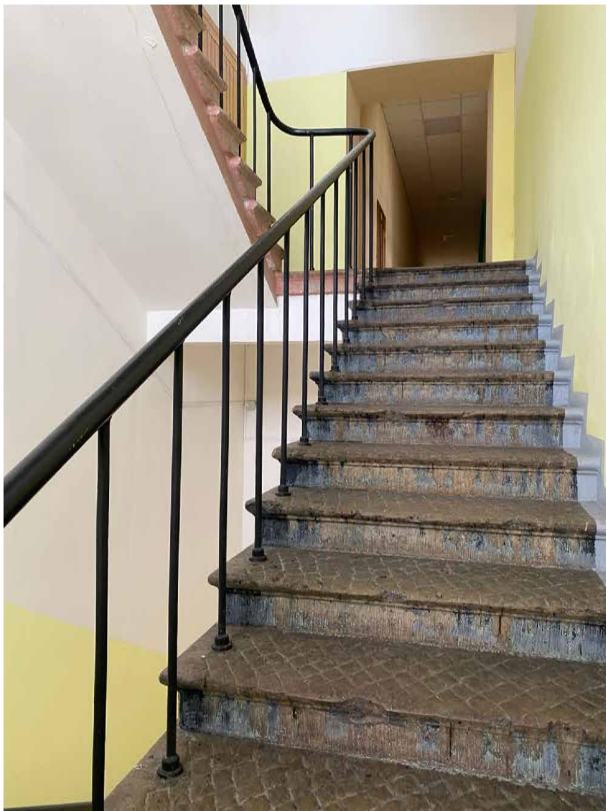
102. Лестница объекта культурного наследия в уровне 2-го этажа. Автор фото: Штиглиц М.С. Дата: 17.04.2023 г.
