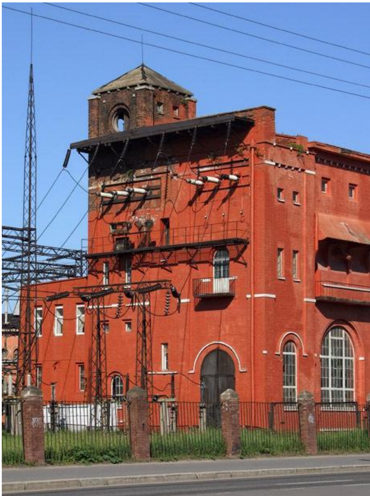
61. Главная понижающая подстанция Волховской ГЭС, 2010 г. [Электронный ресурс]. URL: https://p2.citywalls.ru/photo_34-34898.jpg?mt=1273625807
