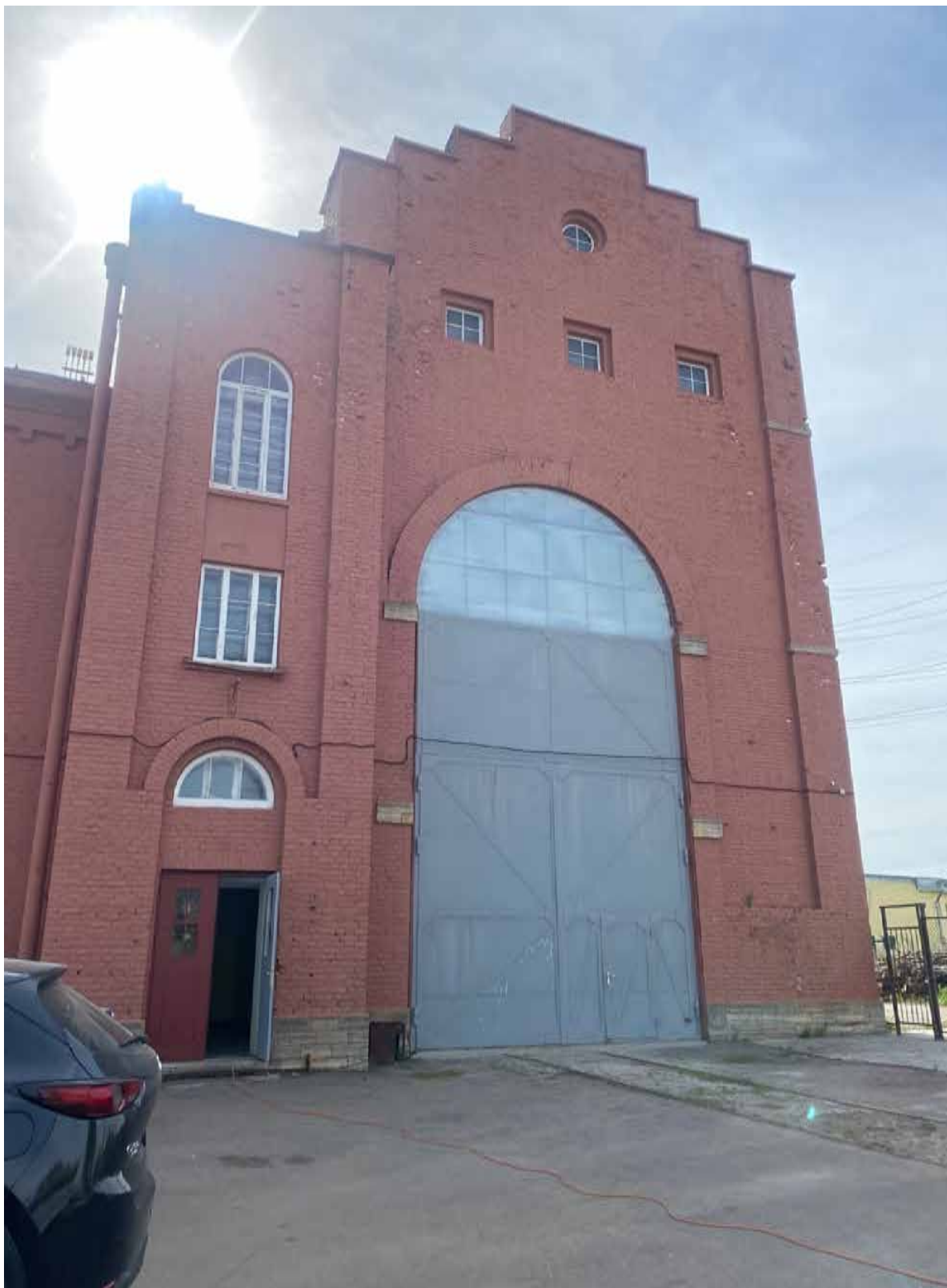
93. Фрагмент торцевого северо-западного фасада объекта культурного наследия. Автор фото: Штиглиц М.С. Дата: 17.04.2023 г.
