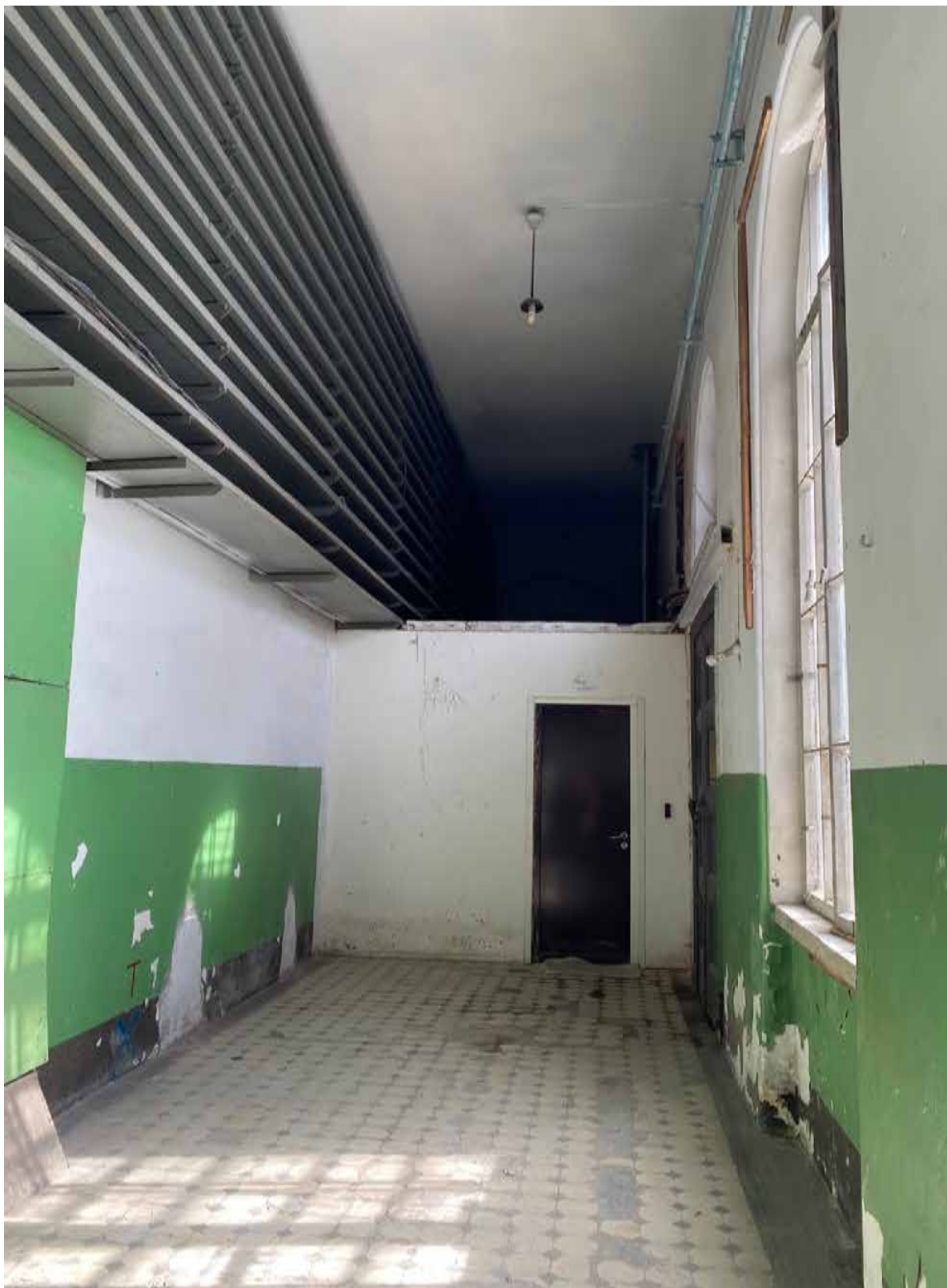
65. Интерьер объекта культурного наследия в уровне 2-го этажа – помещение 4Н(28). Автор фото: Штиглиц М.С. Дата: 17.04.2023 г.
