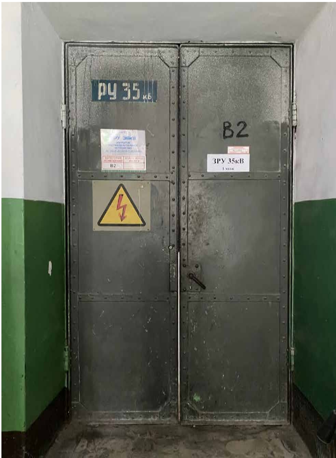
57. Дверное заполнение объекта культурного наследия в уровне 1-го этажа – помещение 4Н(28). Автор фото: Штиглиц М.С. Дата: 17.04.2023 г.
