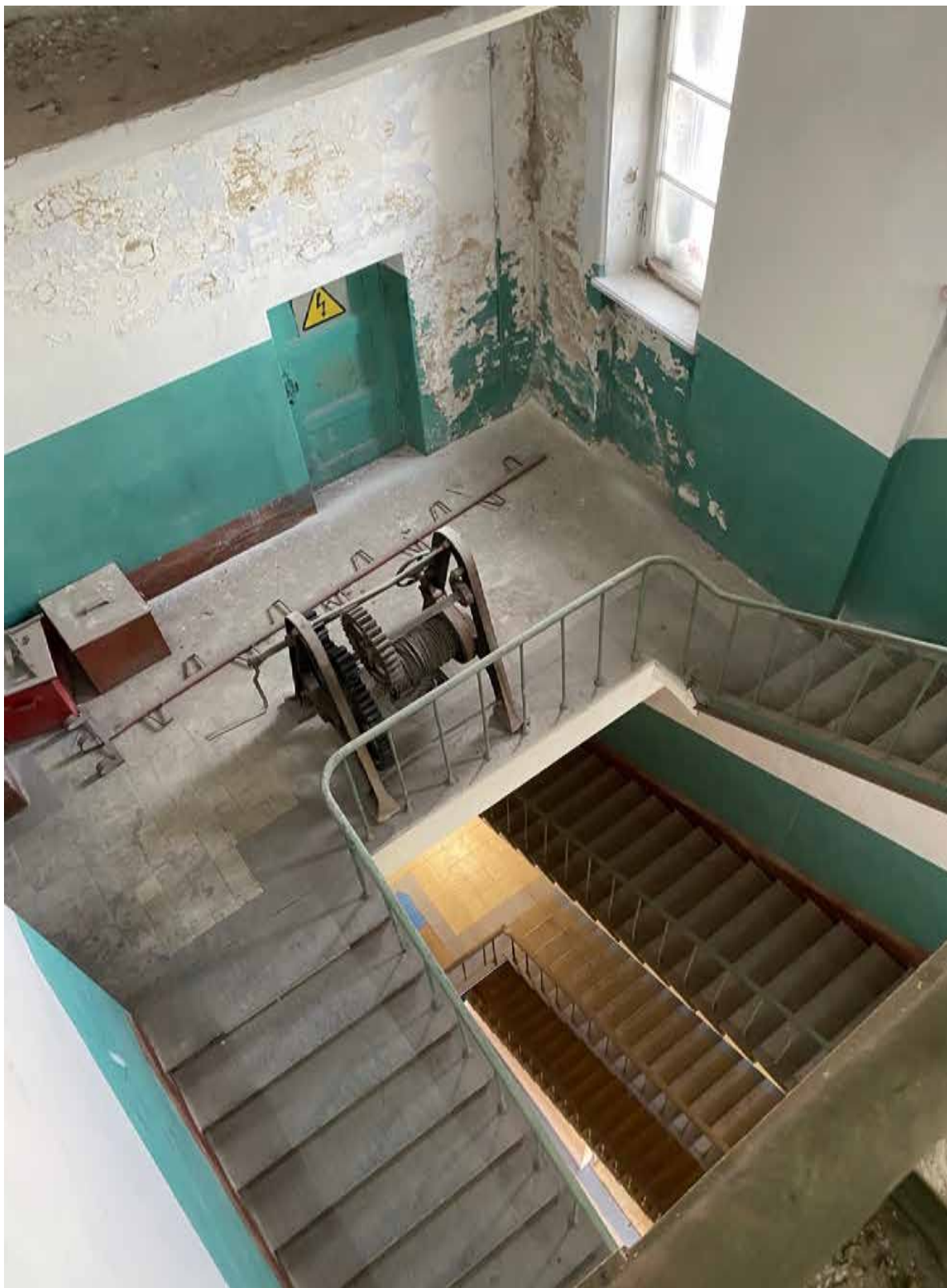
71. Общий вид служебной лестницы башни объекта культурного наследия – помещение 11Н(1). Автор фото: Штиглиц М.С. Дата: 17.04.2023 г.
