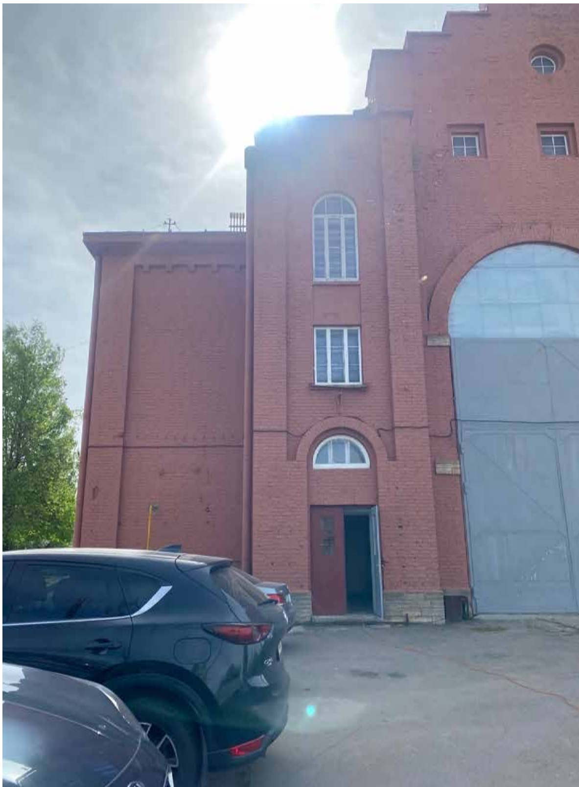
94. Фрагмент торцевого северо-западного фасада объекта культурного наследия. Автор фото: Штиглиц М.С. Дата: 17.04.2023 г.
