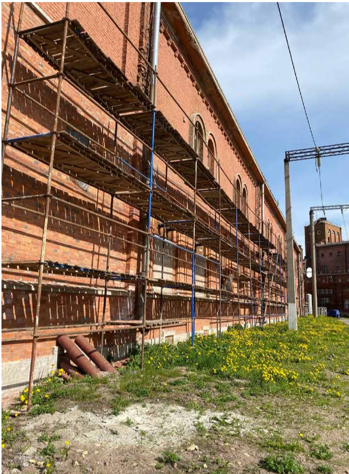
11. Фрагмент западного дворового фасада объекта культурного наследия. Автор фото: Штиглиц М.С. Дата: 17.04.2023 г.
