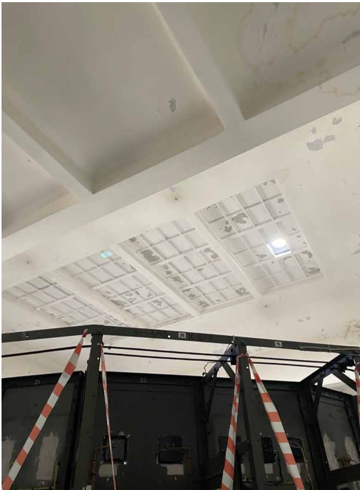
42. Интерьер объекта культурного наследия в уровне 2-го этажа – помещение 8Н(12). Автор фото: Штиглиц М.С. Дата: 17.04.2023 г.
