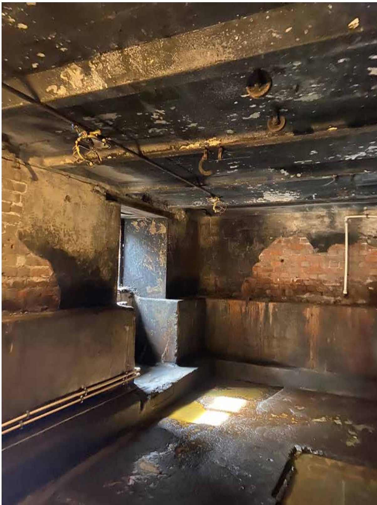
114. Интерьер подвала объекта культурного наследия в уровне подвального этажа. Автор фото: Штиглиц М.С. Дата: 17.04.2023 г.
