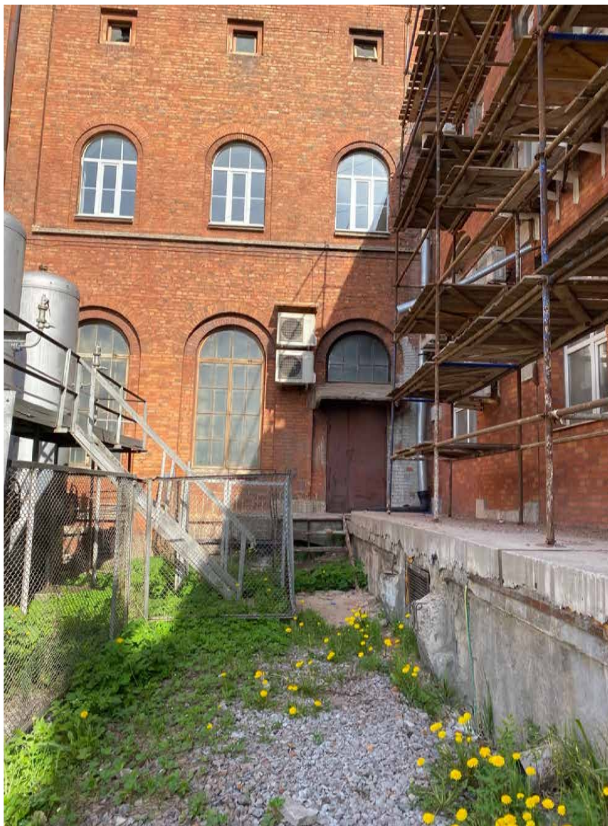
18. Фрагмент западного и юго-восточного дворовых фасадов объекта культурного наследия. Автор фото: Штиглиц М.С. Дата: 17.04.2023 г.
