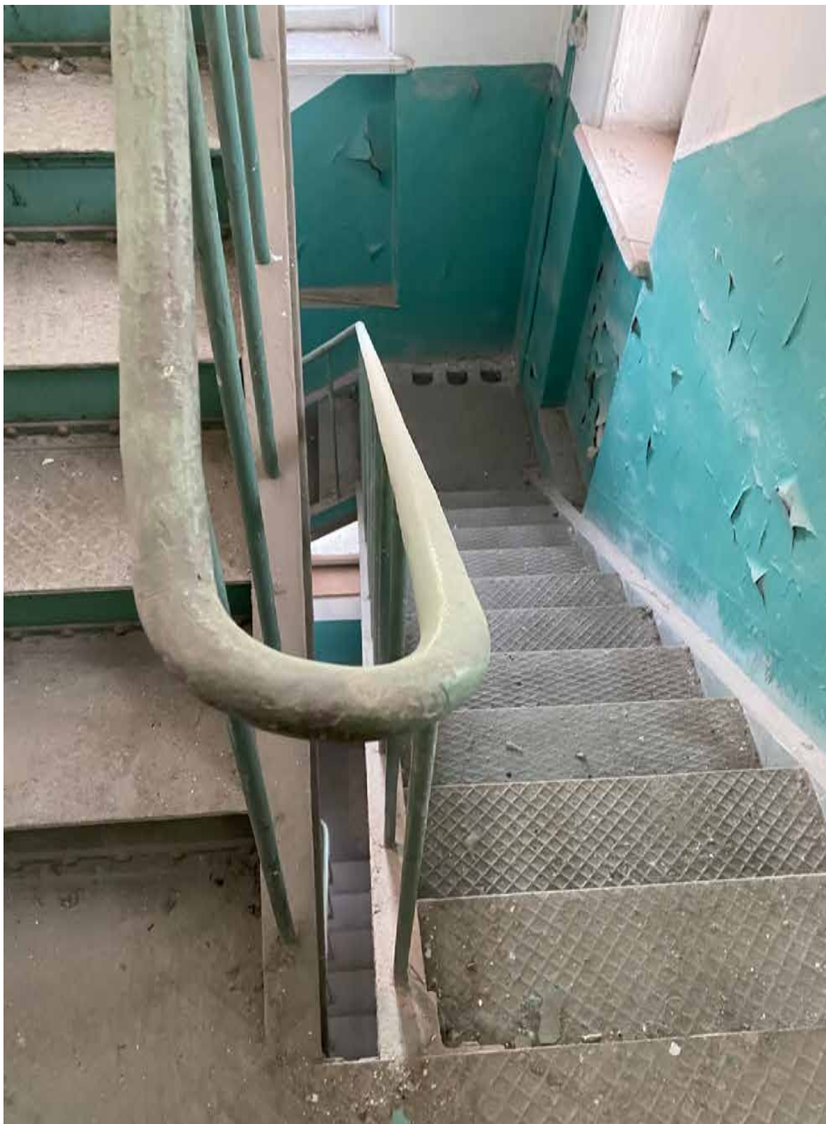
69. Лестница башни объекта культурного наследия – помещение 11Н(1). Автор фото: Штиглиц М.С. Дата: 17.04.2023 г.
