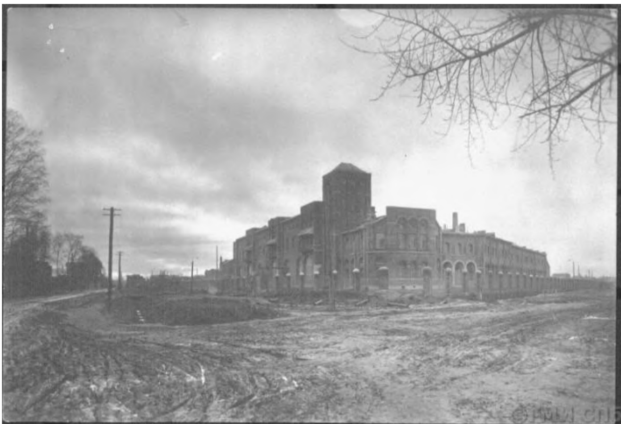
53. Полюстровский проспект. Главная понижающая подстанция Волховской ГЭС, 1926 г. – Госкаталог РФ – Инв. №-II-А-2763 ф
