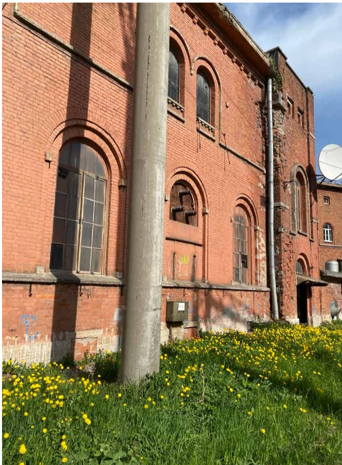
12. Фрагмент западного дворового фасада объекта культурного наследия. Автор фото: Штиглиц М.С. Дата: 17.04.2023 г.
