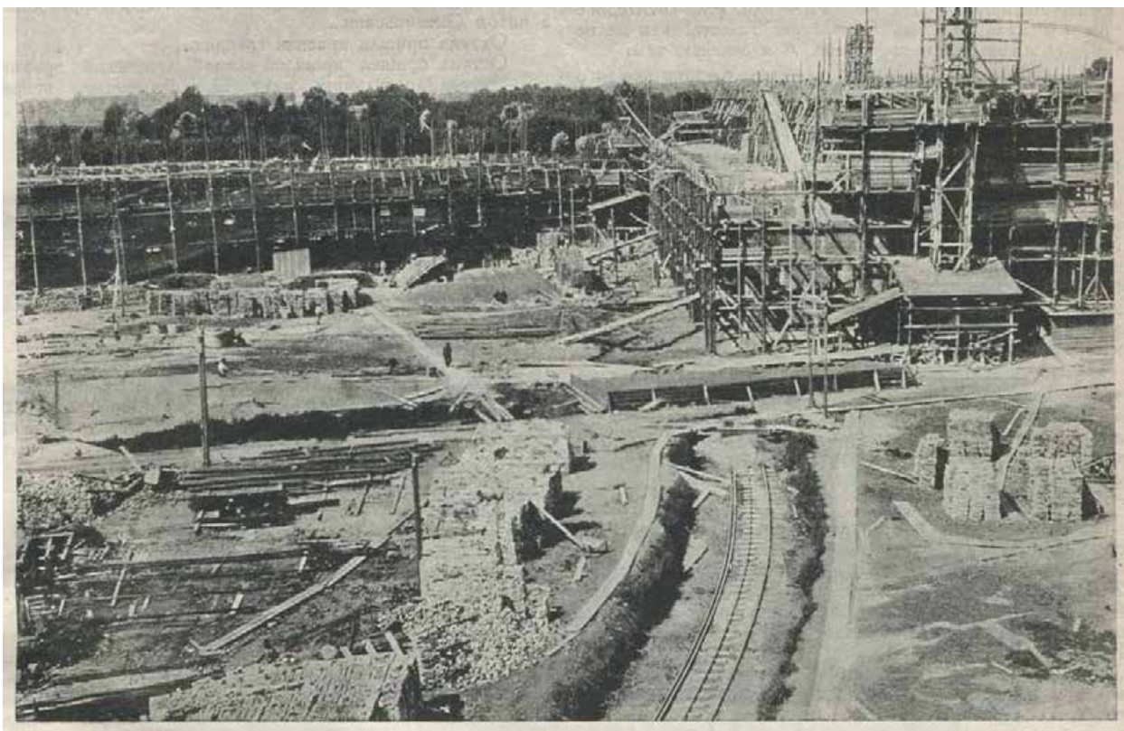
49. Строительство подстанции «Волхов-Северная», 1924 г. [Электронный ресурс]. URL: https://pastvu.com/p/130130
