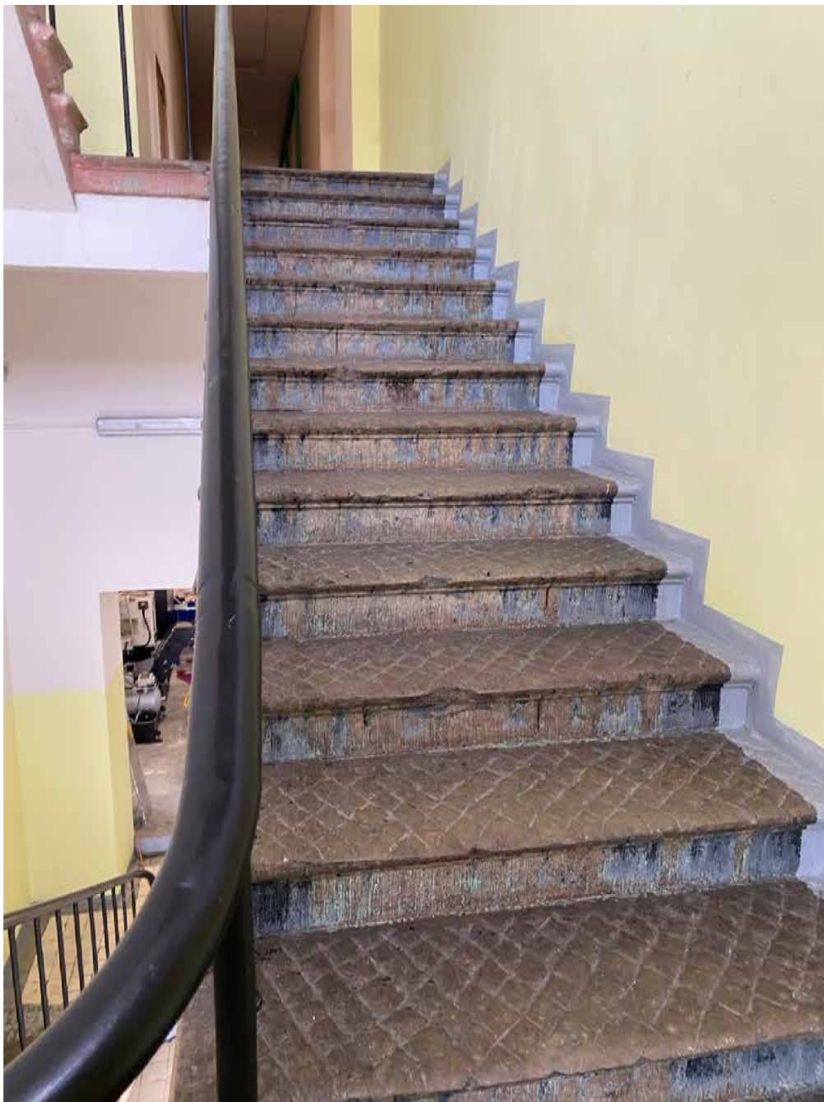
101. Лестница объекта культурного наследия в уровне 1-го этажа. Автор фото: Штиглиц М.С. Дата: 17.04.2023 г.
