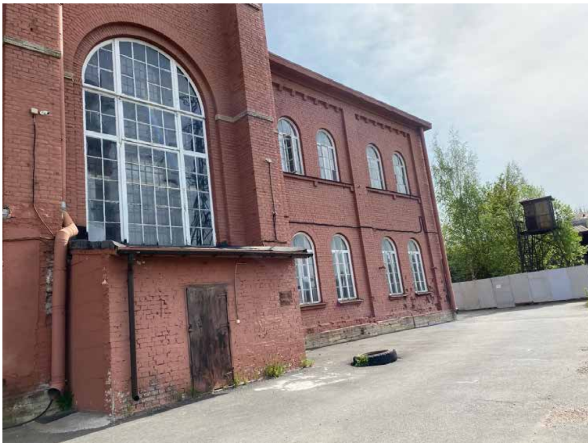
98. Фрагмент юго-западного фасада объекта культурного наследия. Автор фото: Штиглиц М.С. Дата: 17.04.2023 г.
