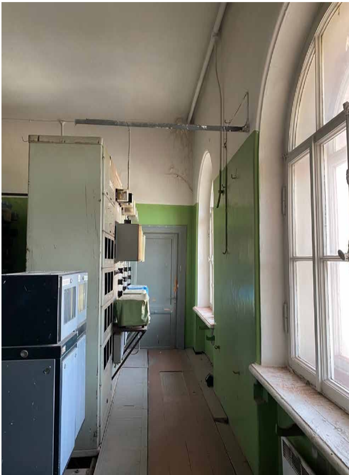
46. Интерьер объекта культурного наследия в уровне 2-го этажа— помещение 8Н(14). Автор фото: Штиглиц М.С. Дата: 17.04.2023 г.
