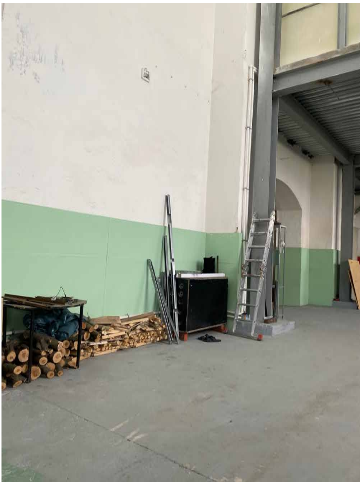
115. Интерьер помещения цеха объекта культурного наследия в уровне 1-го этажа. Автор фото: Штиглиц М.С. Дата: 17.04.2023 г.
