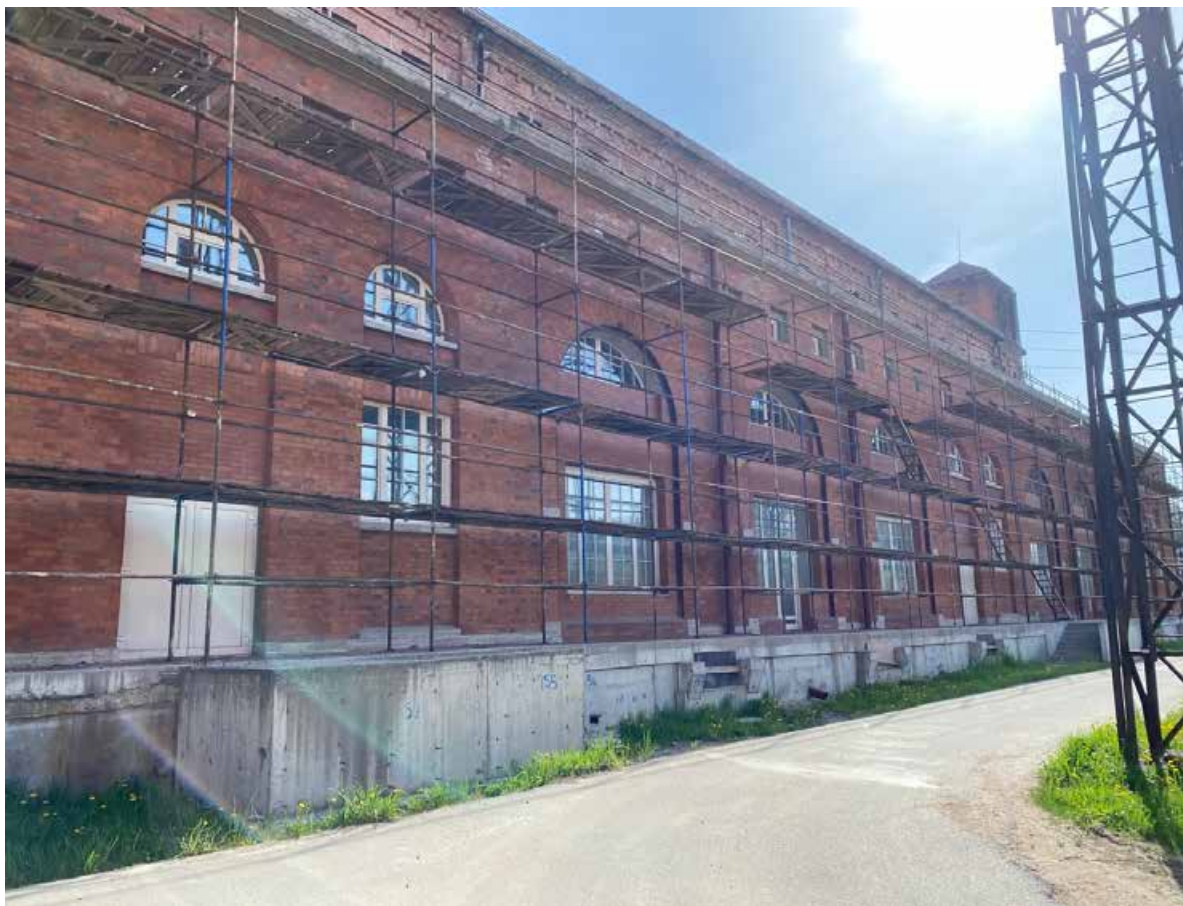
17. Фрагмент западного дворового фасада объекта культурного наследия. Автор фото: Штиглиц М.С. Дата: 17.04.2023 г.
