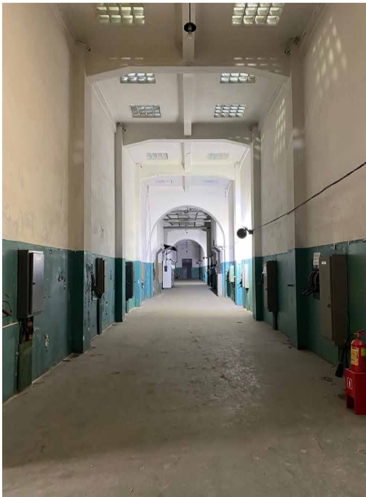
58. Интерьер объекта культурного наследия в уровне 1-го этажа – помещение 4Н(32). Автор фото: Штиглиц М.С. Дата: 17.04.2023 г.
