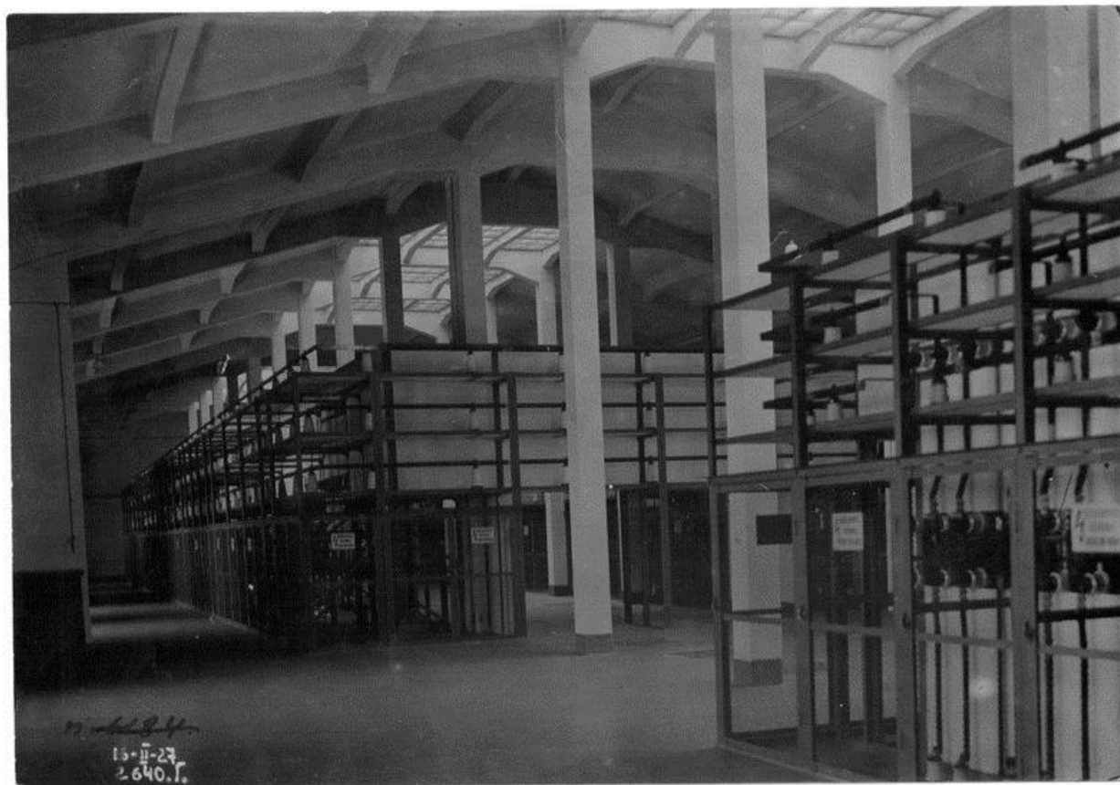
56. Главная понижающая подстанция Волховской ГЭС. Распределительное устройство 35 000 Вольт, 1927 г. [Электронный ресурс]. URL: https://pastvu.com/p/1200617
