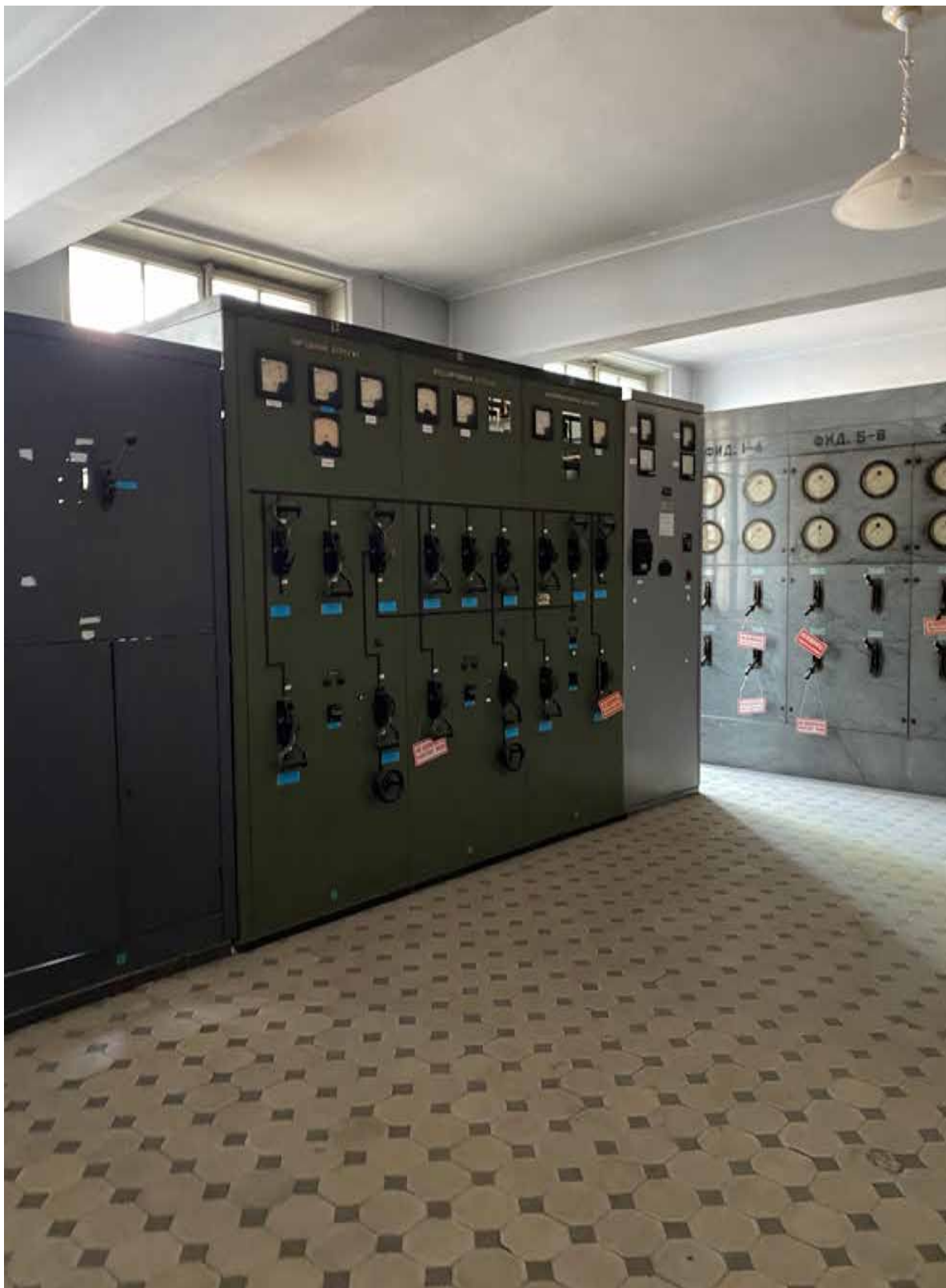
63. Интерьер объекта культурного наследия в уровне 2-го этажа – помещение 4Н(46). Автор фото: Штиглиц М.С. Дата: 17.04.2023 г.
