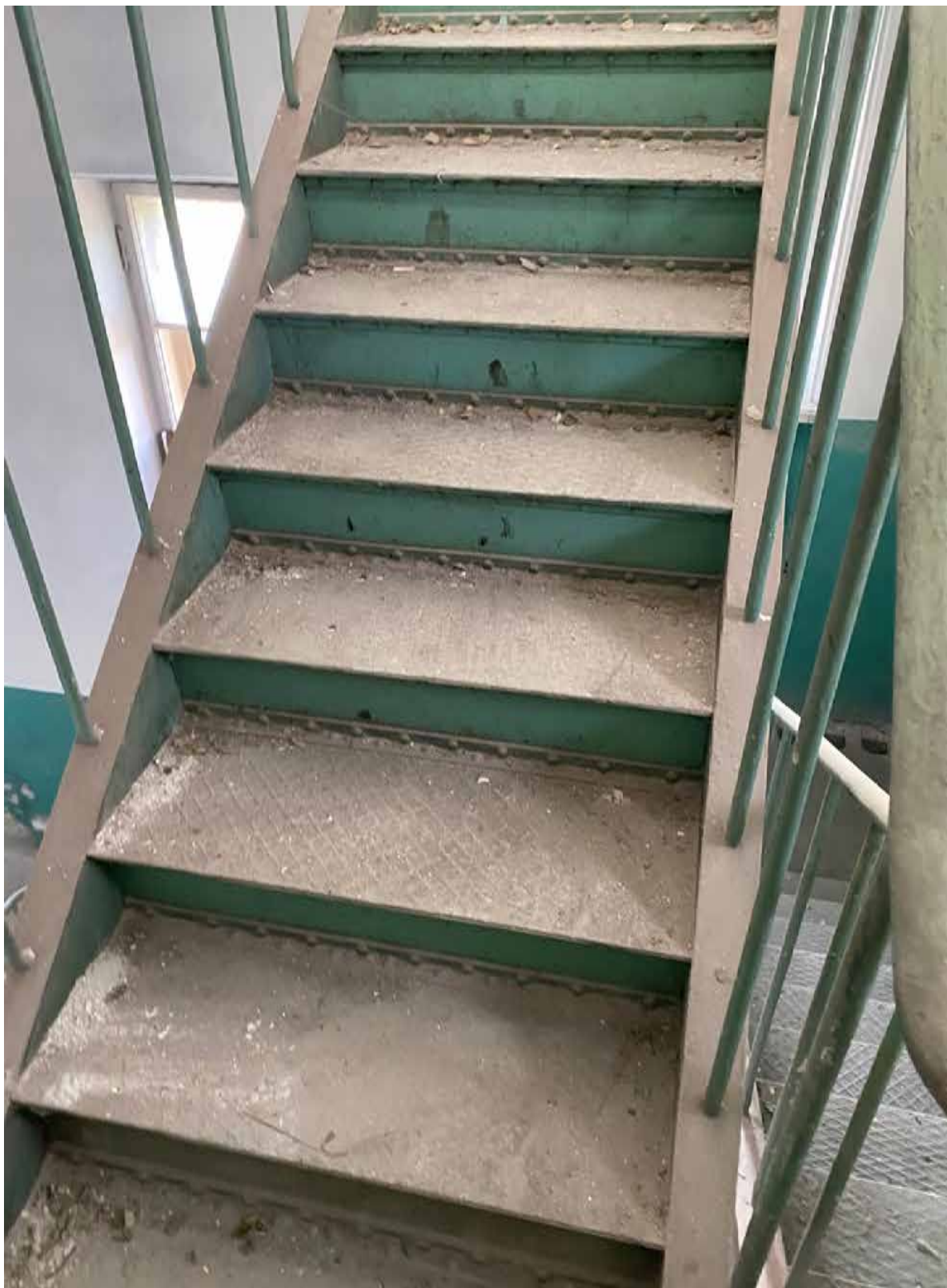
70. Лестница башни объекта культурного наследия – помещение 11Н(1). Автор фото: Штиглиц М.С. Дата: 17.04.2023 г.
