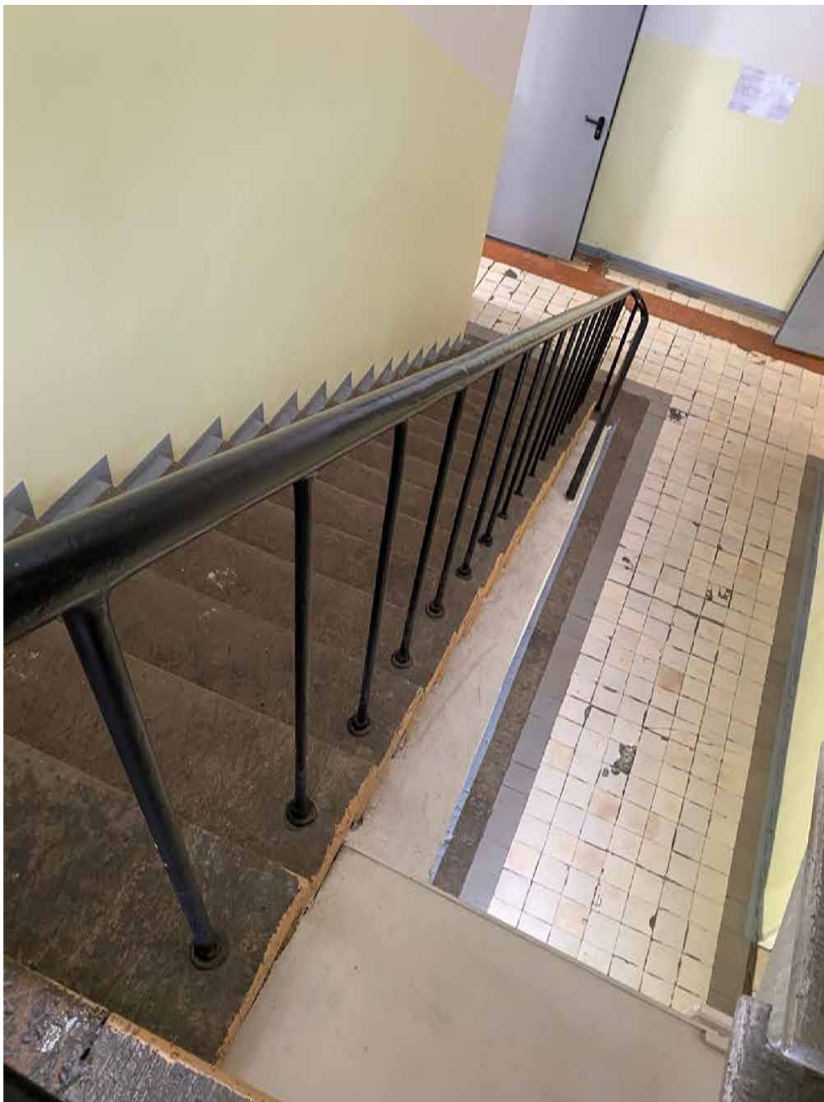
110. Лестница объекта культурного наследия в уровне 1-го этажа. Автор фото: Штиглиц М.С. Дата: 17.04.2023 г.
