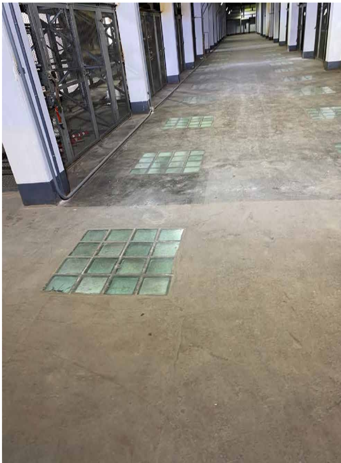
52. Интерьер объекта культурного наследия в уровне 2-го этажа – помещение 8Н(21). Автор фото: Штиглиц М.С. Дата: 17.04.2023 г.
