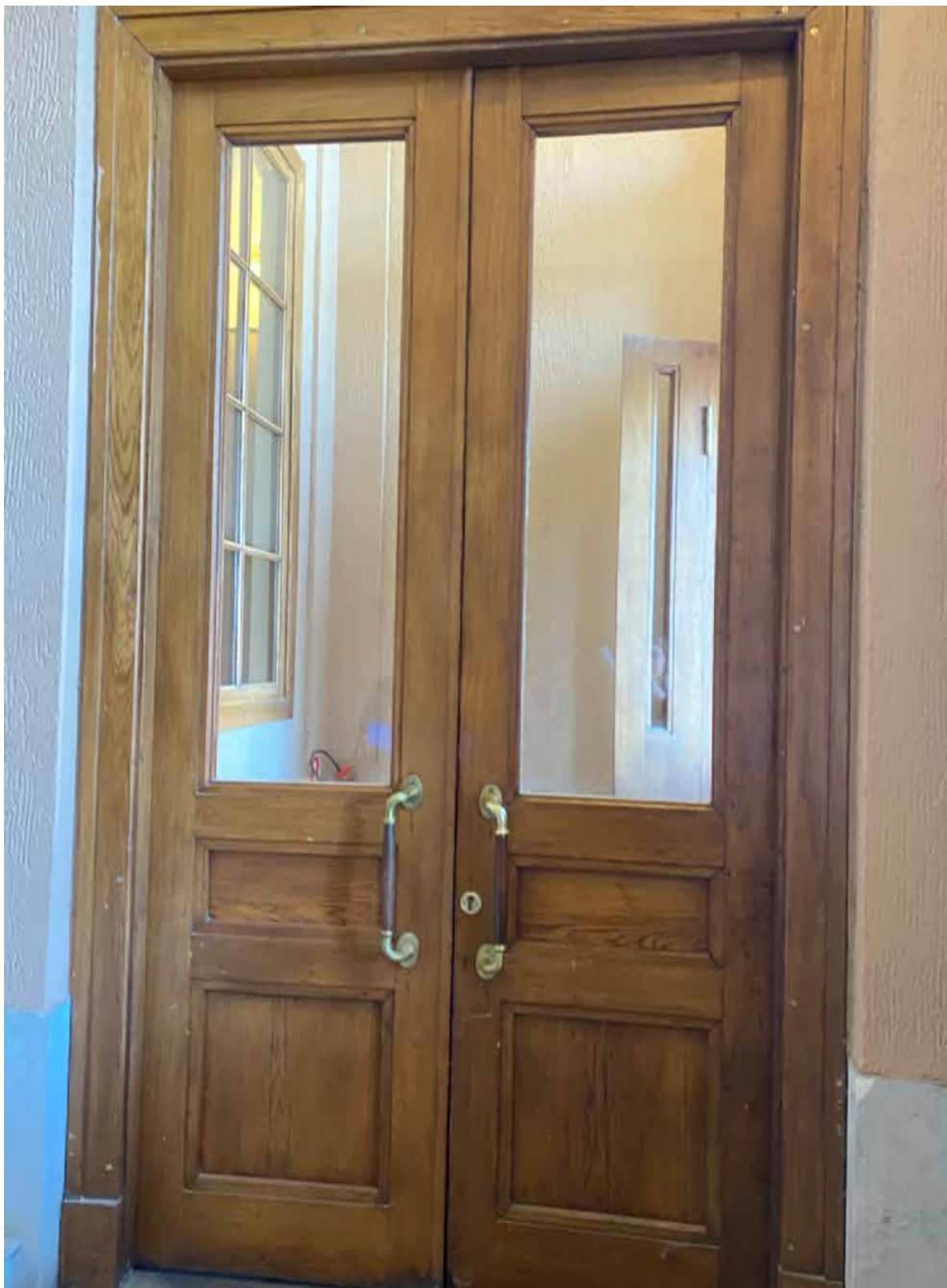
29. Дверное заполнение объекта культурного наследия в уровне 1-го этажа – помещение 4Н(2). Автор фото: Штиглиц М.С. Дата: 17.04.2023 г.
