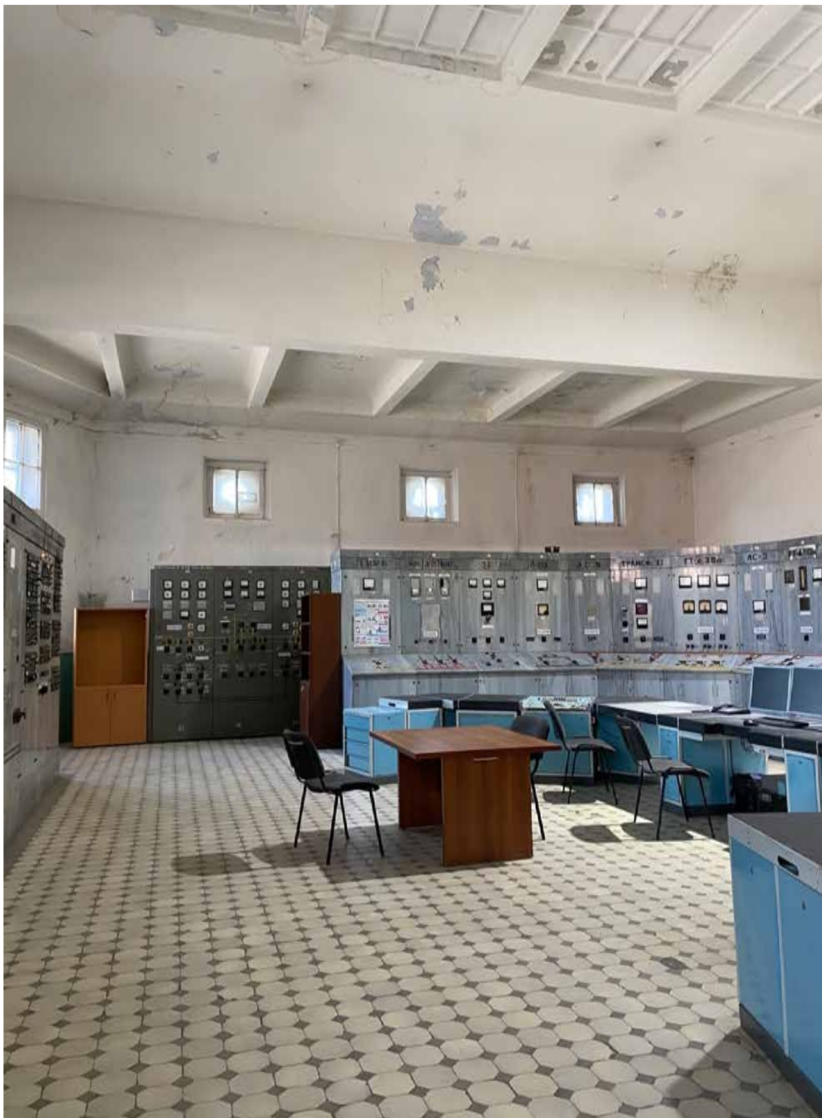
43. Интерьер объекта культурного наследия в уровне 2-го этажа – помещение 8Н(12). Автор фото: Штиглиц М.С. Дата: 17.04.2023 г.
