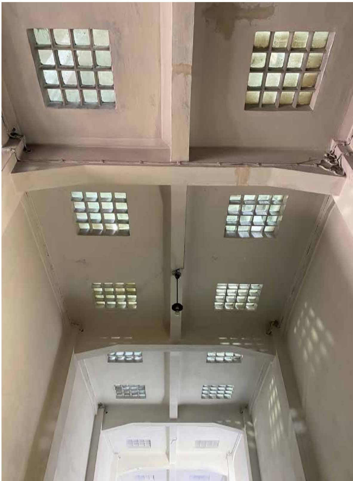
61. Интерьер объекта культурного наследия в уровне 2-го этажа – помещение 4Н(32). Автор фото: Штиглиц М.С. Дата: 17.04.2023 г.
