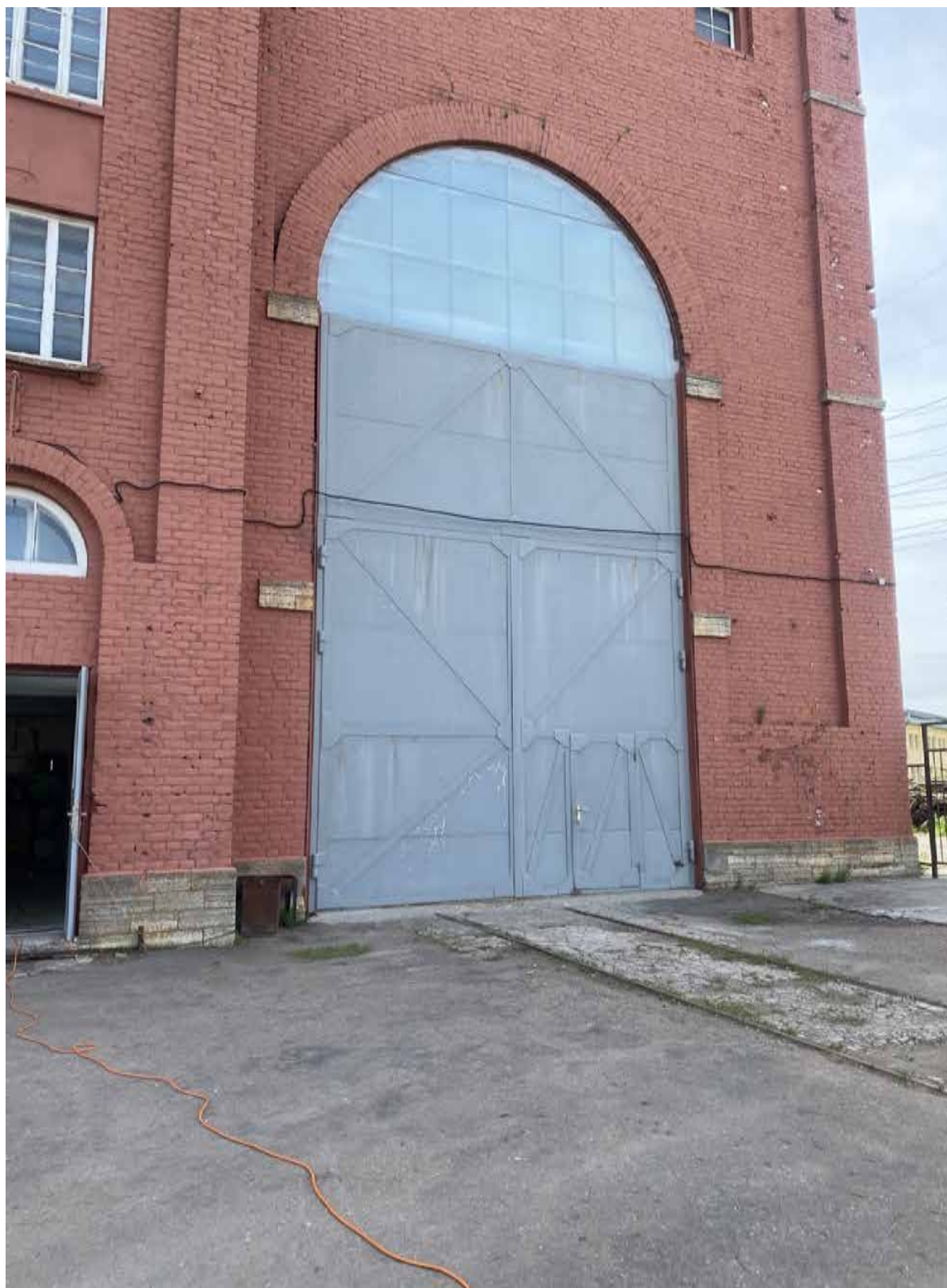
96. Фрагмент торцевого северо-западного фасада объекта культурного наследия. Автор фото: Штиглиц М.С. Дата: 17.04.2023 г.
