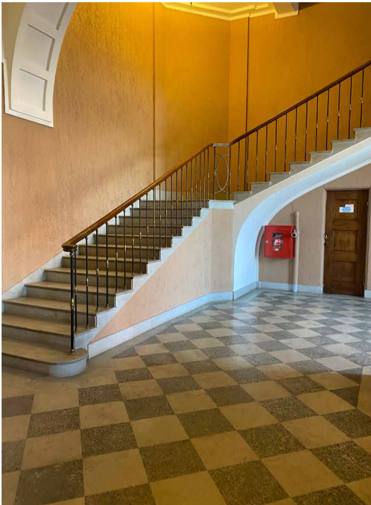
32. Парадная лестница объекта культурного наследия в уровне 1-го этажа – помещение 4Н(2). Автор фото: Штиглиц М.С. Дата: 17.04.2023 г.
