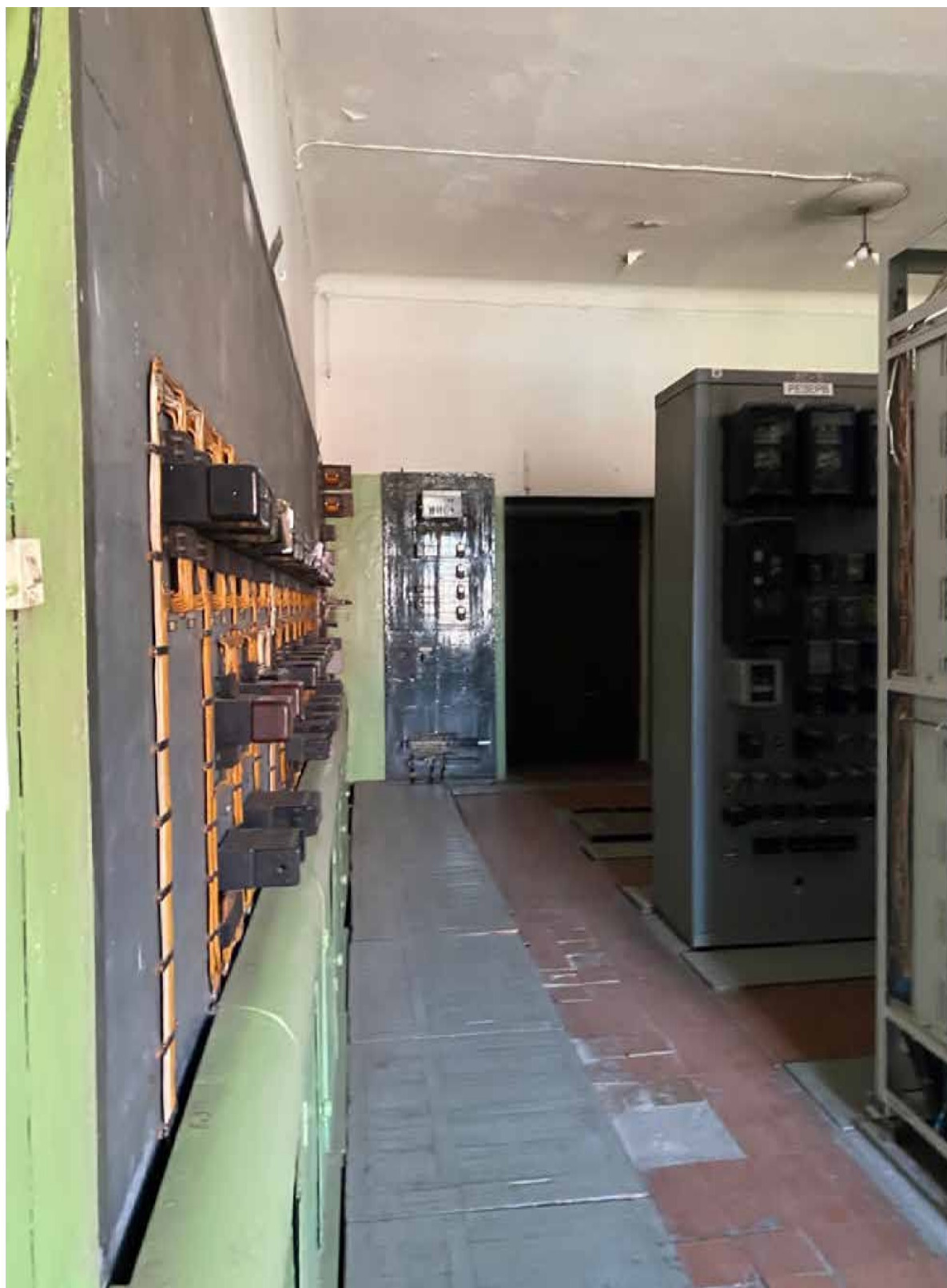
45. Интерьер объекта культурного наследия в уровне 2-го этажа – помещение 8Н(14). Автор фото: Штиглиц М.С. Дата: 17.04.2023 г.
