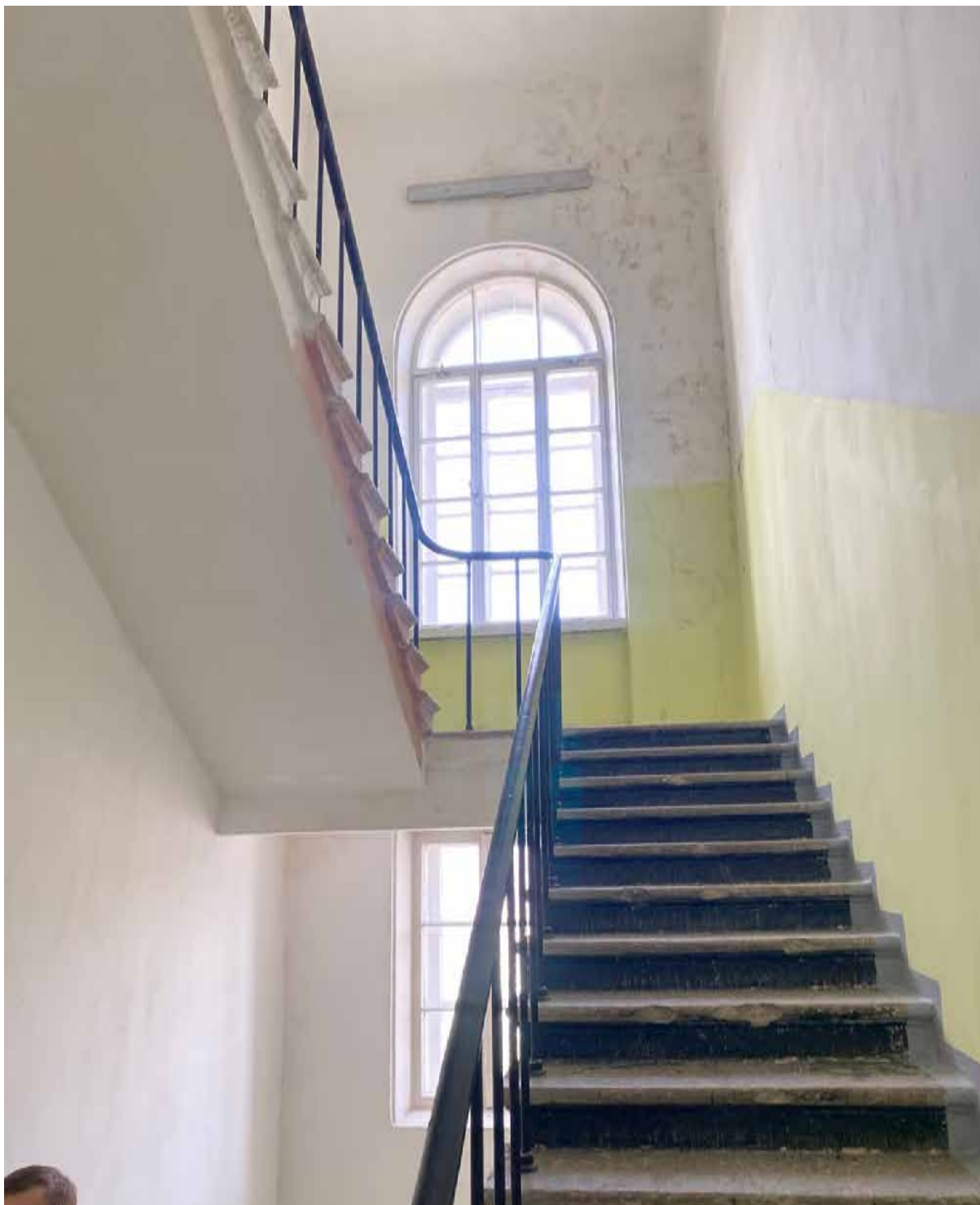
103. Лестница объекта культурного наследия в уровне 2-го этажа. Автор фото: Штиглиц М.С. Дата: 17.04.2023 г.
