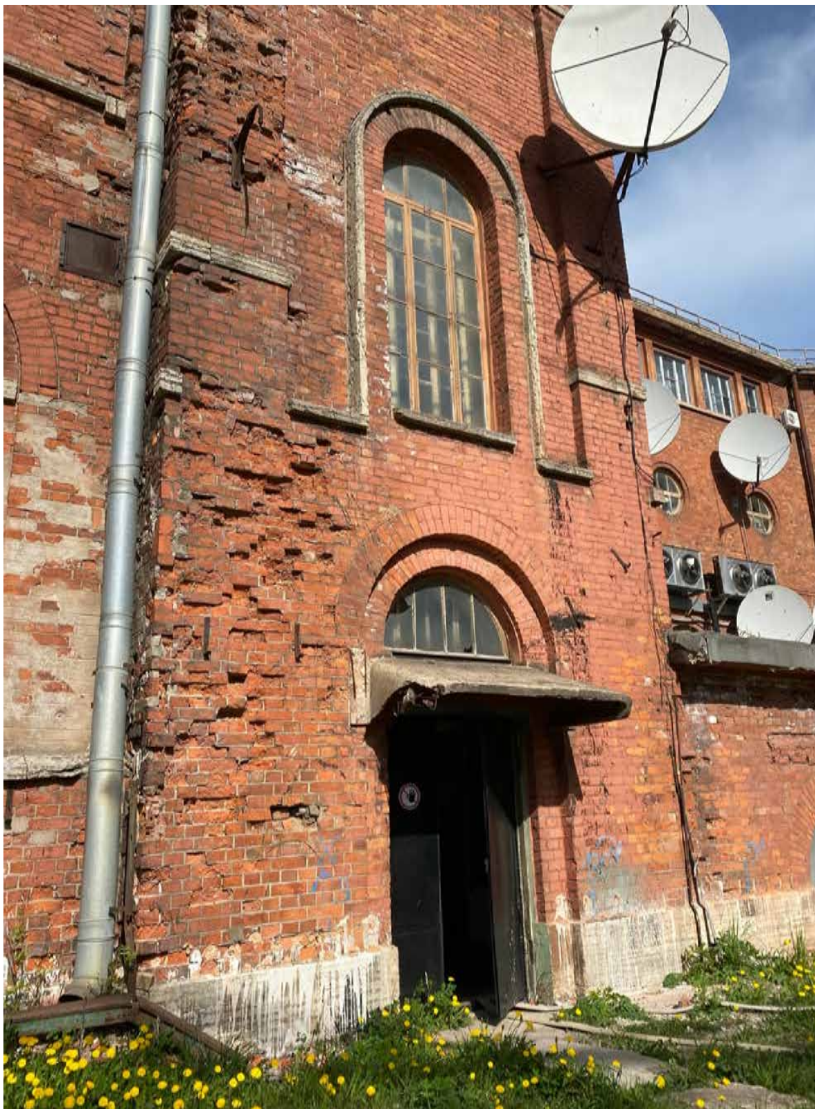
13. Фрагмент западного дворового фасада объекта культурного наследия. Автор фото: Штиглиц М.С. Дата: 17.04.2023 г.
