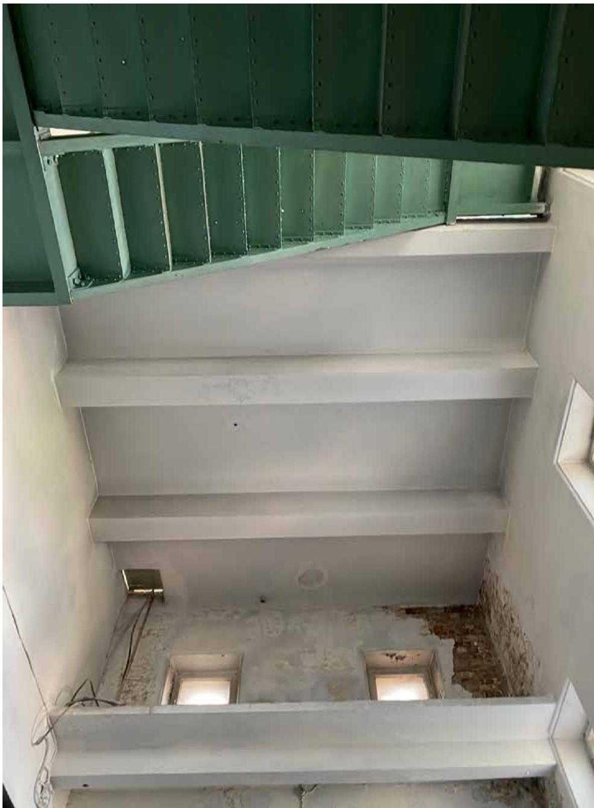
68. Интерьер башни объекта культурного наследия – помещение 11Н(1). Автор фото: Штиглиц М.С. Дата: 17.04.2023 г.
