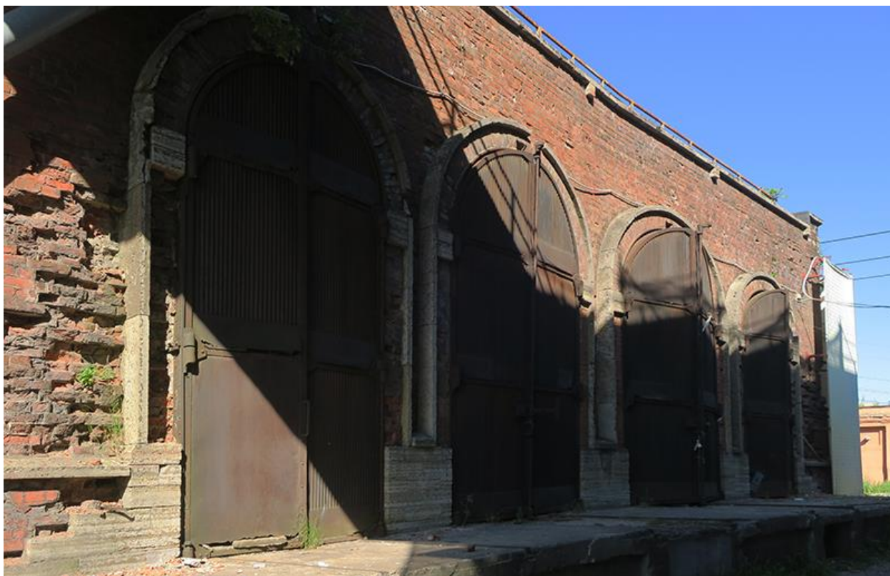
64. Главная понижающая подстанция Волховской ГЭС, 2010 г. [Электронный ресурс]. URL: https://p2.citywalls.ru/photo_509-521474.jpg?mt=1629222108
