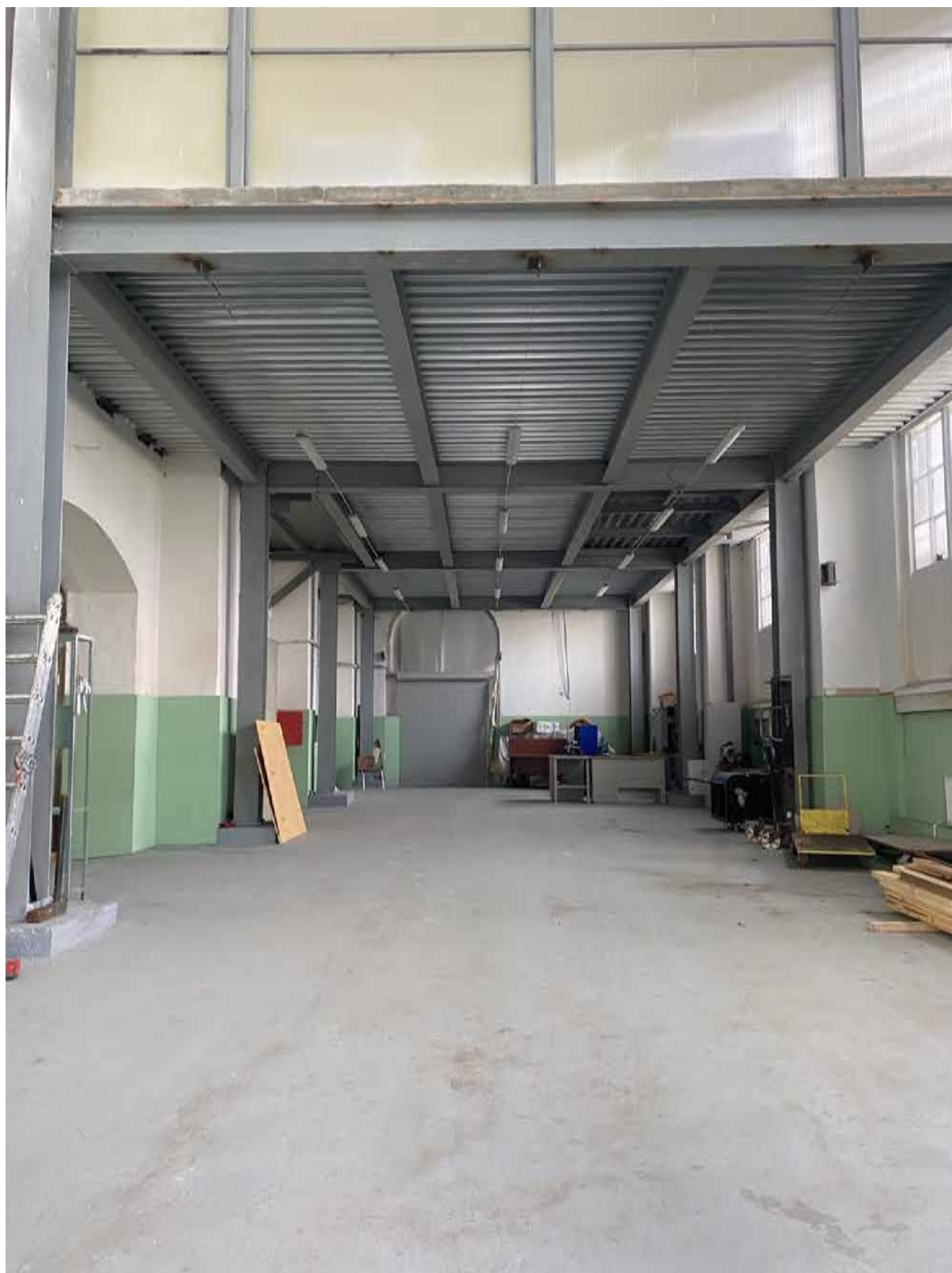
117. Интерьер помещения цеха объекта культурного наследия в уровне 1-го этажа. Автор фото: Штиглиц М.С. Дата: 17.04.2023 г.
