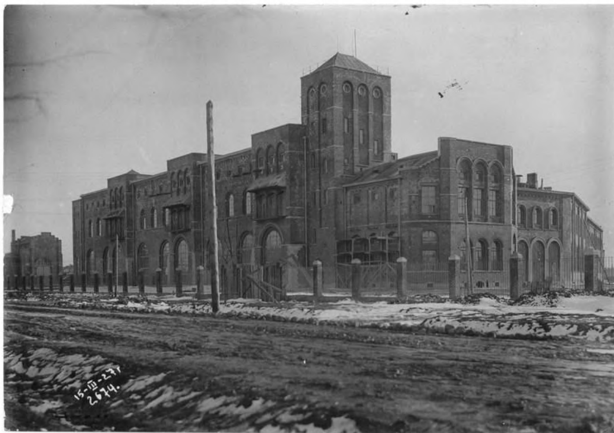
58. Главная подстанция Волховской ГЭС, 1927 г. [Электронный ресурс]. URL: https://pastvu.com/p/570226
