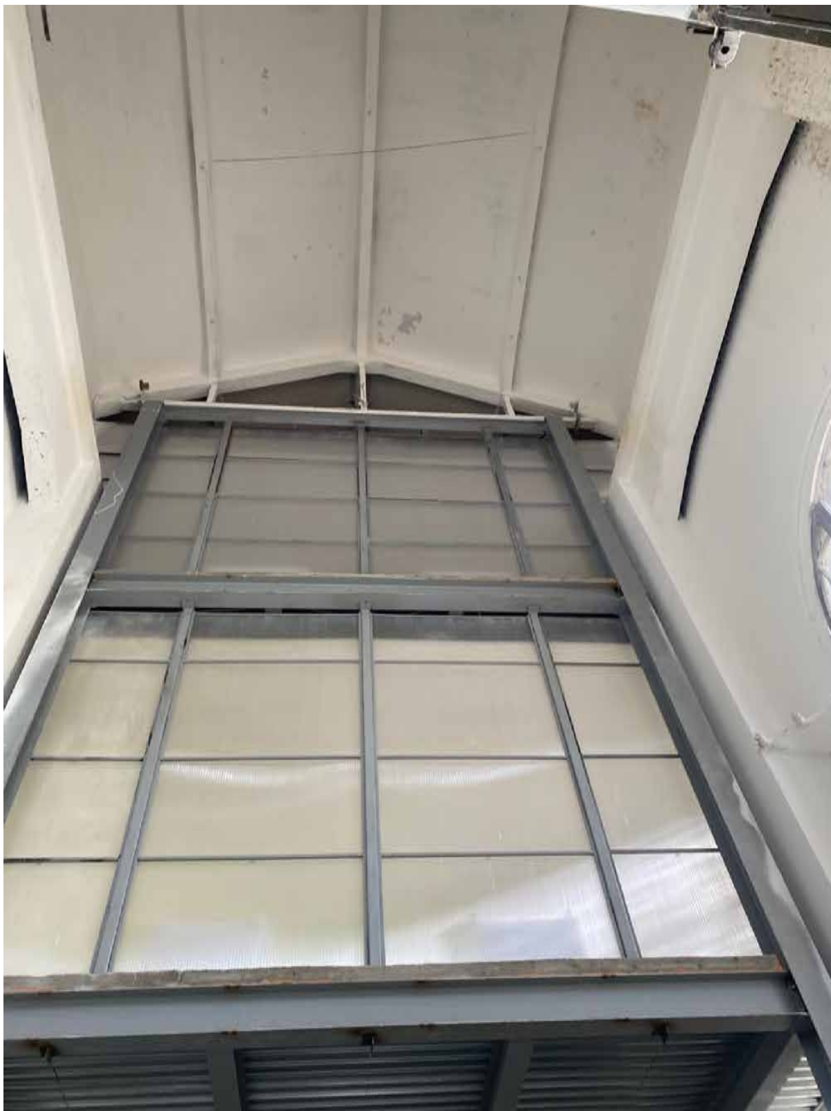
116. Интерьер помещения цеха объекта культурного наследия в уровне 1-го этажа. Автор фото: Штиглиц М.С. Дата: 17.04.2023 г.
