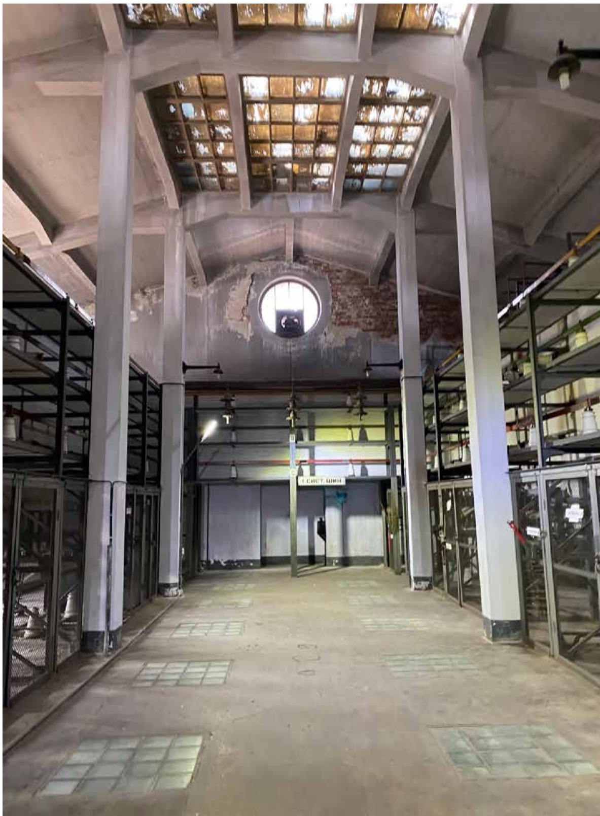
54. Интерьер объекта культурного наследия в уровне 2-го этажа – помещение 8Н(21). Автор фото: Штиглиц М.С. Дата: 17.04.2023 г.
