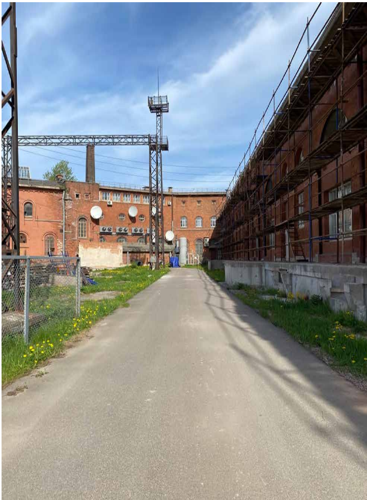
19. Фрагмент западного и юго-восточного дворовых фасадов объекта культурного наследия. Автор фото: Штиглиц М.С. Дата: 17.04.2023 г.
