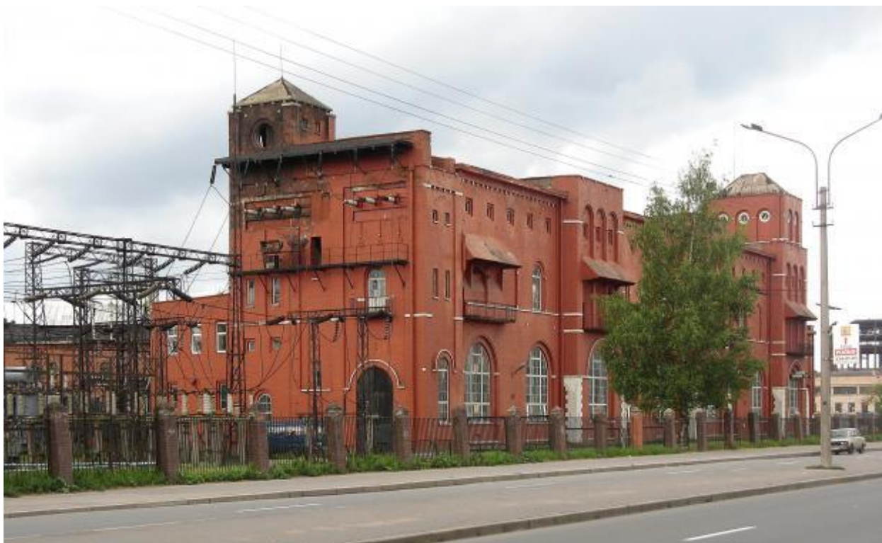
62. Главная понижающая подстанция Волховской ГЭС, 2010 г. [Электронный ресурс]. URL: https://p0.citywalls.ru/photo_53-54748.jpg?mt=1284832618
