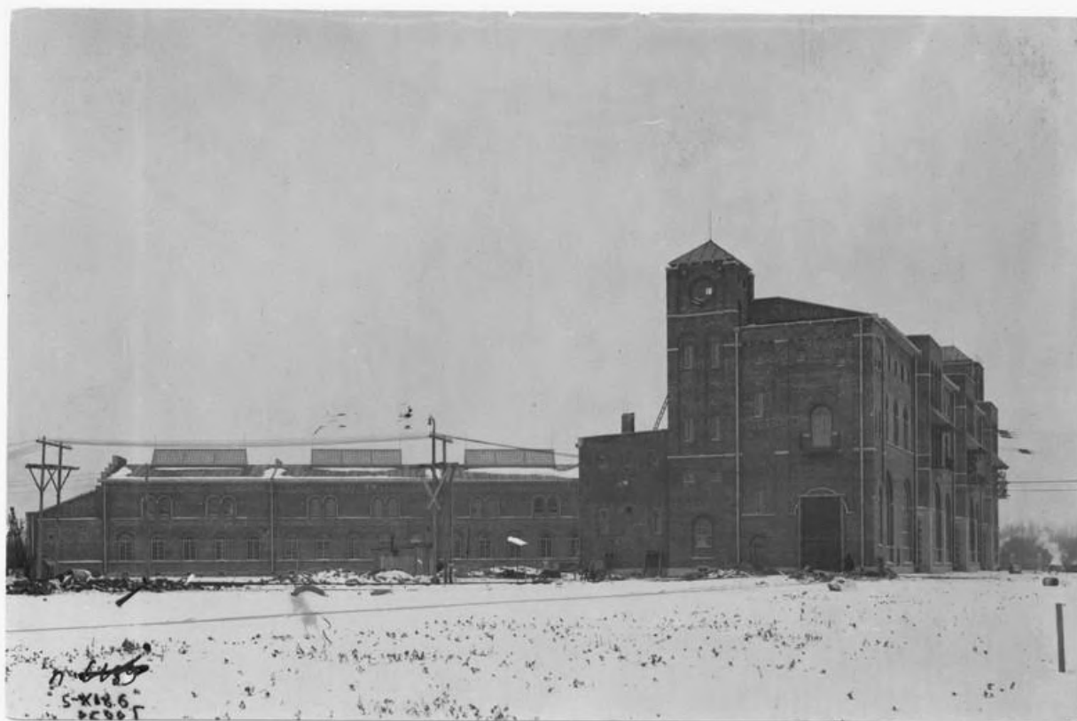
59. Главная подстанция Волховской ГЭС, 1927 г. [Электронный ресурс]. URL: https://pastvu.com/p/570210
