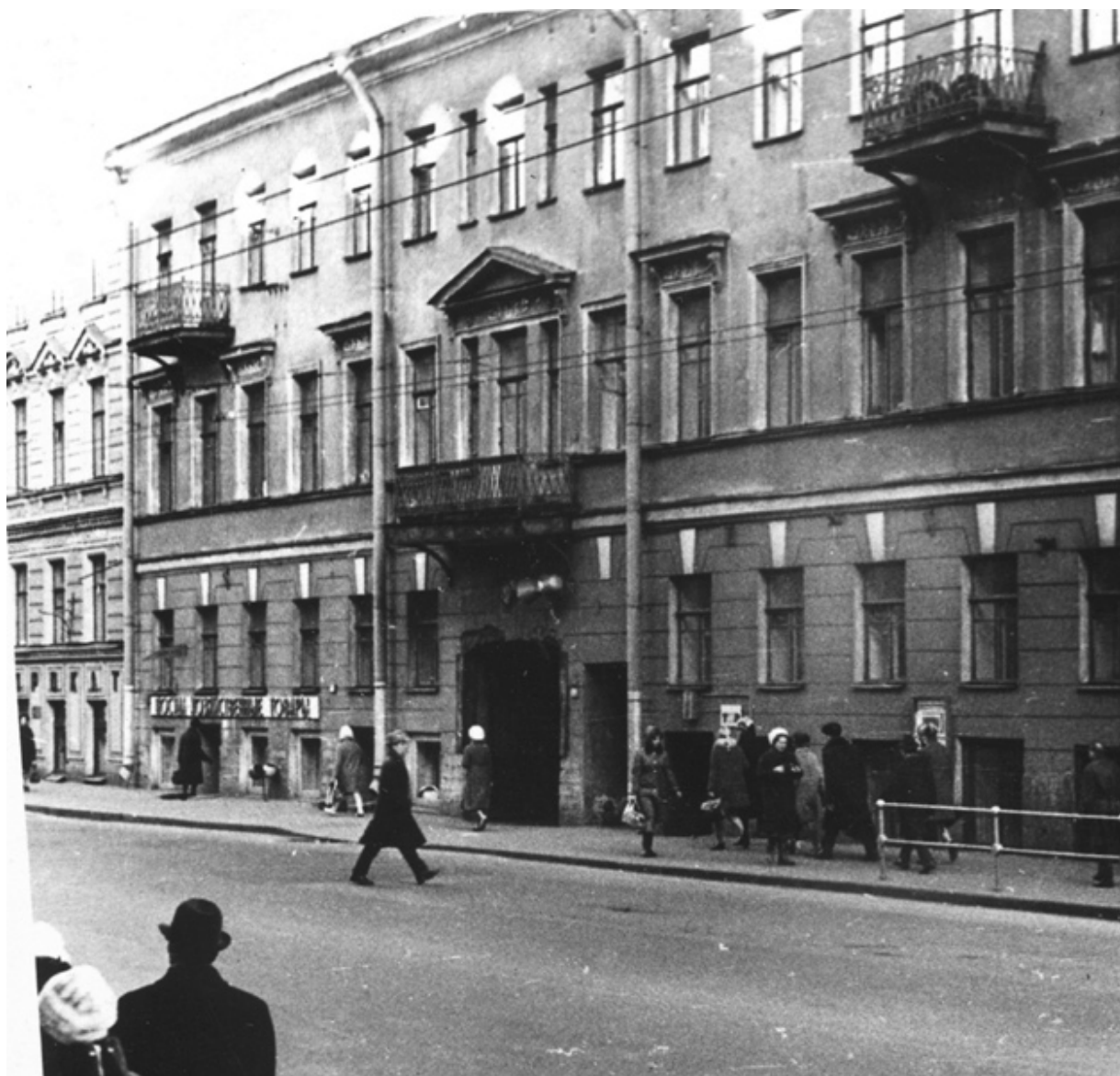
13. Фасад дома Загородный пр. 36. Дата съемки: 1968-1975 гг. Автор съемки неизвестен. Направление съемки: восток. // https://pastvu.com/p/476251
