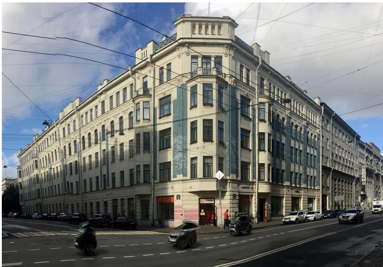
1. Выявленный объект культурного наследия «Дом Санкт-Петербургского мещанского общества», расположенный по адресу: г. Санкт-Петербург, Центральный район, Загородный пр-т, д. 31 (Бородинская ул., д. 12). Вид лицевого фасада с перекрестка пр. Загородного и ул. Бородинской. 12.08.2020
