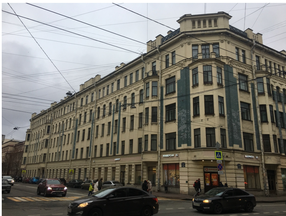
2. Выявленный объект культурного наследия «Дом Санкт-Петербургского мещанского общества», расположенный по адресу: г. Санкт-Петербург, Центральный район, Загородный пр-т, д. 31 (Бородинская ул., д. 12). Вид ул. Бородинской от пр. Загородного. Фото 10.11.2020
