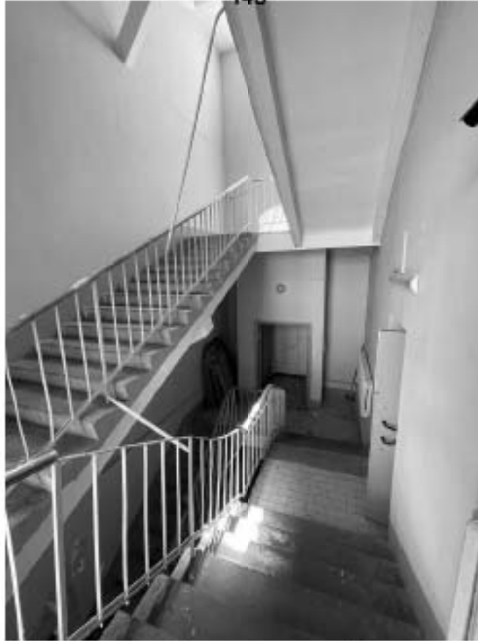
25. Здание по адресу: Санкт-Петербург, Моховая улица, д. 10, строение 1. Черная лестница в уровне первого этажа. Пом. МОП 1
