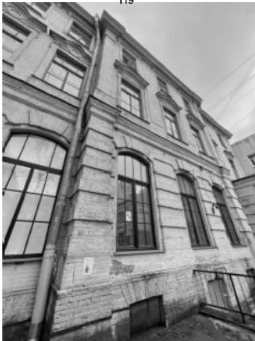
14. Здание по адресу: Санкт-Петербург, Моховая улица, д. 10, строение 1. Фрагмент дворового фасада
