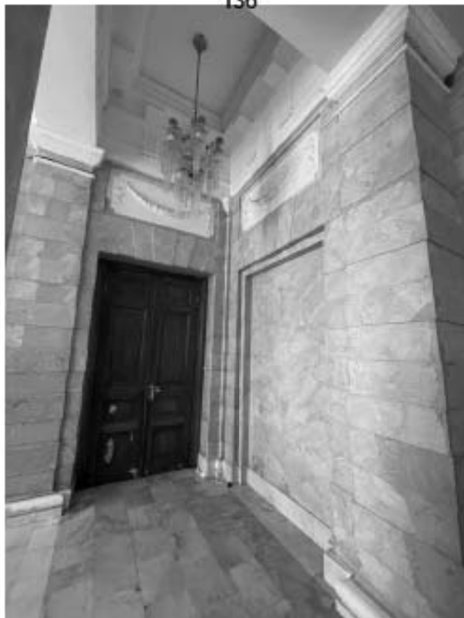
17. Здание по адресу: Санкт-Петербург, Моховая улица, д. 10, строение 1. Вид вестибюля. Пом. МОП 1
