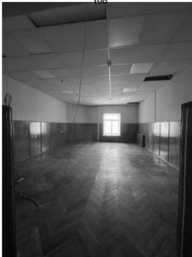
70. Здание по адресу: Санкт-Петербург, Моховая улица, д. 10, строение 1. Пом. 44-Н
