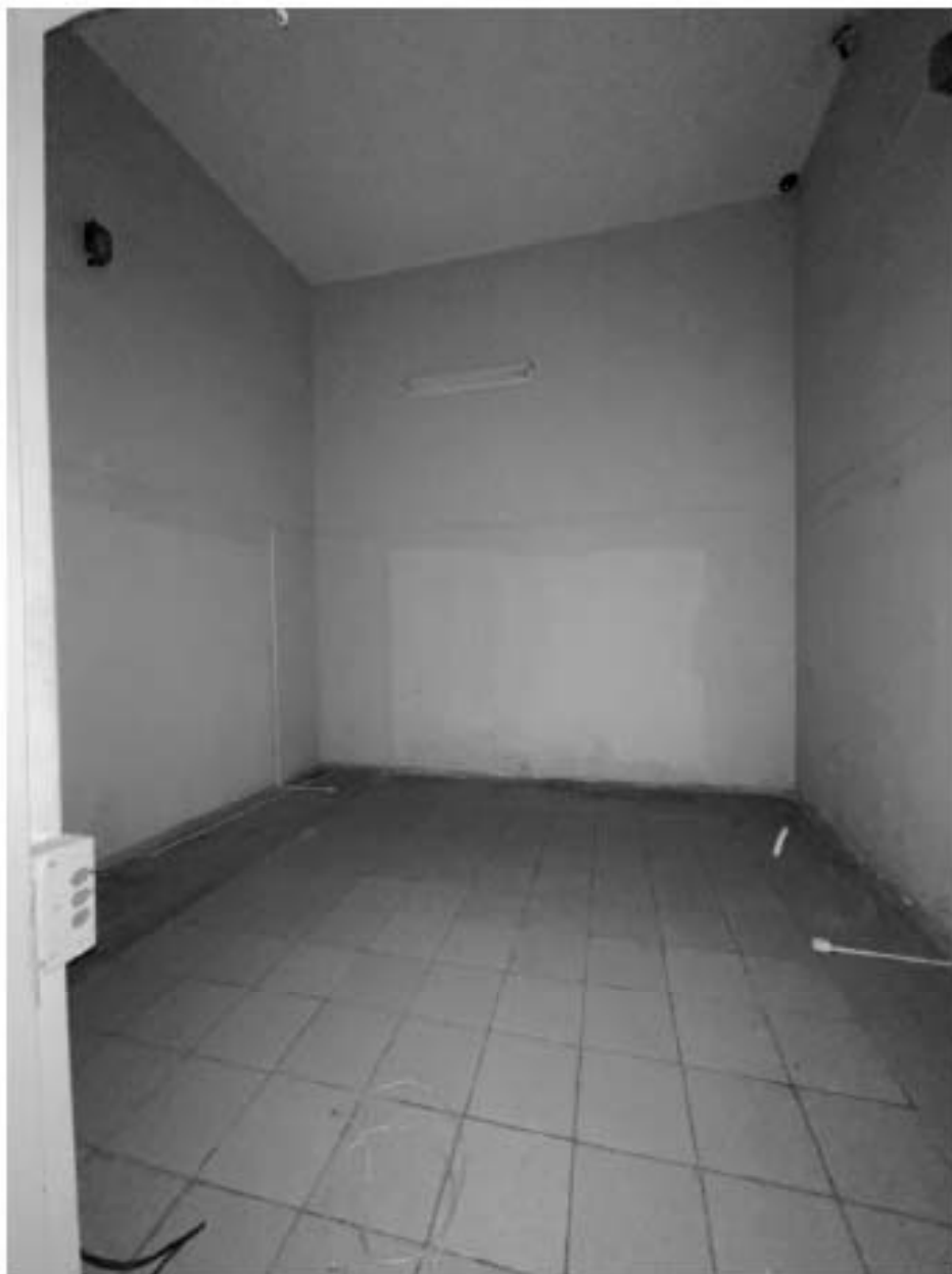
36. Здание по адресу: Санкт-Петербург, Моховая улица, д. 10, строение 1. Пом. 17-Н
