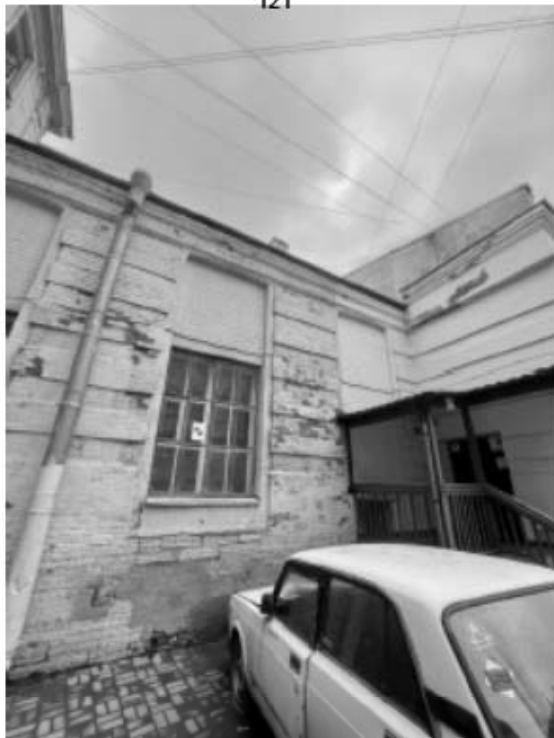
17. Здание по адресу: Санкт-Петербург, Моховая улица, д. 10, строение 1. Фрагмент одноэтажной пристройки
