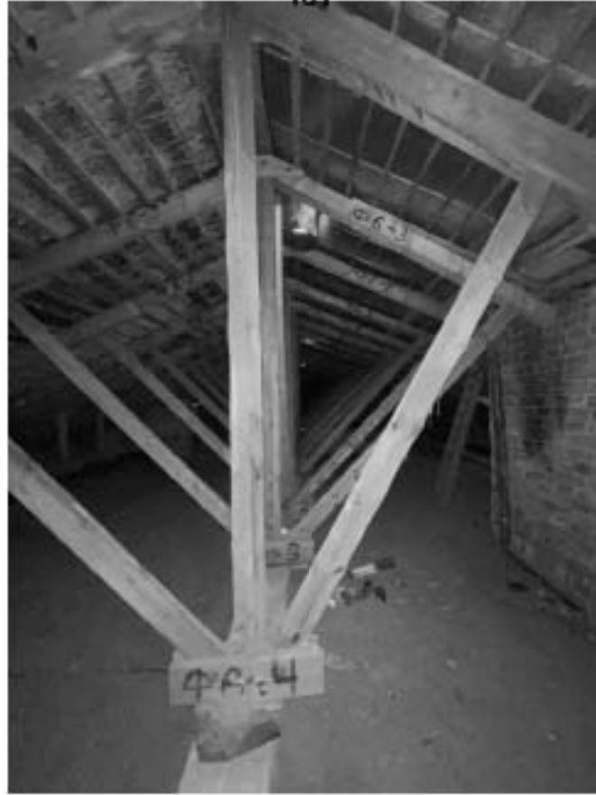
91. Здание по адресу: Санкт-Петербург, Моховая улица, д. 10, строение 1. Чердак
