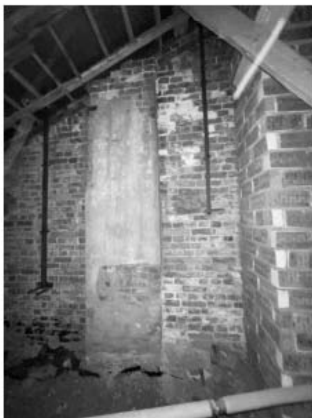
96. Здание по адресу: Санкт-Петербург, Моховая улица, д. 10, строение 1. Чердак
