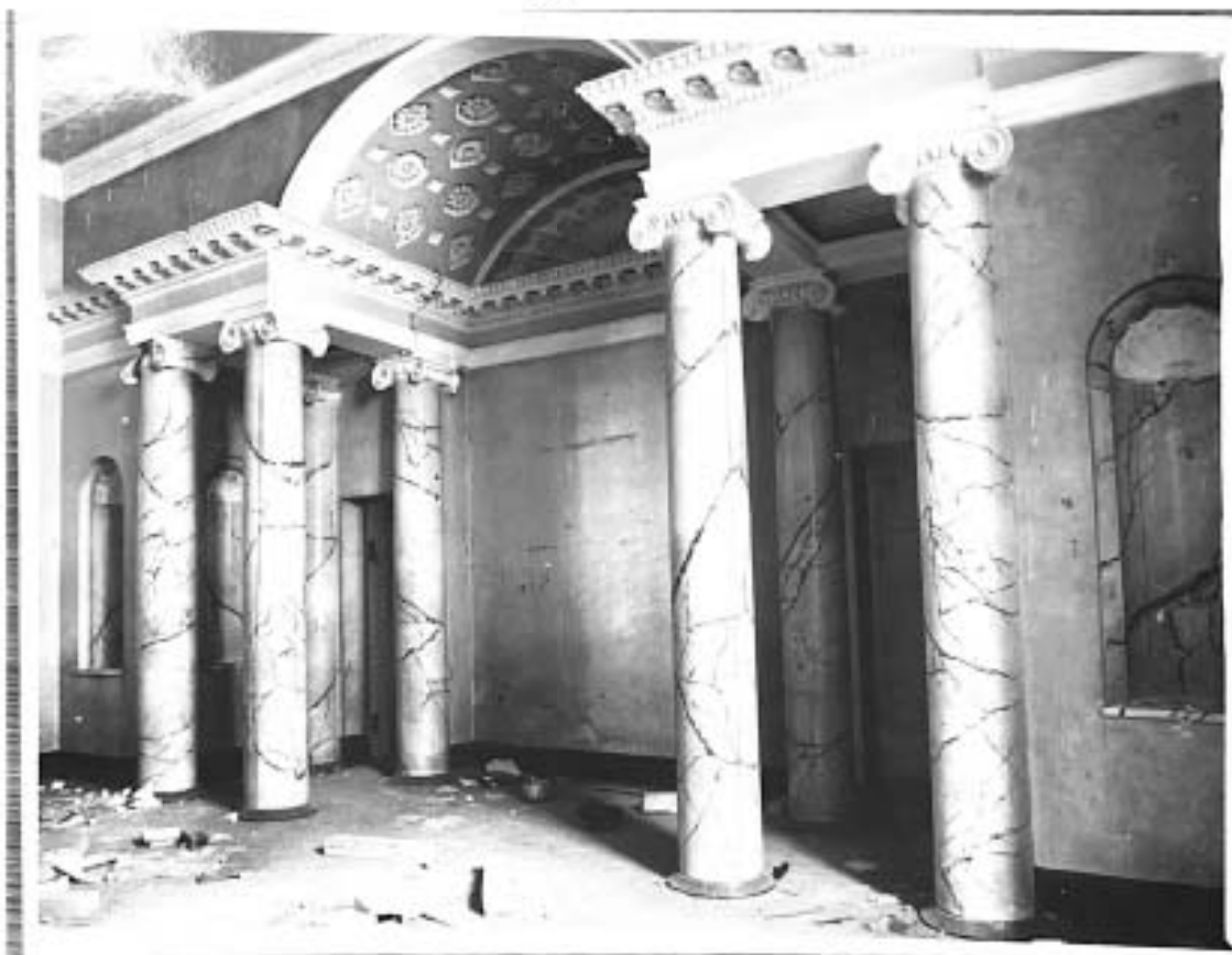
48. Лицевой флигель, главный фасад, 1 этаж, пом. №3, южная стена.
