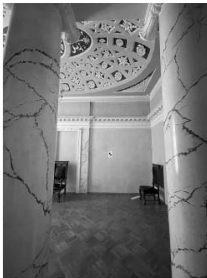
28. Здание по адресу: Санкт-Петербург, Моховая улица, д. 10, строение 1. Пом. 52-Н
