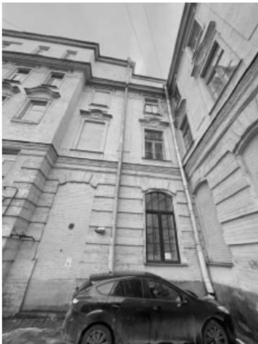
13. Здание по адресу: Санкт-Петербург, Моховая улица, д. 10, строение 1. Фрагмент южного фасада
