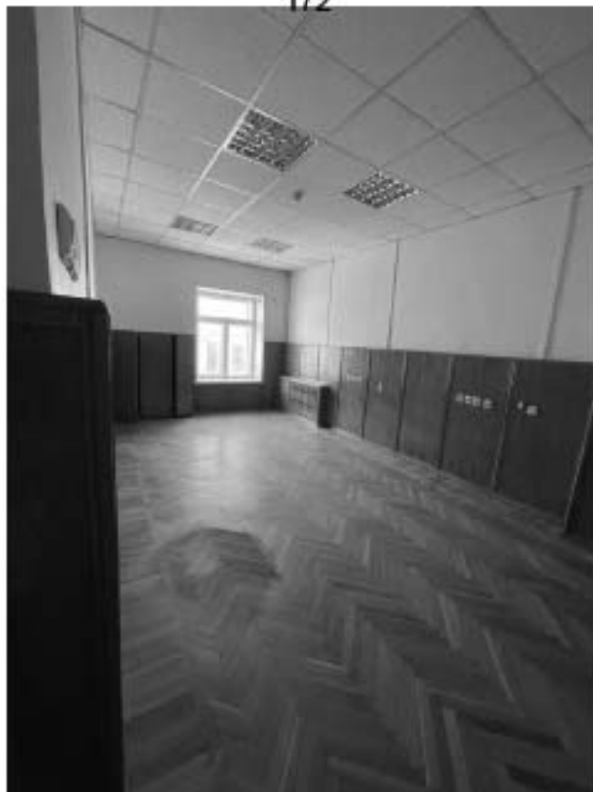
78. Здание по адресу: Санкт-Петербург, Моховая улица, д. 10, строение 1. Пом. 41-Н
