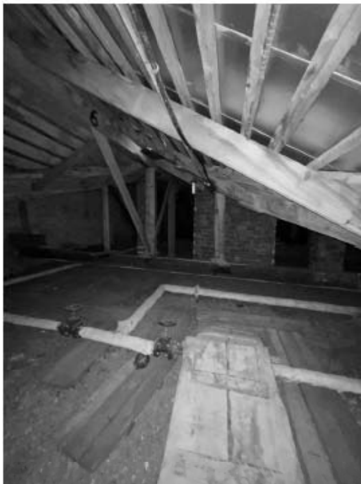
88. Здание по адресу: Санкт-Петербург, Моховая улица, д. 10, строение 1. Чердак
