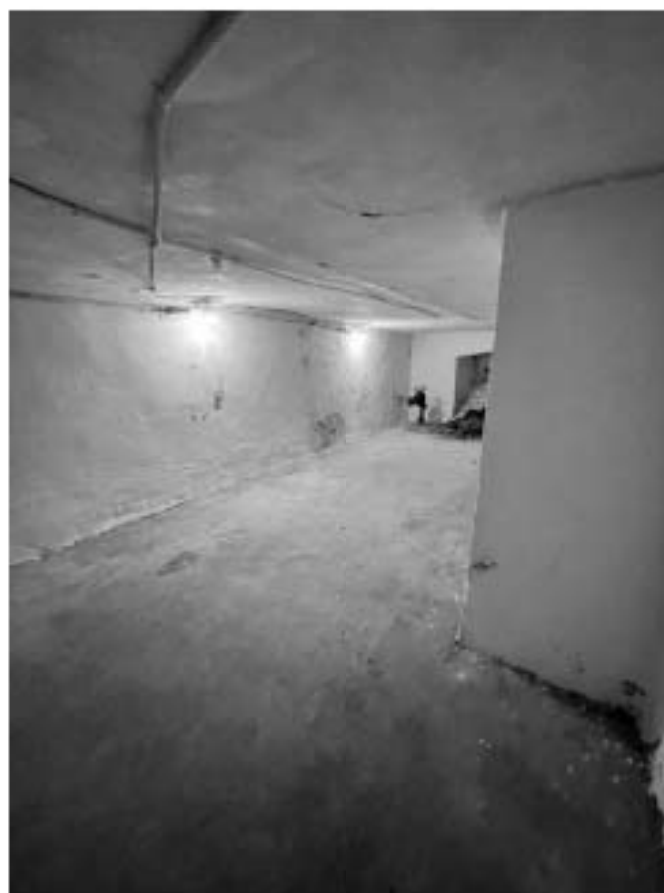
10. Здание по адресу: Санкт-Петербург, Моховая улица, д. 10, строение 1. Подвал (технический этаж). Помещение 1-Н
