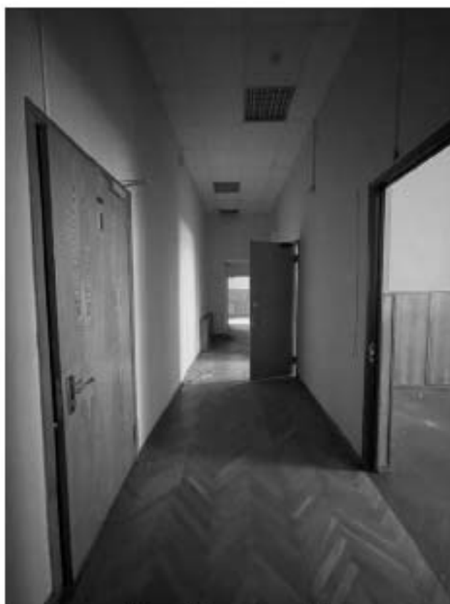
44. Здание по адресу: Санкт-Петербург, Моховая улица, д. 10, строение 1. Второй этаж. Пом. МОП 1
