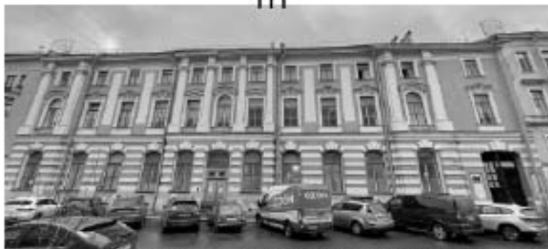
1. Здание по адресу: Санкт-Петербург, Моховая улица, д. 10, строение 1. Общий вид лицевого фасада
