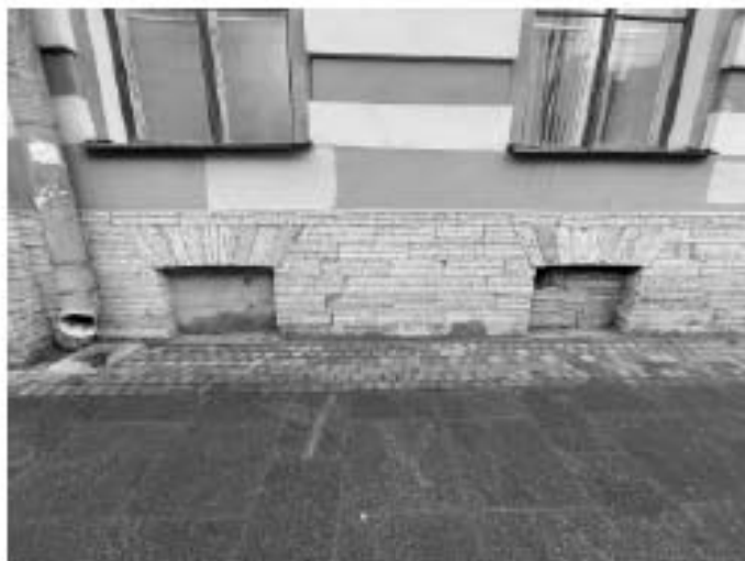
6. Здание по адресу: Санкт-Петербург, Моховая улица, д. 10, строение 1. Фрагмент цоколя лицевого фасада
