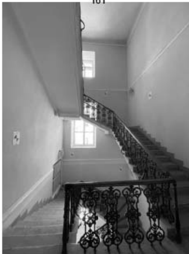
60. Здание по адресу: Санкт-Петербург, Моховая улица, д. 10, строение 1. Межлестничное пространство в уровне второго этажа. Пом. МОП 1
