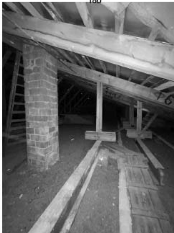
89. Здание по адресу: Санкт-Петербург, Моховая улица, д. 10, строение 1. Чердак
