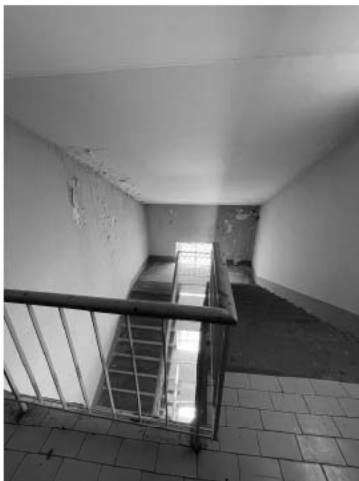
99. Здание по адресу: Санкт-Петербург, Моховая улица, д. 10, строение 1. Чердак
