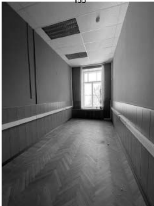
50. Здание по адресу: Санкт-Петербург, Моховая улица, д. 10, строение 1. Пом. 32-Н
