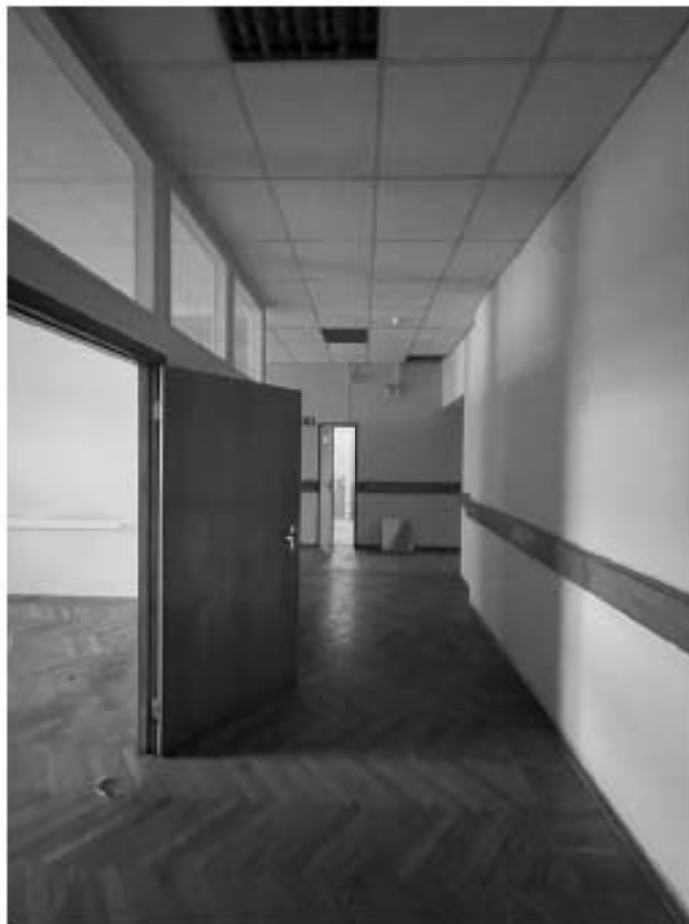
75. Здание по адресу: Санкт-Петербург, Моховая улица, д. 10, строение 1. Коридор 3 этажа. Пом. МОП 1
