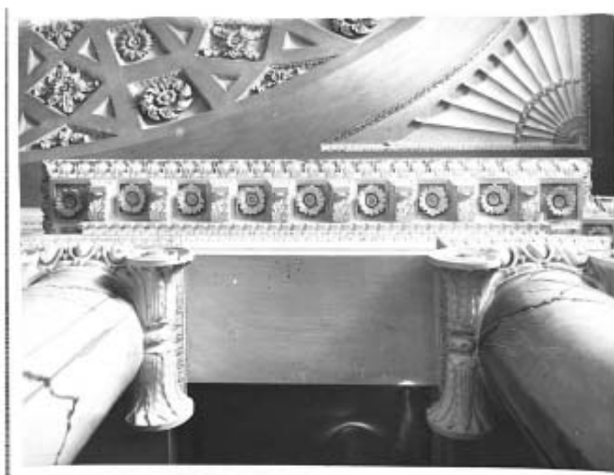
53. Лицевой флигель, главный фасад, 1 этаж, пом. №3, южная стена, фрагмент плафона, правая часть. Фотофиксация интерьеров до реставрации. 1990–1991. ЦГАНТД СПб. Фонд Р-488. Опись 314. Дело 162. Л. 7/14
