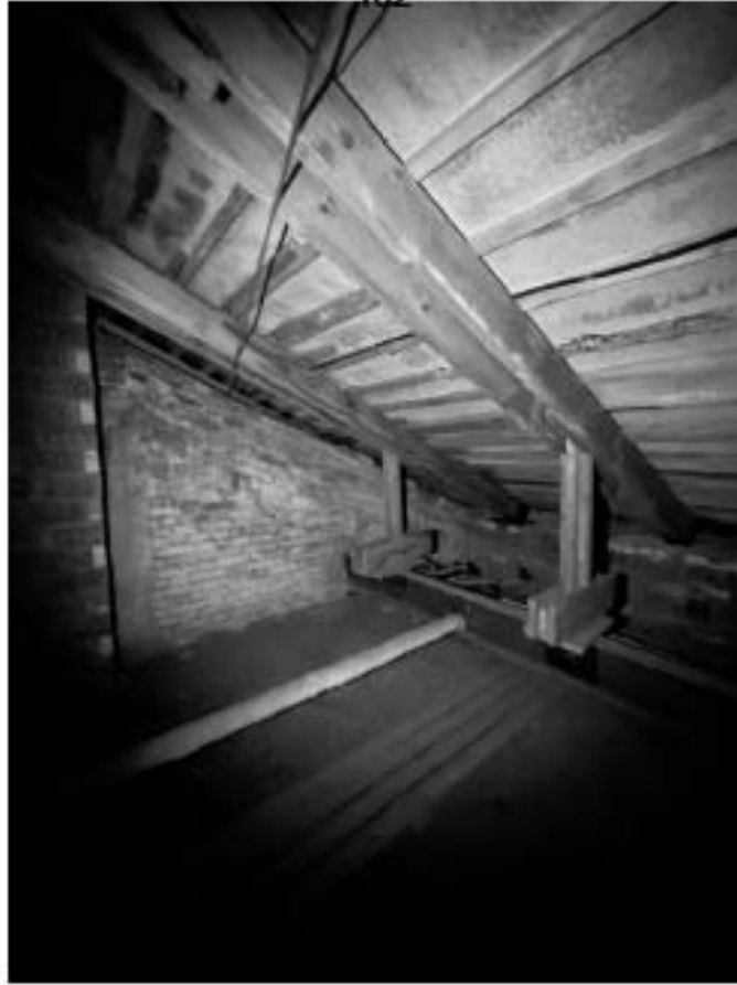
93. Здание по адресу: Санкт-Петербург, Моховая улица, д. 10, строение 1. Чердак
