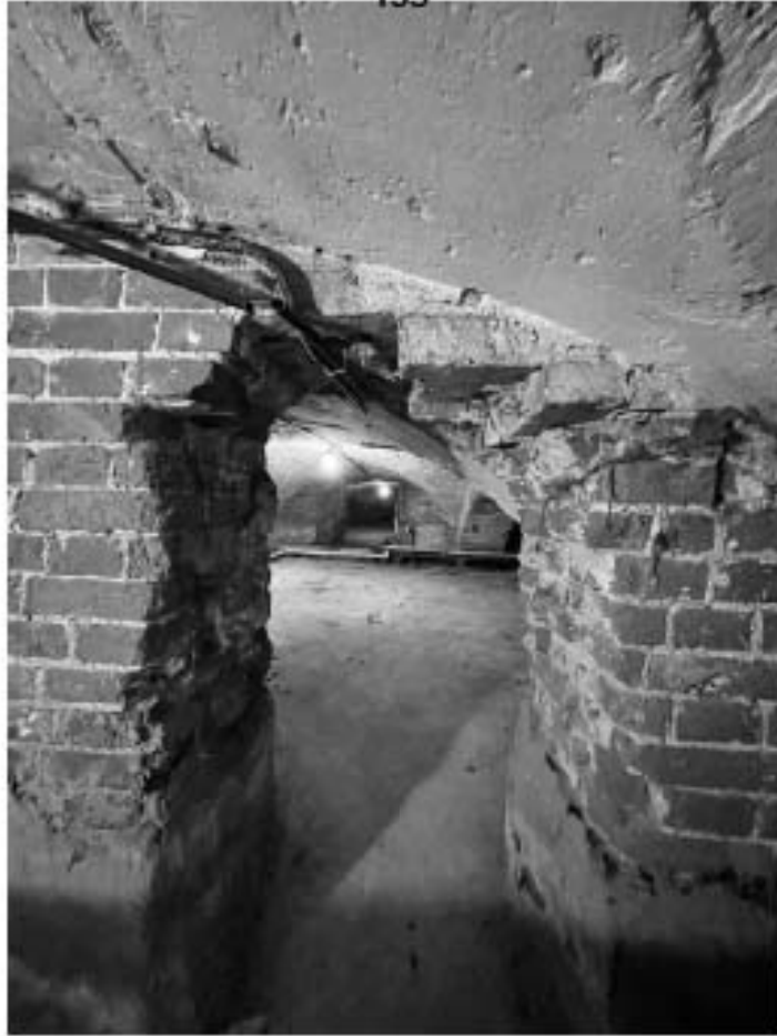
13. Здание по адресу: Санкт-Петербург, Моховая улица, д. 10, строение 1. Подвал (технический этаж). Помещение 1-Н
