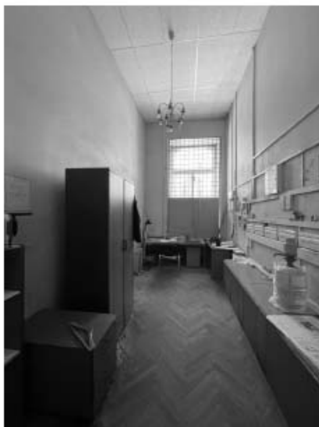
20. Здание по адресу: Санкт-Петербург, Моховая улица, д. 10, строение 1. Пом. 16-Н
