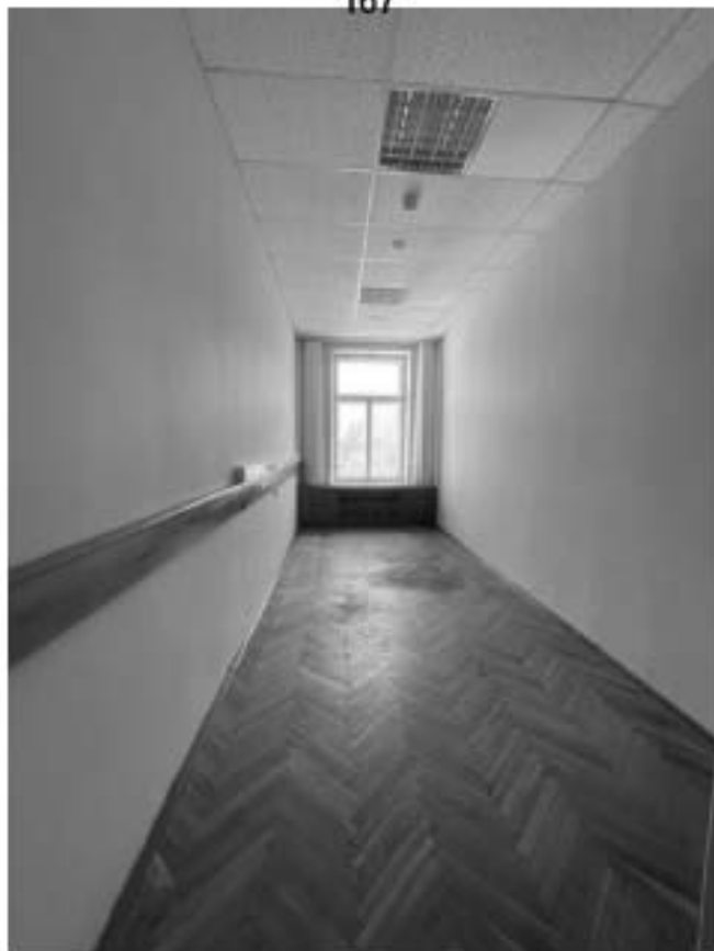
68. Здание по адресу: Санкт-Петербург, Моховая улица, д. 10, строение 1. Пом. 46-Н
