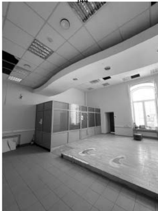
33. Здание по адресу: Санкт-Петербург, Моховая улица, д. 10, строение 1. Пом.19-Н
