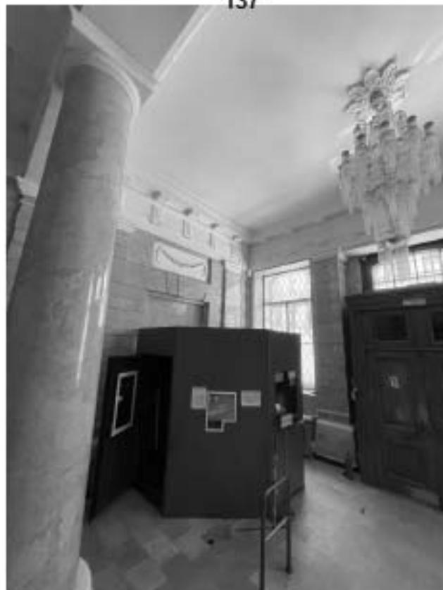
19. Здание по адресу: Санкт-Петербург, Моховая улица, д. 10, строение 1. Вид вестибюля. Пом. МОП 1
