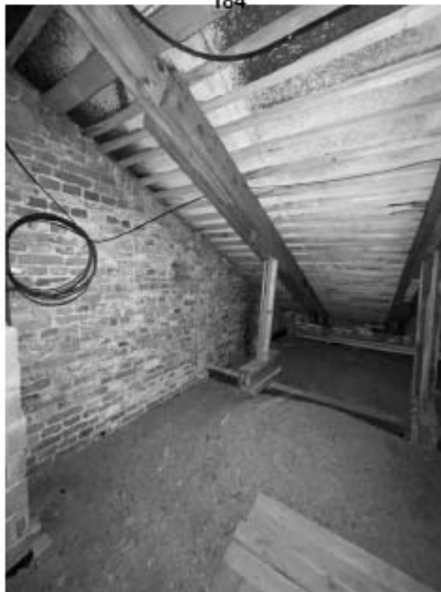
97. Здание по адресу: Санкт-Петербург, Моховая улица, д. 10, строение 1. Чердак
