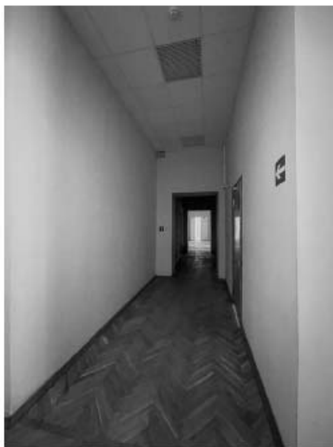
40. Здание по адресу: Санкт-Петербург, Моховая улица, д. 10, строение 1. Коридор второго этажа. Пом. МОП 1
