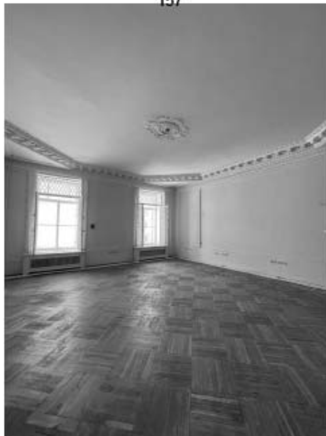
54. Здание по адресу: Санкт-Петербург, Моховая улица, д. 10, строение 1. Помещение с лепными элементами отделки на втором этаже. Фрагмент. Пом. 30-Н
