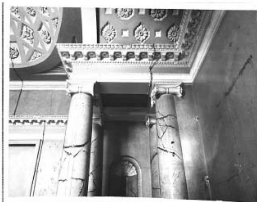
52. Лицевой флигель, главный фасад, 1 этаж, пом. №3, восточная стена, фрагмент ордера и плафона. Фотофиксация интерьеров до реставрации. 1990–1991. ЦГАНТД СПб. Фонд Р-488. Опись 314. Дело 162. Л.5/14
