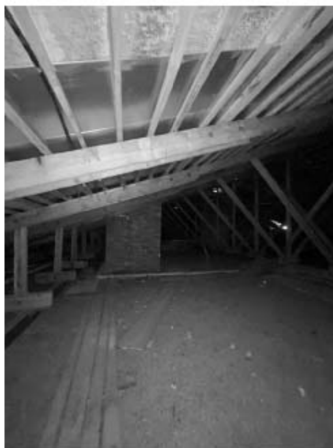
98. Здание по адресу: Санкт-Петербург, Моховая улица, д. 10, строение 1. Чердак
