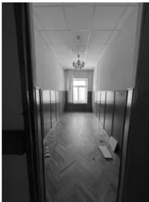
77. Здание по адресу: Санкт-Петербург, Моховая улица, д. 10, строение 1. Пом. 40-Н
