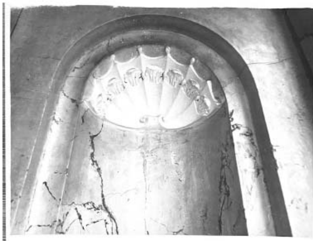
55. Лицевой флигель, главный фасад, 1 этаж, пом. №3, южная стена, ниша у окна. Фотофиксация интерьеров дореставрации. 1990–1991. ЦГАНТД СПб. Фонд Р-488. Опись 314. Дело 162. Л. 9/14
