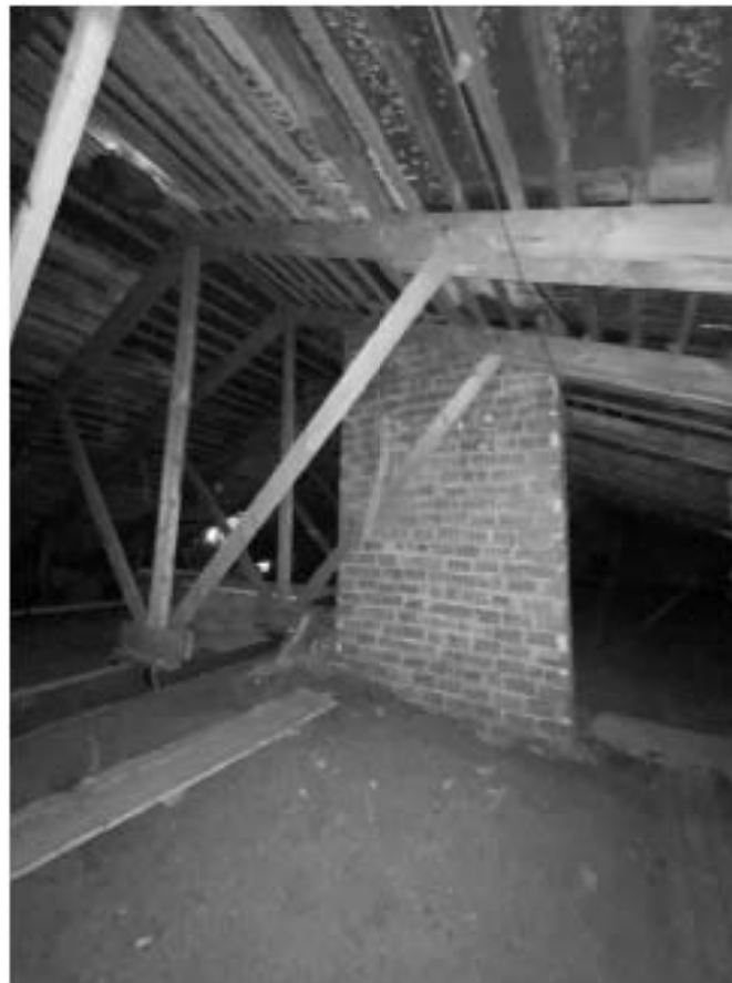
94. Здание по адресу: Санкт-Петербург, Моховая улица, д. 10, строение 1. Чердак
