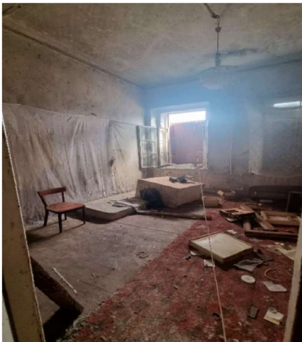
31. Выявленный объект культурного наследия «Казарма Офицерской стрелковой школы» по адресу: Санкт-Петербург, г. Ломоносов, Владимирская ул., д.12, литера А
