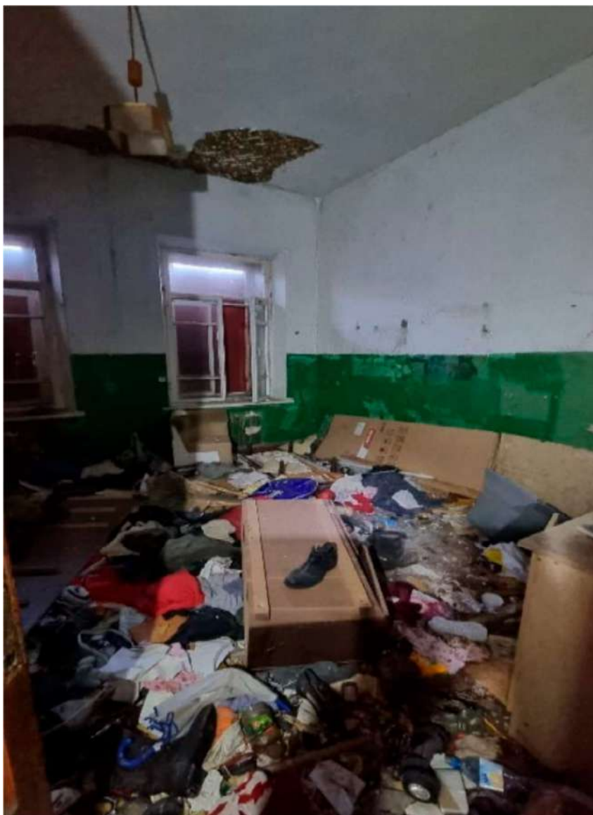
36. Выявленный объект культурного наследия «Казарма Офицерской стрелковой школы» по адресу: Санкт-Петербург, г. Ломоносов, Владимирская ул., д.12, литера А
