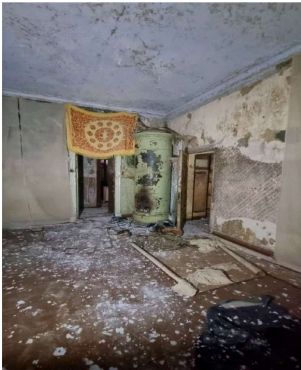
29. Выявленный объект культурного наследия «Казарма Офицерской стрелковой школы» по адресу: Санкт-Петербург, г. Ломоносов, Владимирская ул., д.12, литера А
