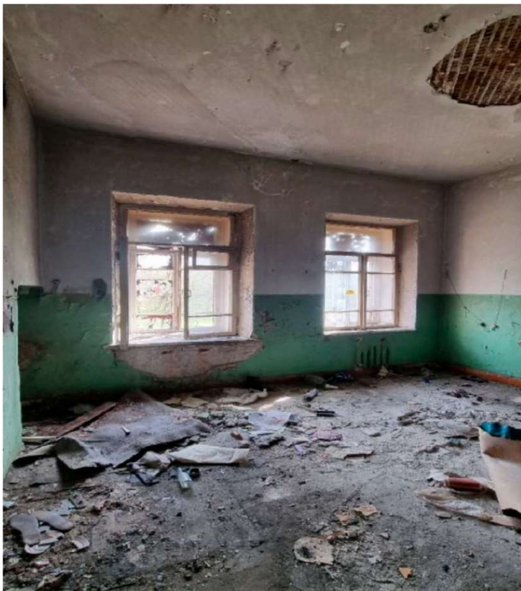
45. Выявленный объект культурного наследия «Казарма Офицерской стрелковой школы» по адресу: Санкт-Петербург, г. Ломоносов, Владимирская ул., д.12, литера А
