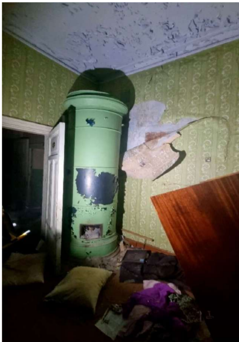
13. Выявленный объект культурного наследия «Казарма Офицерской стрелковой школы» по адресу: Санкт-Петербург, г. Ломоносов, Владимирская ул., д.12, литера А
