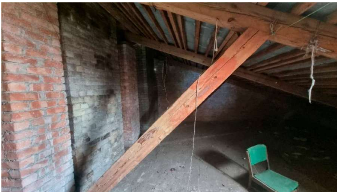
58. Выявленный объект культурного наследия «Казарма Офицерской стрелковой школы» по адресу: Санкт-Петербург, г. Ломоносов, Владимирская ул., д.12, литера А
