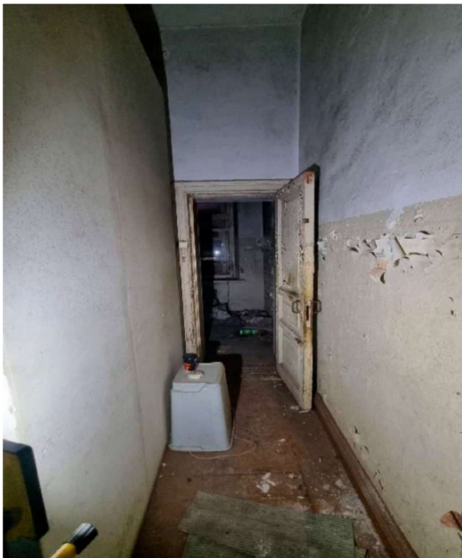
39. Выявленный объект культурного наследия «Казарма Офицерской стрелковой школы» по адресу: Санкт-Петербург, г. Ломоносов, Владимирская ул., д.12, литера А
