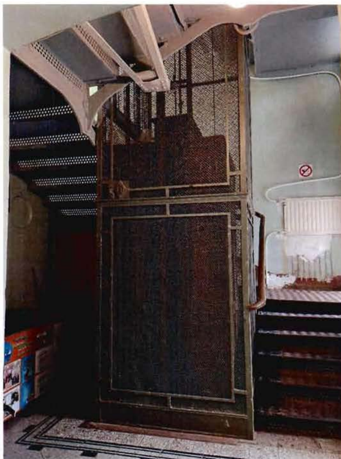
7. Общий вид на служебную лестницу объекта культурного наследия (литера А).
