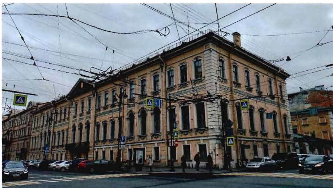
1. Общий вид на объект культурного наследия (литера А).
