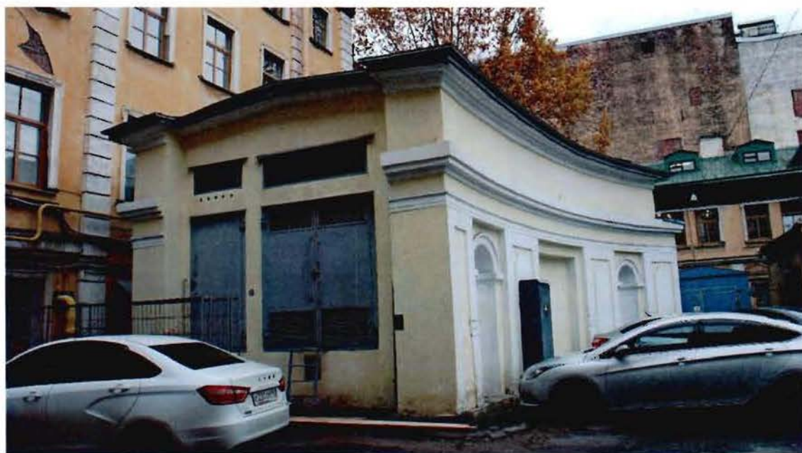
4. Общий вид на объект культурного наследия (здание, расположенное в восточной части двора).
