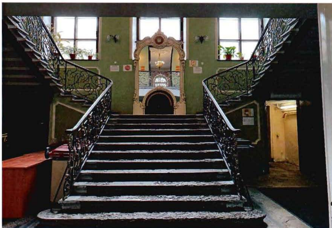
5. Общий вид парадной лестницы объекта культурного наследия (литера А).
