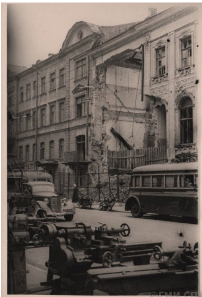
25. Разрушенное здание на улице Гоголя. 1942 г. Номер в Госкаталоге: 37832091. Госкаталог.рф.
