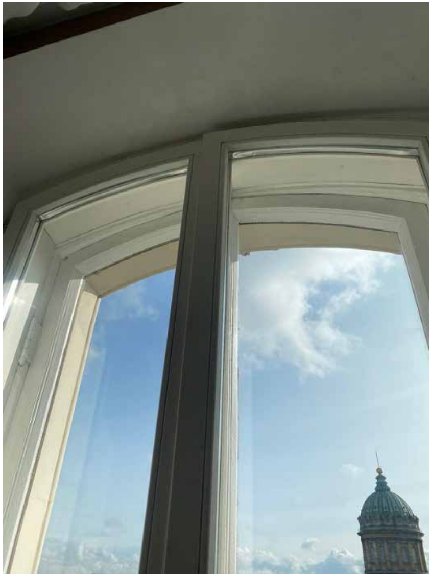
34. Здание по адресу: Санкт-Петербург, ул. Малая Конюшенная, д. 16/26, литера А. Окно пятого этажа (фрагмент).
