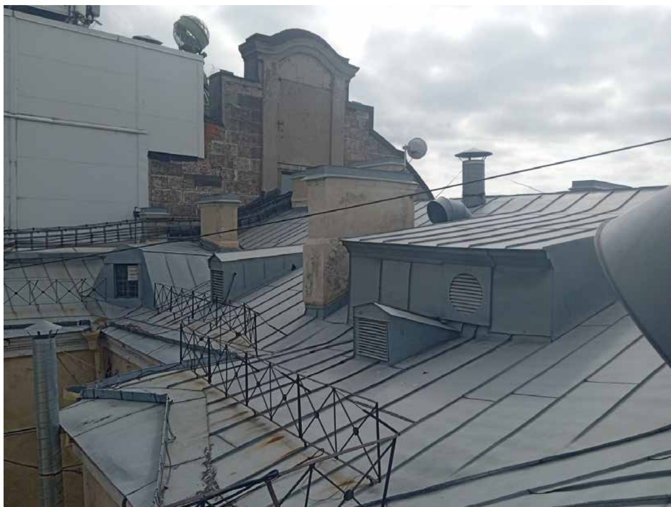
50.Общий вид крыши(с запада на юго-восток) здания по адресу: Санкт-Петербург, ул. Малая Конюшенная, д. 16/26, литера А.
