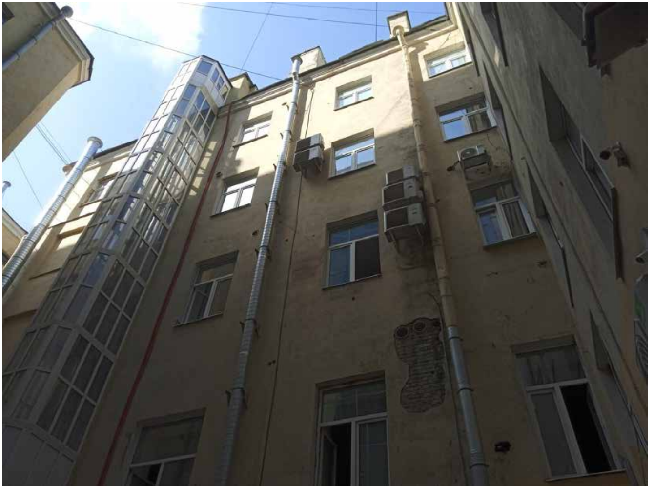
20. Западный дворовой фасад (фрагмент) здания по адресу: Санкт-Петербург, ул. Малая Конюшенная, д. 16/26, литера А
