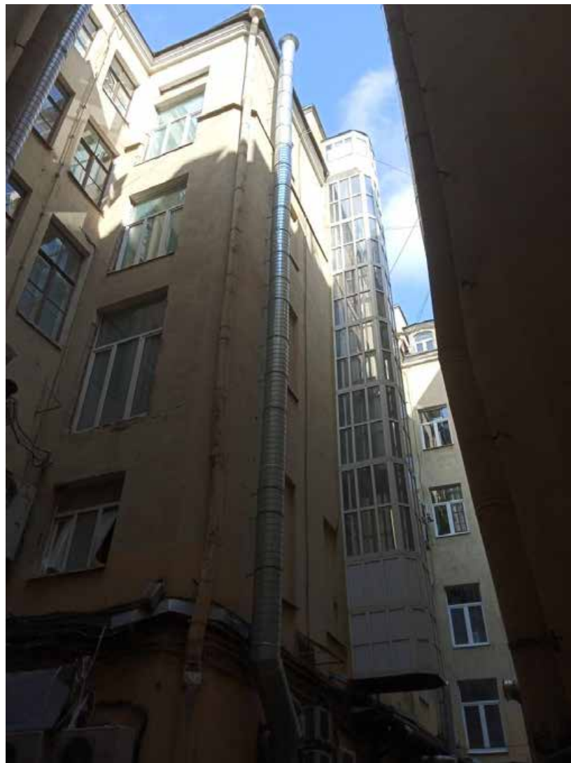
17. Общий вид (с юго-востока на северо-запад) дворовых фасадов здания по адресу: Санкт-Петербург, ул. Малая Конюшенная, д. 16/26, литера А
