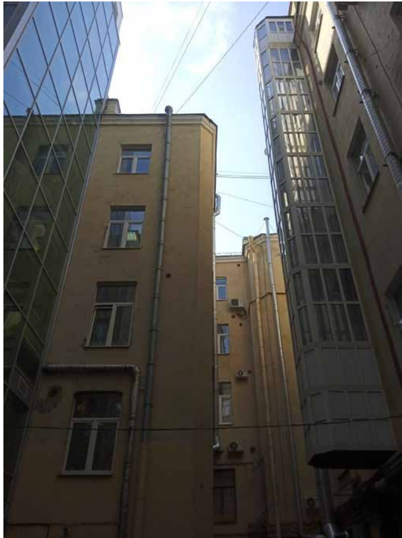
13. Общий вид (с севера на юг) дворовых фасадов здания по адресу: Санкт-Петербург, ул. Малая Конюшенная, д. 16/26, литера А
