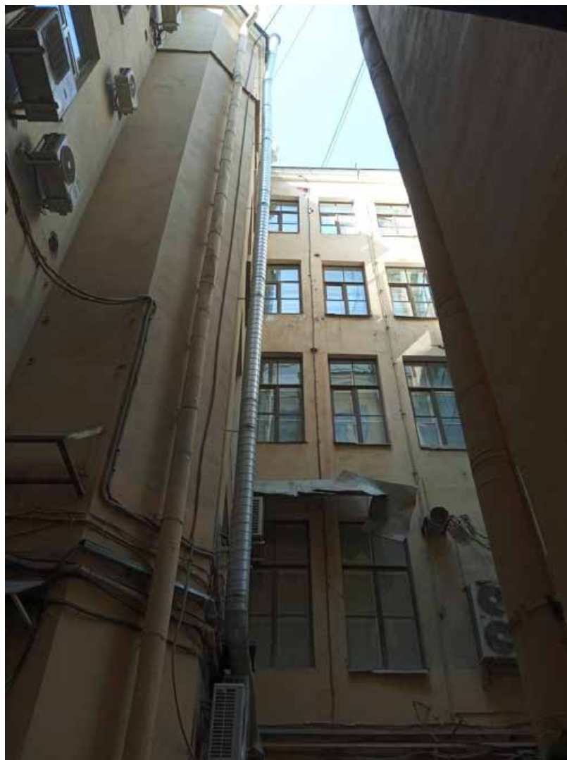
18. Общий вид западного дворового фасада здания по адресу: Санкт-Петербург, ул. Малая Конюшенная, д. 16/26, литера А
