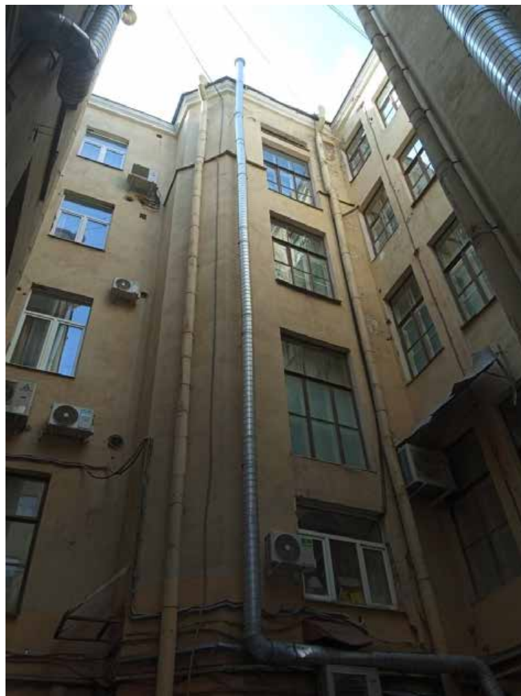
15. Общий вид (с северо-востока на юго-запад) дворовых фасадов здания по адресу: Санкт-Петербург, ул. Малая Конюшенная, д. 16/26, литера А
