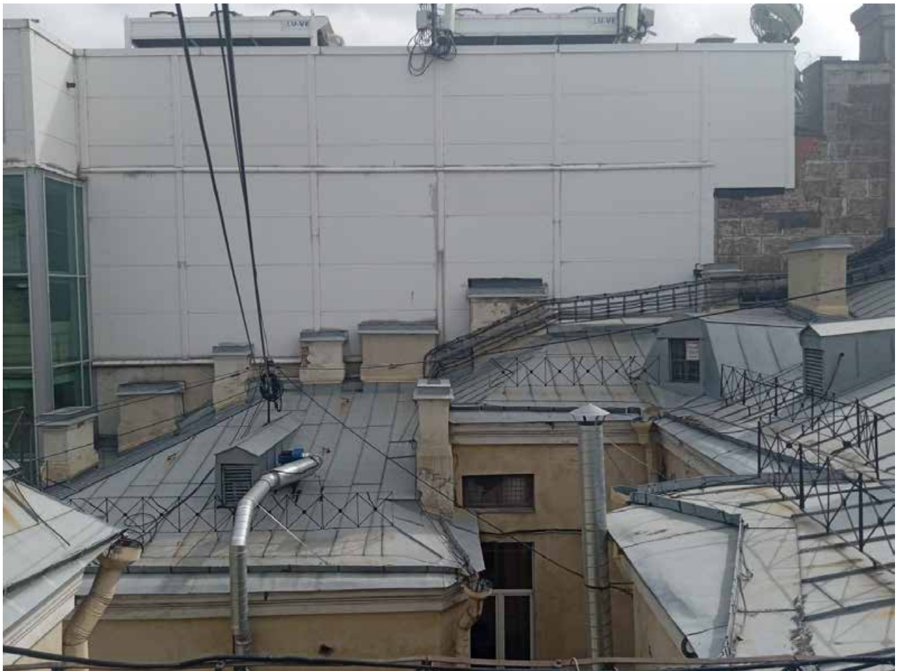
49. Общий вид крыши (с запада на восток) здания по адресу: Санкт-Петербург, ул. Малая Конюшенная, д. 16/26, литера А.
