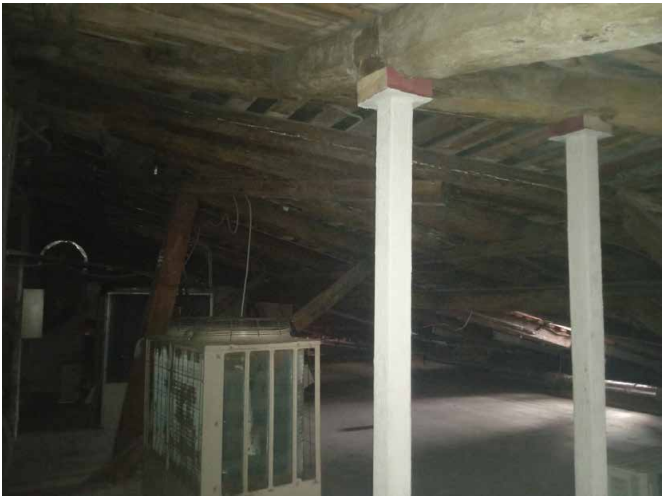
44. Здание по адресу: Санкт-Петербург, ул. Малая Конюшенная, д. 16/26, литера А. Стропильные конструкции.
