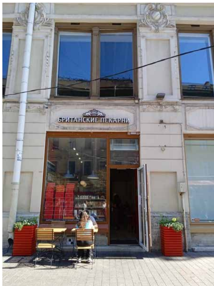
6. Западный фасад (фрагмент) здания по адресу: Санкт-Петербург, ул. Малая Конюшенная, д. 16/26, литера А. Дверь со стороны Малой Конюшенной ул. Витринные окна второго этажа.
