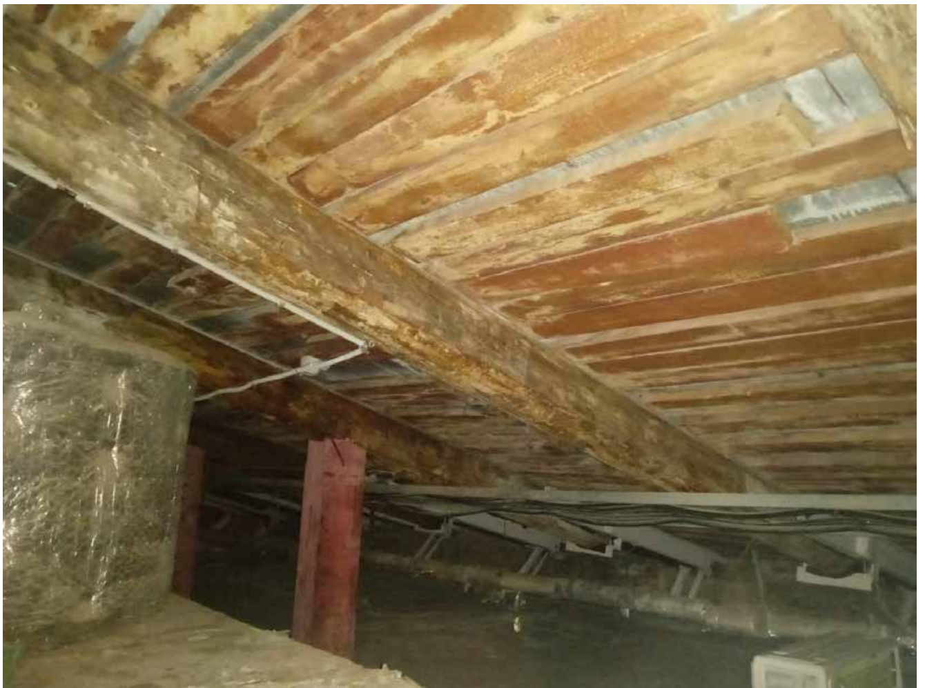
43. Здание по адресу: Санкт-Петербург, ул. Малая Конюшенная, д. 16/26, литера А. Стропильные конструкции.
