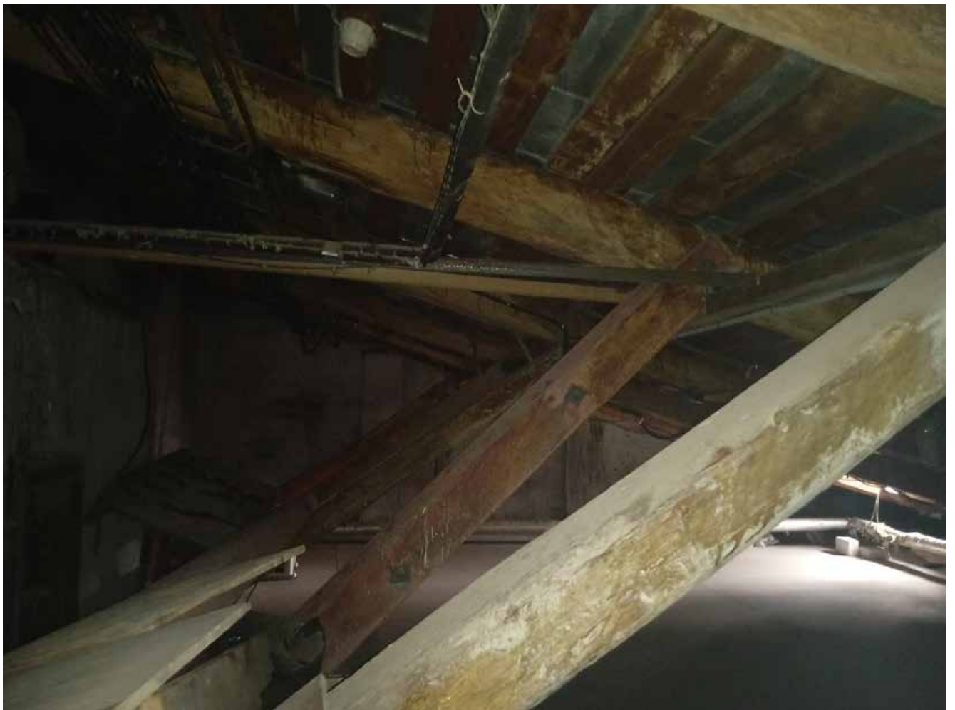
47. Здание по адресу: Санкт-Петербург, ул. Малая Конюшенная, д. 16/26, литера А. Стропильные конструкции.
