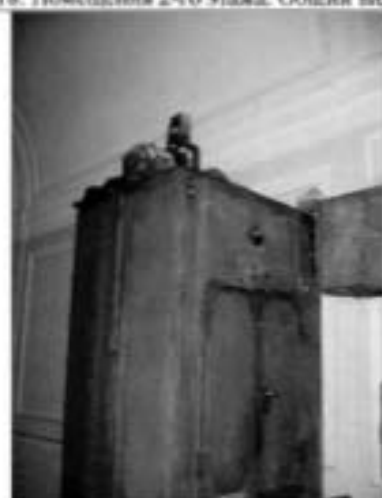
20. Лифтовая шахта. Фрагмент.
