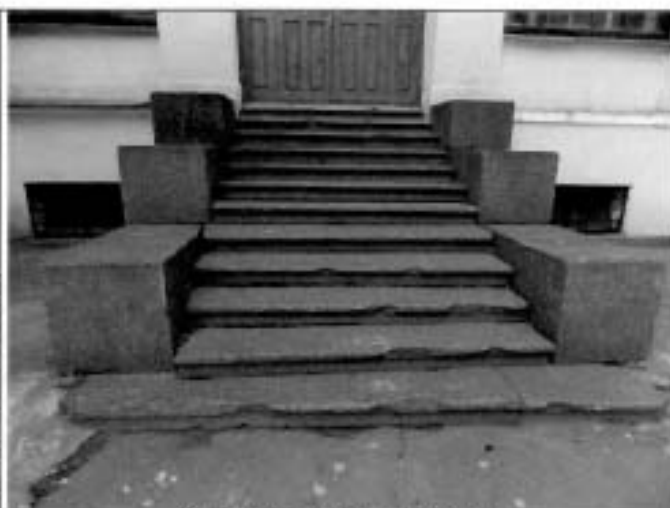
13. Дворовые фасады. Крыльца.
