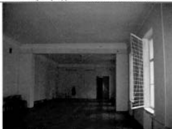
28. Помещение 2-го этажа. Общий вид.
