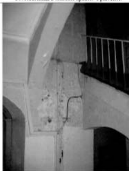
41. Лестница в южном крыле. Фрагмент.
