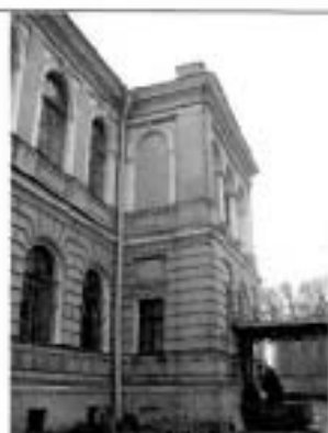
8. Северный фасад. Фрагмент.
