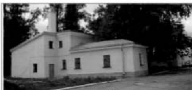
1. Южный фасад. Общий вид.
