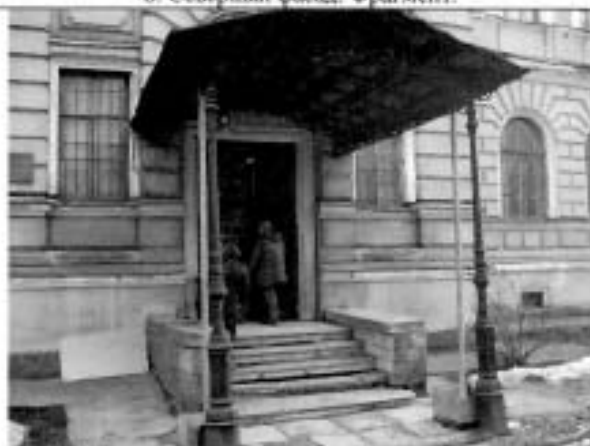
10. Входная группа северного фасада. Общий вид.
