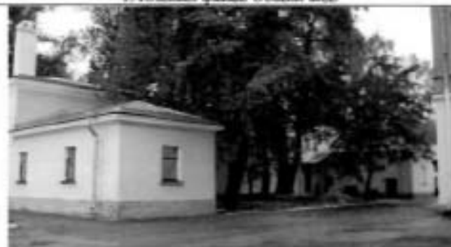
3. Восточный фасад. Общий вид.
