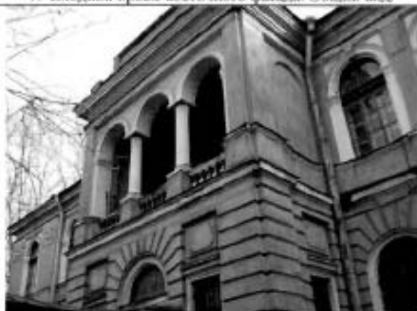
9. Северный фасад. Фрагмент.
