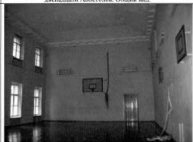
33. Помещение 3-Н (111) бывшего Актового зала. Общий вид.
