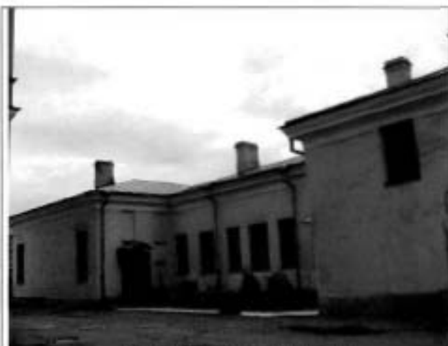
1. Восточный фасад. Общий вид.
