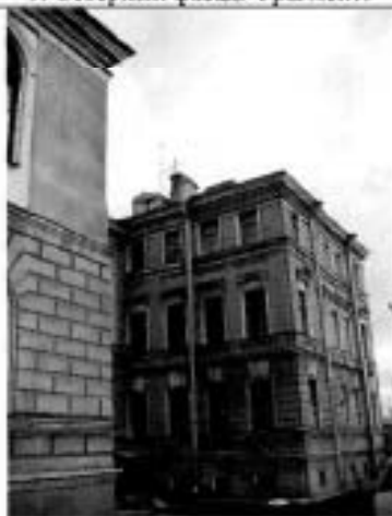
11. Западный фасад. Фрагмент.
