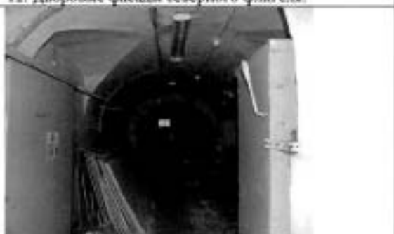
14. Коридор в уровне подвала. Общий вид.
