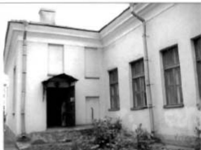
2. Фрагмент восточного фасада.
