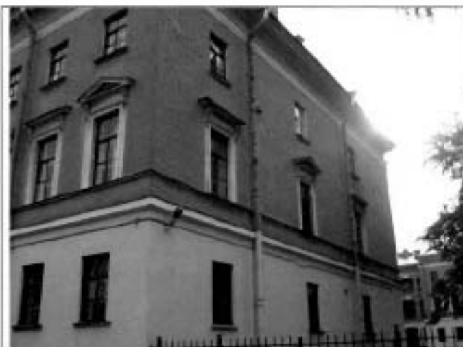
8. Западный торцевой фасад северного флигеля. Общий вид.
