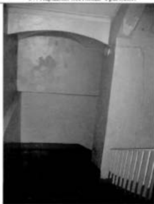
39. Лестница в южном крыле. Фрагмент.
