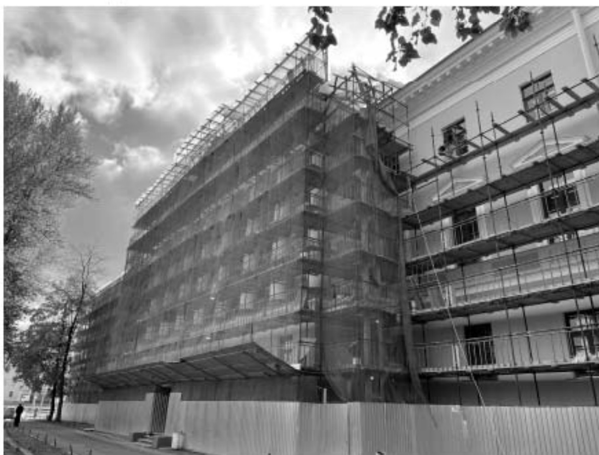
Фото 4. Фасады. Дата съёмки 09.10.2023
