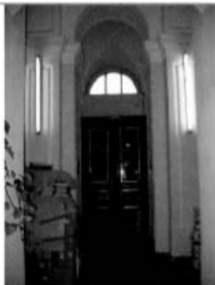
22. Помещение 1-го этажа. Фрагмент.
