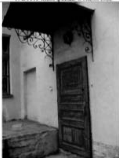
3. Дверной проем восточного фасада.
