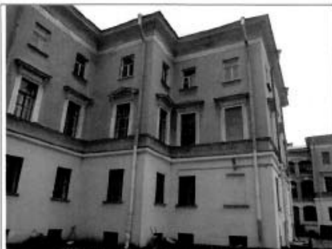
12. Дворовые фасады северного флигеля.
