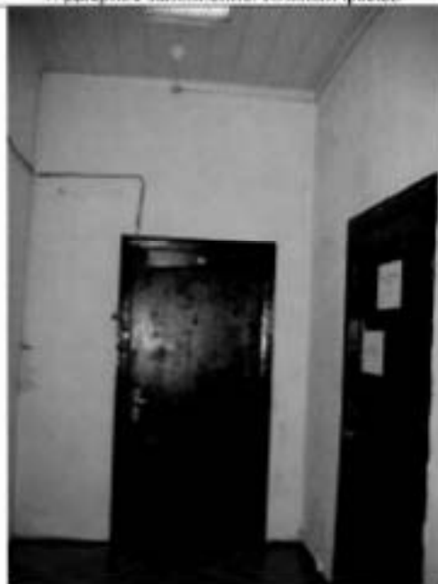
9. Коридор 1-го этажа.
