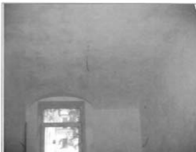
9. Перекрытие помещения 1-го этажа
