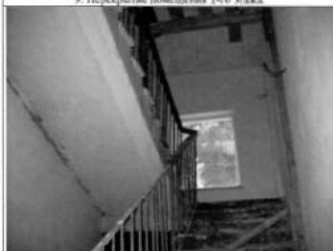
11. Лестница. Общий вид.
