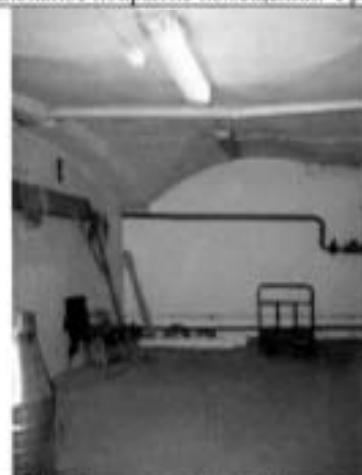
25. Помещение подвала. Общий вид.
