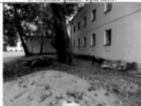
4. Восточный фасад. Фрагмент.
