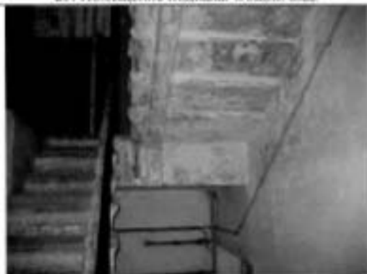
27. Лестница в западной части здания. Общий вид.
