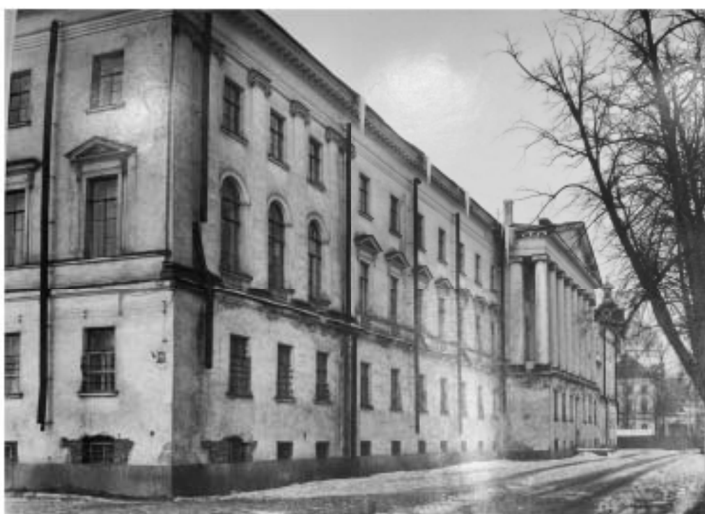
Илл. 29. Фото главного фасада здания Духовной академии. Фото А.А. Григорьева, 1952 г. Фонды Отдела систематизации, популяризации и хранения документированной информации об объектах культурного наследия КГИОП
