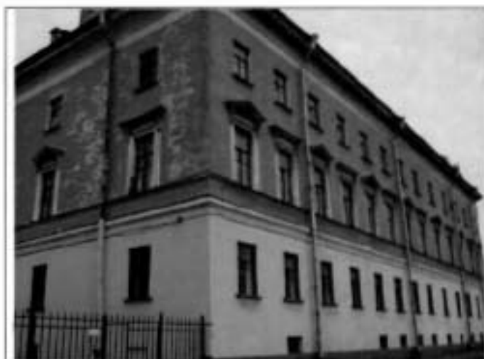
1. Южный фасад. Общий вид
