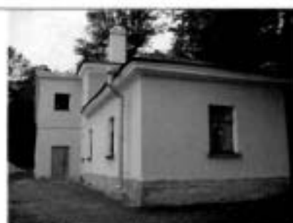
2. Южный фасад. Фрагмент.
