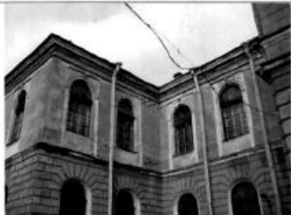
13. Западный фасад. Фрагмент.
