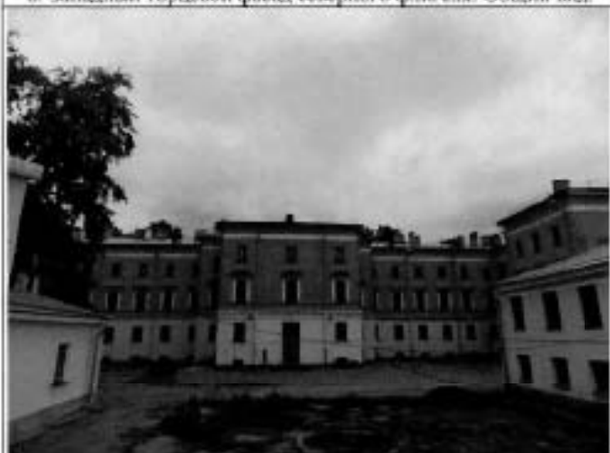
10. Центральный ризалит дворового фасада. Общий вид.
