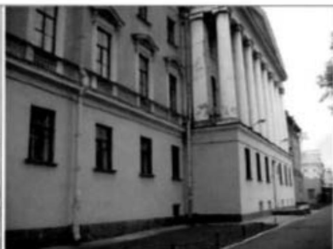
2. Восточный фасад. Общий вид
