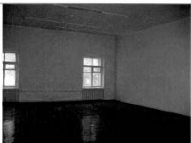
25. Помещения в уровне 2-го этажа. Общий вид.
