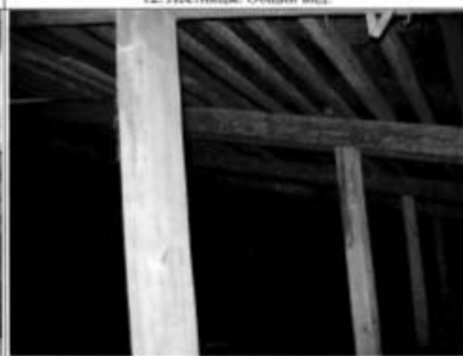
14. Конструкция крыши. Общий вид.
