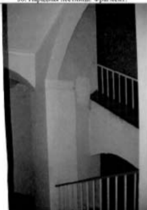
38. Лестница в южном крыле. Фрагмент.
