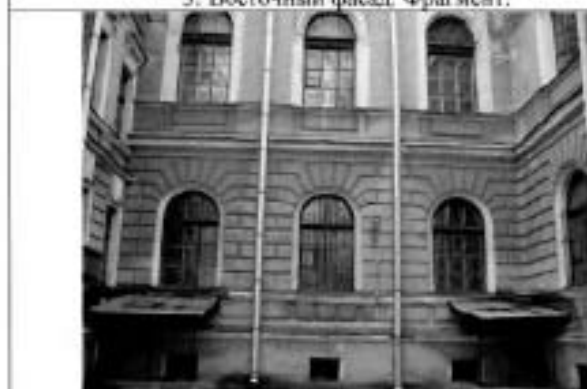
5. Восточный фасад. Фрагмент.
