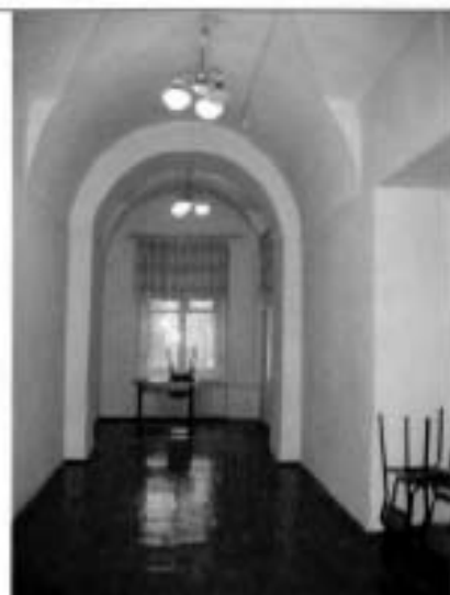
19. Коридор 1-го этажа. Общий вид.
