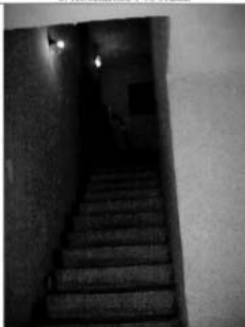
10. Лестница. Общий вид.
