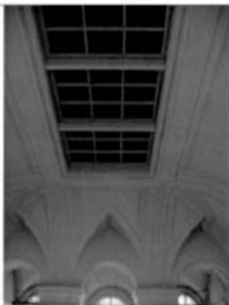
18. Помещение 2-го этажа. Общий вид.
