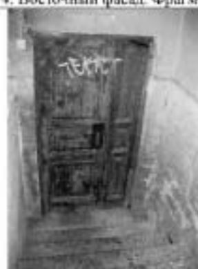
6. Входной проем восточного фасада. Общий вид.
