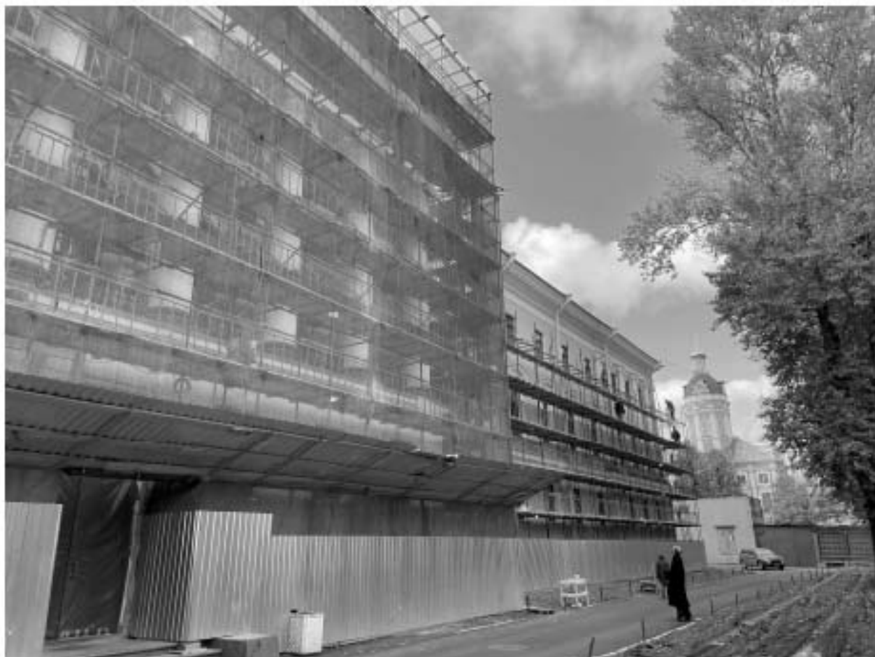
Фото 3. Фасады. Дата съёмки 09.10.2023
