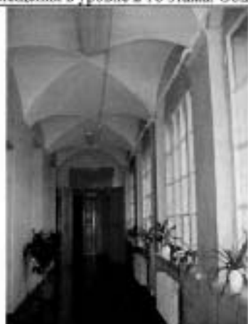
27. Коридор в уровне 2-го этажа. Общий вид.
