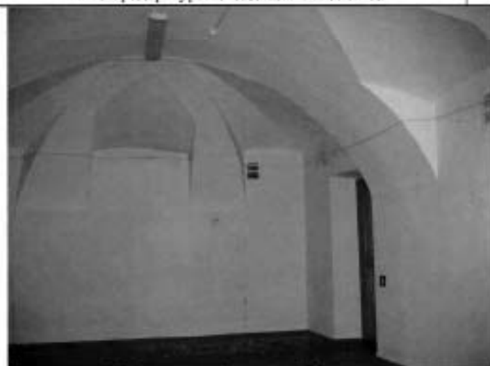
16. Помещения 1-го этажа. Общий вид.
