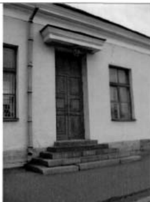
7. Дверное заполнение. Южный фасад.
