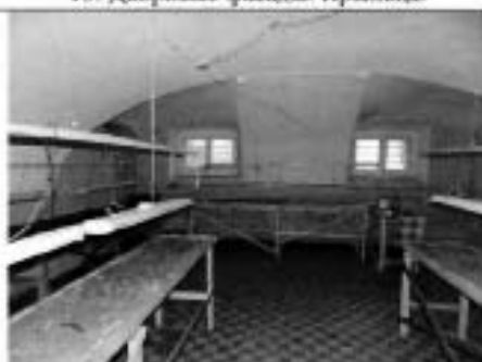
15. Помещение в уровне подвала. Общий вид.
