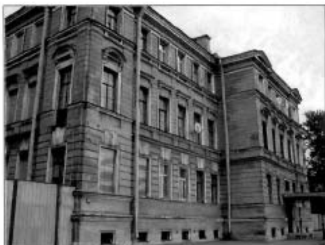
1. Южный фасад. Общий вид.
