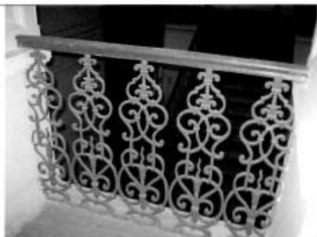
16. Ограждение лестницы северной части здания. Фрагмент.
