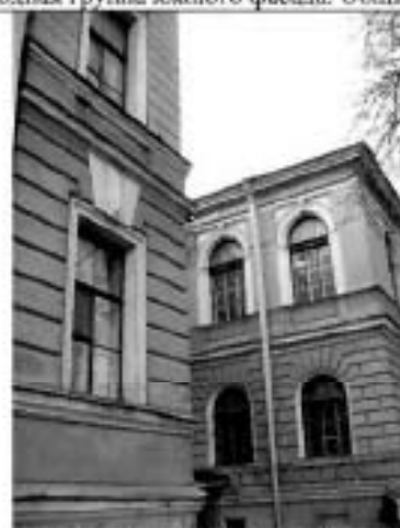
4. Восточный фасад. Фрагмент.
