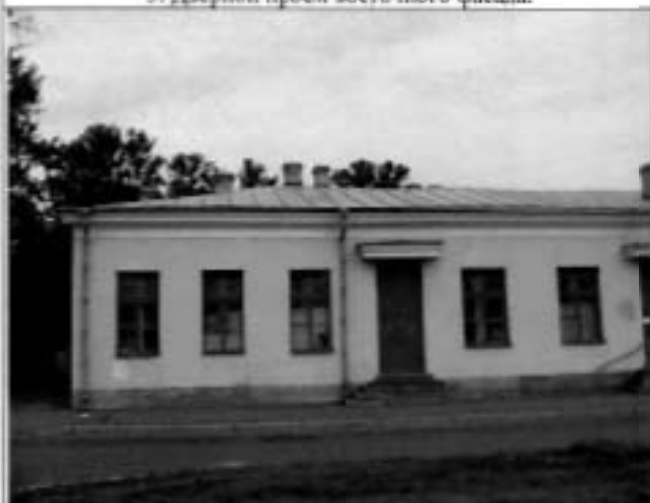
5. Южный фасад. Общий вид.
