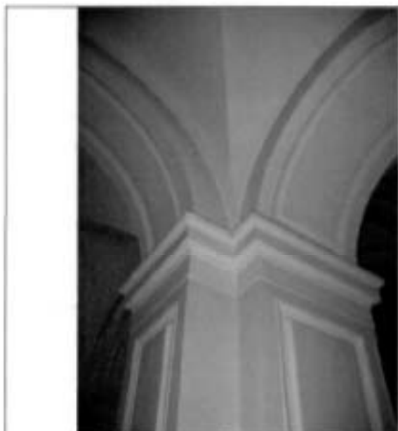
17. Помещение 2-го этажа. Фрагмент.
