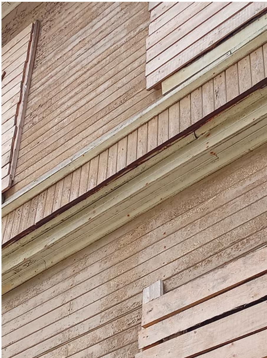
Фото 9. Выявленный объект культурного наследия «Дом купца Елисеева (ресторан) (деревянный)» по адресу: Санкт-Петербург, г. Зеленогорск Приморское шоссе, д. 520 литера Ц.
