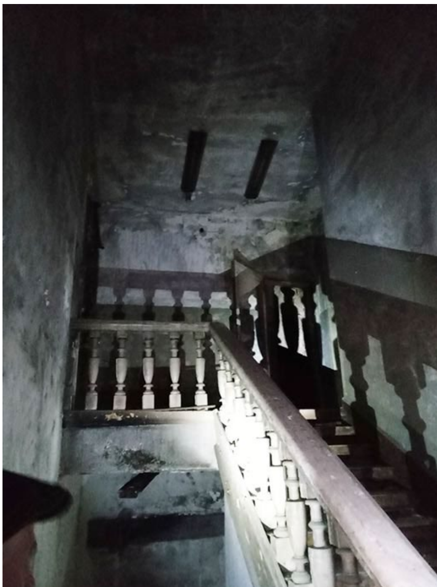
Фото 47. Выявленный объект культурного наследия «Дом купца Елисеева (ресторан) (деревянный)» по адресу: Санкт-Петербург, г. Зеленогорск Приморское шоссе, д. 520 литера Ц.
