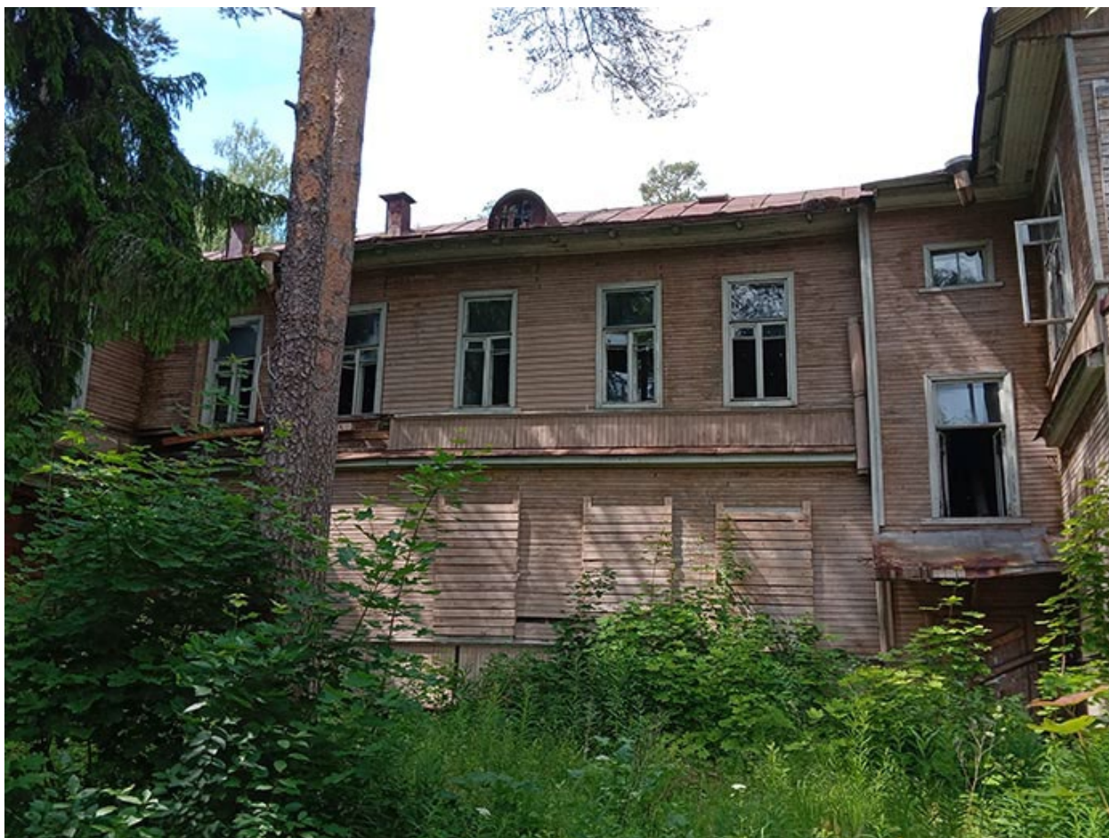
Фото 21. Выявленный объект культурного наследия «Дом купца Елисеева (ресторан) (деревянный)» по адресу: Санкт-Петербург, г. Зеленогорск Приморское шоссе, д. 520 литера Ц.
