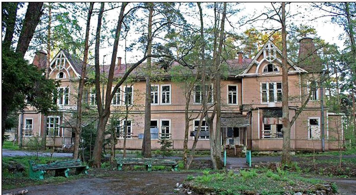
21. Зеленогорск. Дача Кирхнера. Западный фасад. Фото 2011 г. Расположенные попарно оконные проемы устроены вместо окон с трехстворчатыми рамами при устройстве внутренней перепланировки (предположительно в середине XX в.). Сайт terijoki.spb.ru .
