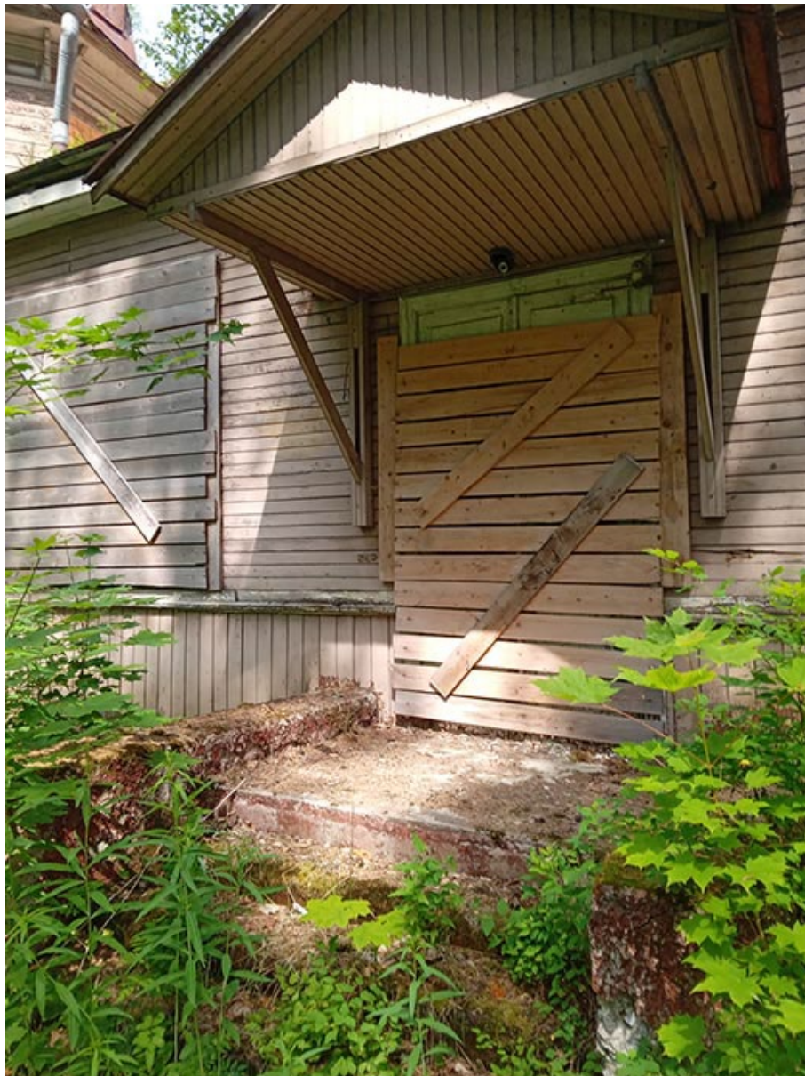
Фото 33. Выявленный объект культурного наследия «Дом купца Елисеева (ресторан) (деревянный)» по адресу: Санкт-Петербург, г. Зеленогорск Приморское шоссе, д. 520 литера Ц.
