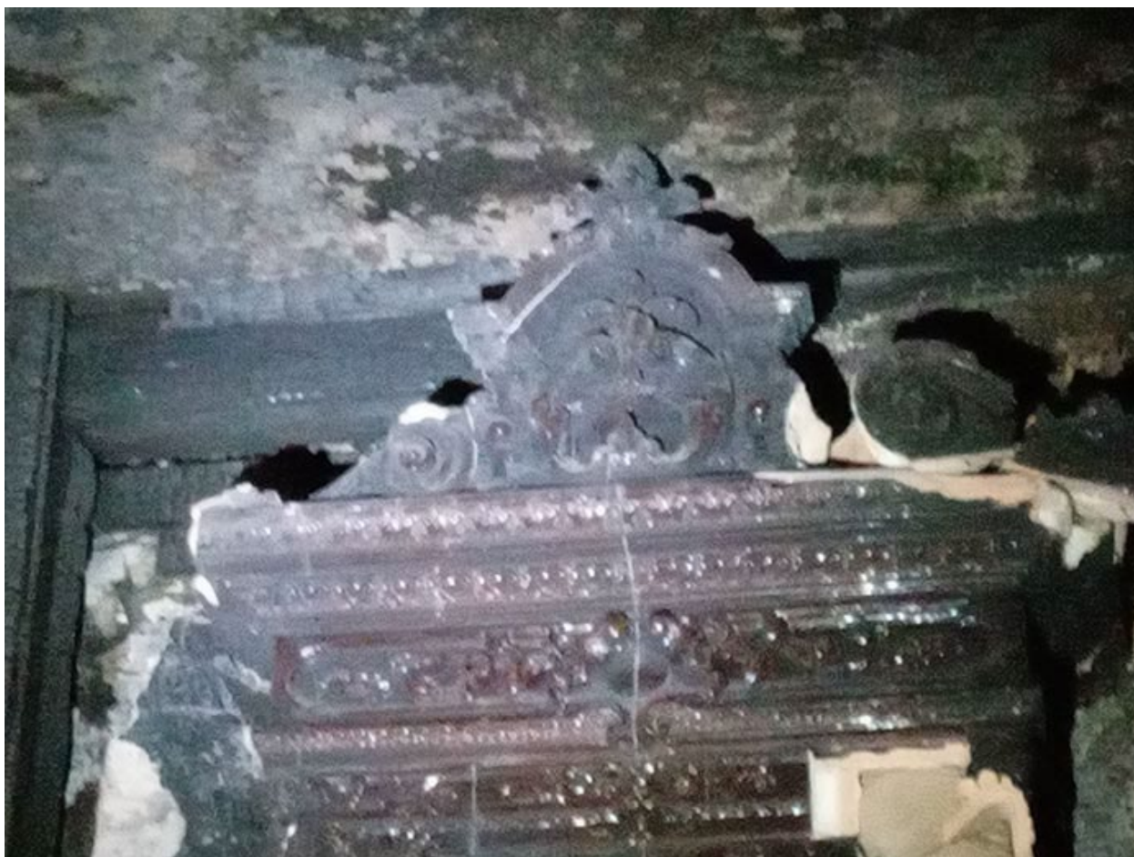
Фото 41. Выявленный объект культурного наследия «Дом купца Елисеева (ресторан) (деревянный)» по адресу: Санкт-Петербург, г. Зеленогорск Приморское шоссе, д. 520 литера Ц.
