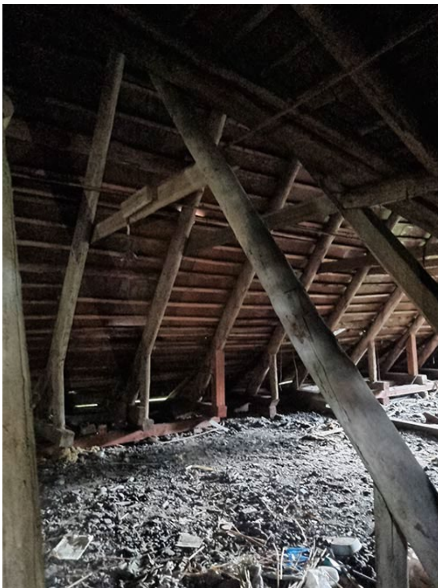
Фото 60. Выявленный объект культурного наследия «Дом купца Елисеева (ресторан) (деревянный)» по адресу: Санкт-Петербург, г. Зеленогорск Приморское шоссе, д. 520 литера Ц.
