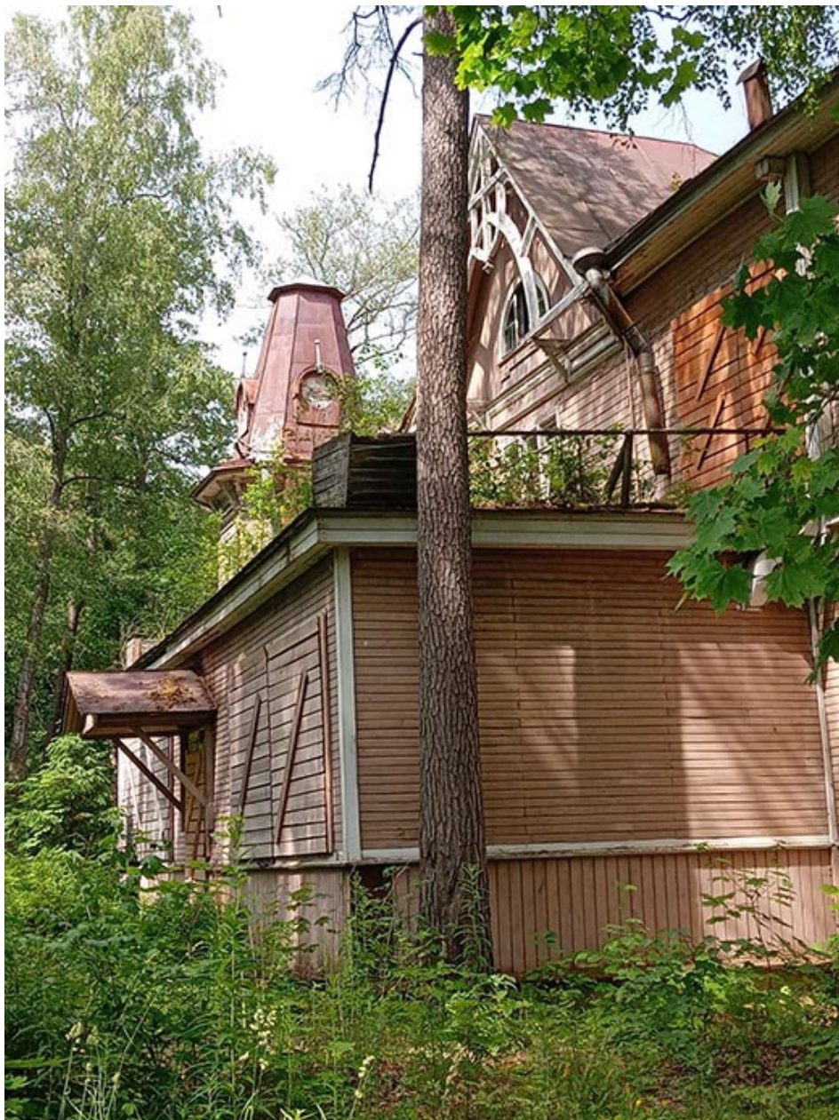
Фото 29. Выявленный объект культурного наследия «Дом купца Елисеева (ресторан) (деревянный)» по адресу: Санкт-Петербург, г. Зеленогорск Приморское шоссе, д. 520 литера Ц.
