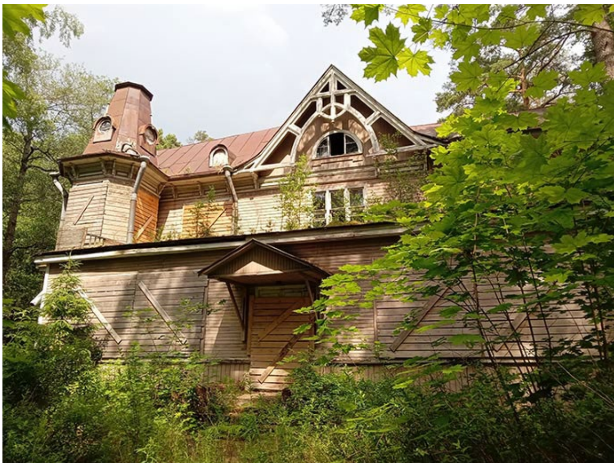
Фото 27. Выявленный объект культурного наследия «Дом купца Елисеева (ресторан) (деревянный)» по адресу: Санкт-Петербург, г. Зеленогорск Приморское шоссе, д. 520 литера Ц.
