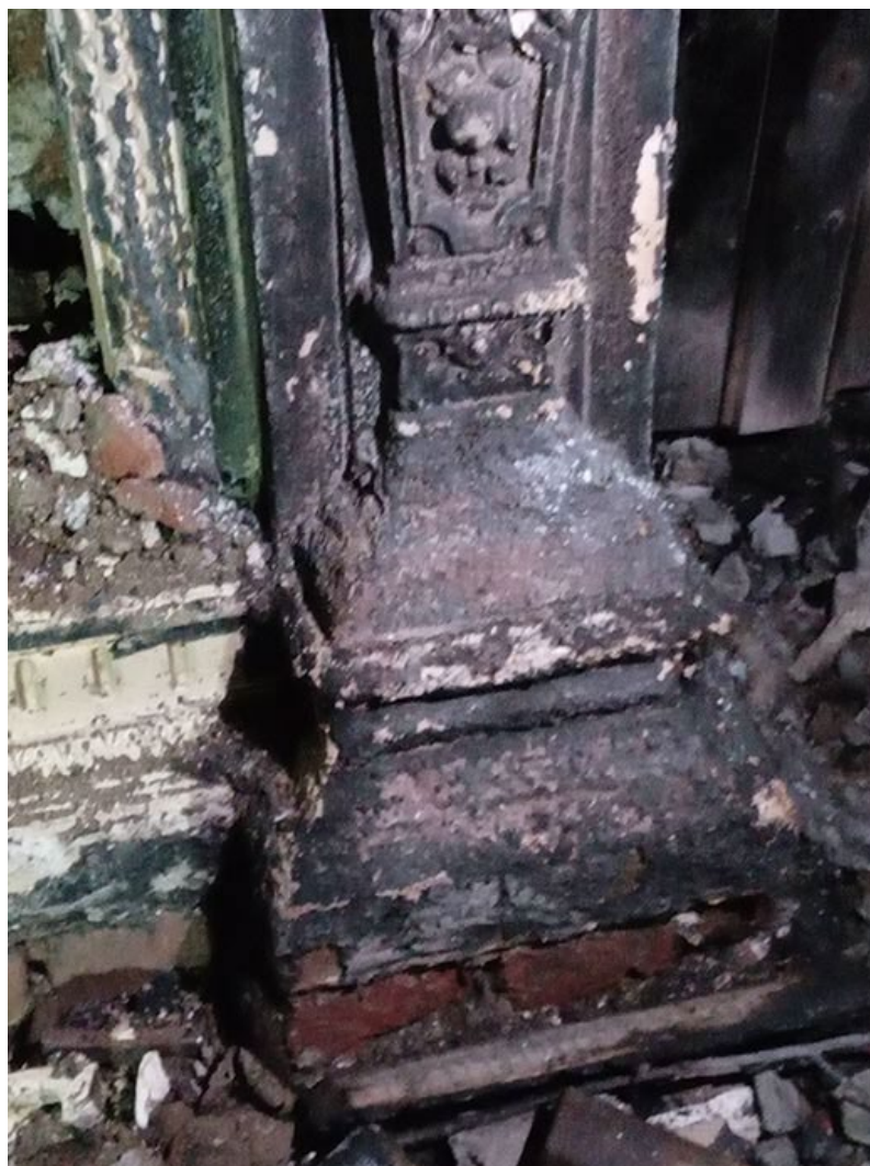
Фото 38. Выявленный объект культурного наследия «Дом купца Елисеева (ресторан) (деревянный)» по адресу: Санкт-Петербург, г. Зеленогорск Приморское шоссе, д. 520 литера Ц.
