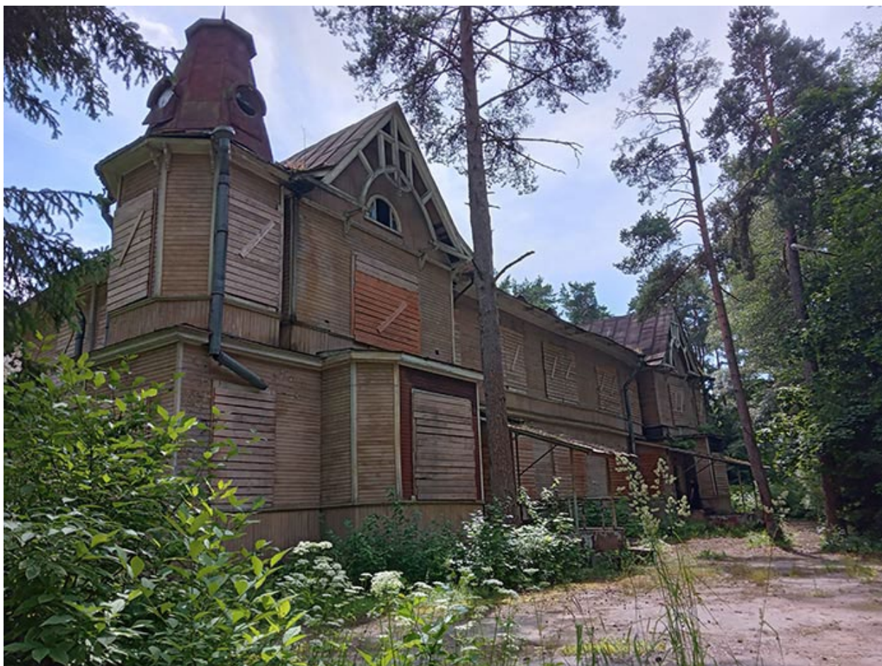
Фото 14. Выявленный объект культурного наследия «Дом купца Елисеева (ресторан) (деревянный)» по адресу: Санкт-Петербург, г. Зеленогорск Приморское шоссе, д. 520 литера Ц.
