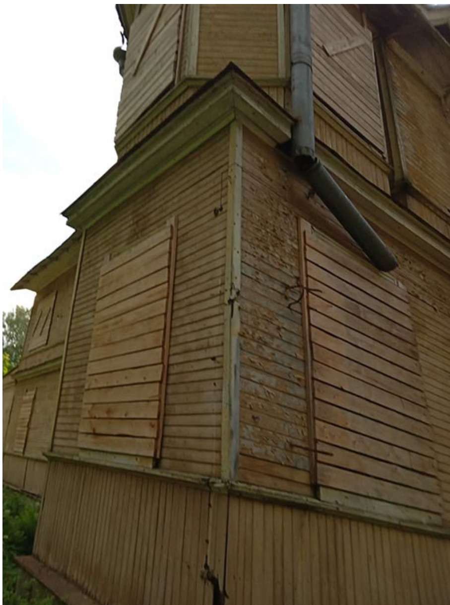
Фото 16. Выявленный объект культурного наследия «Дом купца Елисеева (ресторан) (деревянный)» по адресу: Санкт-Петербург, г. Зеленогорск Приморское шоссе, д. 520 литера Ц.
