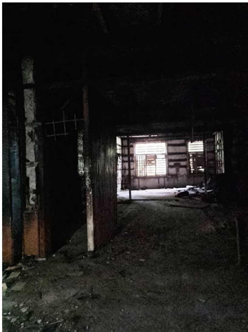
Фото 34. Выявленный объект культурного наследия «Дом купца Елисеева (ресторан) (деревянный)» по адресу: Санкт-Петербург, г. Зеленогорск Приморское шоссе, д. 520 литера Ц.
