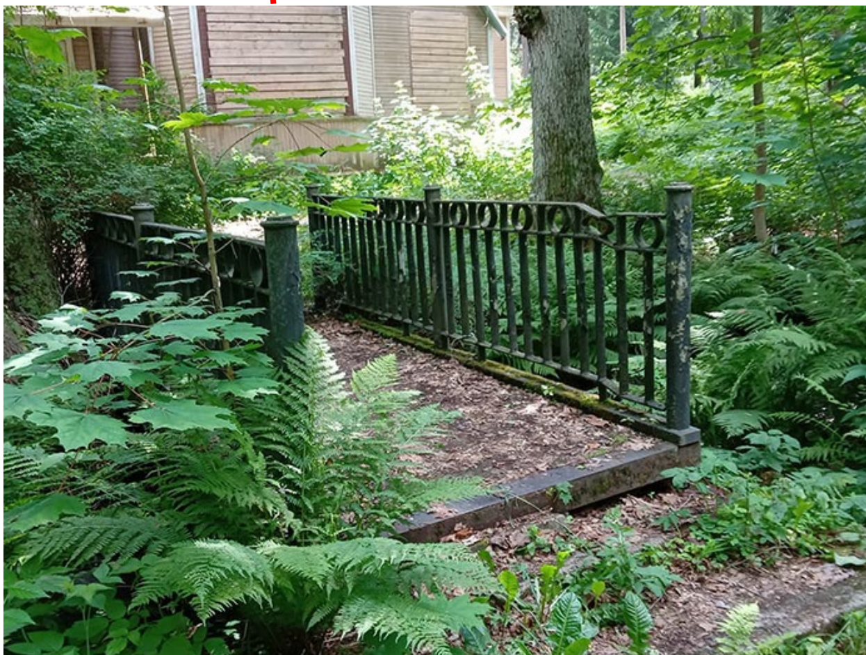
Фото 1. Выявленный объект культурного наследия «Дом купца Елисеева (ресторан) (деревянный)» по адресу: Санкт-Петербург, г. Зеленогорск Приморское шоссе, д. 520 литера Ц.
