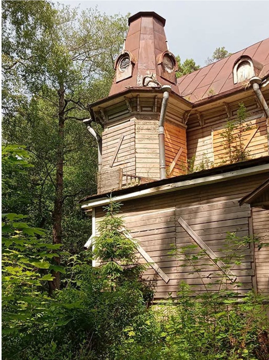
Фото 30. Выявленный объект культурного наследия «Дом купца Елисеева (ресторан) (деревянный)» по адресу: Санкт-Петербург, г. Зеленогорск Приморское шоссе, д. 520 литера Ц.
