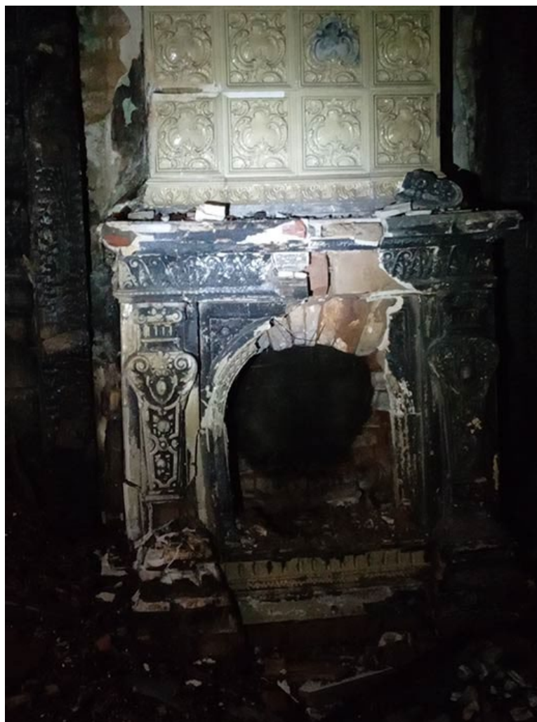
Фото 37. Выявленный объект культурного наследия «Дом купца Елисеева (ресторан) (деревянный)» по адресу: Санкт-Петербург, г. Зеленогорск Приморское шоссе, д. 520 литера Ц.
