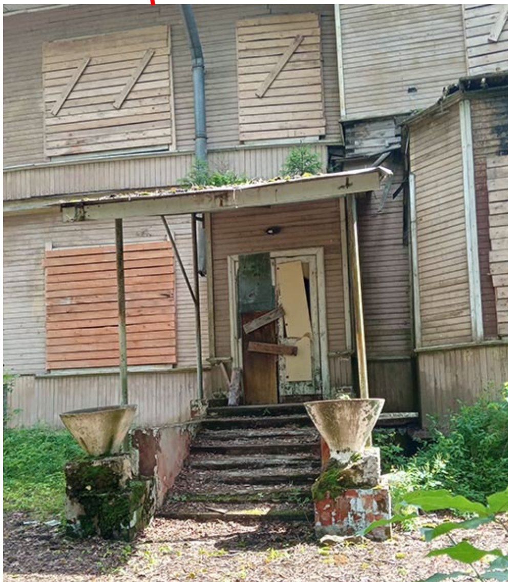
Фото 4. Выявленный объект культурного наследия «Дом купца Елисеева (ресторан) (деревянный)» по адресу: Санкт-Петербург, г. Зеленогорск Приморское шоссе, д. 520 литера Ц.
