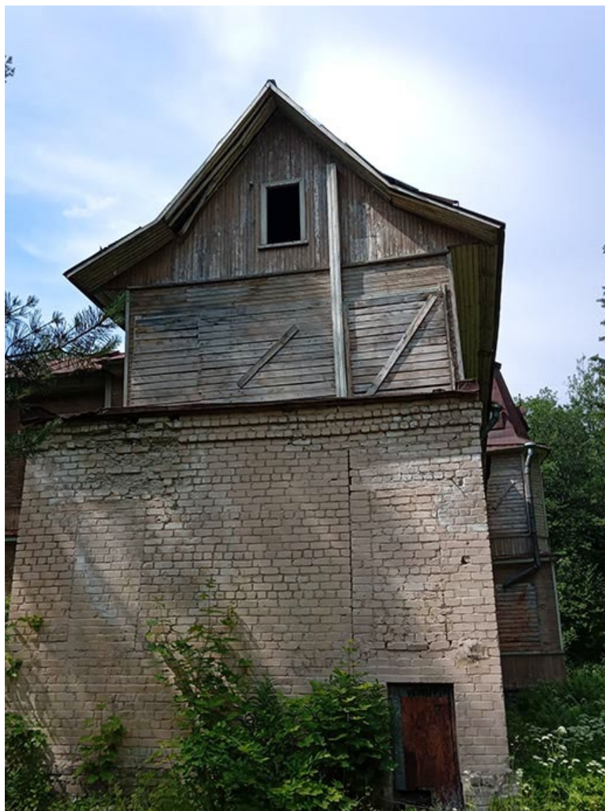
Фото 20. Выявленный объект культурного наследия «Дом купца Елисеева (ресторан) (деревянный)» по адресу: Санкт-Петербург, г. Зеленогорск Приморское шоссе, д. 520 литера Ц.
