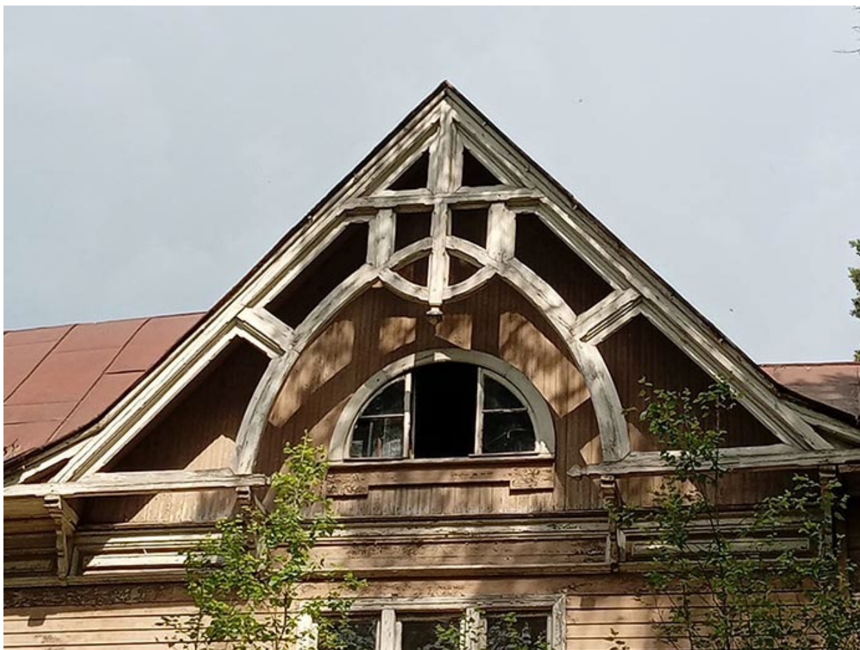
Фото 28. Выявленный объект культурного наследия «Дом купца Елисеева (ресторан) (деревянный)» по адресу: Санкт-Петербург, г. Зеленогорск Приморское шоссе, д. 520 литера Ц.
