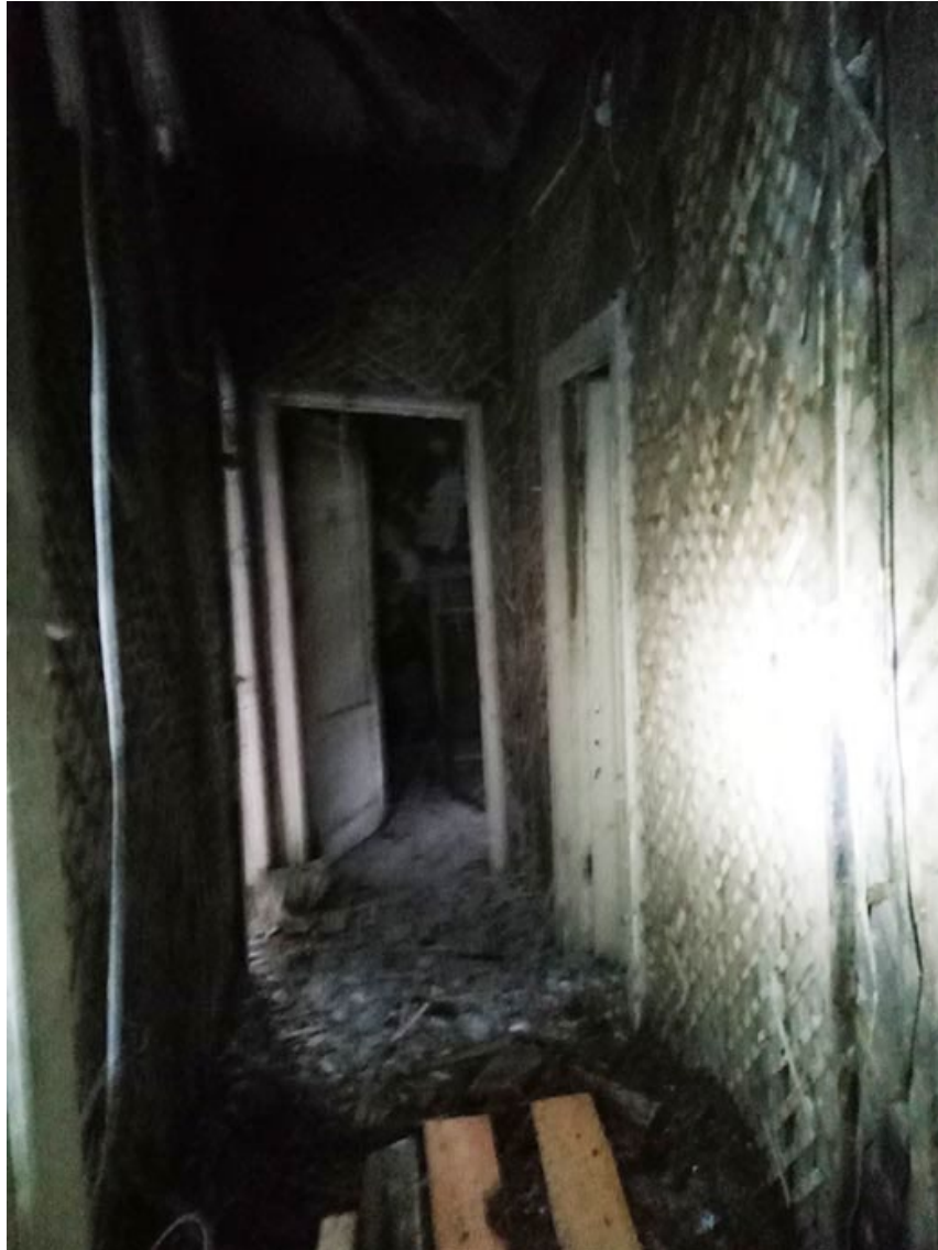
Фото 48. Выявленный объект культурного наследия «Дом купца Елисеева (ресторан) (деревянный)» по адресу: Санкт-Петербург, г. Зеленогорск Приморское шоссе, д. 520 литера Ц.
