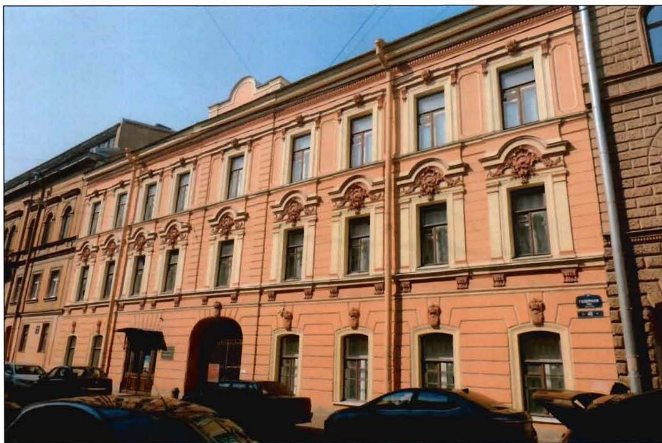
5. Общий вид лицевого фасада объекта культурного наследия по Галерной ул. с юго-востока.
