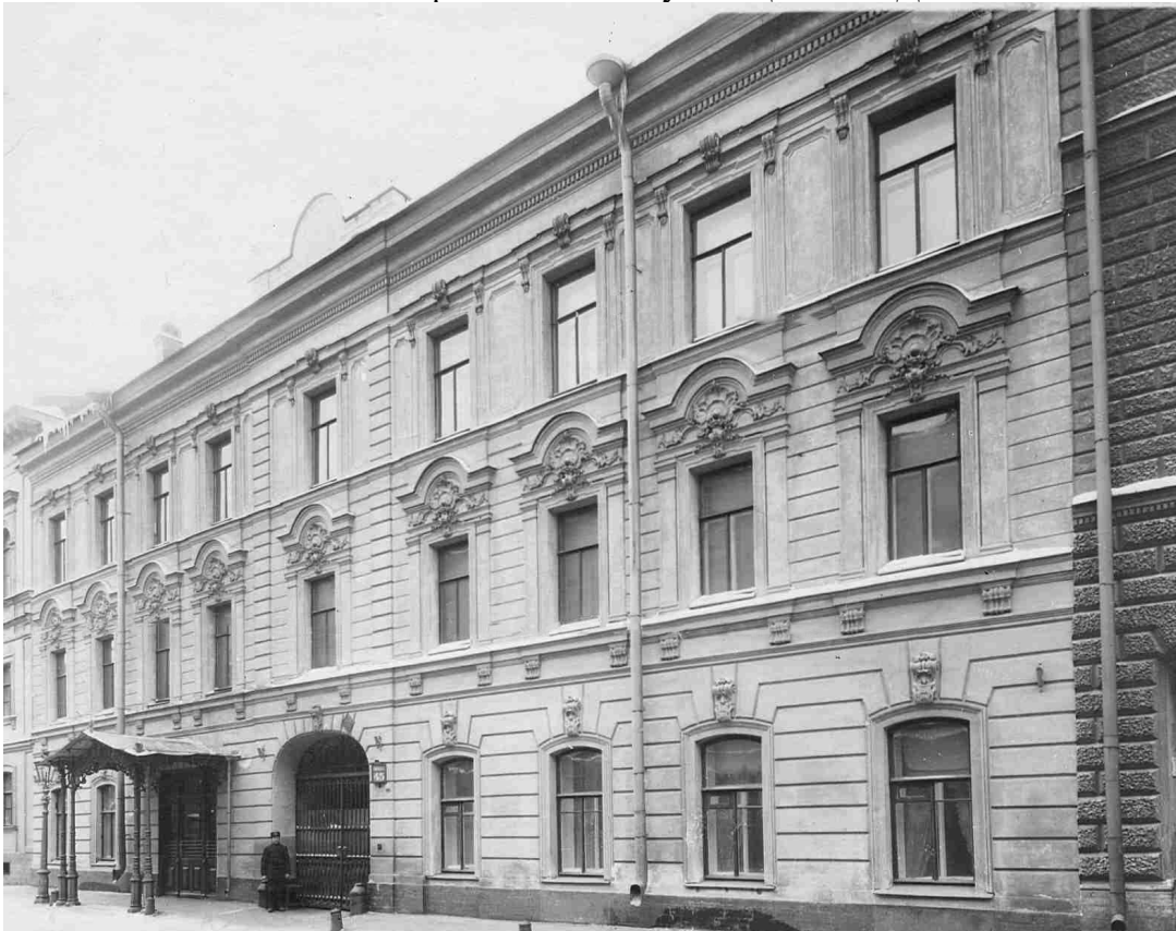
21. 1903-1910. Вход в особняк Кочубея со стороны Галерной улицы. Булла ЦГАКФФД Е 277.
