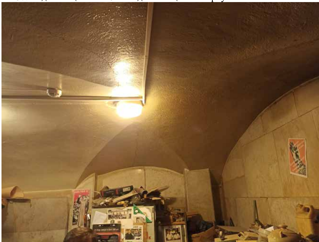
38. Вид помещения № 82 в подвале лицевого корпуса по Английской наб.
