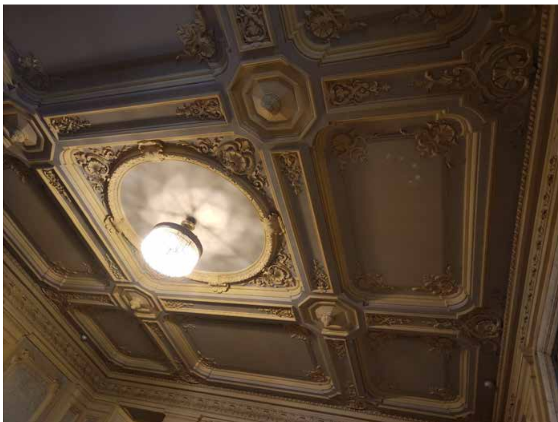
1. Потолок вестибюля корпуса по Английской набережной (пом. № 16).
