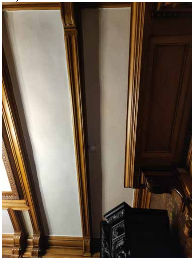
19. Вид потолка в пом. № 21 на 1-м этаже восточного дворового флигеля. Направление съемки восток (Нева слева).
