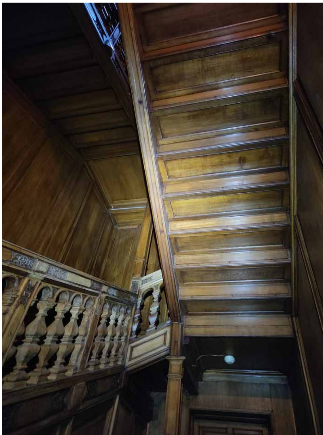
20. Вид дубовой лестницы в уровне 1-го этажа (пом. № 20). Направление съемки север (в сторону Невы).
