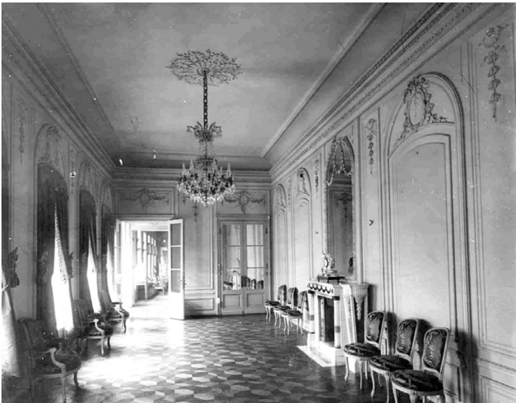
35. 1906 г. Зал западной анфилады. К. К. Булла. ЦГАКФФД СПб. В настоящее время стены и потолок зала зашиты.
