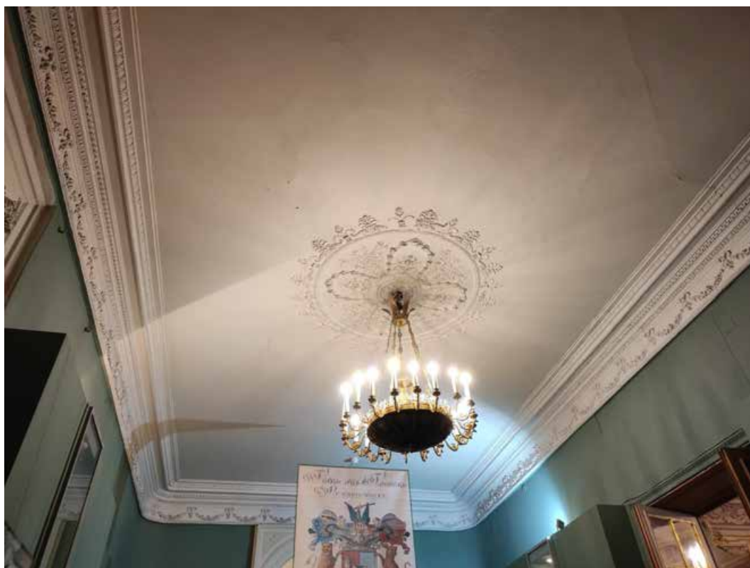
25. Вид пом. № 48 во 2-м этаже лицевого корпуса по Английской наб. Направление съемки запад (Нева справа).
