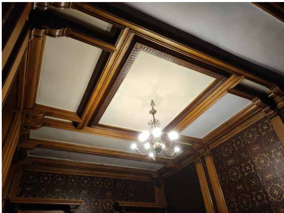
18. Вид потолка в пом. № 21 на 1-м этаже восточного дворового флигеля. Направление съемки север (в сторону Невы).
