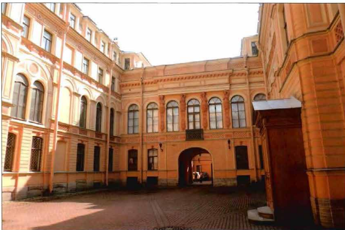
3. Общий вид объекта фасадов северного двора культурного наследия с северо-запада.
