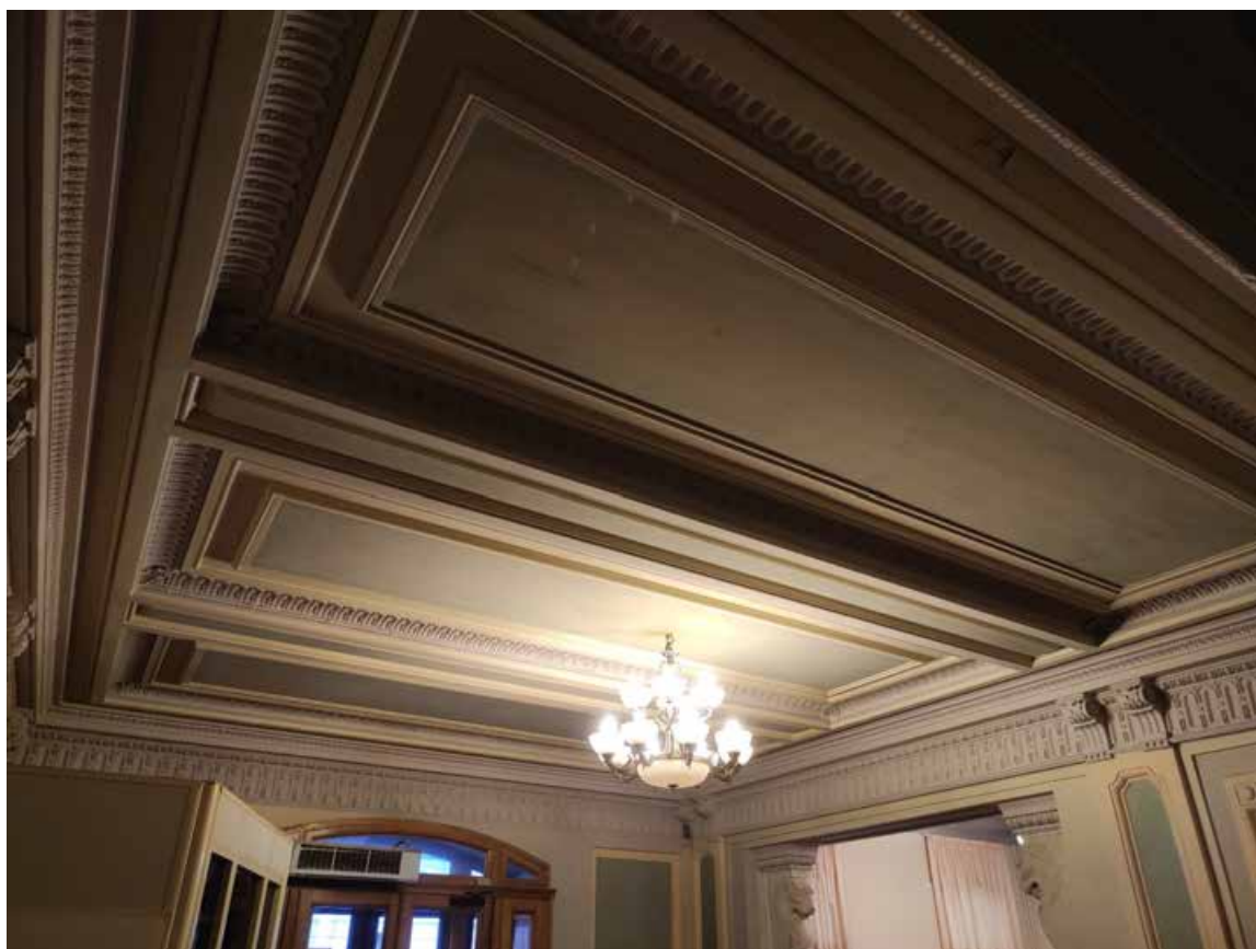
5. Потолок вестибюля корпуса по Галерной улице (пом. № 1).
