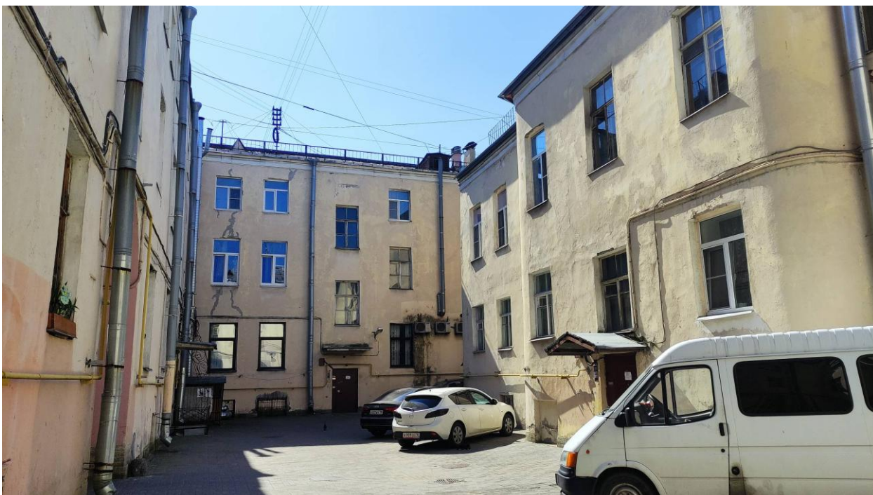
Фото 13. Фрагмент дворового фасада выявленного объекта культурного наследия «Дом Р.В. Риттера»
