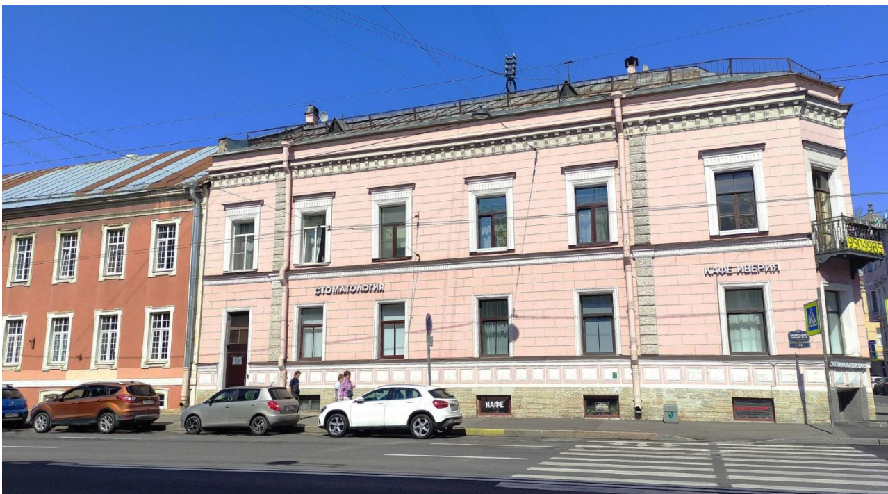
Фото 8. Фасад выявленного объекта культурного наследия «Дом Р.В. Риттера» по Кадетской линии
