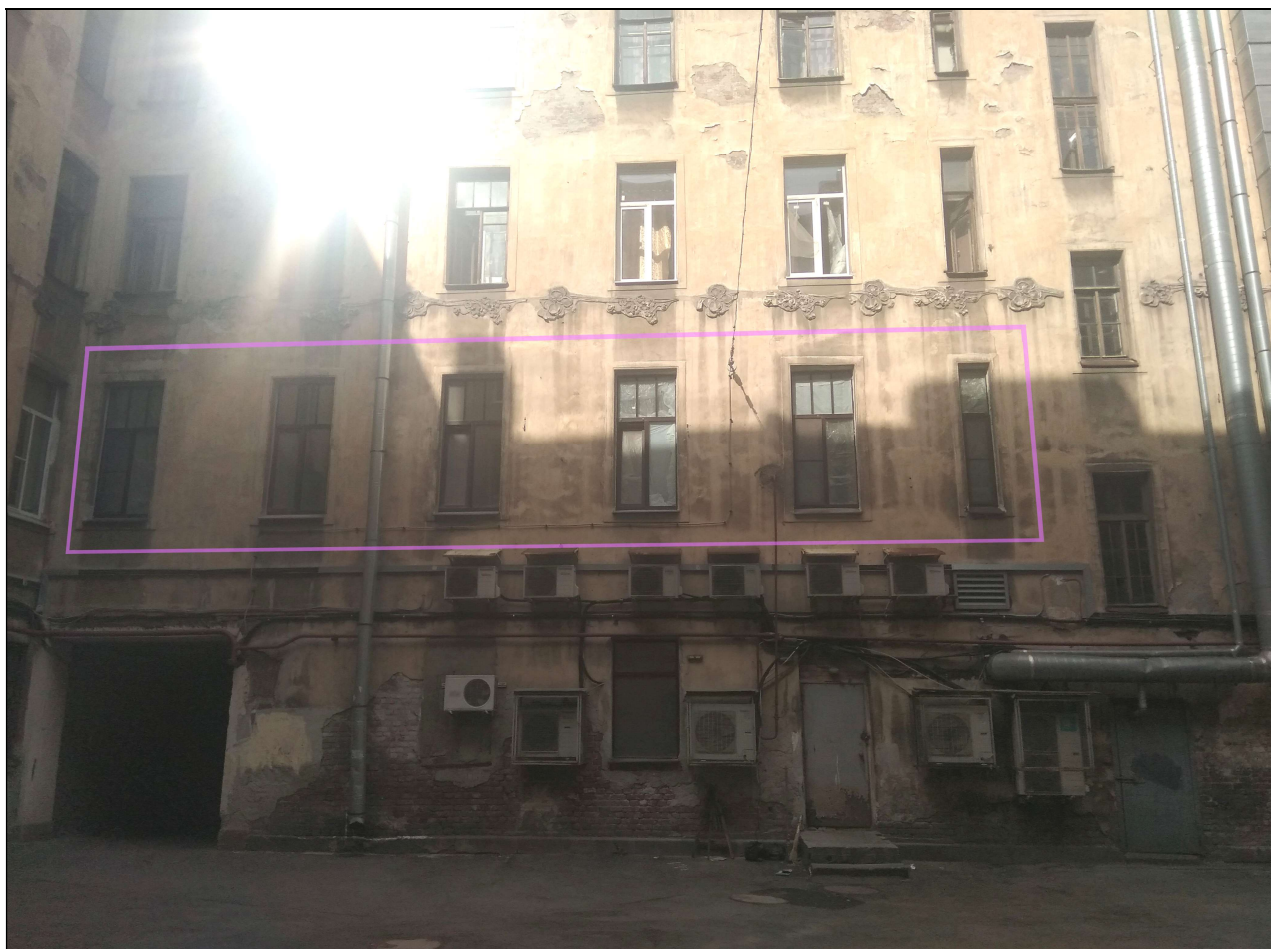
6. Выявленный объект культурного наследия «Здание Невского театра В.А. Неметти (дом В.И. Колышко)». Внутренний двор. Фрагмент дворового фасада северо-восточного корпуса. Окна квартиры № 34.
