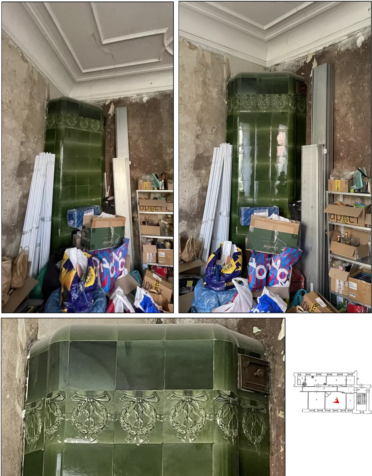
15. Комната (пом. 8: 25,7 м 2 ). Печь угловая одноярусная *.
