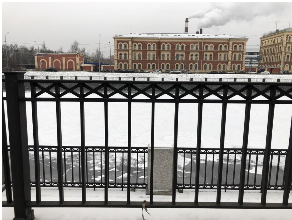
12. Объект культурного наследия регионального значения «Набережная Обводного канала» по адресу: от Шлиссельбургского моста до Московской ж. д. Участок от протоки Французского ковша до Атаманского моста, левый берег. Вид в сторону правого берега с верхнего уровня. Верхний уровень. Металлическое ограждение. Фрагмент.
