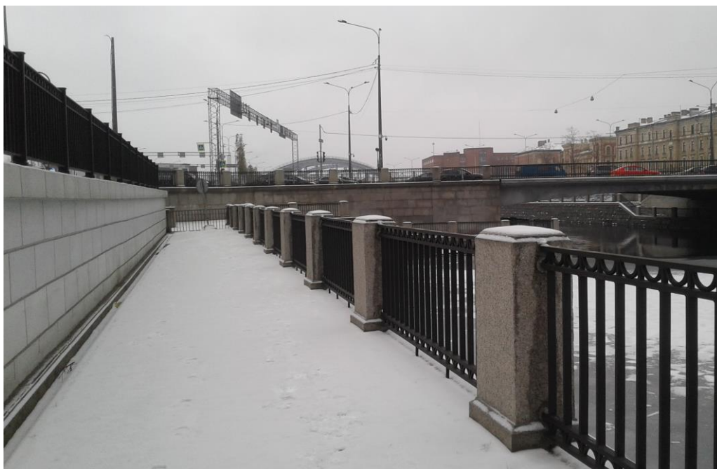
16. Объект культурного наследия регионального значения «Набережная Обводного канала» по адресу: от Шлиссельбургского моста до Московской ж. д. Участок от протоки Французского ковша до Атаманского моста, левый берег. Нижний уровень. Вид в западном направлении на Атаманский мост.
