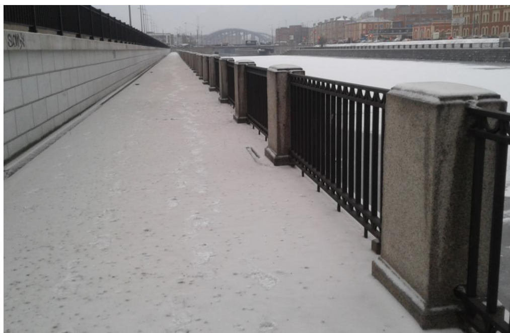
18. Объект культурного наследия регионального значения «Набережная Обводного канала» по адресу: от Шлиссельбургского моста до Московской ж. д. Участок от протоки Французского ковша до Атаманского моста, левый берег. Нижний уровень. Общий вид в западном направлении (в сторону Атаманского моста).
