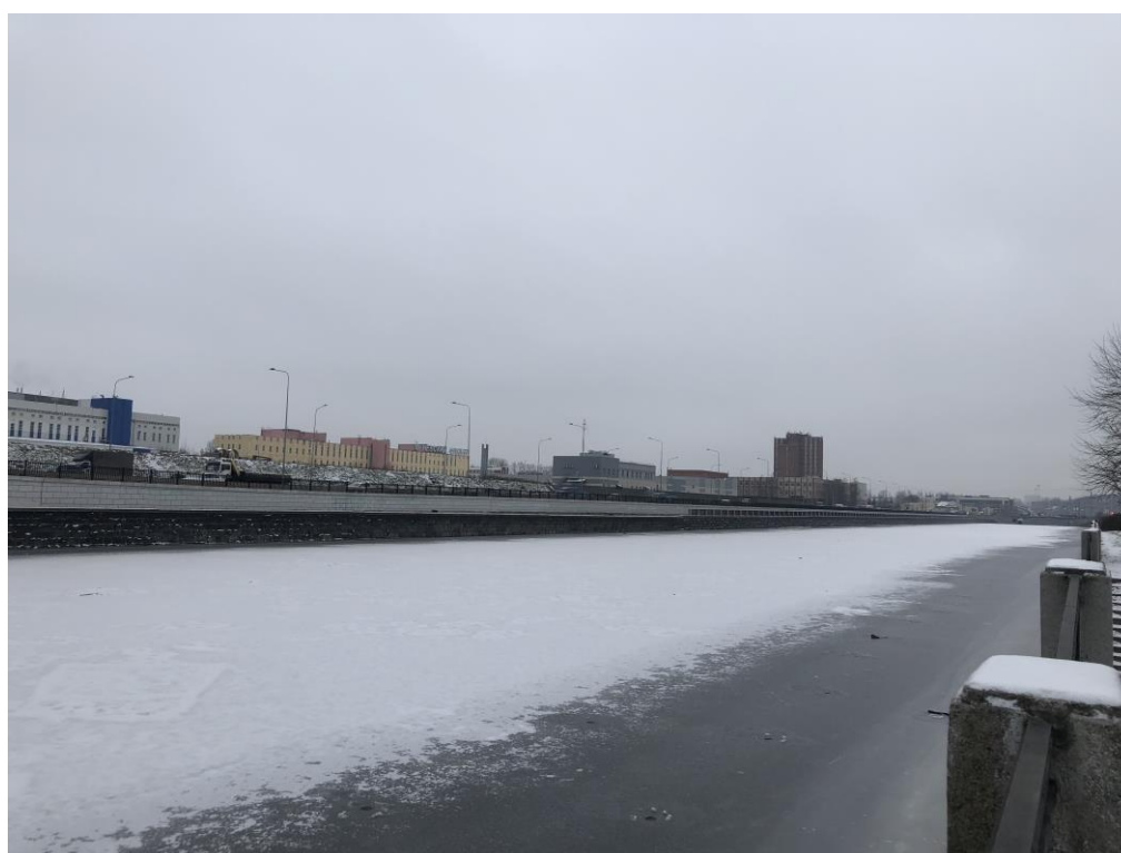
2. Объект культурного наследия регионального значения «Набережная Обводного канала» по адресу: от Шлиссельбургского моста до Московской ж. д. Участок от протоки Французского ковша до Атаманского моста, левый берег. Общий вид с правого берега в западном направлении (в сторону Атаманского моста).
