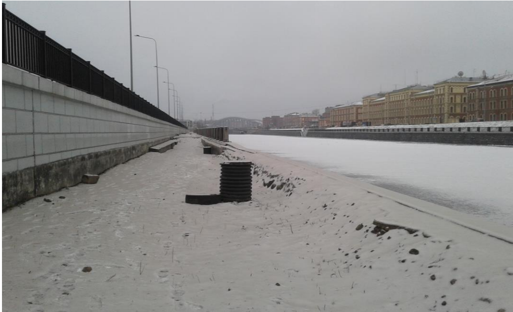
23. Объект культурного наследия регионального значения «Набережная Обводного канала» по адресу: от Шлиссельбургского моста до Московской ж. д. Участок от протоки Французского ковша до Атаманского моста, левый берег. Нижний уровень. Фрагмент (вид в западном направлении в сторону Атаманского моста). Парапет отсутствует.
