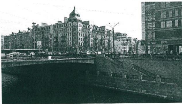
9. Лестничный спуск на нижний ярус. Стенки набережной имеют линейный руст
