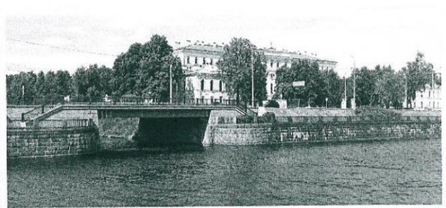
25, 26. Участок восточнее от Атаманского моста вдоль южной стенки имеет отклонение стенки в сторону воды, провалы и трещины в покрытии
