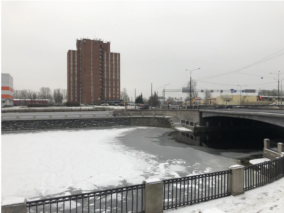
5. Объект культурного наследия регионального значения «Набережная Обводного канала» по адресу: от Шлиссельбургского моста до Московской ж. д. Участок от протоки Французского ковша до Атаманского моста, левый берег. Фрагмент. Вид с правого берега в западном направлении в сторону Атаманского моста.
