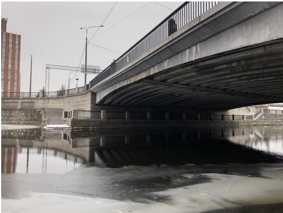
6. Объект культурного наследия регионального значения «Набережная Обводного канала» по адресу: от Шлиссельбургского моста до Московской ж. д. Участок от протоки Французского ковша до Атаманского моста, левый берег. Вид на нижний ярус с правого берега (Атаманский мост).
