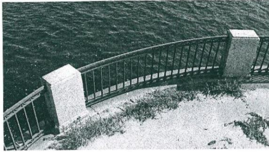
25, 26. Участок восточнее от Атаманского моста вдоль южной стенки имеет отклонение стенки в сторону воды, провалы и трещины в покрытии
