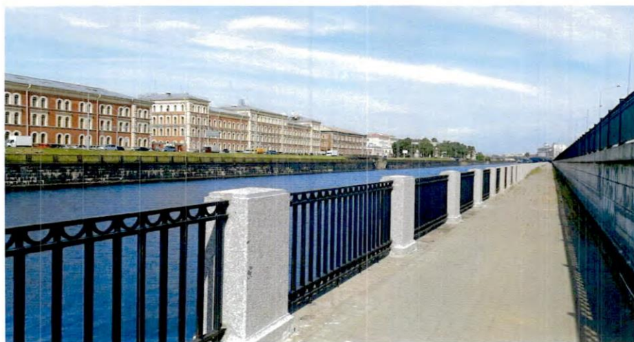
22. Парапет из гранитных тумб и металлической решетки
