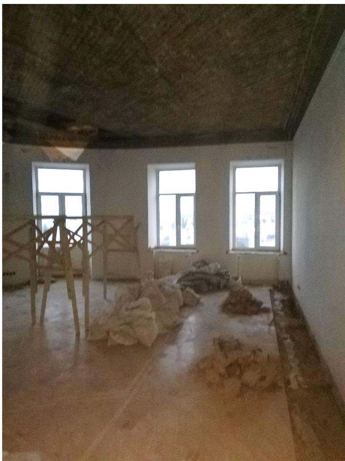
Фото 16. Отсутствие внешней отделки, складирование строительного мусора.
