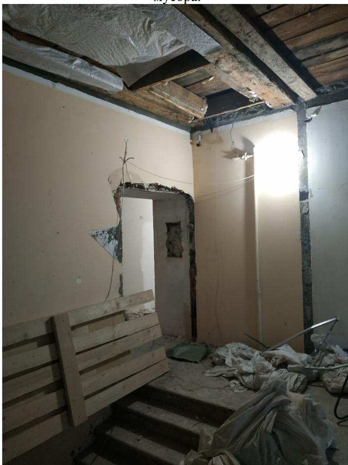
Фото 22. Лестница ЗЛК, 3 этаж. Отсутствие внешней отделки, складирование строительного мусора.
