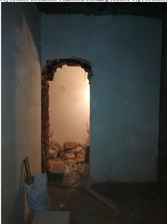
Фото 4. Отсутствие внешней отделки, складирование строительного мусора. Частичная вывалка кирпича в дверном проёме.
