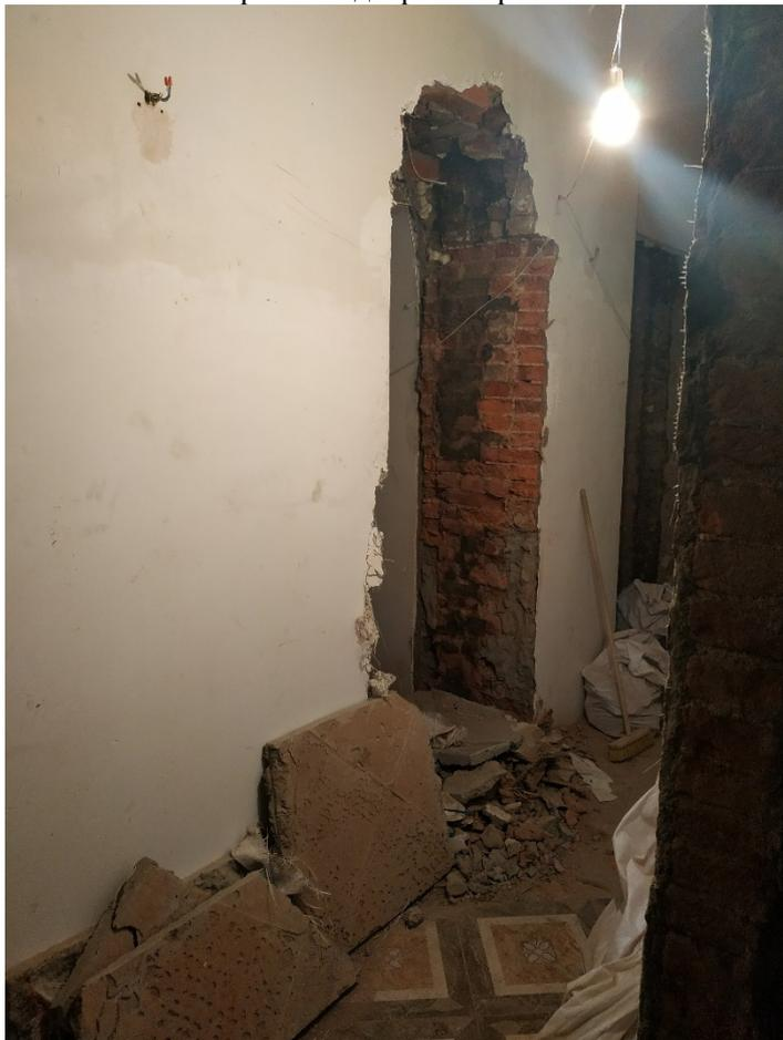
Фото 14. Отсутствие внешней отделки, складирование строительного мусора. Частичная вывалка кирпича в дверном проёме.
