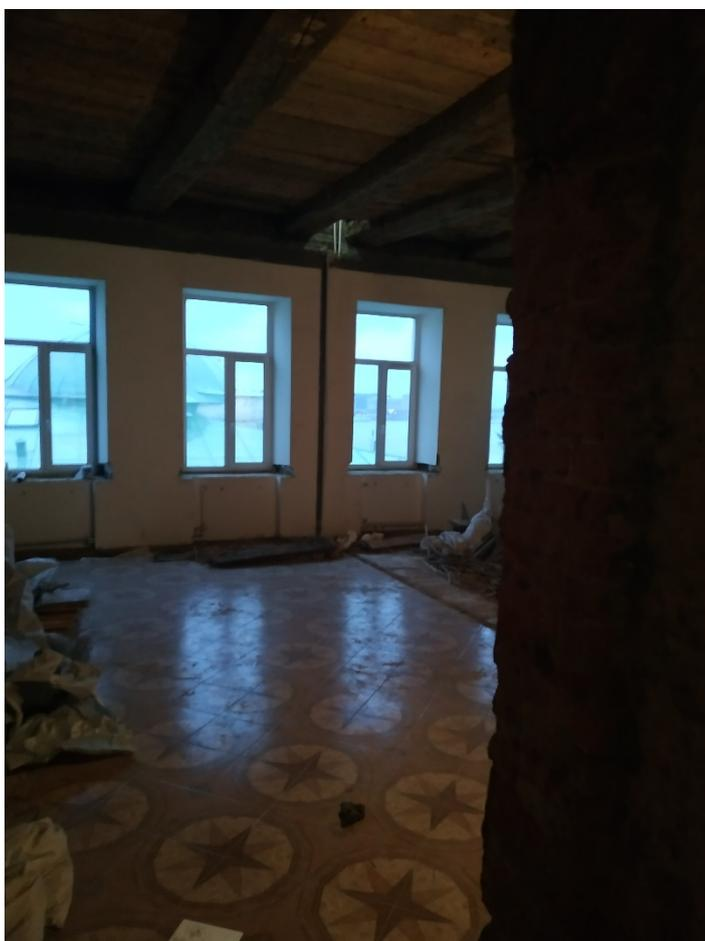
Фото 8. Отсутствие внешней отделки, складирование строительного мусора.
