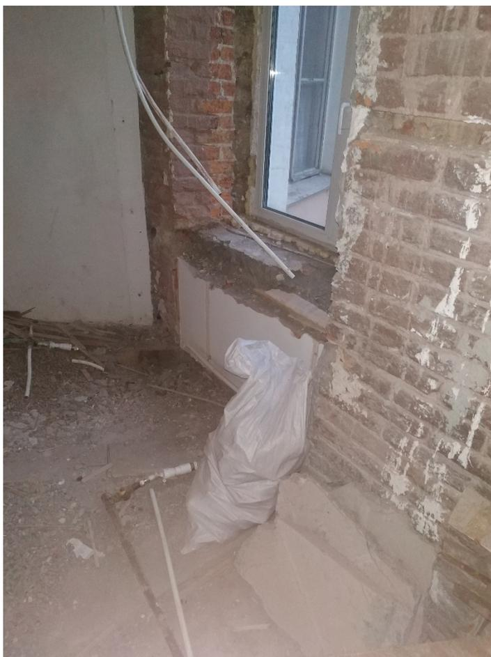
Фото 2. Отсутствие внешней отделки, складирование строительного мусора.
