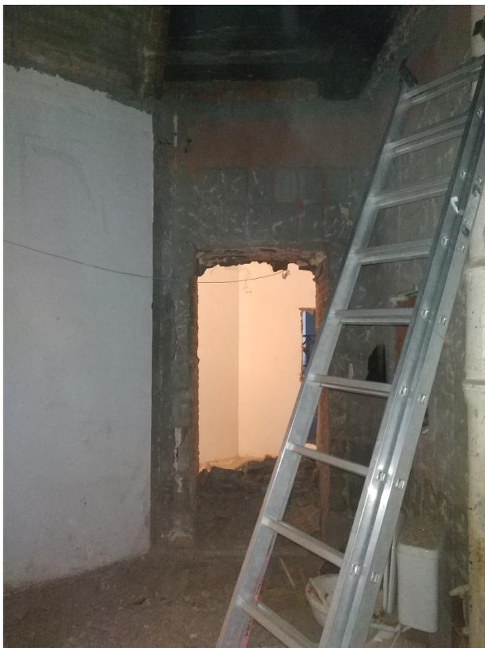
Фото 3. Отсутствие внешней отделки, складирование строительного мусора.
