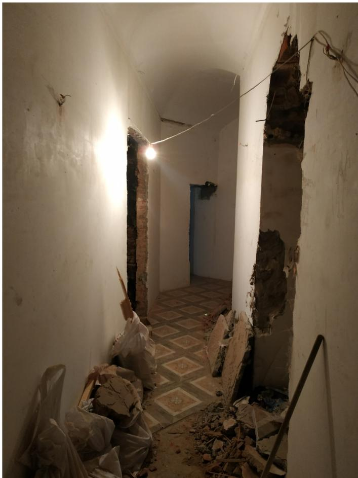
Фото 13. Отсутствие внешней отделки, складирование строительного мусора. Частичная вывалка кирпича в дверном проёме.
