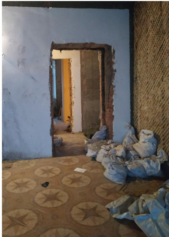
Фото 12. Отсутствие внешней отделки, складирование строительного мусора.
