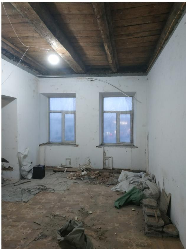
Фото 38. Отсутствие внешней отделки, складирование строительного мусора.
