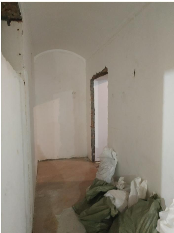
Фото 27. Отсутствие внешней отделки, складирование строительного мусора.
