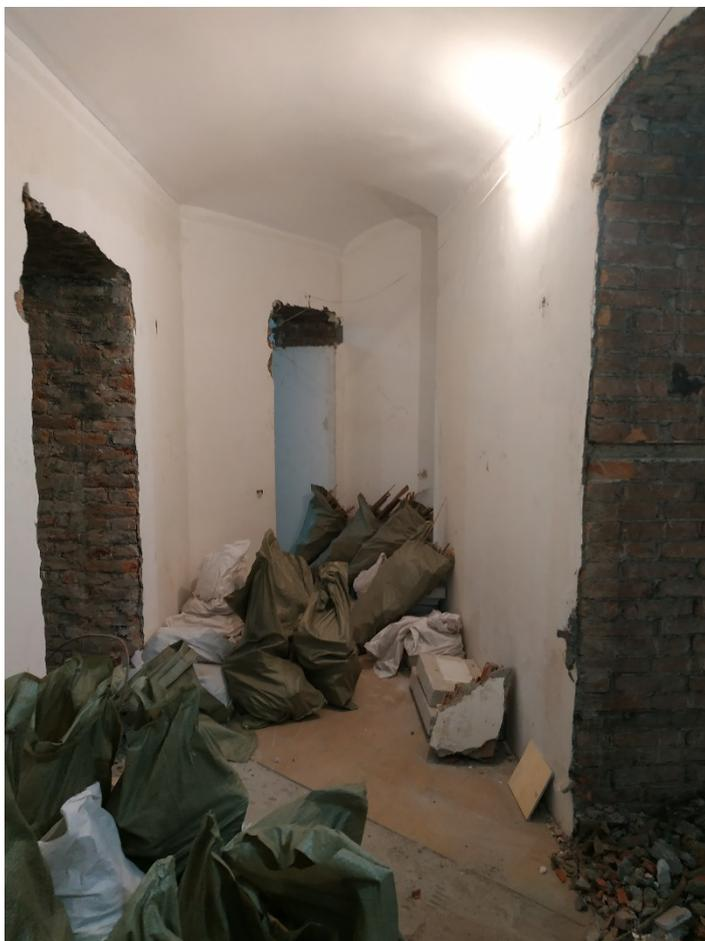
Фото 39. Отсутствие внешней отделки, складирование строительного мусора.
