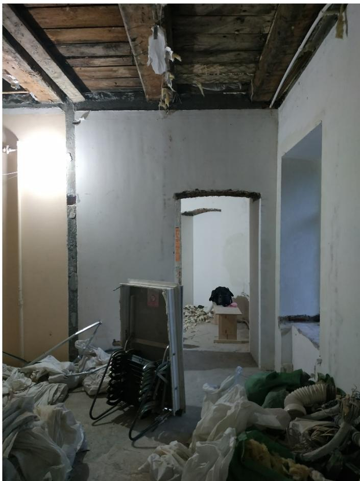
Фото 23. Лестница ЗЛК, 3 этаж. Отсутствие внешней отделки, складирование строительного мусора.
