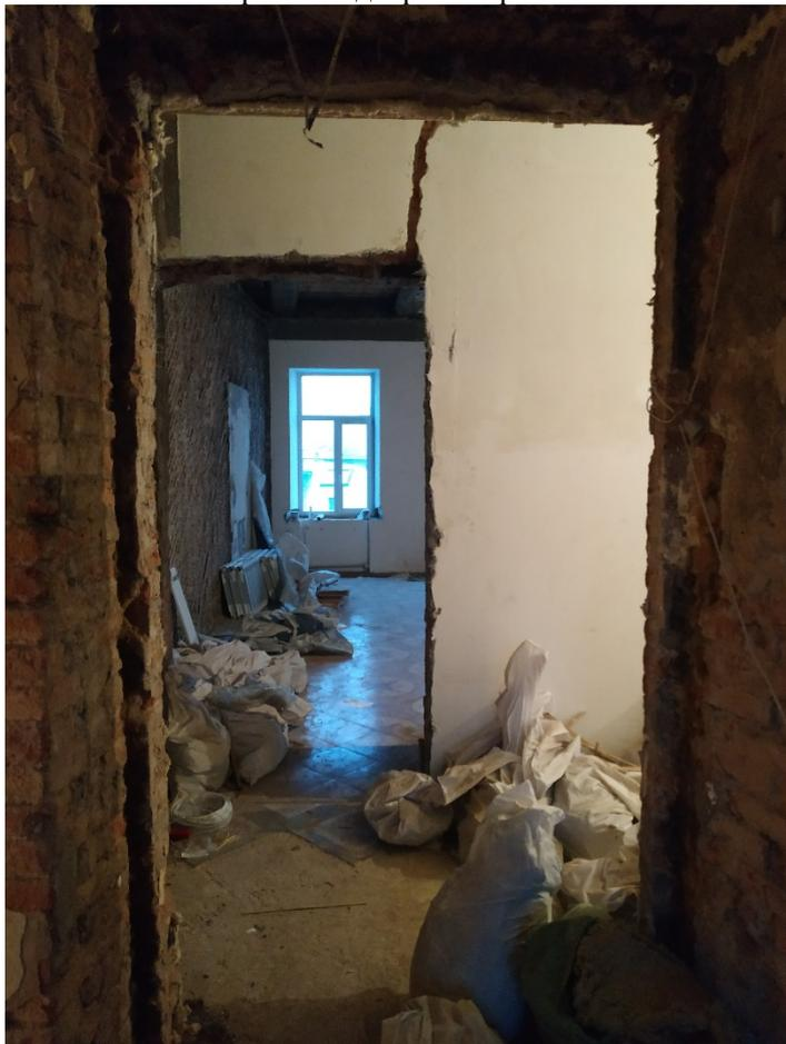
Фото 6. Отсутствие внешней отделки, складирование строительного мусора.
