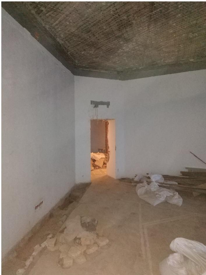
Фото 19. Отсутствие внешней отделки, складирование строительного мусора.
