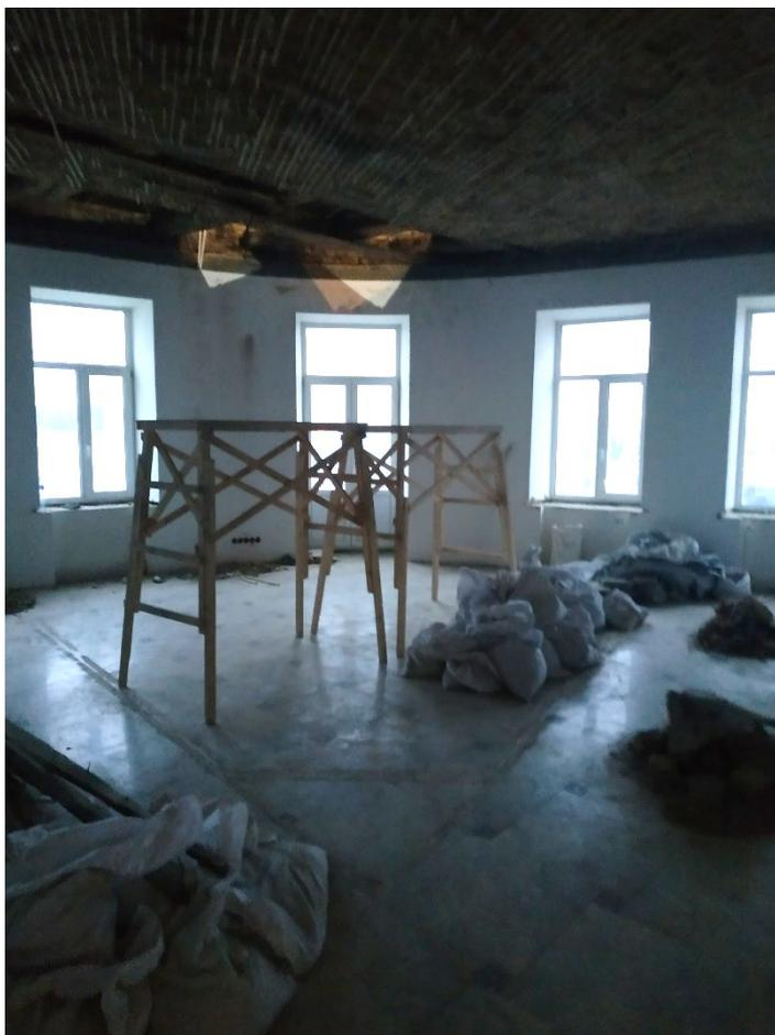
Фото 17. Отсутствие внешней отделки, складирование строительного мусора.
