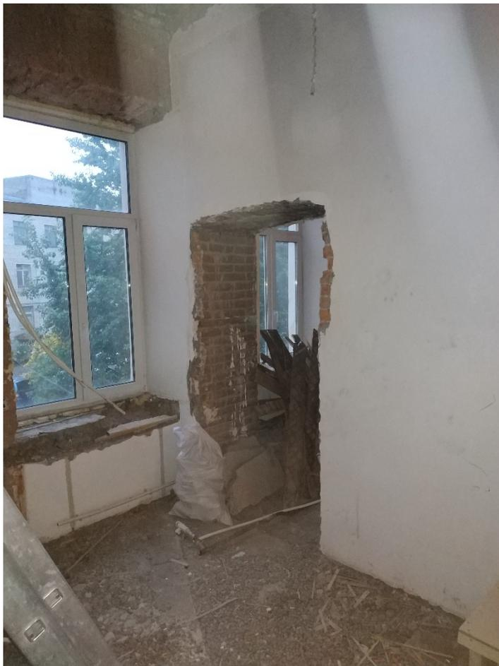
Фото 5. Отсутствие внешней отделки, складирование строительного мусора. Частичная вывалка кирпича в дверном проёме.
