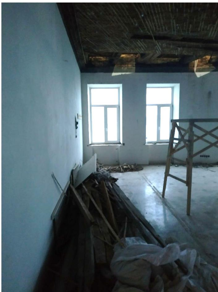
Фото 18. Отсутствие внешней отделки, складирование строительного мусора.
