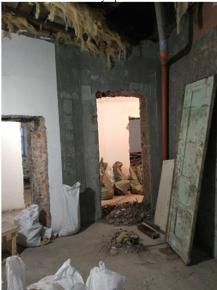
Фото 24. Отсутствие внешней отделки, складирование строительного мусора.
