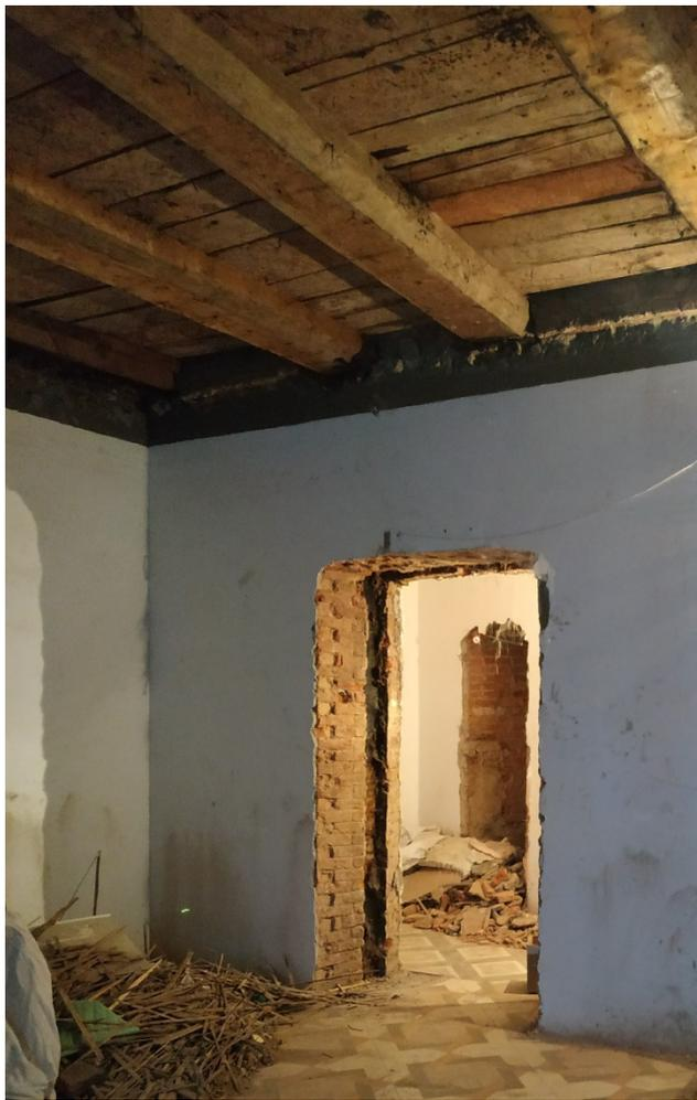
Фото 11. Отсутствие внешней отделки, складирование строительного мусора.
