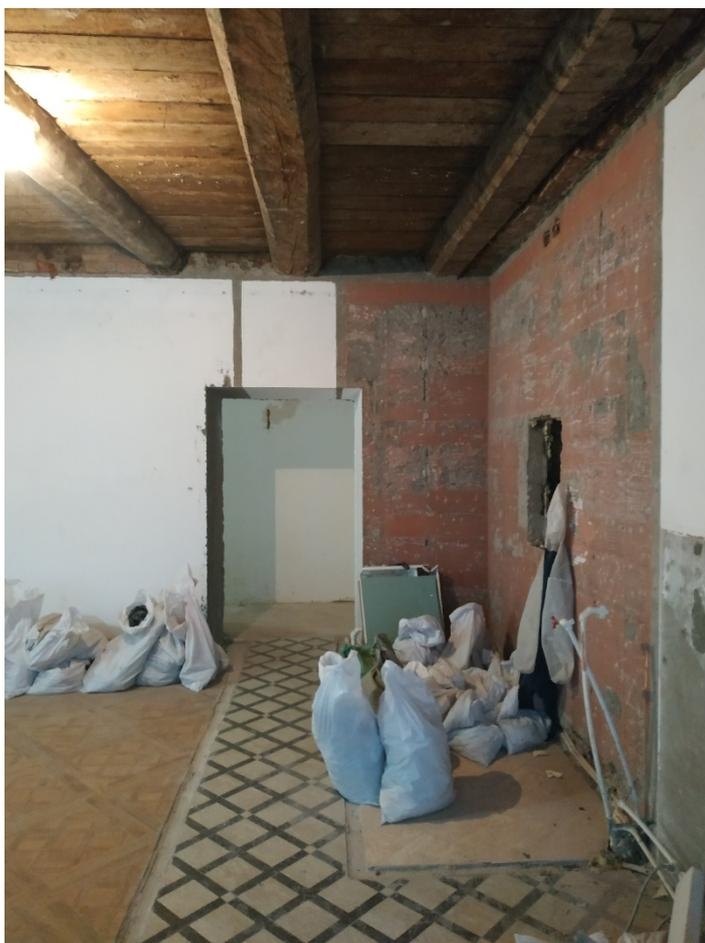
Фото 28. Отсутствие внешней отделки, складирование строительного мусора.
