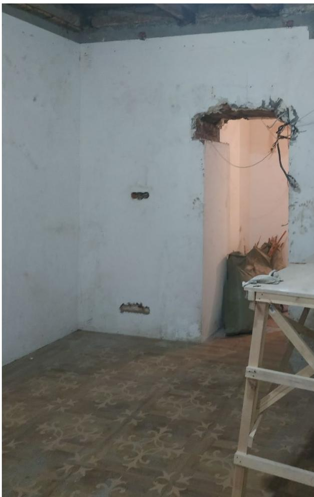
Фото 37. Отсутствие внешней отделки, складирование строительного мусора.
