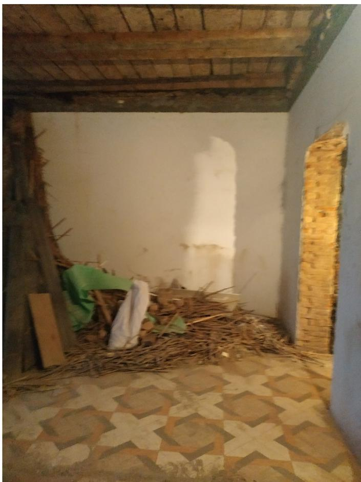
Фото 10. Отсутствие внешней отделки, складирование строительного мусора.
