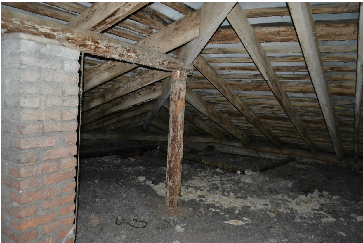
Фото 45. Чердачное пространство Общежития №1. Секция №2. Вид с северо-запада.
