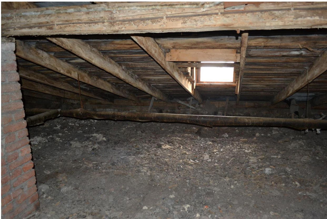
Фото 39. Слуховое окно чердачного пространства секции №4 здания Общежития №6. Вид с северо-запада.
