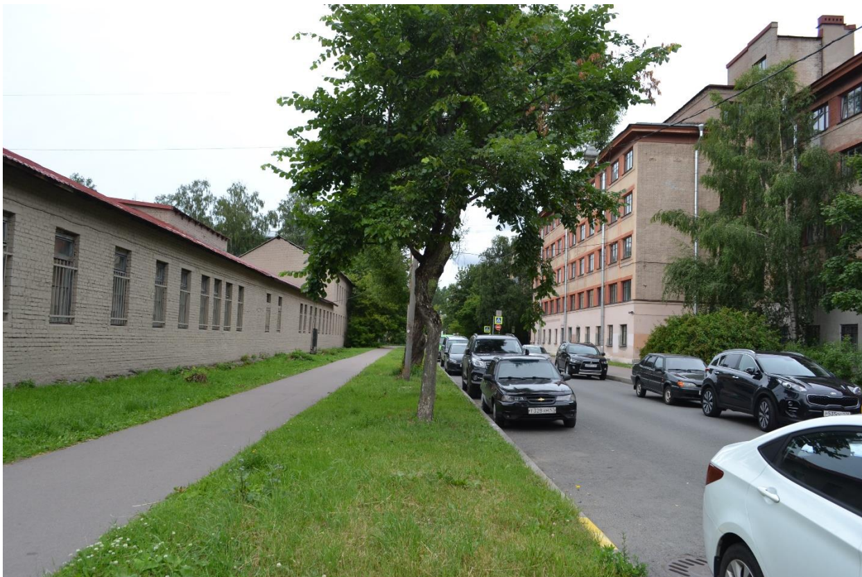
Фото 17. Перспектива Парголовской улицы. Студенческий городок («Комплекс зданий Студенческого городка Политехнического института»). Вид с юго-востока.
