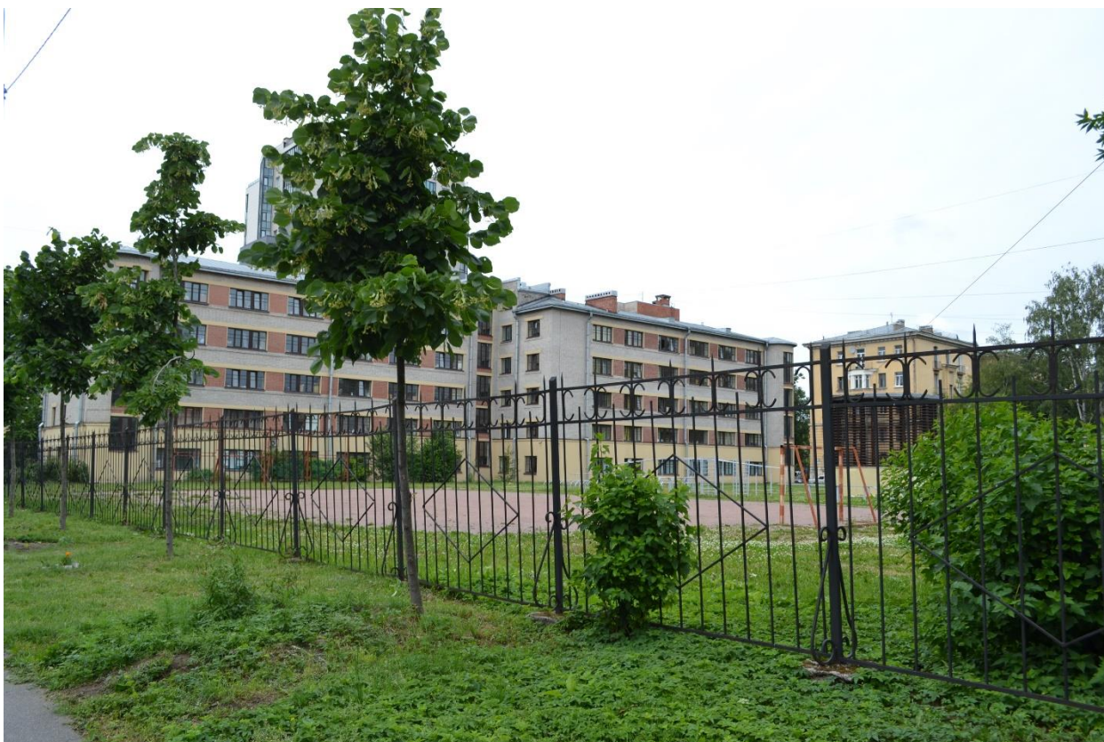
Фото 20. Вид на здания Общежития №3 («Жилой корпус»). Территория Студенческого городка («Комплекс зданий Студенческого городка Политехнического института»). Вид с юго-востока.
