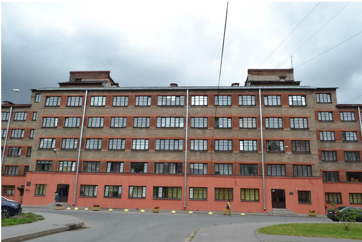
Фото 3. Часть дворового фасада здания Общежития №6 – секция №3 («Жилой корпус»). Вид с юго-запада.
