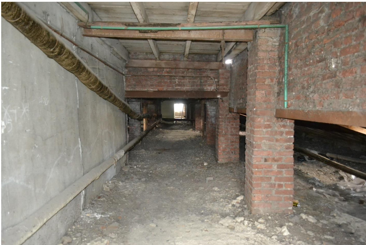
Фото 37. Общий вид чердачного пространства секции №4 здания Общежития №6. Вид с северо-запада.
