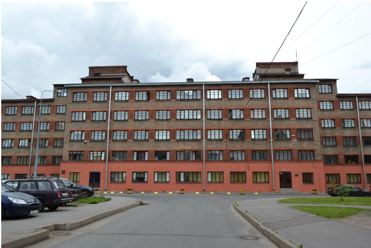
Фото 13. Вид на придомовую территорию здания Общежития №6 («Жилой корпус»). Вид с юго-запада.
