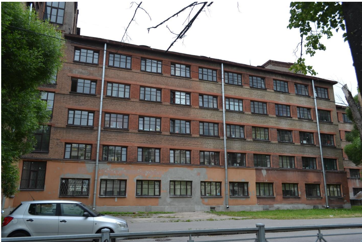
Фото 7. Часть фасада здания Общежития №6 («Жилой корпус») по улице Харченко – секция №2. Вид с северо-востока.
