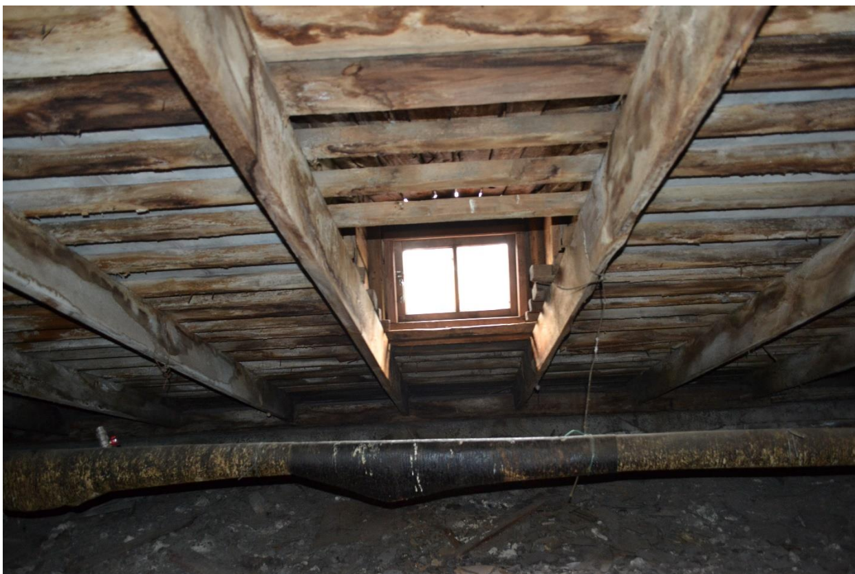
Фото 44. Слуховое окно чердачного пространства секции №5 здания Общежития №6. Вид с юго-востока.
