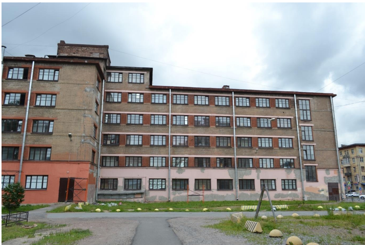
Фото 2. Часть дворового фасада здания Общежития №6 – секция №1 («Жилой корпус»). Вид с юго-запада.
