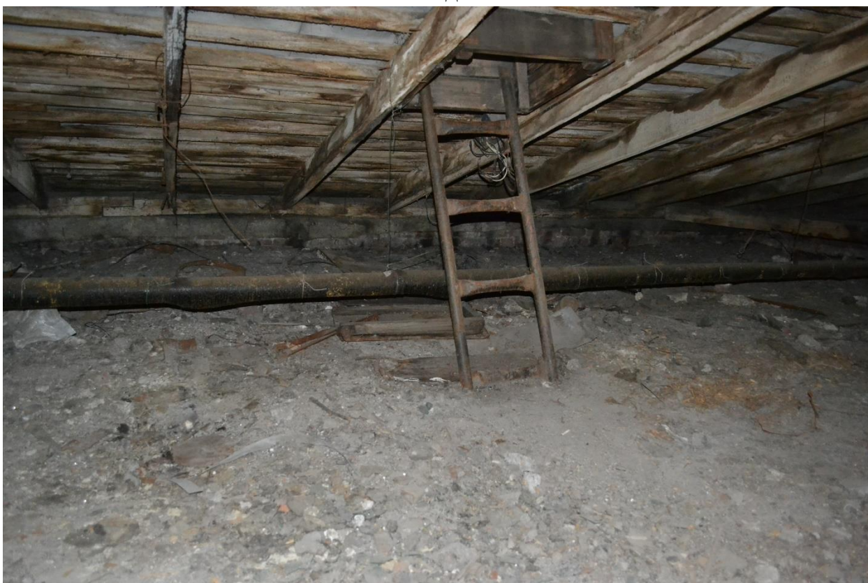
Фото 46. Металлическая лестница к слуховому окну чердачного пространства секции №5 Общежития №6. Вид с юго-востока.
