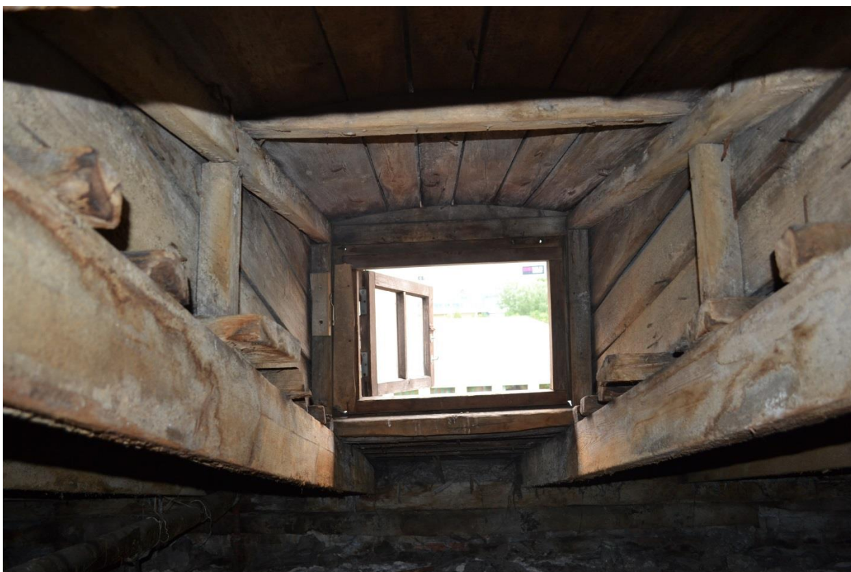
Фото 30. Слуховое окно секции №2 чердачного пространства Общежития №6. Вид с юго-востока.
