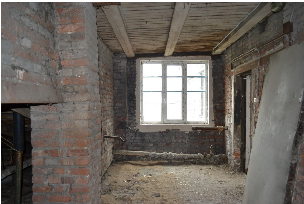
Фото 40. Чердачное пространство Общежития №6. Секция №4. Вид на узел примыкания кровли к брандмауэрной стене.
