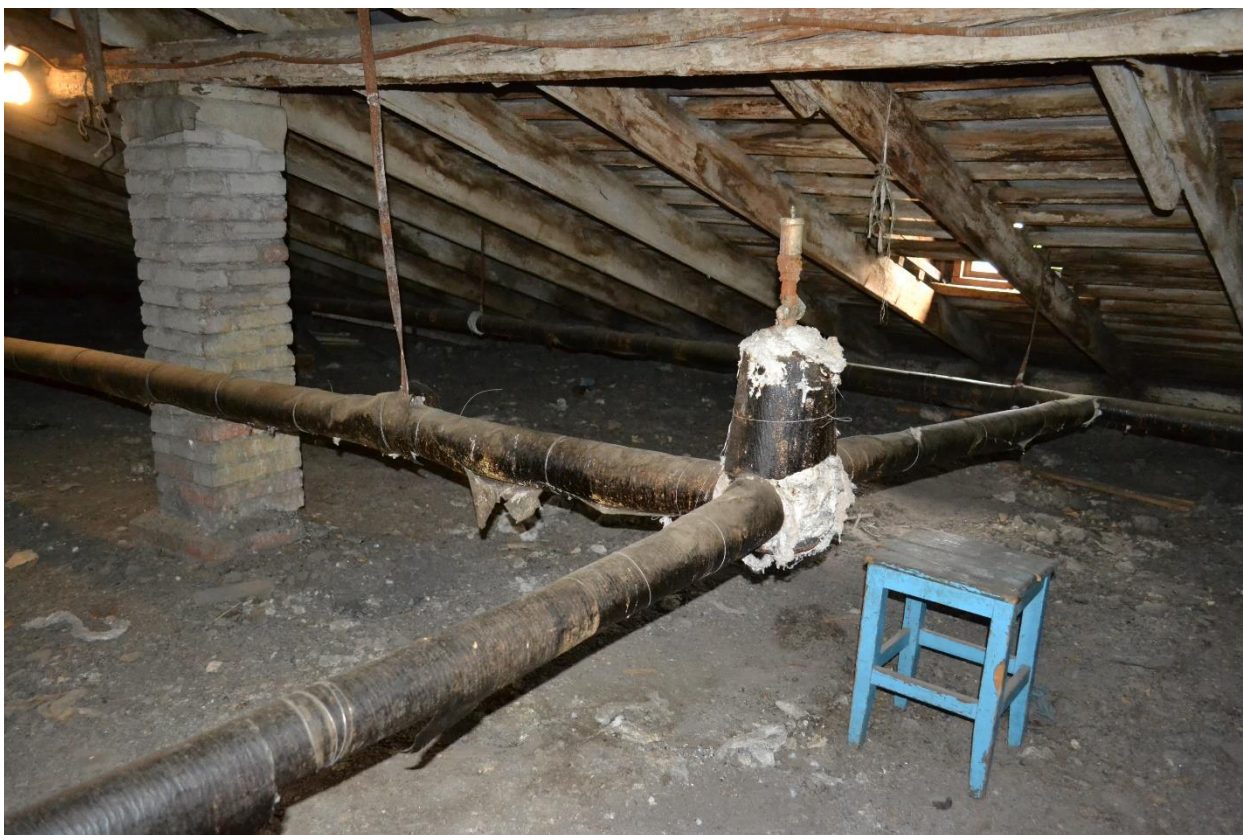
Фото 34. Общий вид чердачного пространства секции №3 здания Общежития №6. Вид с юго-запада.
