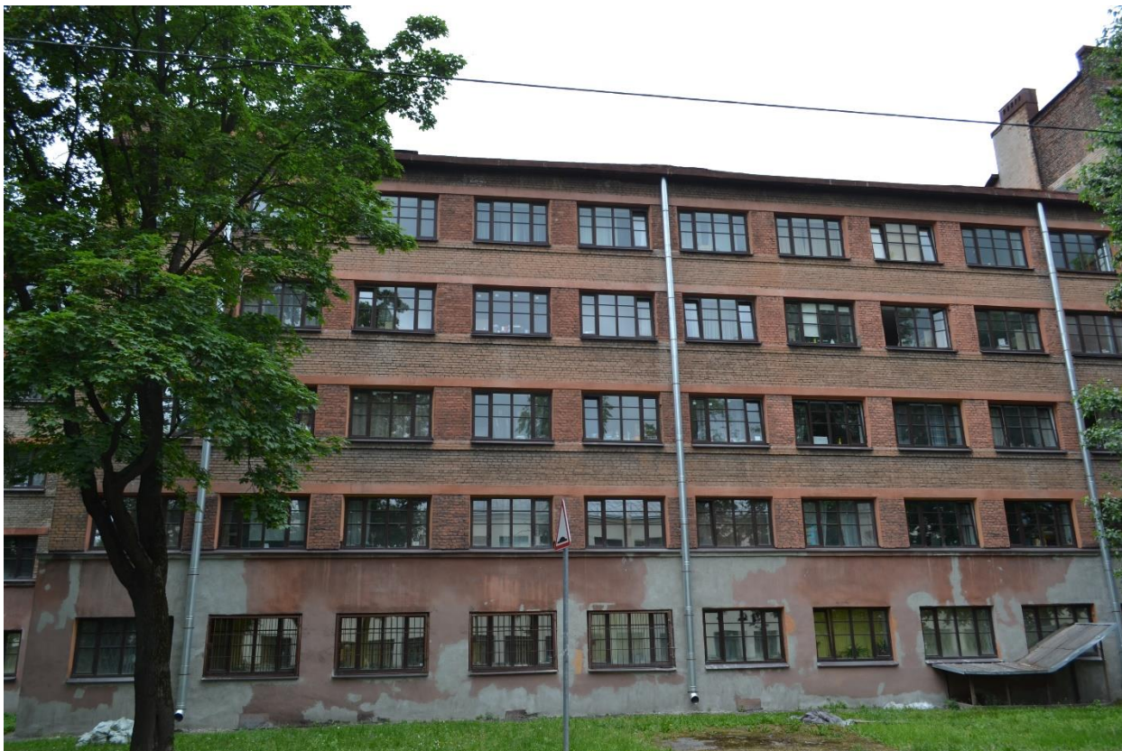
Фото 9. Часть фасада здания Общежития №6 («Жилой корпус») по улице Харченко – секция №4. Вид с северо-востока.
