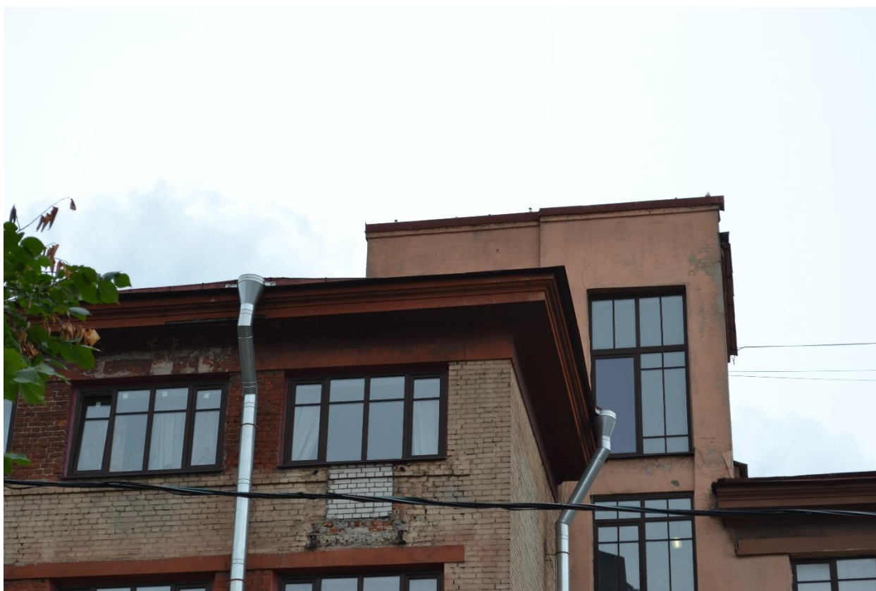
Фото 16. Вид на исторический штукатурный профилированный карниз Общежития №4 («Жилой корпус»). Вид с юго-запада.
