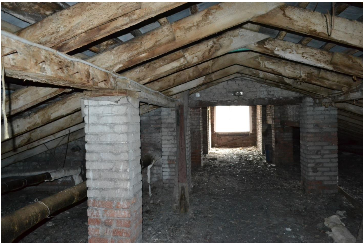
Фото 29. Чердачное пространство Общежития №6. Секция №2. Вид с северо-востока.
