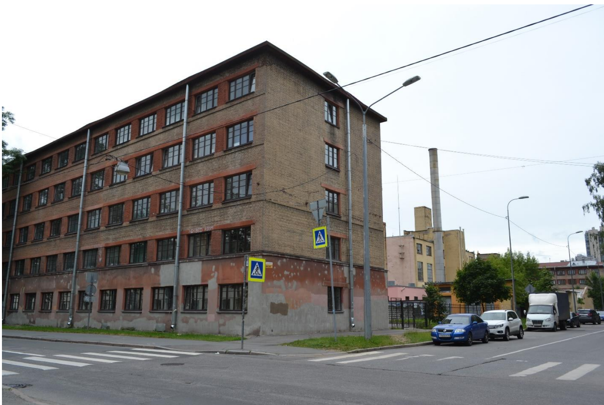
Фото 12. Фасад Общежития №6 («Жилой корпус») по улице Капитана Воронина. Вид с северо-востока.
