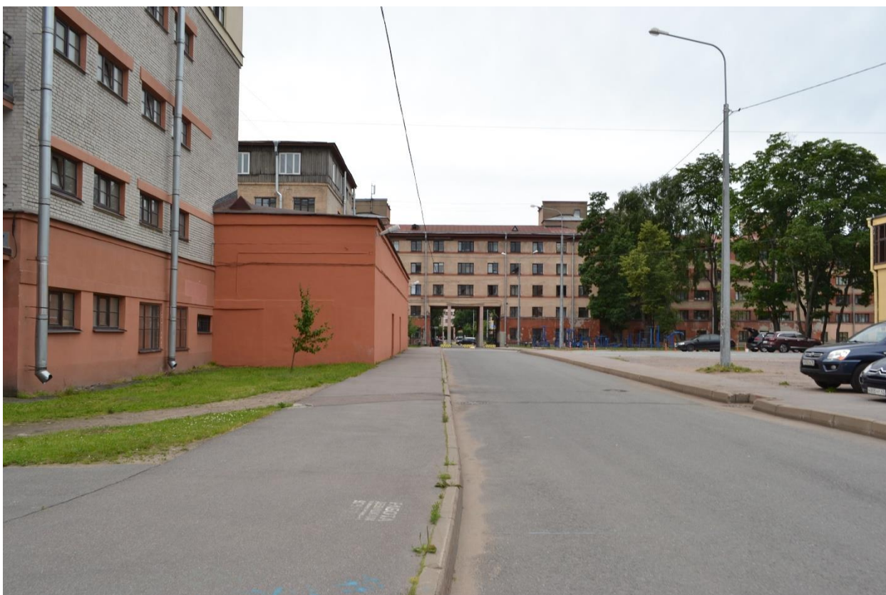
Фото 14. Вид на дворовую территорию Студенческого городка («Комплекс зданий Студенческого городка Политехнического института»). Общежитие №4 («Жилой корпус») по Парголовской ул. Вид с северо-востока.
