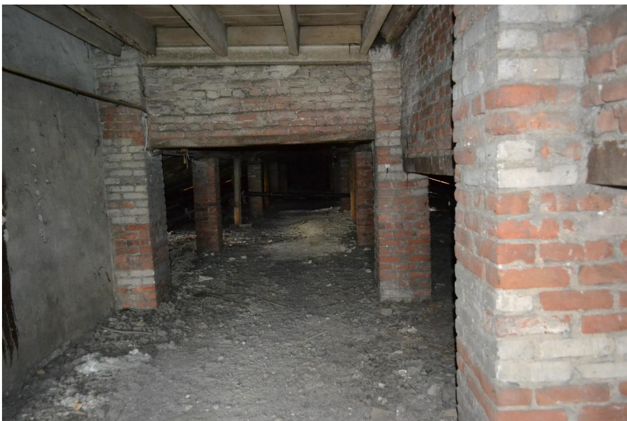
Фото 42. Чердачное пространство Общежития №6. Секция №5. Вид с северо-востока.
