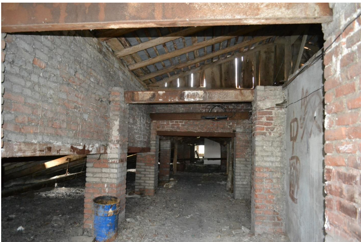
Фото 26. Чердачное пространство Общежития №6. Секция №2. Вид с юго-запада.
