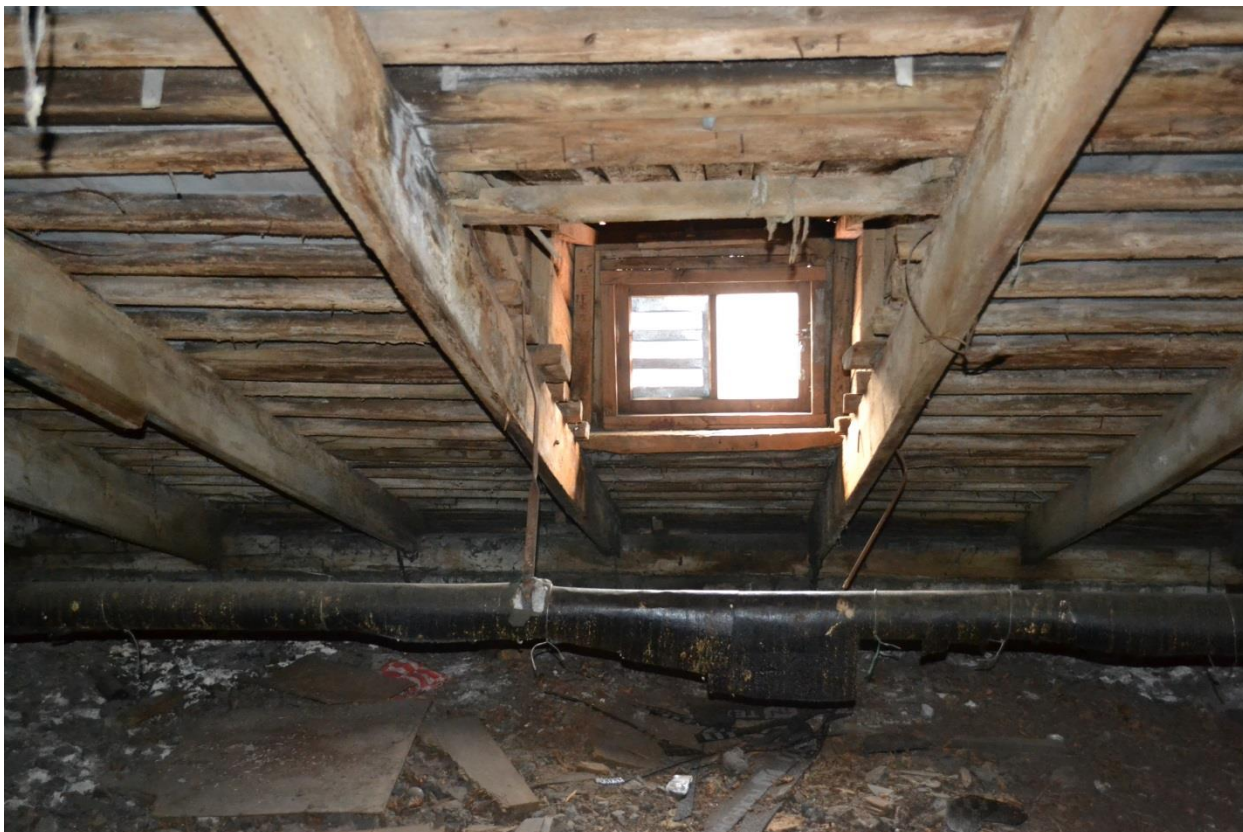
Фото 25. Слуховое окно секция №1 чердачного пространства Общежития №6. Вид с юго-востока.
