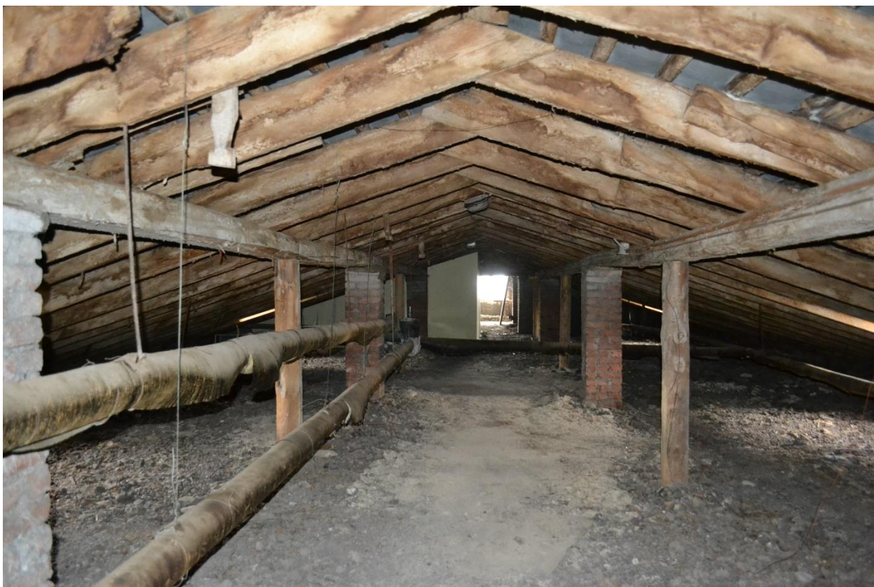
Фото 38. Чердачное пространство Общежития №6. Секция №4. Вид с северо-запада.
