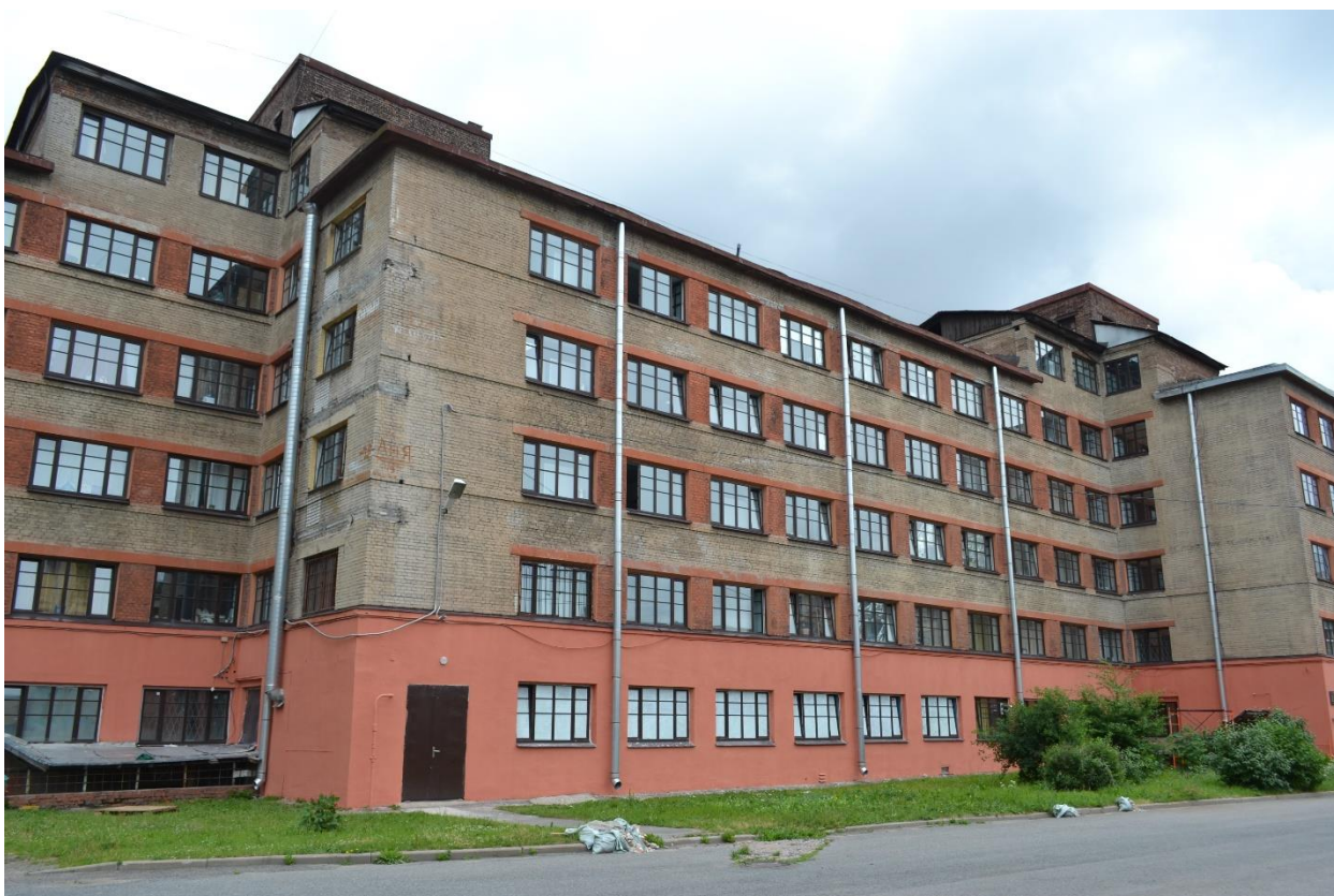
Фото 4. Часть дворового фасада здания Общежития №6 – секция №4 («Жилой корпус»). Вид с северо-запада.
