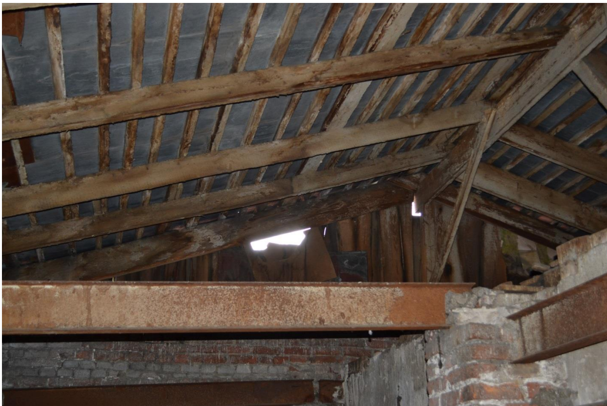
Фото 23. Чердачное пространство Общежития №6. Секция №1. Вид с юго-запада.
