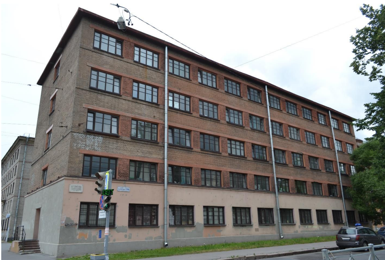
Фото 6. Часть фасада здания Общежития («Жилой корпус») №6 по улице Харченко – секция №1. Вид с юго-востока.
