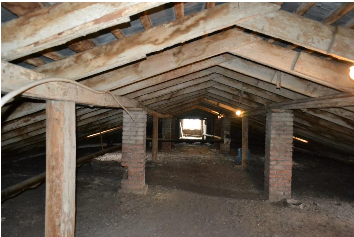
Фото 33. Общий вид чердачного пространства секции №3 здания Общежития №6. Вид с юго-востока.
