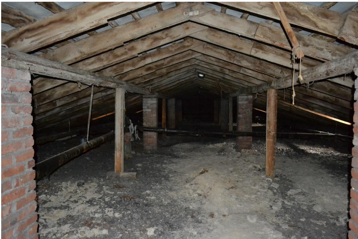
Фото 43. Общий вид чердачного пространства Общежития №6. Секция №5. Вид с северо-востока.
