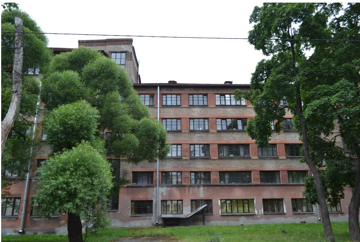
Фото 8. Часть фасада здания Общежития №6 («Жилой корпус») по улице Харченко – секция №3. Вид с северо-востока.
