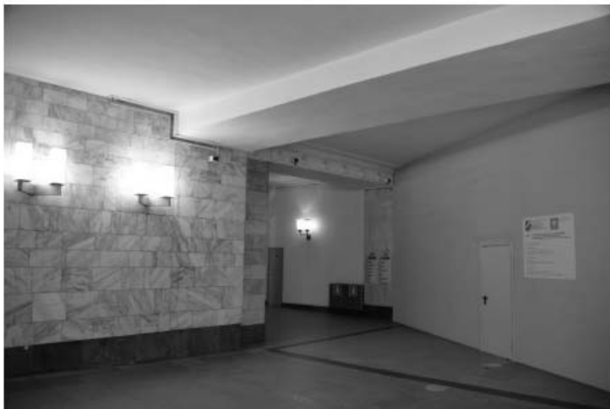
16. Фрагмент интерьера вестибюль метро «Технологический институт»
