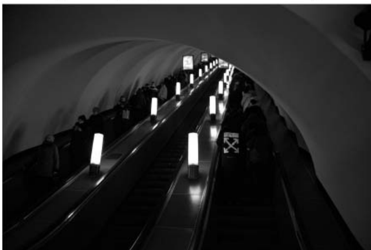
23. Наклонный ход станции «Технологический институт -2»
