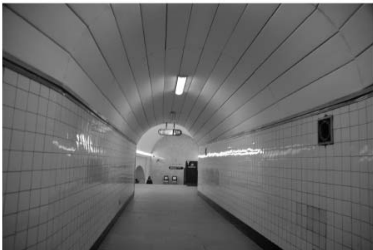
19. Переход между станциями «Технологический институт -1» и «Технологический институт -2»
