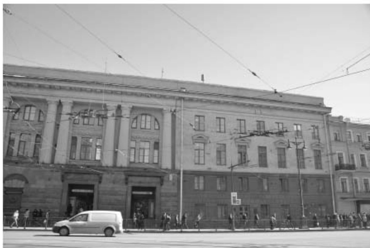
1. Станция метро «Технологический институт» (с перронным залом). Вид на западный фасад
