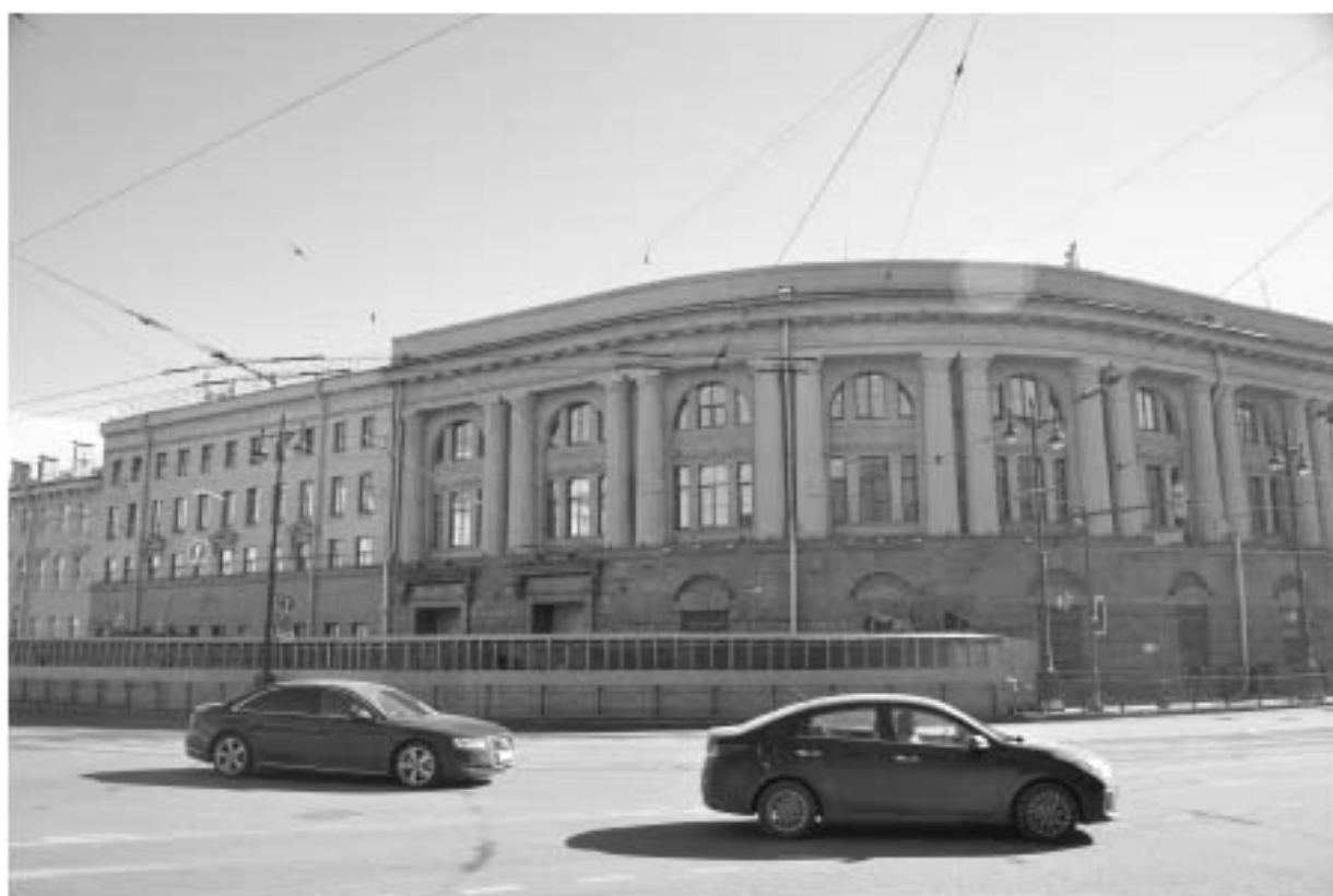
3. Станция метро «Технологический институт» (с перронным залом). Вид на северо-западный фасад
