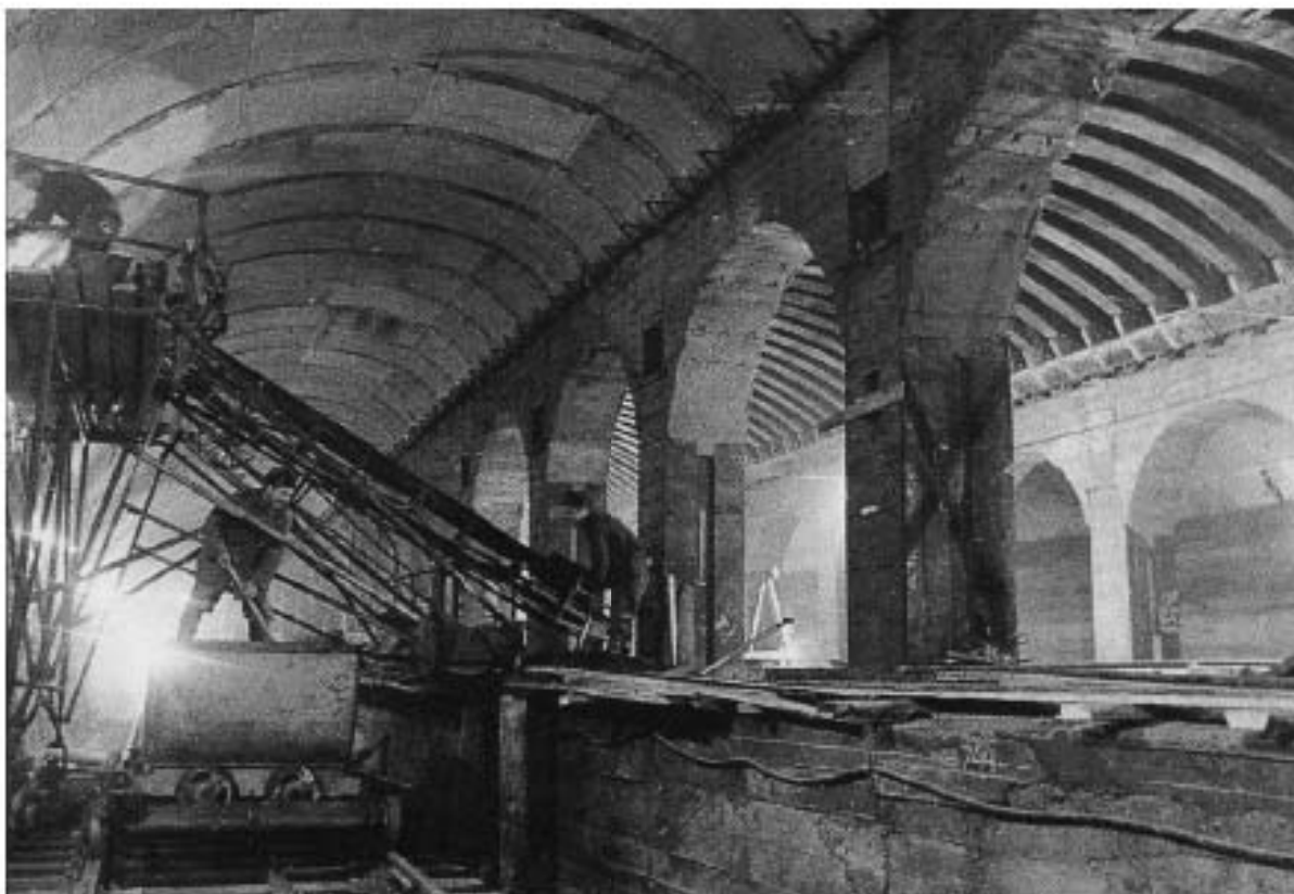
Илл. 16. Строительство станции метро "Технологический институт". 1954 – 1955. — «PastVu» – ретро-фотографии стран и городов [Электронный ресурс]. URL: https://pastvu.com/p/120854
