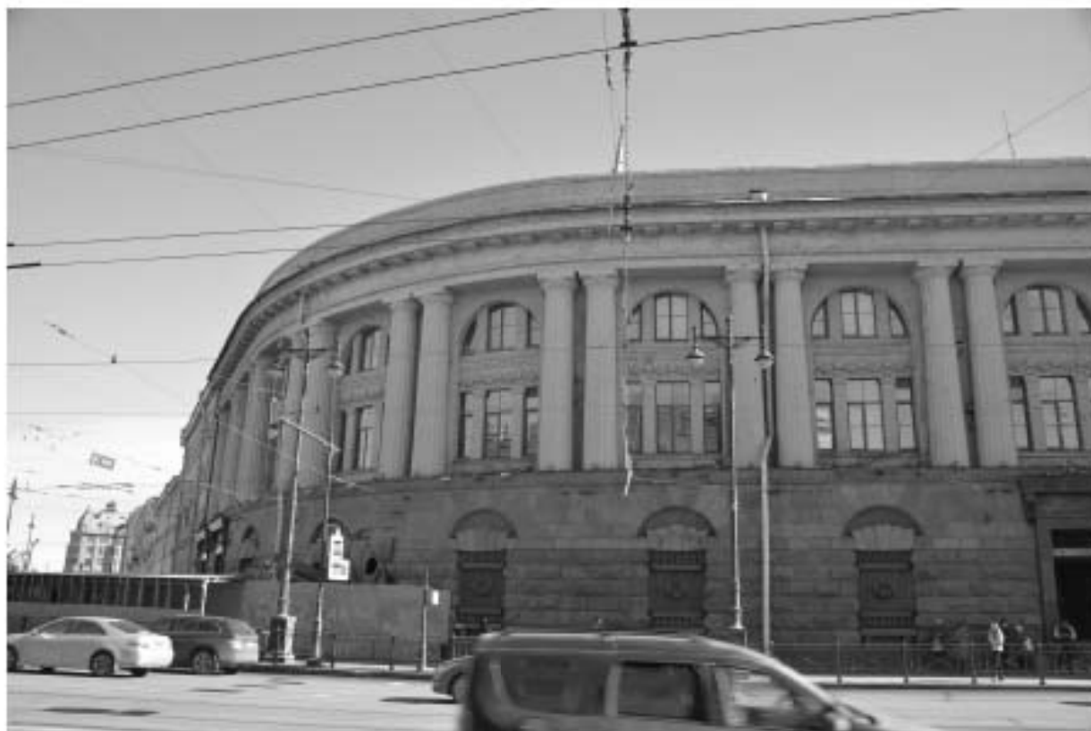
2. Станция метро «Технологический институт» (с перронным залом). Вид на северо-западный фасад
