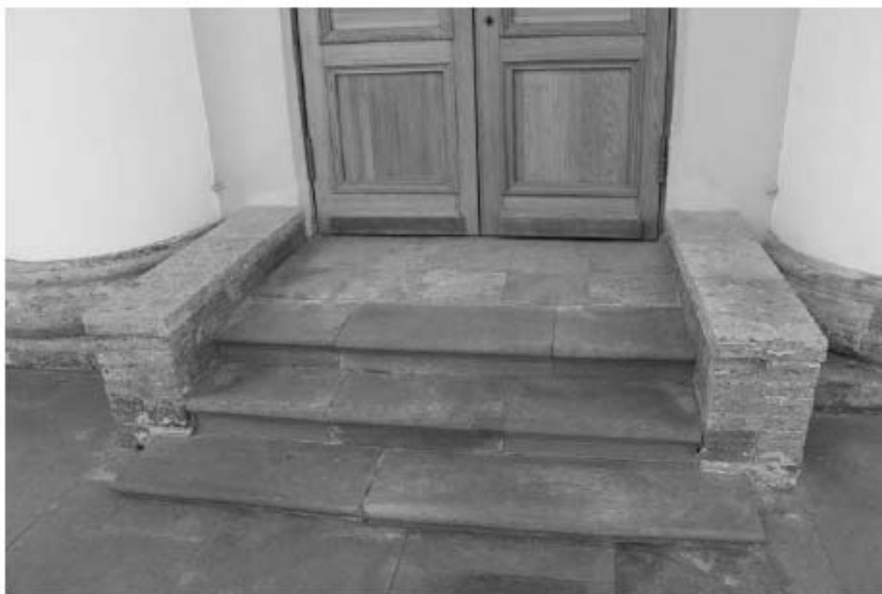
5. Крыльцо центрального портика Парадного двора объекта культурного наследия федерального значения «Дворец Таврический. Дворец», расположенного по адресу: г. Санкт-Петербург, ул. Шпалерная, д. 47, лит. А. 01.12.2020
