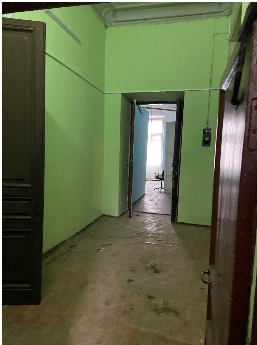
55. ОКН регионального значения «Жилой дом страхового общества “Россия” с садом и оградой» (г. Санкт-Петербург, Моховая ул., 27-29). Квартира № 37. Коридор. Пом. № 1.
