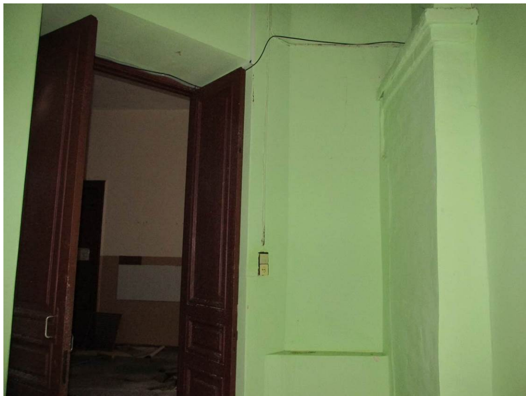
11. ОКН регионального значения «Жилой дом страхового общества “Россия” с садом и оградами» (г. Санкт-Петербург, Моховая ул., 27-29). Квартира № 37. Коридор. Пом. №. 14
