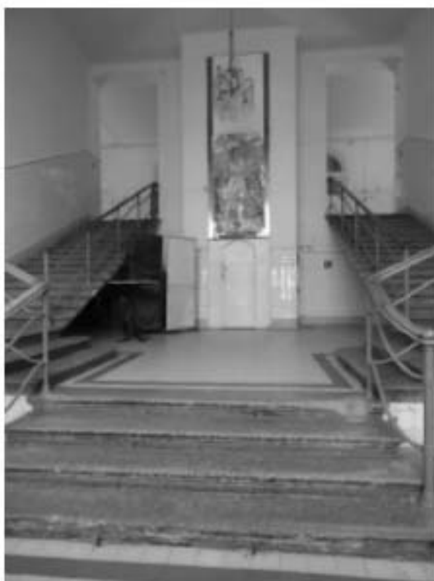
19. «Главное здание», входящее в состав объекта культурного наследия федерального значения «Институт ортопедический», Александровский парк, д.5 литера А. Лестница вестибюля парадной лестницы. Общий вид. Фото 11.03.2021 г.
