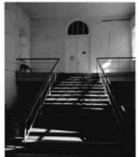
8. Лестница в центральной части здания.
