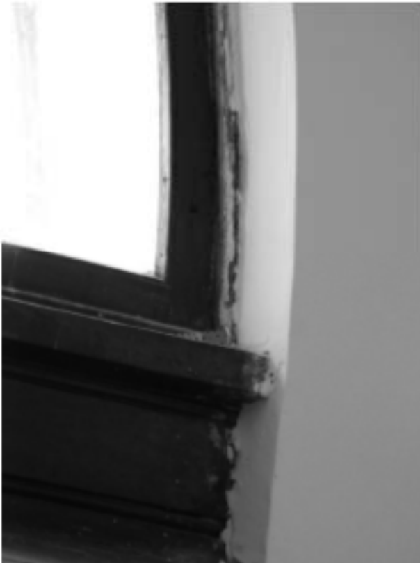
34. «Главное здание», входящее в состав объекта культурного наследия федерального значения «Институт ортопедический», Александровский парк, д.5 литера А. Главный вход. Фрагмент тамбура. Фото 11.03.2021 г.
