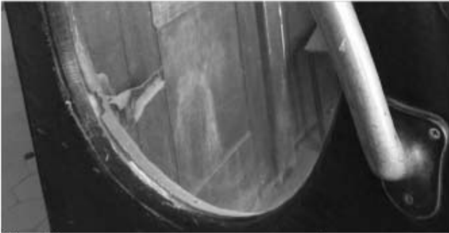
33. «Главное здание», входящее в состав объекта культурного наследия федерального значения «Институт ортопедический», Александровский парк, д.5 литера А. Главный вход. Фрагмент тамбура. Фото 11.03.2021 г.
