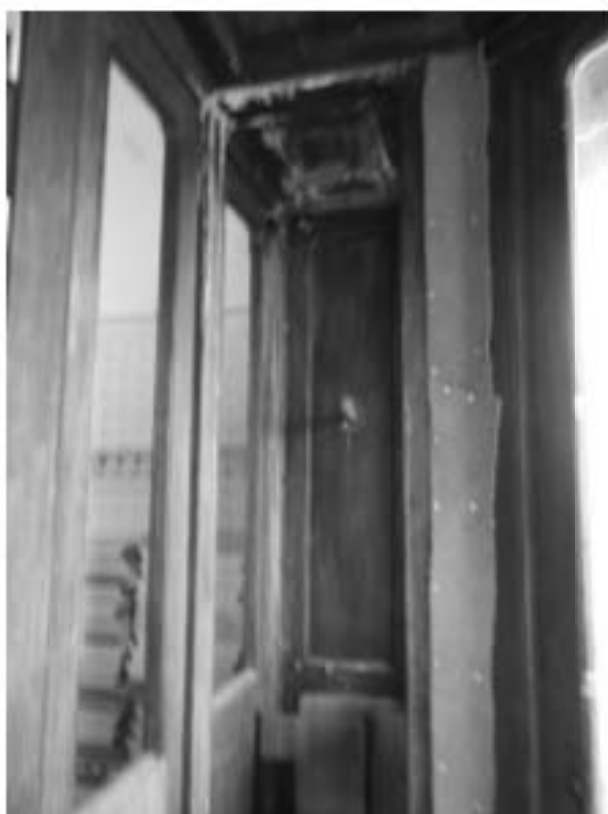
27. «Главное здание», входящее в состав объекта культурного наследия федерального значения «Институт ортопедический», Александровский парк, д.5 литера А. Главный вход. Фрагмент тамбура. Фото 11.03.2021 г.
