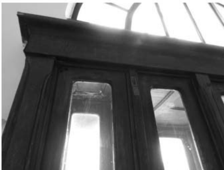
23. «Главное здание», входящее в состав объекта культурного наследия федерального значения «Институт ортопедический», Александровский парк, д.5 литера А. Главный вход. Фрагмент тамбура со стороны вестибюля. Фото 11.03.2021 г.
