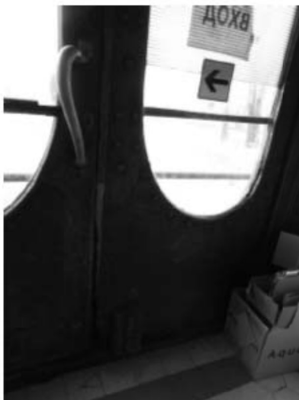
29. «Главное здание», входящее в состав объекта культурного наследия федерального значения «Институт ортопедический», Александровский парк, д.5 литера А. Главный вход. Фрагмент тамбура. Фото 11.03.2021 г.
