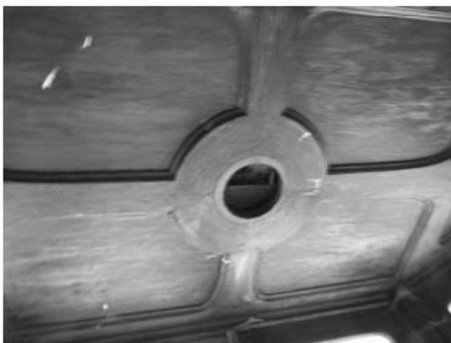
28. «Главное здание», входящее в состав объекта культурного наследия федерального значения «Институт ортопедический», Александровский парк, д.5 литера А. Главный вход. Фрагмент тамбура. Фото 11.03.2021 г.
