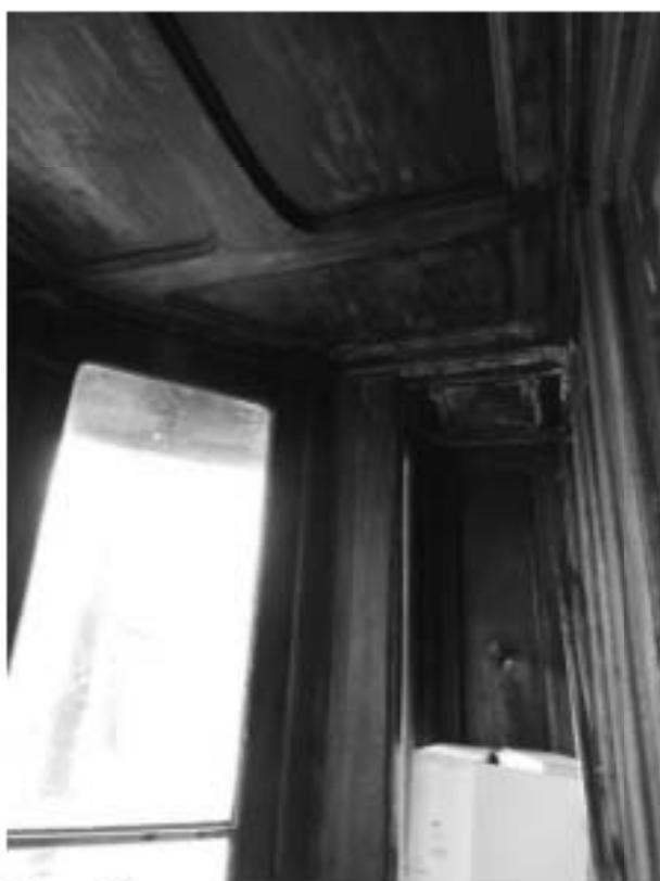
26. «Главное здание», входящее в состав объекта культурного наследия федерального значения «Институт ортопедический», Александровский парк, д.5 литера А. Главный вход. Фрагмент тамбура. Фото 11.03.2021 г.
