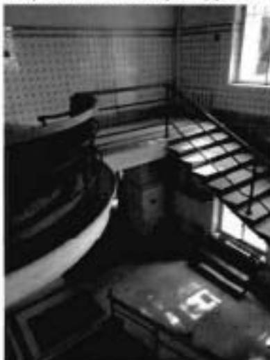
6. Лестница в юго-восточной части здания.
