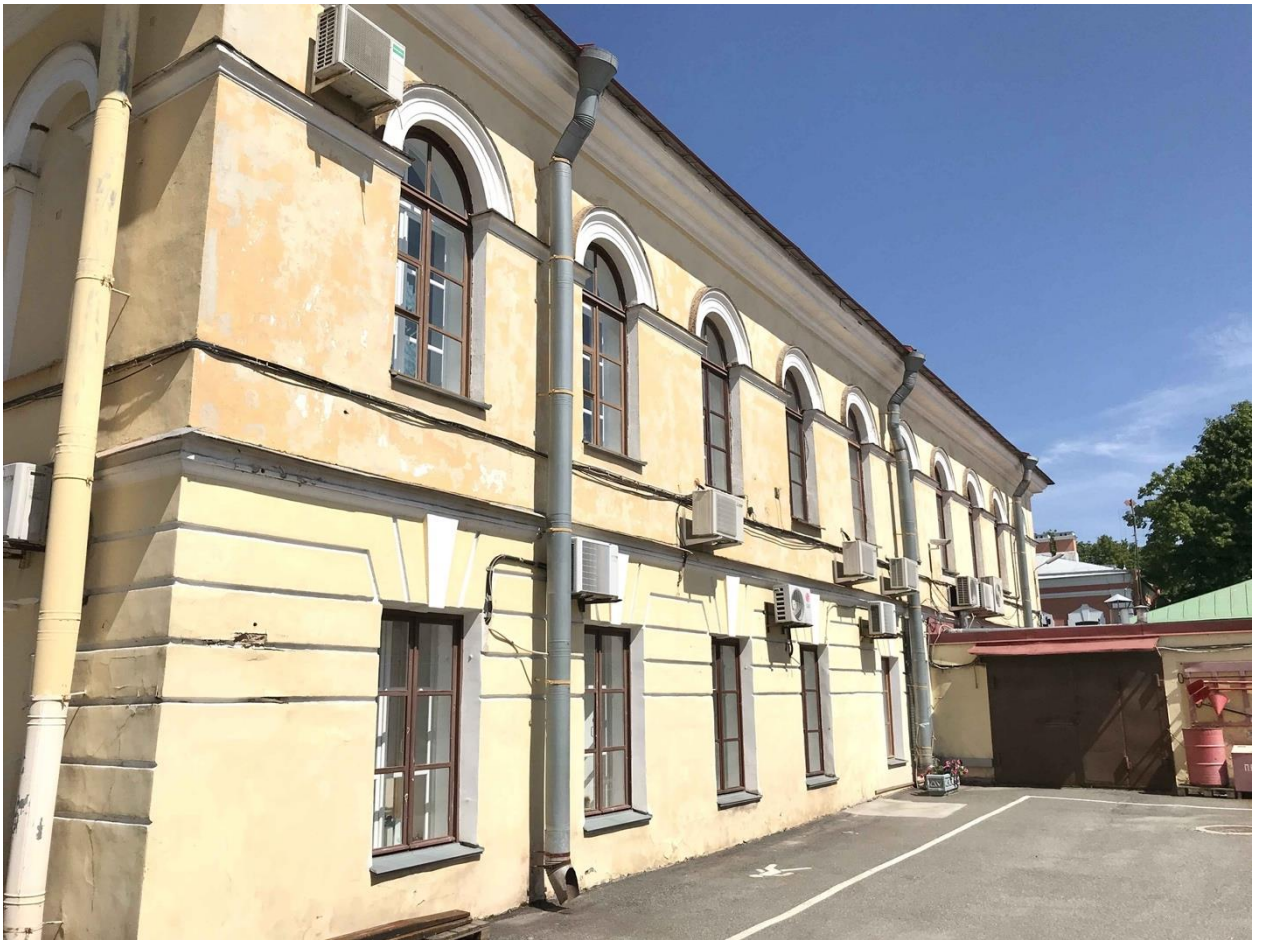
Фото 15. ОКН федерального значения «Дом плац-майорский» (Петропавловская крепость, дом 6 лит В). Юго-восточный фасад. Общий вид. Съёмка 17 мая 2021 г.
