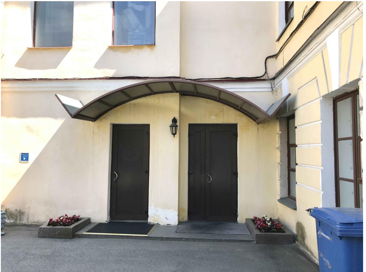
Фото 11. ОКН федерального значения «Дом плац-майорский» (Петропавловская крепость, дом 6 лит В). Северо-западный фасад. Крыльцо. Фрагмент. Съёмка 17 мая 2021 г.
