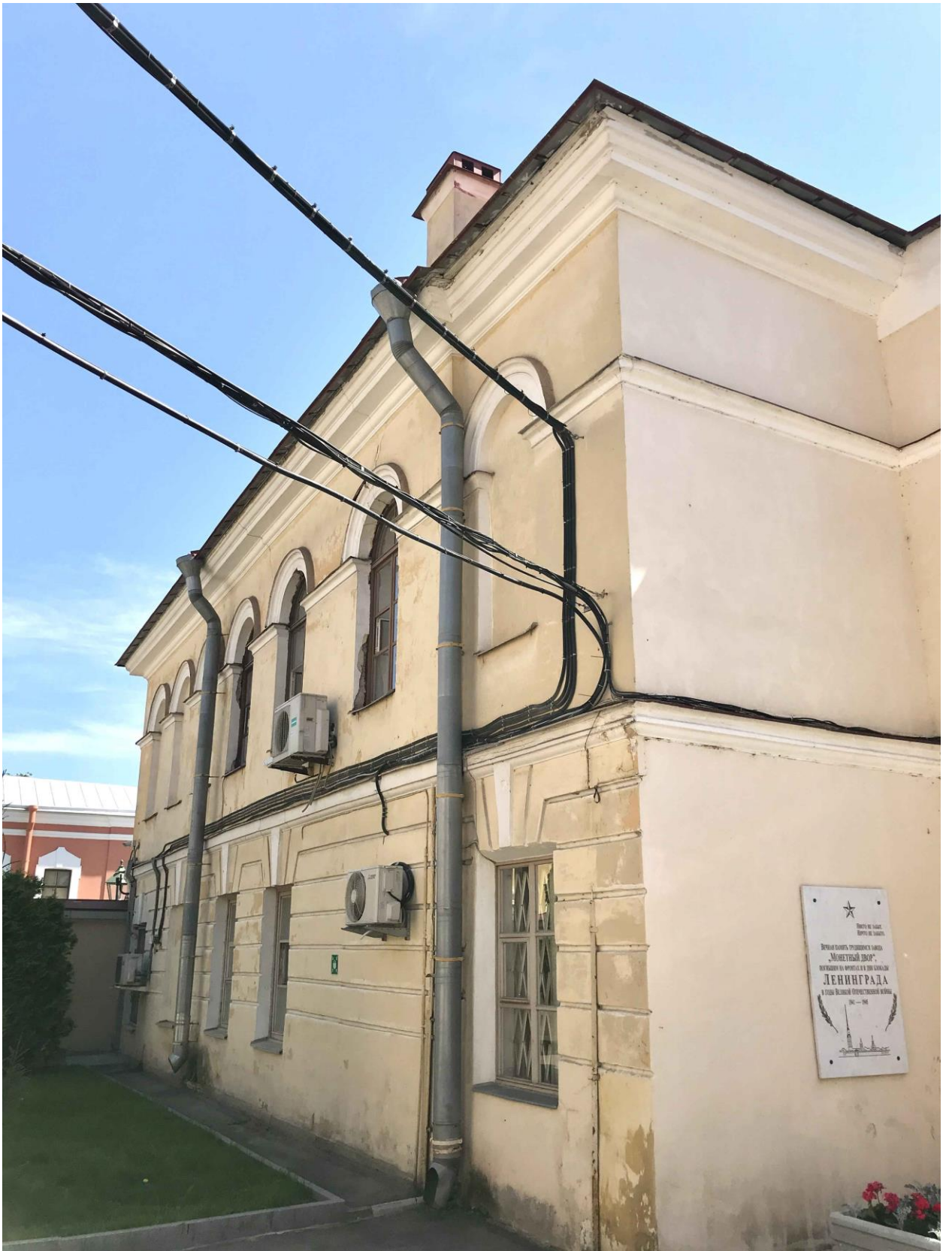
Фото 08. ОКН федерального значения «Дом плац-майорский» (Петропавловская крепость, дом 6 лит В). Северо-западный фасад. Фрагмент. Съёмка 17 мая 2021 г.
