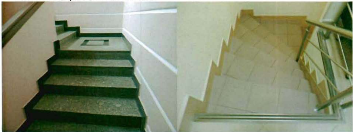
4. Межэтажные средистенные лестницы.
