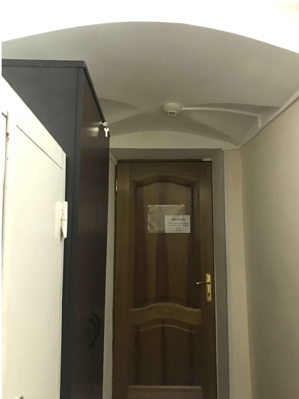
Фото 24. ОКН федерального значения «Дом плац-майорский» (Петропавловская крепость, дом 6 лит В). Первый этаж. Помещение 11. Общий вид. Съёмка 17 мая 2021 г.
