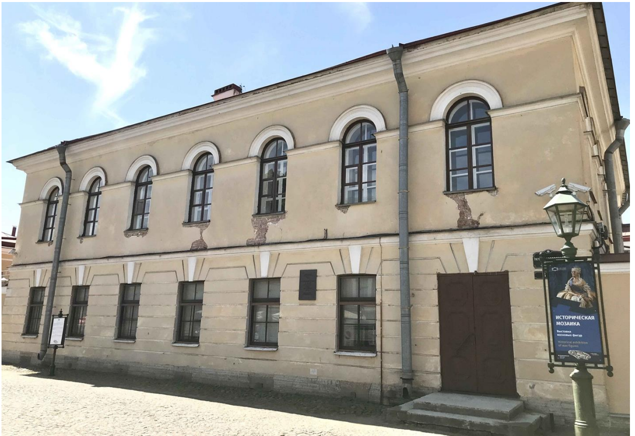
Фото 03. ОКН федерального значения «Дом плац-майорский» (Петропавловская крепость, дом 6 лит В). Северо-восточный фасад. Фрагмент. Съёмка 17 мая 2021 г.
