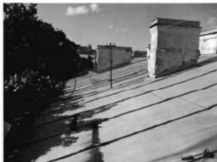
15. Металлическое покрытие кровли
