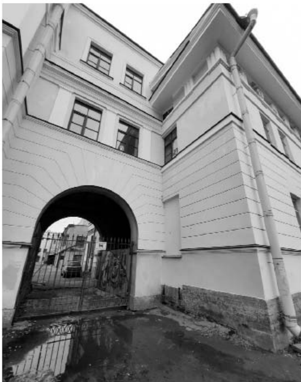
Фото 17. «Флигель жилой» (4-я линия Васильевского острова, 3, лит. Б). Фрагмент главного фасада, арочный проезд.
