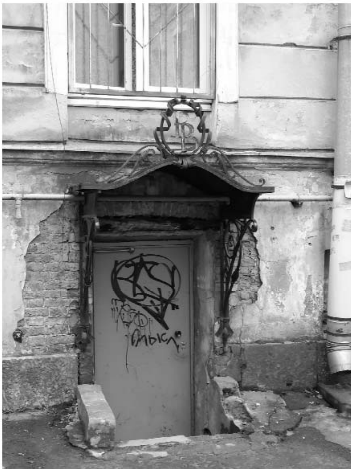
Фото 37. «Флигель жилой» (3-я линия Васильевского острова, д. 2 лит. Б). Фрагмент дворового фасада, вид на входную дверь с восточной стороны.
