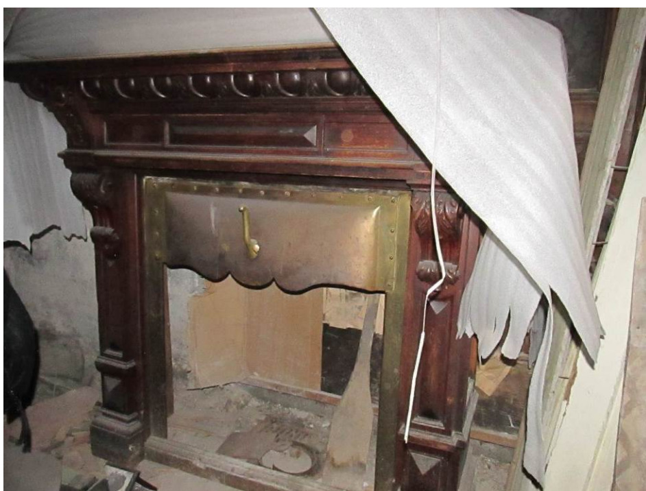
39. ОКН регионального значения «Жилой дом страхового общества “Россия” с садом и оградями» (г. Санкт-Петербург, Моховая ул., 27-29). Квартира № 34. Каминный портал демонтирован на время реставрационных работ.
