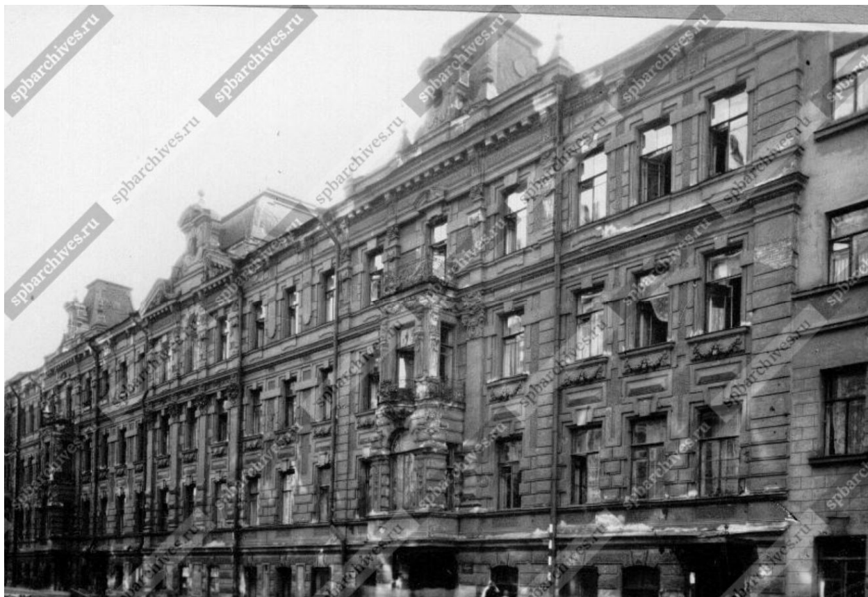
20. Фасад дома № 27-29 по Моховой улице. ЦГАКФФД СПб. Фотодокумент Гр 75418 Дата съёмки: 1960г.
