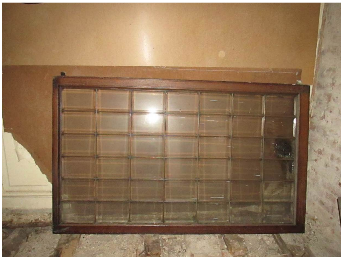
22. ОКН регионального значения «Жилой дом страхового общества «Россия» с садом и оградами» (г. Санкт-Петербург, Моховая ул., 27-29). Квартира № 34. Оконные заполнения из древесины дуба.
