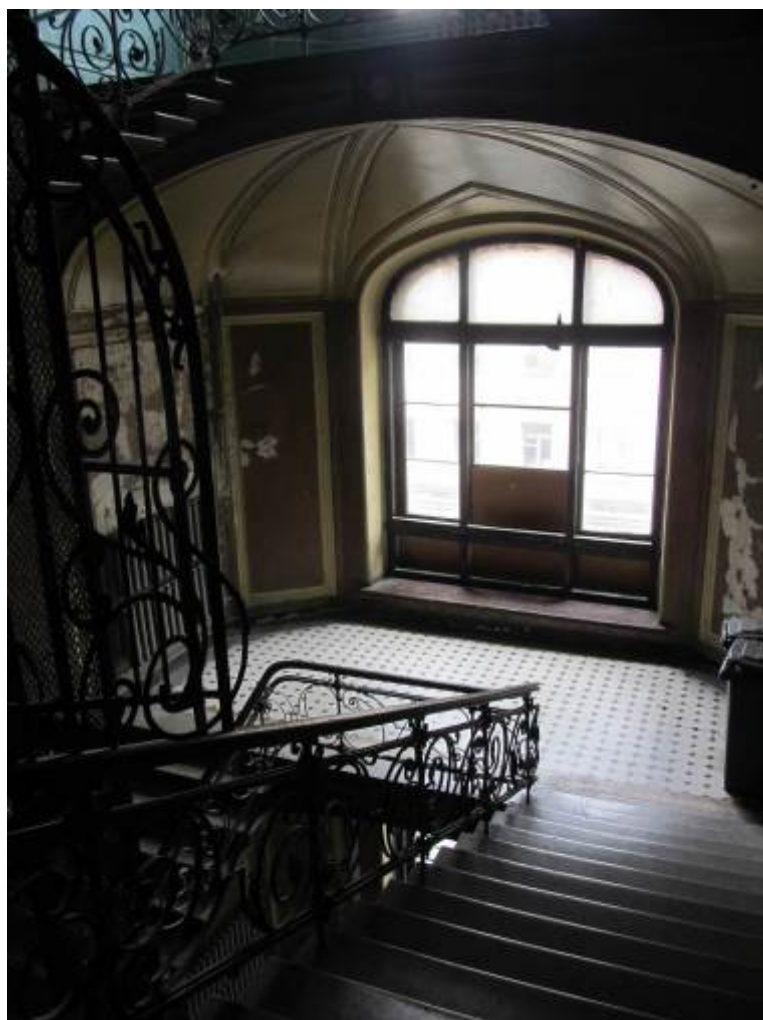
6. ОКН регионального значения «Жилой дом страхового общества «Россия» с садом и оградями» (г. Санкт-Петербург, Моховая ул., 27-29) Парадная лестница.
