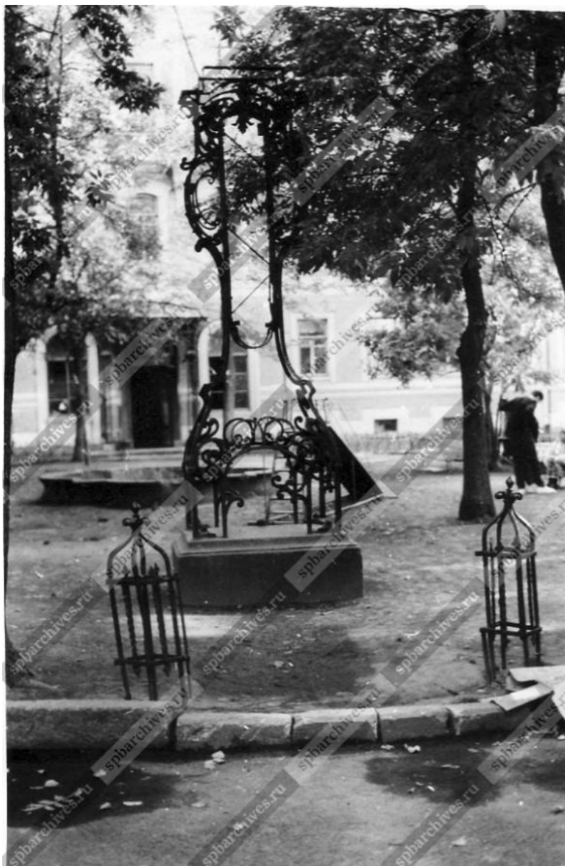
22. Вид площадки с разрушенным метеорологическим прибором во дворе-курдонере жилого дома № 27-29 по Моховой улице (бывший жилой дом страхового общества "Россия", архитектор Л.Н.Бенуа, конец 1897-1900 гг.).
