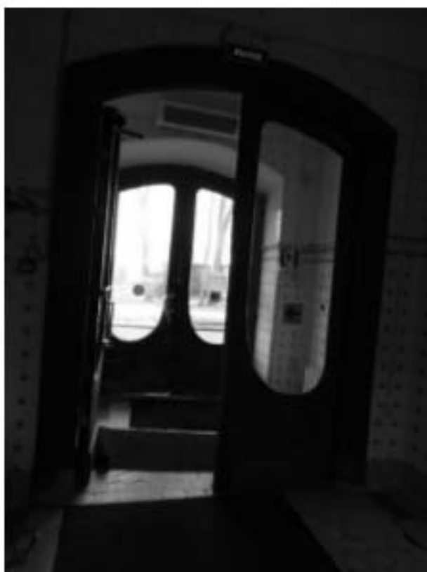
21. «Главное здание», входящее в состав объекта культурного наследия федерального значения «Институт ортопедический», Александровский парк, д. 5 литера А. Вход со стороны Троицкой площади. Тамбур. Общий вид. Фото 11.03.2021 г.
