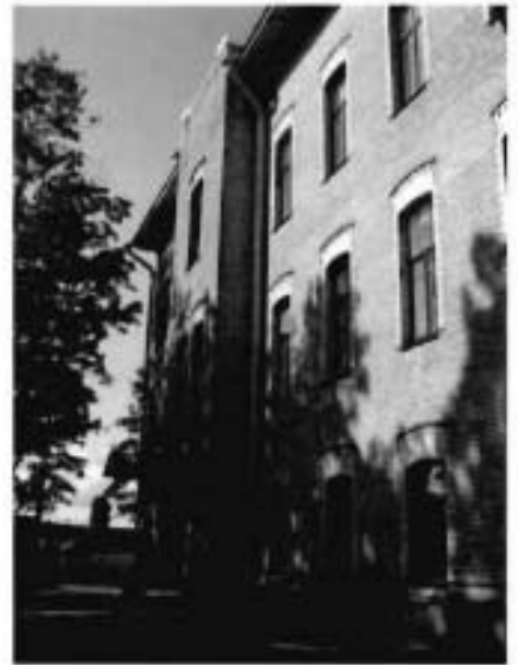
3. Вид на объект культурного наследия с юго-восточной стороны.
