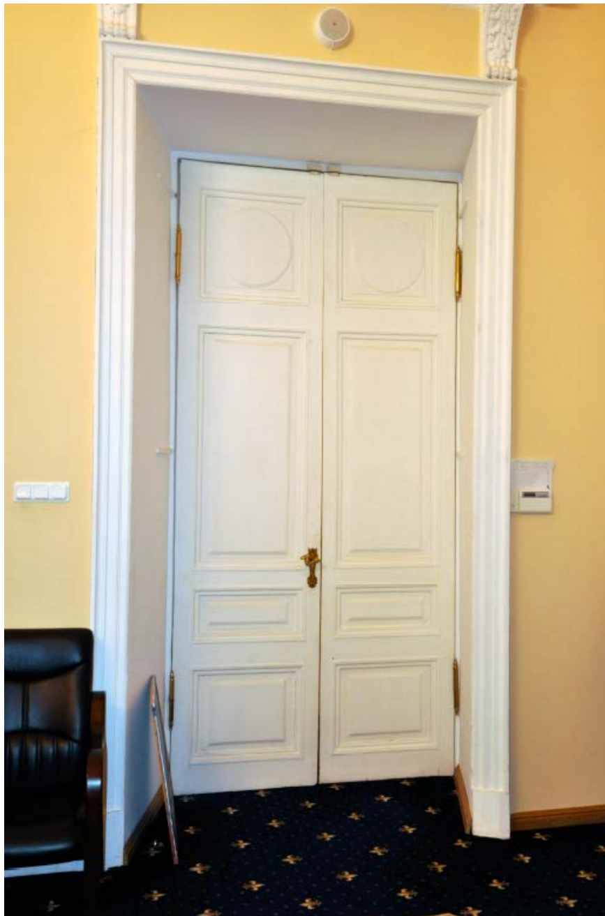
7. Заполнение дверного проема северной стены зала №22 (пом. 1-Н (126) в уровне 1-ого этажа объекта культурного наследия федерального значения «Дворец Таврический. Дворец». 21.06.2020
