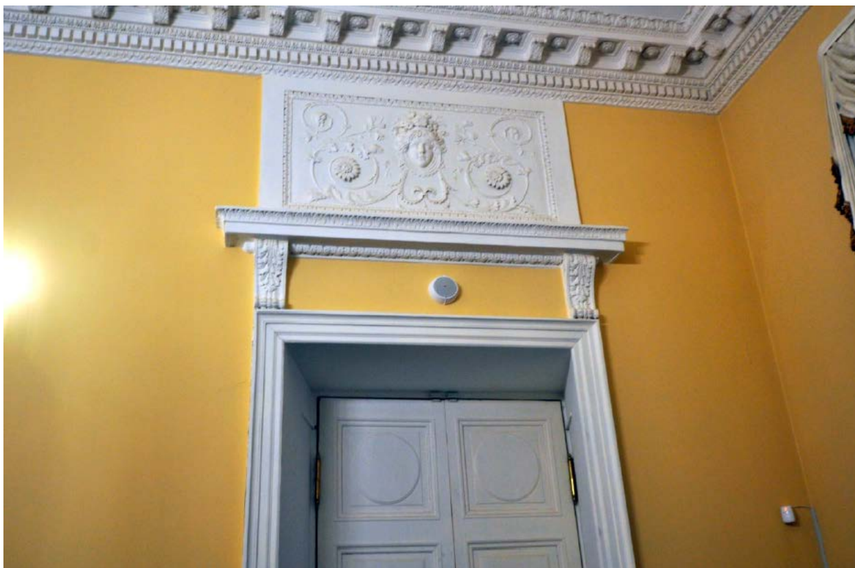
6. Десюдепорт дверного проемы на северной стене зала №22 (пом. 1-Н (126) в уровне 1-ого этажа объекта культурного наследия федерального значения «Дворец Таврический. Дворец», расположенного по адресу: г. Санкт-Петербург, ул. Шпалерная, д. 47, лит. А. 21.06.2020
