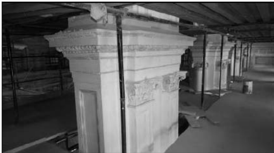
42. Объект культурного наследия федерального значения «Консерватория». Помещение 2-го этажа в осях «К» - «Д»/«1» - «3».
