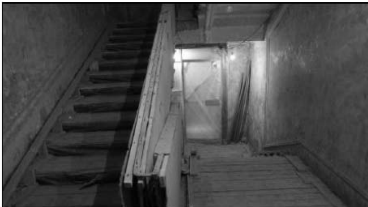
34. Объект культурного наследия федерального значения «Консерватория». Лестница Л-7. 1-й этаж.
