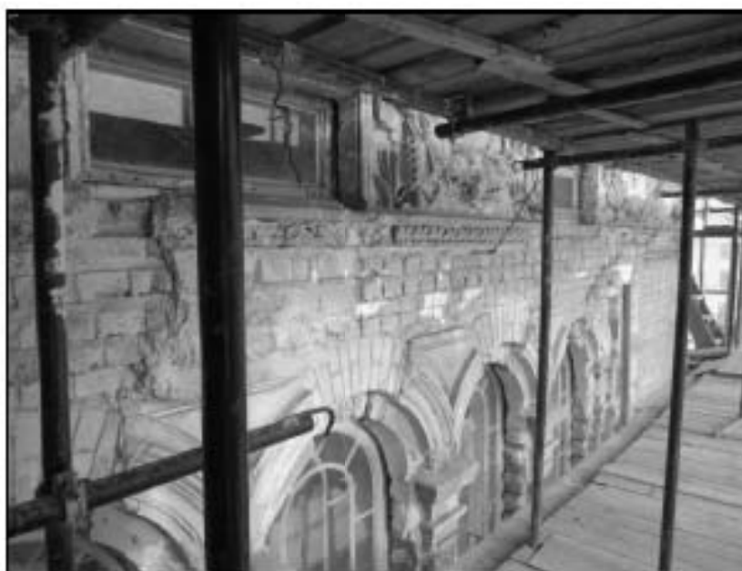
28. Объект культурного наследия федерального значения «Консерватория». Фрагмент фасада 4-го этажа.
