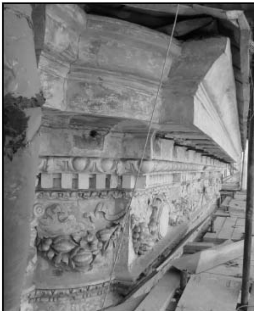
27. Объект культурного наследия федерального значения «Консерватория». Фрагмент фасада 4-го этажа.
