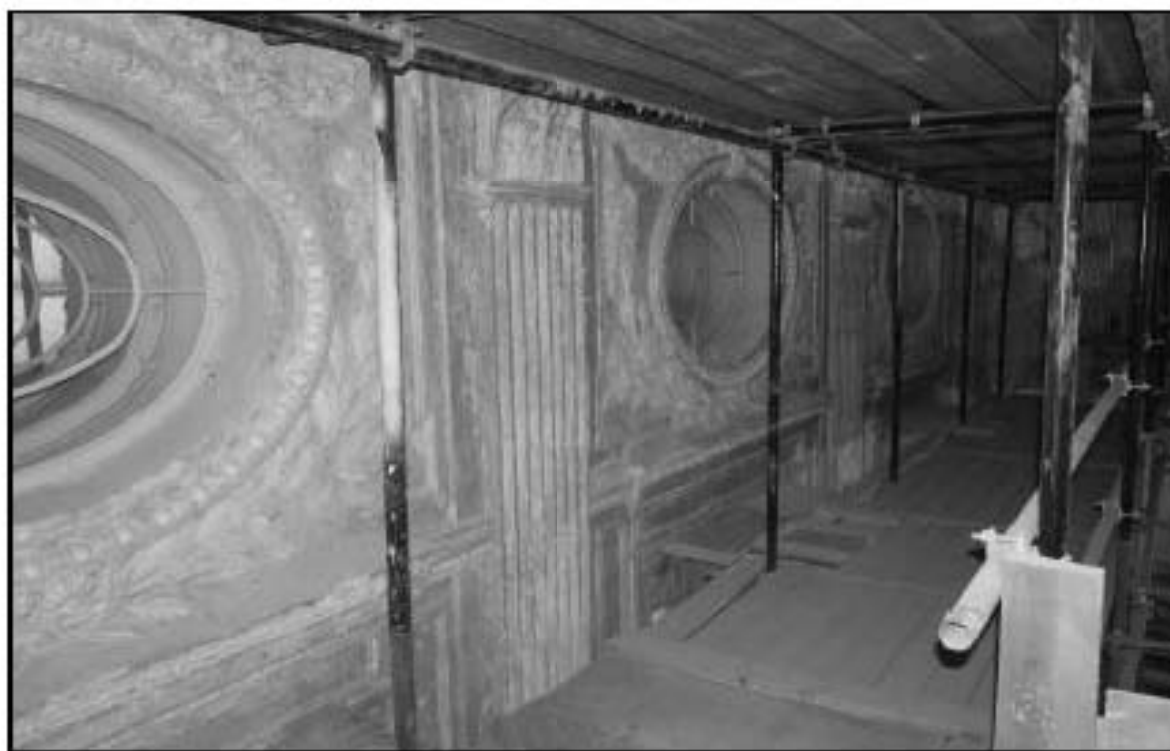
47. Объект культурного наследия федерального значения «Консерватория». Помещение 3-го этажа в осях «1» - «7»/«П» - «Ю».
