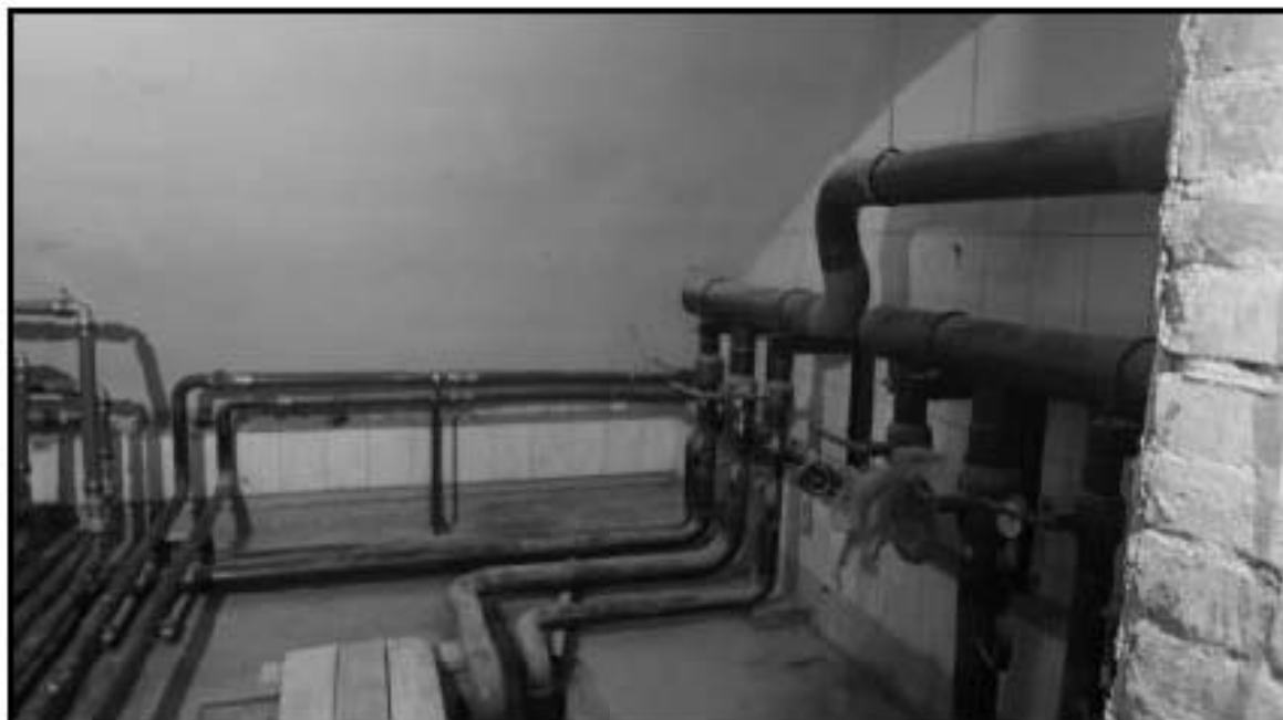
32. Объект культурного наследия федерального значения «Консерватория». Помещение 1-го этажа в осях «Я» - «Ю»/«19» - «22».
