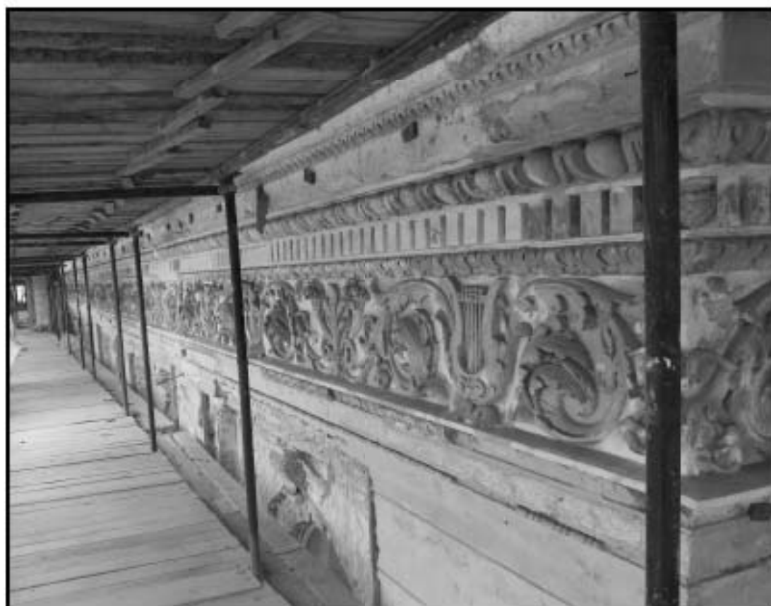
24. Объект культурного наследия федерального значения «Консерватория». Фрагмент фасада 3-го этажа.
