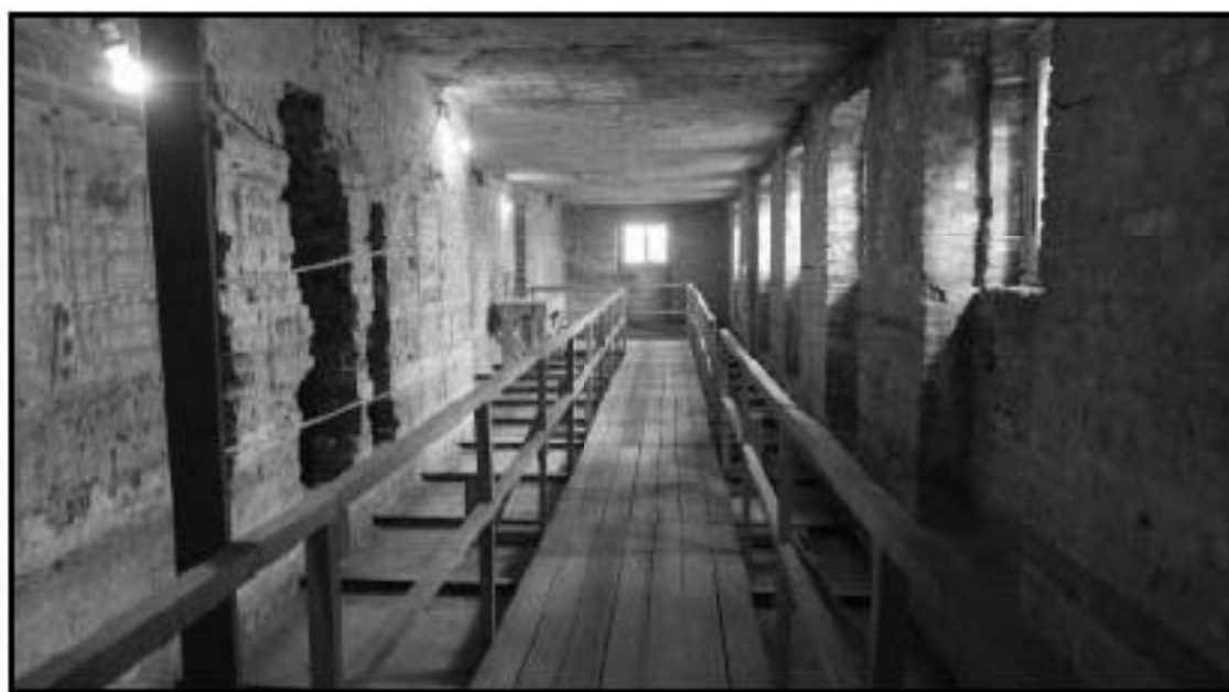
57. Объект культурного наследия федерального значения «Консерватория». Помещение 4-го этажа в осях «Д» - «Г»/«31» - «37».
