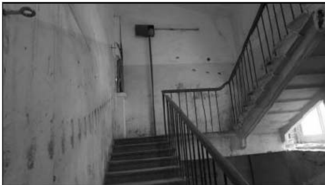
54. Объект культурного наследия федерального значения «Консерватория». Лестница Л-6. 5-й этаж.
