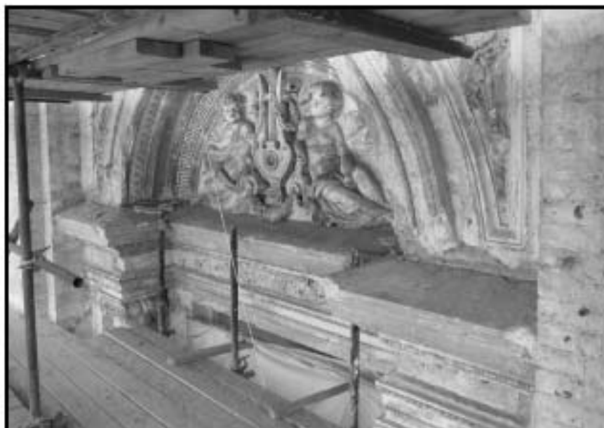
21. Объект культурного наследия федерального значения «Консерватория». Фрагмент фасада 3-го этажа.
