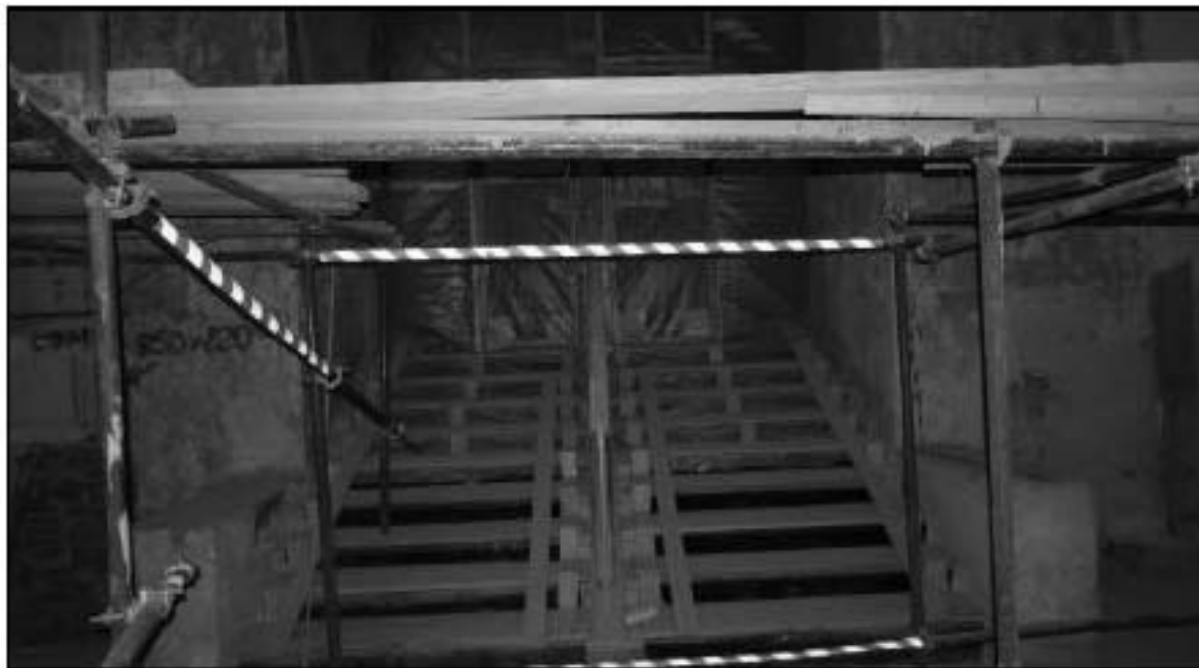
36. Объект культурного наследия федерального значения «Консерватория». Лестница Л-4.5.
