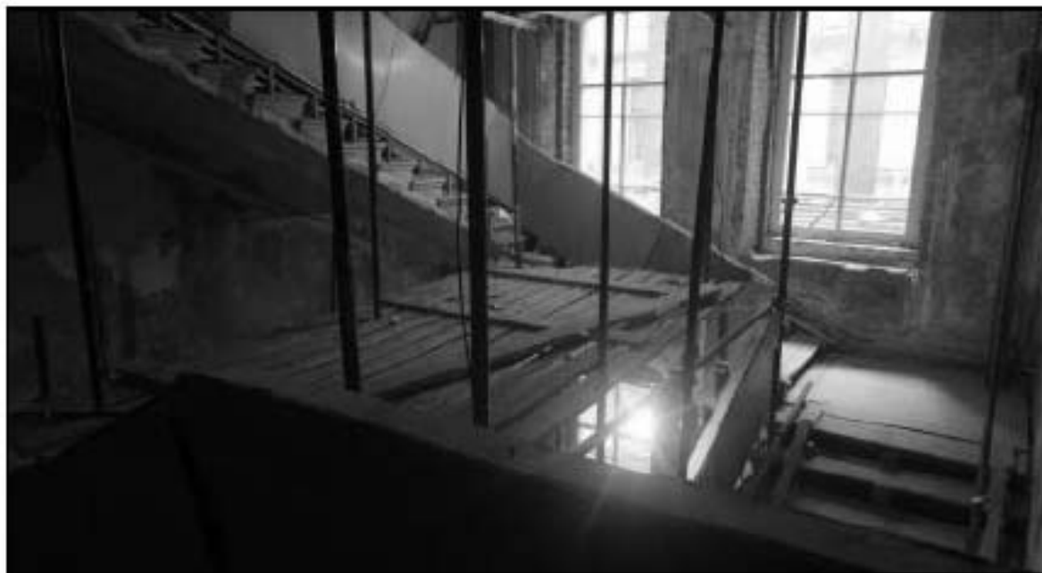
48. Объект культурного наследия федерального значения «Консерватория». Лестницы Л-2, Л-3. 3-й этаж.
