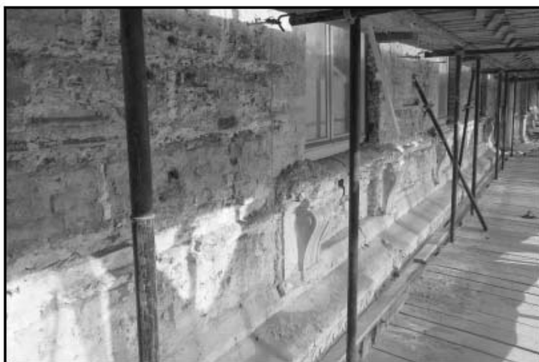
18. Объект культурного наследия федерального значения «Консерватория». Фрагмент фасада 2-го этажа.
