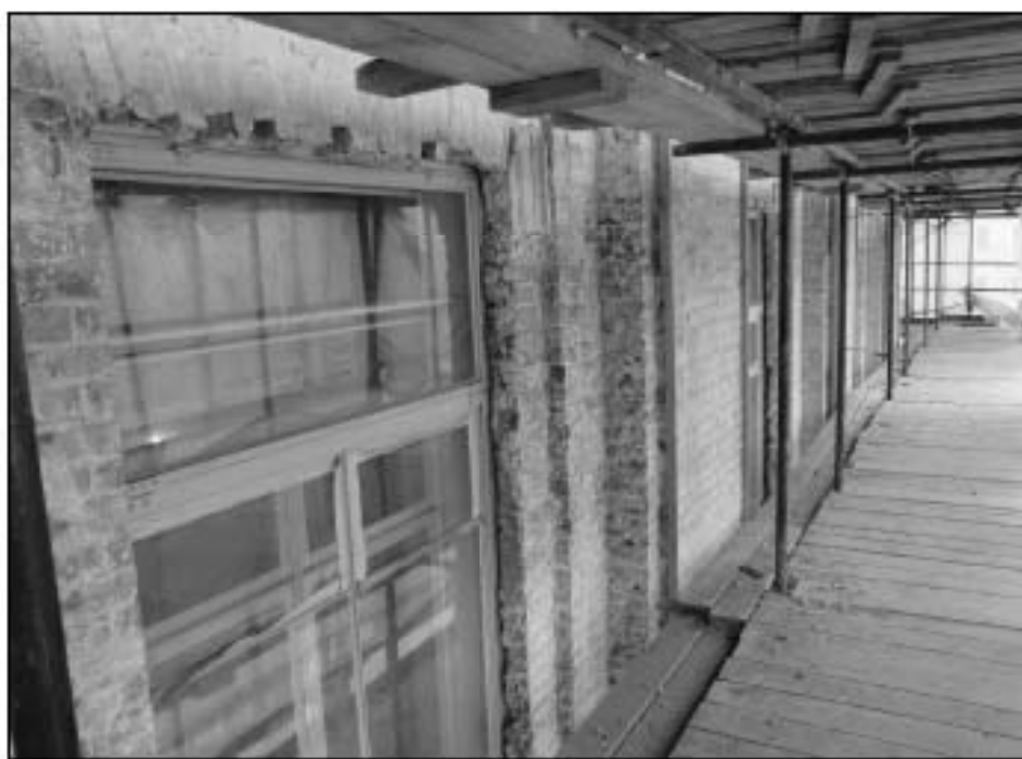
20. Объект культурного наследия федерального значения «Консерватория». Фрагмент фасада 2-го этажа.
