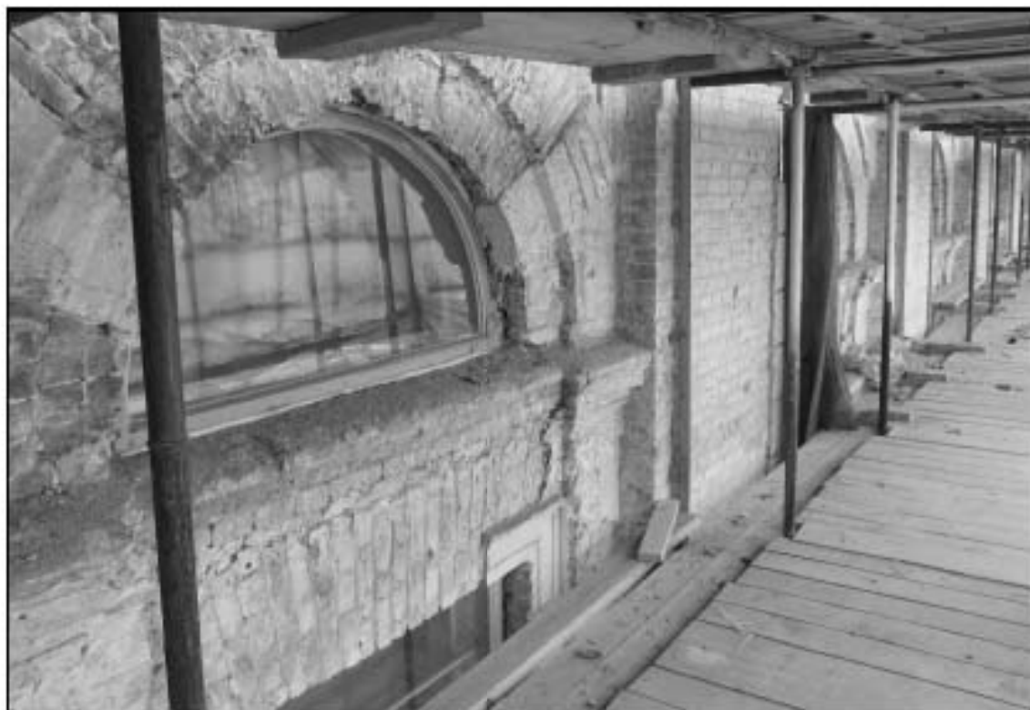
23. Объект культурного наследия федерального значения «Консерватория». Фрагмент фасада 3-го этажа.
