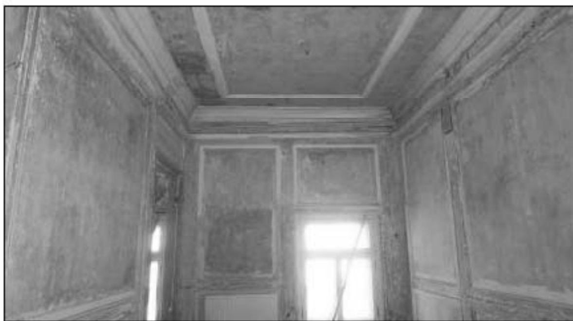
51. Объект культурного наследия федерального значения «Консерватория». Помещение 4-го этажа в осях «7» - «9»/«Ю» - «Я».
