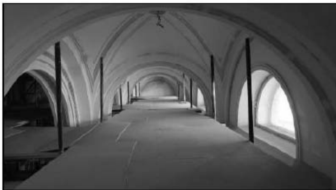
43. Объект культурного наследия федерального значения «Консерватория». Помещение 2-го этажа в осях «К» - «Д»/«1» - «3».
