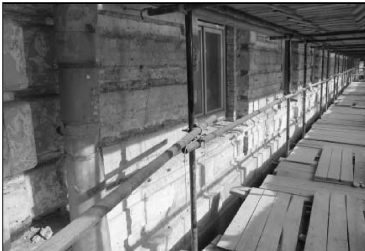
15. Объект культурного наследия федерального значения «Консерватория». Фрагмент фасада 1-го этажа.
