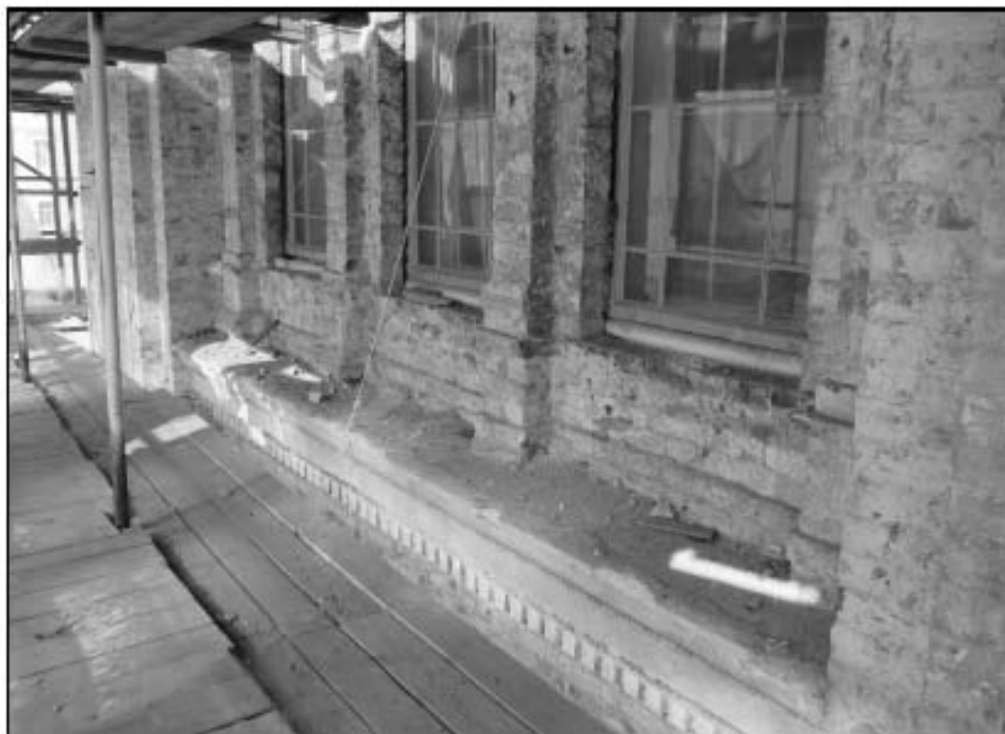
25. Объект культурного наследия федерального значения «Консерватория». Фрагмент фасада 3-го этажа.
