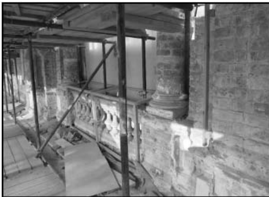
19. Объект культурного наследия федерального значения «Консерватория». Фрагмент фасада 2-го этажа.
