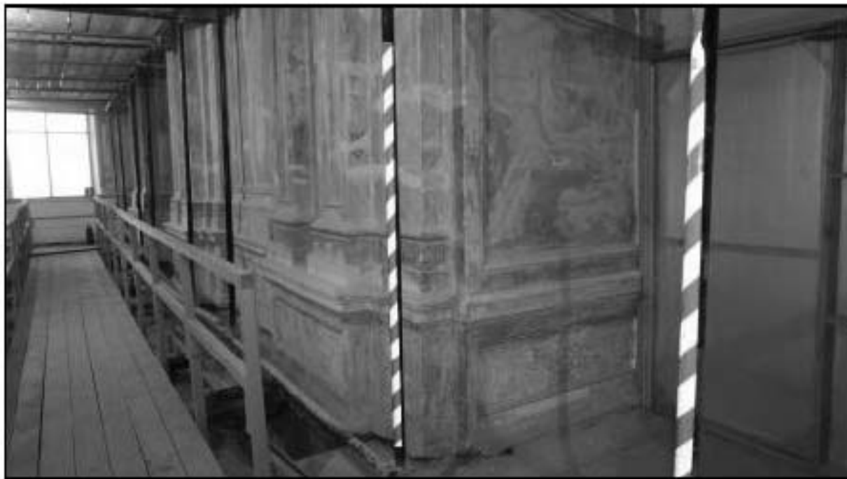
40. Объект культурного наследия федерального значения «Консерватория». Помещение 2-го этажа в осях «Н» - «М»/«8».
