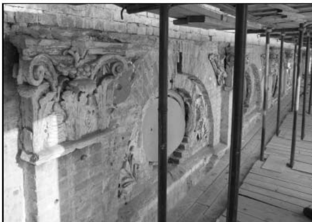
26. Объект культурного наследия федерального значения «Консерватория». Фрагмент фасада 3-го этажа.
