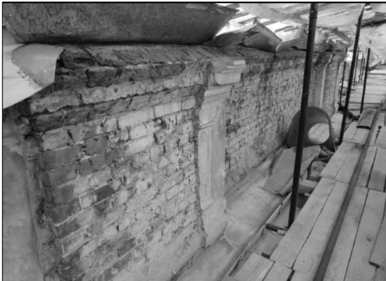
29. Объект культурного наследия федерального значения «Консерватория». Фрагмент фасада 4-го этажа.
