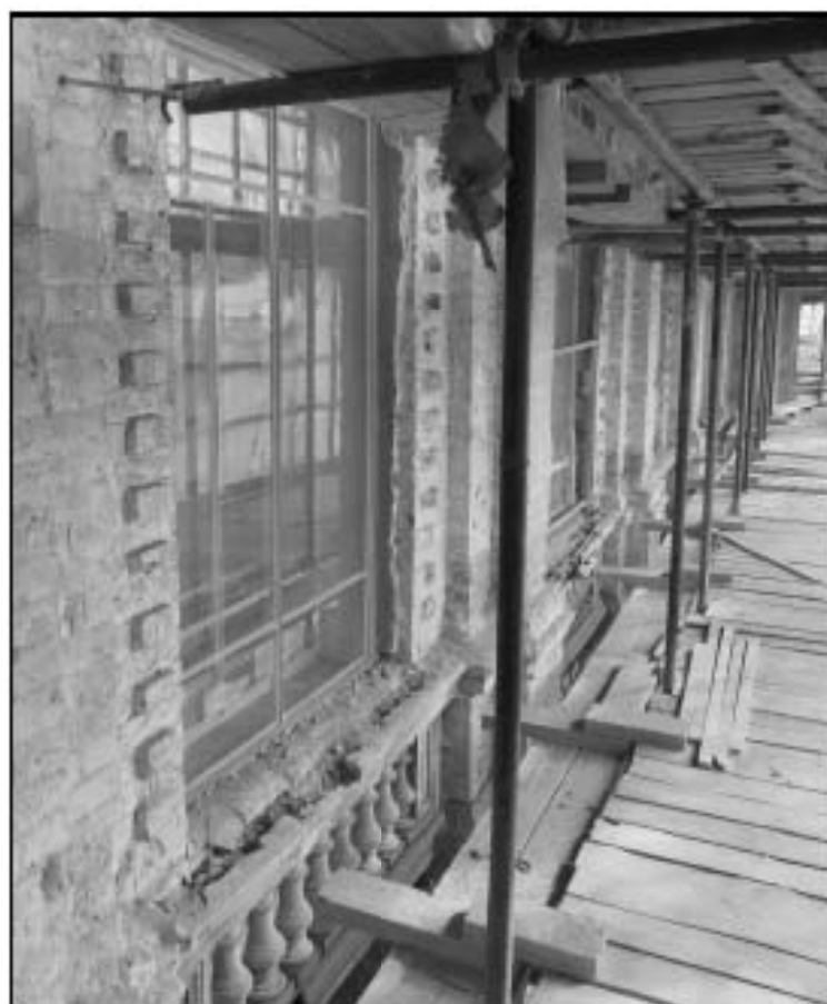
22. Объект культурного наследия федерального значения «Консерватория». Фрагмент фасада 3-го этажа.
