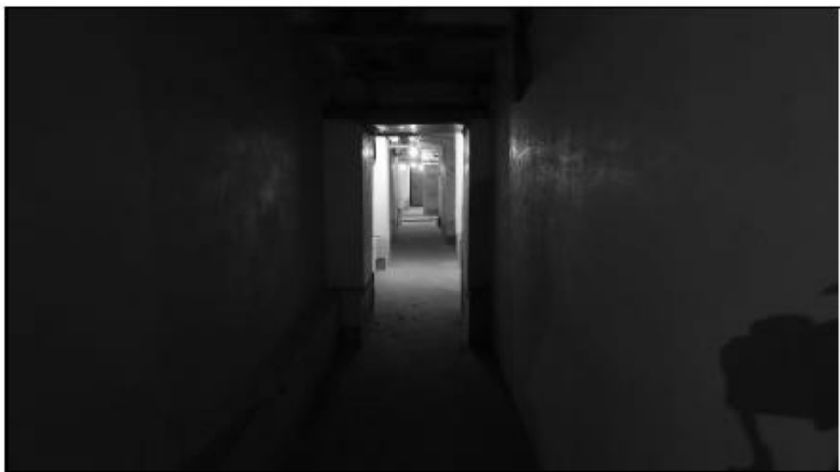
31. Объект культурного наследия федерального значения «Консерватория». Помещение 1-го этажа в осях «Ю» - «Э»/«22» - «32».
