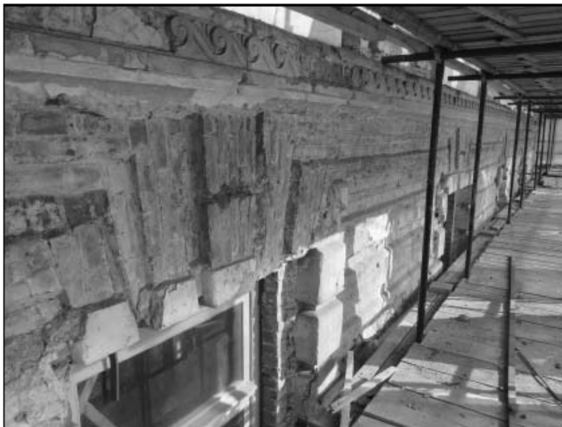
17. Объект культурного наследия федерального значения «Консерватория». Фрагмент фасада 1-го этажа.
