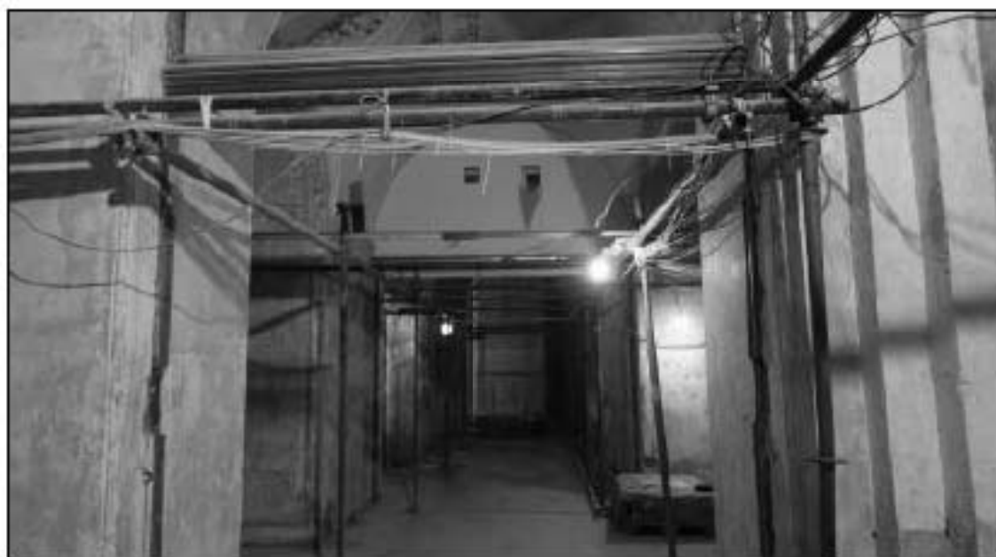
39. Объект культурного наследия федерального значения «Консерватория». Помещение 1-го этажа в осях «Н» - «М»/«1» - «8».
