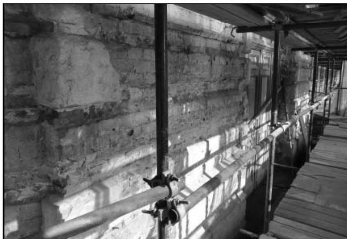
16. Объект культурного наследия федерального значения «Консерватория». Фрагмент фасада 1-го этажа.
