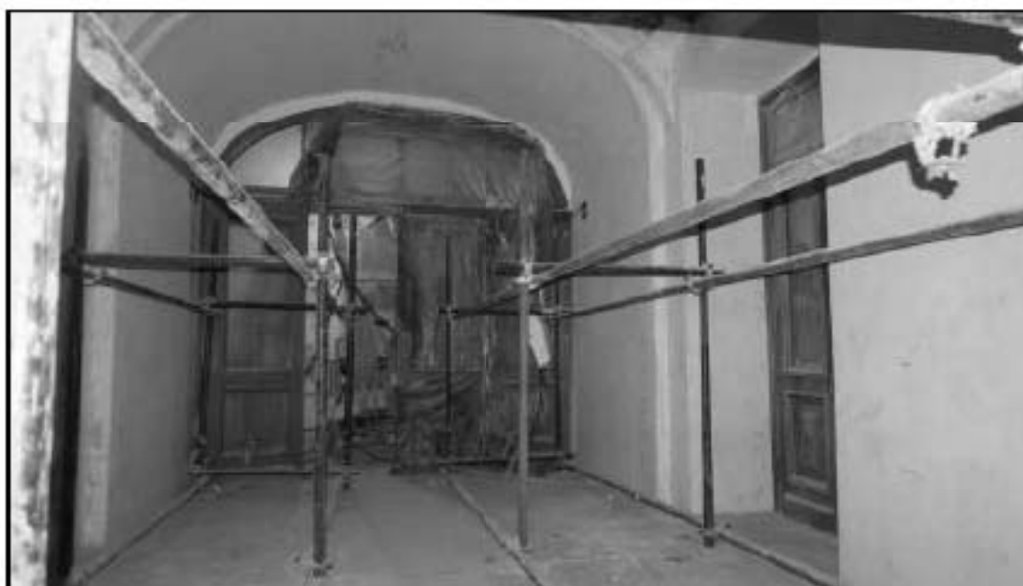
35. Объект культурного наследия федерального значения «Консерватория». Лестница Л-19. 1-й этаж.
