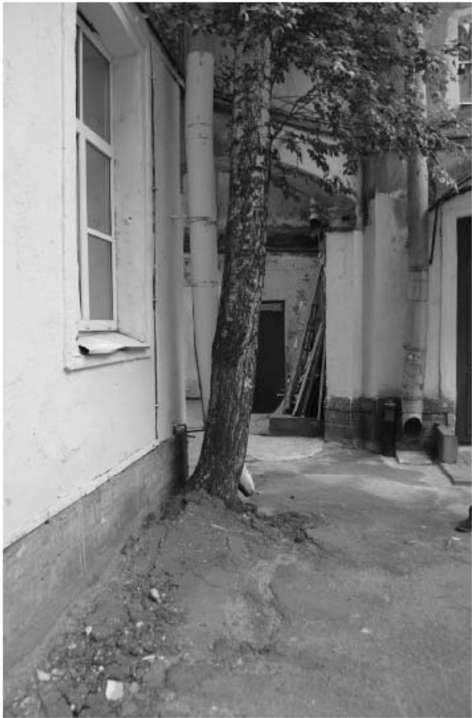
Фото 18. ОКН регионального значения «Особняк Строгановой А.Д.». Дворовые фасады. Фрагмент. Съёмка 21.06.2021 г.
