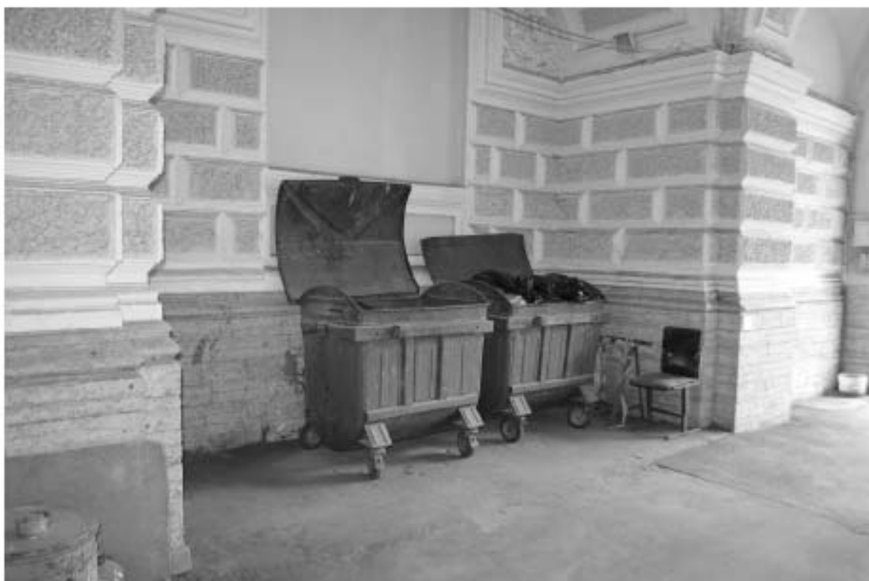
Фото 13. ОКН регионального значения «Особняк Строгановой А.Д.». Воротный проезд. Фрагмент. Съёмка 21.06.2021 г.
