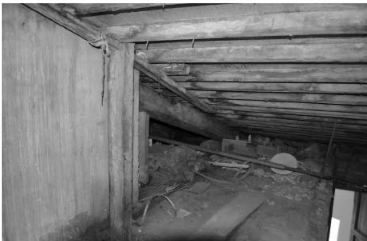
Фото 37. ОКН регионального значения «Особняк Строгановой А.Д.». Чердак. Стропильная система. Фрагмент. Съёмка 21.06.2021 г.
