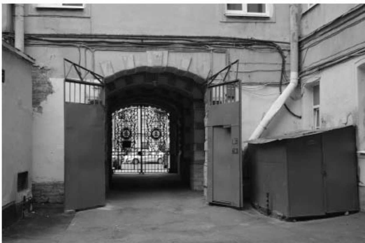
Фото 10. ОКН регионального значения «Особняк Строгановой А.Д.». Дворовые фасады. Фрагмент. Съёмка 21.06.2021 г.
