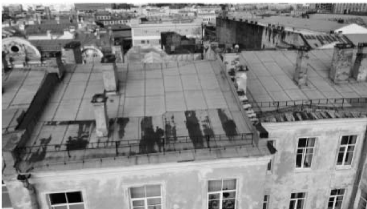
Фото 34. ОКН регионального значения «Особняк Строгановой А.Д.». Кровля. Общий вид. Съёмка 21.06.2021 г.
