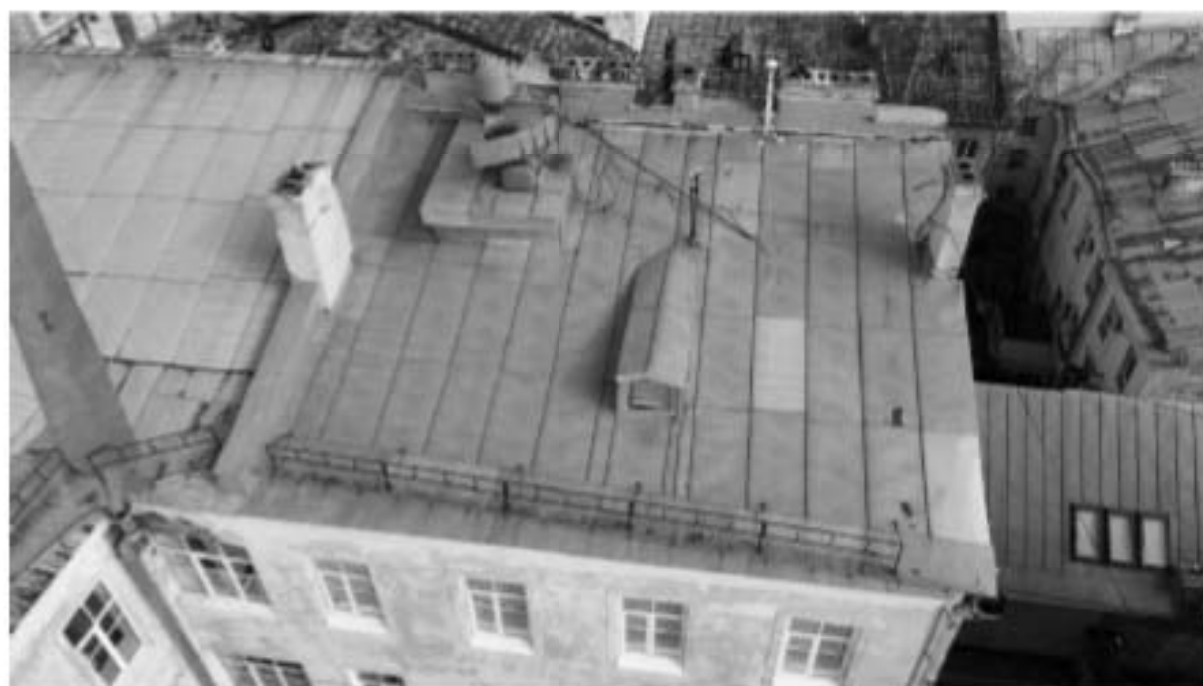
Фото 35. ОКН регионального значения «Особняк Строгановой А.Д.». Кровля. Общий вид. Съёмка 21.06.2021 г.
