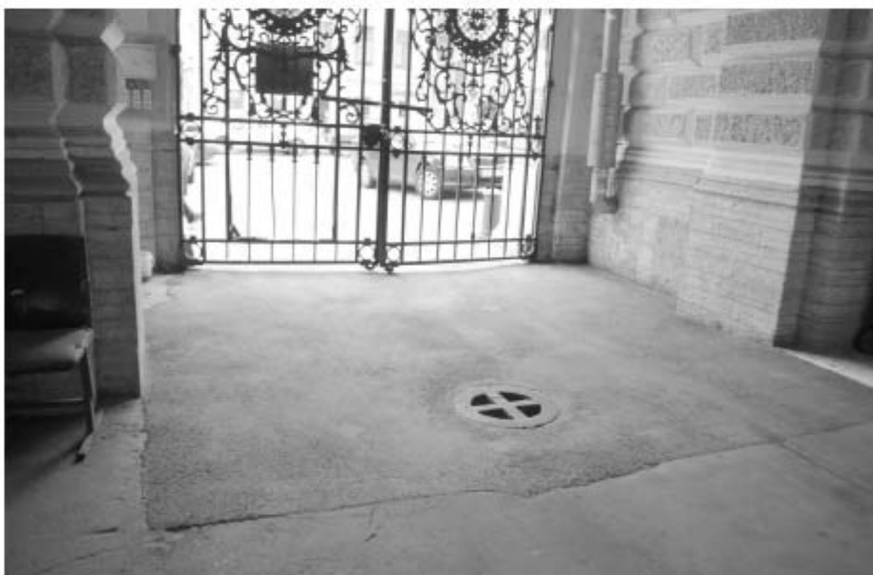
Фото 14. ОКН регионального значения «Особняк Строгановой А.Д.». Воротный проезд. Фрагмент. Съёмка 21.06.2021 г.
