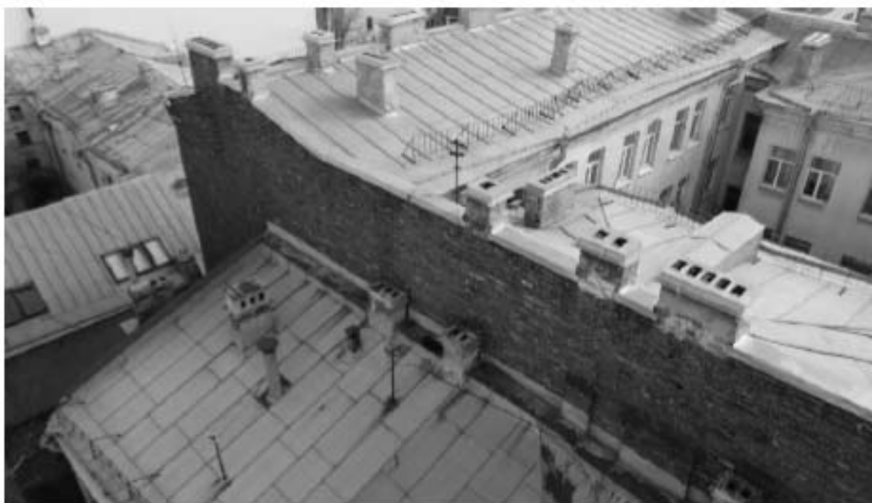
Фото 36. ОКН регионального значения «Особняк Строгановой А.Д.». Кровля. Общий вид. Съёмка 21.06.2021 г.
