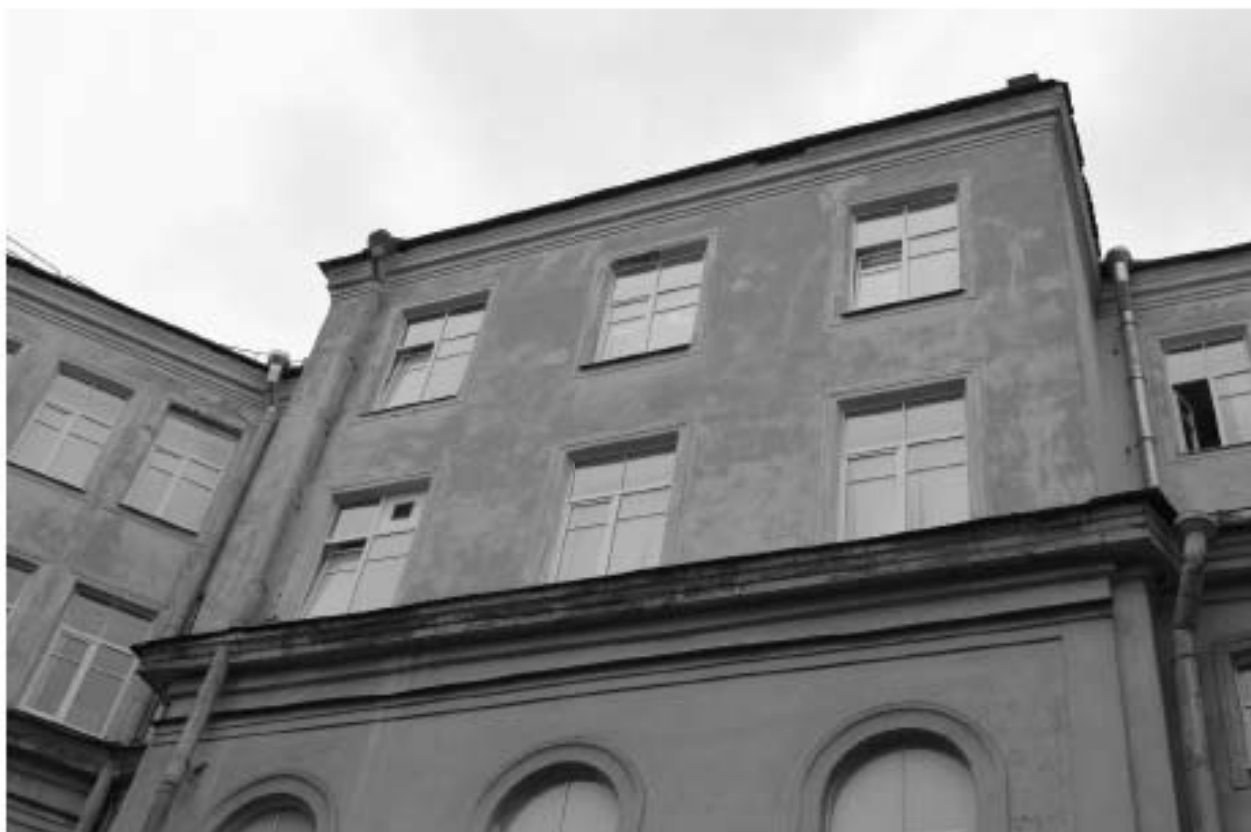
Фото 09. ОКН регионального значения «Особняк Строгановой А.Д.». Дворовые фасады. Фрагмент. Съёмка 21.06.2021 г.
