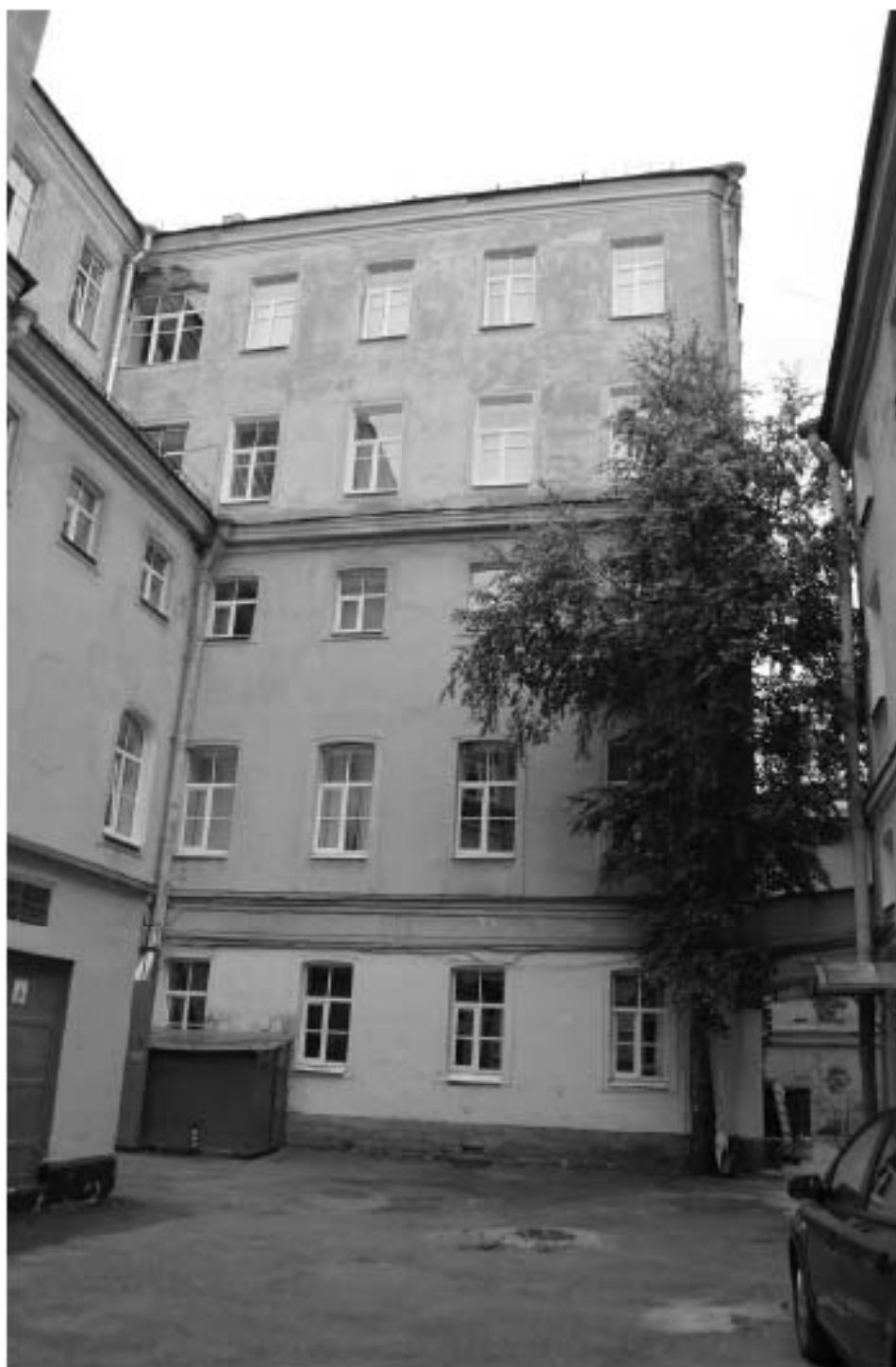
Фото 16. ОКН регионального значения «Особняк Строгановой А.Д.». Дворовые фасады. Фрагмент. Съёмка 21.06.2021 г.
