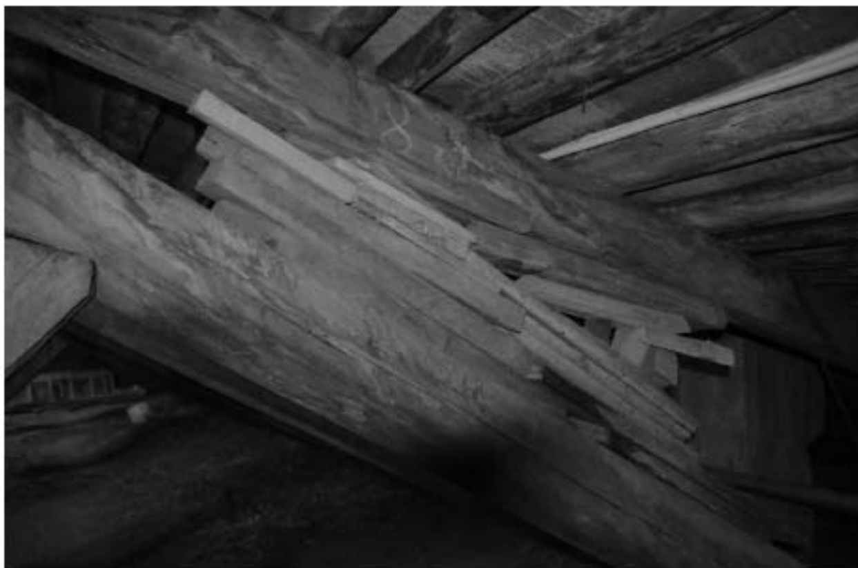
Фото 45. ОКН регионального значения «Особняк Строгановой А.Д.». Чердак. Стропильная система. Фрагмент. Съёмка 21.06.2021 г.
