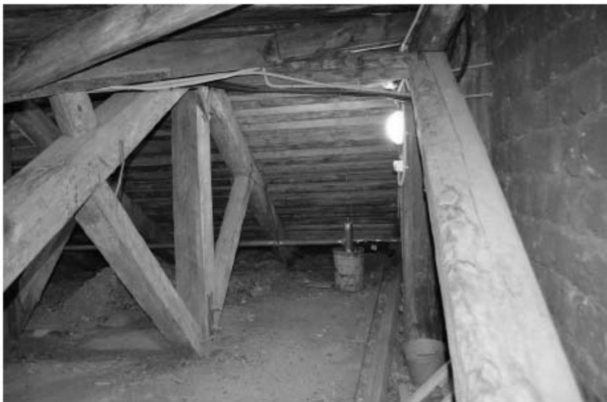
Фото 41. ОКН регионального значения «Особняк Строгановой А.Д.». Чердак. Стропильная система. Фрагмент. Съёмка 21.06.2021 г.
