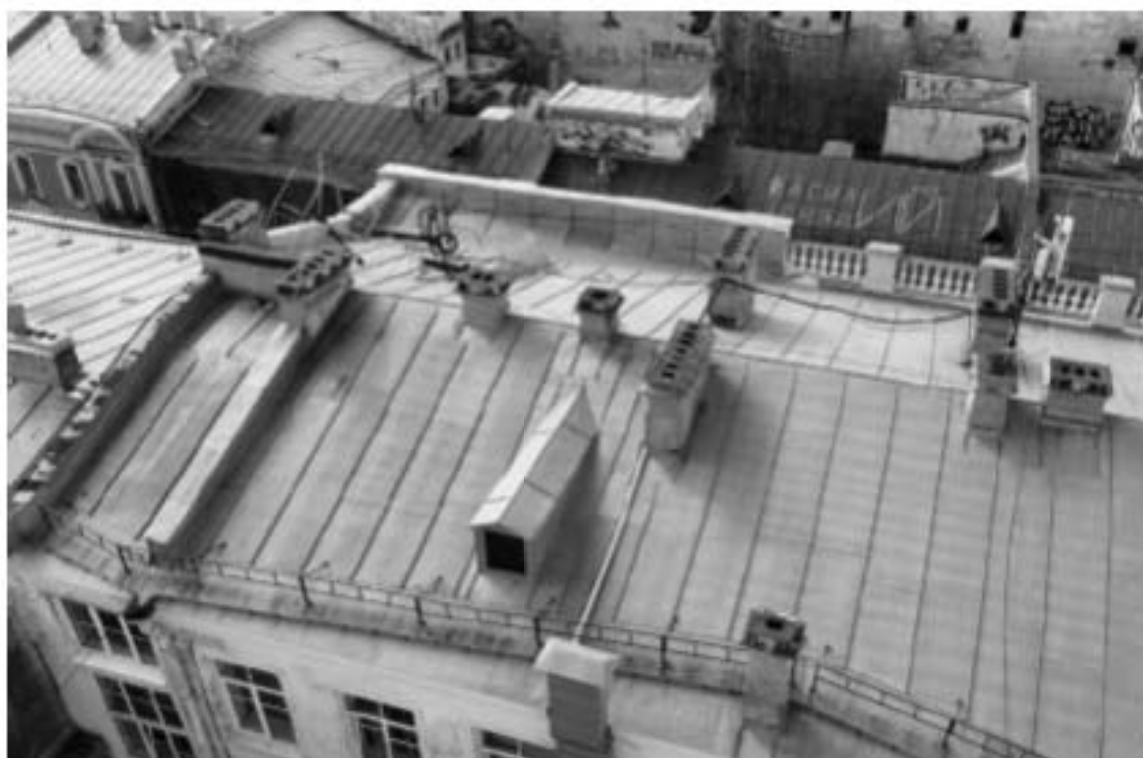
Фото 32. ОКН регионального значения «Особняк Строгановой А.Д.». Кровля. Общий вид. Съёмка 21.06.2021 г.
