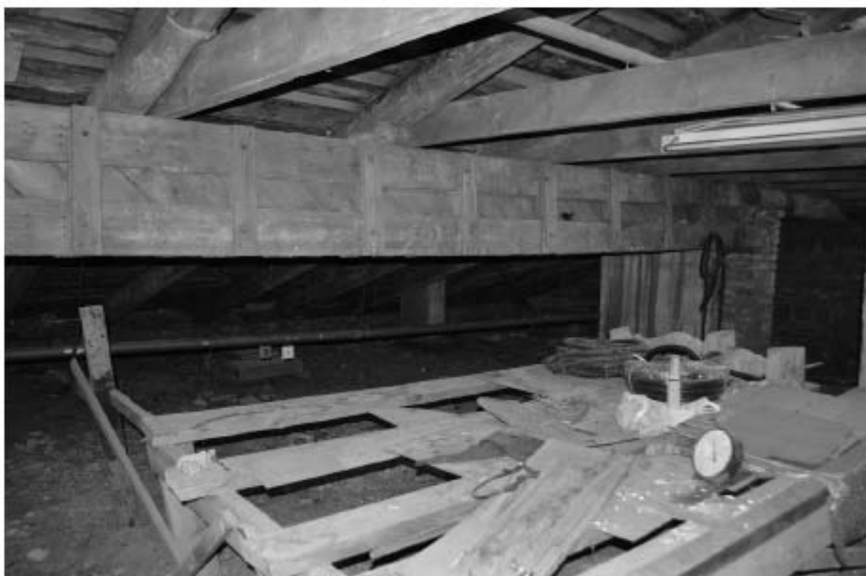
Фото 46. ОКН регионального значения «Особняк Строгановой А.Д.». Чердак. Стропильная система. Фрагмент. Съёмка 21.06.2021 г.
