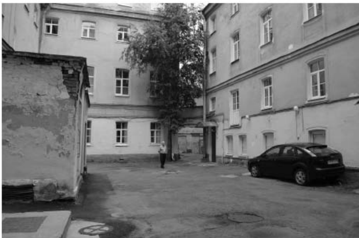
Фото 28. ОКН регионального значения «Особняк Строгановой А.Д.». Дворовые фасады. Двор. Общий вид. Съёмка 21.06.2021 г.
