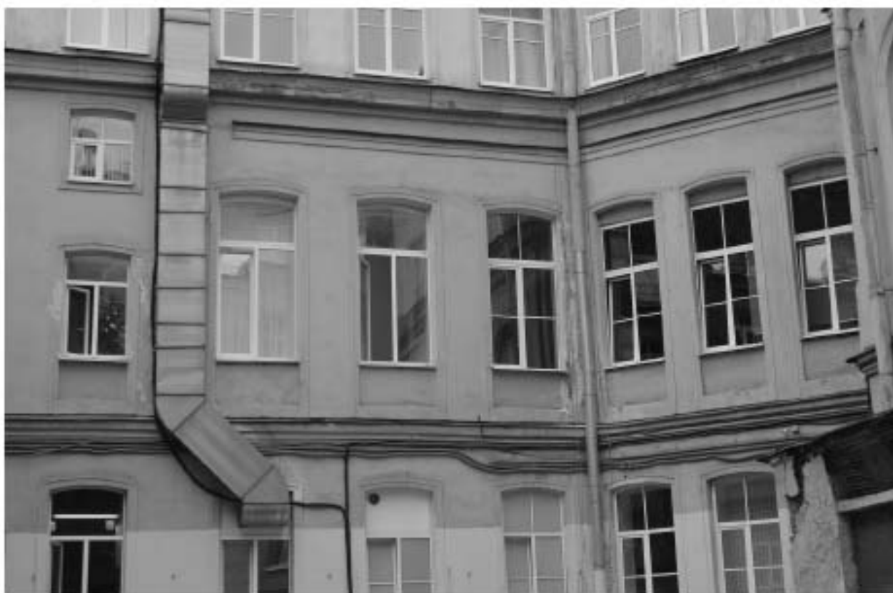
Фото 04. ОКН регионального значения «Особняк Строгановой А.Д.». Дворовые фасады. Фрагмент. Съёмка 21.06.2021 г.
