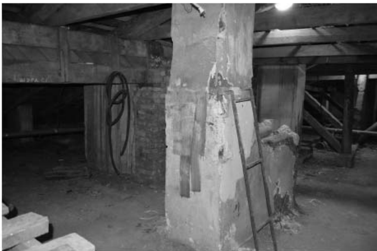
Фото 47. ОКН регионального значения «Особняк Строгановой А.Д.». Чердак. Стропильная система. Фрагмент. Съёмка 21.06.2021 г.
