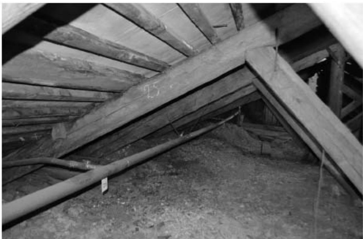
Фото 44. ОКН регионального значения «Особняк Строгановвой А.Д.». Чердак. Стропильная система. Фрагмент. Съёмка 21.06.2021 г.
