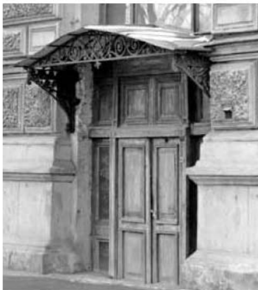
Илл. 48. Козырек дома П.А. Зубова. 1870. Архитектор К.К. Шульц. Железо. Исаакневская пл., 5. Аналог кованого козырька.
