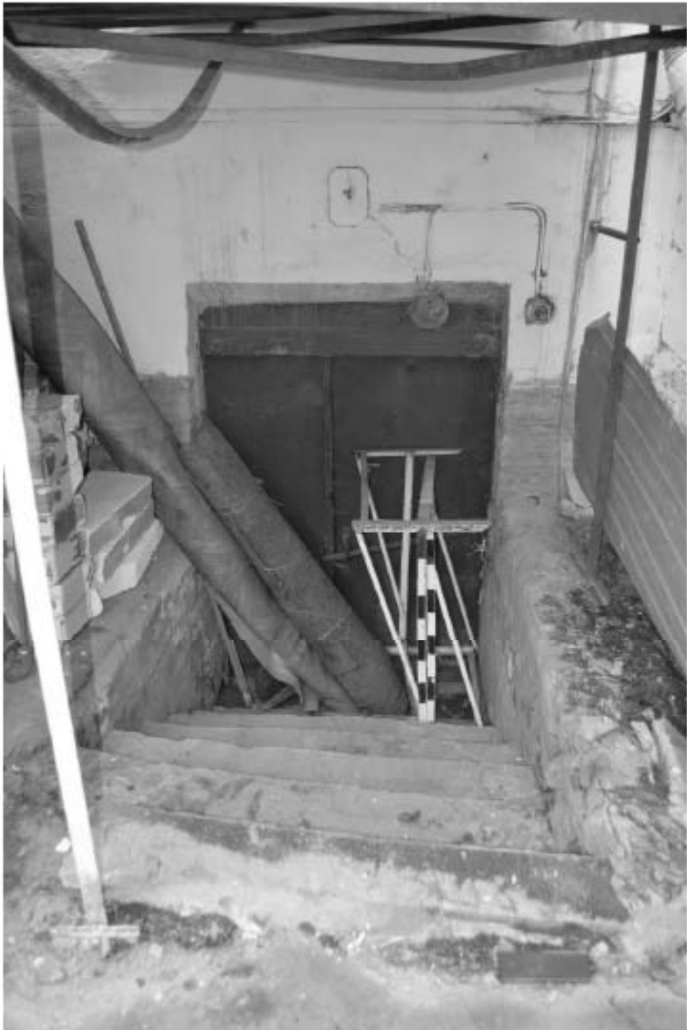
Фото 06. ОКН регионального значения «Особняк Строгановой А. Д.». Дворовые фасады. Фрагмент. Съёмка 21.06.2021 г.
