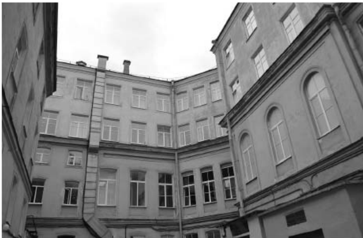
Фото 02. ОКН регионального значения «Особняк Строгановой А.Д.». Дворовые фасады. Фрагмент. Съёмка 21.06.2021 г.
