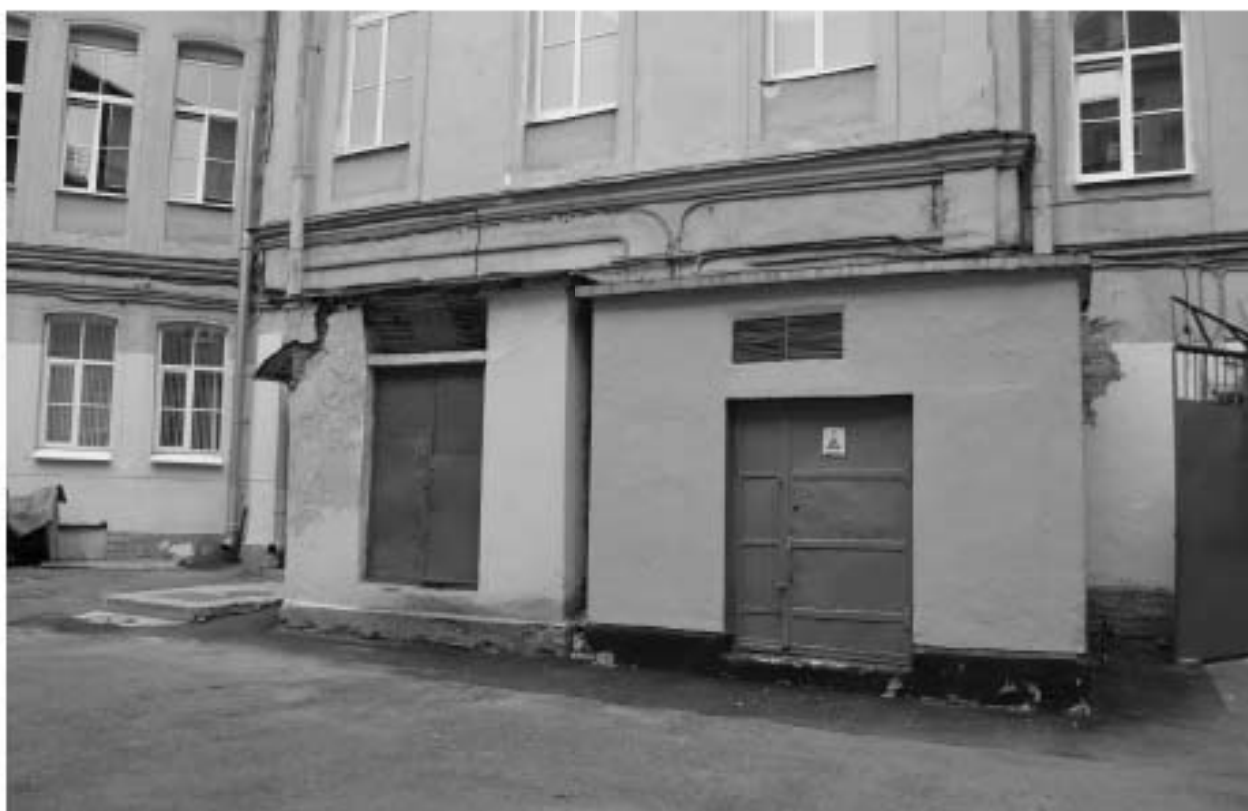
Фото 07. ОКН регионального значения «Особняк Строгановой А.Д.». Дворовые фасады. Фрагмент. Съёмка 21.06.2021 г.
