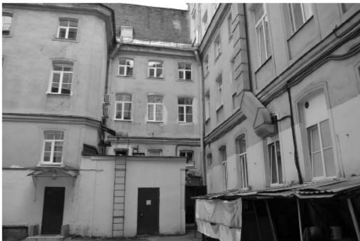
Фото 29. ОКН регионального значения «Особняк Строгановой А.Д.». Дворовые фасады. Двор. Фрагмент. Съёмка 21.06.2021 г.
