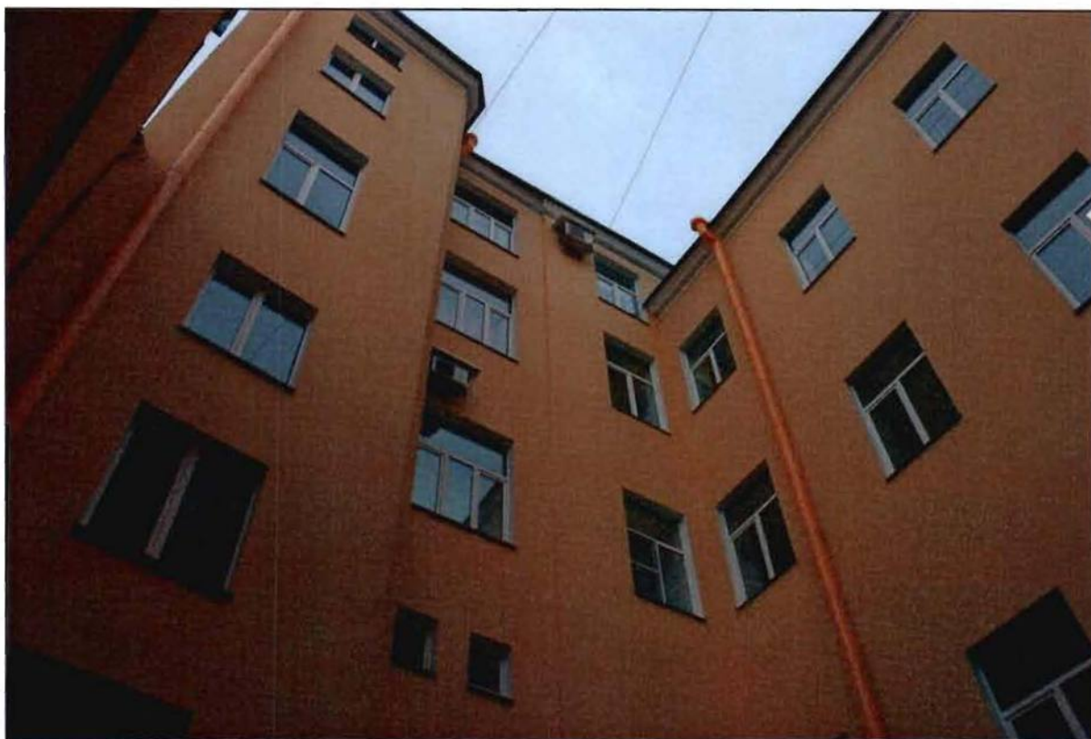
2. Вид на дворовые фасады.
