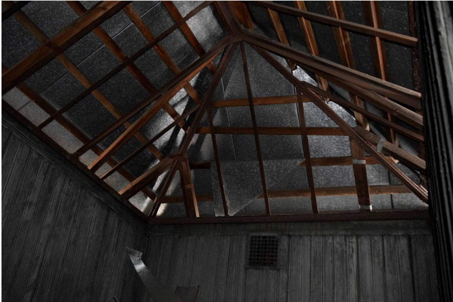
36. “Дом А.Ф. Кларка (здание общества «Мазут») Английская наб., д. 38, лит. А. Фонарь над лестницей №2. Фрагмент. Фото:01.02.21.
