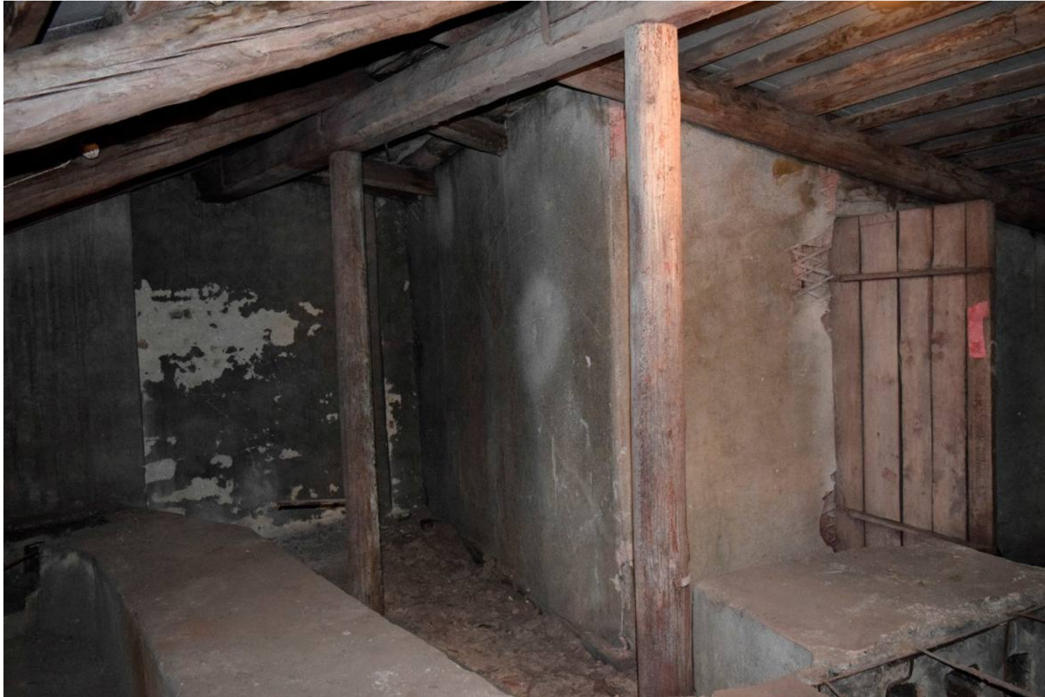
37. “Дом А.Ф. Кларка (здание общества «Мазут») Английская наб., д. 38, лит. А. Фонарь над лестницей №2. Фрагмент. Фото:01.02.21.
