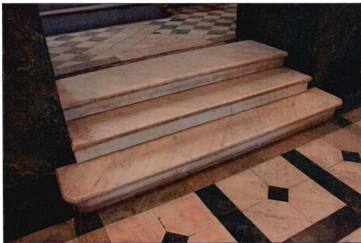
10. Интерьер. Фрагмент. Средистенная лестница со ступенями, облицованными плитами мрамора.
