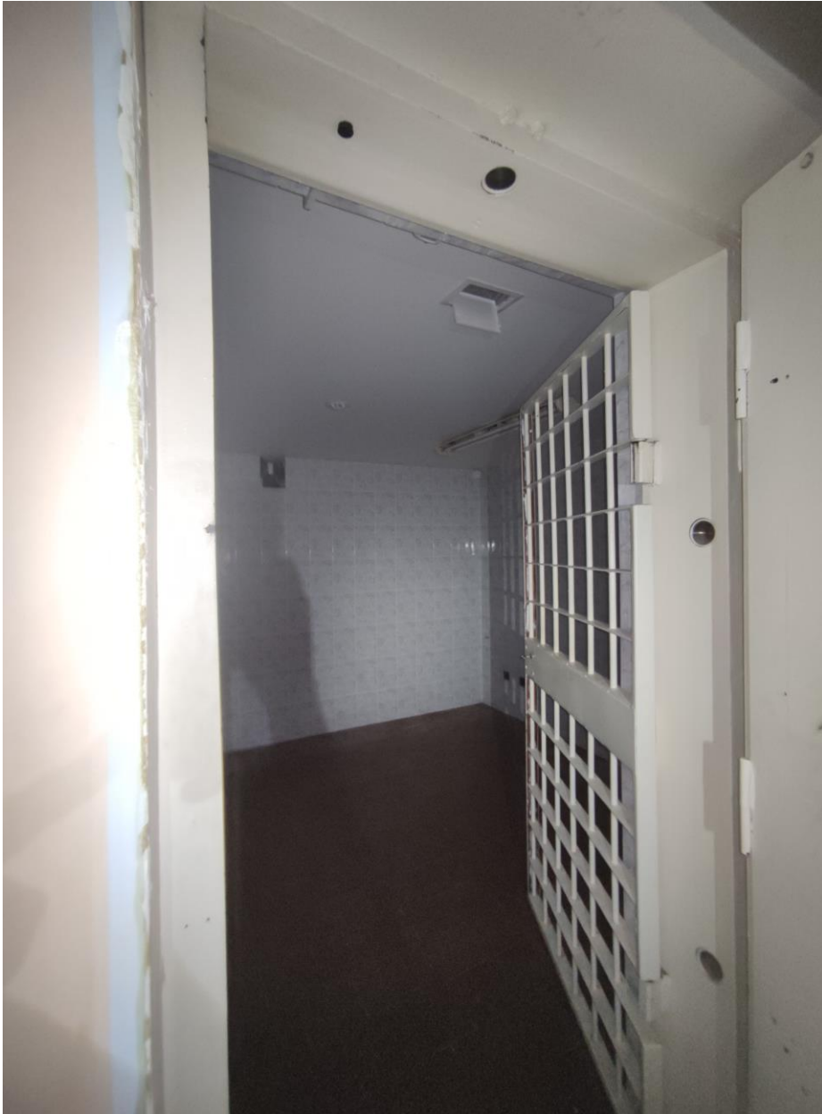
Фото 17. Выявленный объект культурного наследия «Дом А.А. Каплуна». Санкт-Петербург, Каменноостровский проспект, дом 53/22 лит.А (Каменноостровский пр., 53; Профессора Попова ул., 22 (угловой дом)). Помещение 21. Дата съёмки – 12.07.2021 г.
