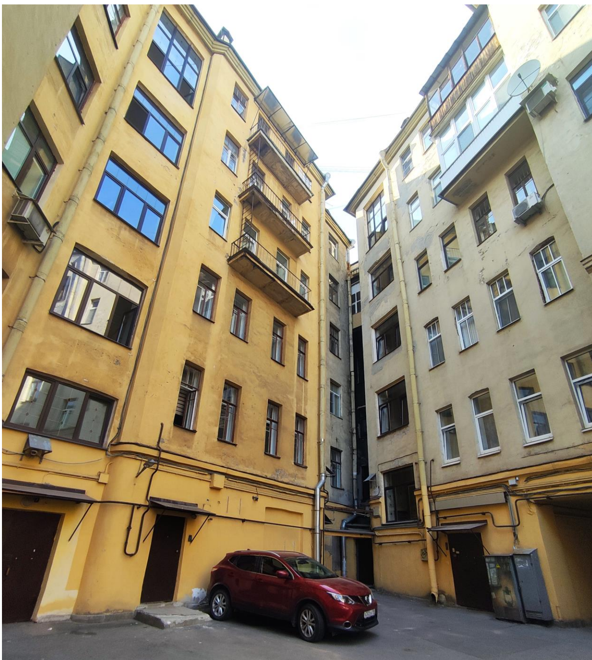
Фото 6. Выявленный объект культурного наследия «Дом А.А. Каплуна». Санкт-Петербург, Каменноостровский проспект, дом 53/22 лит.А (Каменноостровский пр., 53; Профессора Попова ул., 22 (угловой дом)). Фрагменты дворовых фасадов. Дата съёмки – 12.07.2021 г.
