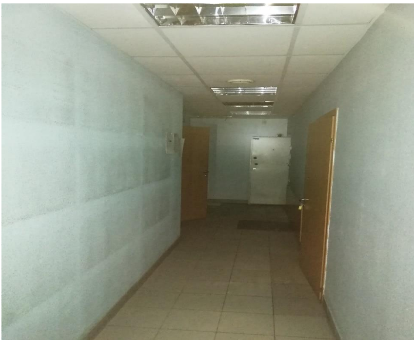
Фото 18. Выявленный объект культурного наследия «Дом А.А. Каплуна». Санкт-Петербург, Каменноостровский проспект, дом 53/22 лит.А (Каменноостровский пр., 53; Профессора Попова ул., 22 (угловой дом). Помещение 25.
