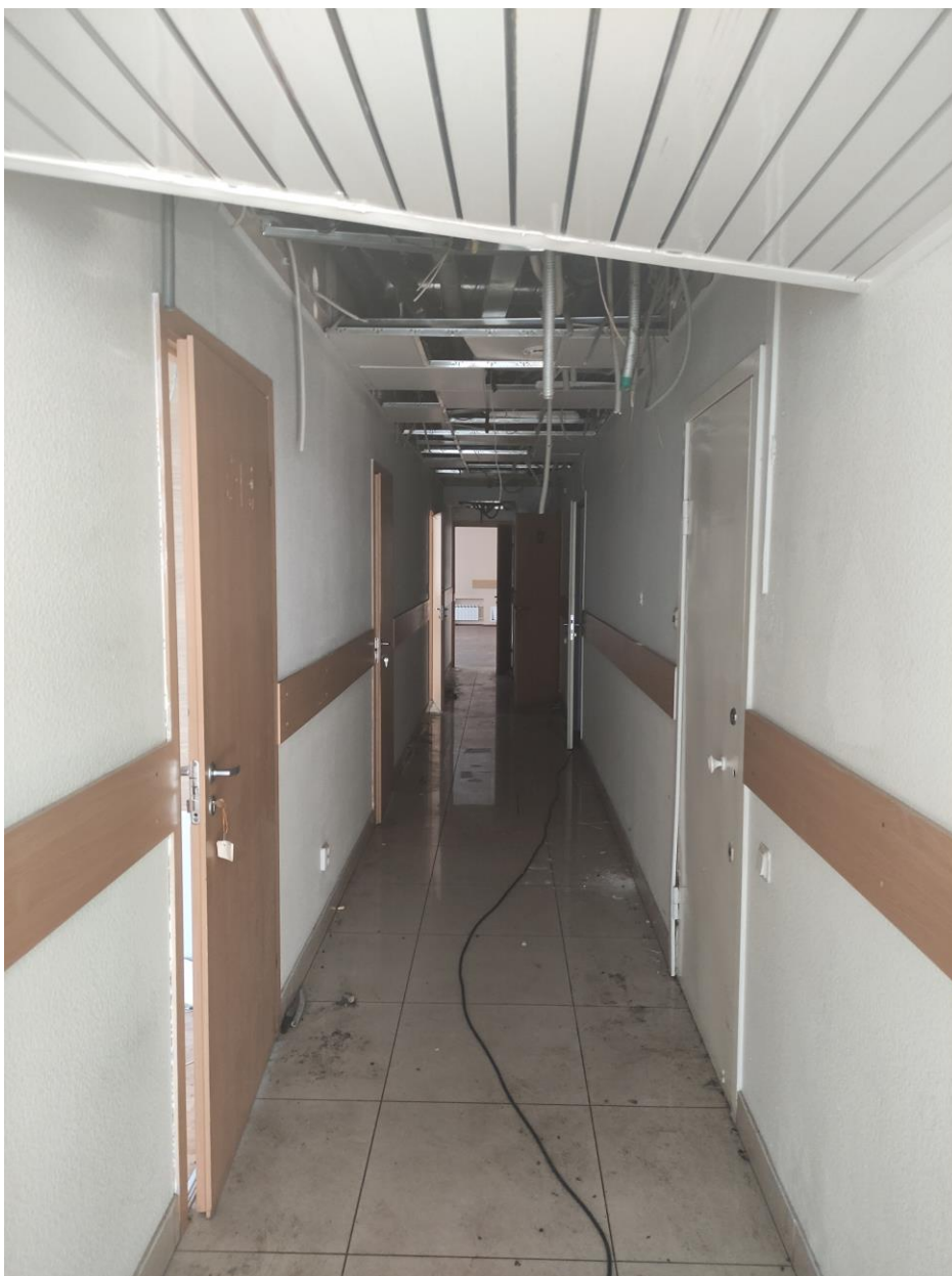
Фото 27. Выявленный объект культурного наследия «Дом А.А. Каплуна». Санкт-Петербург, Каменноостровский проспект, дом 53/22 лит.А (Каменноостровский пр., 53; Профессора Попова ул., 22 (угловой дом). Помещение 6. Дата съёмки – 12.07.2021 г.
