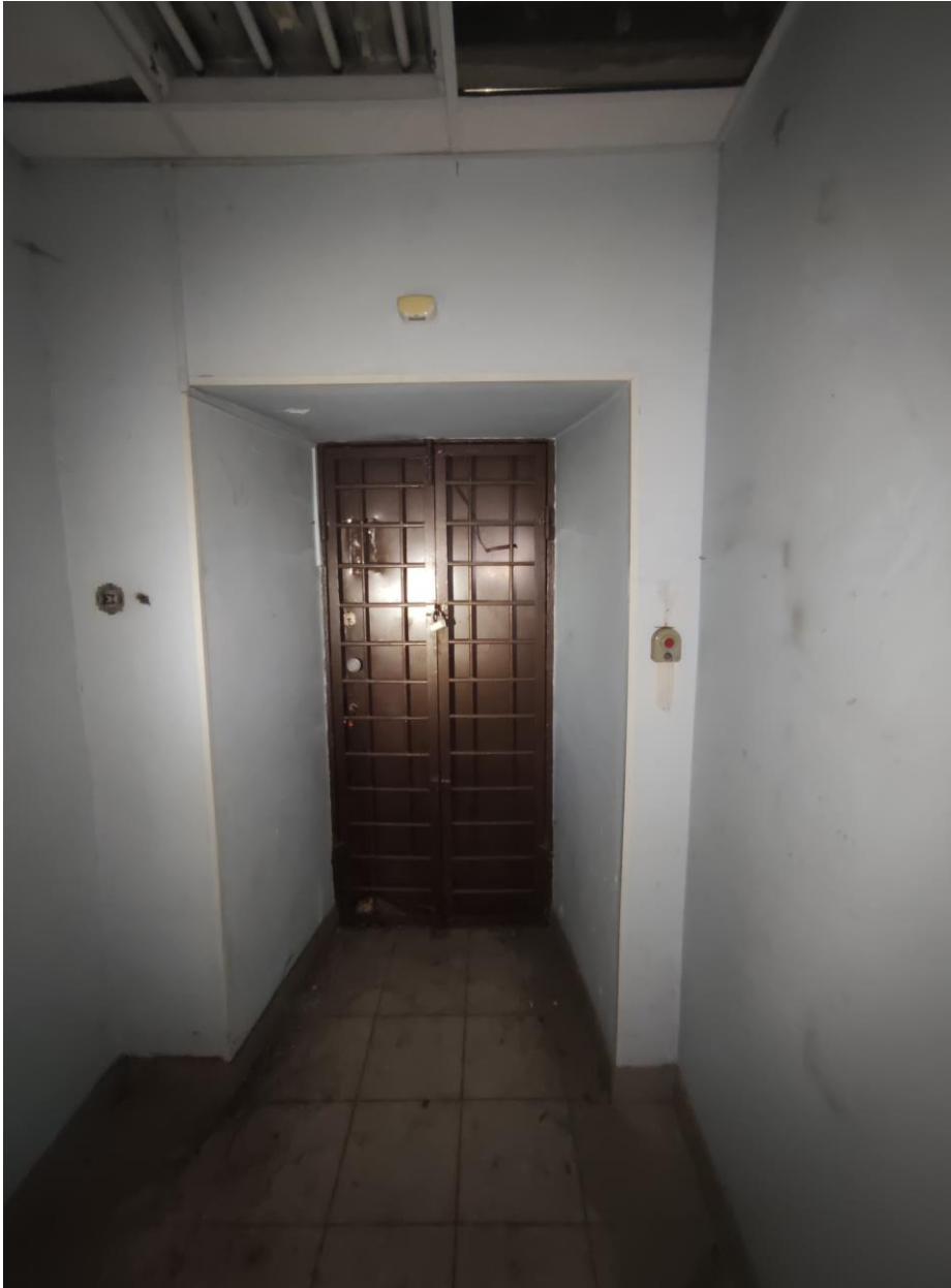
Фото 15. Выявленный объект культурного наследия «Дом А.А. Каплуна». Санкт-Петербург, Каменноостровский проспект, дом 53/22 лит.А (Каменноостровский пр., 53; Профессора Попова ул., 22 (угловой дом). Помещение 23. Дверной проем с заполнением. Дата съёмки – 12.07.2021 г.
