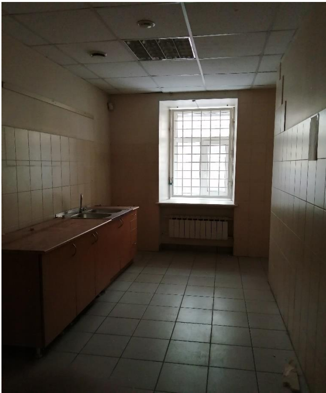
Фото 23. Выявленный объект культурного наследия «Дом А.А. Каплуна». Санкт-Петербург, Каменноостровский проспект, дом 53/22 лит.А (Каменноостровский пр., 53; Профессора Попова ул., 22 (угловой дом). Помещение 41.
