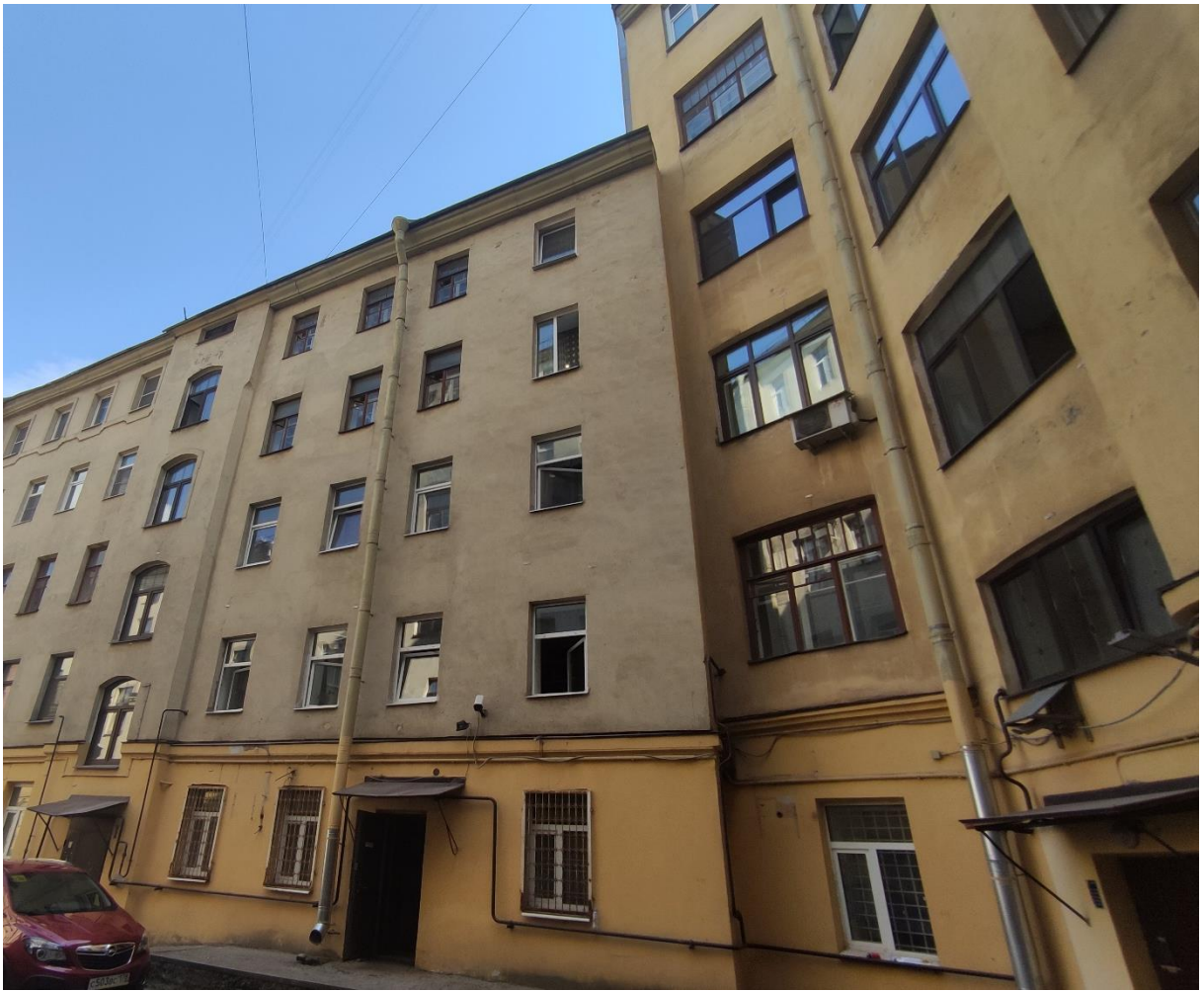
Фото 5. Выявленный объект культурного наследия «Дом А.А. Каплуна». Санкт-Петербург, Каменноостровский проспект, дом 53/22 лит.А (Каменноостровский пр., 53; Профессора Попова ул., 22 (угловой дом). Фрагменты дворовых фасадов. Дата съёмки – 12.07.2021 г.
