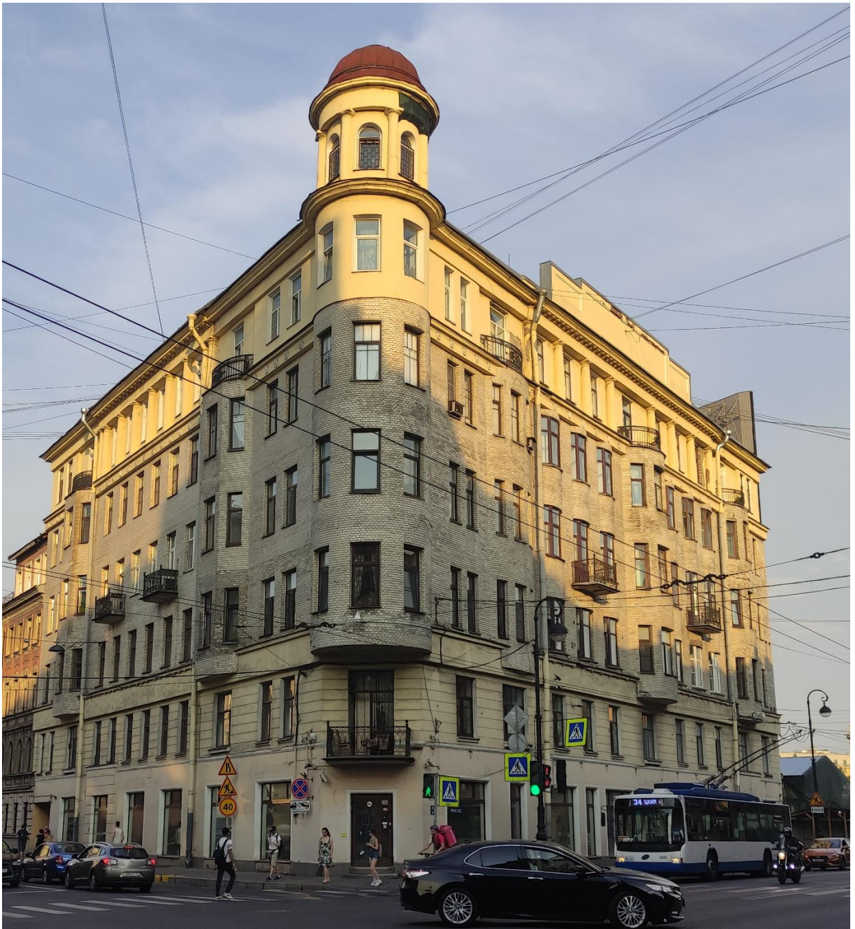
Фото 1. Выявленный объект культурного наследия «Дом А.А. Каплуна». Санкт-Петербург, Каменноостровский проспект, дом 53/22 лит.А (Каменноостровский пр., 53; Профессора Попова ул., 22 (угловой дом). Общий вид. Фасады. Дата съёмки – 12.07.2021 г.
