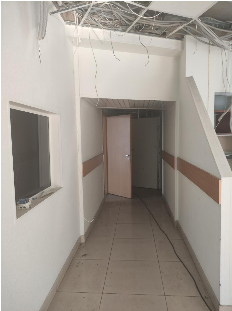
Фото 11. Выявленный объект культурного наследия «Дом А.А. Каплуна». Санкт-Петербург, Каменноостровский проспект, дом 53/22 лит.А (Каменноостровский пр., 53; Профессора Попова ул., 22 (угловой дом)). Вид на помещение 6 (коридор). Дата съёмки – 12.07.2021 г.
