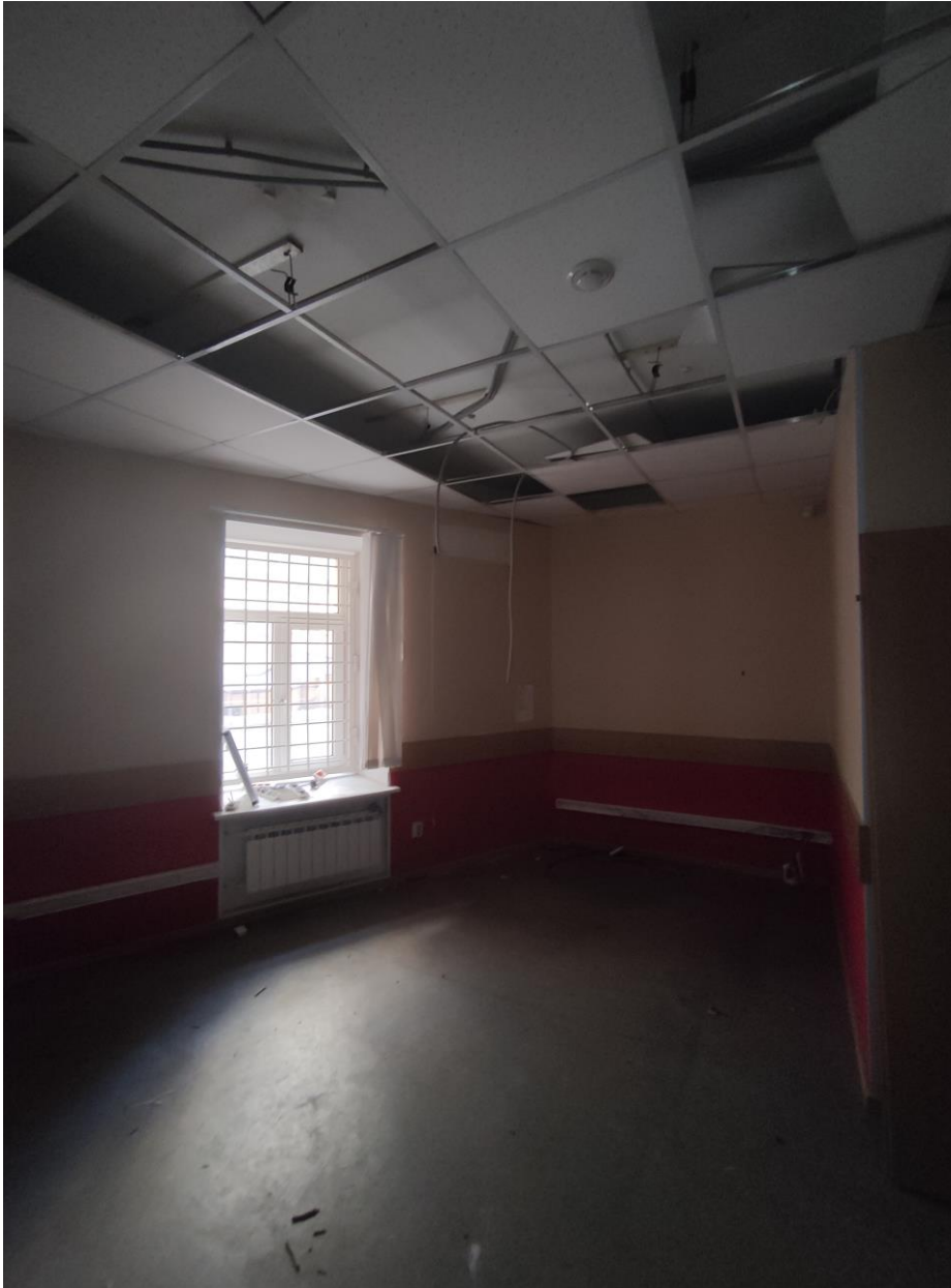
Фото 22. Выявленный объект культурного наследия «Дом А.А. Каплуна». Санкт-Петербург, Каменноостровский проспект, дом 53/22 лит.А (Каменноостровский пр., 53; Профессора Попова ул., 22 (угловой дом). Помещение 40. Дата съёмки – 12.07.2021 г.
