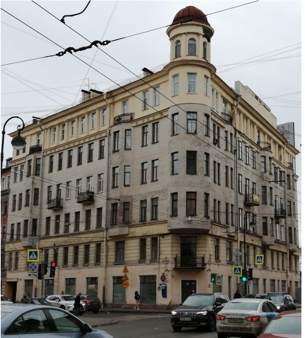
Фото 1. Выявленный объект культурного наследия «Дом А.А. Каплуна». Санкт-Петербург, Каменноостровский проспект, дом 53/22 лит.А (Каменноостровский пр., 53; Профессора Попова ул., 22 (угловой дом). Общий вид. Фасады.
