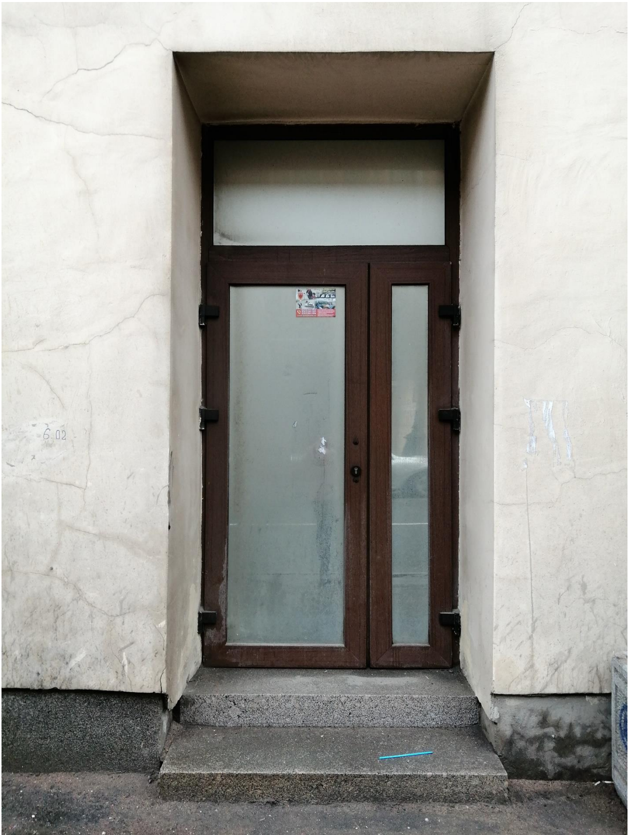
Фото 3. Выявленный объект культурного наследия «Дом А.А. Каплуна». Санкт-Петербург, Каменноостровский проспект, дом 53/22 лит.А (Каменноостровский пр., 53; Профессора Попова ул., 22 (угловой дом). Фрагмент фасада по Каменноостровскому проспекту. Входной проем с дверным заполнением (вход в помещение 4-Н).
