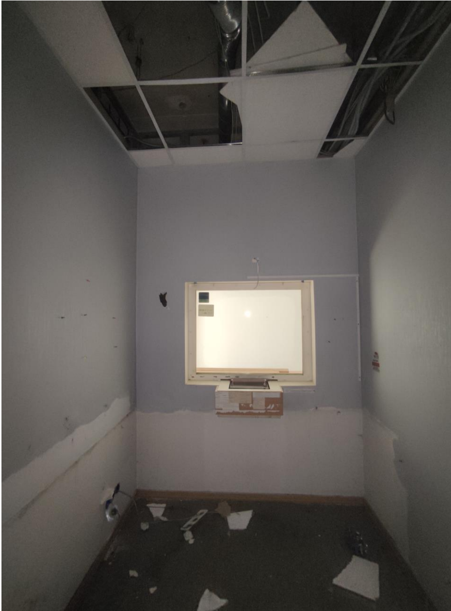
Фото 20. Выявленный объект культурного наследия «Дом А.А. Каплуна». Санкт-Петербург, Каменноостровский проспект, дом 53/22 лит.А (Каменноостровский пр., 53; Профессора Попова ул., 22 (угловой дом). Помещение 29. Дата съёмки – 12.07.2021 г.
