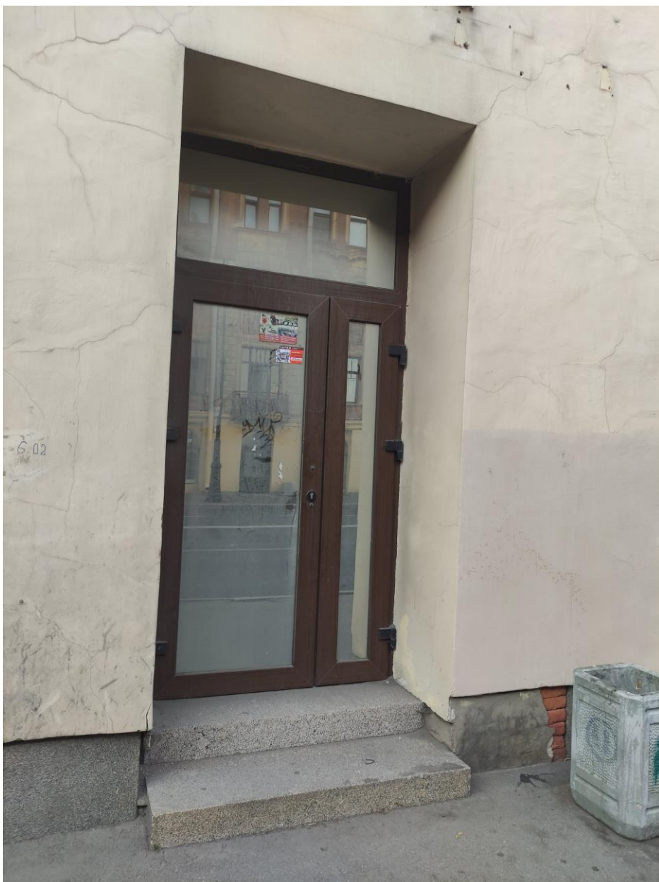
Фото 3. Выявленный объект культурного наследия «Дом А.А. Каплуна». Санкт-Петербург, Каменноостровский проспект, дом 53/22 лит.А (Каменноостровский пр., 53; Профессора Попова ул., 22 (угловой дом). Фрагмент фасада по Каменноостровскому проспекту. Входной проем с дверным заполнением (вход в помещение 4-Н). Дата съёмки – 12.07.2021 г.
