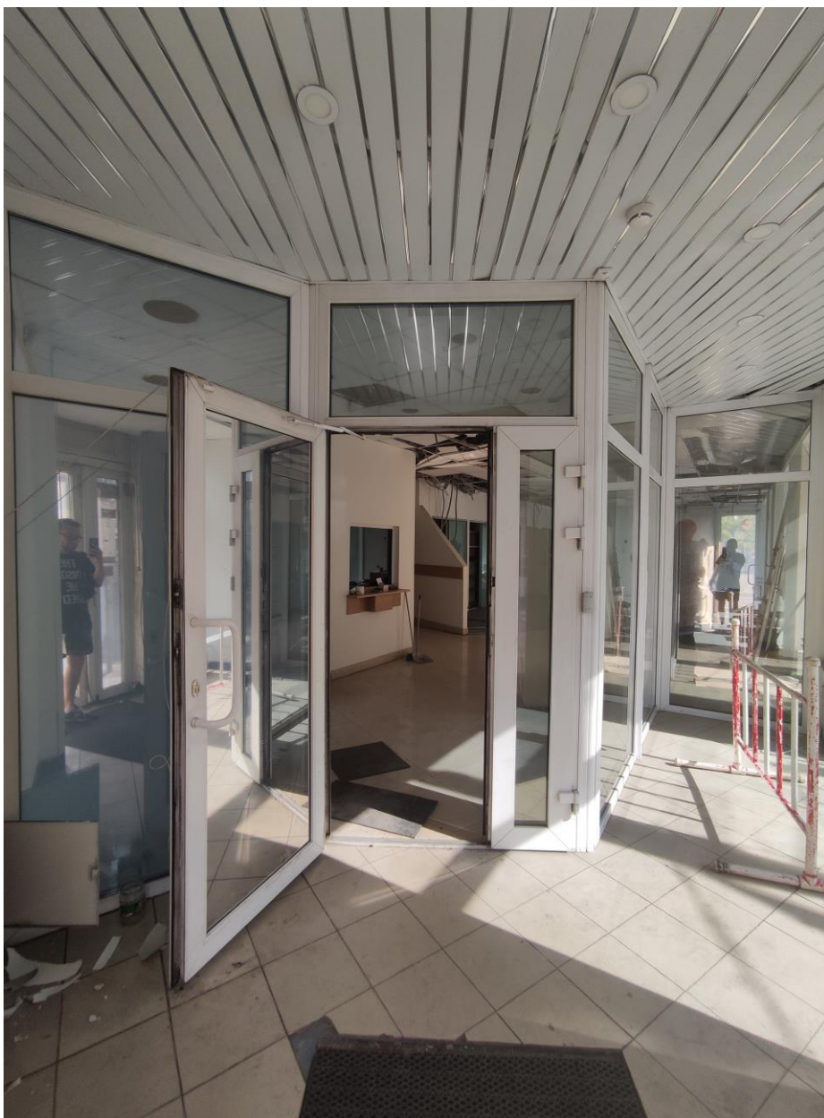
Фото 7. Выявленный объект культурного наследия «Дом А.А. Каплуна». Санкт-Петербург, Каменноостровский проспект, дом 53/22 лит.А (Каменноостровский пр., 53; Профессора Попова ул., 22 (угловой дом). Фрагмент угловой части фасада, на пересечении Каменноостровского проспекта и ул. Профессора Попова. Тамбур входа в помещение 4-Н, помещение 1. Дата съёмки – 12.07.2021 г.
