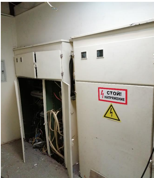
Фото 30. Выявленный объект культурного наследия «Дом А.А. Каплуна». Санкт-Петербург, Каменноостровский проспект, дом 53/22 лит.А (Каменноостровский пр., 53; Профессора Попова ул., 22 (угловой дом). Помещение 14.
