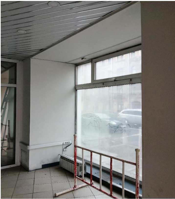
Фото 10. Выявленный объект культурного наследия «Дом А.А. Каплуна». Санкт-Петербург, Каменноостровский проспект, дом 53/22 лит.А (Каменноостровский пр., 53; Профессора Попова ул., 22 (угловой дом)). Оконный проем с заполнением, помещение 1.
