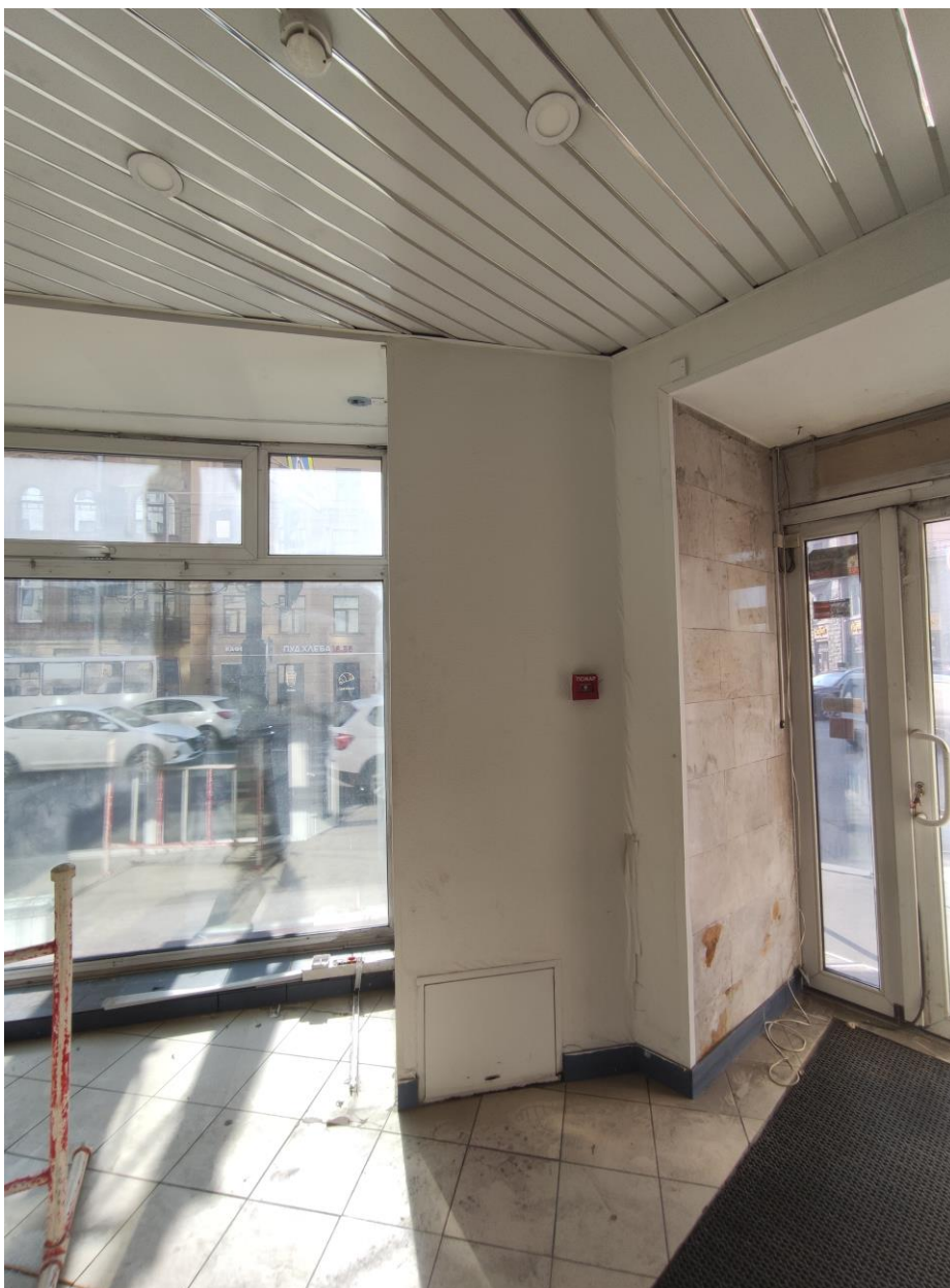
Фото 10. Выявленный объект культурного наследия «Дом А.А. Каплуна». Санкт-Петербург, Каменноостровский проспект, дом 53/22 лит.А (Каменноостровский пр., 53; Профессора Попова ул., 22 (угловой дом). Оконный проем с заполнением, помещение 1, вход в помещение 4-Н. Дата съёмки – 12.07.2021 г.
