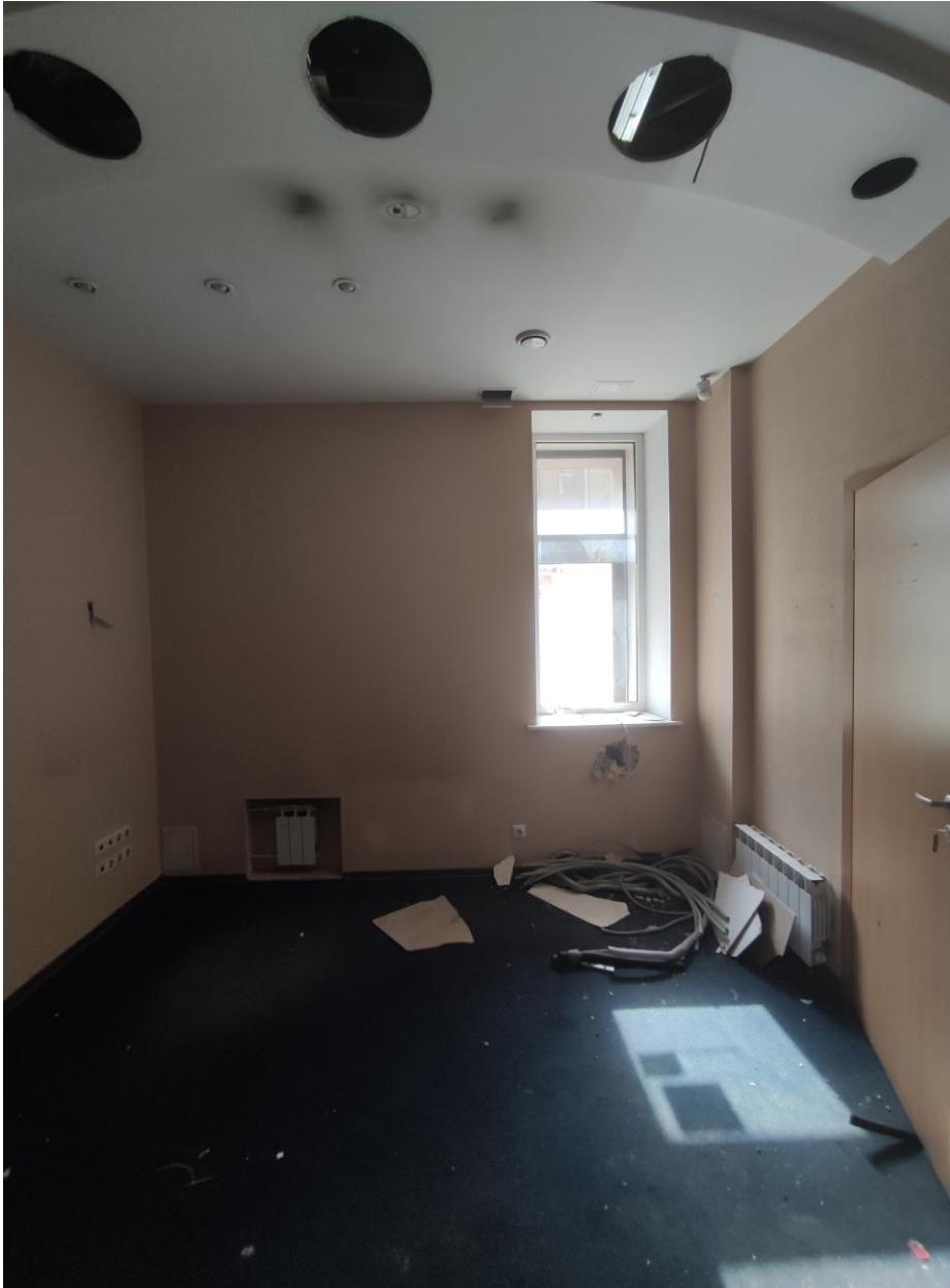
Фото 12. Выявленный объект культурного наследия «Дом А.А. Каплуна». Санкт-Петербург, Каменноостровский проспект, дом 53/22 лит.А (Каменноостровский пр., 53; Профессора Попова ул., 22 (угловой дом). Помещение 36. Вид на оконный проем, с заполнением, на месте дверного проема видна часть внешнего дверного заполнения. Дата съёмки – 12.07.2021 г.
