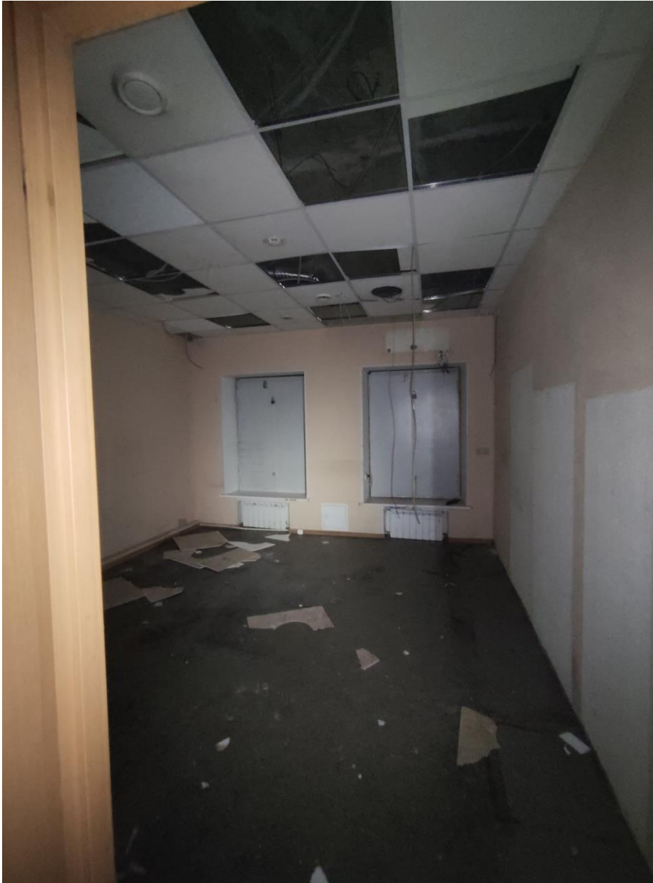
Фото 19. Выявленный объект культурного наследия «Дом А.А. Каплуна». Санкт-Петербург, Каменноостровский проспект, дом 53/22 лит.А (Каменноостровский пр., 53; Профессора Попова ул., 22 (угловой дом). Помещение 20. Дата съёмки – 12.07.2021 г.
