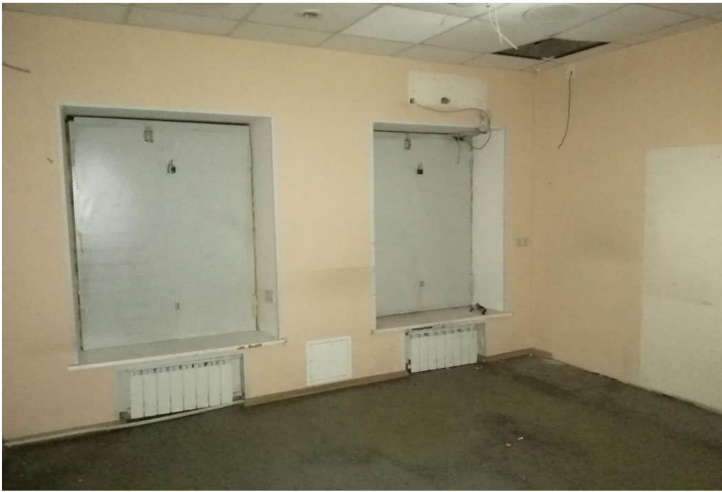
Фото 19. Выявленный объект культурного наследия «Дом А.А. Каплуна». Санкт-Петербург, Каменноостровский проспект, дом 53/22 лит.А (Каменноостровский пр., 53; Профессора Попова ул., 22 (угловой дом)). Помещение 20.
