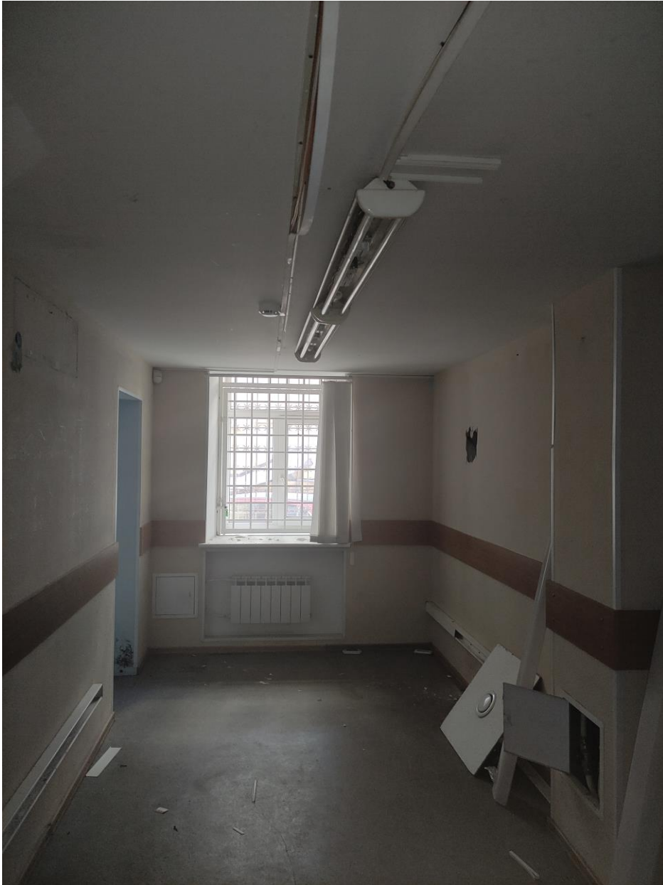
Фото 25. Выявленный объект культурного наследия «Дом А.А. Каплуна». Санкт-Петербург, Каменноостровский проспект, дом 53/22 лит.А (Каменноостровский пр., 53; Профессора Попова ул., 22 (угловой дом). Помещение 45 (слева ниша). Дата съёмки – 12.07.2021 г.
