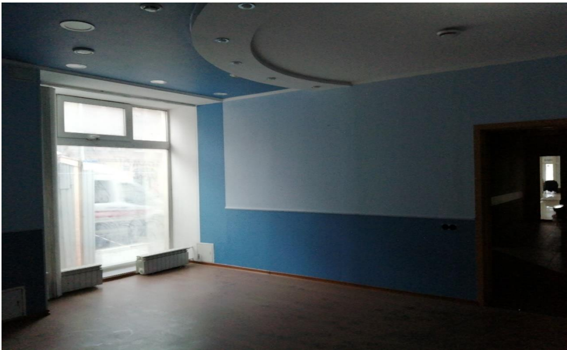
Фото 14. Выявленный объект культурного наследия «Дом А.А. Каплуна». Санкт-Петербург, Каменноостровский проспект, дом 53/22 лит.А (Каменноостровский пр., 53; Профессора Попова ул., 22 (угловой дом). Помещение 37.
