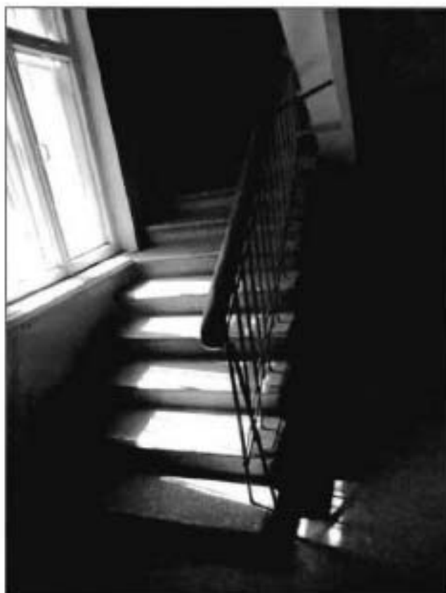
4. Межэтажная лестница. Общий вид.
