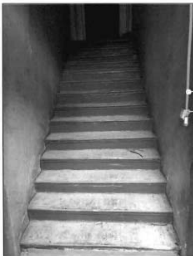
3. Лестница. Общій вид.
