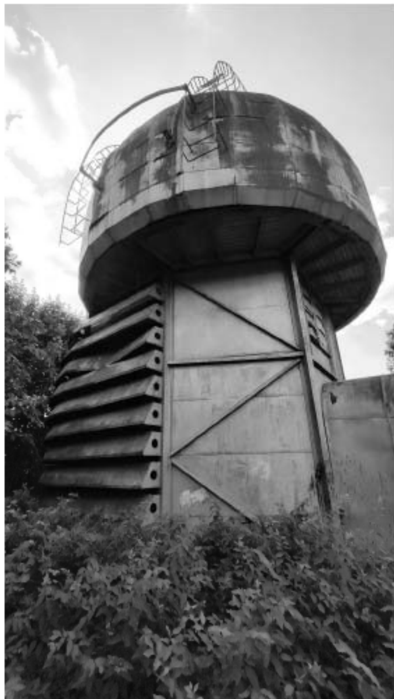
62. Объект культурного наследия федерального значения «Павильон рефлектора макетного (PM-700)», входящий в состав ансамбля «Обсерватория Пулковская» по адресу: г. Санкт-Петербург, Пулковское шоссе, д.65, лит. III, корп. 1 Вид с северо-востока Дата съемки: 21 июня 2021 г.
