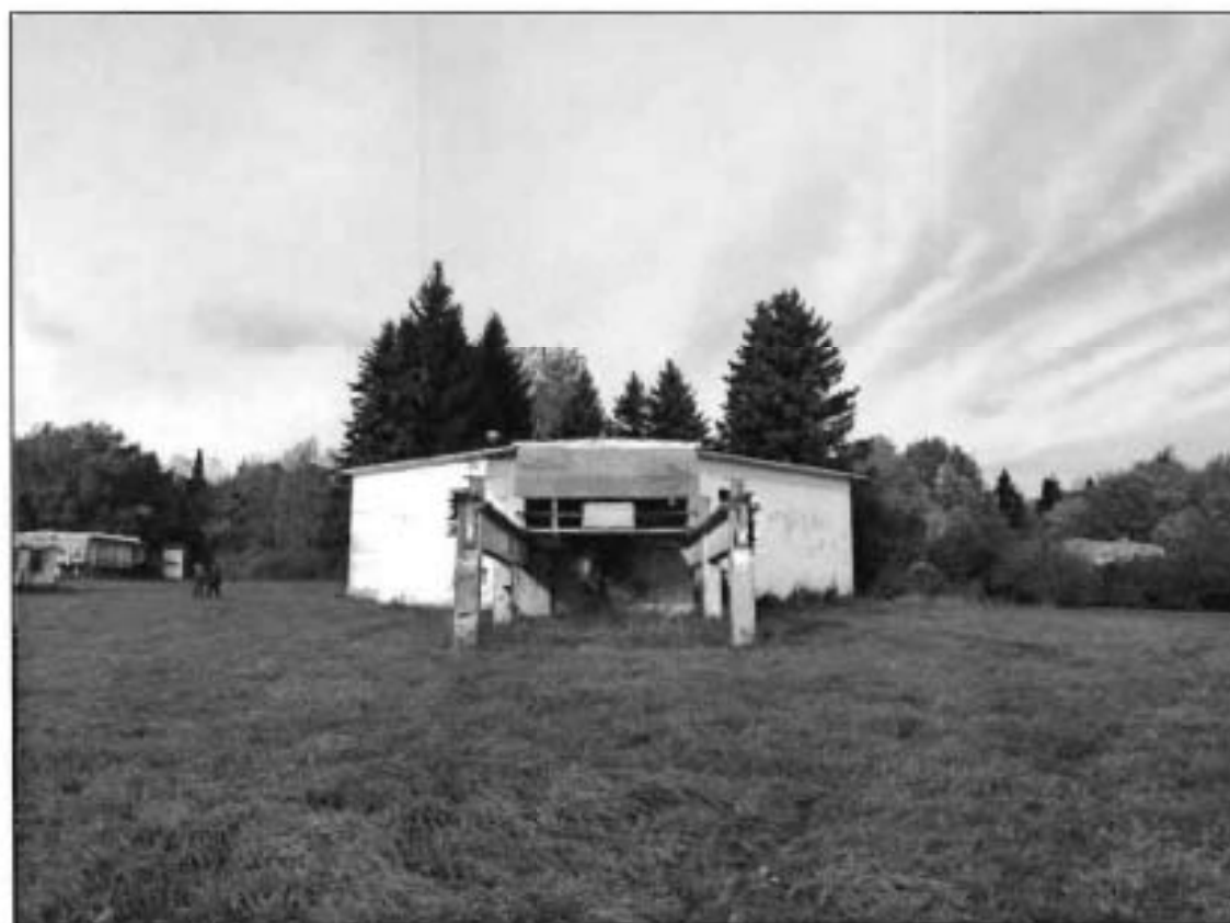
1. Общий вид с южной стороны.
