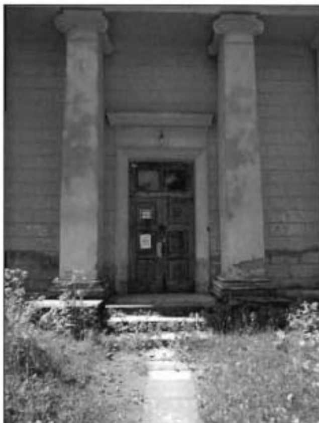
2. «Павильон 26-дюймового рефрактора». Восточный фасад. Фрагмент.
