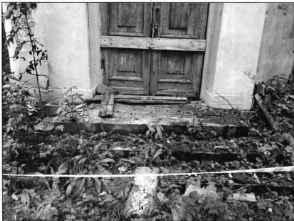
3. Восточный фасад. Крыльцо.
