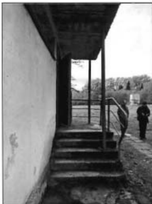
3. Северный фасад. Фрагмент. Крыльцо.
