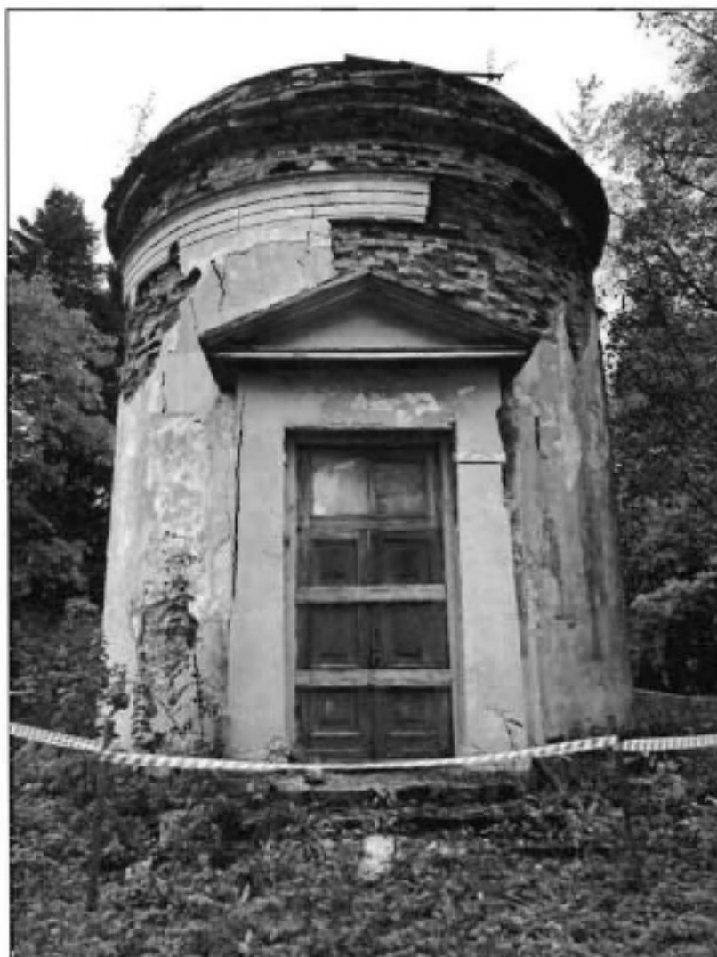
1. Восточный фасад. Общий вид.
