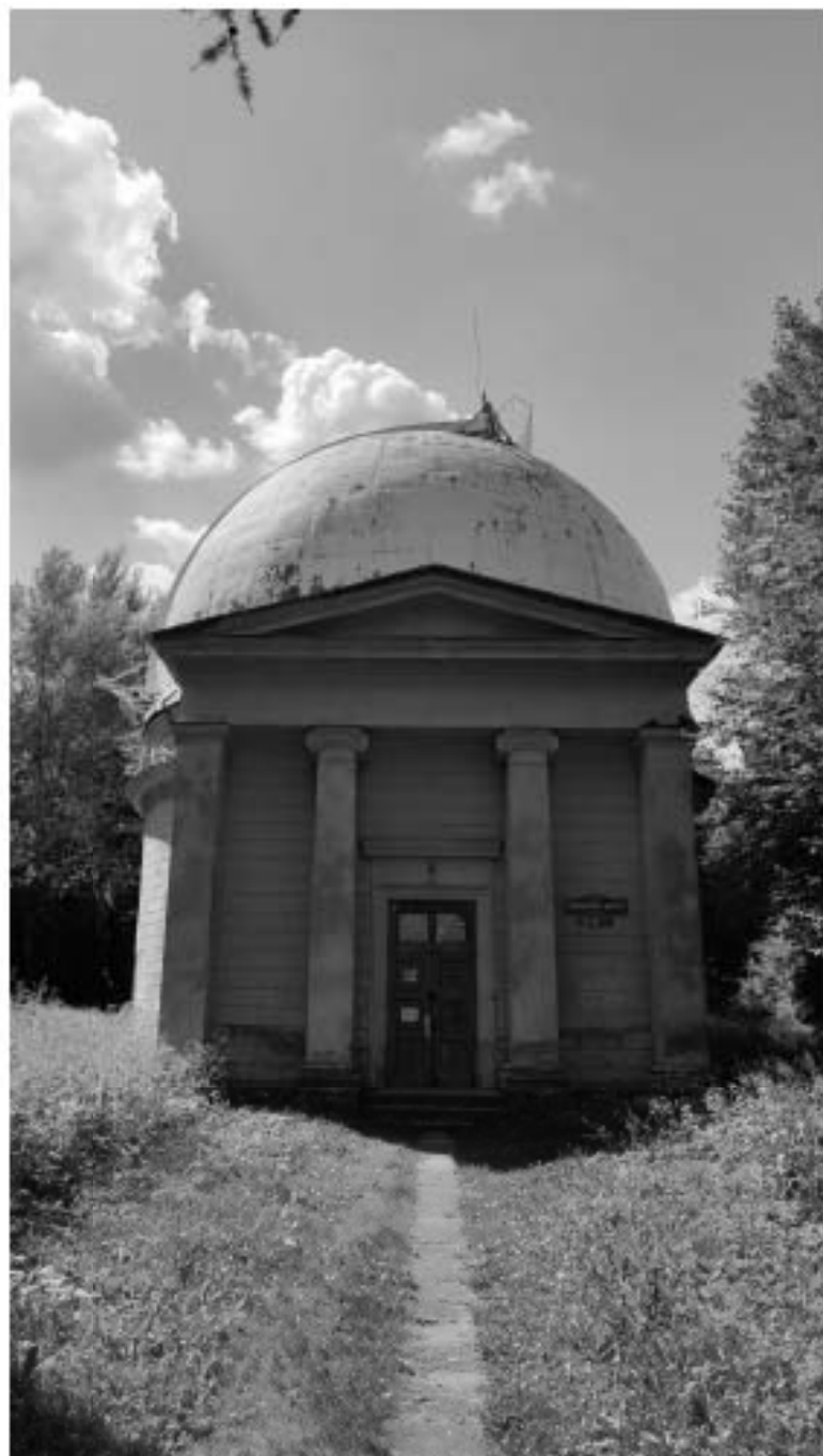
53. Объект культурного наследия федерального значения «Павильон 26-дюймового рефрактора», входящий в состав ансамбля «Обсерватория Пулковская» по адресу: г. Санкт-Петербург, Пулковское шоссе, д.65, лит. Ч, корп. 1 Вид с востока Дата съемки: 21 июня 2021 г.
