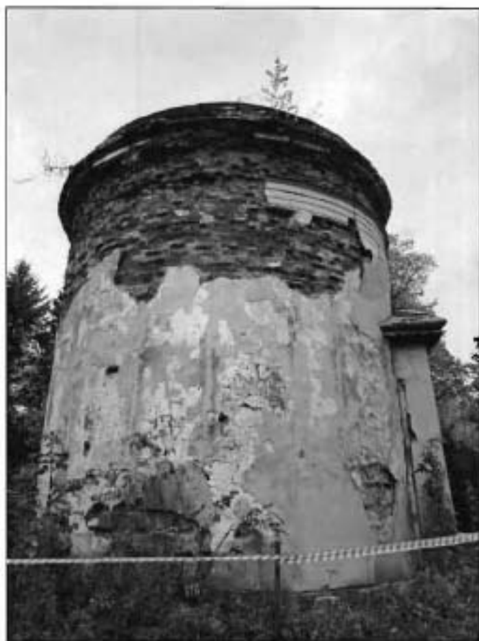
2. Южный фасад. Общий вид.
