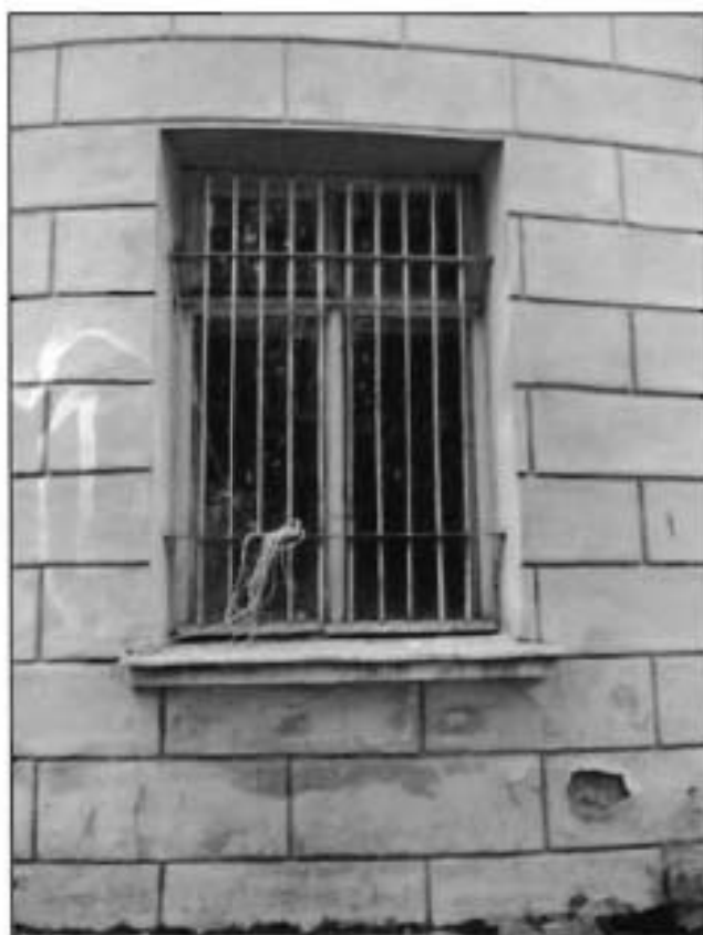
3. «Павильон 26-дюймового рефрактора». Оконный проем.
