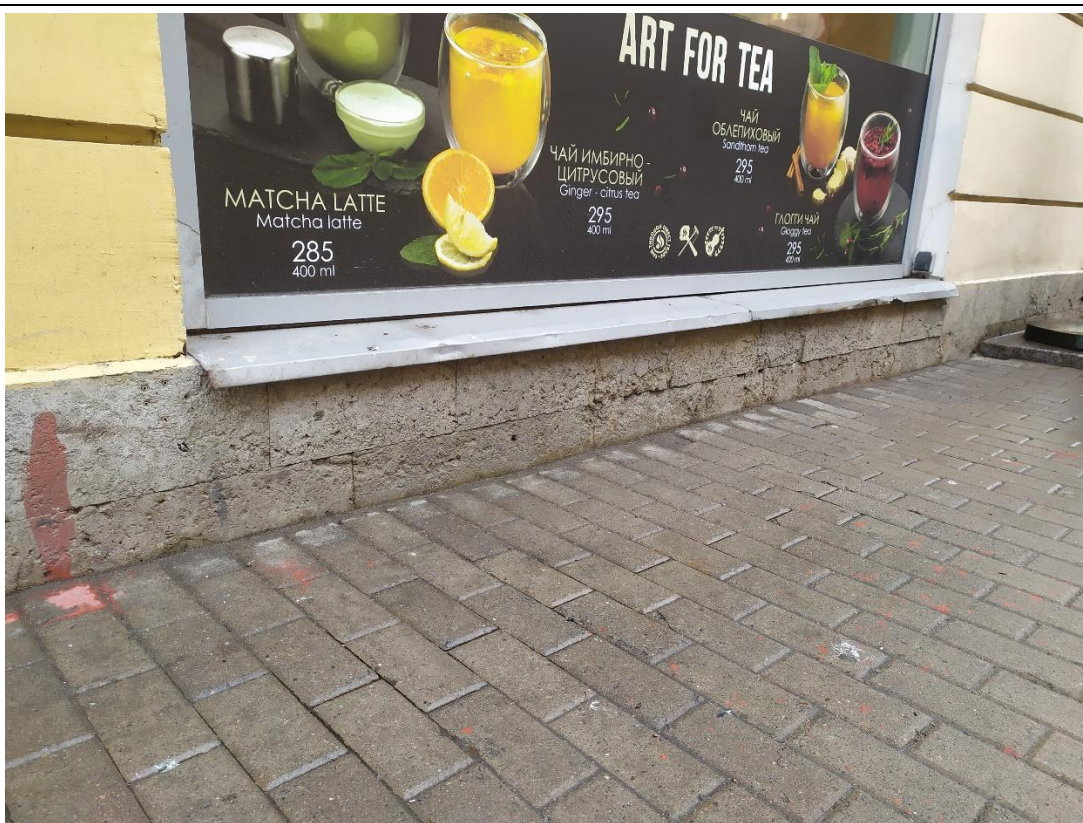
10. Фрагмент отделки цоколя под оконным проемом 5-й световой оси лицевого фасада корпуса по Малой Садовой улице выявленного объекта культурного наследия «Дом Демидовых (А.М. Ушакова)», расположенного по адресу: г. Санкт-Петербург, Малая Садовая улица, дом 3/54, литера А.
