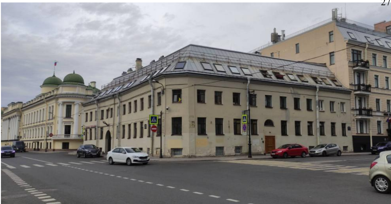
Фото 1. Общий выявленного объекта культурного наследия «Жилой дом»
