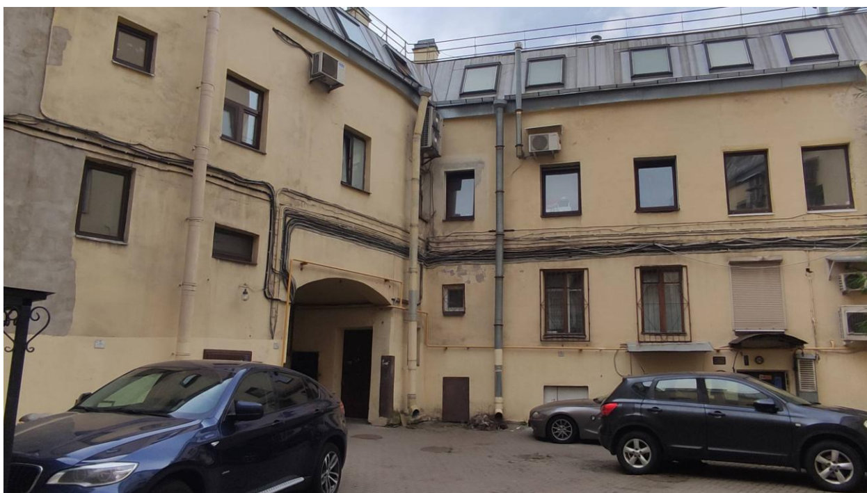
Фото 16. Фрагмент дворового фасада выявленного объекта культурного наследия «Жилой дом»
