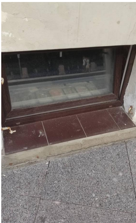
Фото 10. Оконные заполнения фасада выявленного объекта культурного наследия «Жилой дом» по наб. реки Фонтанки
