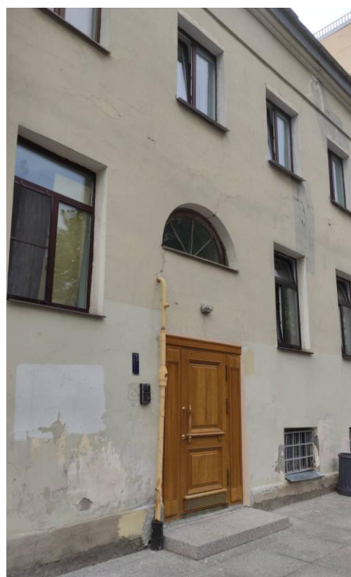
Фото 13. Дверное заполнение фасада выявленного объекта культурного наследия «Жилой дом» по ул. Гангутской
