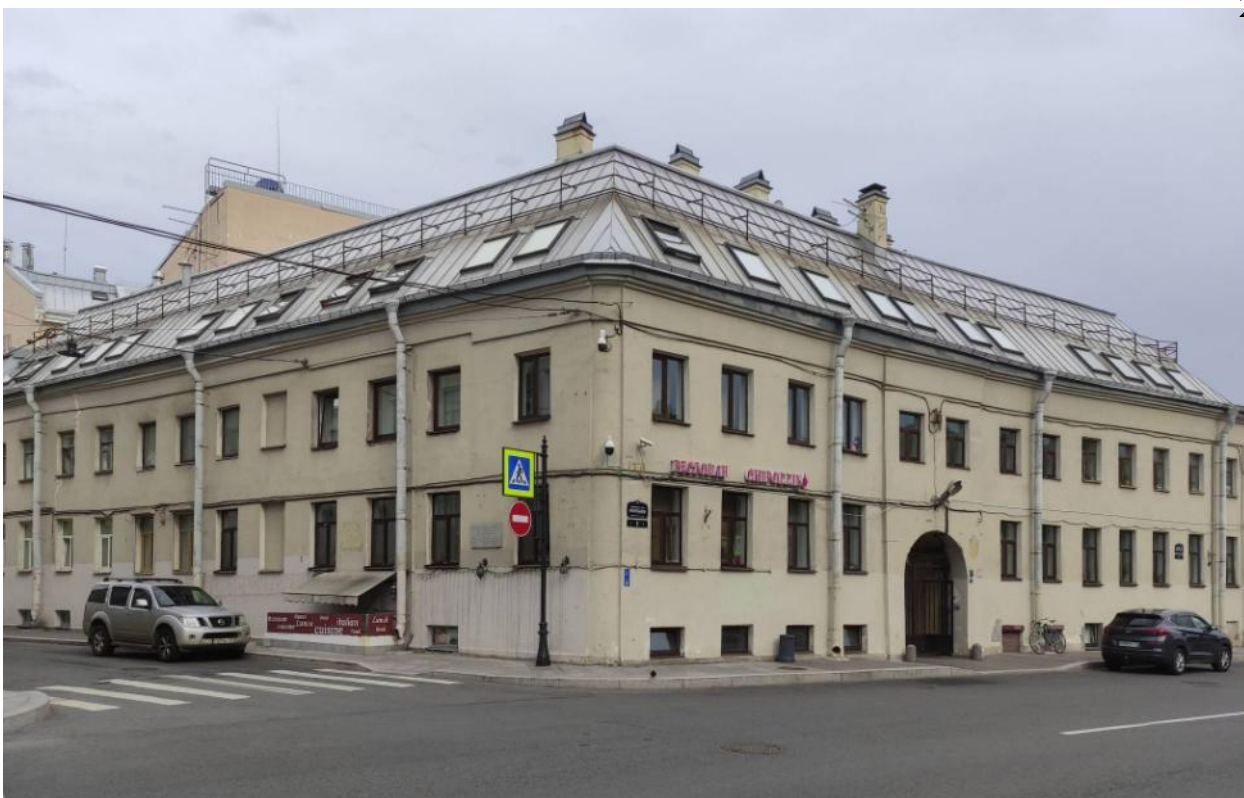
Фото 3.Общий вид фасада выявленного объекта культурного наследия «Жилой дом», угол наб. реки Фонтанки и ул. Оружейника Федорова
