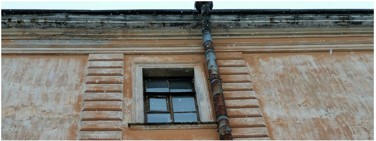
Фото 19. Торцевой фасад. Карниз. Оконный проем 3-го этажа.
