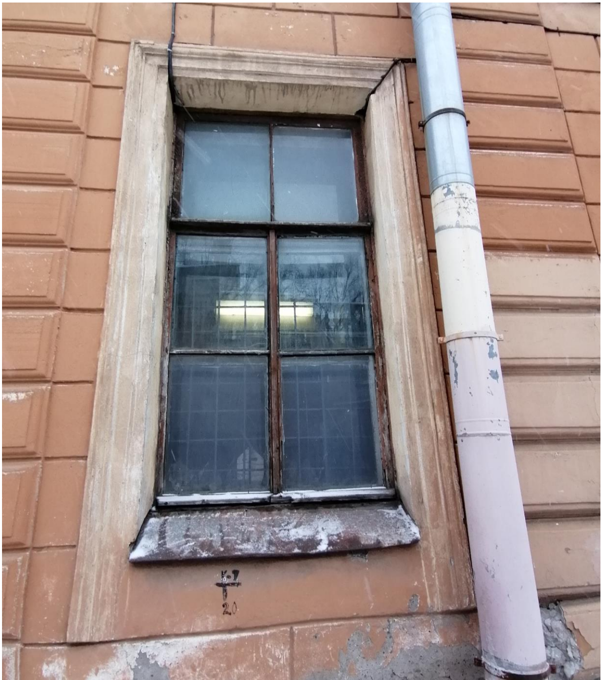
Фото 20. Торцевой фасад. Оконный проем в уровне 1-го этажа.
