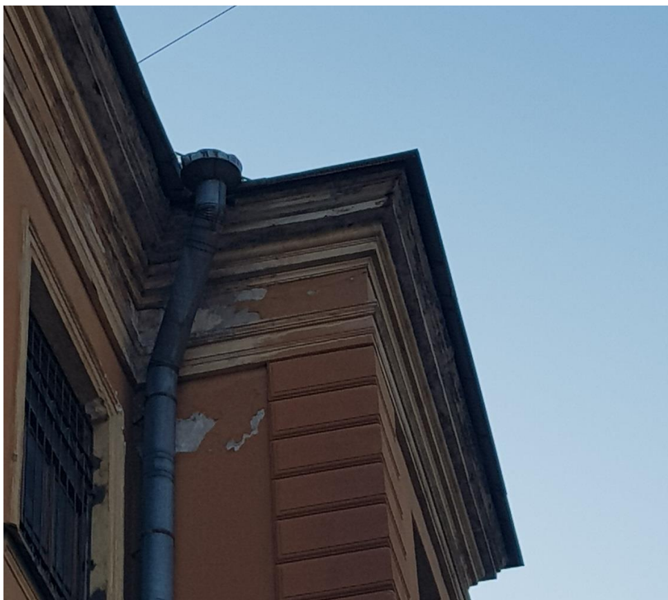
Фото 12. Дворовой фасад. Карниз.
