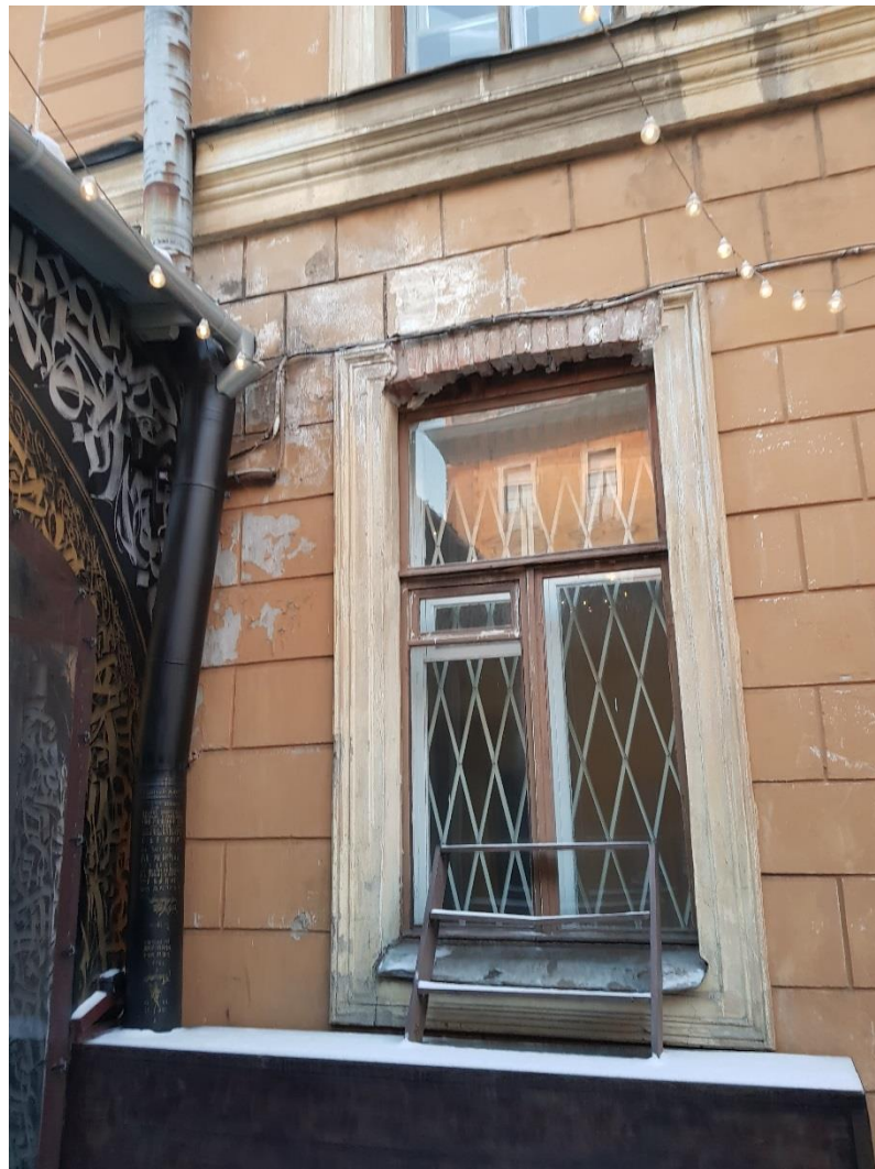
Фото 9. Торцевой фасад. Оформление оконного проема 1-го этажа.
