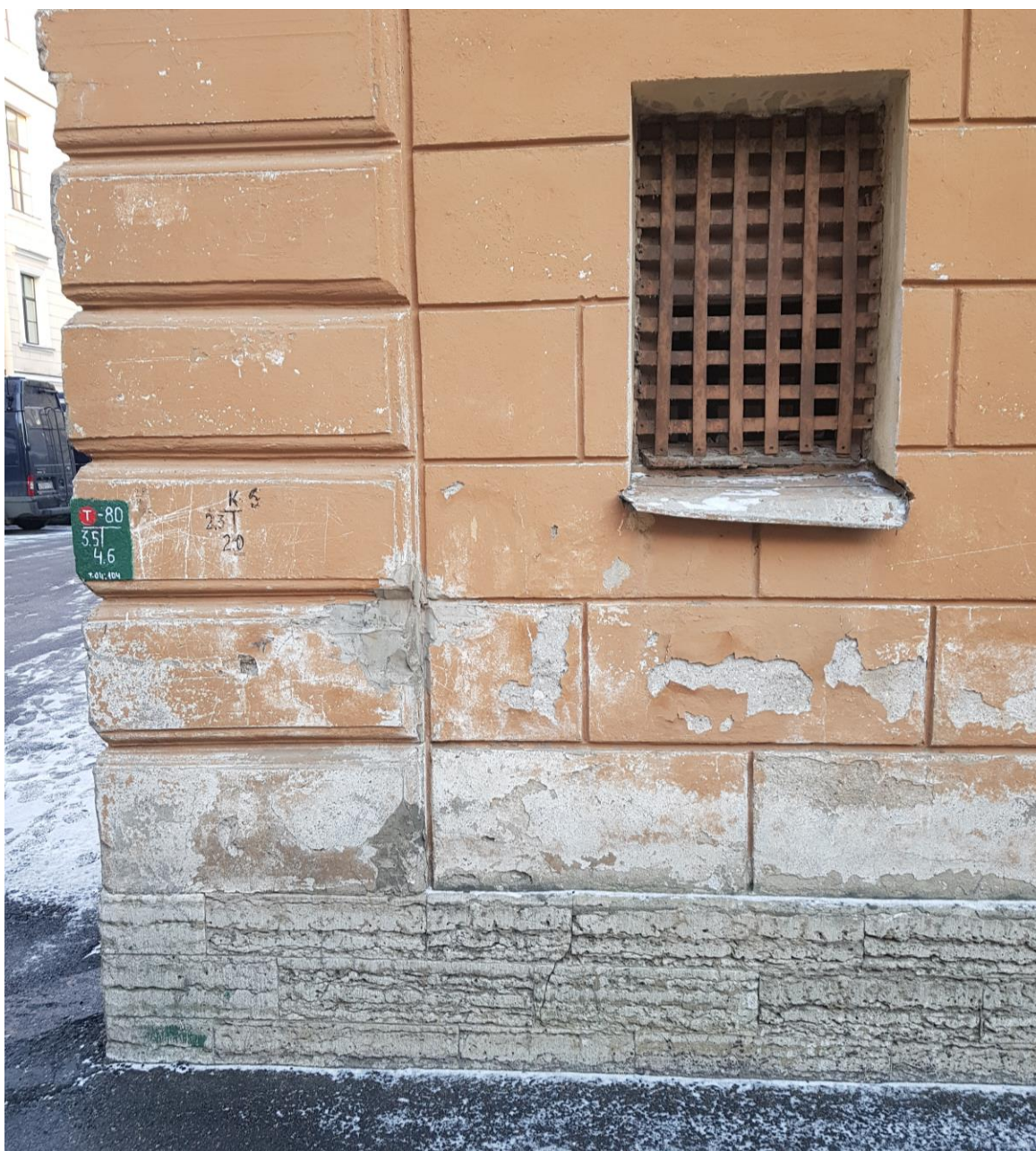
Фото 21. Торцевой фасад. Оконный проем в уровне 1-го этажа.
