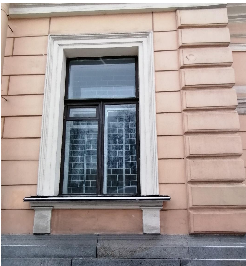
Фото 4. Лицевой фасад. Оконный проем 1-го этажа.
