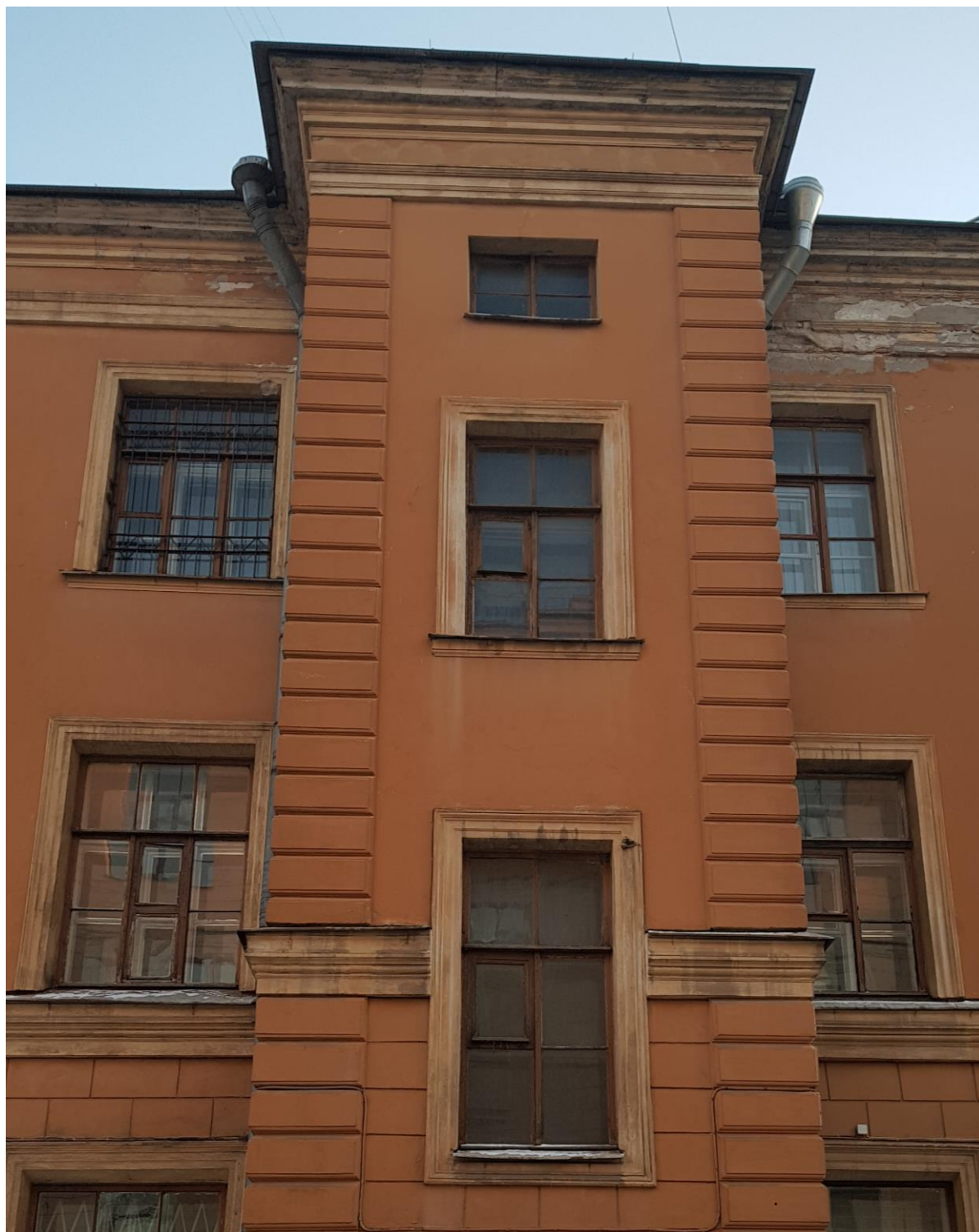
Фото 16. Дворовой фасад. Оконные проемы в уровне 2-го и 3-го этажей.
