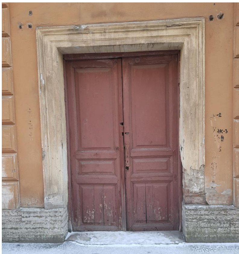
Фото 14. Дворовой фасад. Дверной проем на ризалите.
