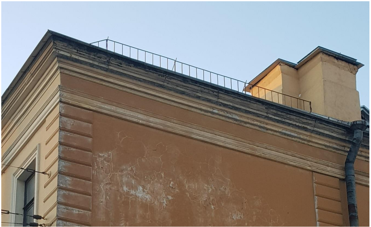
Фото 8. Торцевой фасад. Карниз.
