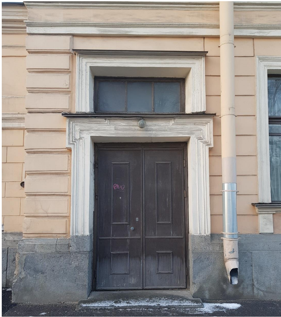
Фото 5. Лицевой фасад. Оформление дверного проема.
