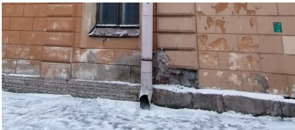
Фото 22. Торцевой фасад. Цоколь.
