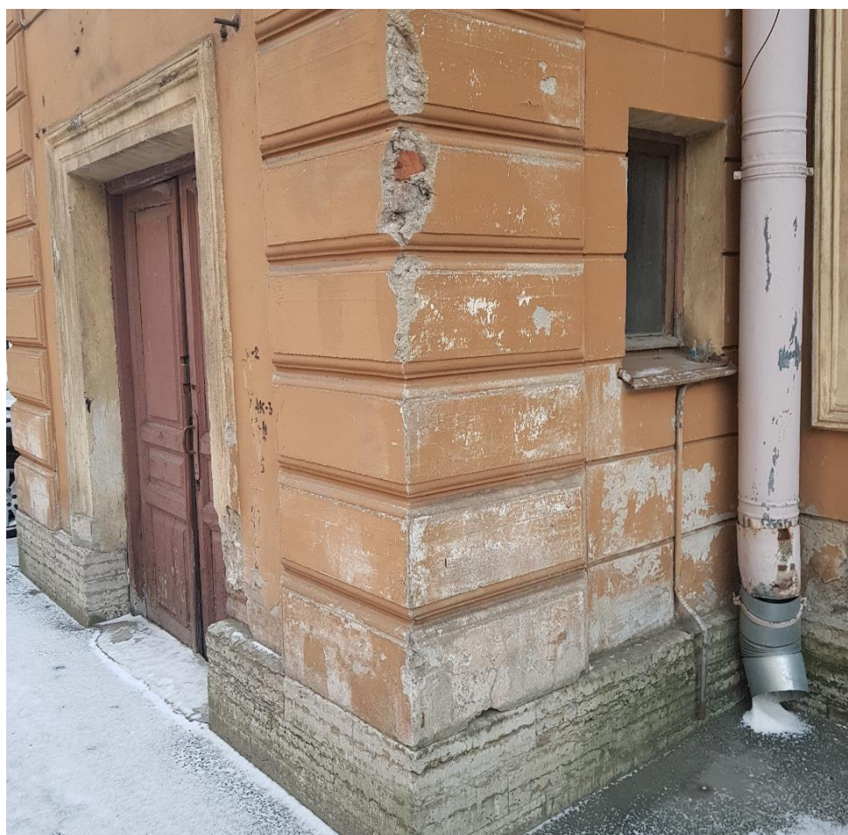
Фото 13. Дворовой фасад. Дверной и оконный проемы на ризалите.
