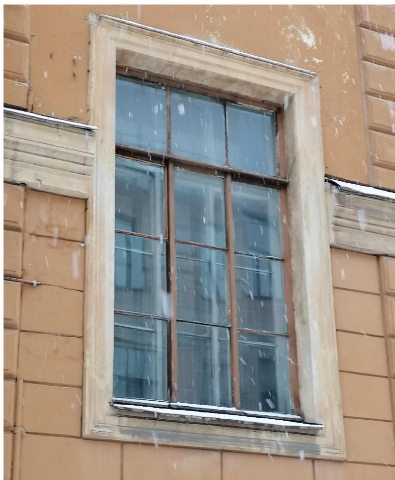
Фото 15. Дворовой фасад. Оконный проем в лестнице ЛК-1.
