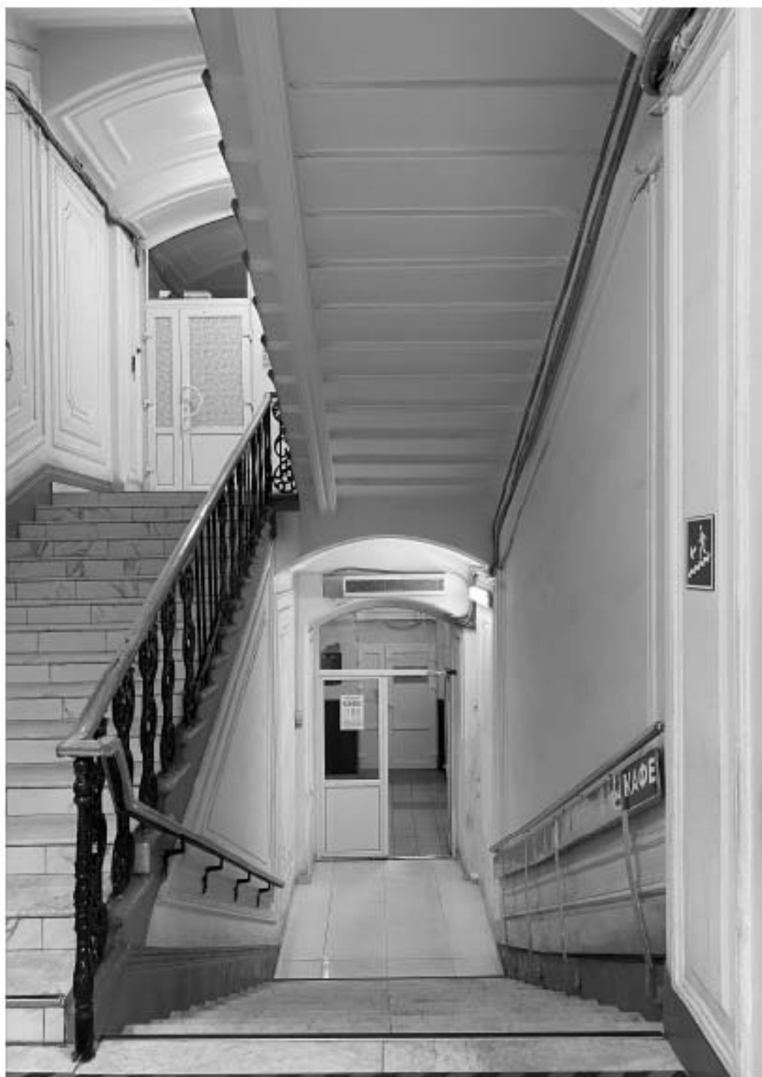
20. Объект культурного наследия «Комплекс зданий Дома призрения А.И. Тименкова и В.А. Фролова». Помещение №3. Вид на север. 18.06.2021 г.
