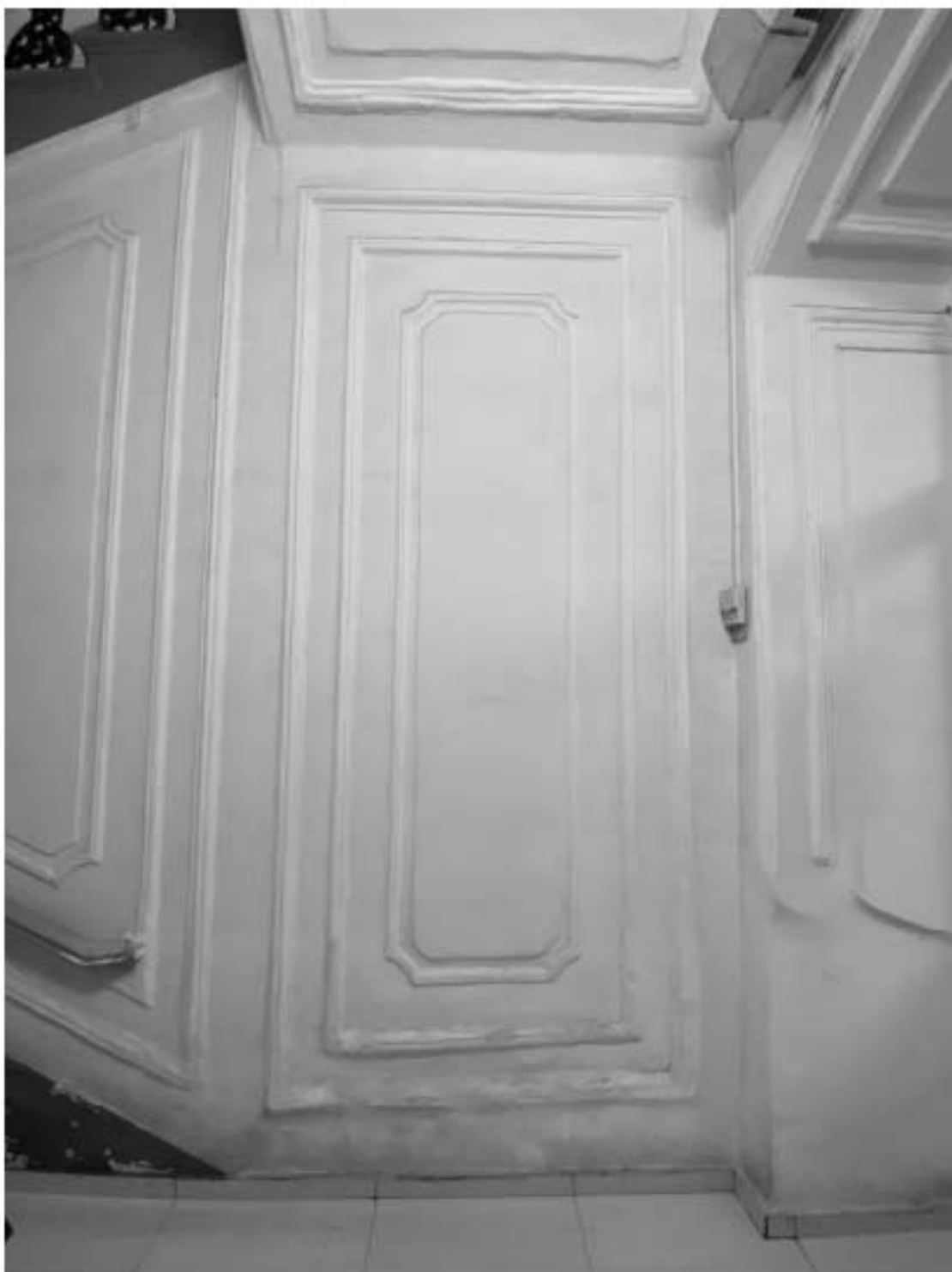
23. Объект культурного наследия «Комплекс зданий Дома призрения А.И. Тименкова и В.А. Фролова». Помещение №3. Вид на запад. 18.06.2021 г.
