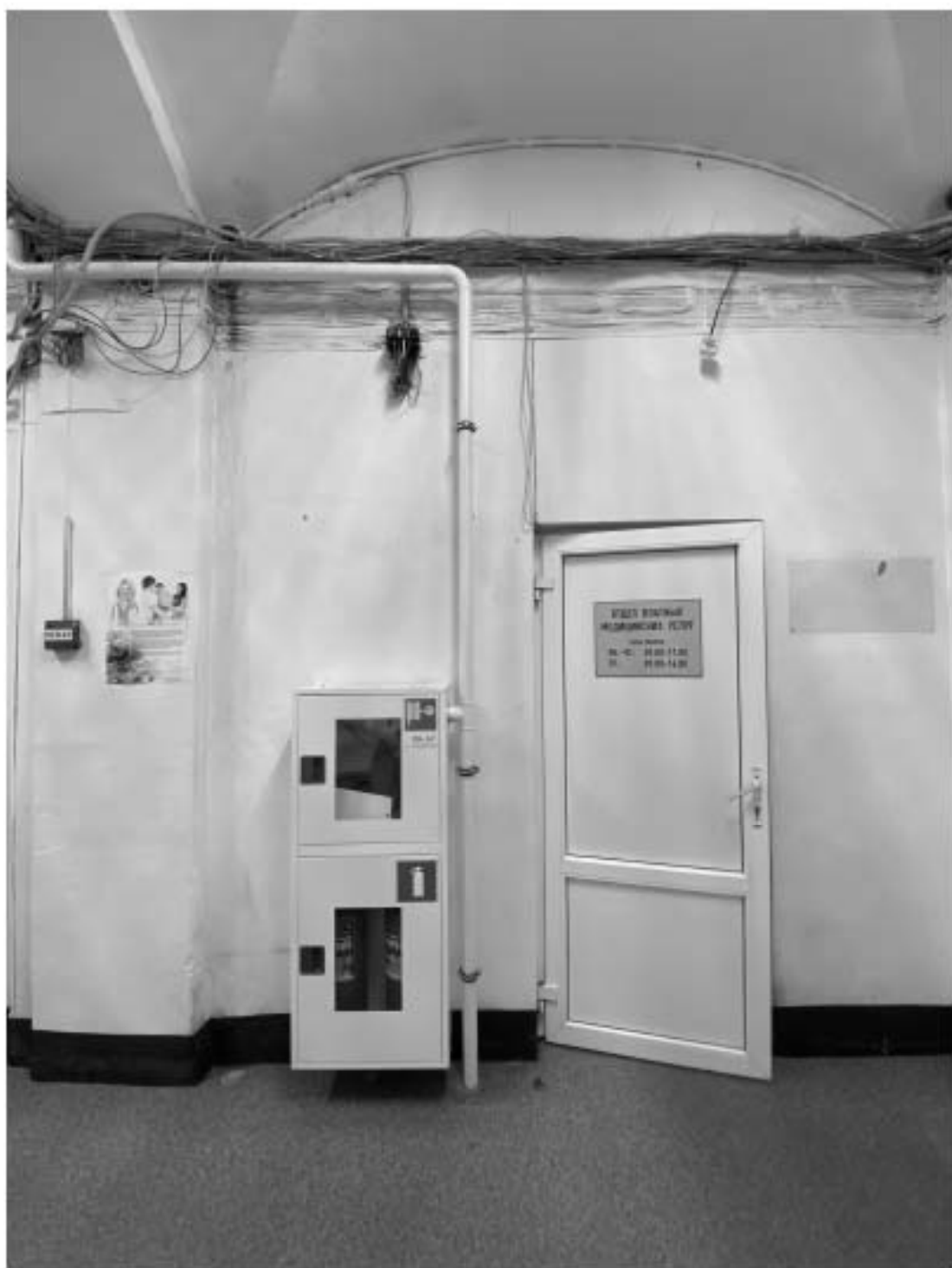
13. Объект культурного наследия «Комплекс зданий Дома призрения А.И. Тименкова и В.А. Фролова». Помещение №3. Вид на север. 18.06.2021 г.
