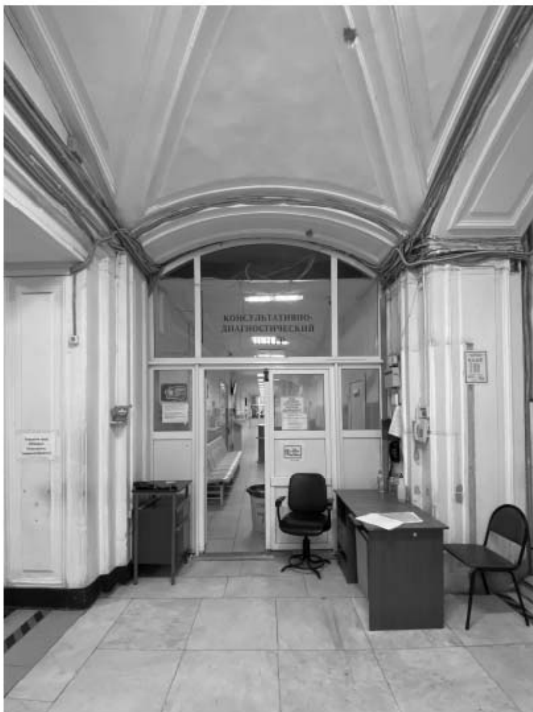
18. Объект культурного наследия «Комплекс зданий Дома призрения А.И. Тименкова и В.А. Фролова». Помещение №3. Вид на запад. 18.06.2021 г.
