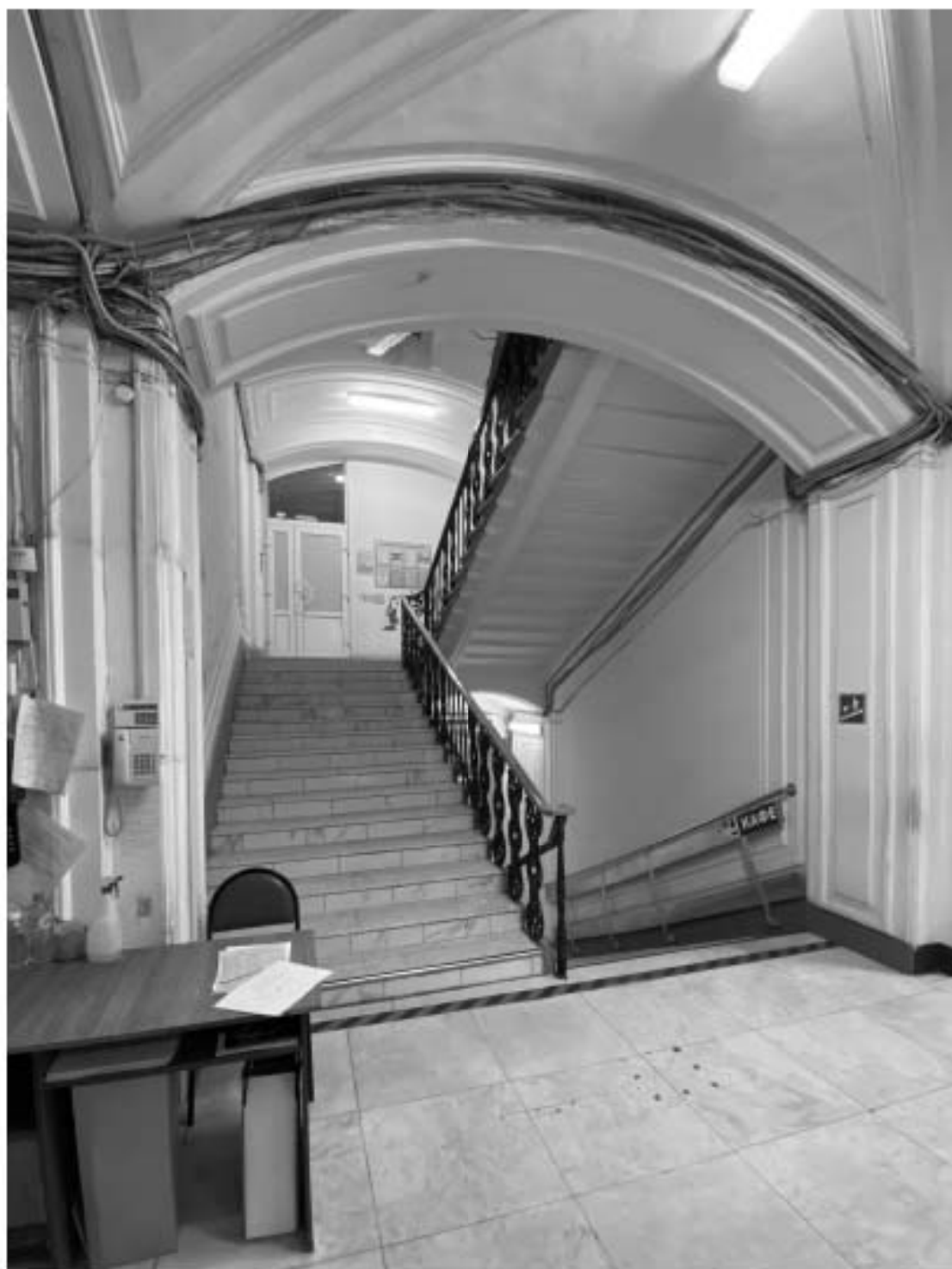
9. Объект культурного наследия «Комплекс зданий Дома призрения А.И. Тименкова и В.А. Фролова». Помещение №3. Вид на северо-восток. 18.06.2021 г.
