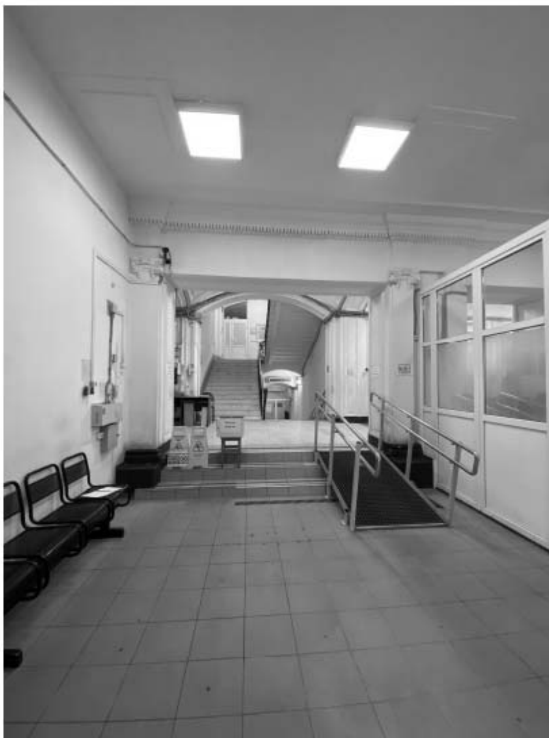
1. Объект культурного наследия «Комплекс зданий Дома призрения А.И. Тименкова и В.А. Фролова». Помещение №1. Вид на север. 18.06.2021 г.
