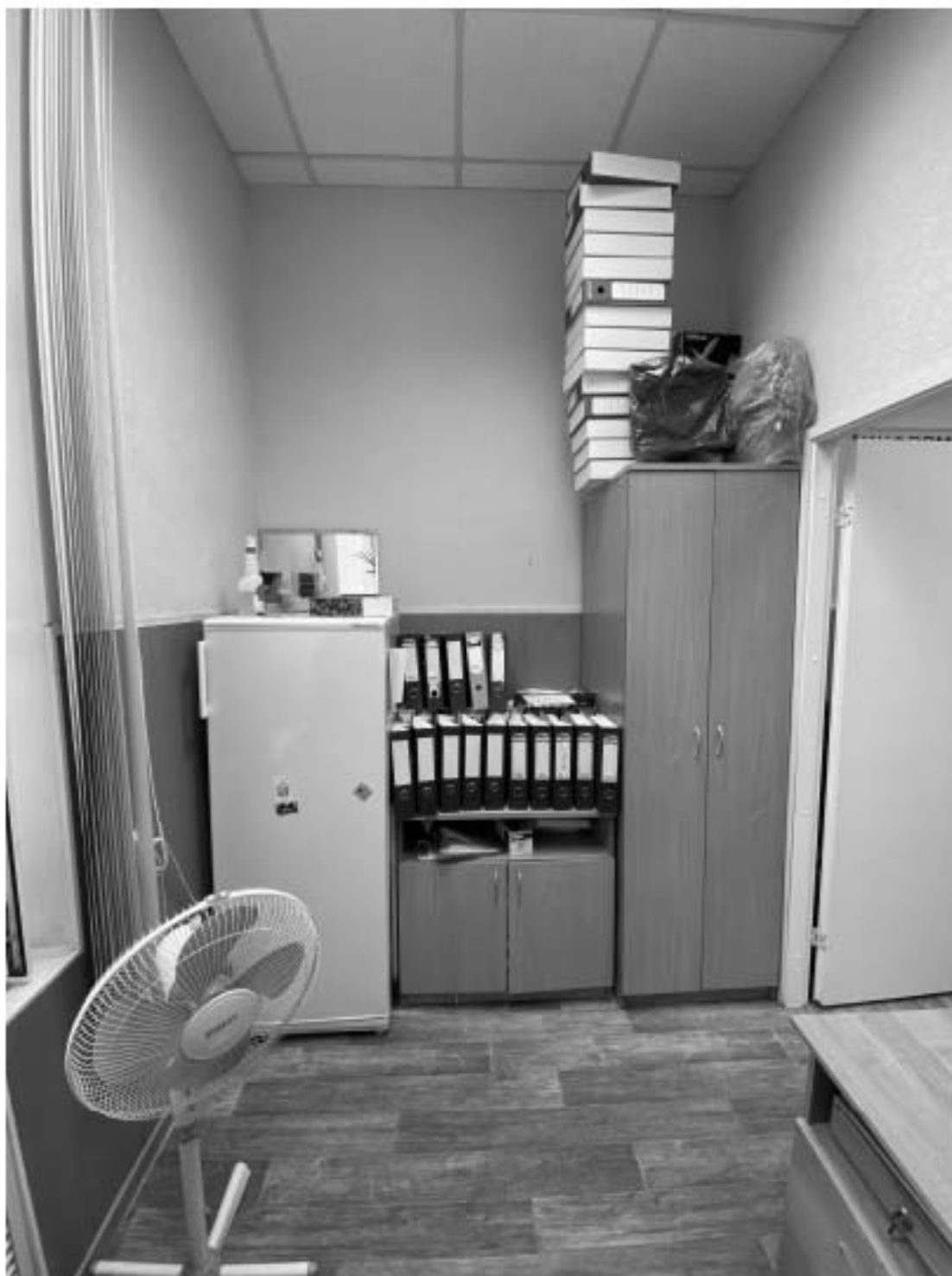
47. Объект культурного наследия «Комплекс зданий Дома призрения А.И. Тименкова и В.А. Фролова». Помещение №8. Вид на восток. 18.06.2021 г.
