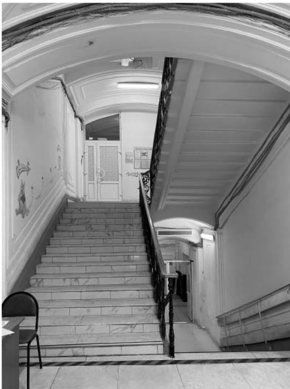
24. Объект культурного наследия «Комплекс зданий Дома призрения А.И. Тименкова и В.А. Фролова». Помещение №3. Вид на север. 18.06.2021 г.
