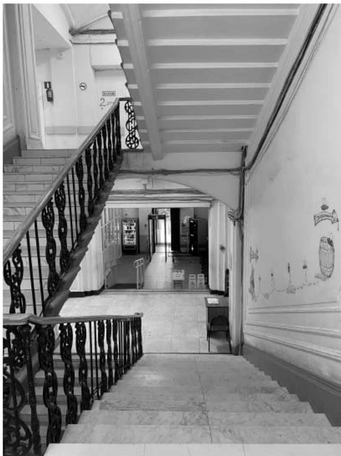
27. Объект культурного наследия «Комплекс зданий Дома призрения А.И. Тименкова и В.А. Фролова». Помещение №3. Вид на юг. 18.06.2021 г.
