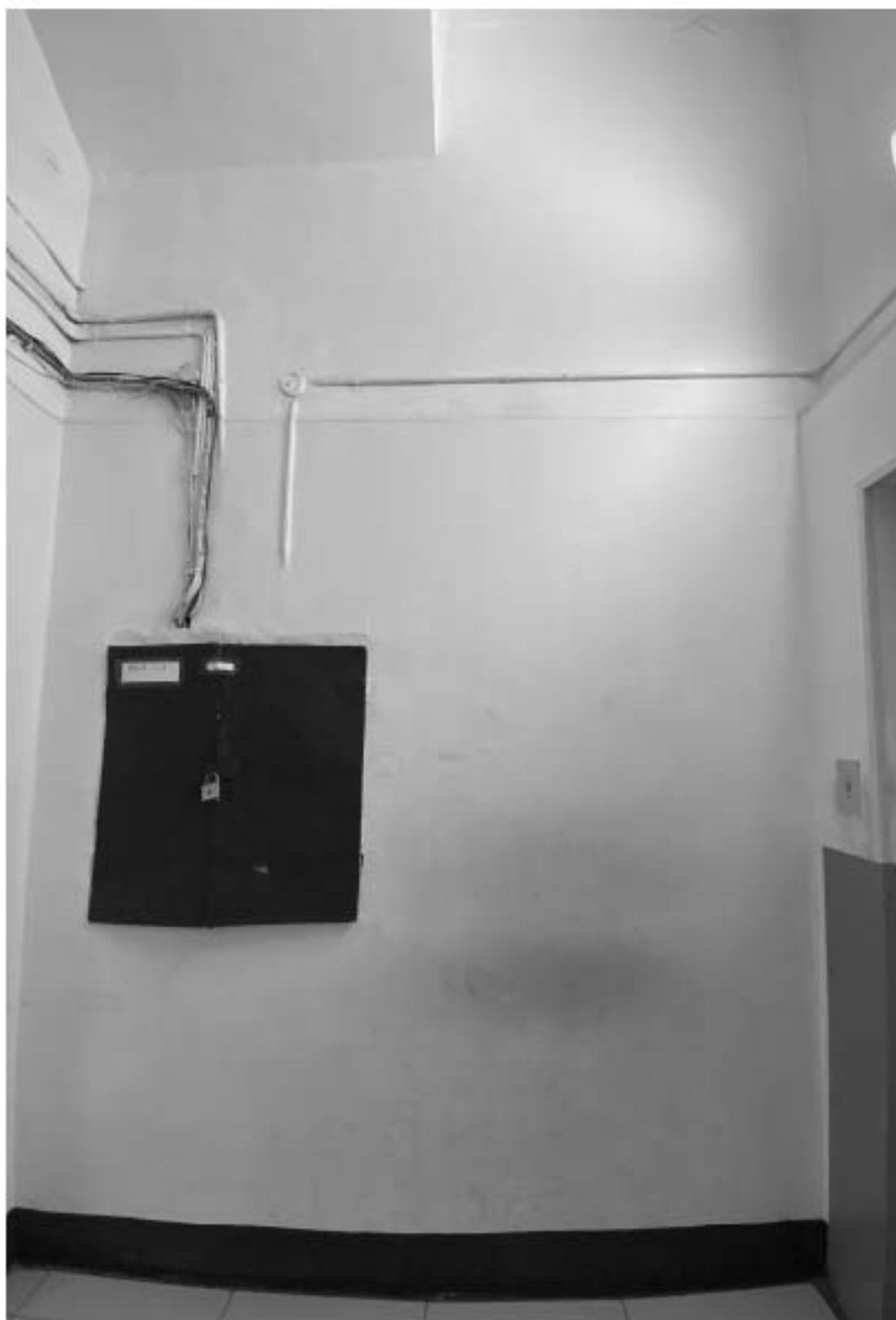
31. Объект культурного наследия «Комплекс зданий Дома призрения А.И. Тименкова и В.А. Фролова». Помещение №4. Вид на запад. 18.06.2021 г.
