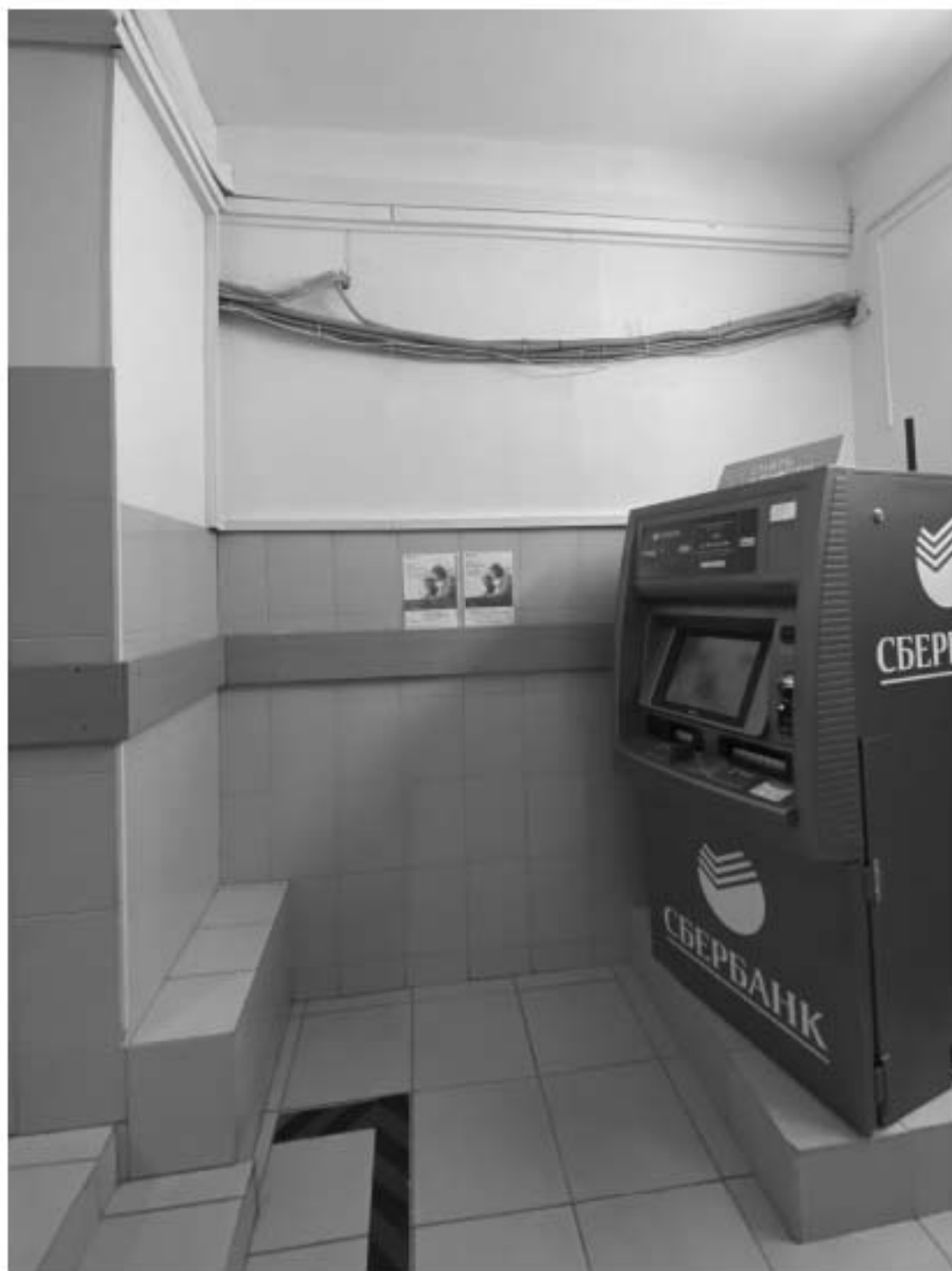
50. Объект культурного наследия «Комплекс зданий Дома призрения А.И. Тименкова и В.А. Фролова». Помещение №10. Вид на восток. 18.06.2021 г.
