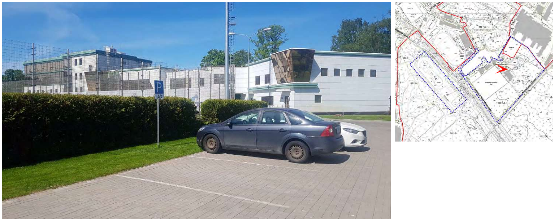
16. Территория проектирования в границах объекта культурного наследия регионального значения: «Удельный парк». Вид в западном направлении. Юго-восточный угол восточного корпуса Спортивной базы, служебная стоянка а/м. Дата фотофиксации: 8 июня 2021 г.
