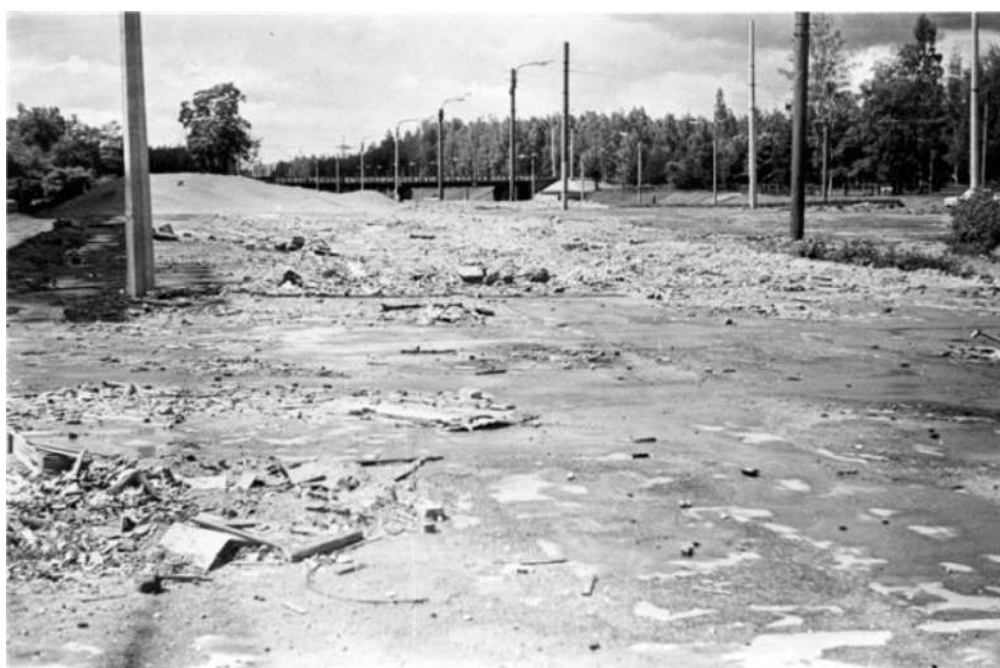
Илл. 58 Строительство Светановской площади. 1973 г.
