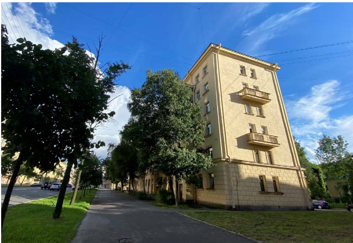
Фото 1. Общий вид с северо-запада
