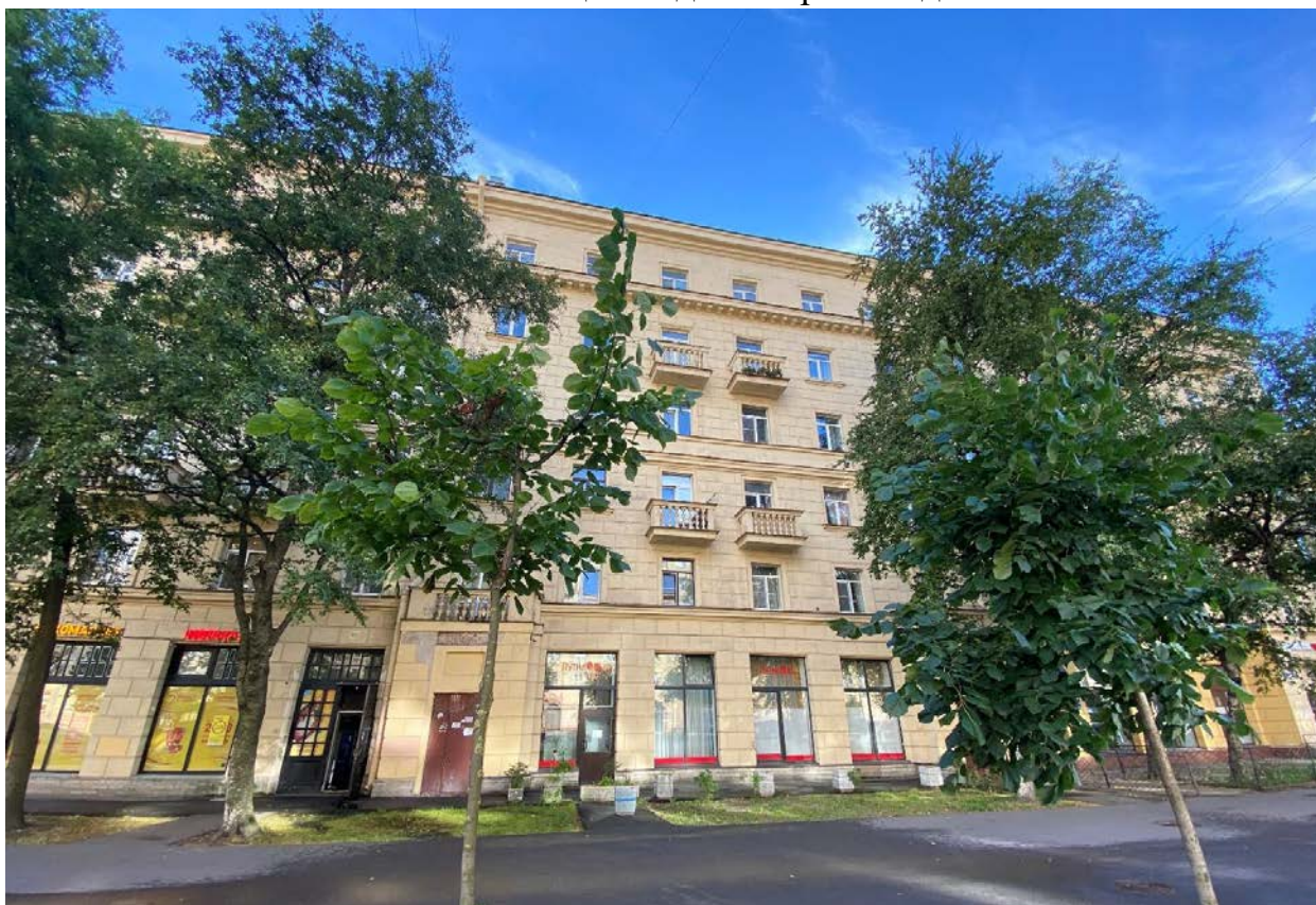
Фото 2. Северо-восточный лицевой фасад. Вид с северо-востока
