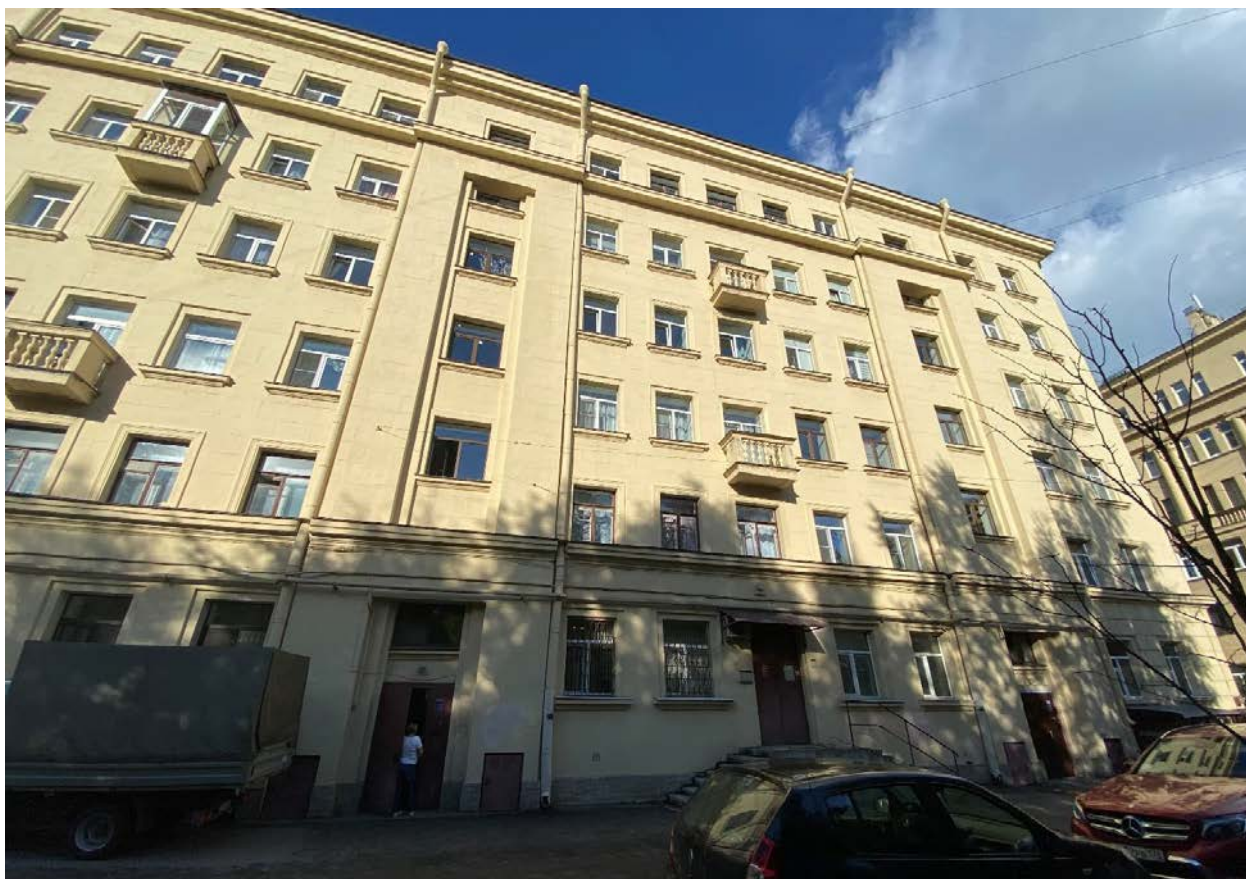
Фото 5. Восточная часть юго-западного дворового фасада. Вид с запада
