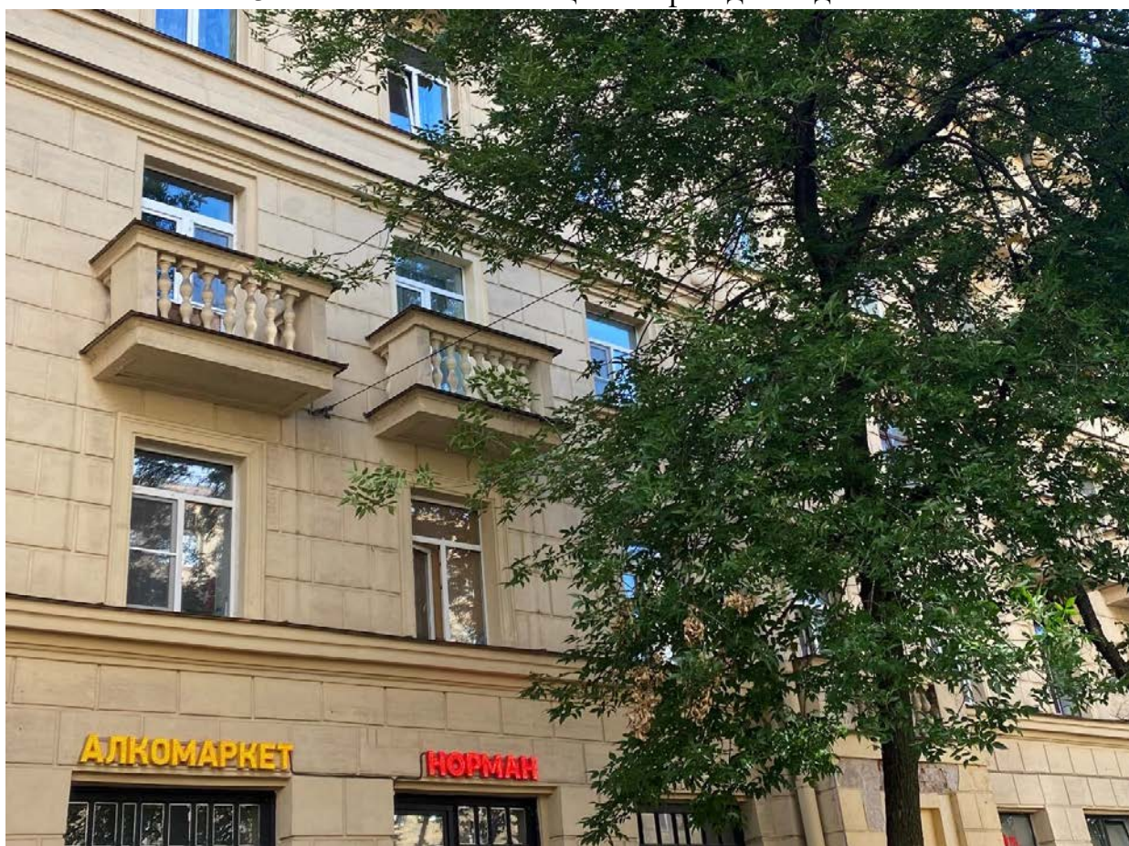
Фото 4. Восточная часть лицевого фасада. В уровне 3-го этажа расположены балконный и оконный проем кв. № 23. Вид с востока
