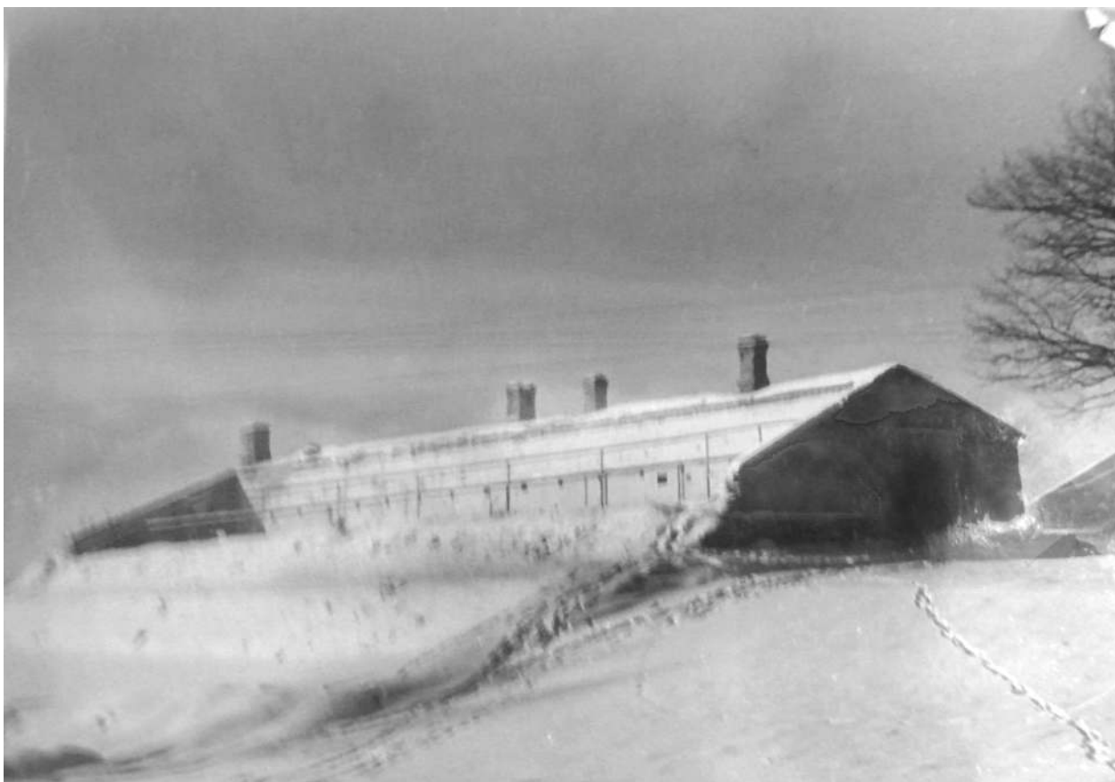
Илл. 40. Разрушенный юго-восточный фасад оранжереи «е». 1956 г.- Фото из ист. Спр. Н.И. Громовой (илл.52).
