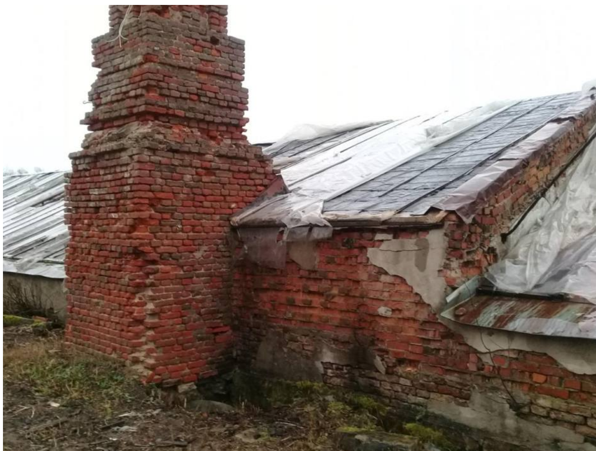
Фото № 61. Оранжерея № 3. Фрагмент центральной части северного фасада. Примыкание кирпичной трубы к стене здания.
