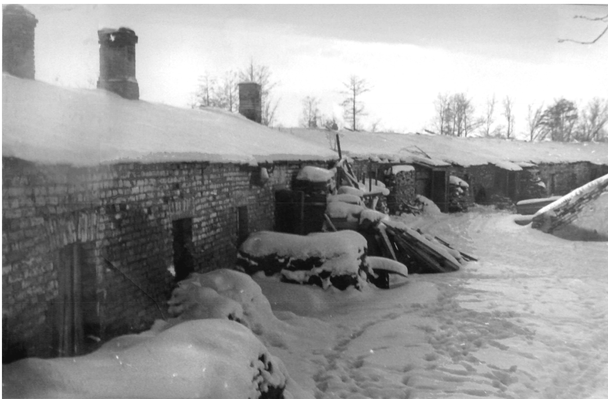
Илл. 41. Северо-западный фасад оранжереи «е». 1956 г. – Фото из ист. спр. Н.И. Громовой (илл.51)
