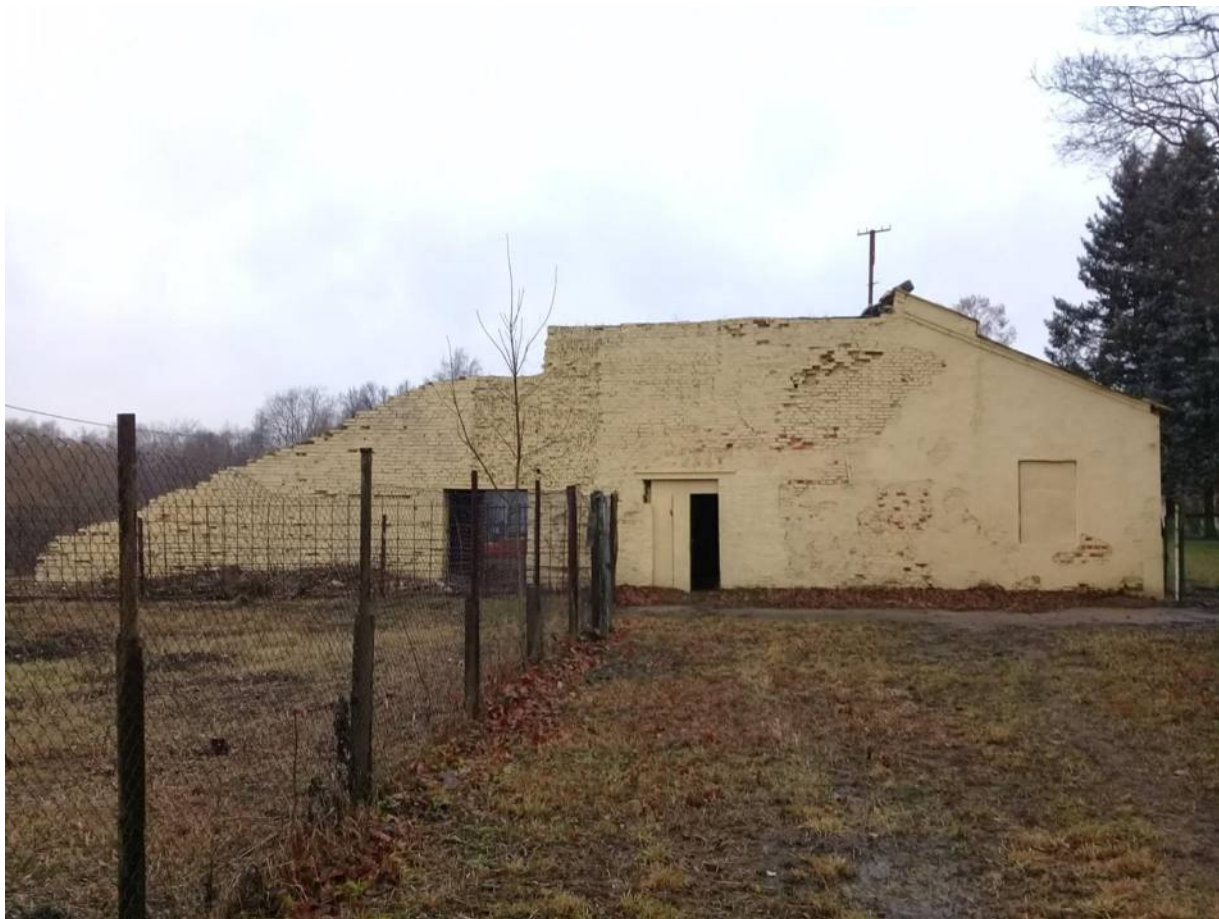
Фото № 70. Оранжерея № 5. Восточный фасад.
