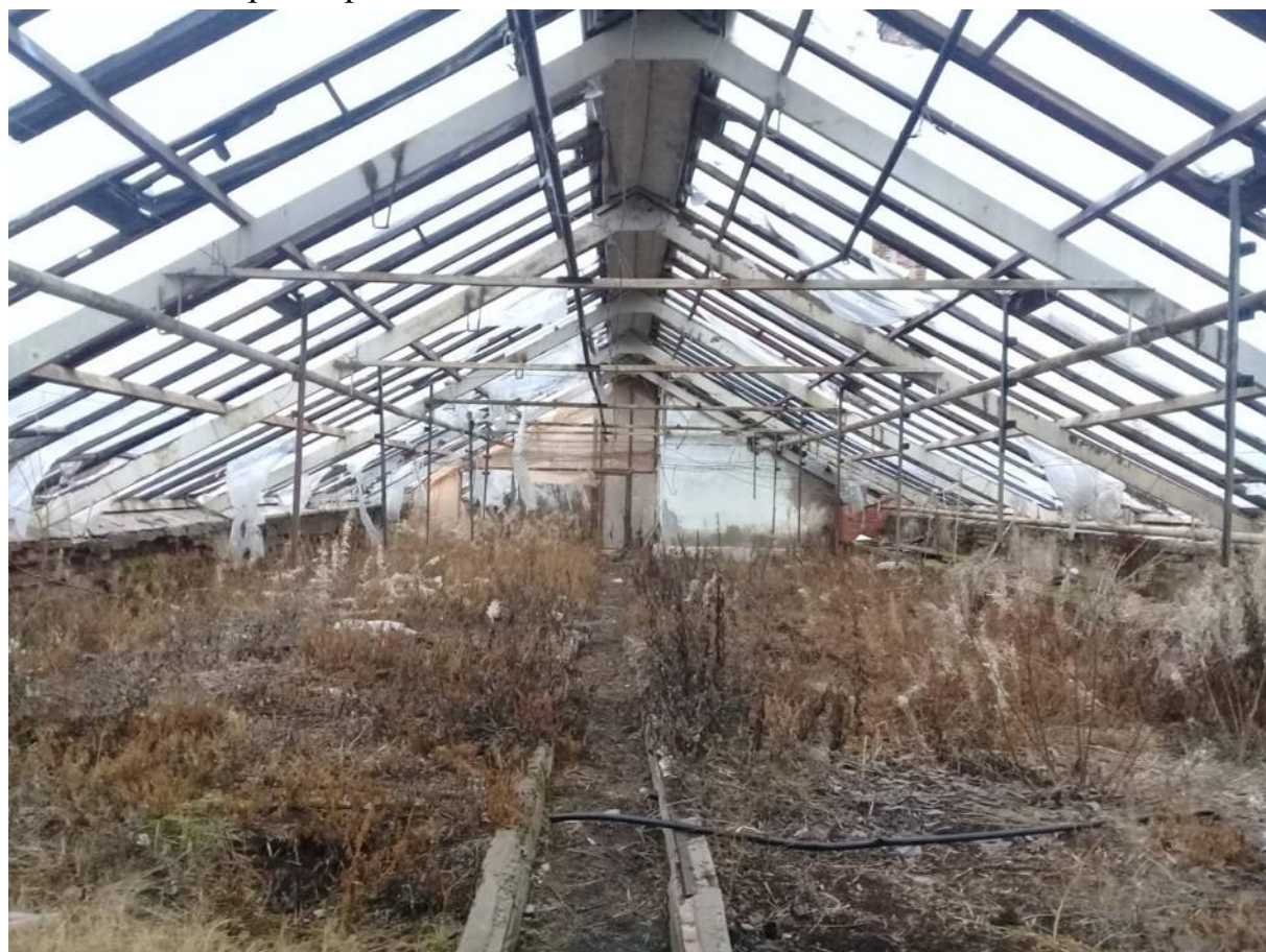
Фото № 66-67. Оранжерея № 3. Общий вид помещения восточной части здания.
