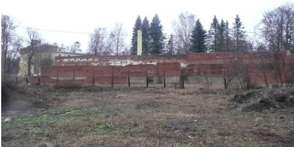
Фото № 74. Оранжерея № 5. Вид с юга. На переднем плане недостроенный поздний объем, возведенный на фундаментах утраченной Оранжереи № 4.
