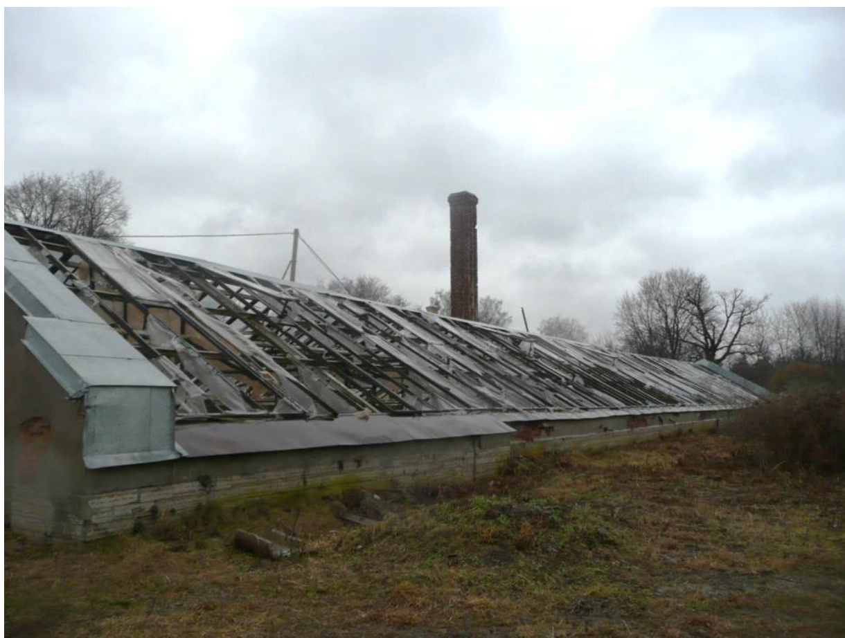
Фото № 57. Оранжерея № 3. Общий вид южного фасада.
