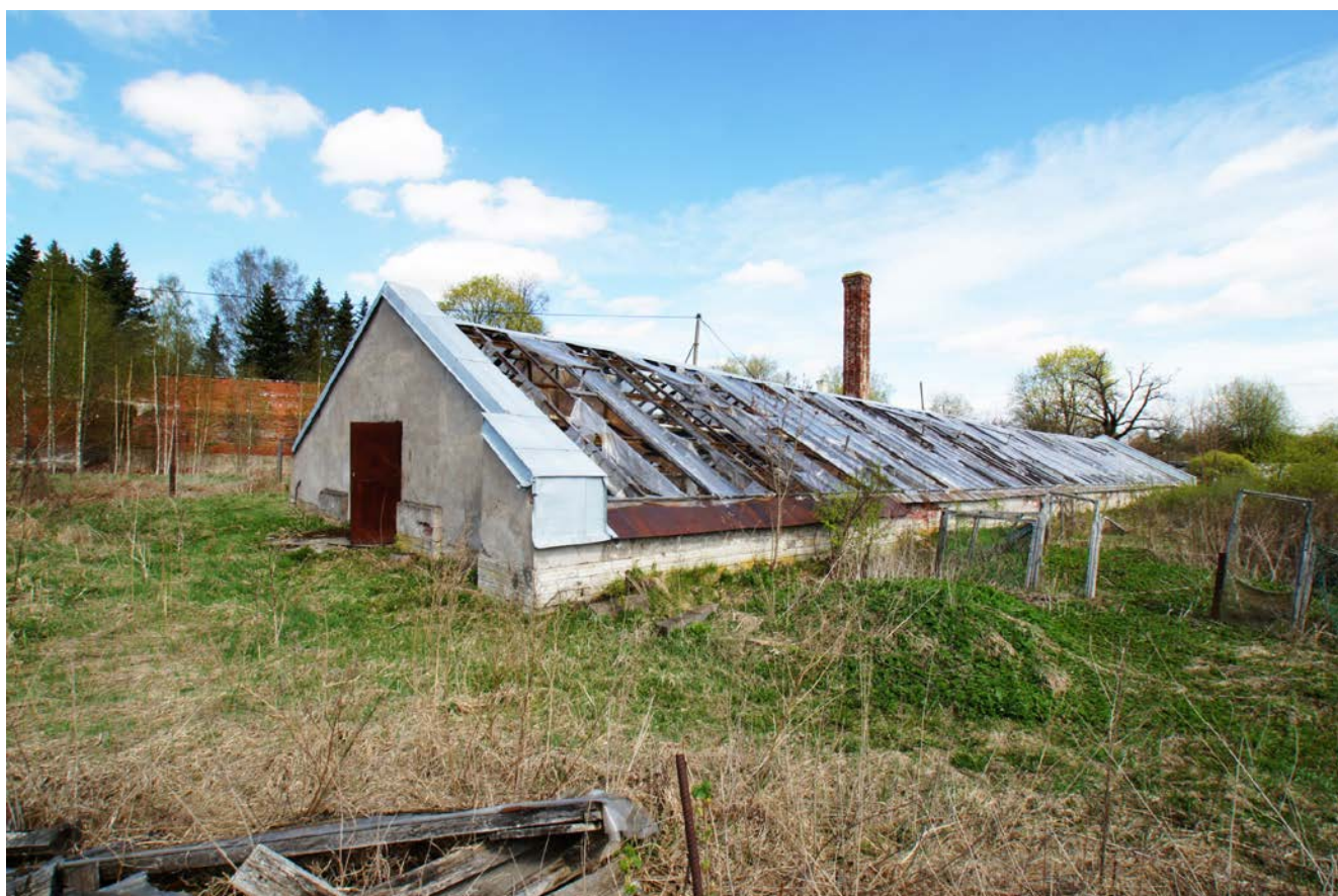
Илл. 76. Оранжерея № 3. Вид с юго-запада. Фото 2017 г. из архива материалов заказчика.
