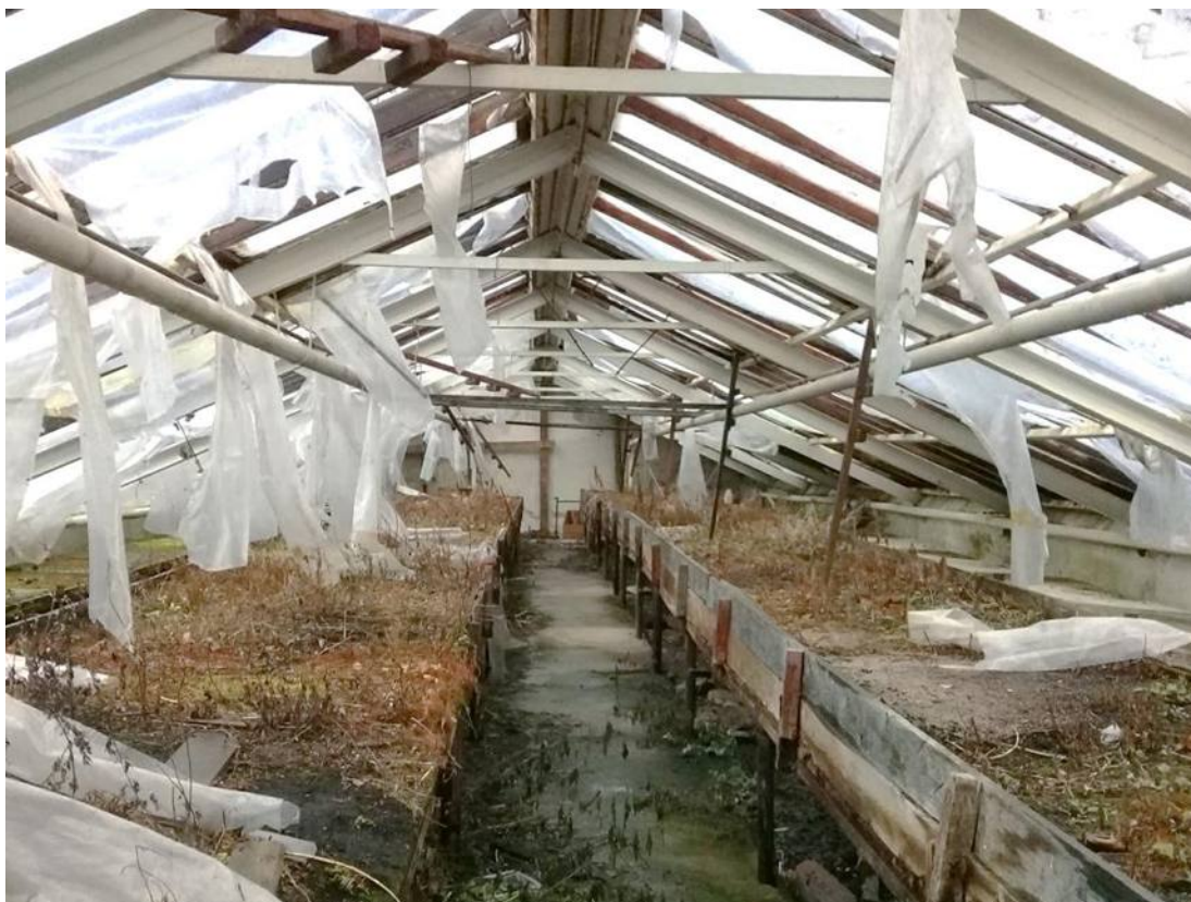
Фото № 50. Оранжерея № 2. Общий вид помещения восточной части здания.
