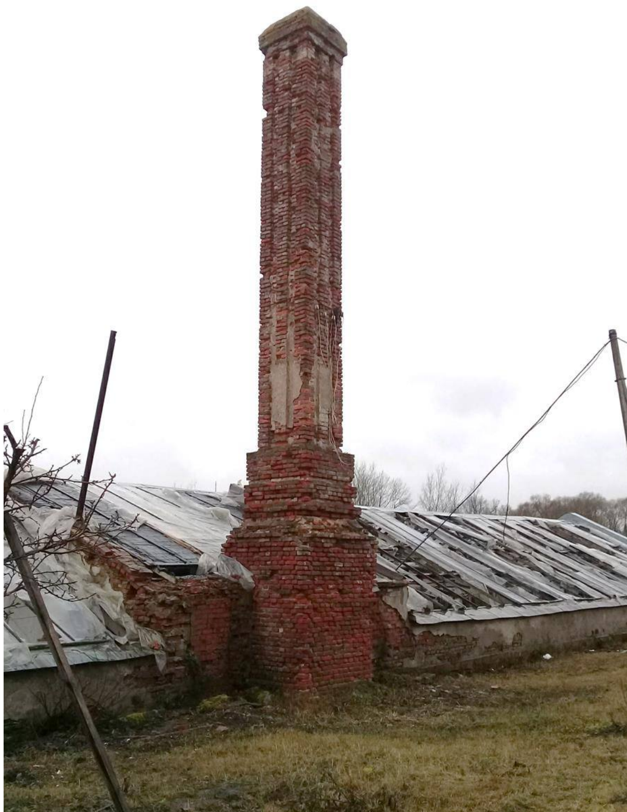
Фото № 62. Оранжерея № 3. Общий вид кирпичной трубы со стороны северного фасада здания.
