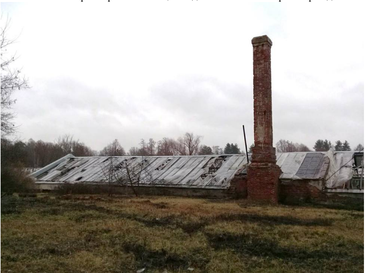
Фото № 59. Оранжерея № 3. Северный фасад, восточная часть здания.
