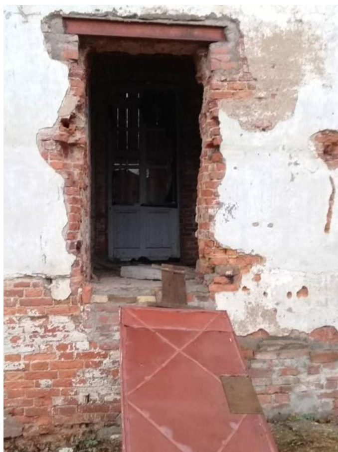
Фото № 41. Оранжерея № 1. Фрагмент южного фасада основного объема здания.
