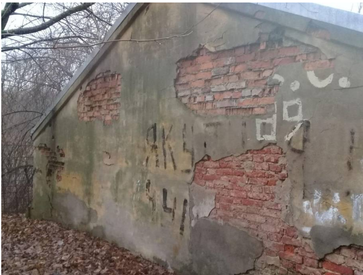
Фото № 48. Оранжерея № 2. Северо-восточный фасад здания. Общий вид.
