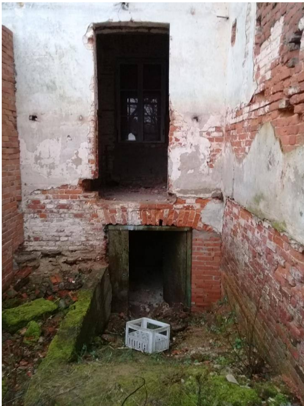
Фото № 37. Оранжерея № 1. Фрагмент южного фасада с входом в подвальное помещение.
