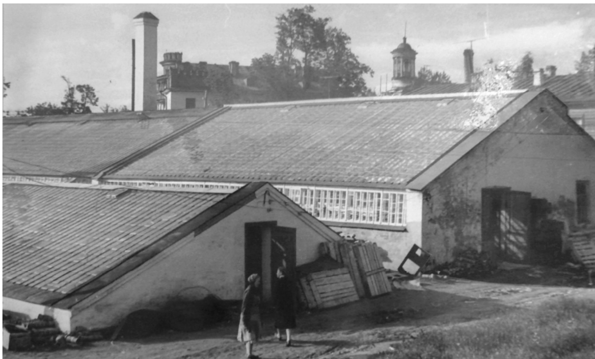
Илл. 61. «Восстановленные оранжереи «б» и «в»». Вид на восточные торцевые фасады с юго-востока. 1956 г. – Фото из исторической справки Н.И. Громовой (илл. 48).
