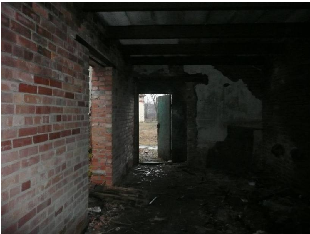
Фото № 76. Оранжерея № 5. Общий вид помещения.
