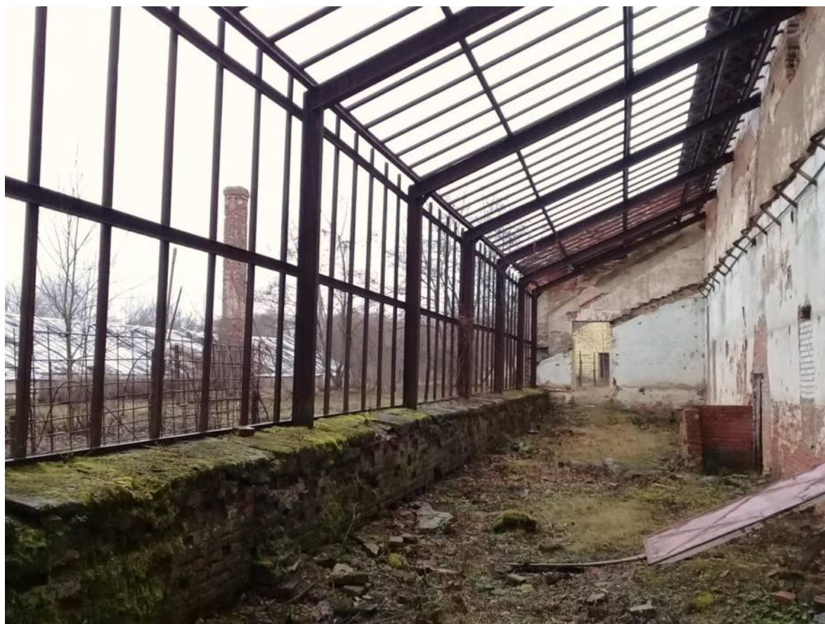
Фото № 38-39. Оранжерея № 1. Помещение теплицы в южной части здания. Общий вид.
