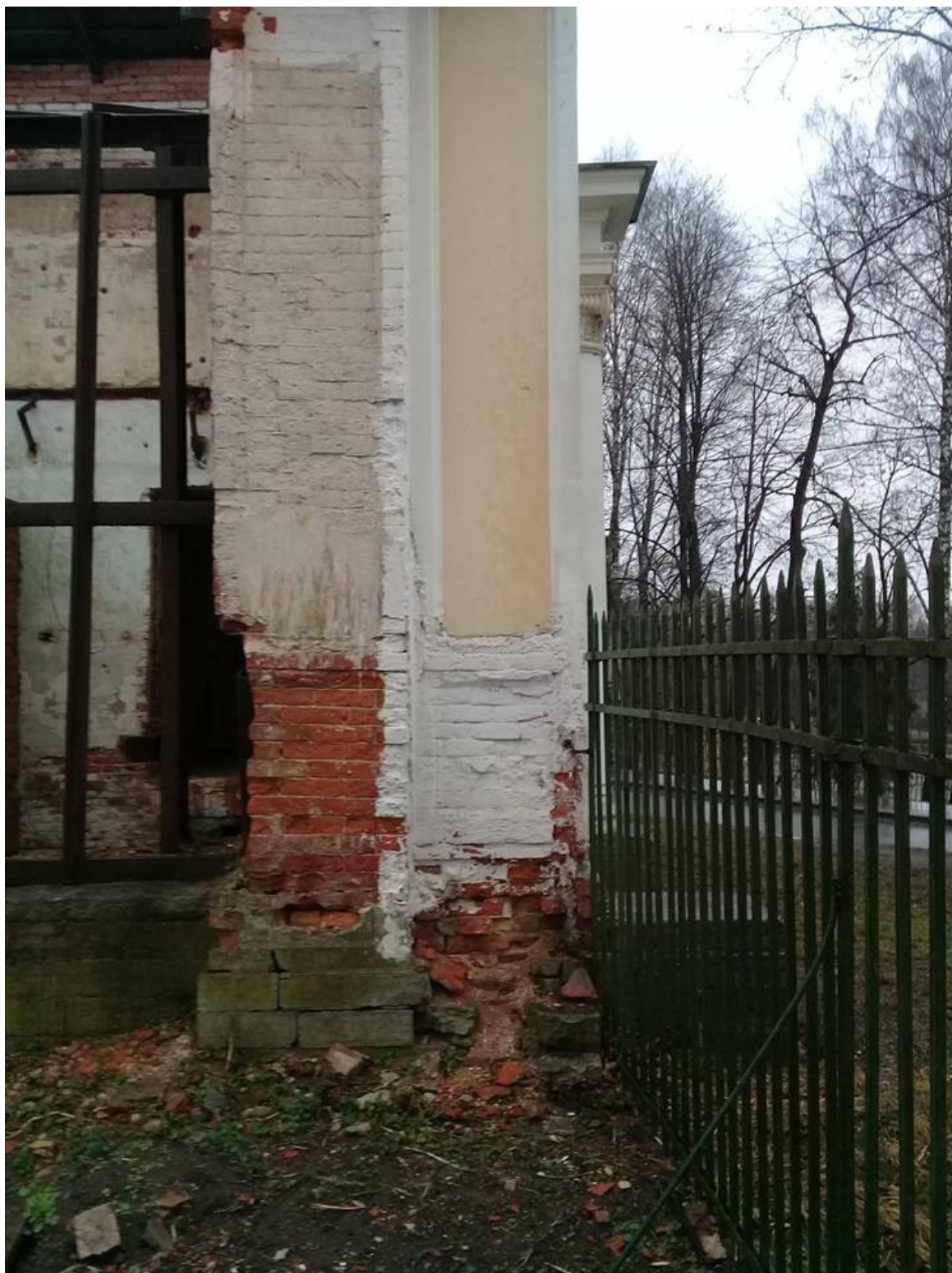
Фото № 36. Оранжерея № 1. Нижняя часть восточной стены здания. Вид со стороны южного фасада.
