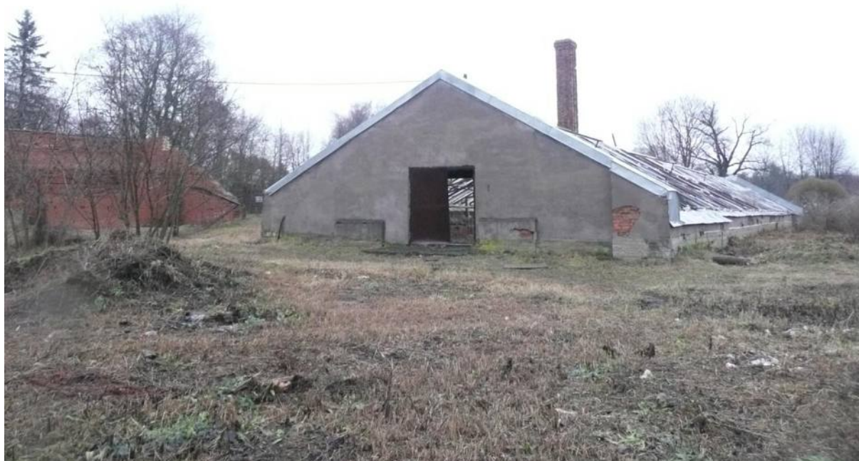
Фото № 56. Оранжерея № 3. Общий вид западного фасада.
