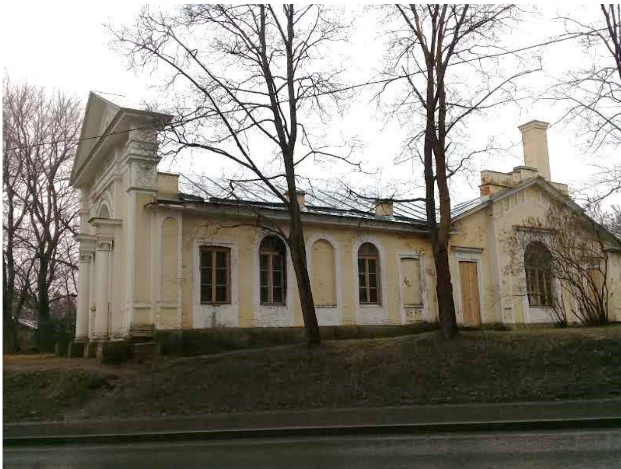
Фото № 21. Оранжерея № 1. Вид здания с северо-востока.
