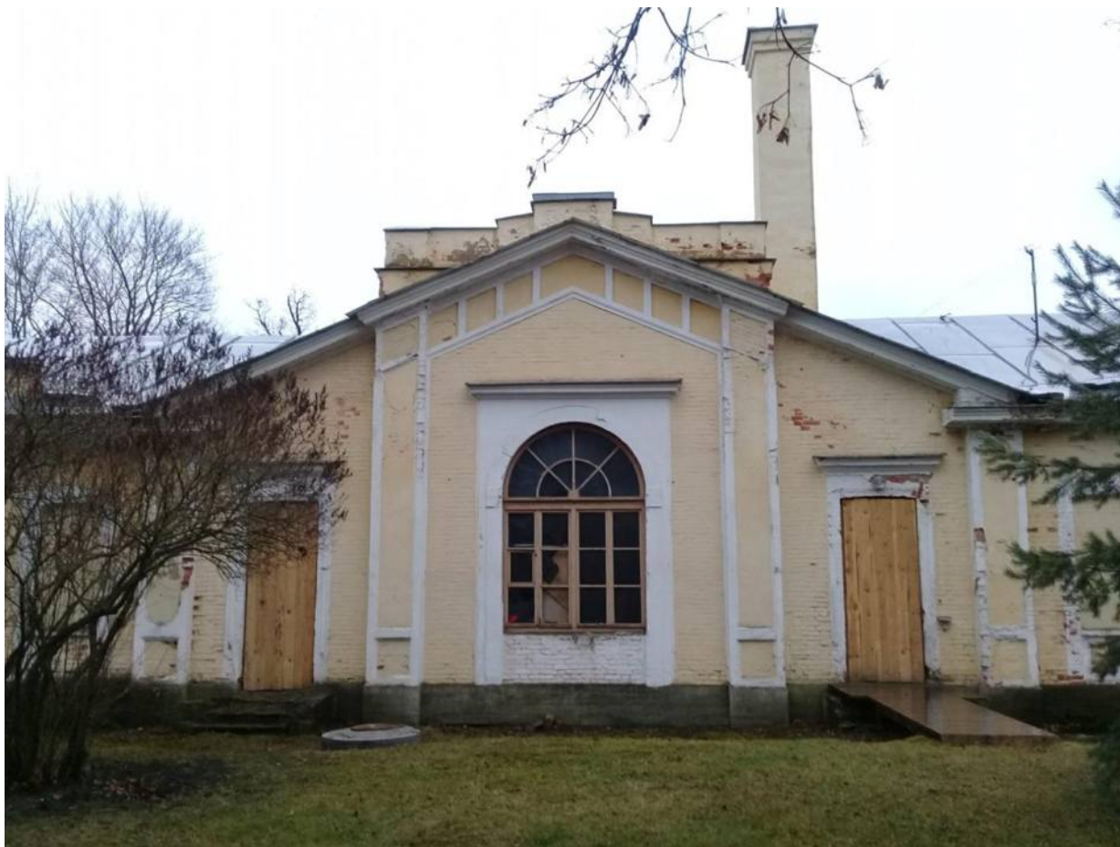
Фото № 27. Оранжерея № 1. Центральная часть северного фасада.
