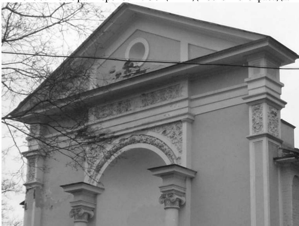
Фото № 24. Оранжерея № 1. Фронтон восточного фасада.
