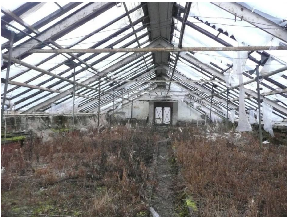
Фото № 66. Оранжерея № 3. Общий вид помещения восточной части здания.
