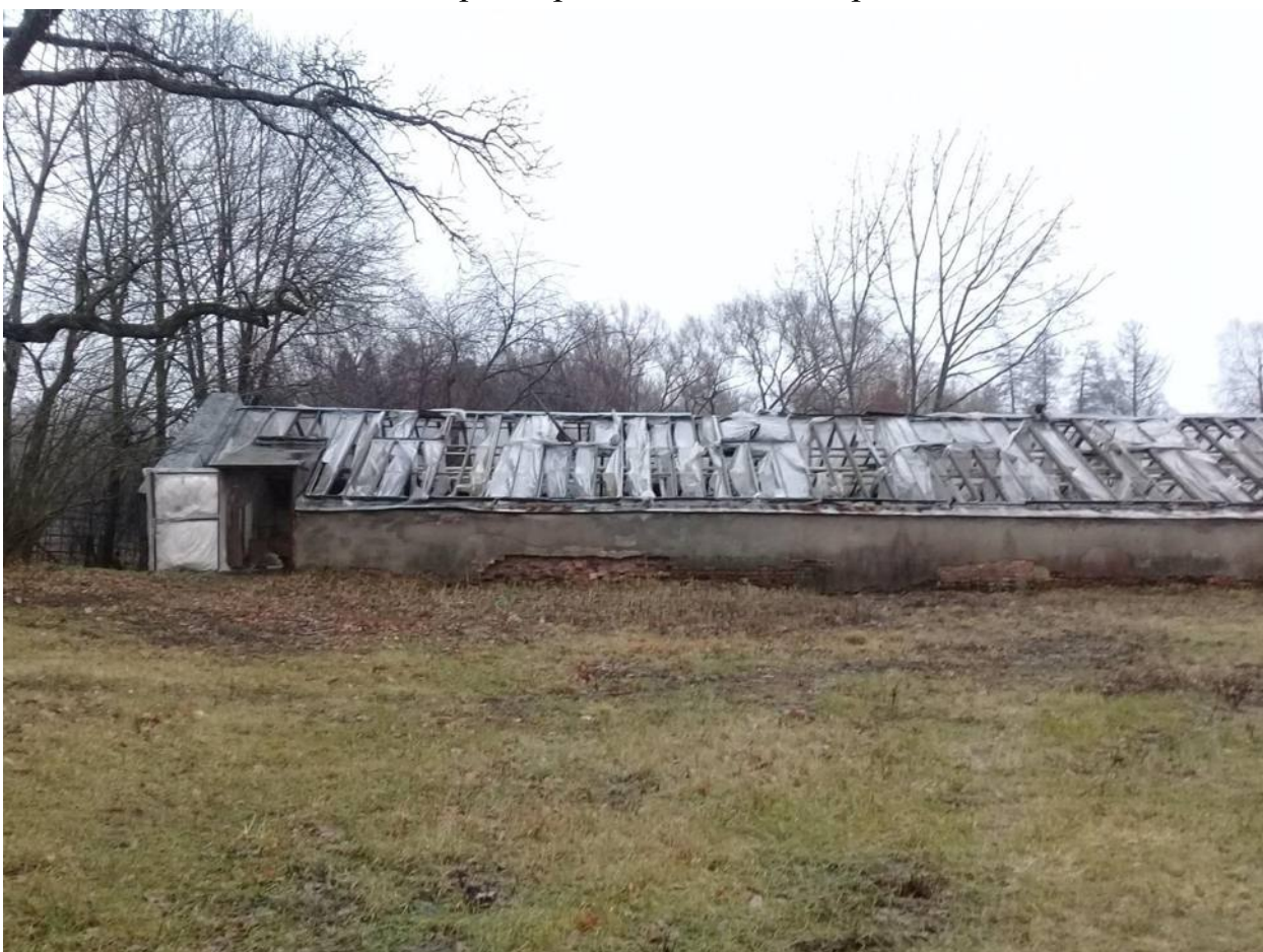
Фото № 43. Оранжерея № 2. Восточная часть здания. Северо-западный фасад.
