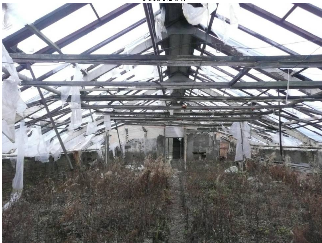
Фото № 64-65. Оранжерея № 3. Общий вид помещения западной части здания.
