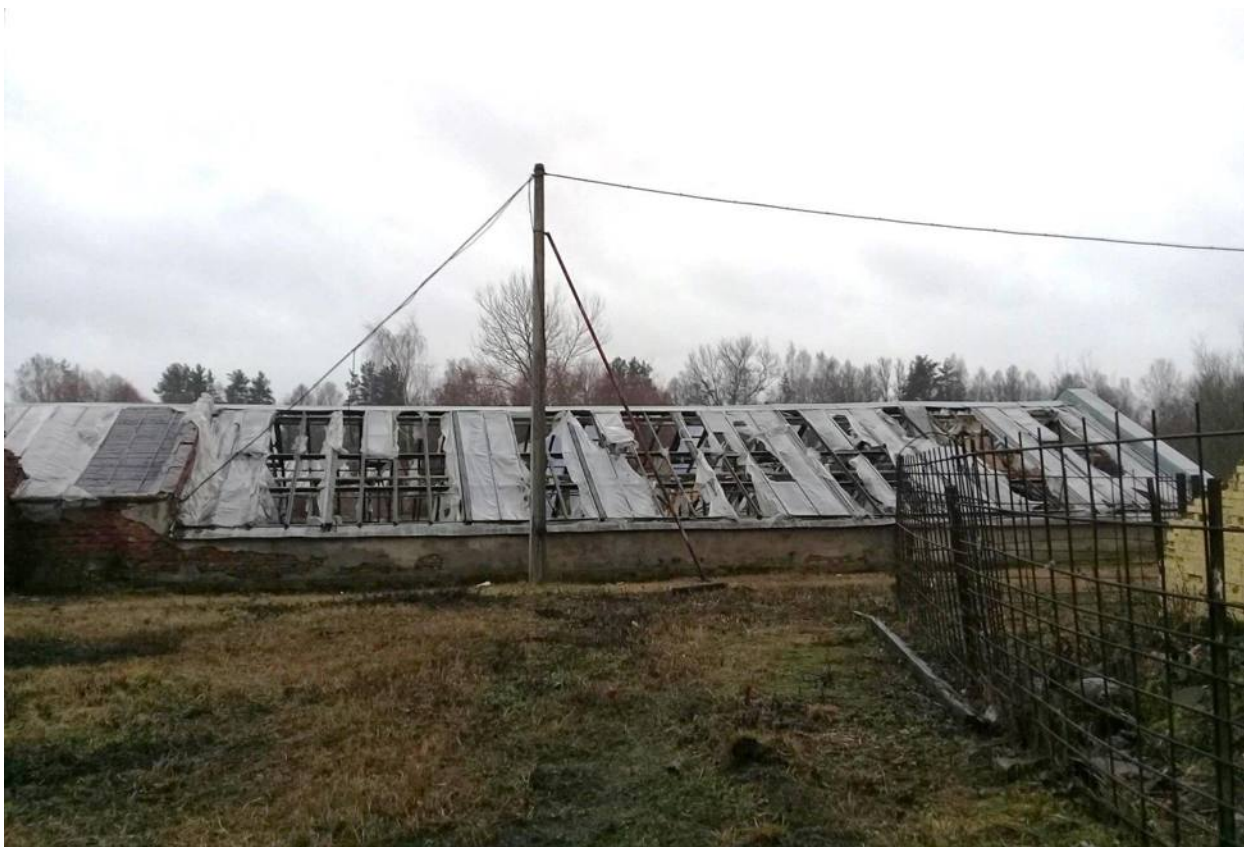
Фото № 60. Оранжерея № 3. Северный фасад, западная часть здания.
