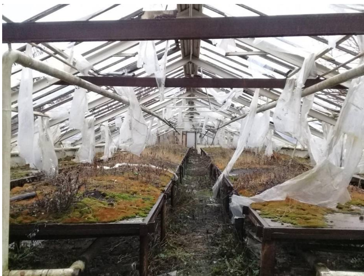
Фото № 52-53. Оранжерея № 2. Общий вид помещения центральной части здания.
