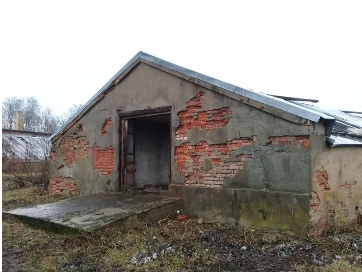
Фото № 46. Оранжерея № 2. Западный фасад здания. Общий вид.
