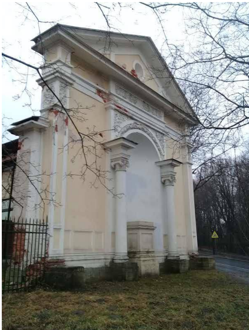
Фото № 23. Оранжерея № 1. Общий вид восточного фасада.
