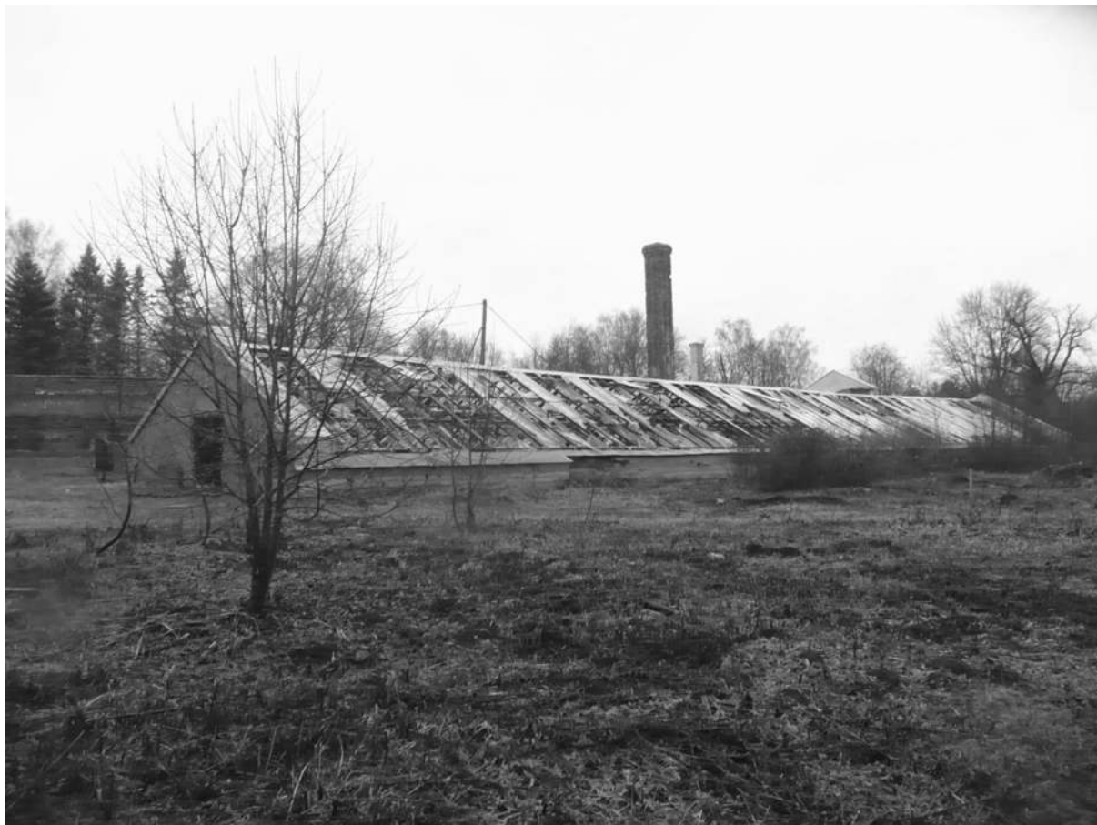
Фото № 12. Общий вид Оранжереи № 3 с юго-запада.
