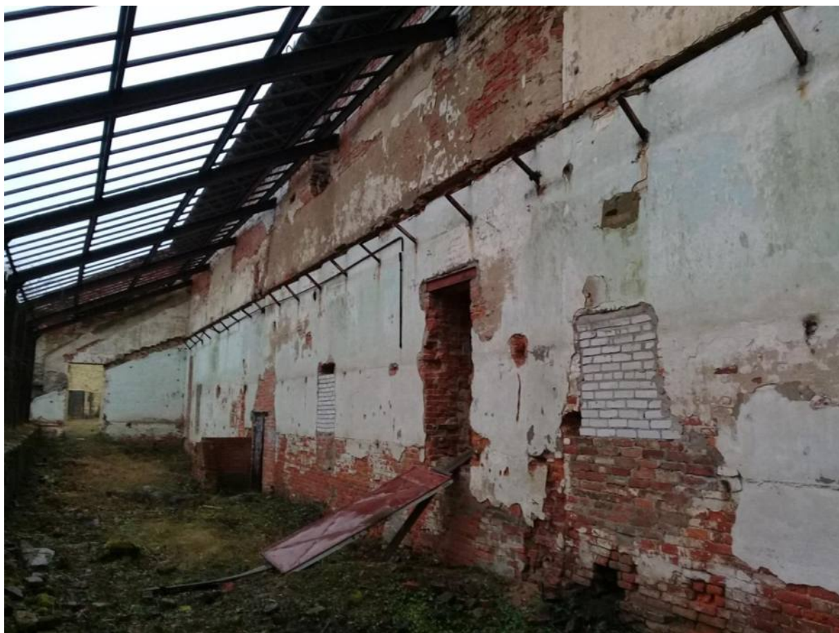
Фото № 40. Оранжерея № 1. Фрагмент южного фасада основного объема здания.
