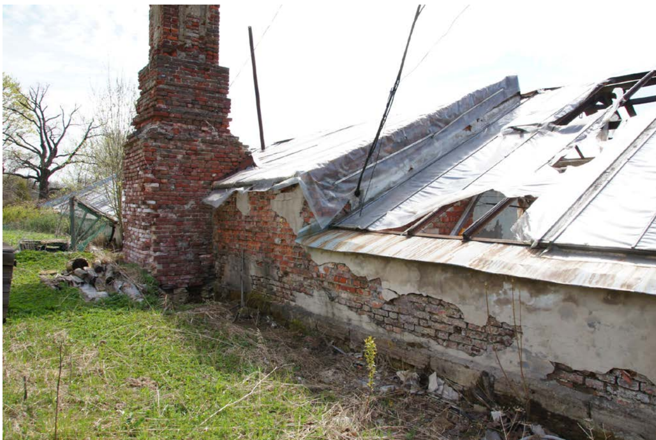
Илл. 77. Оранжерея № 3. Фрагмент северного фасада. Фото 2017 г. из архива материалов заказчика.
