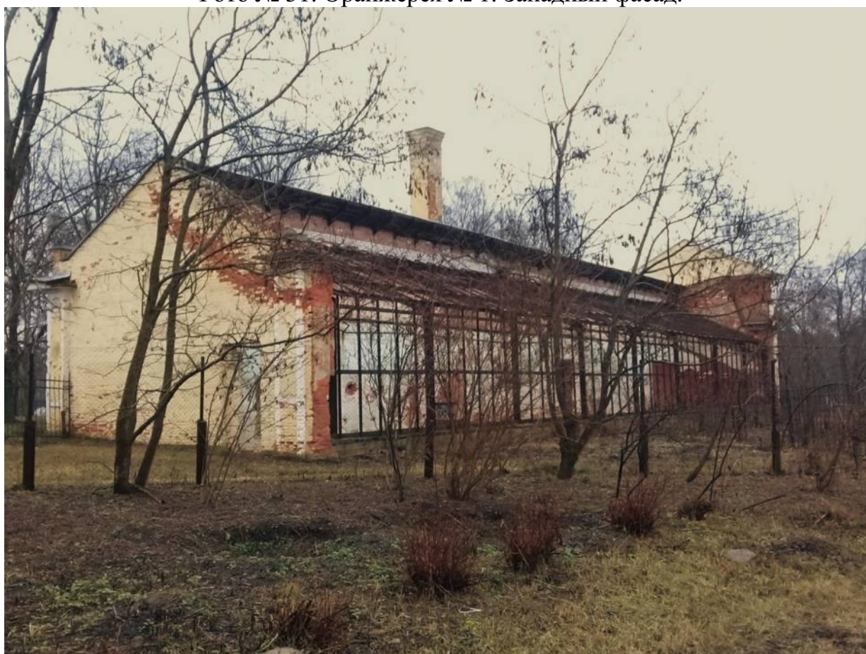
Фото № 32. Оранжерея № 1. Вид с юго-запада.
