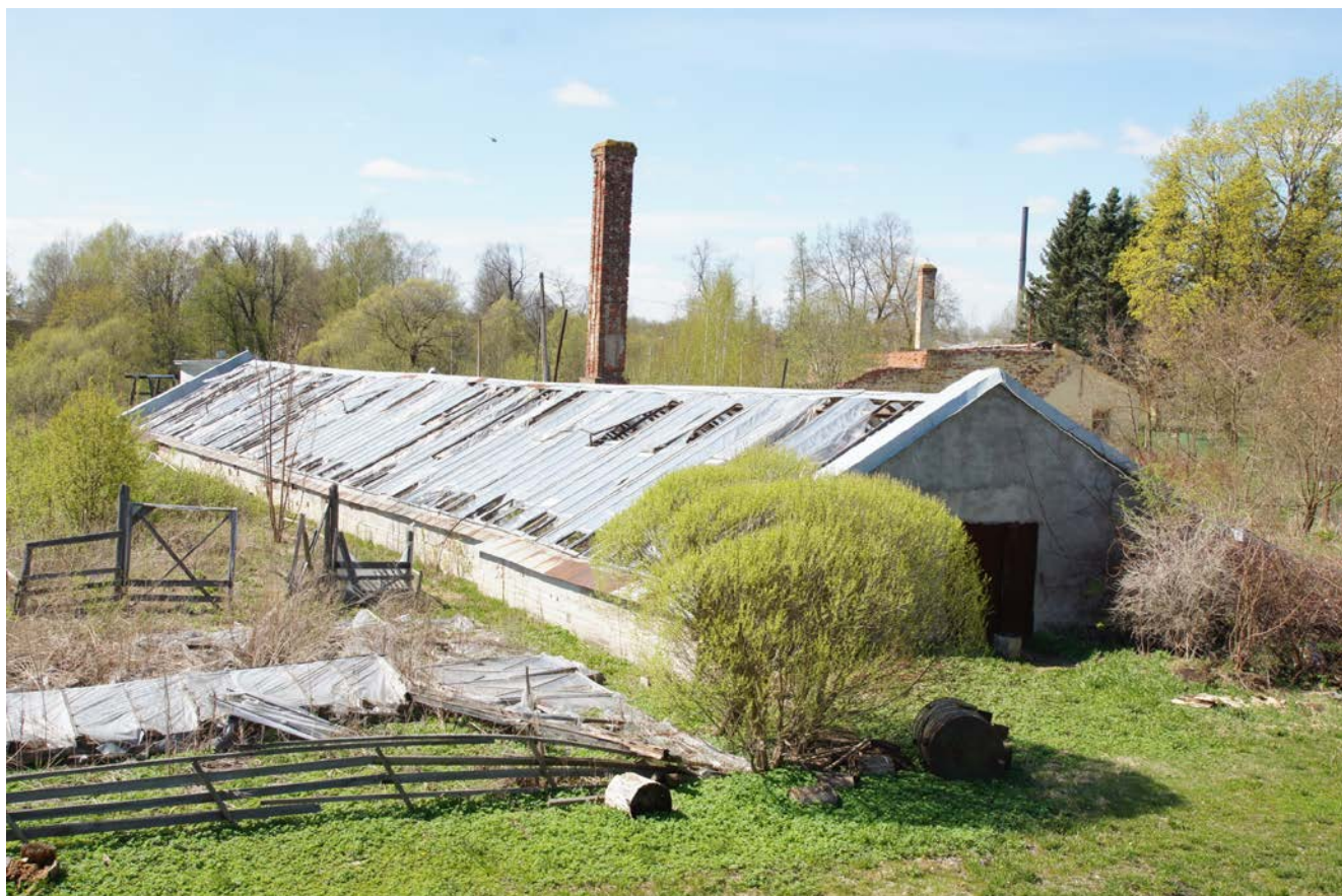
Илл. 75. Оранжерея № 3. Вид с юго-востока. Фото 2017 г. из архива материалов заказчика.
