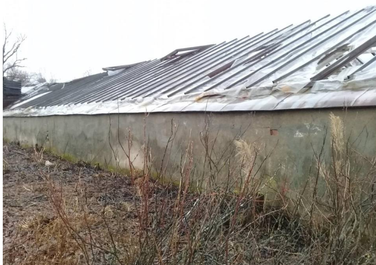
Фото № 45. Оранжерея № 2. Западная часть здания. Северный фасад.
