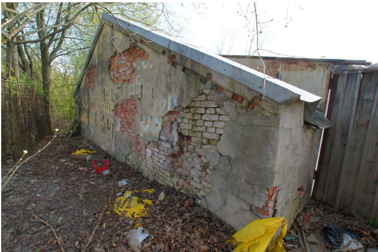
Илл. 71. Оранжерея № 2. Северо-восточный фасад. Фото 2017 г. из материалов заказчика.
