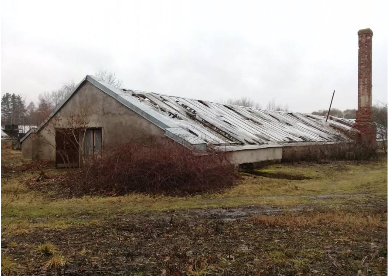
Фото № 58. Оранжерея № 3. Общий вид восточного и северного фасадов.
