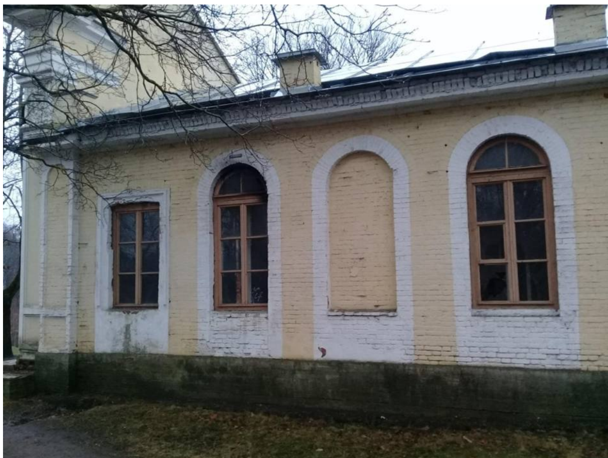
Фото № 29. Оранжерея № 1. Левый фланг северного фасада.
