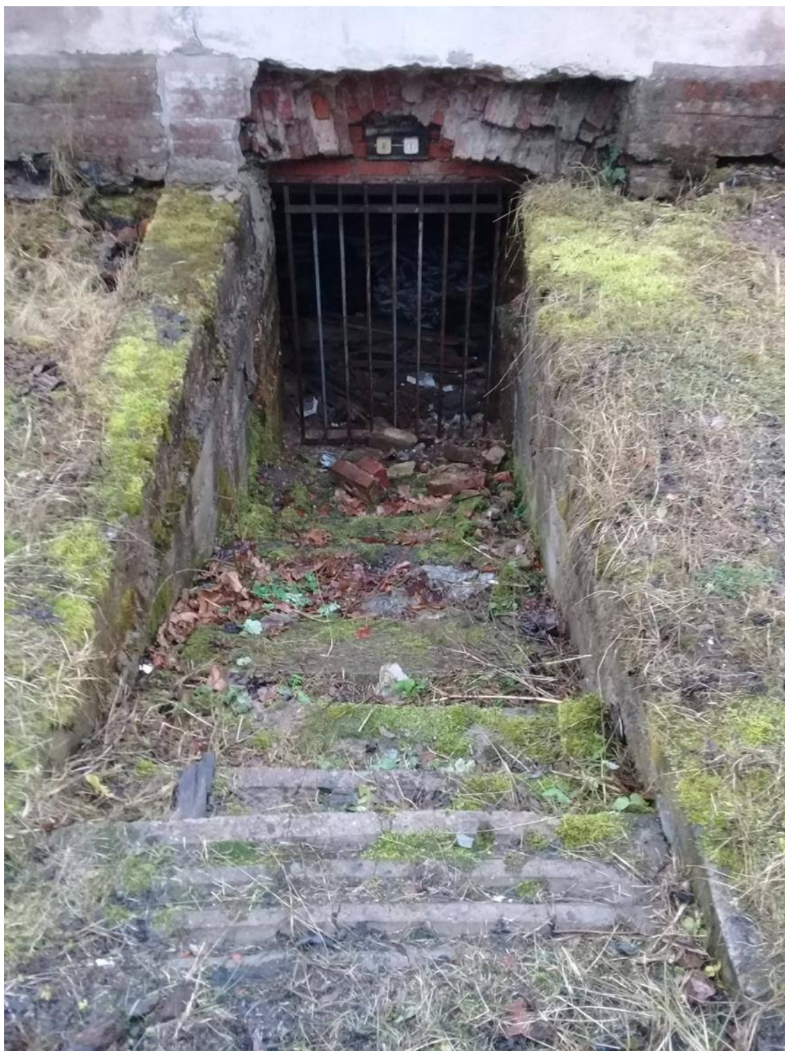
Фото № 63. Оранжерея № 3. Фрагмент северного фасада с лестницей спуска в подвальное помещение.
