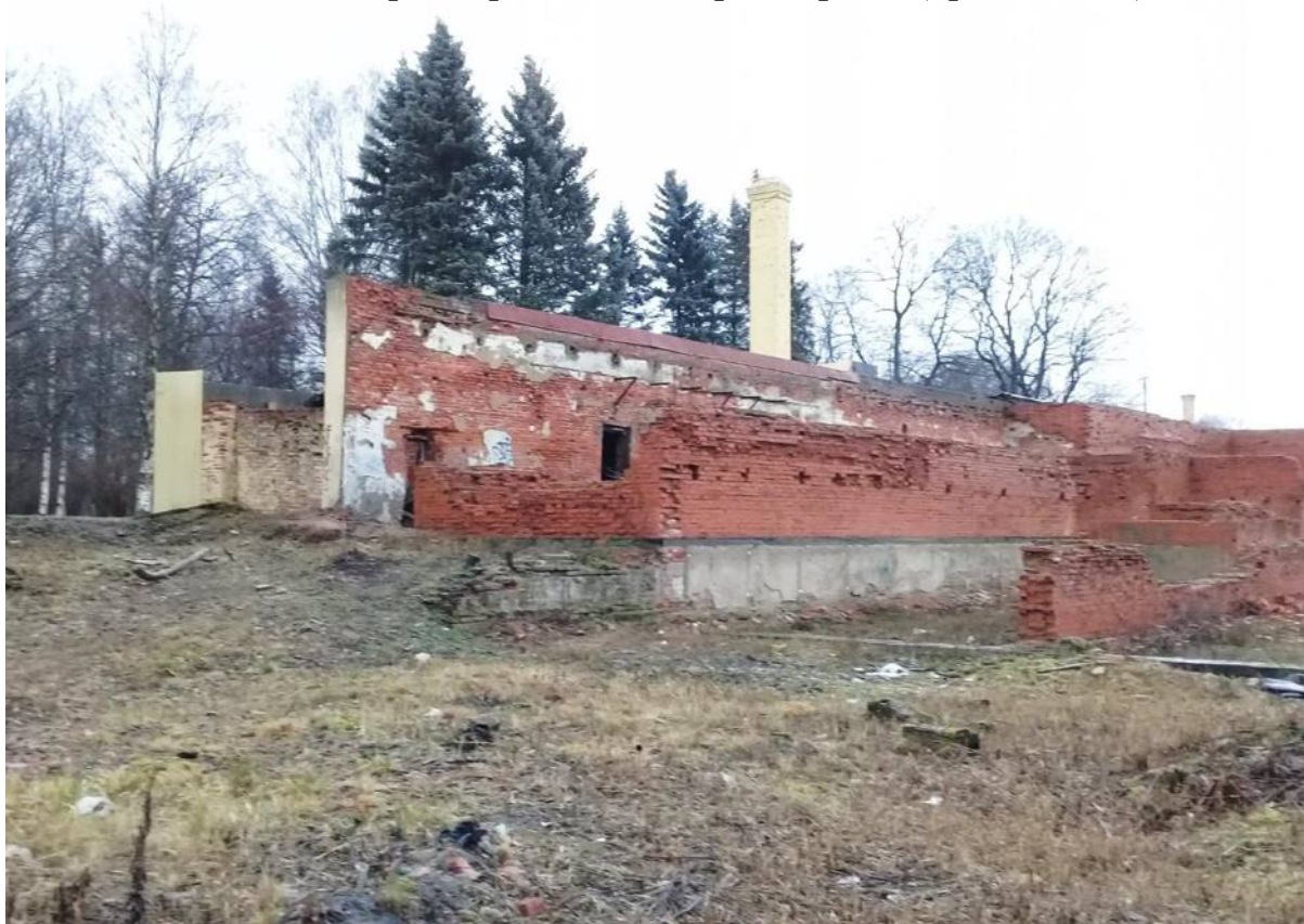
Фото № 73. Оранжерея № 5. Вид с юго-запада. На переднем плане недостроенный поздний объем, возведенный на фундаментах утраченной Оранжереи № 4.
