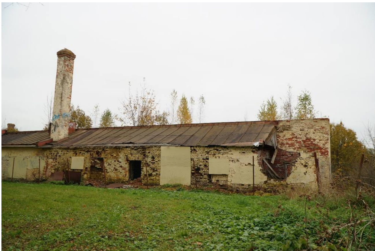
Илл. 83. Оранжерея № 5. Западная часть северного фасада. Фото 2016 г. из архива материалов заказчика.
