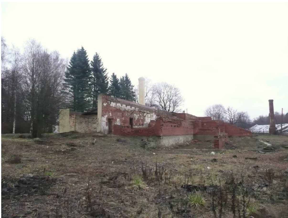
Фото № 9. Общий вид здания Оранжереи № 5 с юго-запада.
