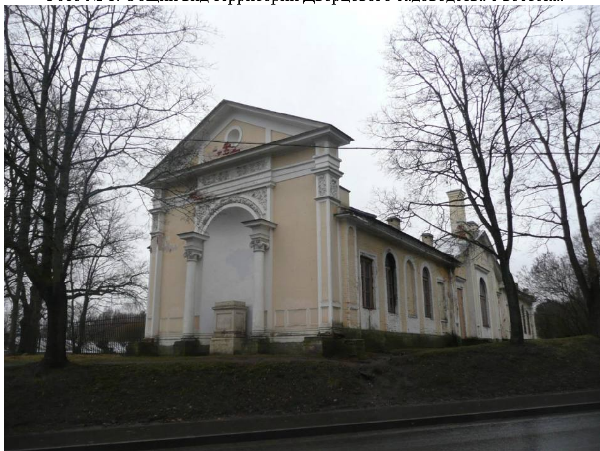
Фото № 2. Общий вид здания Оранжереи № 1 с северо-востока.
