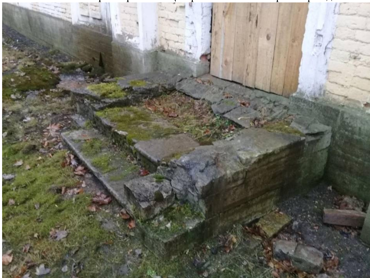
Фото № 28. Оранжерея № 1. Крыльцо центральной части северного фасада.
