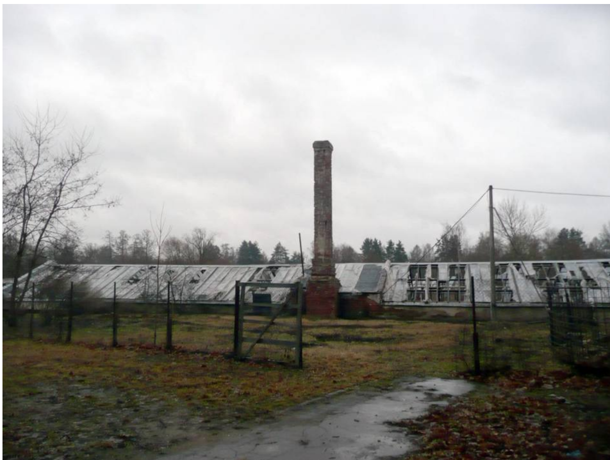
Фото № 5. Общий вид здания Оранжереи № 3 с севера.
