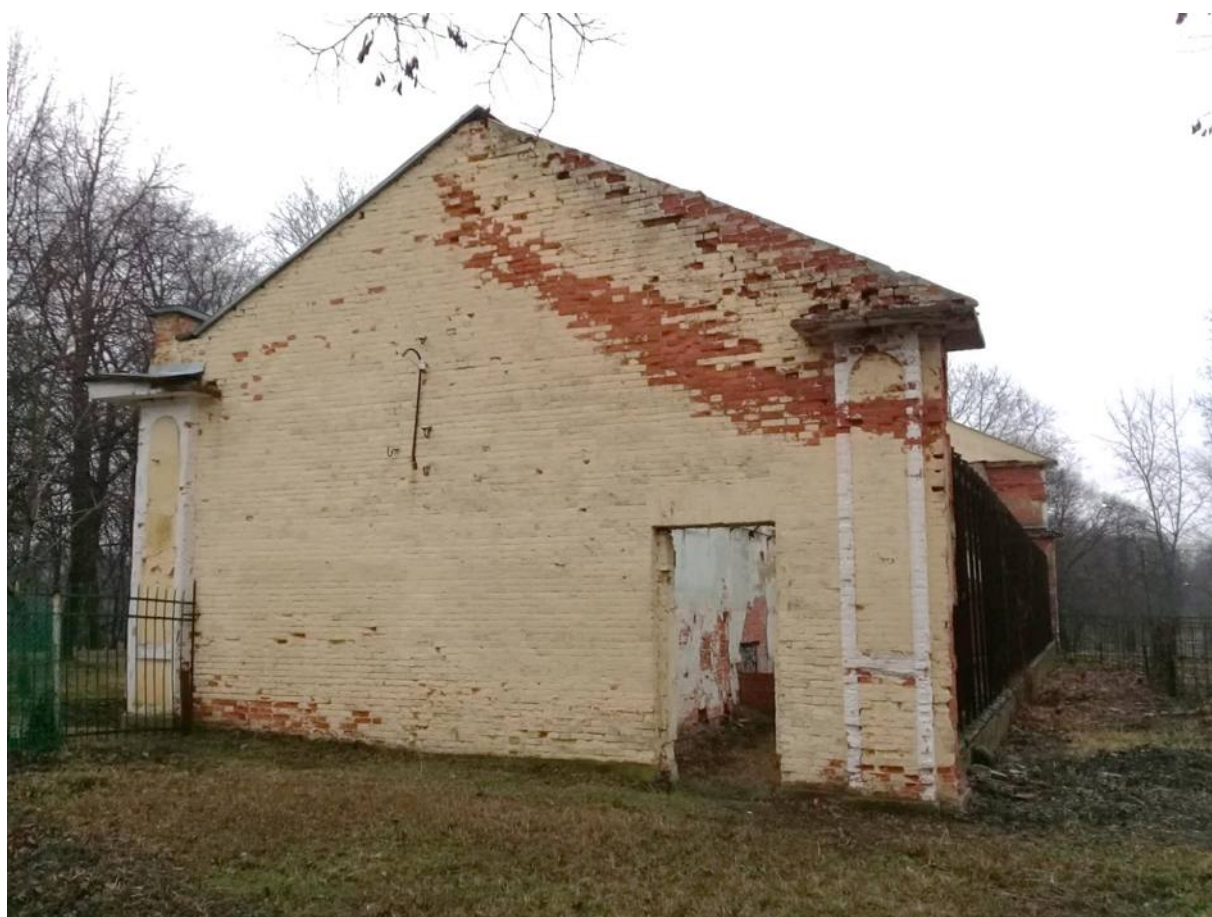
Фото № 31. Оранжерея № 1. Западный фасад.
