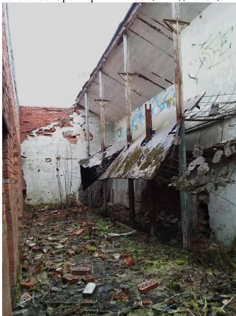
Фото № 77. Оранжерея № 5. Общий вид помещения.
