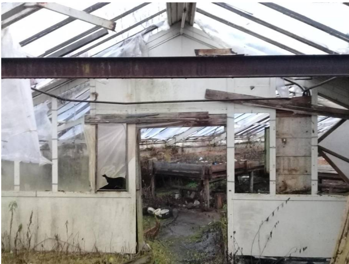
Фото № 54. Оранжерея № 2. Общий вид помещения между центральной и западной секциями (частями) здания.
