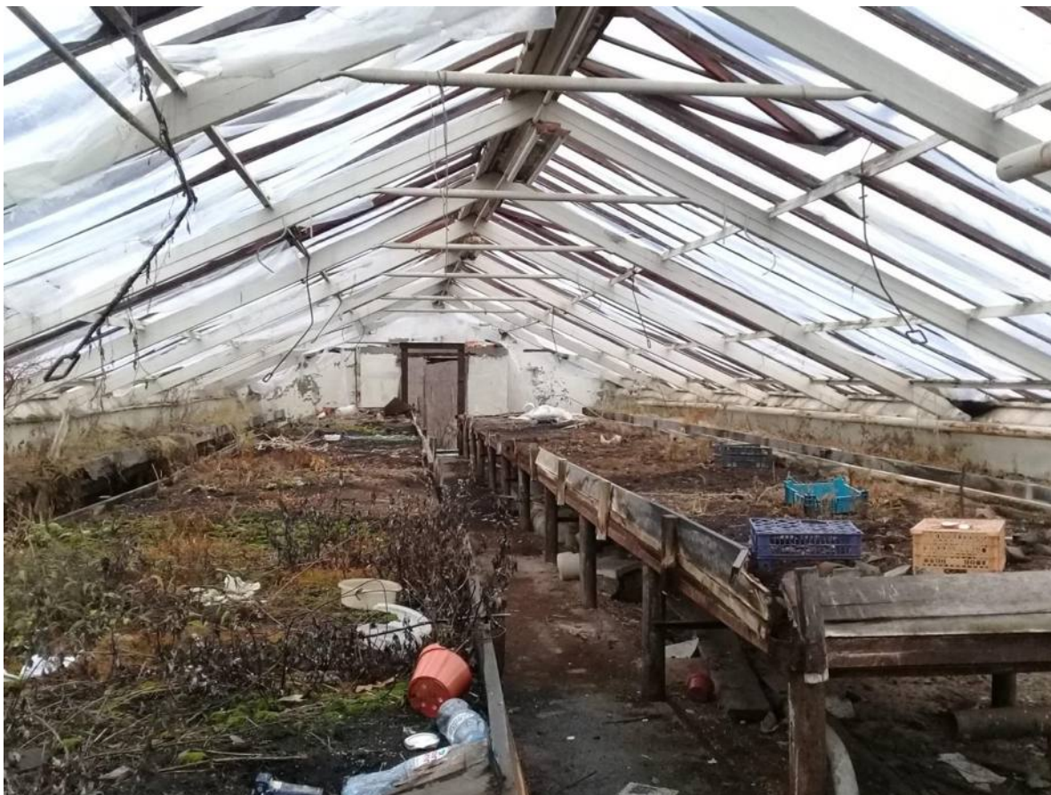
Фото № 55. Оранжерея № 2. Общий вид помещения западной части здания.
