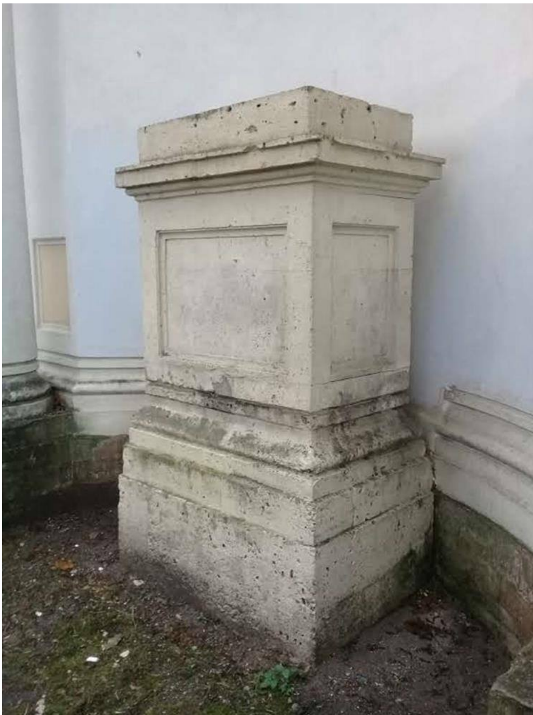
Фото № 25. Оранжерея № 1. Фрагмент восточного фасада. Каменный постамент в полукруглой эсдре.
