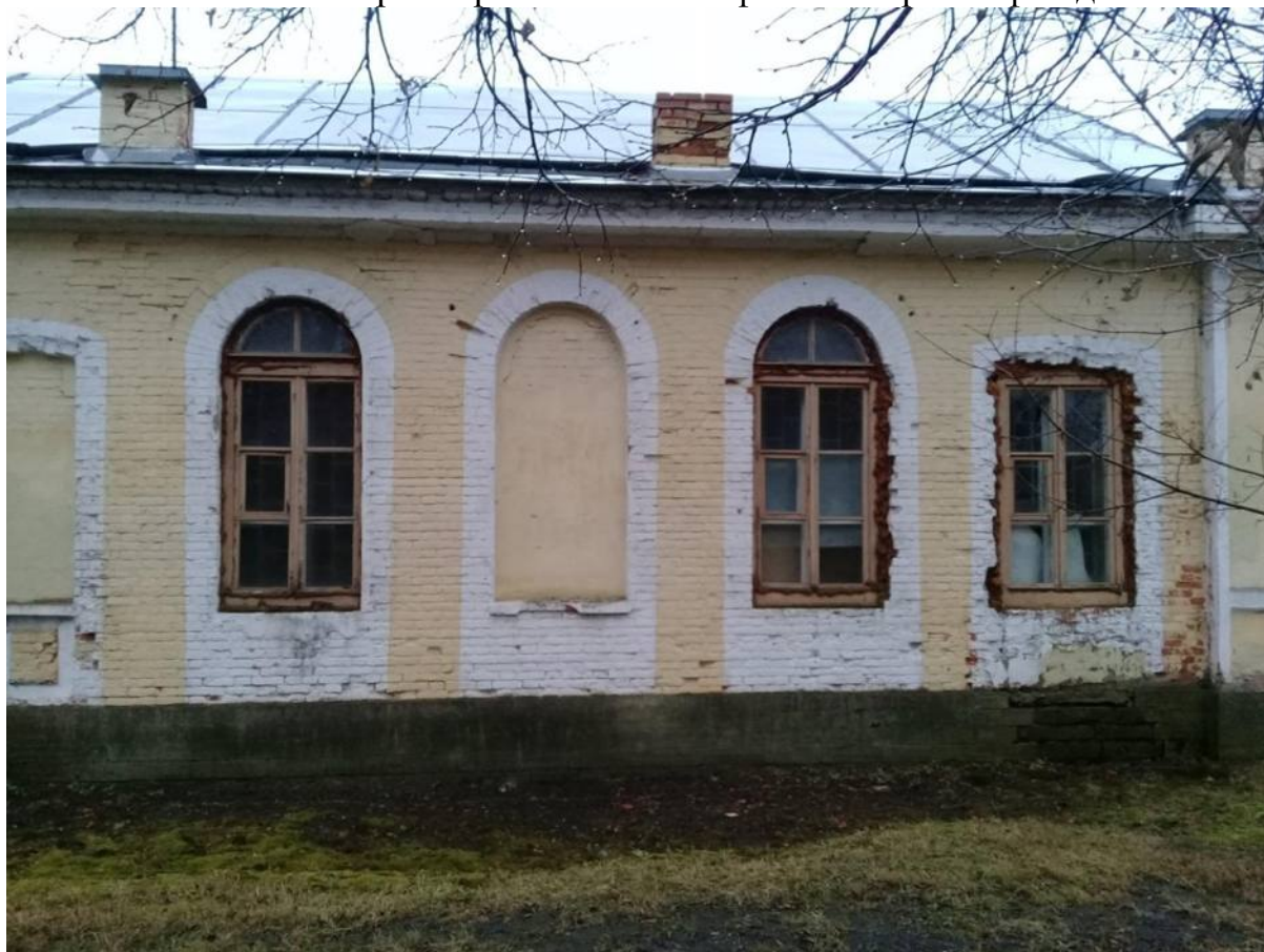
Фото № 30. Оранжерея № 1. Правый фланг северного фасада.
