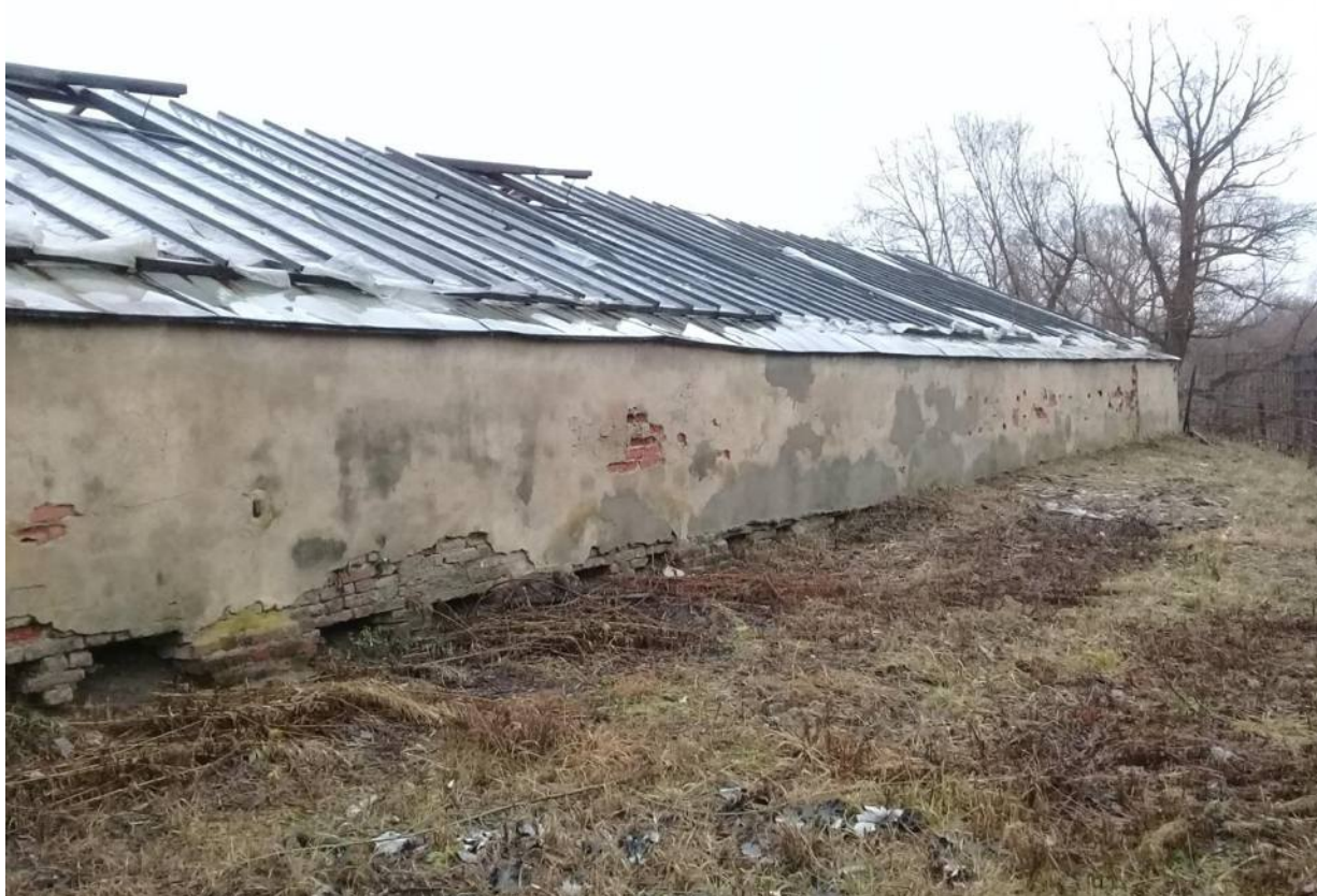
Фото № 47. Оранжерея № 2. Западная часть здания. Общий вид южного фасада.
