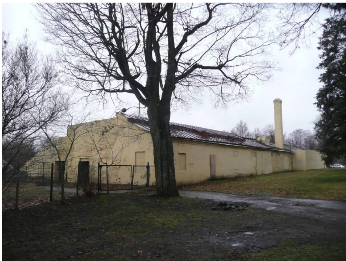
Фото № 4. Общий вид здания Оранжереи № 5 с северо-востока.
