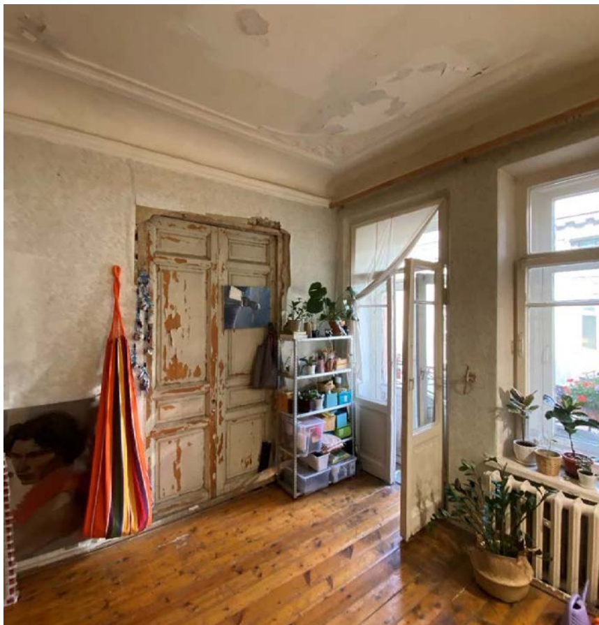
Фото 13. Помещение № 10. Комната. Сохранившиеся оконные и дверные заполнения. Вид с юго-запада.
