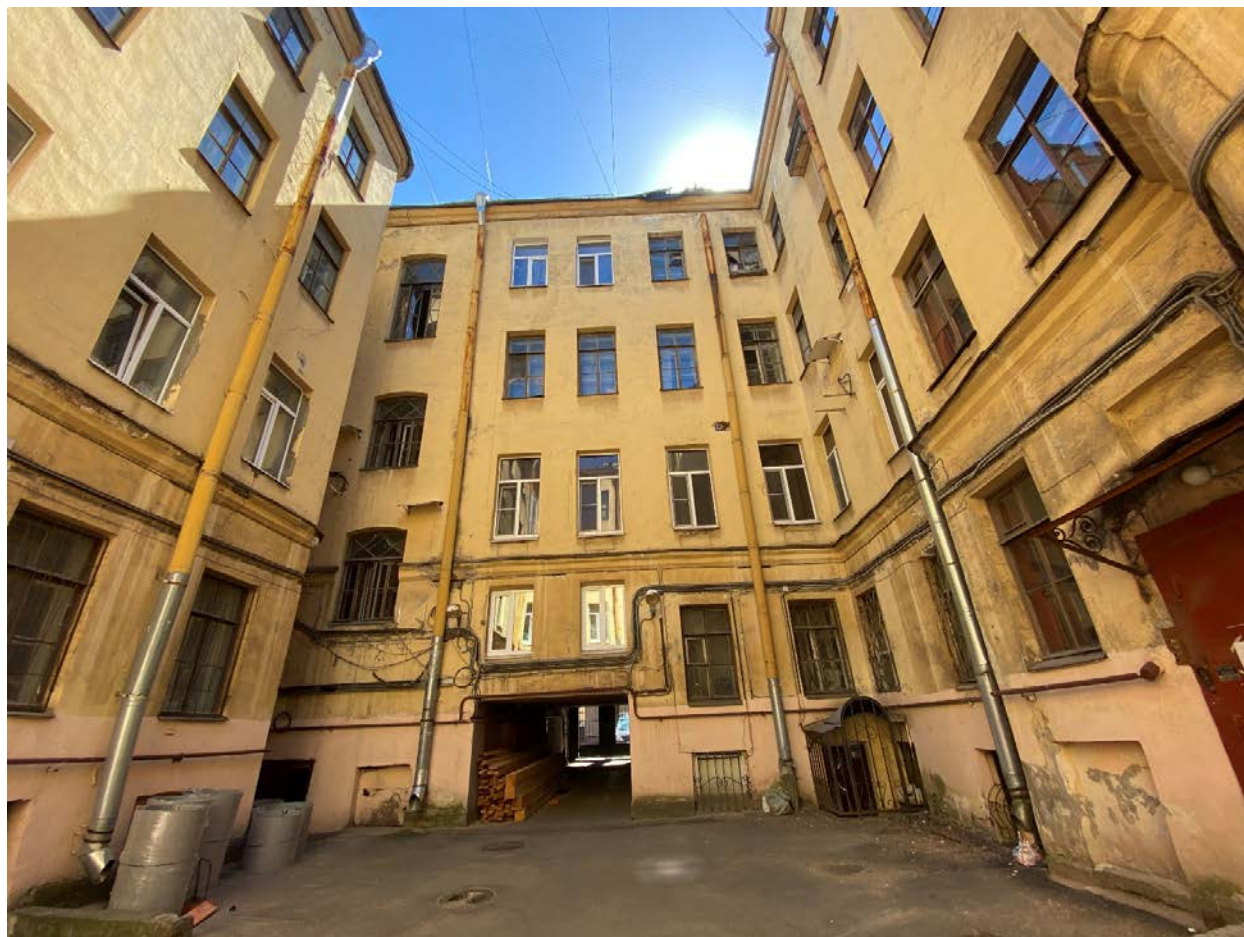
Фото 7. Восточный дворовой фасад. Вид с востока.
