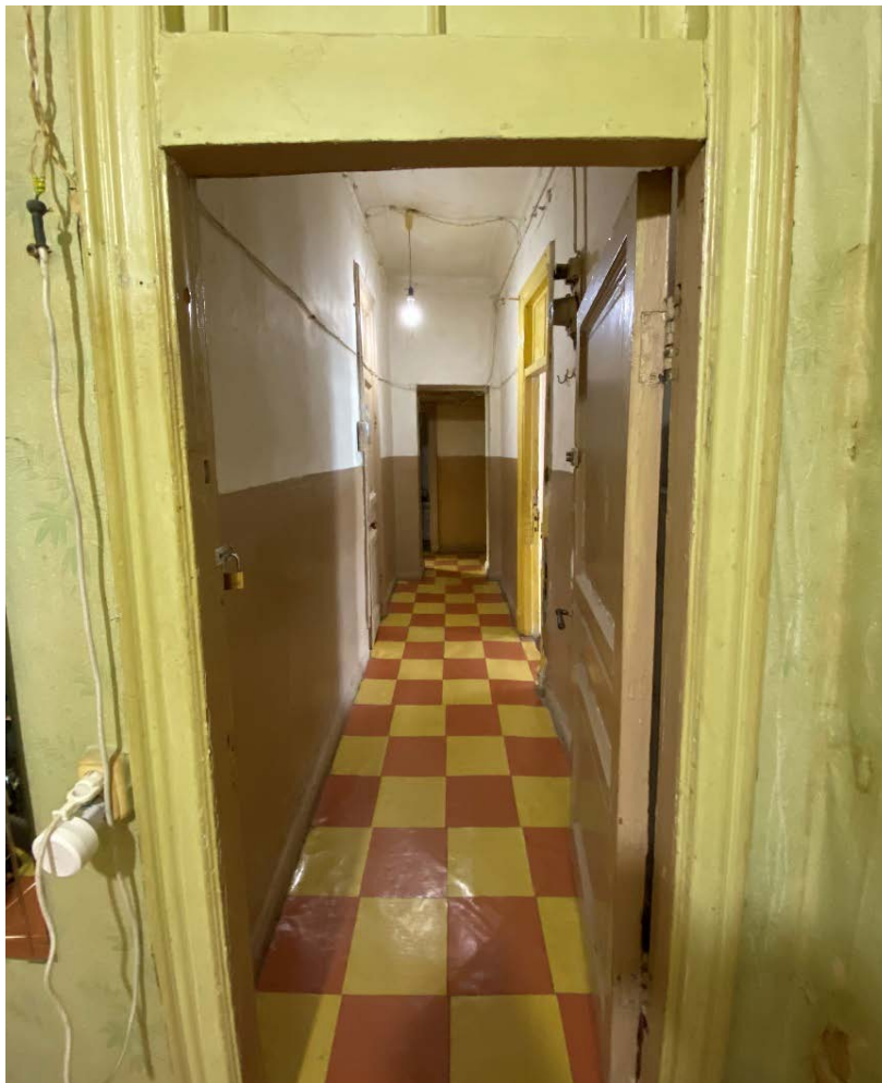
Фото 11. Помещение № 2. Коридор. Вид с юга.
