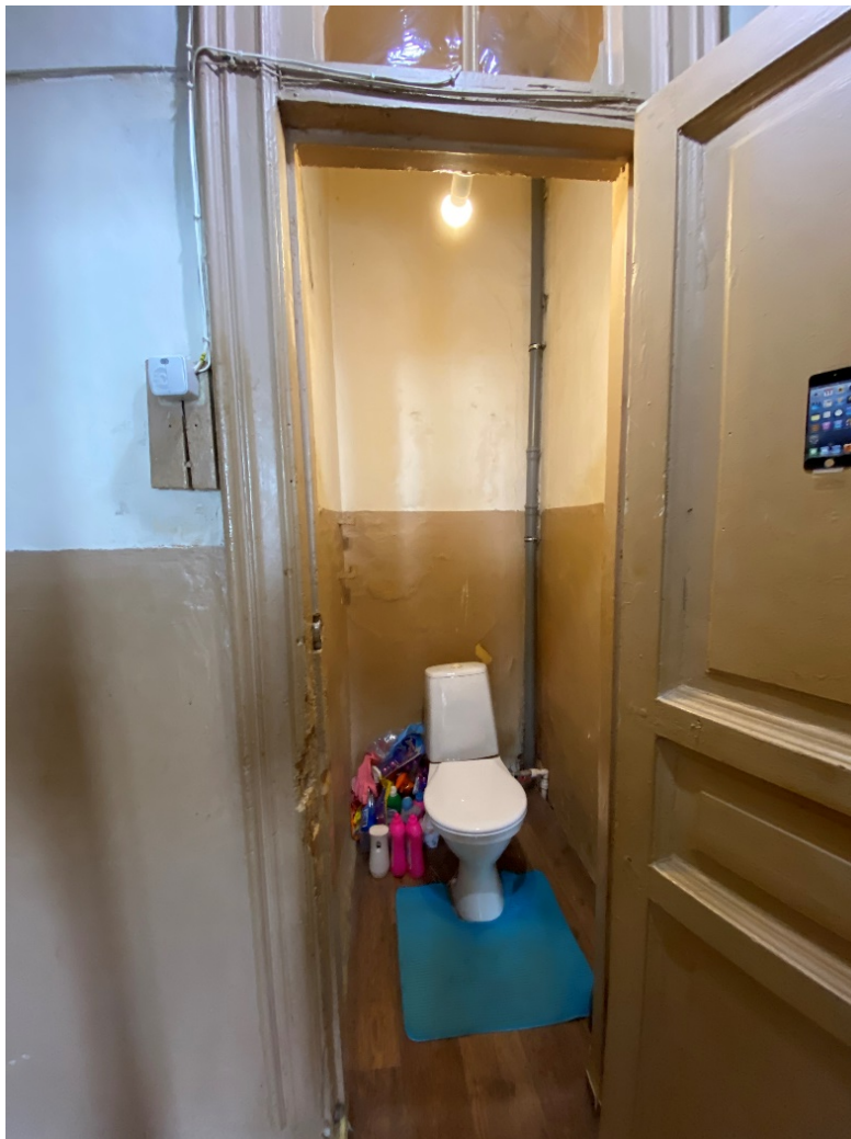
Фото 19. Помещение № 3. Туалет. Общий вид с востока.
