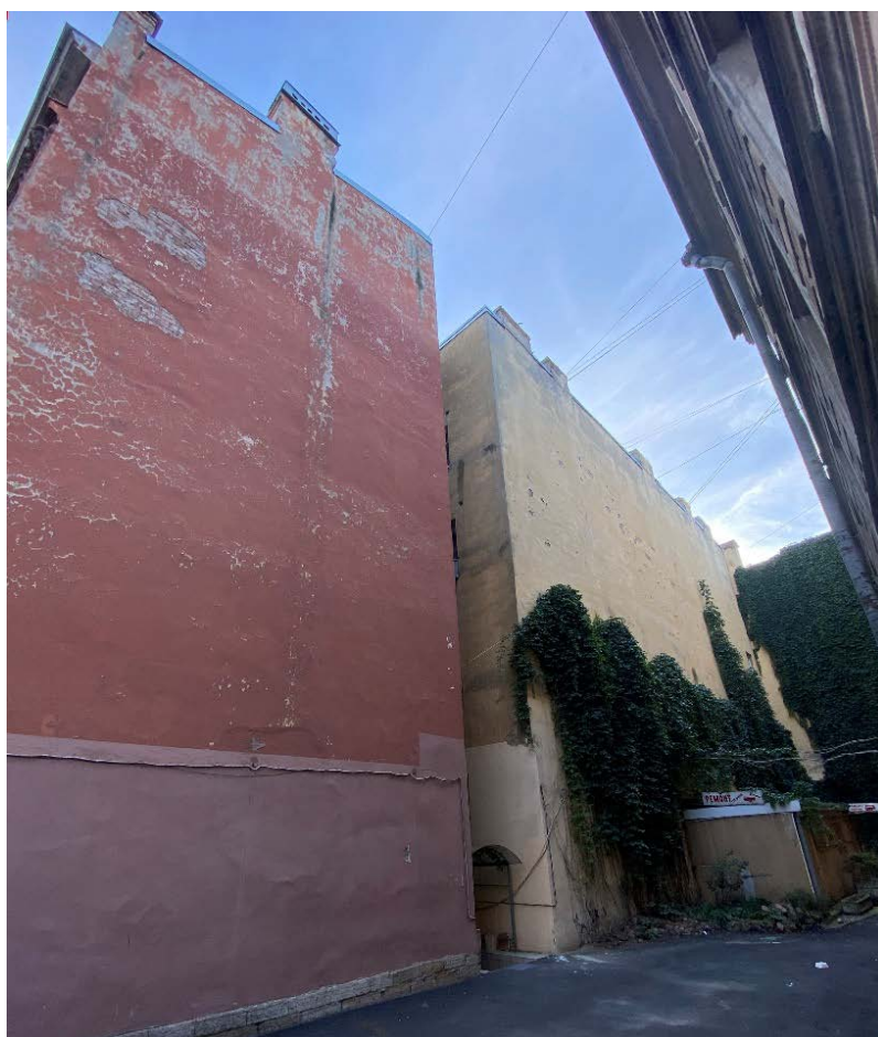
Фото 4. Брандмауэрная стена. Вид с северо-востока.
