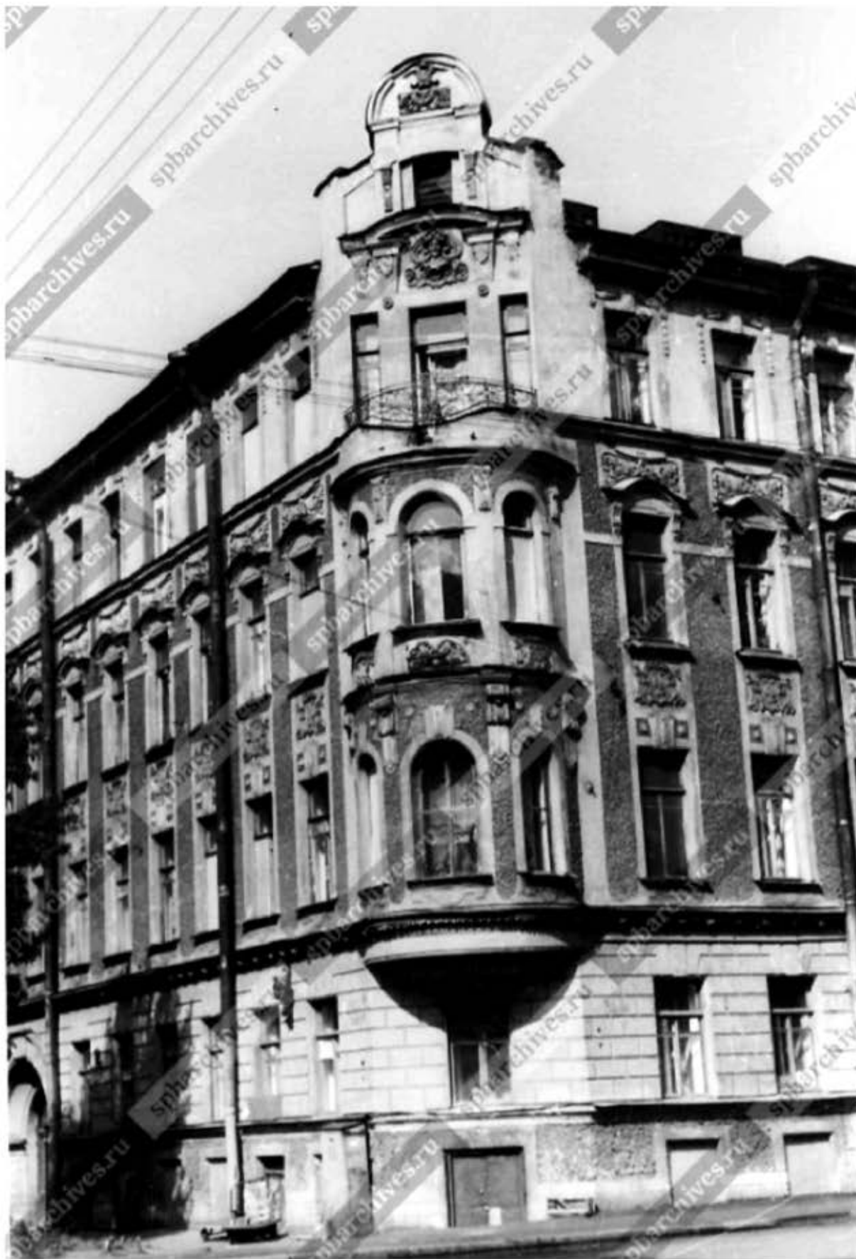
Илл. 21. «Вид углового эркера жилого дома № 15/17 по 6-й Красноармейской улице (бывший доходный дом З.Н.Левина, архитектор А.И. Зазерский, 1903 год)». Архивный шифр: ЦГАКФФД СПб Ар 225735. Дата съёмки: 10 августа 1986 г.
