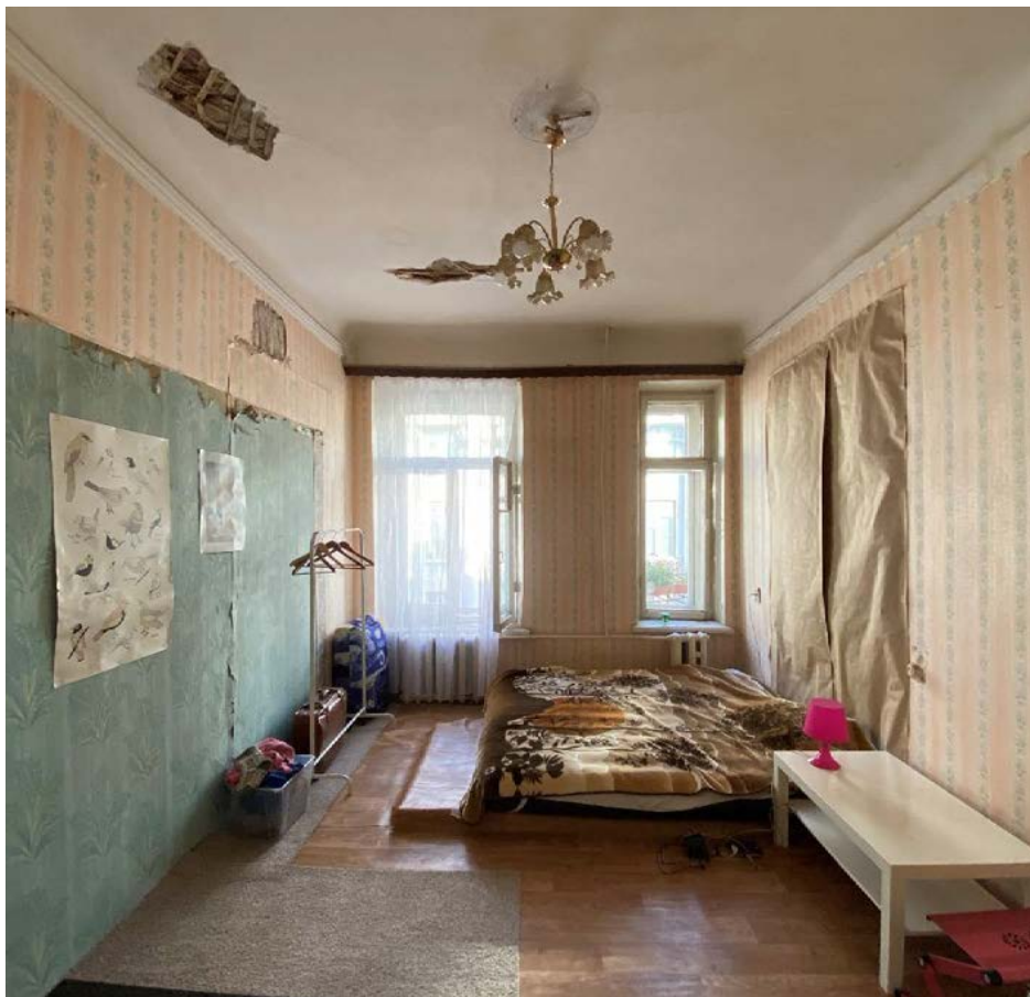
Фото 17. Помещение № 9. Комната. Общий вид с запада.
