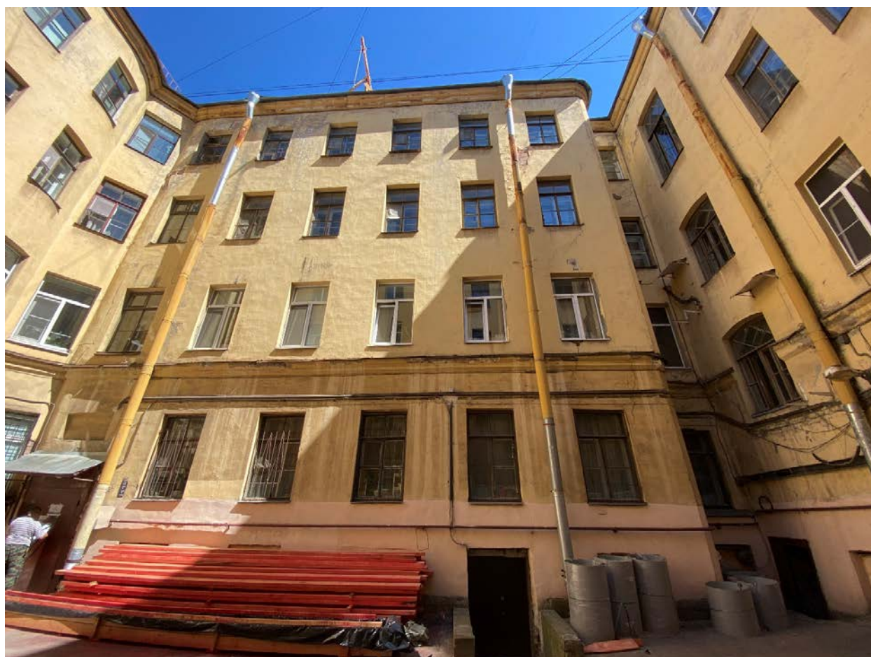
Фото 6. Северный дворовой фасад. Вид с севера.
