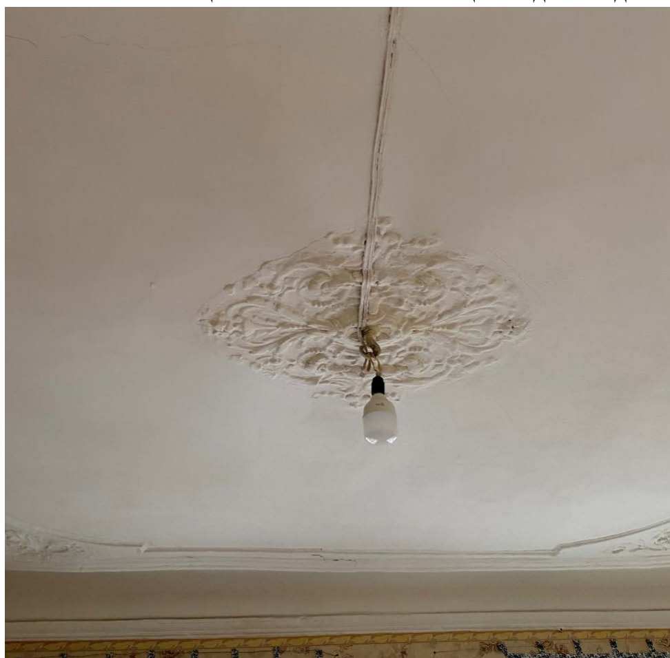
Фото 28. Декоративная отделка потолка в помещении № 7. Комната. Общий вид с запада.
