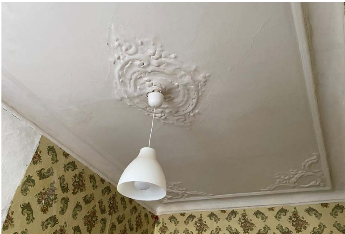
Фото 31. Декоративная отделка потолка в помещении № 8. Комната. Вид с востока.
