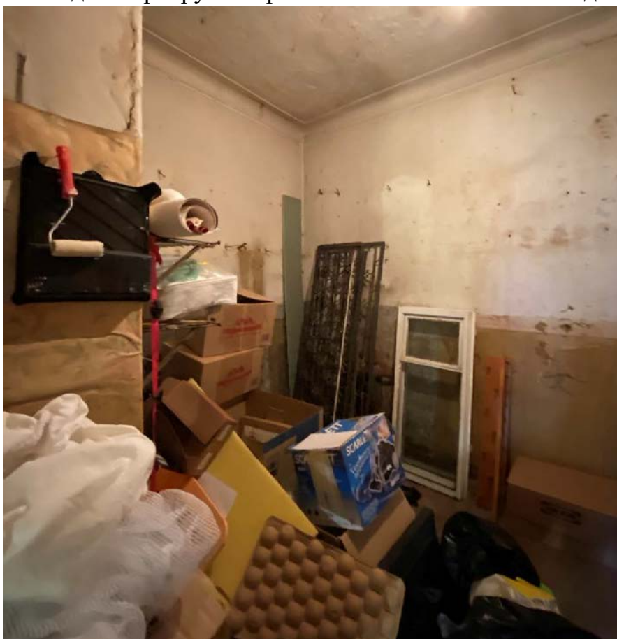
Фото 24. Помещение № 11. Кладовая. Общий вид с северо-запада.
