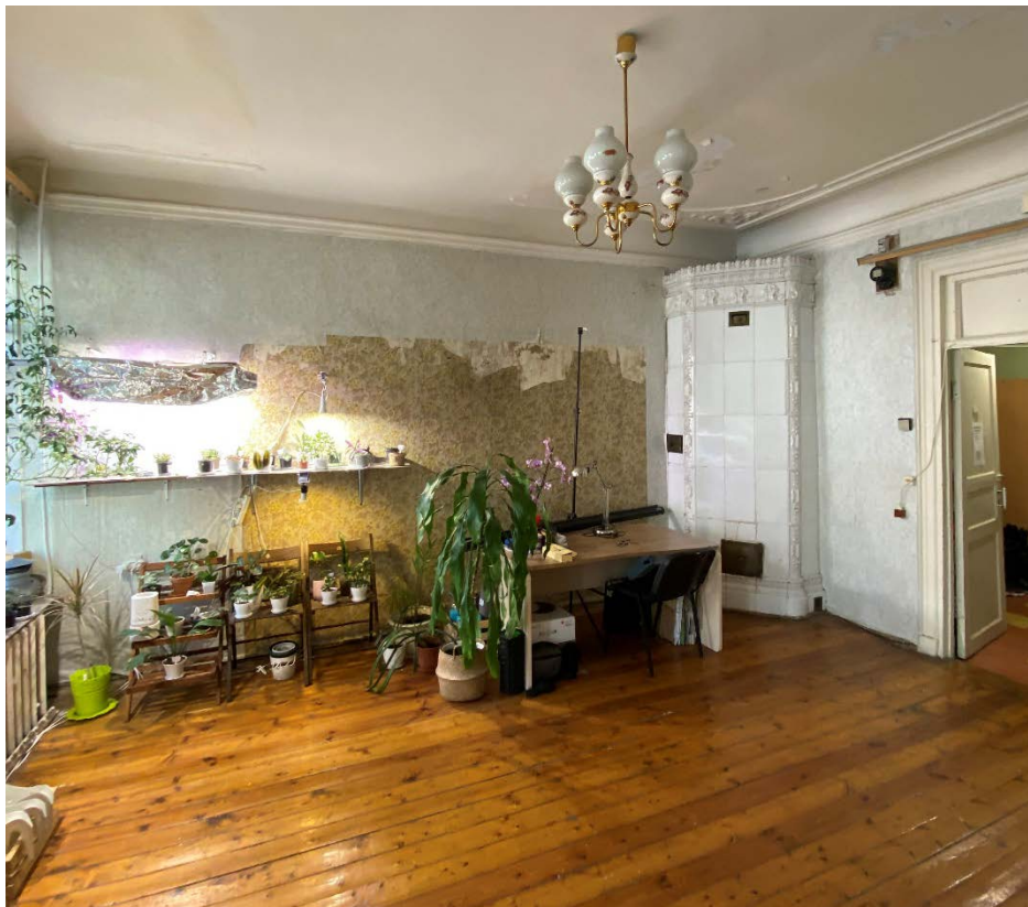
Фото 15. Помещение № 10. Комната. Вид с северо-востока.
