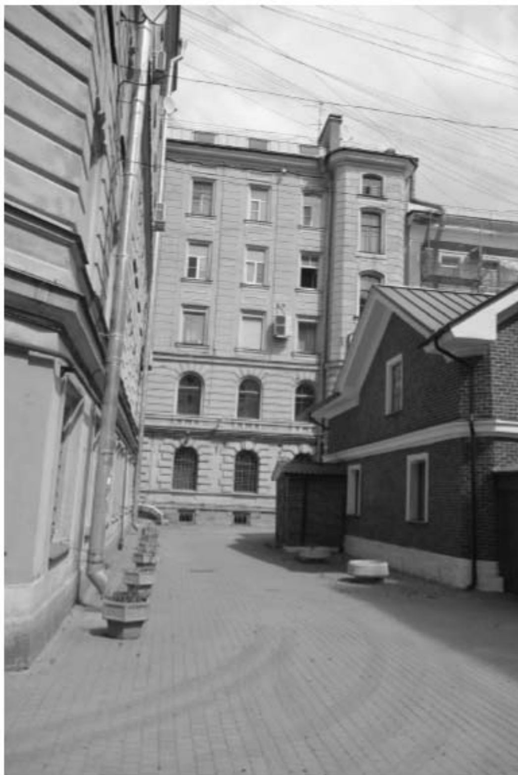
9. Фрагмент юго-западного дворового фасада объекта культурного наследия регионального значения «Доходный дом Александрo-Невской Лавры», расположенного по адресу: г. Санкт-Петербург, Невский пр., д. 153, литера А.
