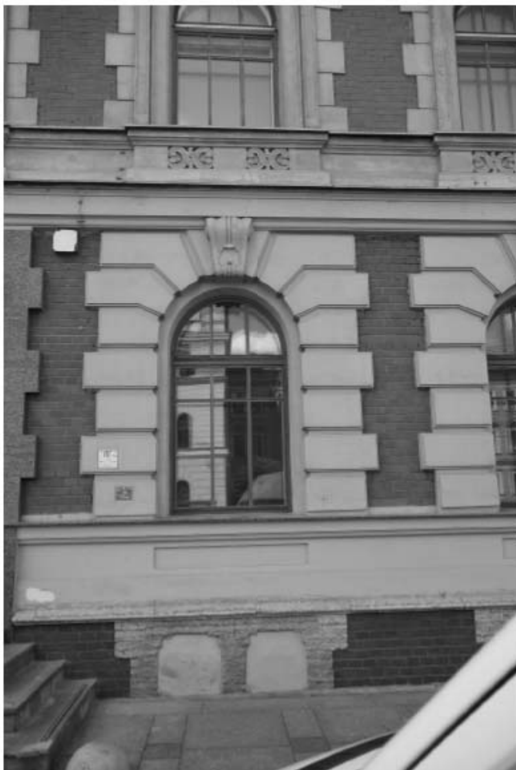
6. Вид оконного проема в уровне 1-го этажа, по 2-й световой оси лицевого фасада объекта культурного наследия регионального значения «Доходный дом Александро-Невской Лаврь», расположенного по адресу: г. Санкт-Петербург, Невский пр., д. 153, литера А.
