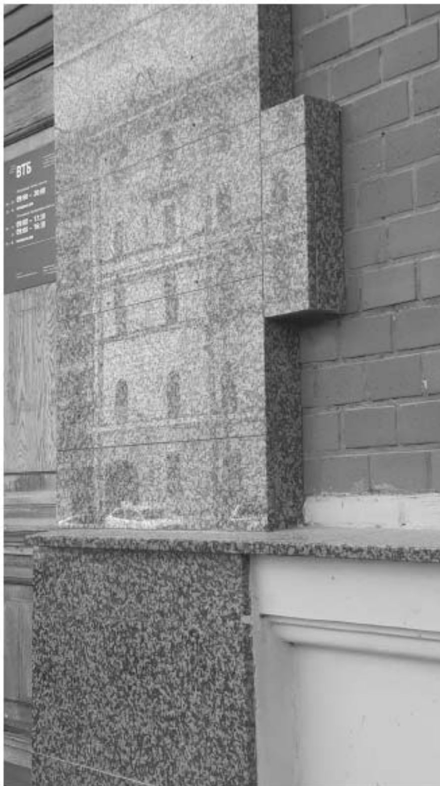
4. Фрагмент поздней гранитной облицовки на лицевом фасаде объекта культурного наследия регионального значения «Доходный дом Александро-Невской Лавры», расположенного по адресу: г. Санкт-Петербург, Невский пр., д. 153, литера А.
