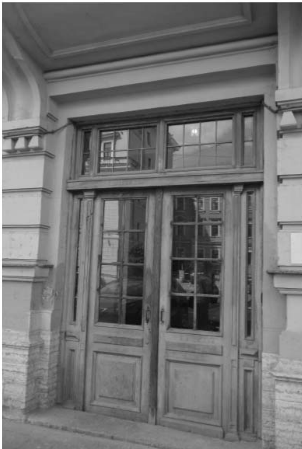
8. Вид дверного проема по 7-й световой оси лицевого фасада объекта культурного наследия регионального значения «Доходный дом Александро-Невской Лавры», расположенного по адресу: г. Санкт-Петербург, Невский пр., д. 153, литера А.
